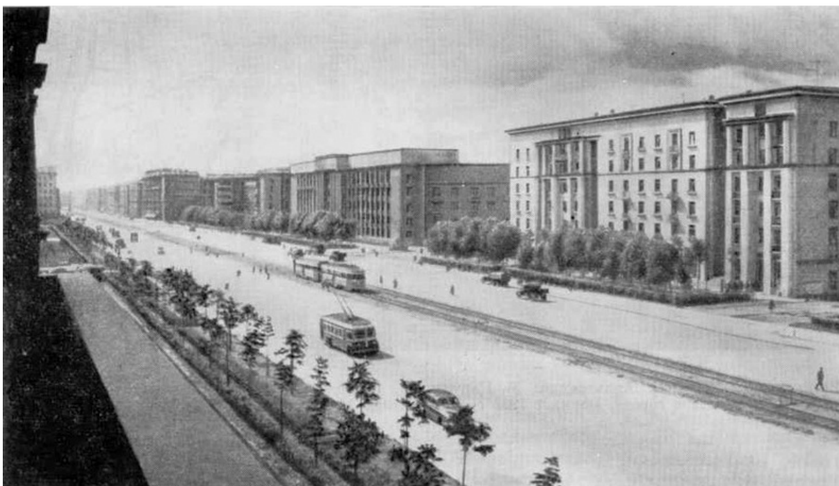
Илл. 20. Застройка Московского проспекта. 1954 г. https://pastvu.com/p/692298
