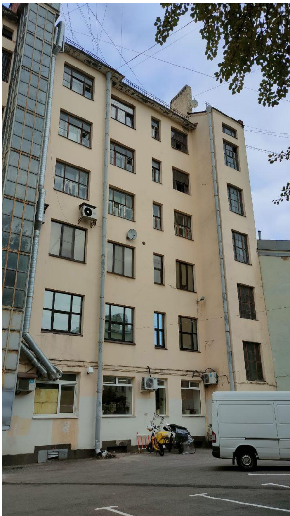
Фото 11. Вид на фрагмент дворового юго-восточного фасада объекта культурного наследия федерального значения «Доходный дом Демидова Н.П.», расположенный по адресу: Санкт-Петербург, Большой проспект В.О., д. 50, лит. А (Большой пр. В.О., 50).
