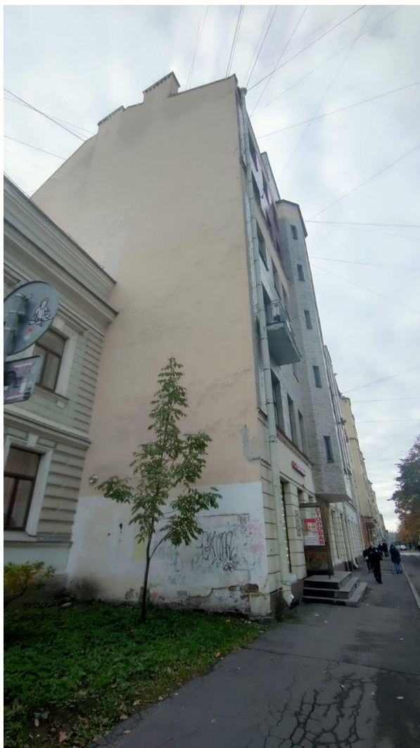
Фото 7. Вид на фрагмент северо-восточного фасада объекта культурного наследия федерального значения «Доходный дом Демидова Н.П.», расположенный по адресу: Санкт-Петербург, Большой проспект В.О., д. 50, лит. А (Большой пр. В.О., 50).
