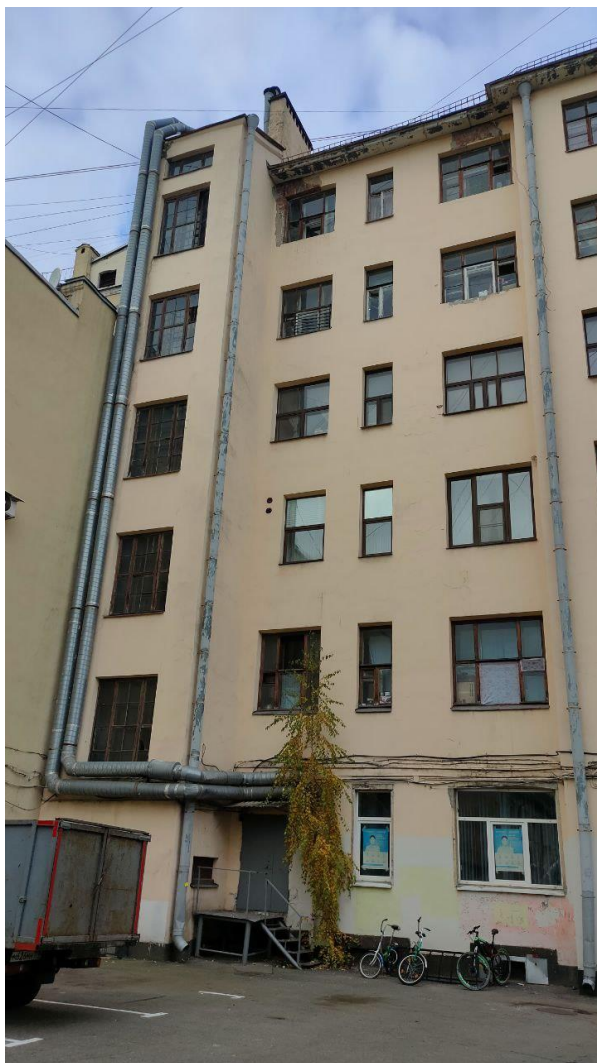
Фото 9. Вид на фрагмент дворового юго-восточного фасада объекта культурного наследия федерального значения «Доходный дом Демидова Н.П.», расположенный по адресу: Санкт-Петербург, Большой проспект В.О., д. 50, лит. А (Большой пр. В.О., 50).
