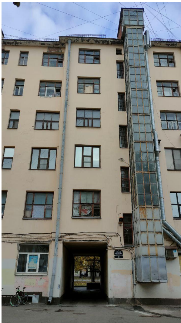
Фото 10. Вид на фрагмент дворового юго-восточного фасада объекта культурного наследия федерального значения «Доходный дом Демидова Н.П.», расположенный по адресу: Санкт-Петербург, Большой проспект В.О., д. 50, лит. А (Большой пр. В.О., 50).
