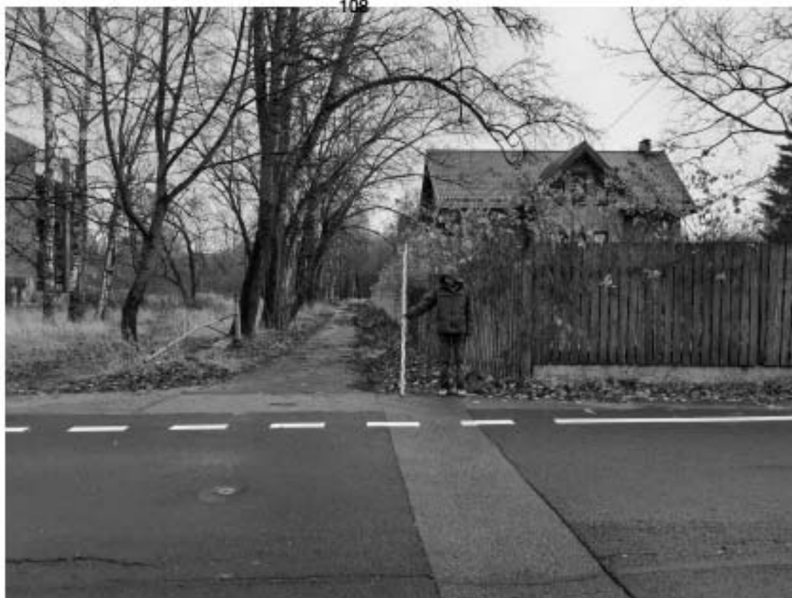
Рис. 23. «Реконструкция КЛ-6 кВ Ф.65-6 Л ПС-250 в части замены трассы КЛ на кабель из спитого ПЭ ориентировочной протяженностью 3,08 км» и «Реконструкция КЛ-6 кВ Ф.65-3 Л ПС-250 в части замены трассы КЛ на кабель из спитого ПЭ ориентировочной протяженностью 3,08 км». Общий вид трассы. Точка съемки 2. Вид на восток.
