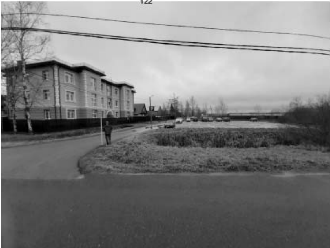
Рис. 51. «Реконструкция КЛ-6 кВ Ф.65-6 Л ПС-250 в части замены трассы КЛ на кабель из спитого ПЭ ориентировочной протяженностью 3,08 км» и «Реконструкция КЛ-6 кВ Ф.65-3 Л ПС-250 в части замены трассы КЛ на кабель из спитого ПЭ ориентировочной протяженностью 3,08 км». Общий вид трассы. Точка съемки 18. Вид на юг.
