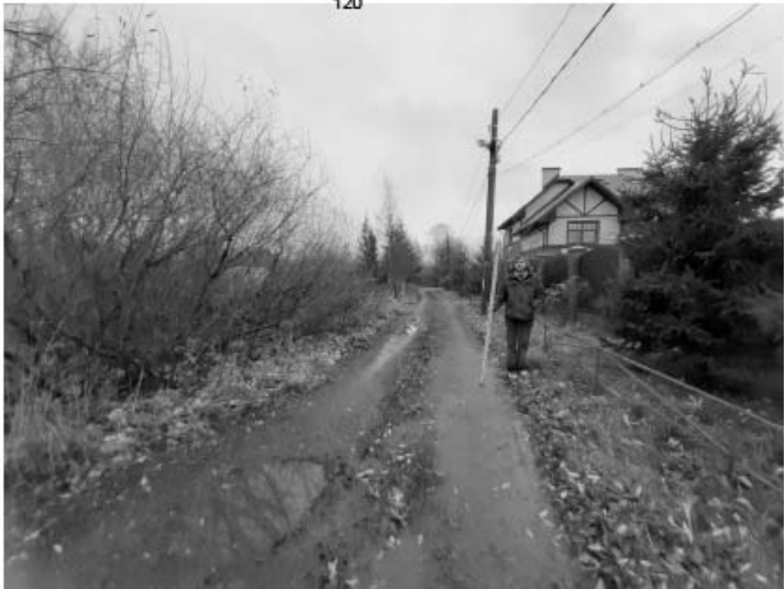
Рис. 47. «Реконструкция КЛ-6 кВ Ф.65-6 Л ПС-250 в части замены трассы КЛ на кабель из спитого ПЭ ориентировочной протяженностью 3,08 км» и «Реконструкция КЛ-6 кВ Ф.65-3 Л ПС-250 в части замены трассы КЛ на кабель из спитого ПЭ ориентировочной протяженностью 3,08 км». Общий вид трассы. Точка съемки 15. Вид на восток.
