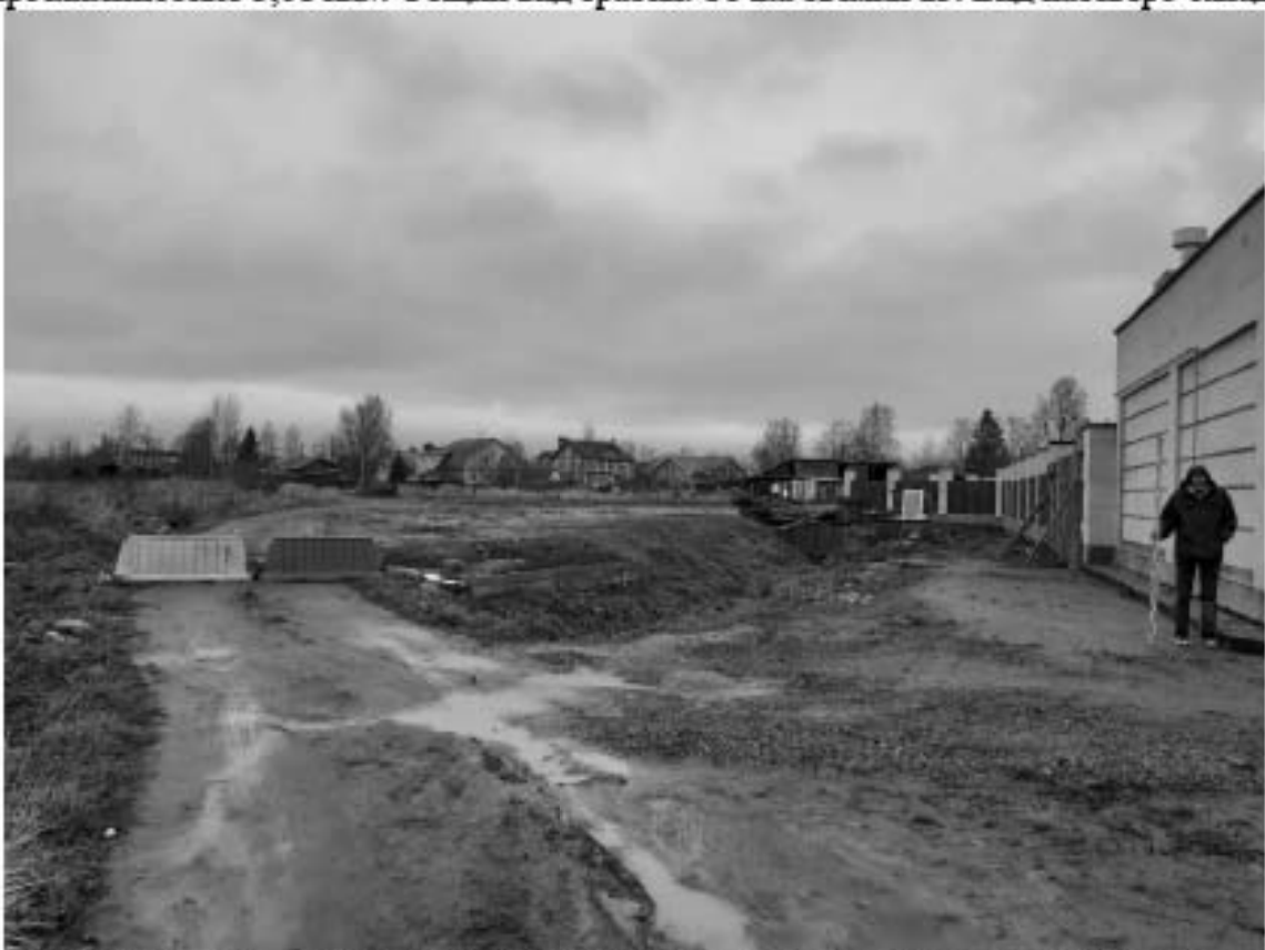
Рис. 62. «Реконструкция КЛ-6 кВ Ф.65-6 Л ПС-250 в части замены трассы КЛ на кабель из спитого ПЭ ориентировочной протяженностью 3,08 км» и «Реконструкция КЛ-6 кВ Ф.65-3 Л ПС-250 в части замены трассы КЛ на кабель из спитого ПЭ ориентировочной протяженностью 3,08 км». Общий вид трассы. Точка съемки 24. Вид на север.
