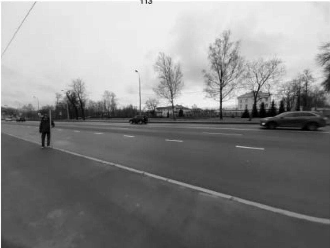
Рис. 33. «Реконструкция КЛ-6 кВ Ф.65-6 Л ПС-250 в части замены трассы КЛ на кабель из спитого ПЭ ориентировочной протяженностью 3,08 км» и «Реконструкция КЛ-6 кВ Ф.65-3 Л ПС-250 в части замены трассы КЛ на кабель из спитого ПЭ ориентировочной протяженностью 3,08 км». Общий вид трассы. Точка съемки 8. Вид на юго-восток.
