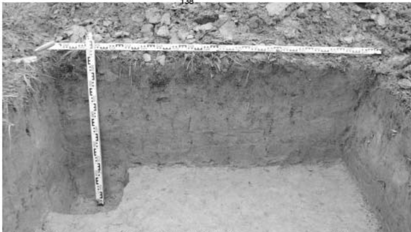
Рис. 80. «Реконструкция КЛ-6 кВ Ф.65-6 Л ПС-250 в части замены трассы КЛ на кабель из спитого ПЭ ориентировочной протяженностью 3,08 км» и «Реконструкция КЛ-6 кВ Ф.65-3 Л ПС-250 в части замены трассы КЛ на кабель из спитого ПЭ ориентировочной протяженностью 3,08 км». Шурф 2. Стратиграфия восточной стенки.
