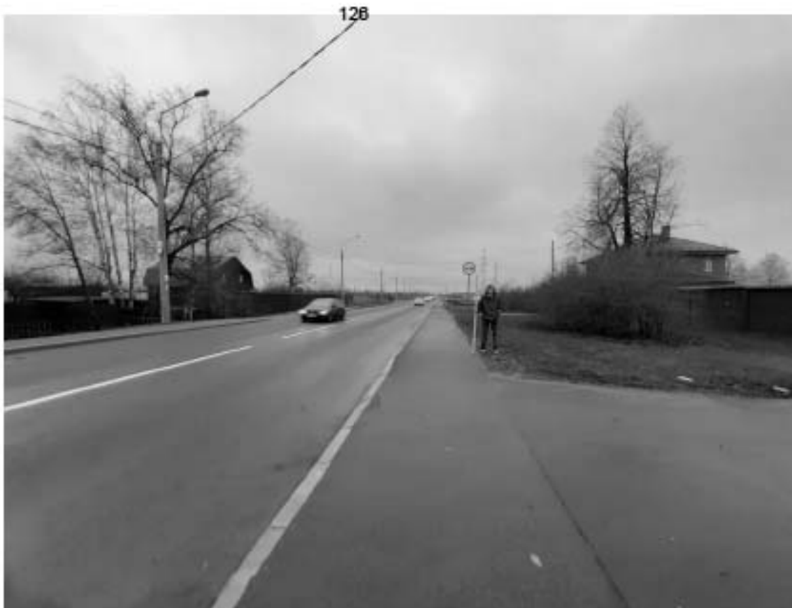
Рис. 59. «Реконструкция КЛ-6 кВ Ф.65-6 Л ПС-250 в части замены трассы КЛ на кабель из спитого ПЭ ориентировочной протяженностью 3,08 км» и «Реконструкция КЛ-6 кВ Ф.65-3 Л ПС-250 в части замены трассы КЛ на кабель из спитого ПЭ ориентировочной протяженностью 3,08 км». Общий вид трассы. Точка съемки 22. Вид на север.
