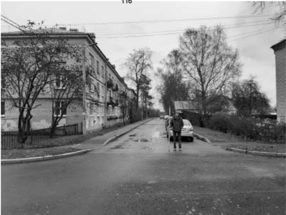
Рис. 39. «Реконструкция КЛ-6 кВ Ф.65-6 Л ПС-250 в части замены трассы КЛ на кабель из спитого ПЭ ориентировочной протяженностью 3,08 км» и «Реконструкция КЛ-6 кВ Ф.65-3 Л ПС-250 в части замены трассы КЛ на кабель из спитого ПЭ ориентировочной протяженностью 3,08 км». Общий вид трассы. Точка съемки 11 вид на восток.
