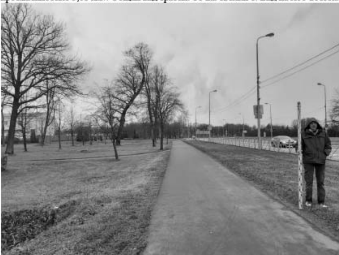
Рис. 34. «Реконструкция КЛ-6 кВ Ф.65-6 Л ПС-250 в части замены трассы КЛ на кабель из спитого ПЭ ориентировочной протяженностью 3,08 км» и «Реконструкция КЛ-6 кВ Ф.65-3 Л ПС-250 в части замены трассы КЛ на кабель из спитого ПЭ ориентировочной протяженностью 3,08 км». Общий вид трассы. Точка съемки 9 вид на запад.
