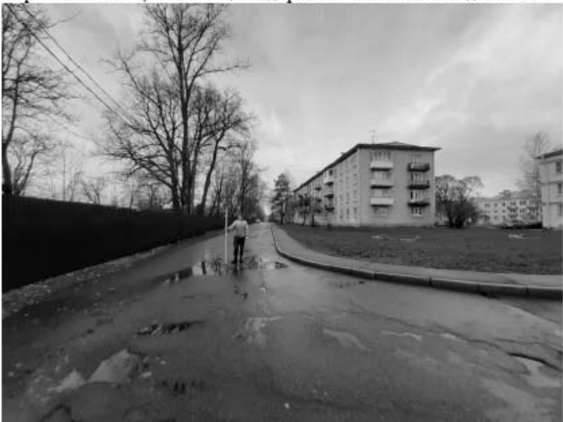
Рис. 40. «Реконструкция КЛ-6 кВ Ф.65-6 Л ПС-250 в части замены трассы КЛ на кабель из спитого ПЭ ориентировочной протяженностью 3,08 км» и «Реконструкция КЛ-6 кВ Ф.65-3 Л ПС-250 в части замены трассы КЛ на кабель из спитого ПЭ ориентировочной протяженностью 3,08 км». Общий вид трассы. Точка съемки 12 вид на запад.
