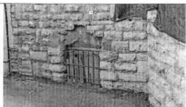
Фото 12. Фрагмент западного торцевого фасада.
