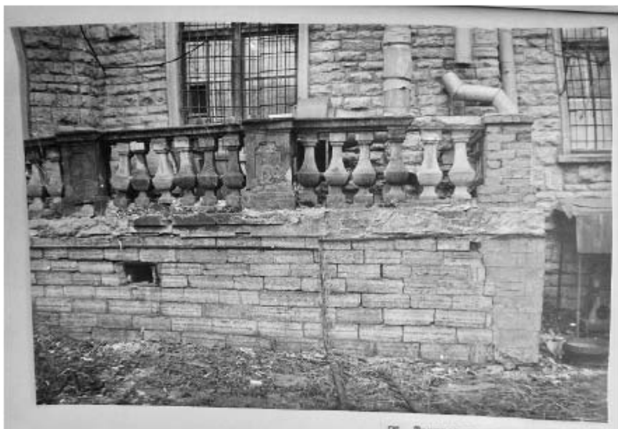
Илл. 125. Терраса восточного фасада. Лит. В. 1991 г. Архив КГИОП. П. 1560. Пр-4. Научно-проектная документация. Раздел 2. Фотофиксация.
