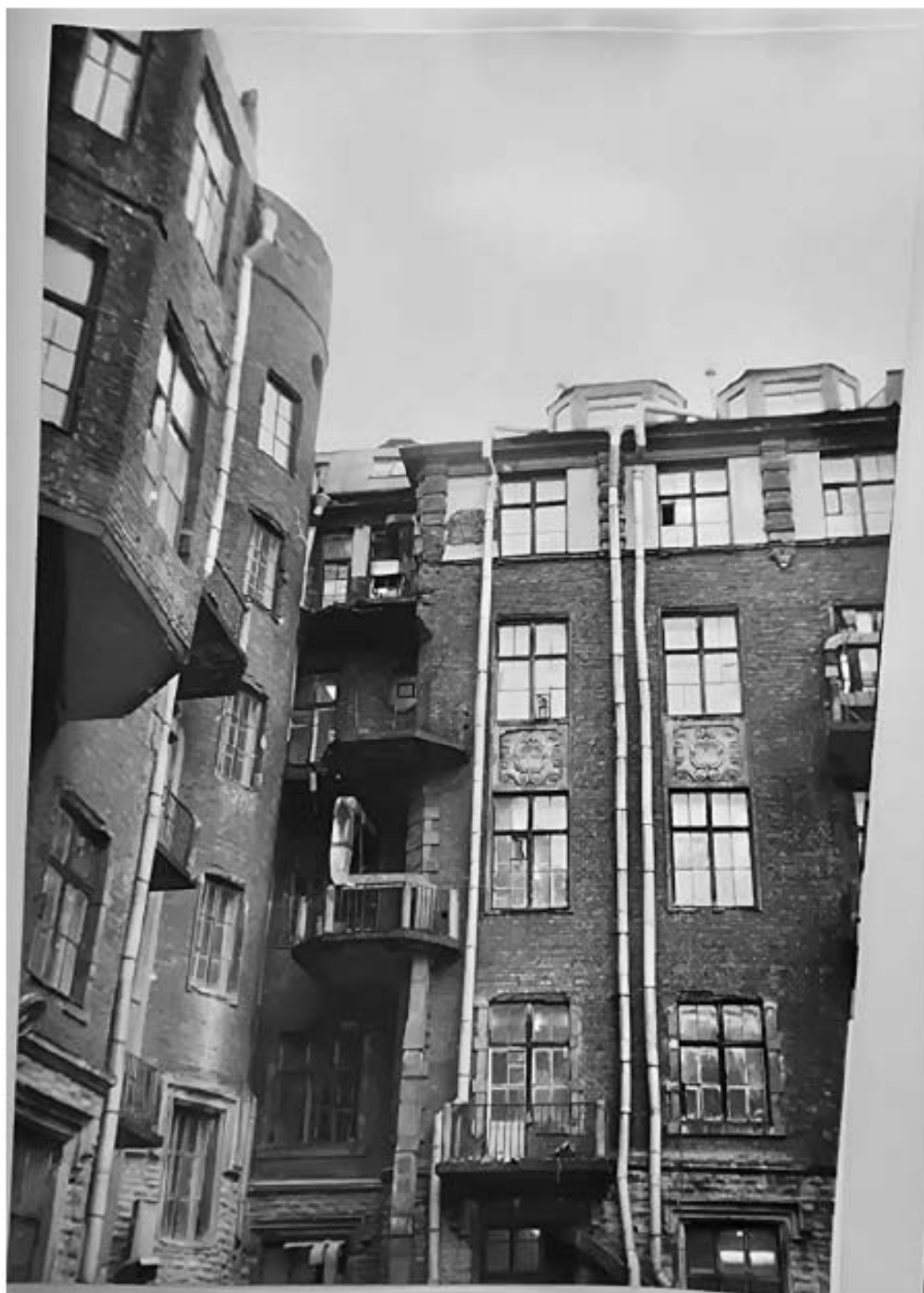
Илл. 142. Фрагмент дворового западного фасада с балконами. Лит. Б, В. 1991 г. Архив КГИОП. П. 1560. Пр-5. Научно-проектная документация. Раздел 2. Фотофиксация. Фасады дворовых флигелей, ограда и калитки.
