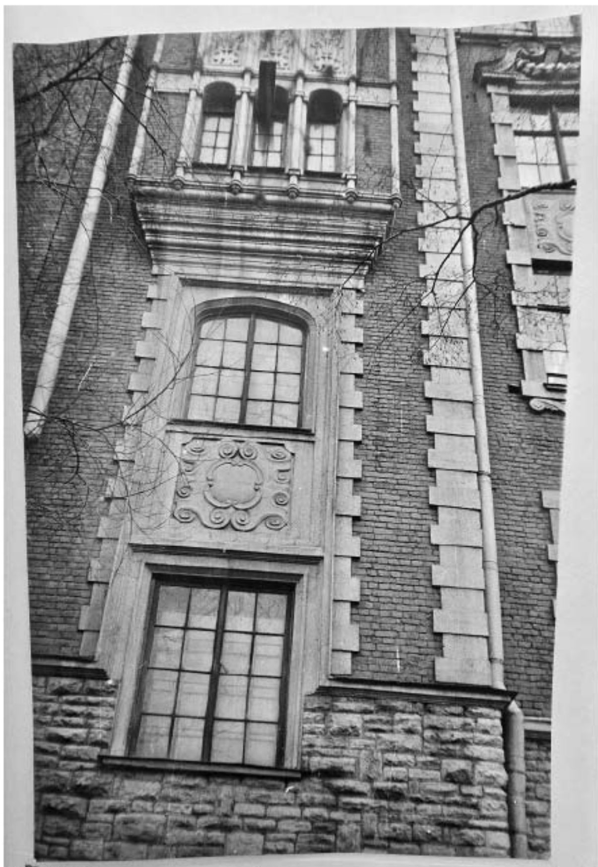
Илл. 122. Фрагмент восточного фасада у линии примыкания к соседу. Лит. В. 1991 г.
