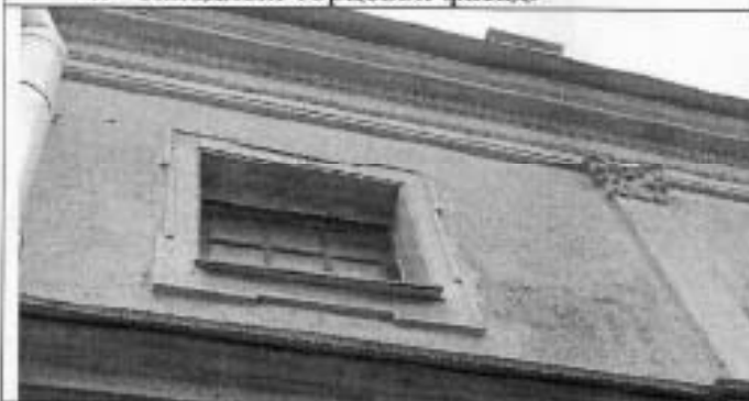
6. Северный лицевой фасад.
