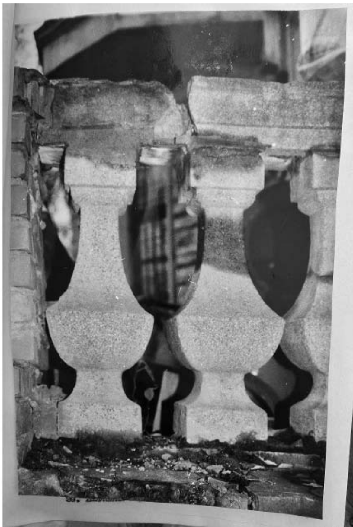
Илл. 129. Балясины ограждения террасы восточного фасада. Лит. В. 1991 г. Архив КГИОП. П. 1560. Пр-4. Научно-проектная документация. Раздел 2. Фотофиксация.
