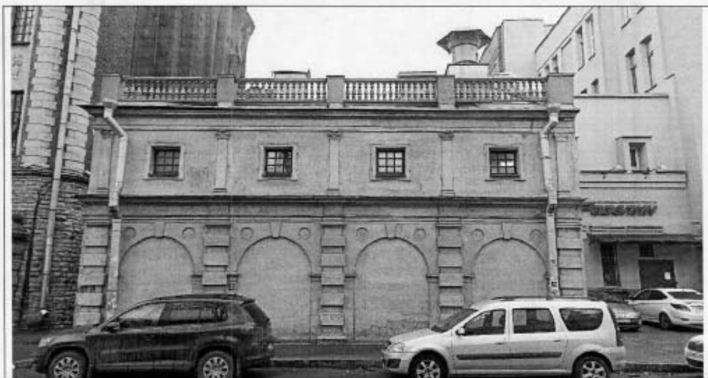
1. Северный лицевой фасад.
