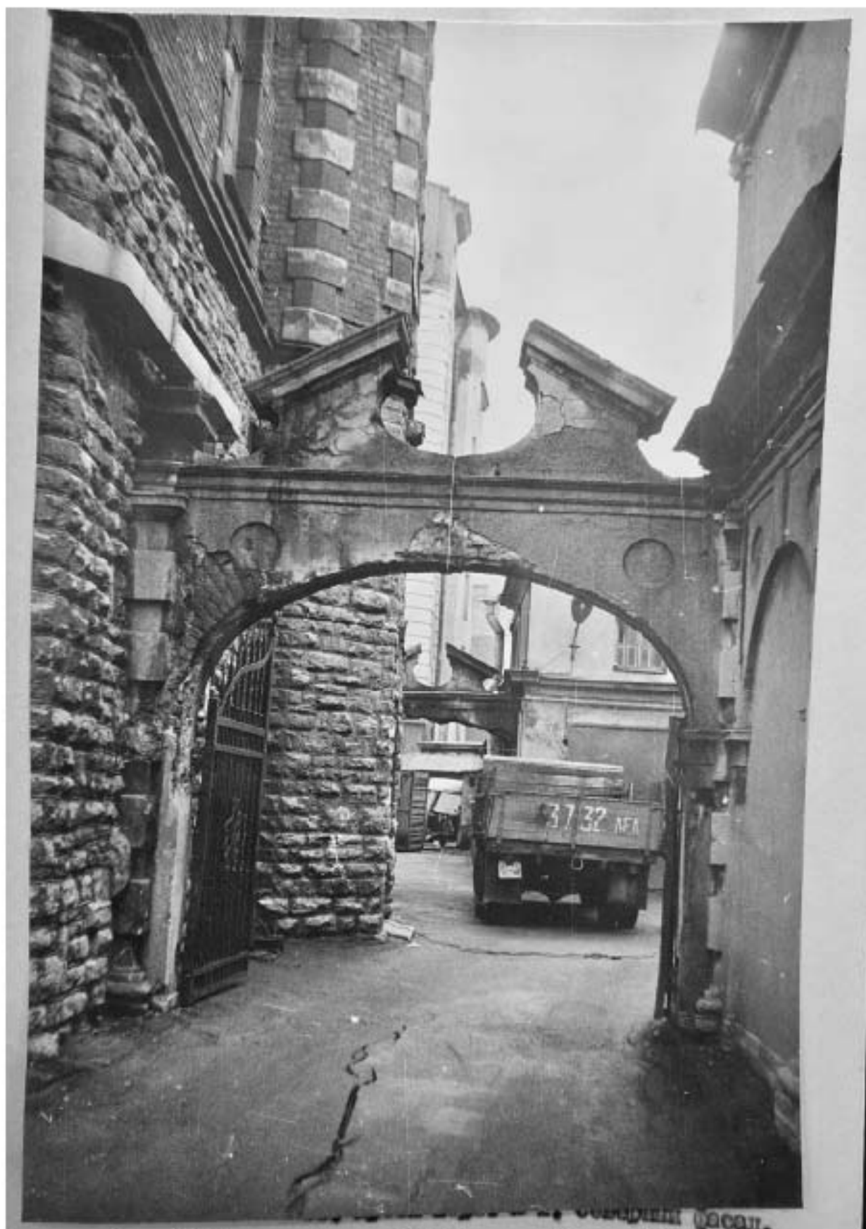
Илл. 76. Воротный проем №2. Северный фасад. 1991 г. Архив КГИОП. П. 1560. Пр-3. Научно-проектная документация. Раздел 2. Фотофиксация.
