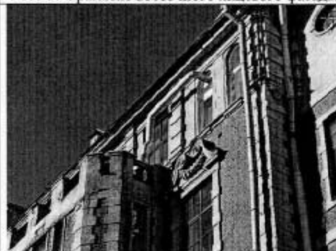
Фото 5. Фрагмент восточного лицевого фасада.
