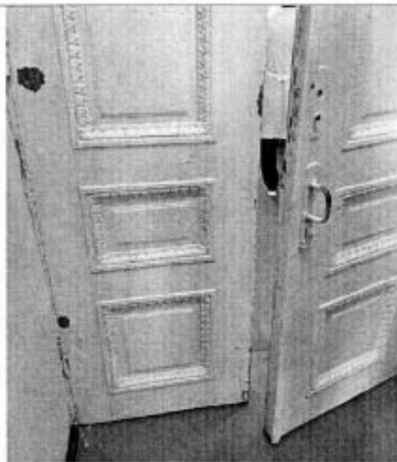
Фото 76. Фрагмент дверного заполнения.
