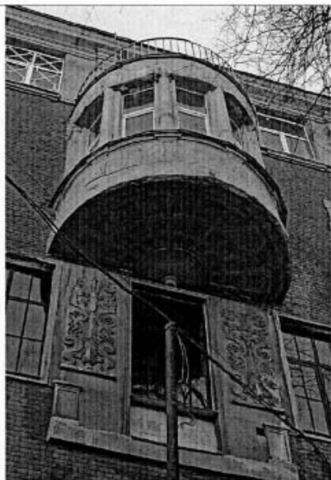
Фото 7. Фрагмент северного лицевого фасада.
