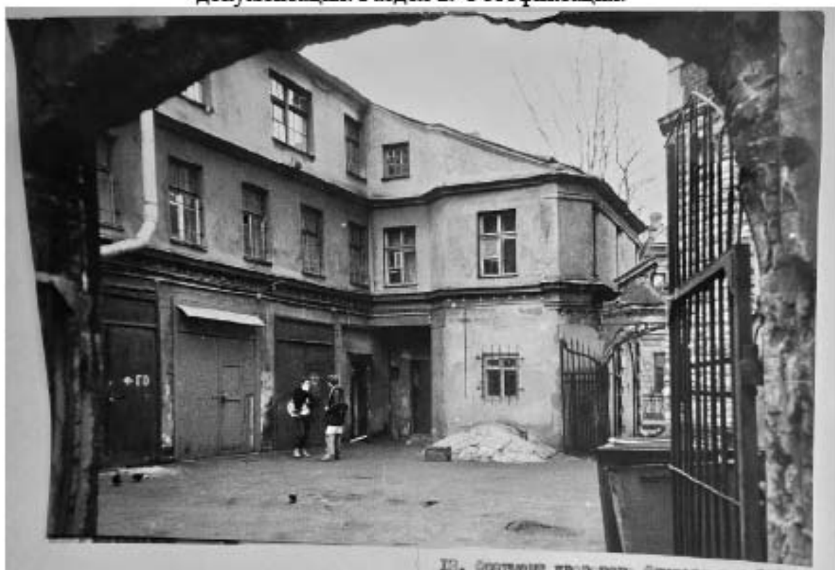
Илл. 73. Фрагмент дворового флигеля лит. Б с воротами №2. Южный и восточный фасады. 1991 г. Архив КГИОП. П. 1560. Пр-3. Научно-проектная документация. Раздел 2. Фотофиксация.
