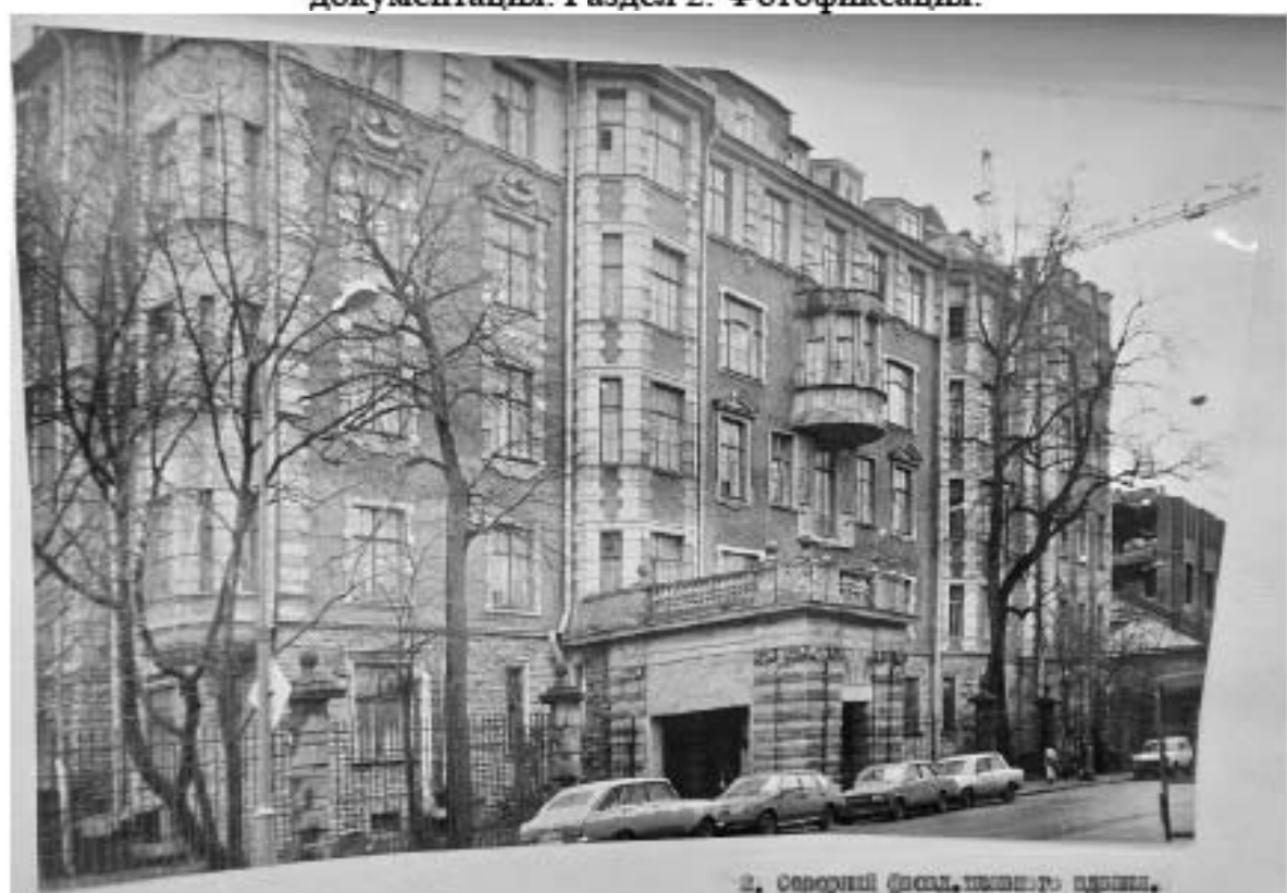
Илл. 92. Северный фасад главного здания. Лит. В. 1991 г. Архив КГИОП. П. 1560. Пр-4. Научно-проектная документация. Раздел 2. Фотофиксация.
