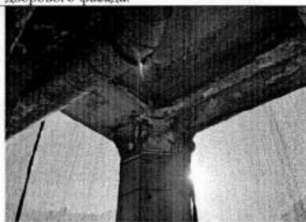
Фото 23. Фрагмент лоджии южного дворового фасада.
