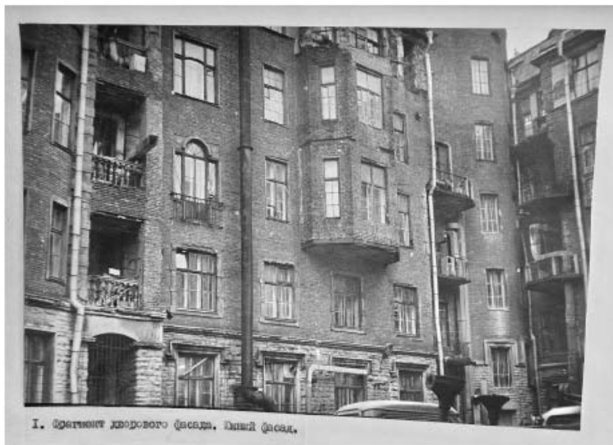
Илл. 130. Фрагмент дворового фасада. Южный фасад. Лит. Б, В. 1991 г. Архив КГИОП. П. 1560. Пр-5. Научно-проектная документация. Раздел 2. Фотофиксация. Фасады дворовых флигелей, ограда и калитки.
