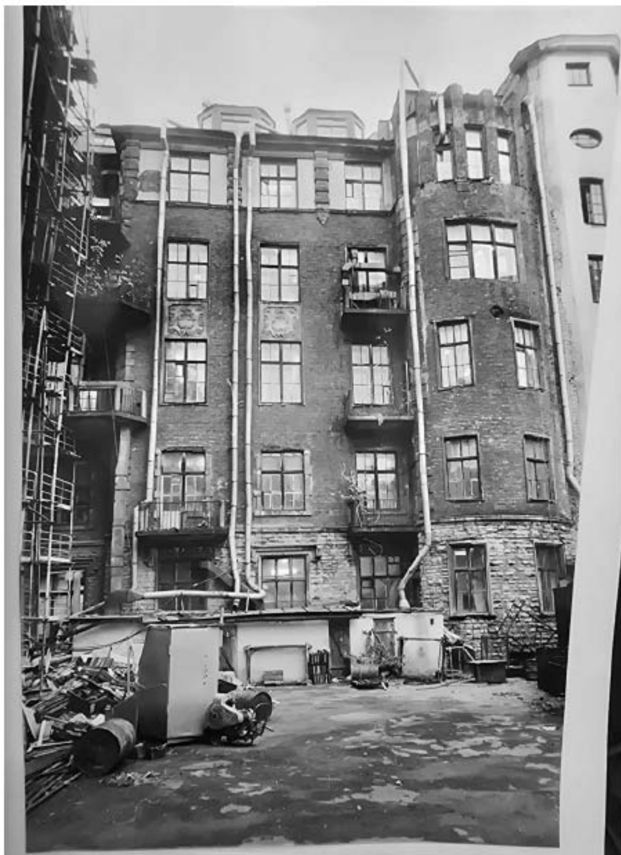
Илл. 141. Западный дворовой фасад. Примыкание к соседнему зданию.
