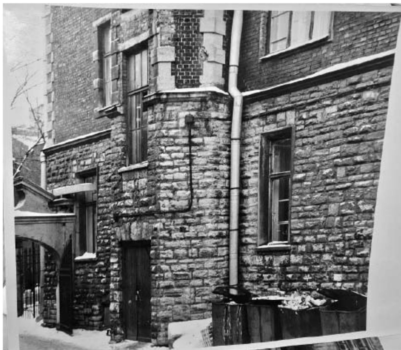
Илл. 59. Вид на фрагмент дворового фасада. 1988 г. Архив КГИОП. П. 1560. Фотоматериалы.
