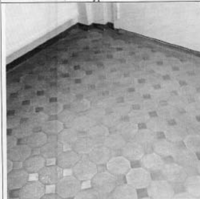
25. Площадка в уровне 2 этажа.
