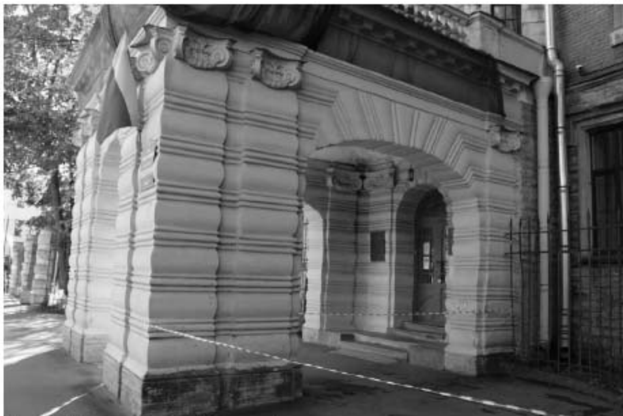
Фото 26. Вид на лицевой фасад объекта культурного наследия регионального значения «Лицевой корпус Литера В» со стороны улицы Профессора Попова.
