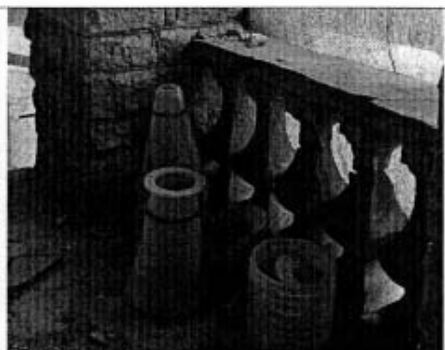
Фото 21. Фрагмент лоджии южного дворового фасада.
