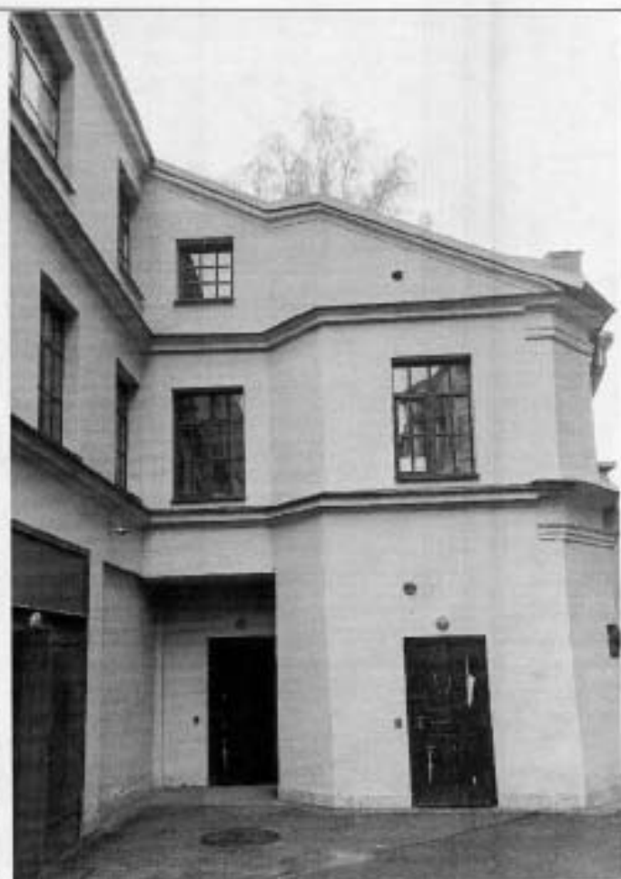
9. Южный дворовый фасад.
