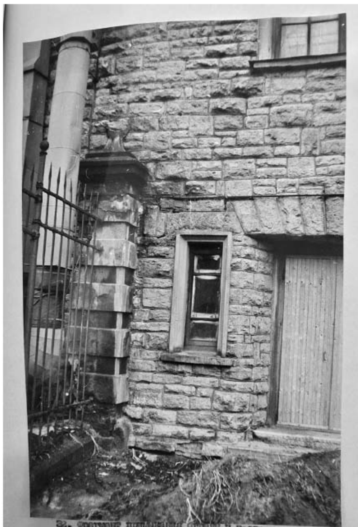
Илл. 90. Фрагмент примыкания ограды к восточному фасаду главного входа. 1991 г.
