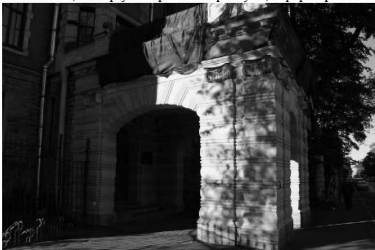
Фото 24. Вид на лицевой фасад объекта культурного наследия регионального значения «Лицевой корпус Литера В» со стороны улицы Профессора Попова.
