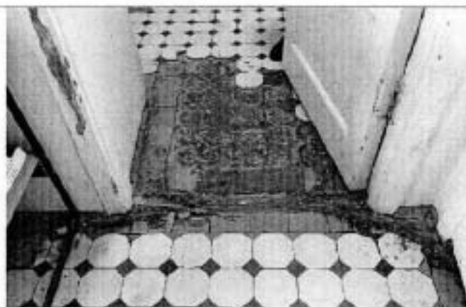
Фото 60. Помещение в уровне 5 этажа.
