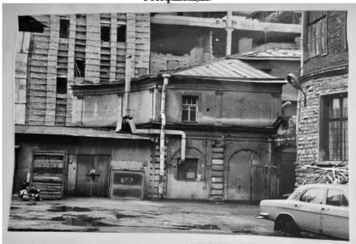
Илл. 69. Восточный фасад флигеля лит. Б. 1991 г. Архив КГИОП. П. 1560. Пр-3. Научно-проектная документация. Раздел 2. Фотофиксация.
