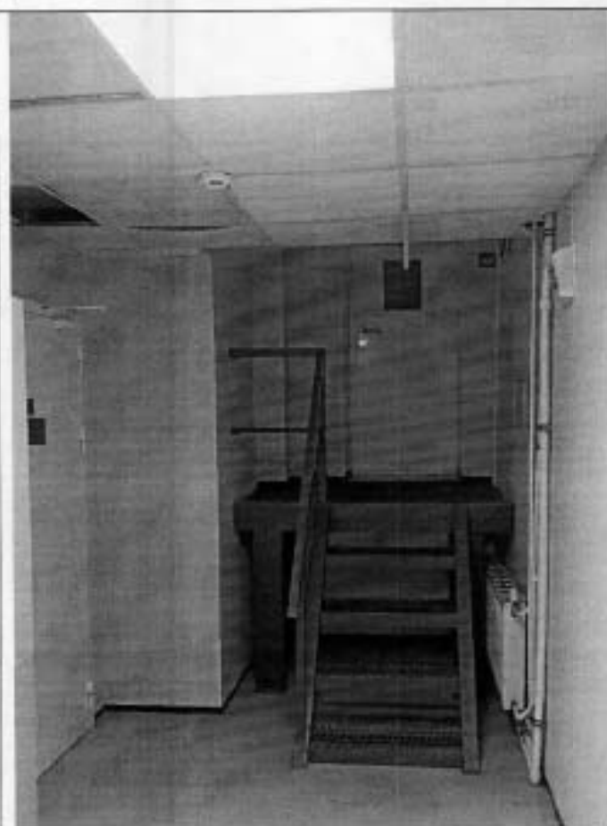
23. Помещение в уровне 1 этажа.
