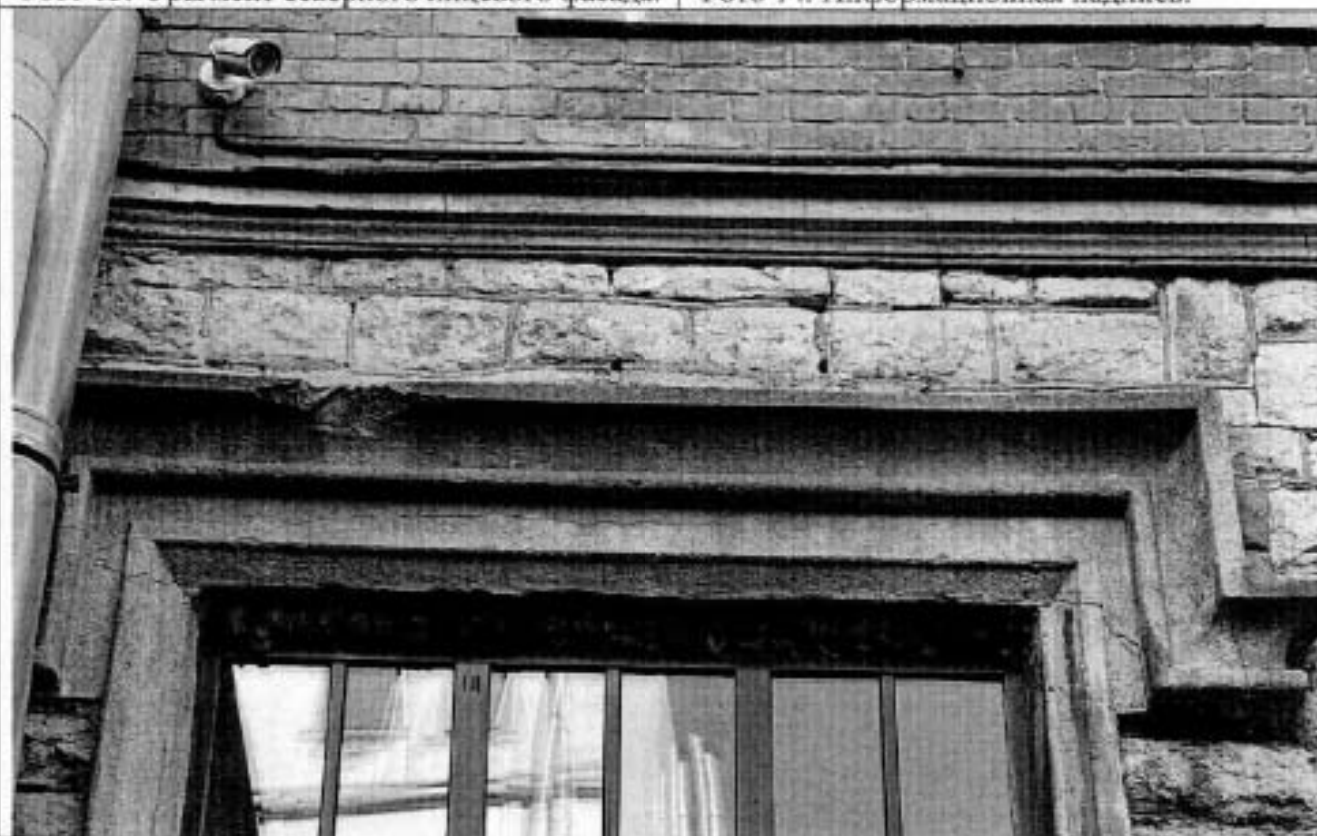
Фото 15. Фрагмент северного лицевого фасада.
