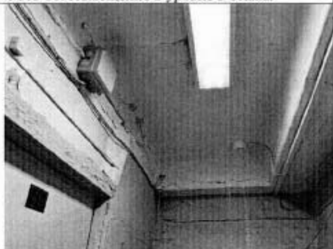
Фото 62. Помещение в уровне 5 этажа.
