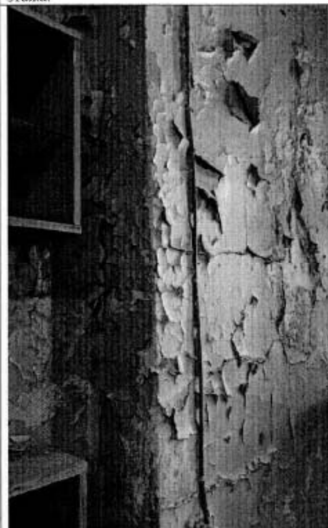
Фото 67. Фрагмент помещения в уровне 5 этажа.
