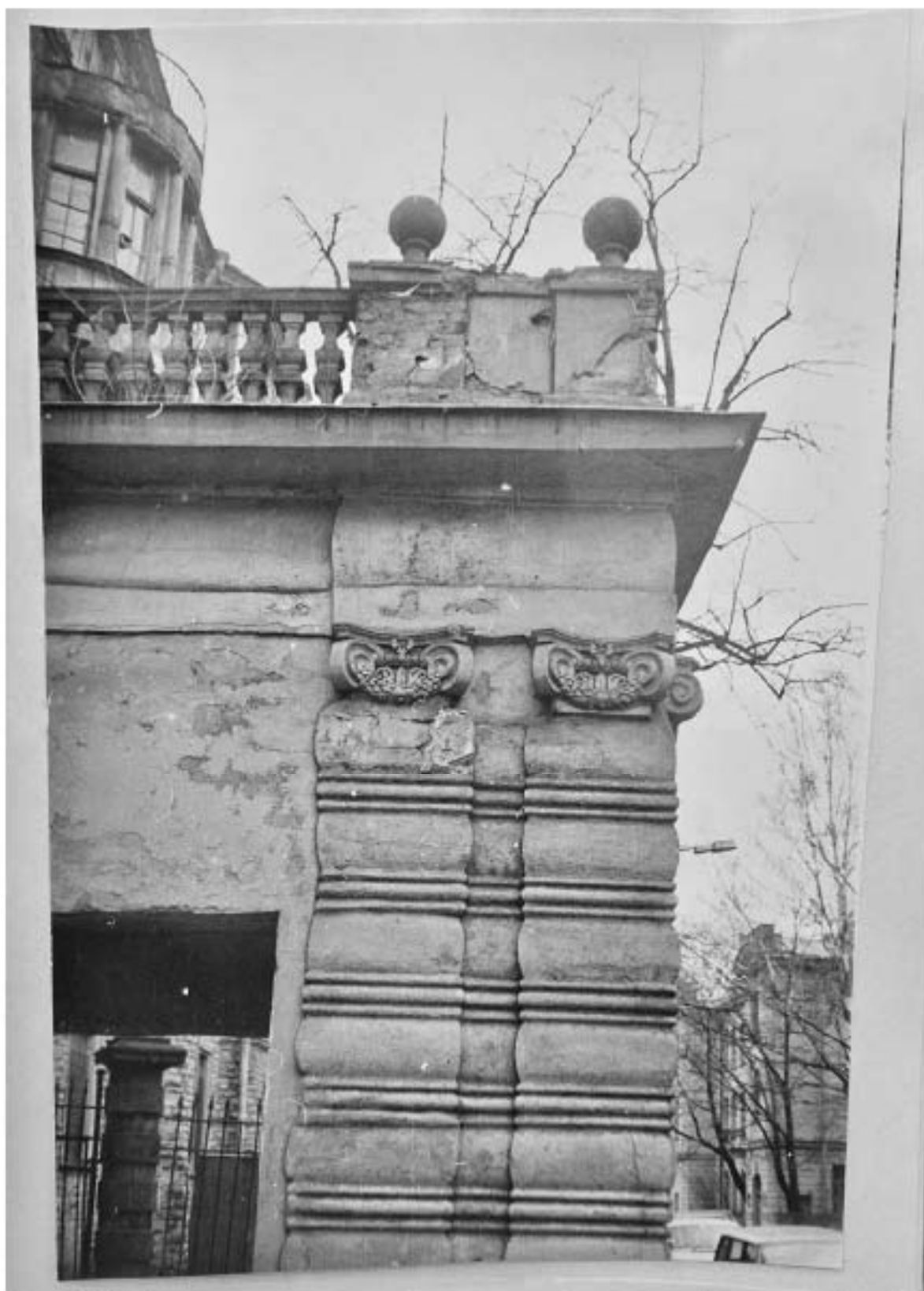
Илл. 100. Фрагмент восточного фасада главного входа с балконом. Лит. В. 1991 г. Архив КГИОП. П. 1560. Пр-4. Научно-проектная документация. Раздел 2. Фотофиксация.
