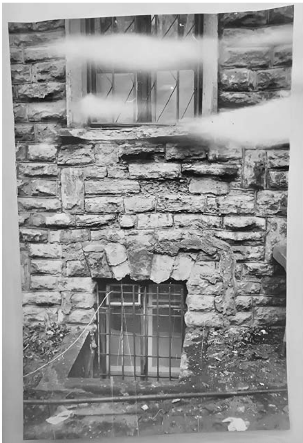
Илл. 116. Фрагмент северного фасада с подвальным окном. Лит. В. 1991 г. Архив КГИОП. П. 1560. Пр-4. Научно-проектная документация. Раздел 2. Фотофиксация.
