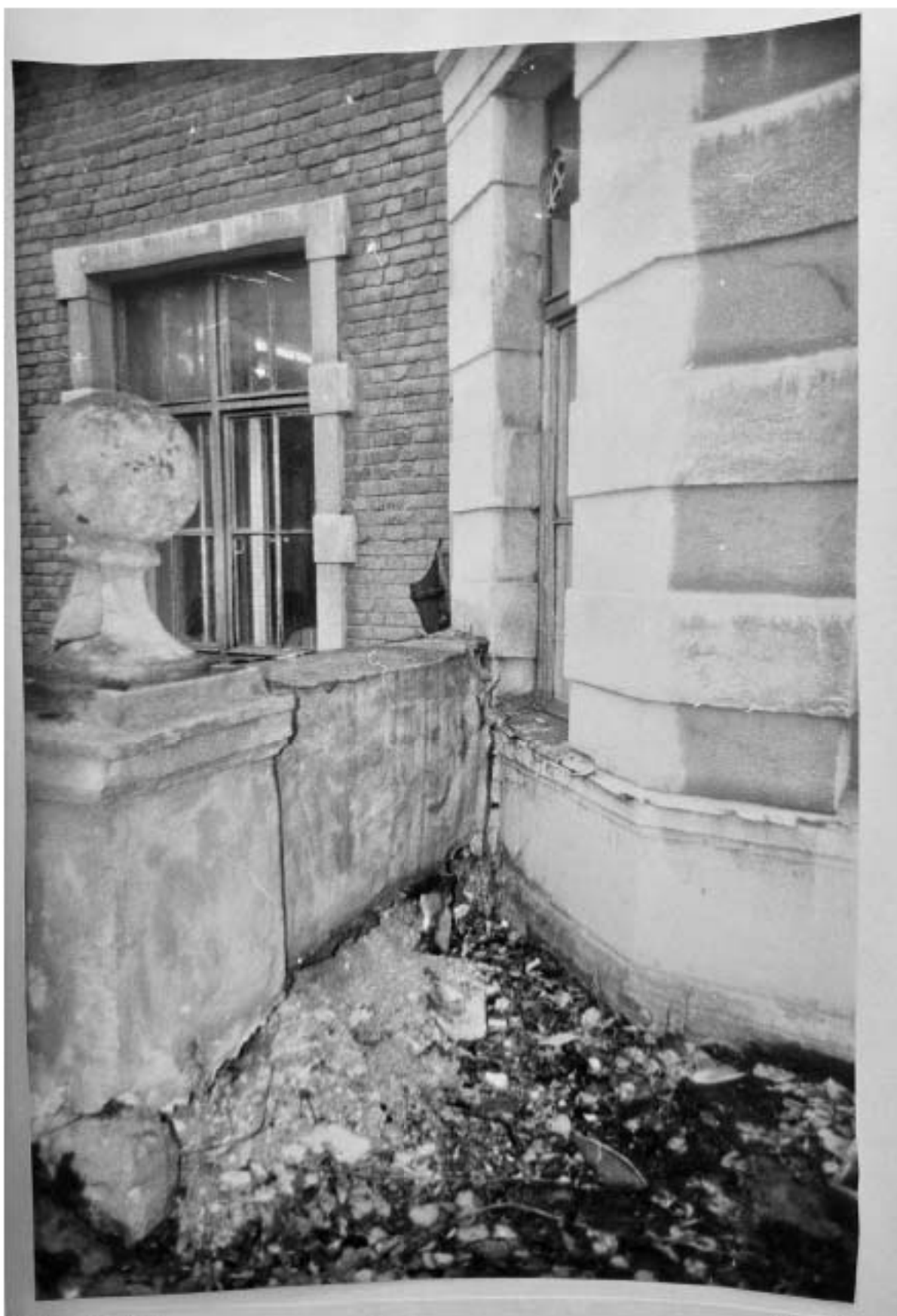
Илл. 105. Левое примыкание балкона главного входа к зданию. Лит. В. 1991 г. Архив КГИОП. П. 1560. Пр-4. Научно-проектная документация. Раздел 2. Фотофиксация.
