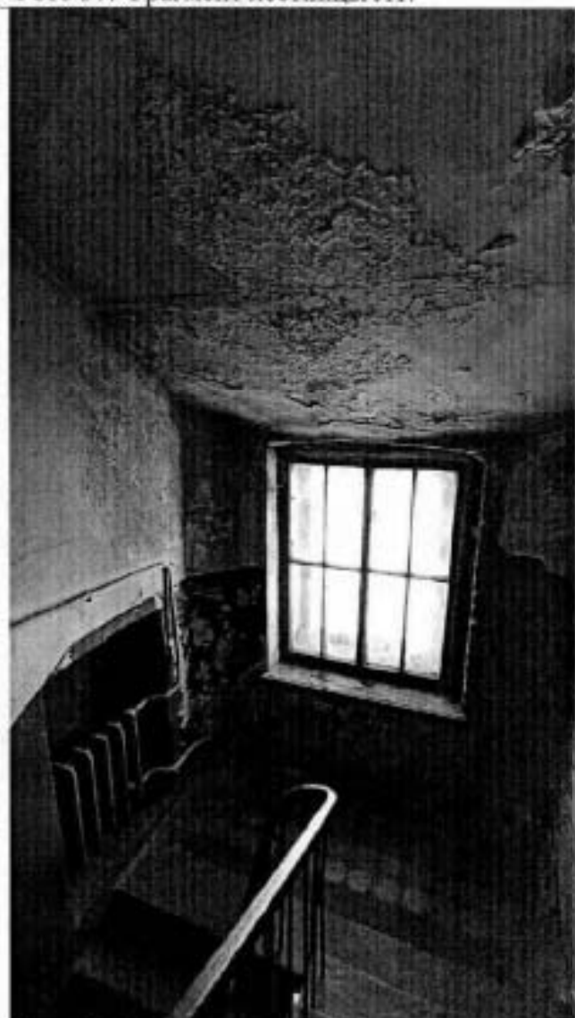
Фото 39. Помещение лестничной клетки лестницы Л3.
