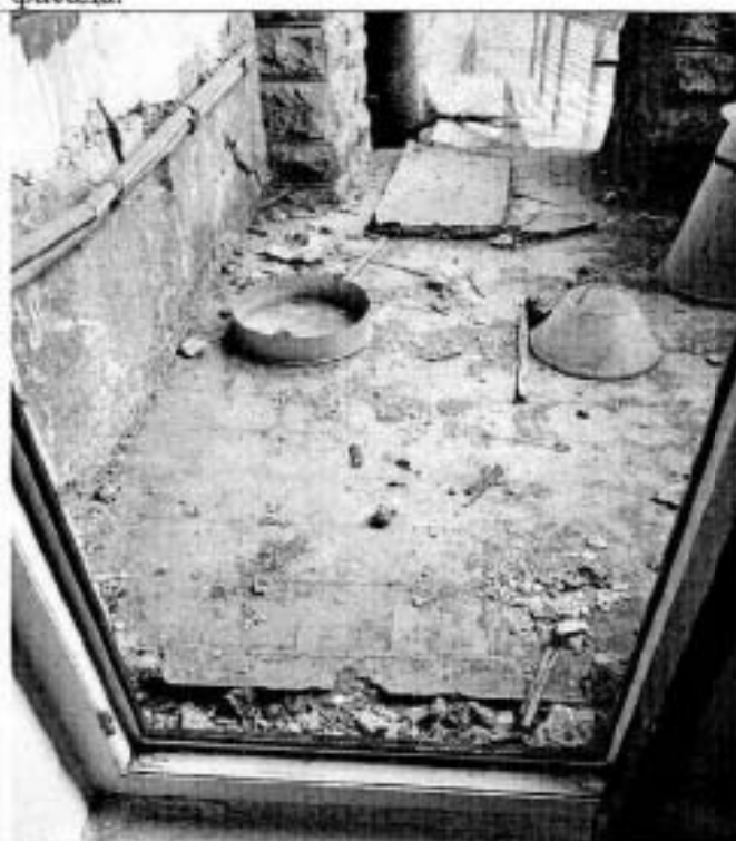
Фото 24. Фрагмент балкона южного дворового фасада.
