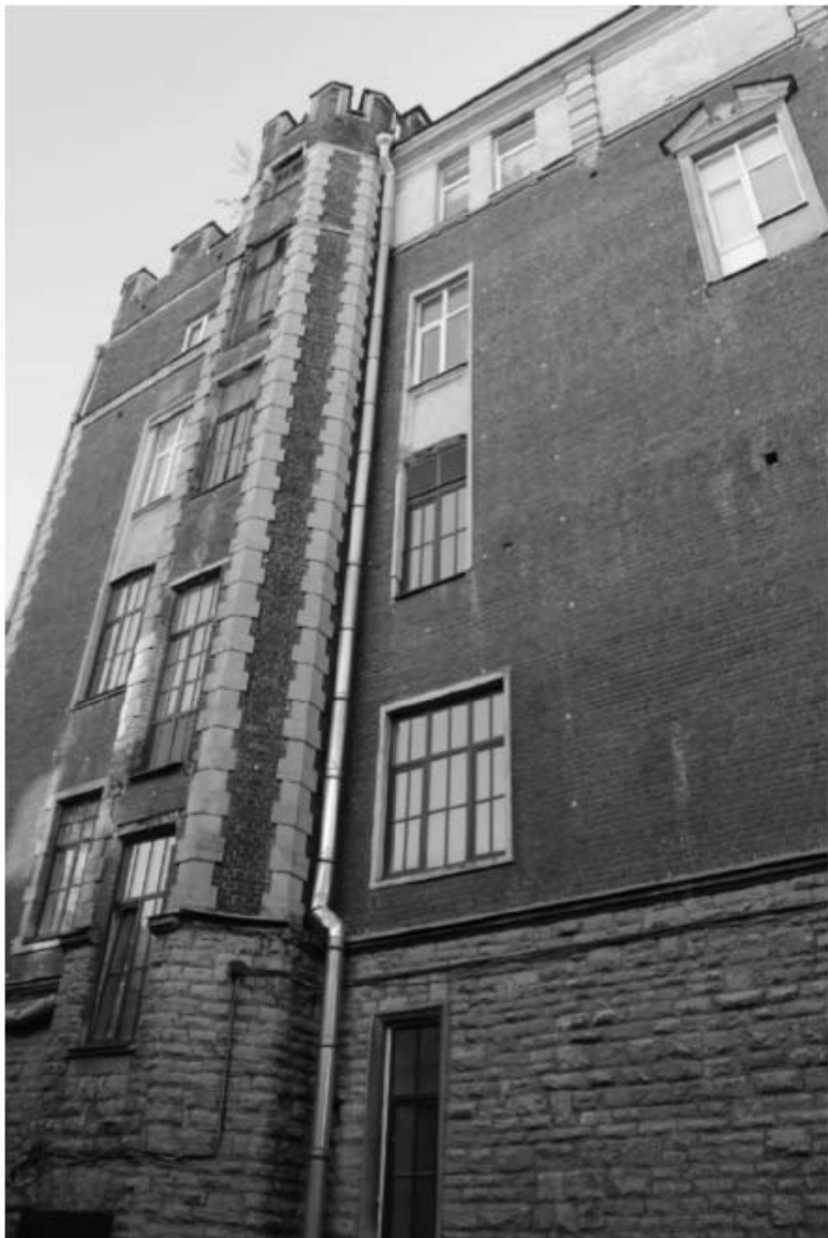
Фото 28. Вид на торцевой фасад объекта культурного наследия регионального значения «Лицевой корпус Литера В» со стороны улицы Профессора Попова.
