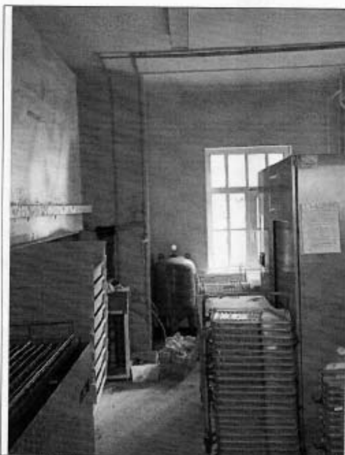
27. Помещение в уровне 2 этажа.
