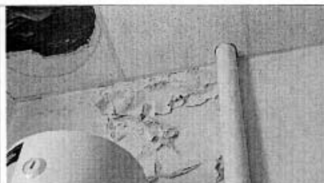
Фото 65. Фрагмент помещения в уровне 5 этажа.
