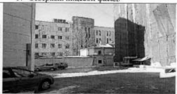
7. Восточный дворовый фасад.
