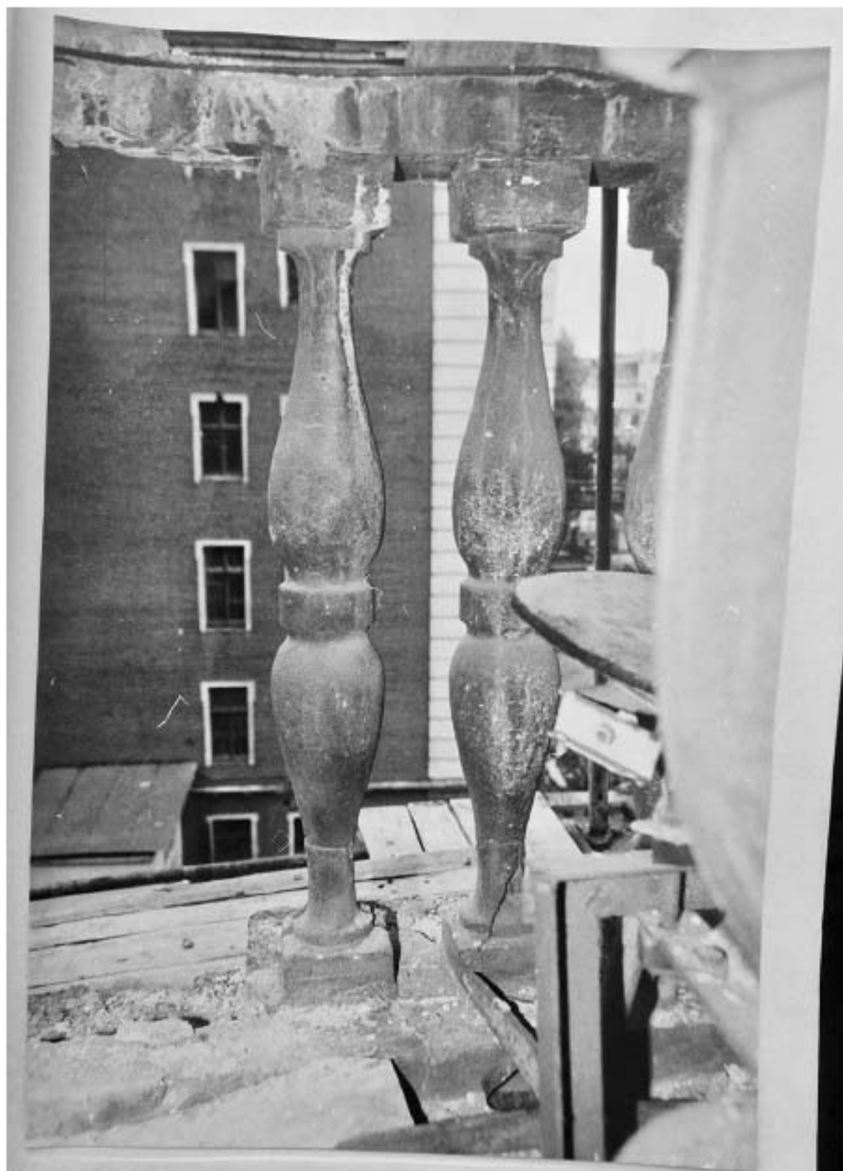
Илл. 135. Балясины ограждения балкона 2-го и 3-го этажей южного фасада. Лит. Б, В. 1991 г. Архив КГИОП. П. 1560. Пр-5. Научно-проектная документация. Раздел 2. Фотофиксация. Фасады дворовых флигелей, ограда и калитки.
