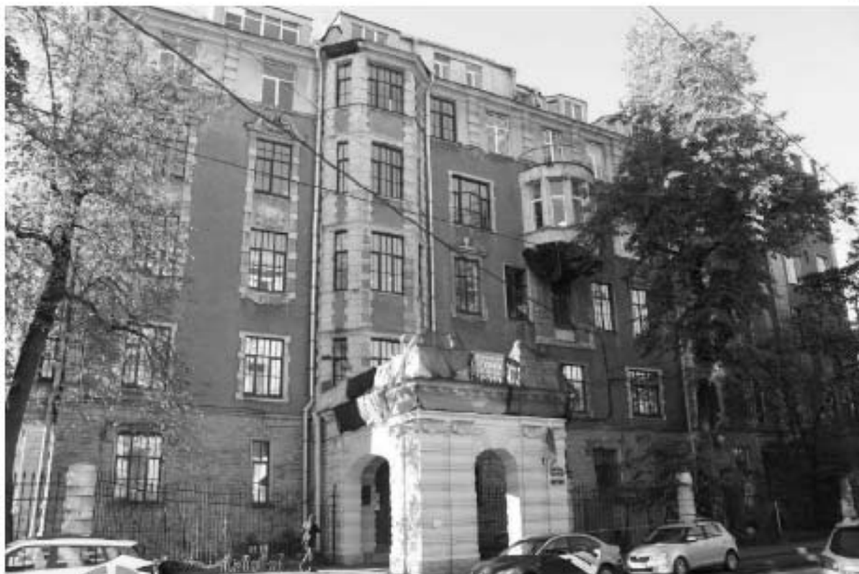
Фото 23. Вид на лицевой фасад объекта культурного наследия регионального значения «Лицевой корпус Литера В» со стороны улицы Профессора Попова.
