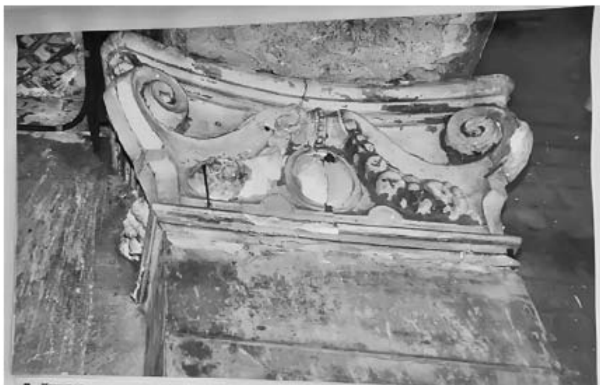
Илл. 136. Капитель пилястры на балконе 3-го этажа южного фасада. Лит. Б, В. 1991 г. Архив КГИОП. П. 1560. Пр-5. Научно-проектная документация. Раздел 2. Фотофиксация. Фасады дворовых флигелей, ограда и калитки.
