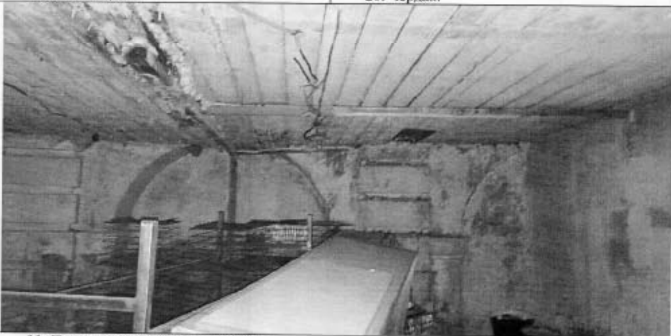
22. Помещение в уровне 1-го этажа
