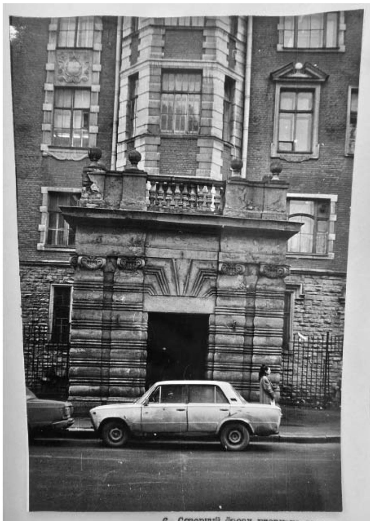
Илл. 96. Северный фасад главного входа. Лит. В. 1991 г. Архив КГИОП. П. 1560. Пр-4. Научно-проектная документация. Раздел 2. Фотофиксация.
