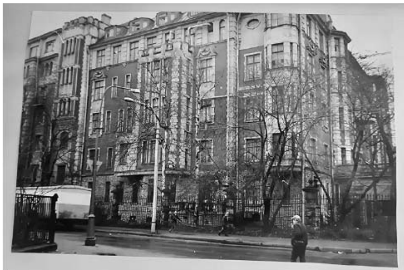
Илл. 118. Восточный фасада главного здания. Лит. В. 1991 г. Архив КГИОП. П. 1560. Пр-4. Научно-проектная документация. Раздел 2. Фотофиксация.
