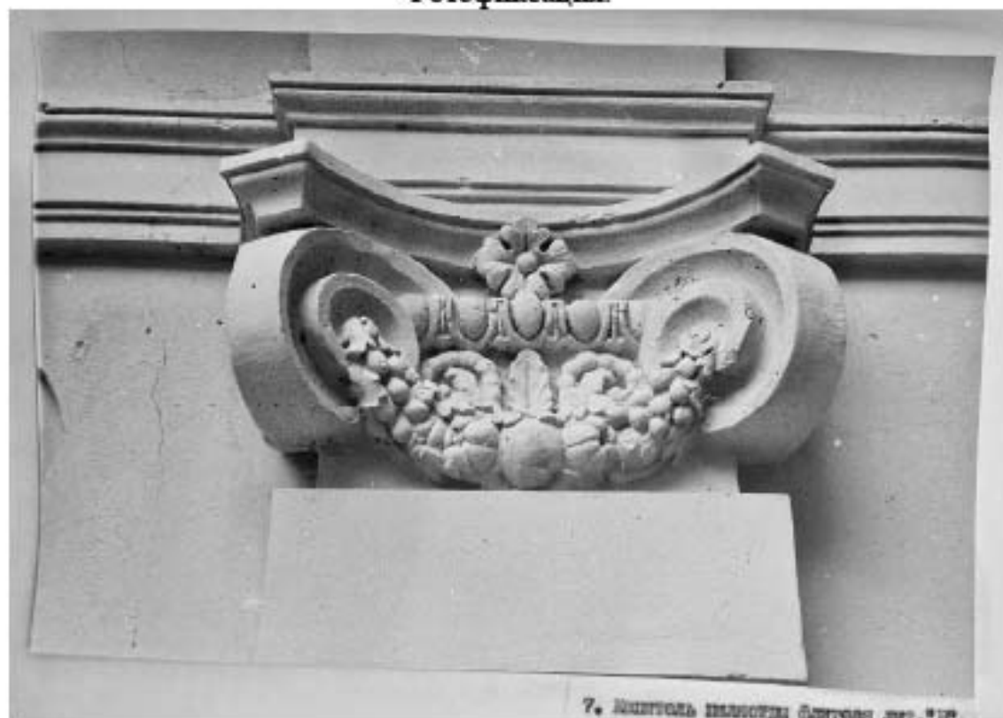
Илл. 67. Капитель пилястры флигеля лит. Б. 1991 г. Архив КГИОП. П. 1560. Пр-3. Научно-проектная документация. Раздел 2. Фотофиксация.
