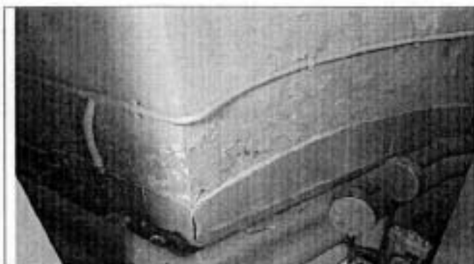
Фото 41. Фрагмент помещения в уровне подвального этажа.
