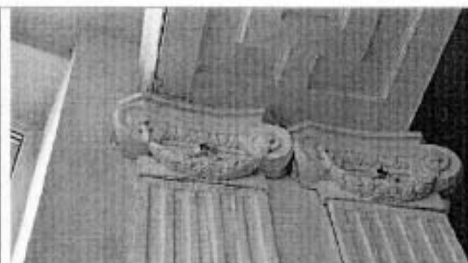
Фото 54. Фрагмент помещения в уровне 2 этажа.
