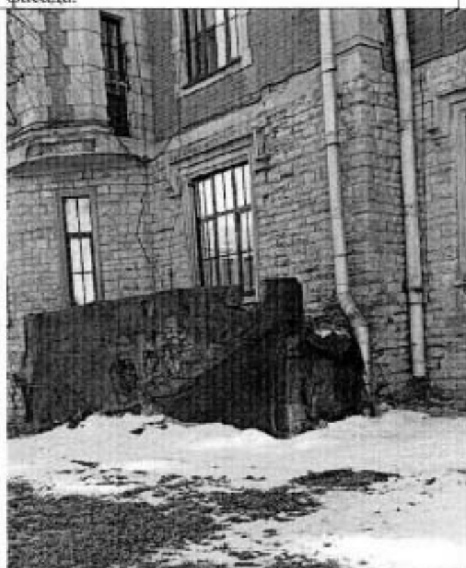
Фото 10. Фрагмент восточного лицевого фасада.
