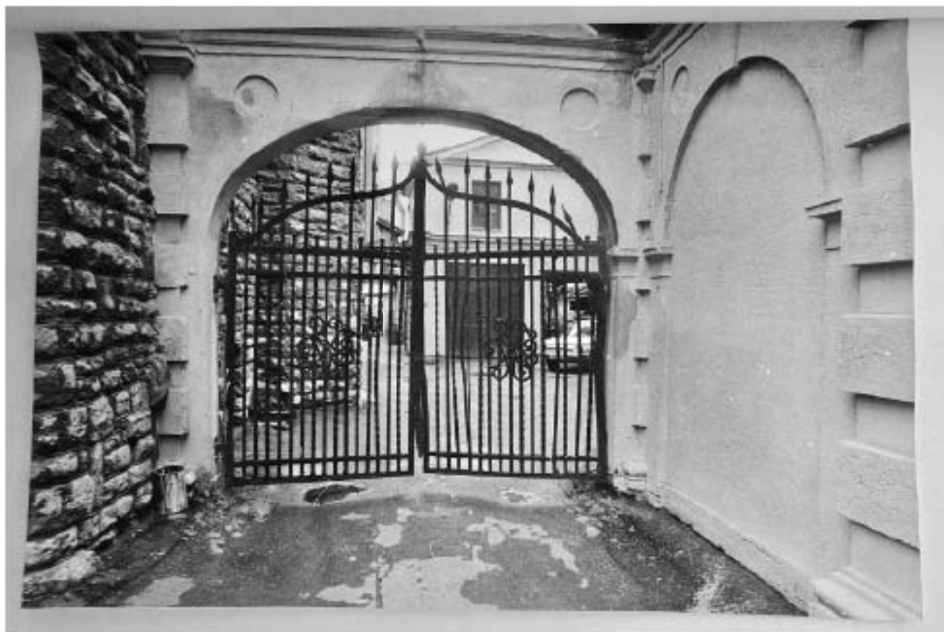
Илл. 77. Воротный проем №1. Северный фасад. 1991 г. Архив КГИОП. П. 1560. Пр-3. Научно-проектная документация. Раздел 2. Фотофиксация.
