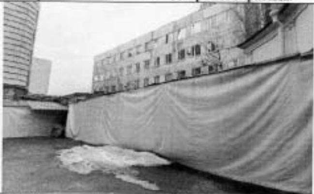
14. Восточный дворовый фасад.
