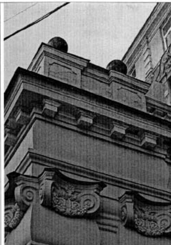
Фото 16. Фрагмент портика северного лицевого фасада.
