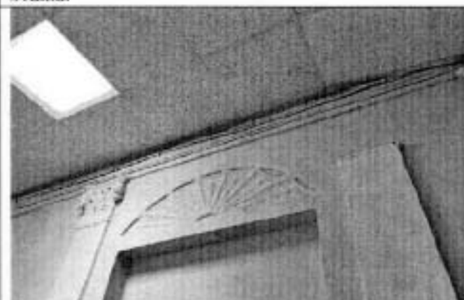
Фото 56. Фрагмент помещения в уровне 4 этажа.
