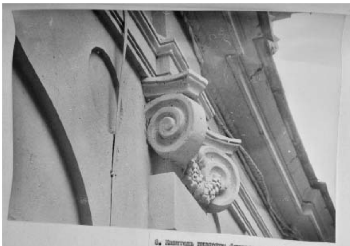
Илл. 68. Капиталь пилястры флигеля лит. Б. Вид сбоку. 1991 г. Архив КГИОП. П. 1560. Пр-3. Научно-проектная документация. Раздел 2. Фотофиксация.
