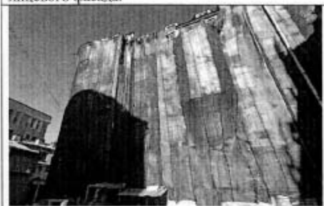
Фото 18. Южный дворовой фасад.
