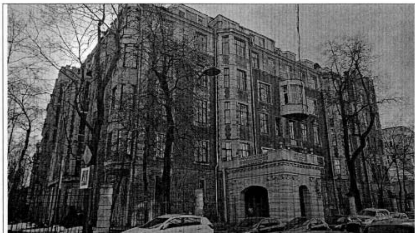
Фото 1. Северный лицевой фасад.
