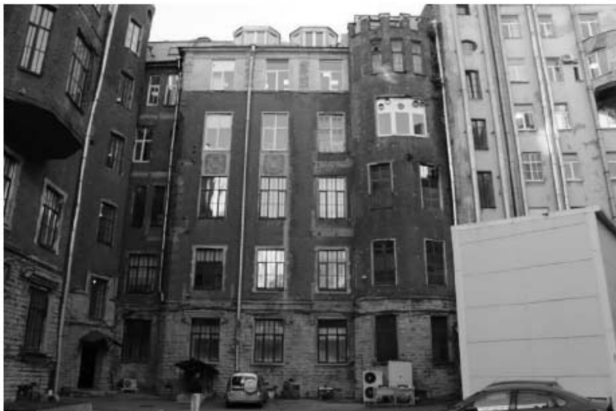
Фото 31. Вид на дворовый фасад объекта культурного наследия регионального значения «Лицевой корпус Литера В» со стороны Аптекарского проспекта.
