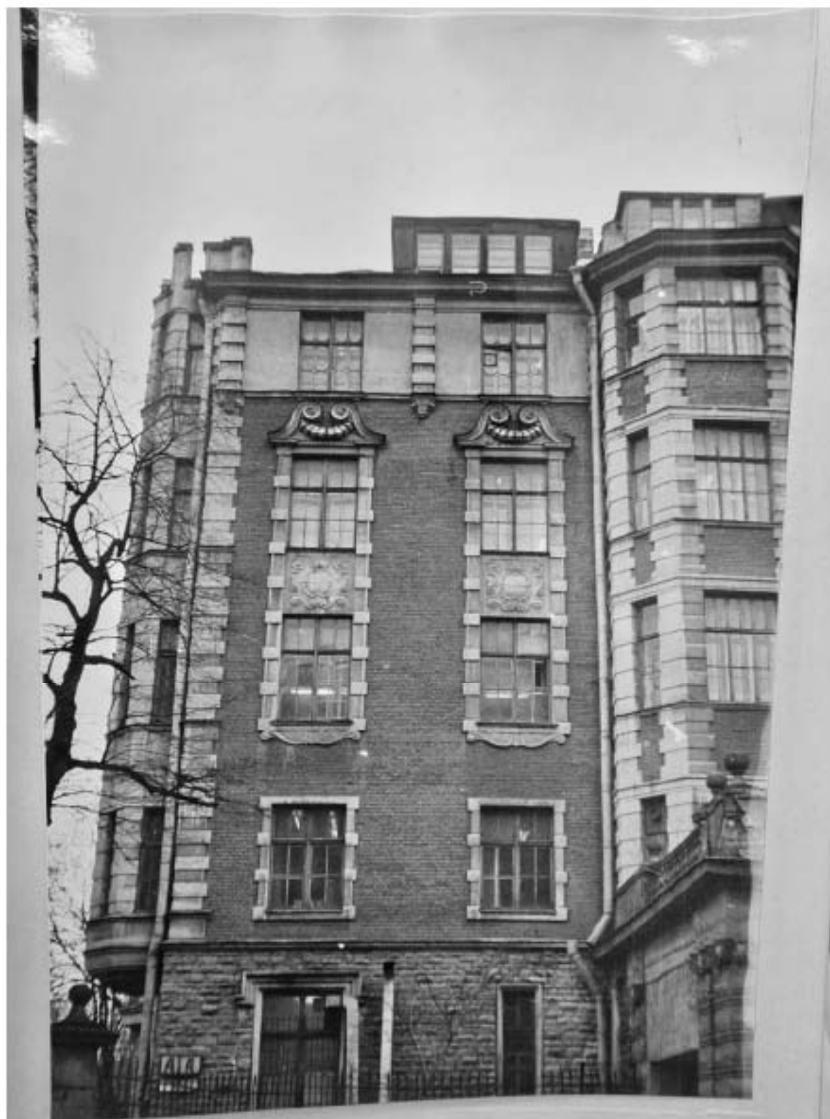
Илл. 101. Угловой (к Аптекарскому пр.) фрагмент северного фасада главного здания. Лит. В. 1991 г. Архив КГИОП. П. 1560. Пр-4. Научно-проектная документация. Раздел 2. Фотофиксация.
