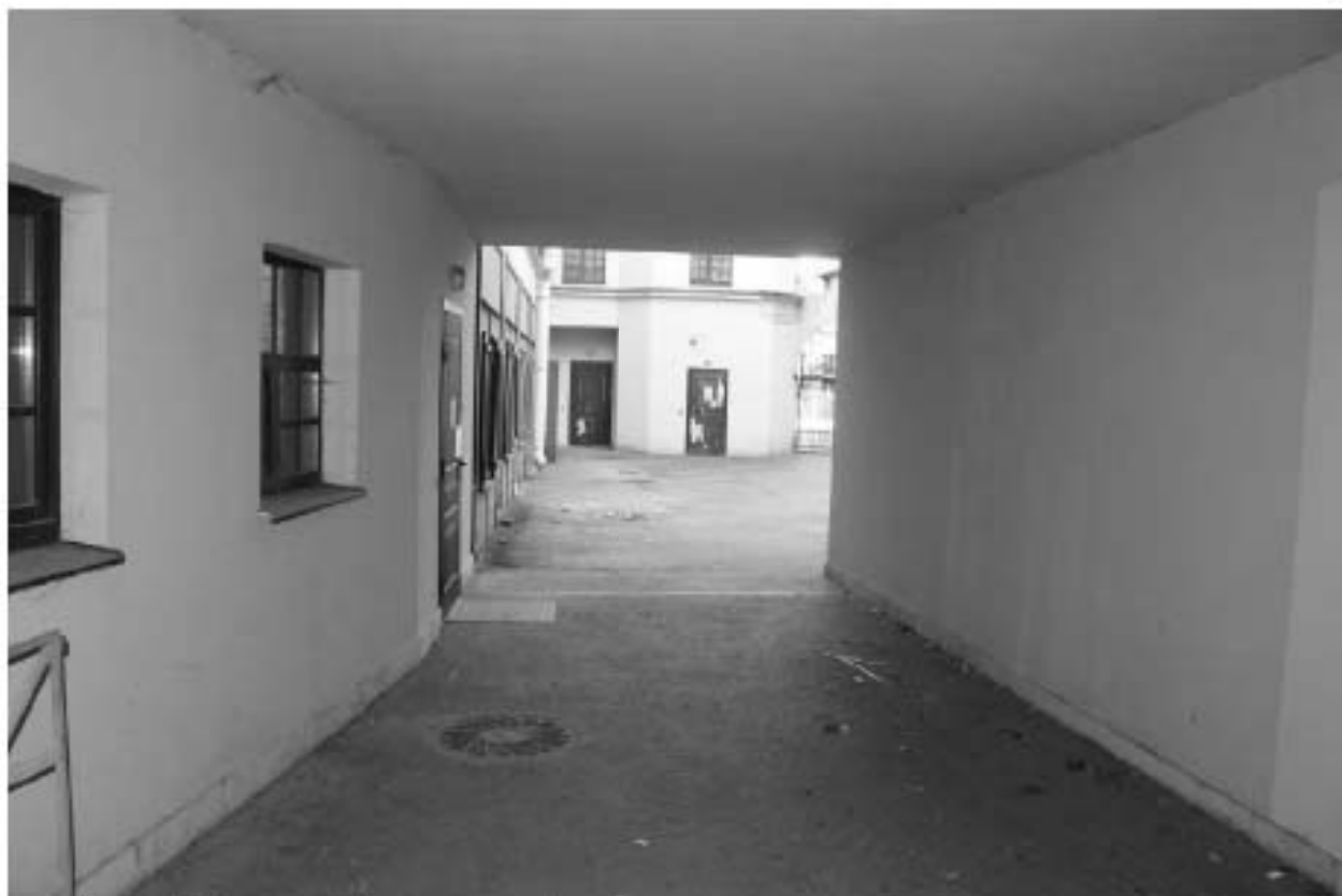
Фото 7. Воротный проезд объекта культурного наследия регионального значения «Служебный корпус Литера Б с двумя соединительными арками».
