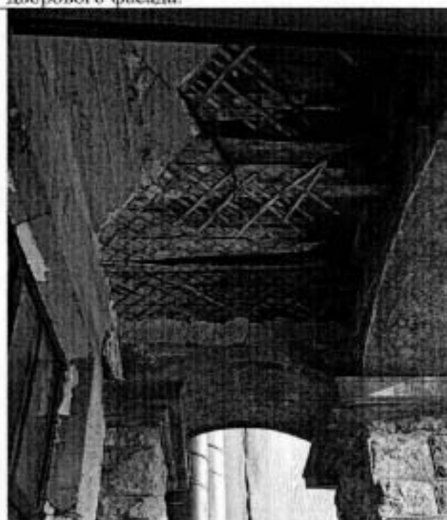
Фото 25. Фрагмент балкона южного дворового фасада.
