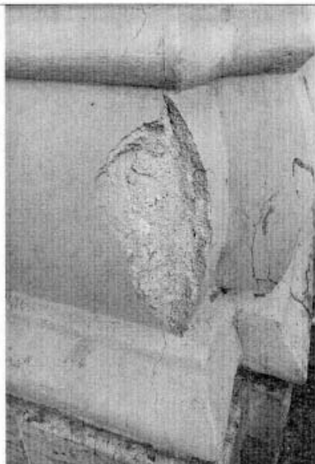
Фото 17. Фрагмент портика северного лицевого фасада.
