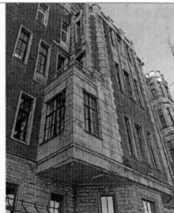
Фото 9. Фрагмент восточного лицевого фасада.
