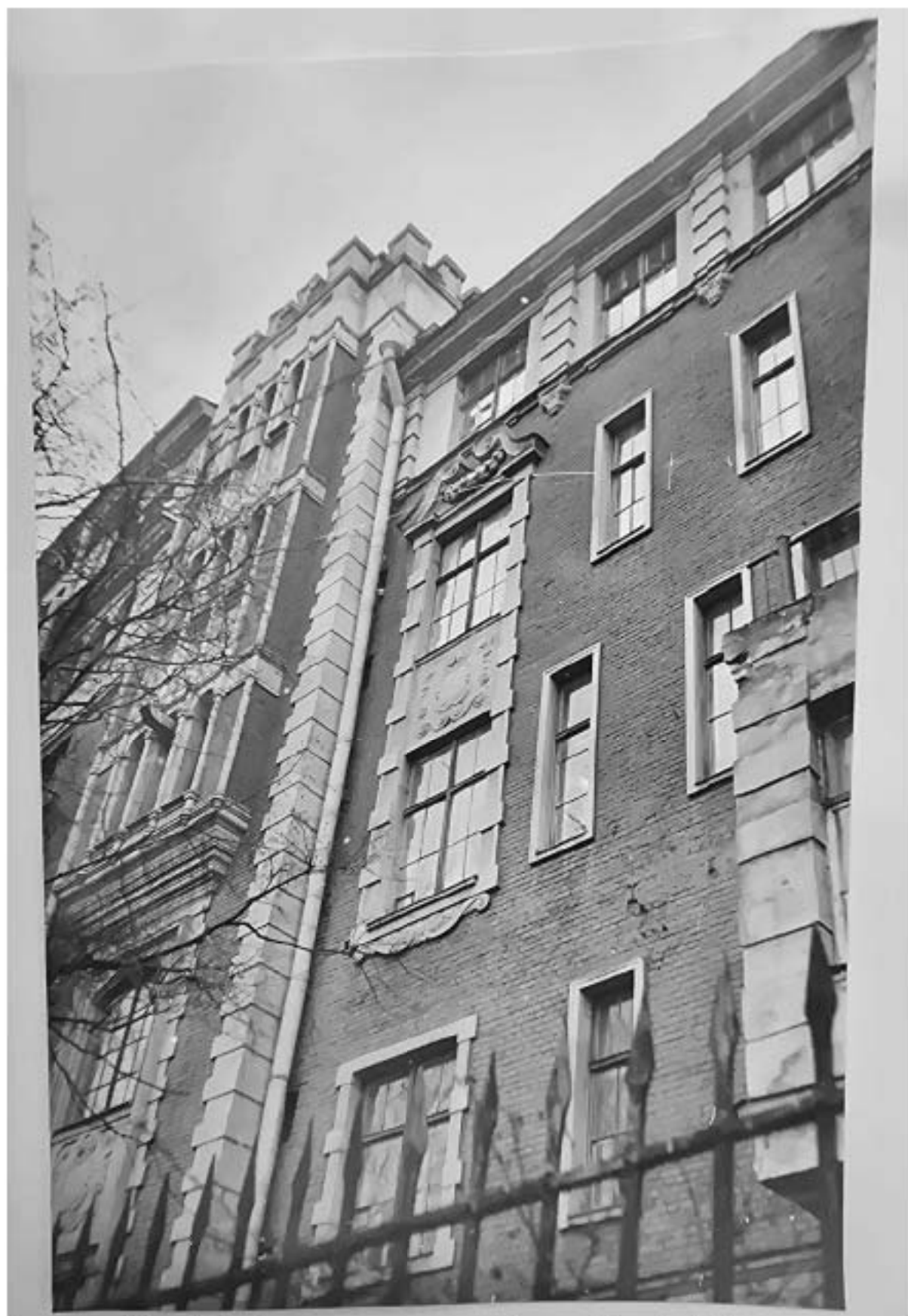
Илл. 120. Фрагмент восточного фасада. Лит. В. 1991 г. Архив КГИОП. П. 1560. Пр-4. Научно-проектная документация. Раздел 2. Фотофиксация.
