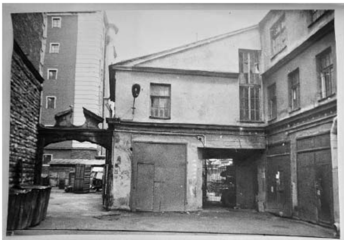
Илл. 72. Фрагмент дворового флигеля лит. Б с воротами №2. Северный фасад. 1991 г. Архив КГИОП. П. 1560. Пр-3. Научно-проектная документация. Раздел 2. Фотофиксация.
