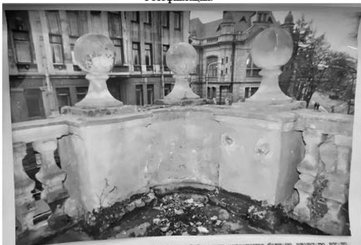
18. Угловой фрагмент ограждения балкона главного входа.
