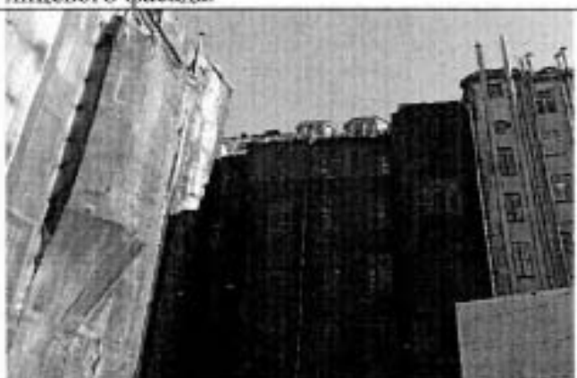
Фото 19. Западный дворовой фасад.
