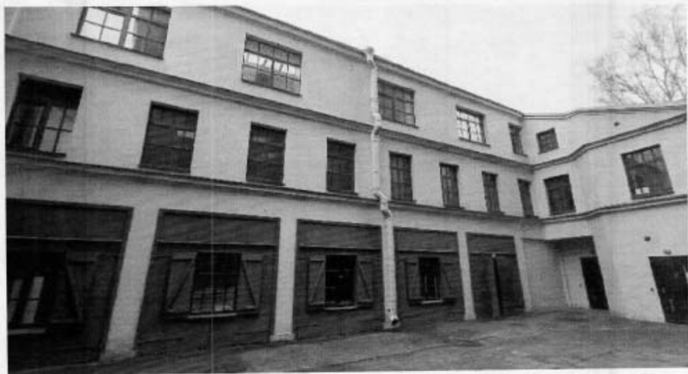
10. Восточный дворовый фасад.
