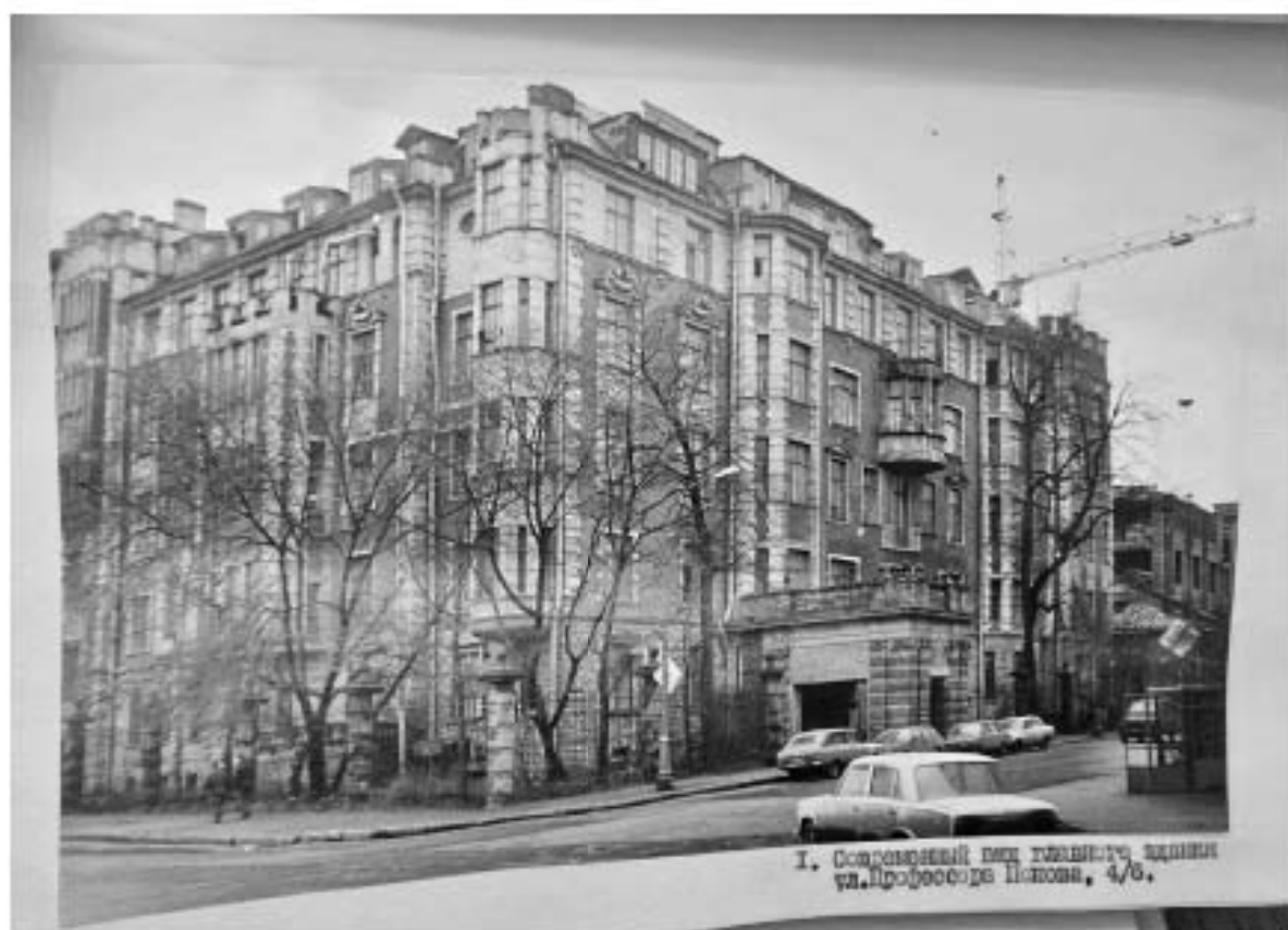
Илл. 91. Современный вид главного здания ул. Профессора Попова, 4/6. Лит. В. 1991 г. Архив КГИОП. П. 1560. Пр-4. Научно-проектная документация. Раздел 2. Фотофиксация.
