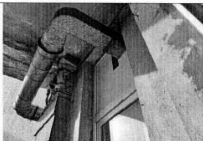
Фото 22. Фрагмент лоджии южного дворового фасада.
