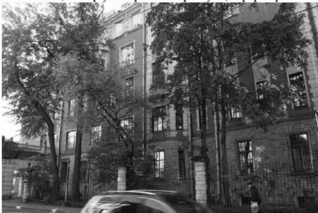
Фото 27. Вид на лицевой фасад объекта культурного наследия регионального значения «Лицевой корпус Литера В» со стороны улицы Профессора Попова.
