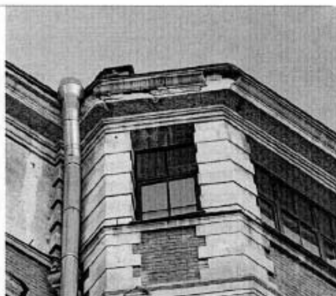
Фото 4. Фрагмент северного лицевого фасада.
