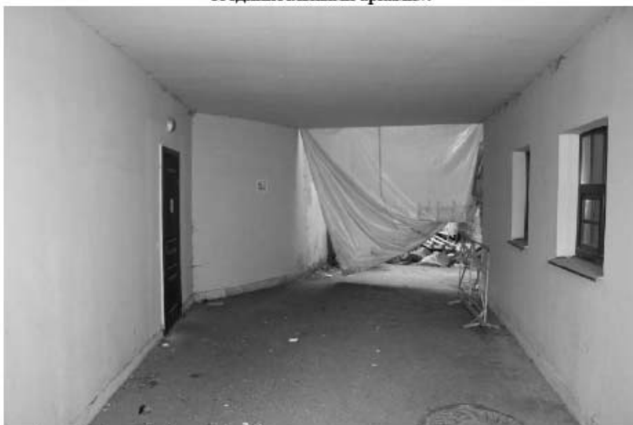
Фото 6. Воротный проезд объекта культурного наследия регионального значения «Служебный корпус Литера Б с двумя соединительными арками».
