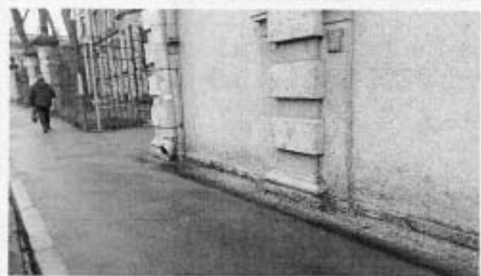
5. Северный лицевой фасад.
