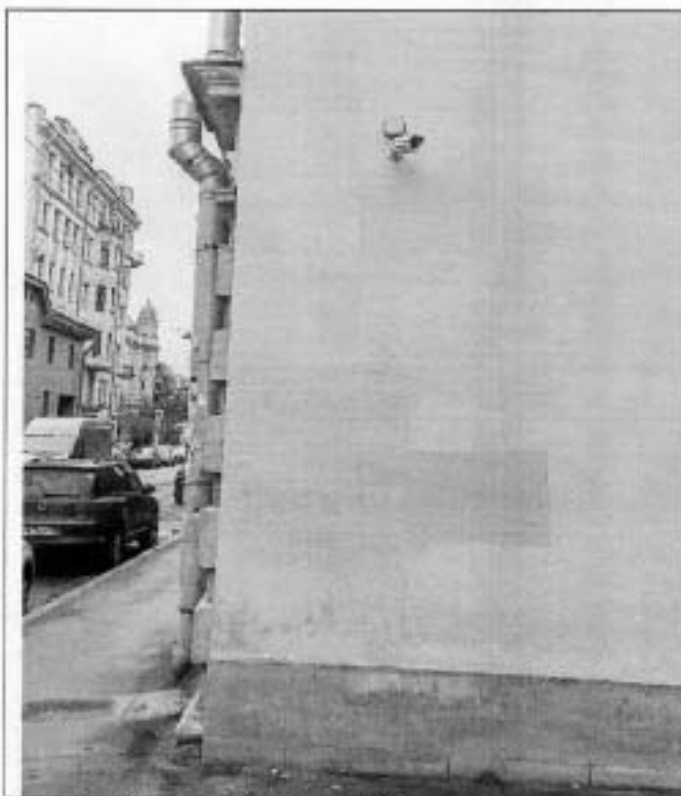
4. Западный торцевой фасад.
