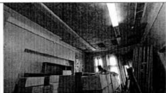
Фото 66. Помещение в уровне 5 этажа.
