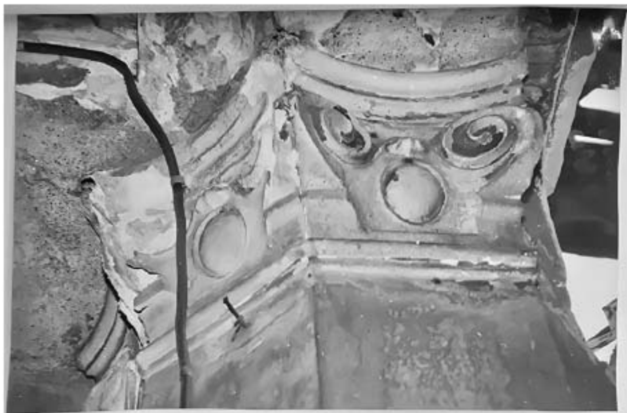
Илл. 139. Капитель шестигранного столба на балконе 3-го этажа южного фасада. Лит. Б, В. 1991 г. Архив КГИОП. П. 1560. Пр-5. Научно-проектная документация. Раздел 2. Фотофиксация. Фасады дворовых флигелей, ограда и калитки.
