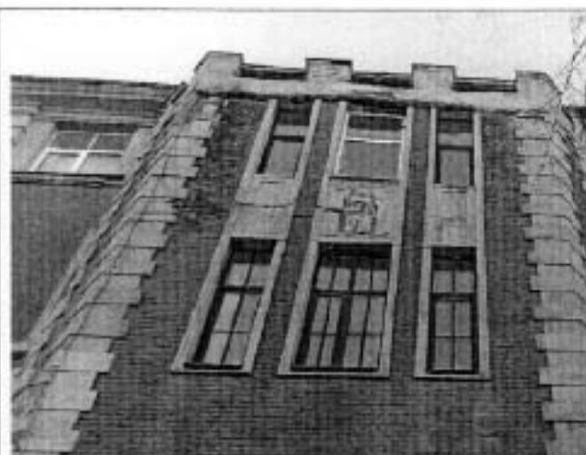
Фото 3. Фрагмент восточного лицевого фасада.
