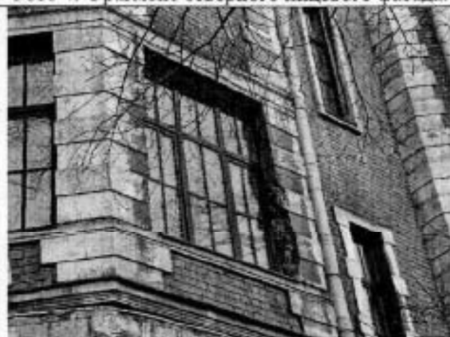
Фото 6. Фрагмент восточного лицевого фасада.
