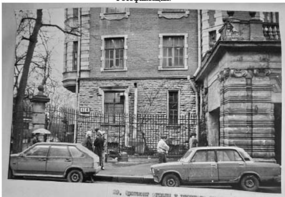
Илл. 88. Фрагмент ограды у главного входа. Левая сторона. 1991 г. Архив КГИОП. П. 1560. Пр-3. Научно-проектная документация. Раздел 2. Фотофиксация.
