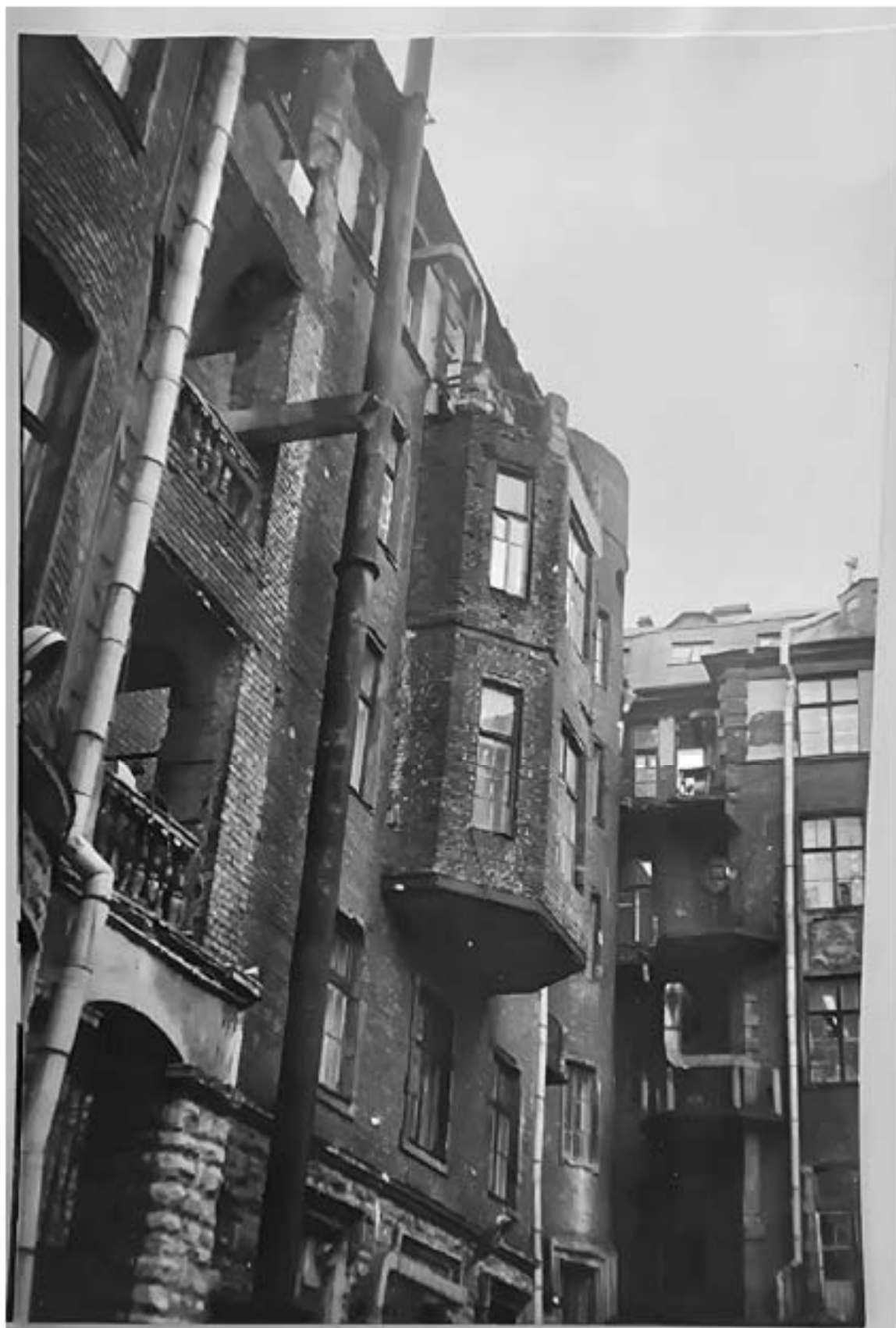
Илл. 140. Фрагмент дворовых фасадов южного и западного. Лит. Б, В. 1991 г. Архив КГИОП. П. 1560. Пр-5. Научно-проектная документация. Раздел 2. Фотофиксация. Фасады дворовых флигелей, ограда и калитки.
