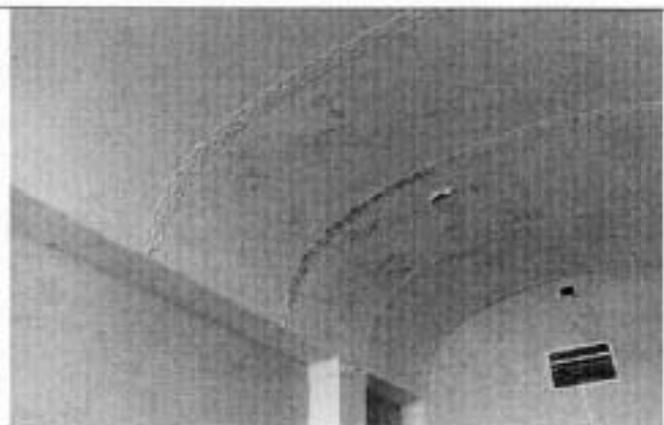
Фото 51. Помещение в уровне 2 этажа.
