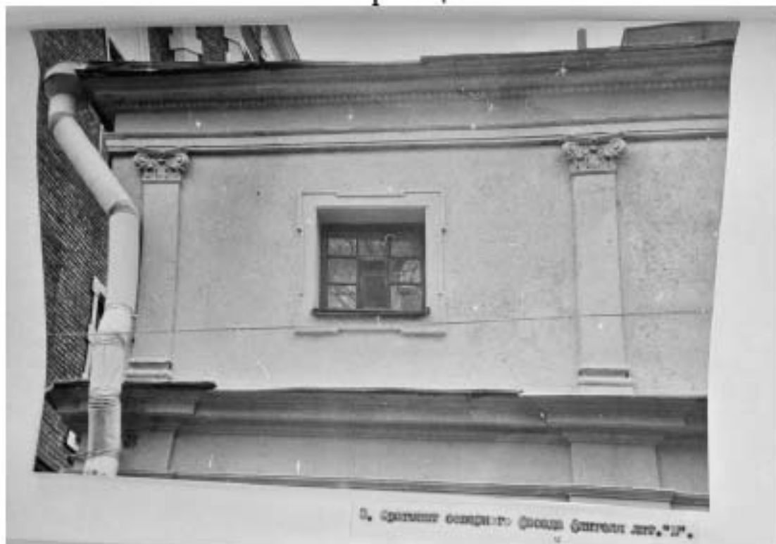
Илл. 63. Фрагмент северного фасада флигеля лит. Б. 1991 г. Архив КГИОП. П. 1560. Пр-3. Научно-проектная документация. Раздел 2. Фотофиксация.
