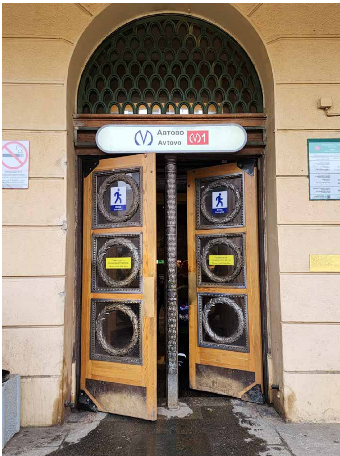
Фото 8. Лицевой фасад. Дверное заполнение левого проема.
