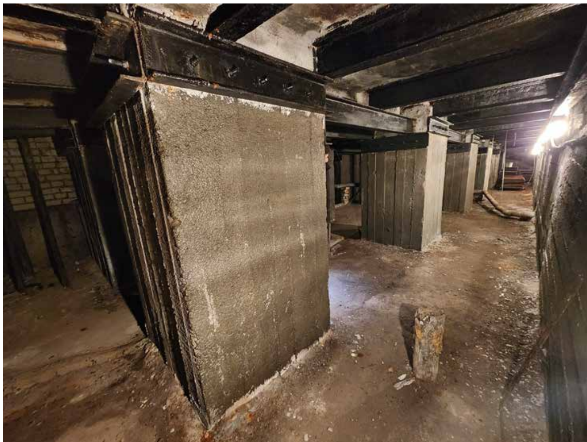
Фото 49. Подземная часть. Помещение № 015а.
