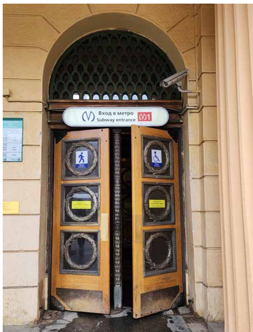
Фото 6. Лицевой фасад. Дверное заполнение правого проема.
