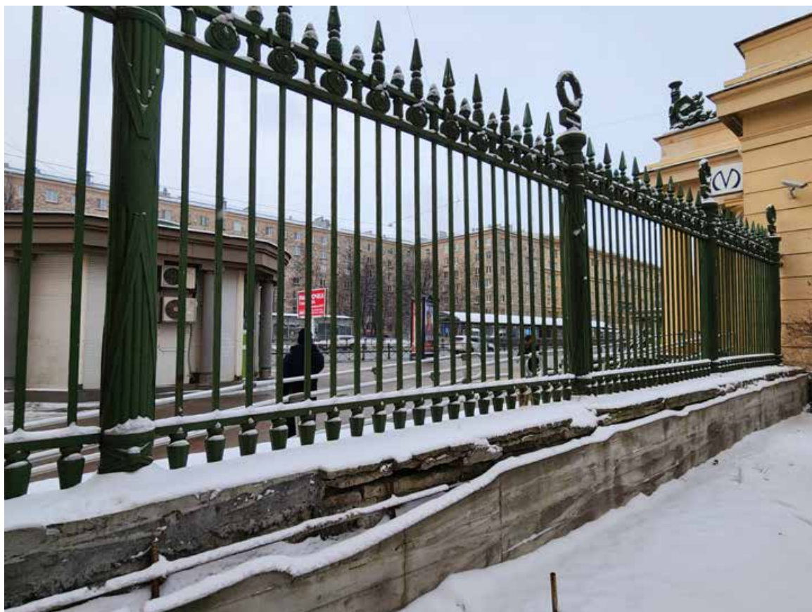
Фото 14. Чугунная ограда на каменном цоколе, примыкающая к южному фасаду.
