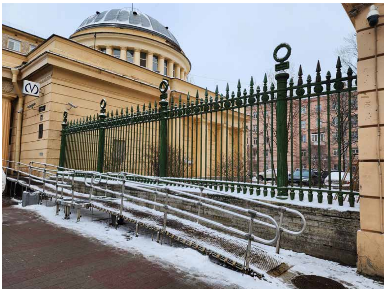
Фото 4. Чугунная ограда на каменном цоколе, примыкающая к южному фасаду.
