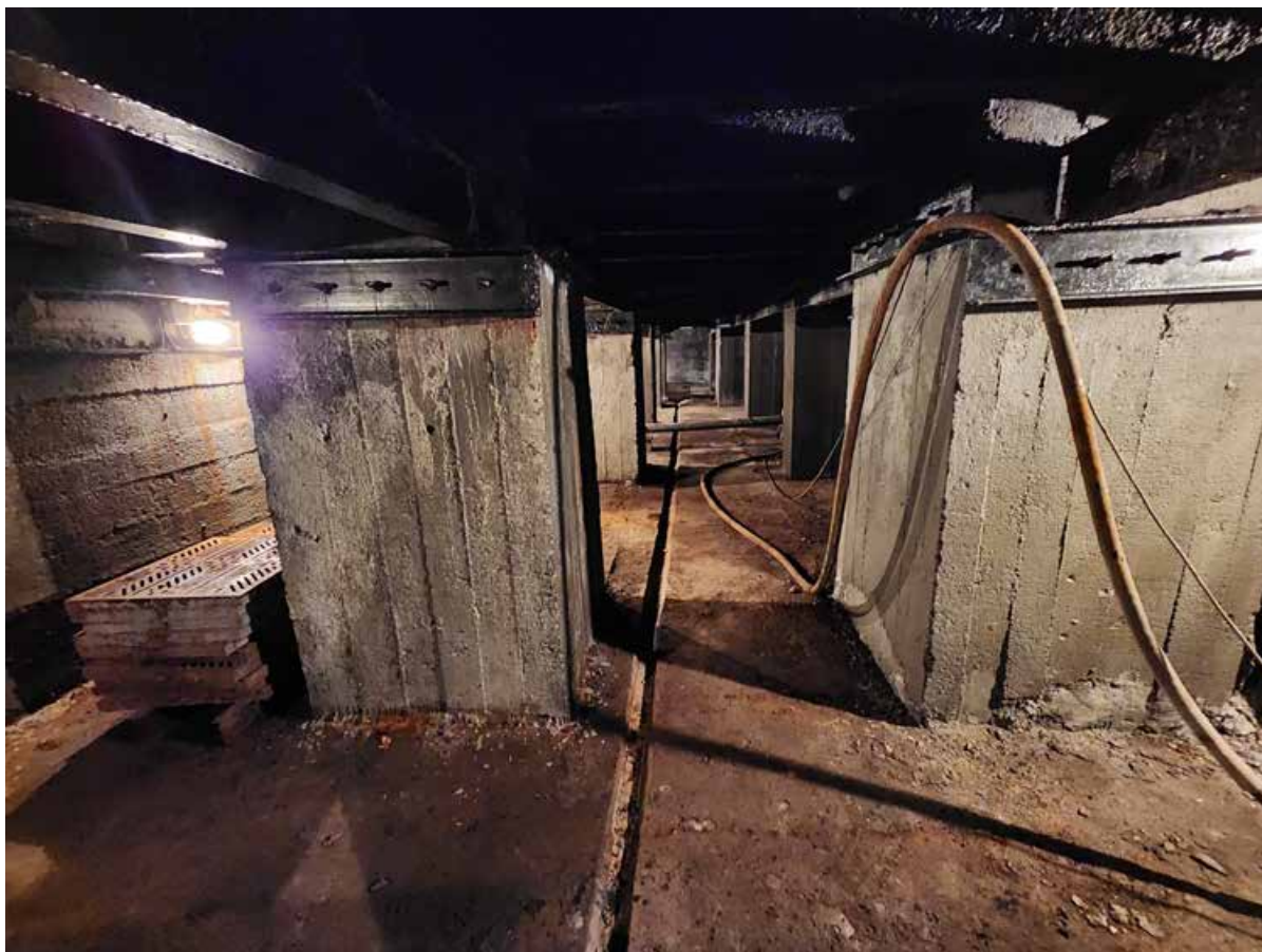
Фото 48. Подземная часть. Помещение № 015а.
