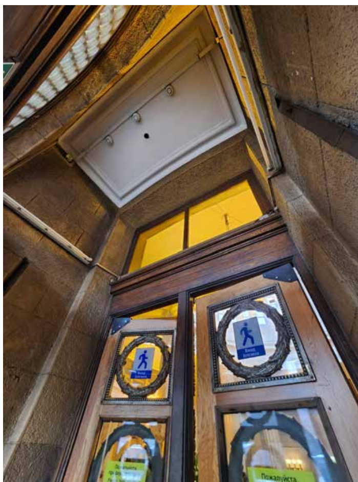
Фото 15. Центральный тамбур 1-го этажа.
