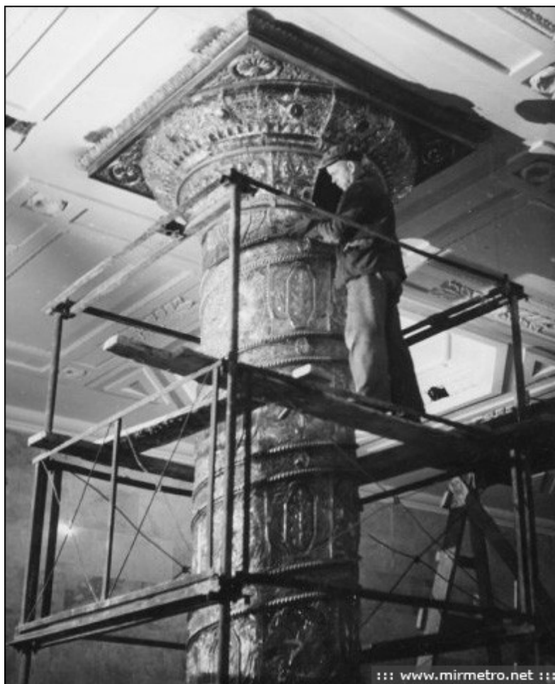
10. Монтаж хрустального стекла на капитель колонны. 1955. mirmetro.net .
