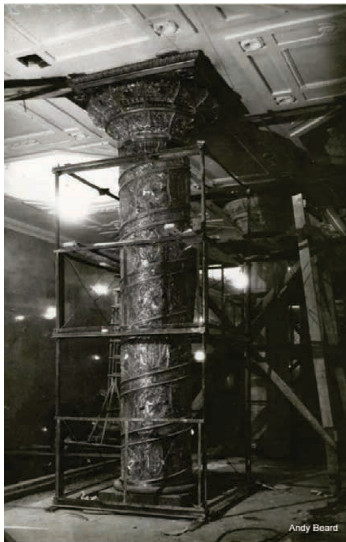
8. Отделочные работы. 1955. JKL@MN)C)
