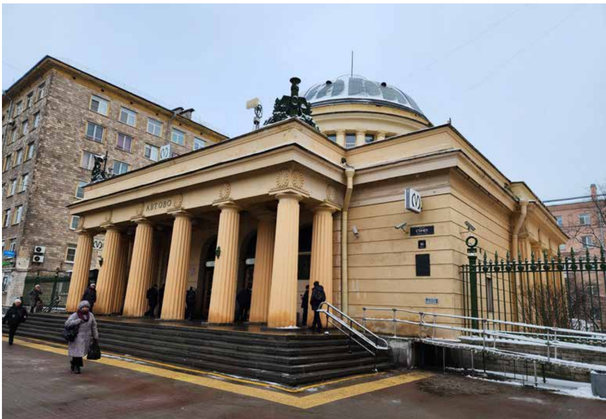
Фото 3. Лицевой фасад. Южный фасад.
