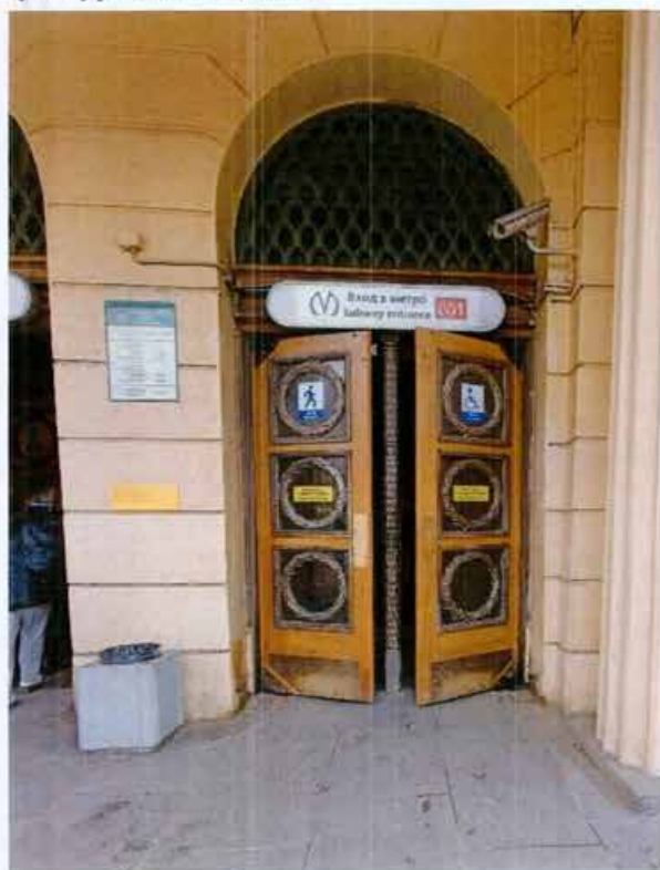
6. Входной проем главного входа объекта культурного наследия.
