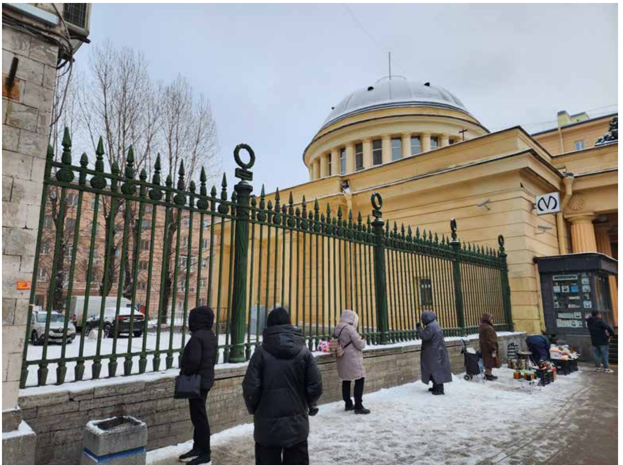
Фото 10. Чугунная ограда на каменном цоколе, примыкающая к северному фасаду.
