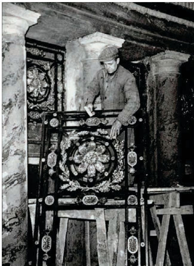
11. Слесарь-монтажник Сергей Лесников работает над оформлением станции. 1955. Q: " ( 4 4 Д С&б Бр 12554.
