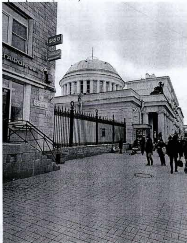
6. Вид с северо-западной стороны. Ограда. Пристройка (киоск).
