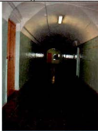
17. Коридор 1-го этажа. Общий вид.
