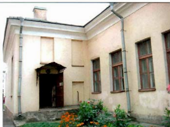
2. Фрагмент восточного фасада.
