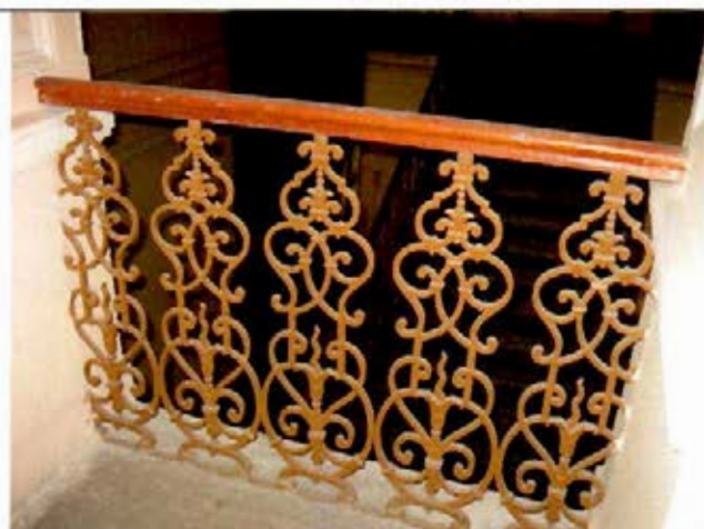
16. Ограждение лестницы северной части здания. Фрагмент.
