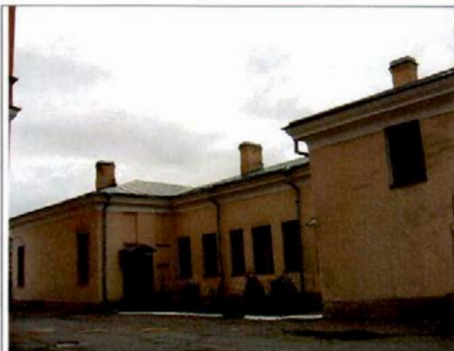
1. Восточный фасад. Общий вид.
