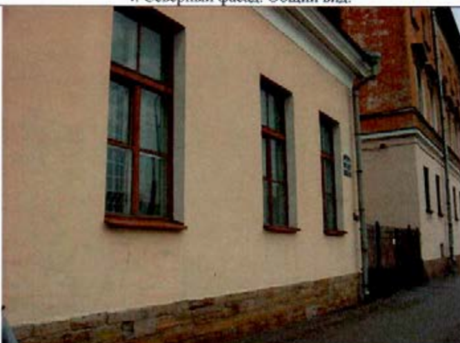
6. Южный фасад. Общий вид.
