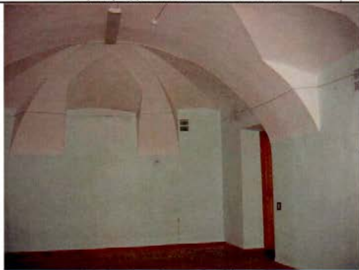
16. Помещения 1-го этажа. Общий вид.
