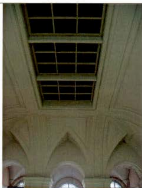
18. Помещения 2-го этажа. Общий вид.
