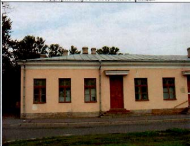
5. Южный фасад. Общий вид.
