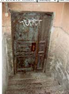
6. Входной проем восточного фасада. Общий вид.
