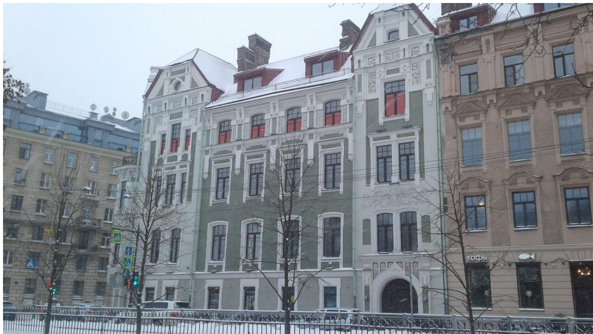
2. Объект культурного наследия регионального значения «Особняк и доходный дом И.Е. Ритинга» по адресу: г. Санкт-Петербург, пр. Добролюбова, д. 1/79, лит. Б. Фасад со стороны Кронверкского проспекта.
