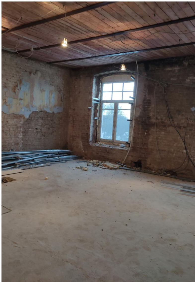
13. Объект культурного наследия регионального значения «Особняк и доходный дом И.Е. Ритинга» по адресу: г. Санкт-Петербург, пр. Добролюбова, д. 1/79, лит. Б. Четвертый этаж. Квартира №53. Фрагмент интерьера (в зоне восстановления утраченной лестничной клетки).
