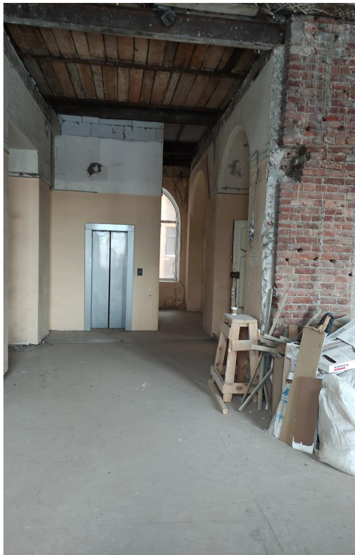
10. Объект культурного наследия регионального значения «Особняк и доходный дом И.Е. Ритинга» по адресу: г. Санкт-Петербург, пр. Добролюбова, д. 1/79, лит. Б. Третий этаж. Помещение 9-Н. Общий вид в зоне восстановления исторической лестничной клетки.
