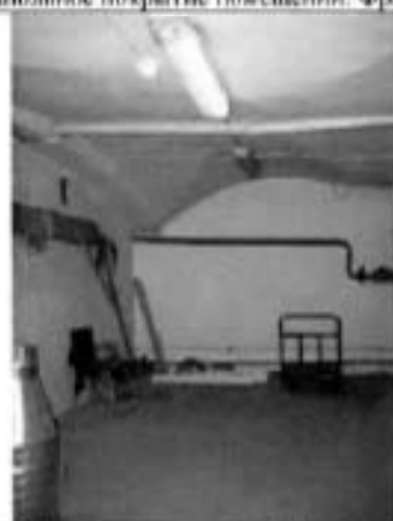
25. Помещение подвала. Общий вид.
