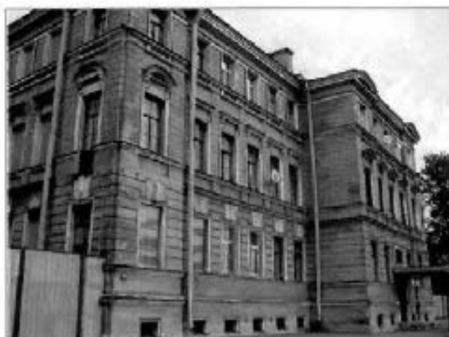
1. Южный фасад. Общий вид.
