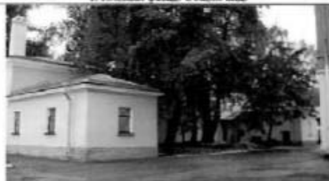
3. Восточный фасад. Общий вид.
