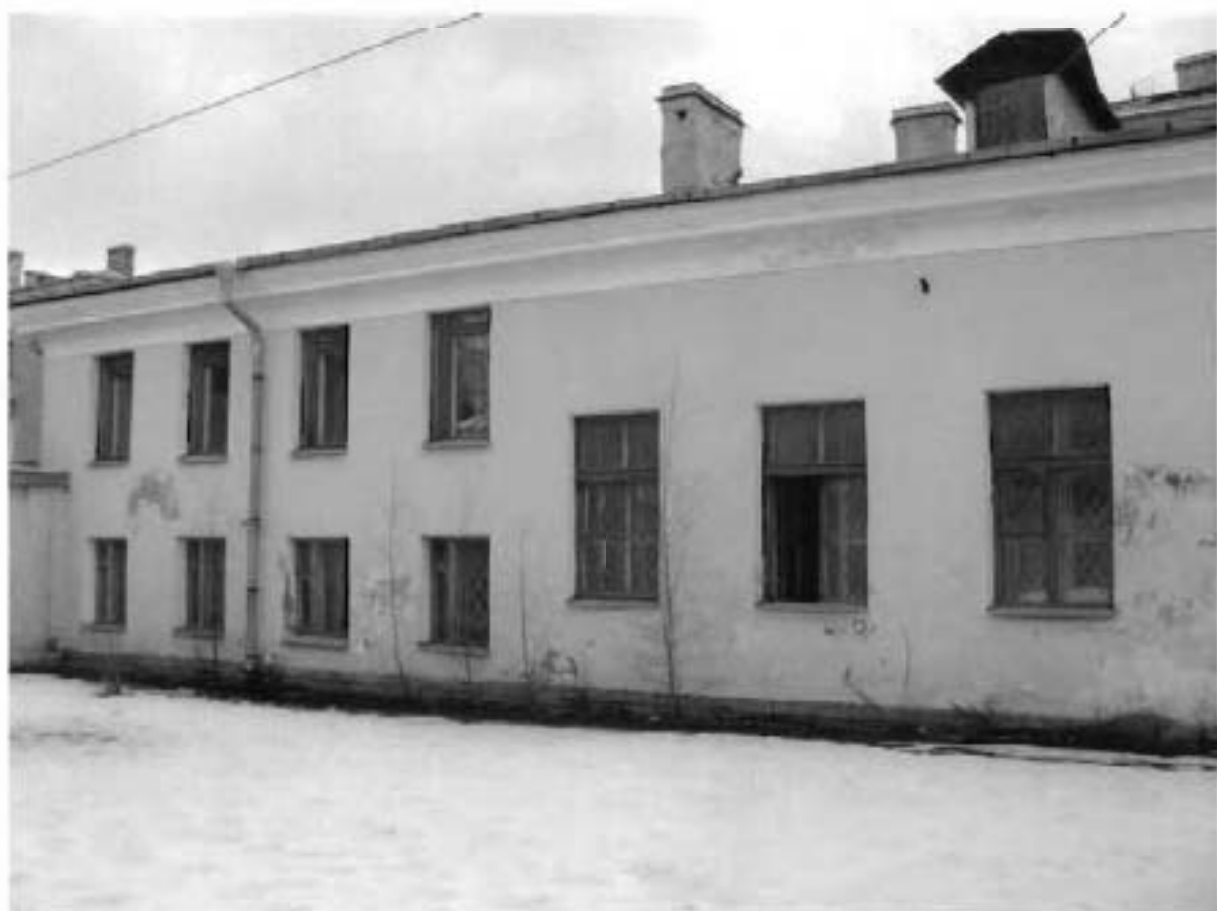
4. Фрагмент западного фасада. Вид с юго-запада.
