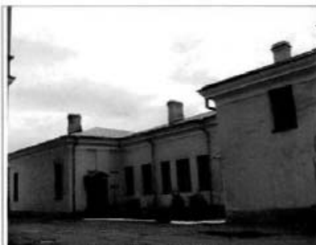
1. Восточный фасад. Общий вид.
