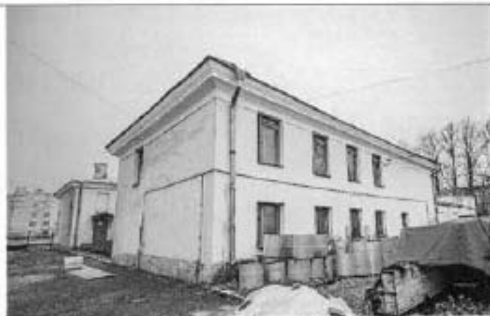
Северный фасад здания. 01.05.2020 г.
