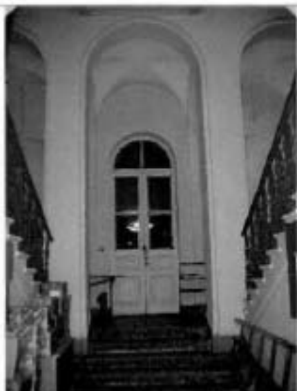
21. Помещение 1-го этажа. Фрагмент.
