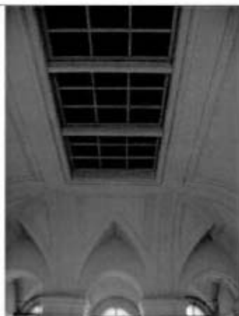
18. Помещение 2-го этажа. Общий вид.
