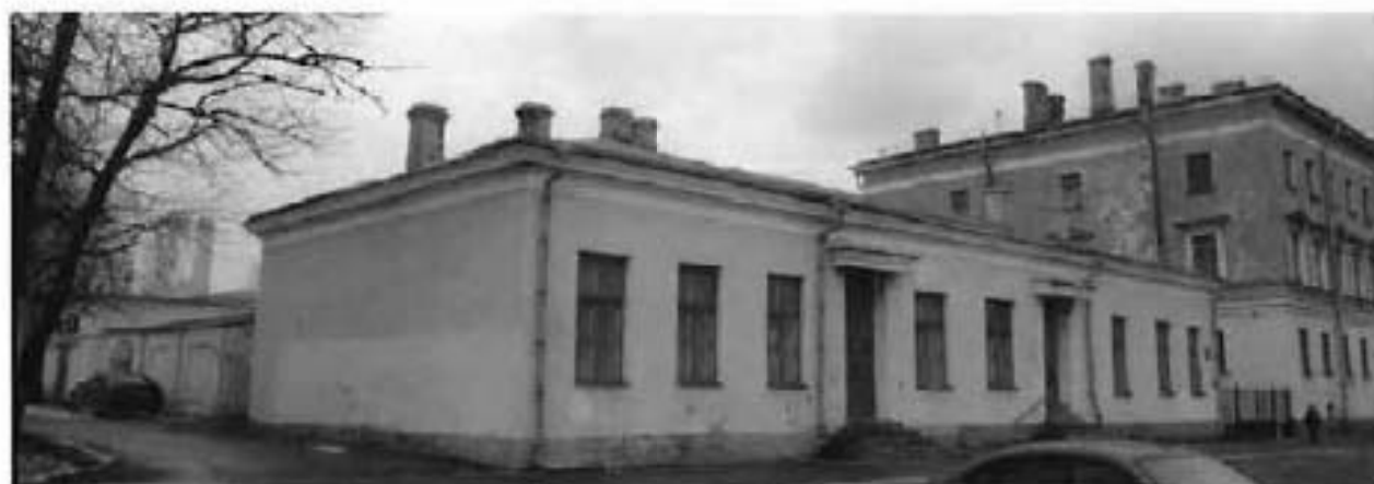
1. Объект культурного наследия. Общий вид с юго-запада.
