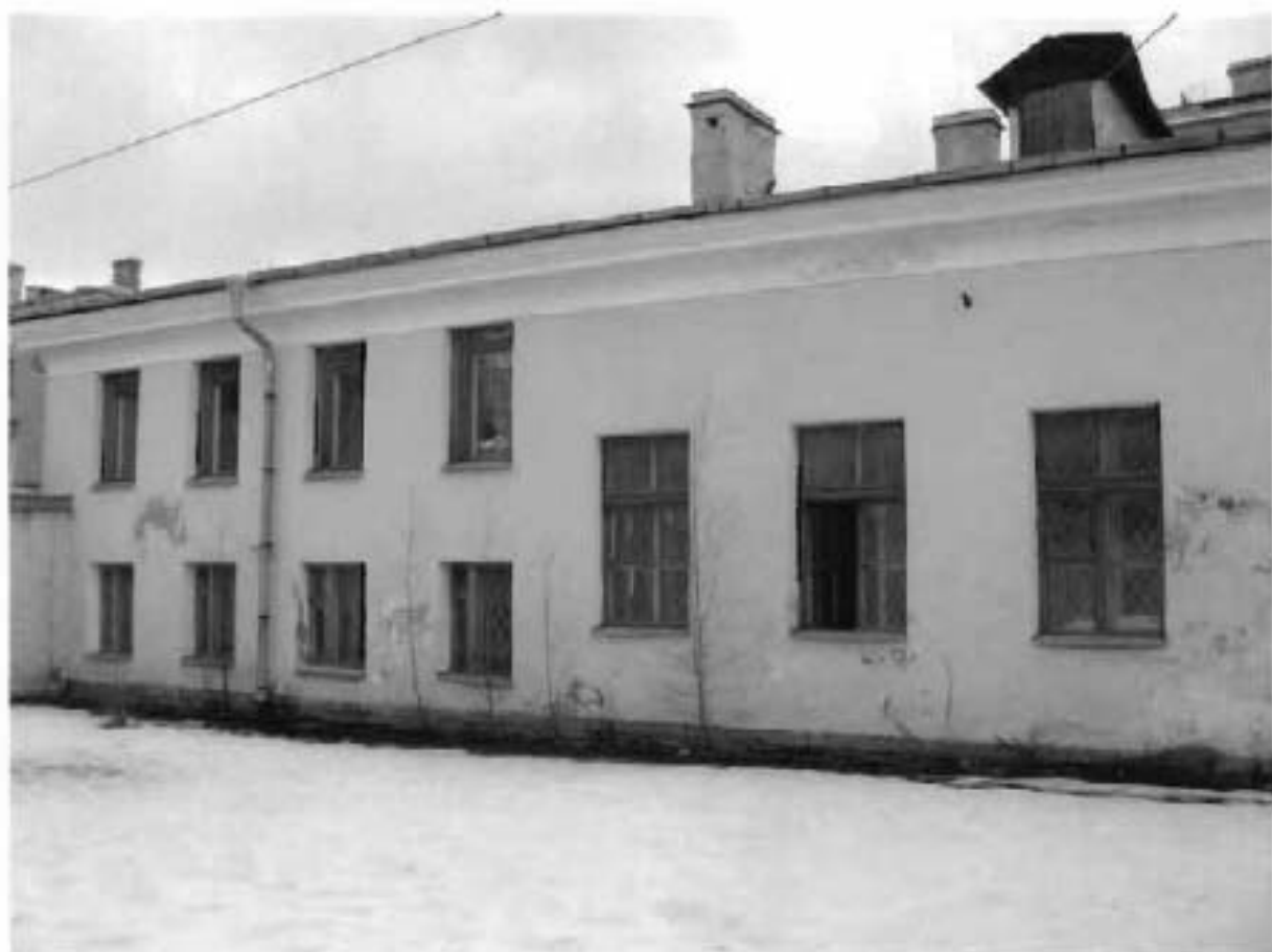
4. Фрагмент западного фасада. Вид с юго-запада.
