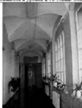
27. Коридор в уровне 2-го этажа. Общий вид.
