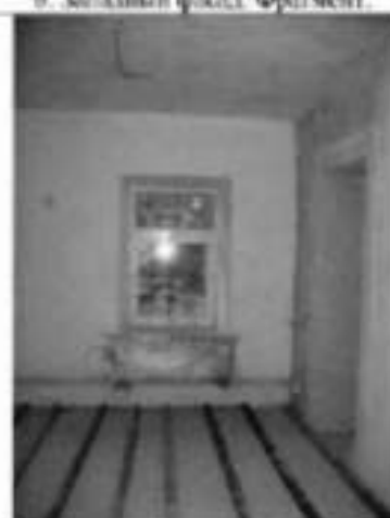
8. Помещение 1-го этажа. Общий вид.
