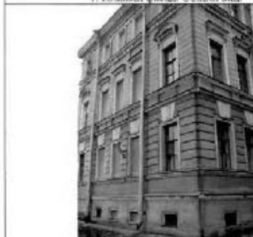
3. Восточный фасад. Фрагмент.
