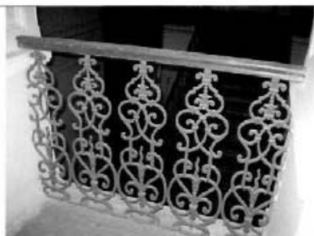
16. Ограждение лестница северной части здания. Фрагмент.
