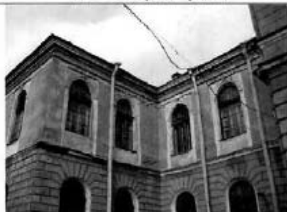
13. Западный фасад. Фрагмент.
