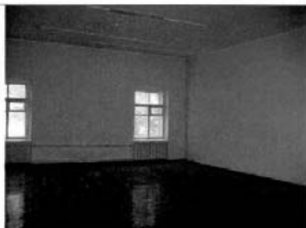
25. Помещение в уровне 2-го этажа. Общий вид.
