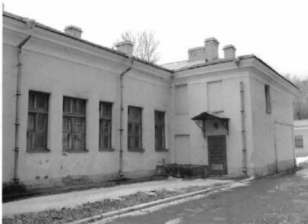
3. Фрагмент восточного фасада. Вид с юго-востока.
