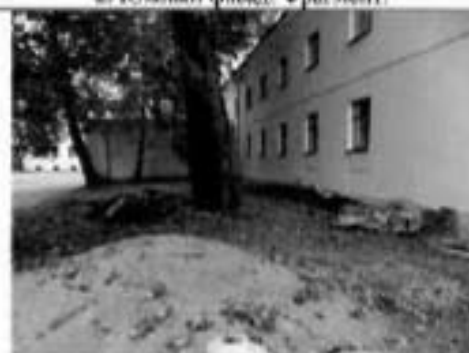
4. Восточный фасад. Фрагмент.
