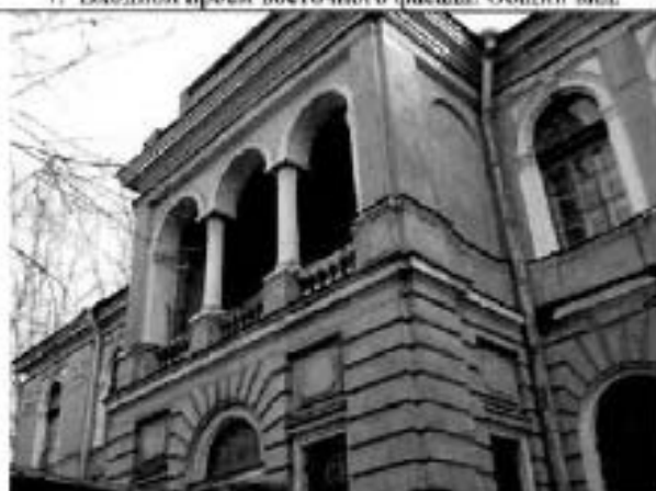
9. Северный фасад. Фрагмент.
