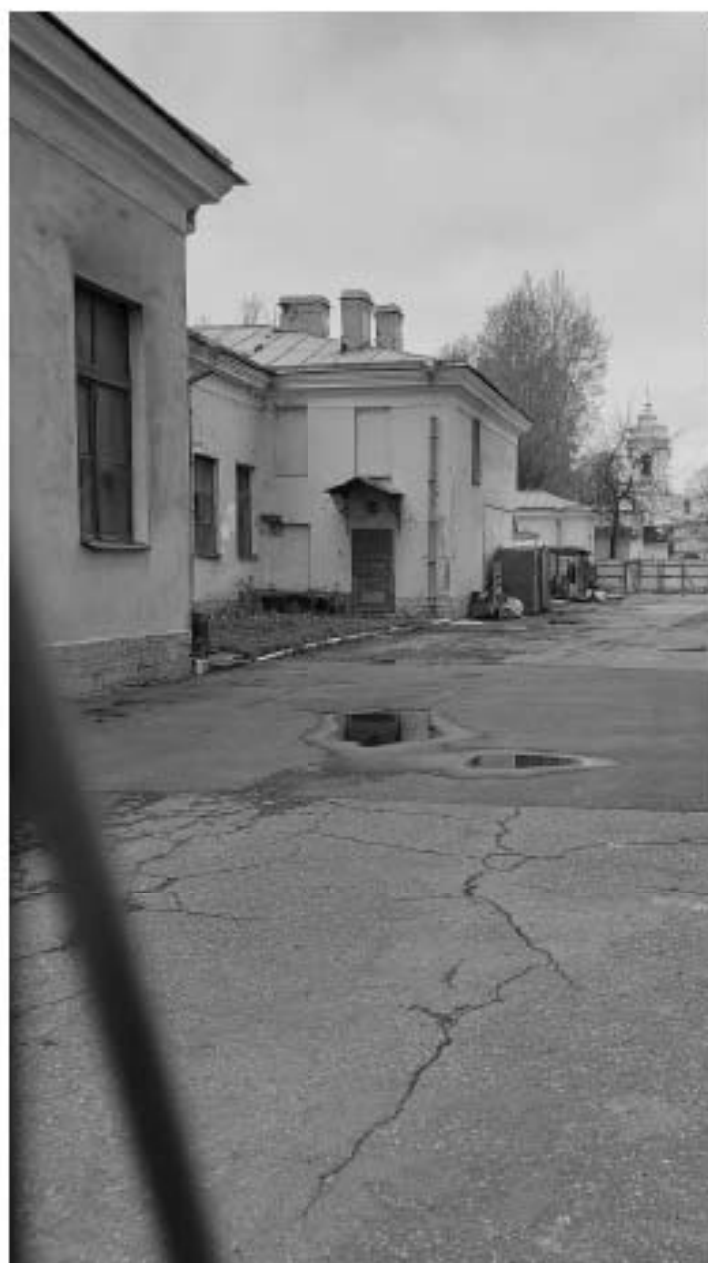
Фото 3. Вид дворового фасада.
