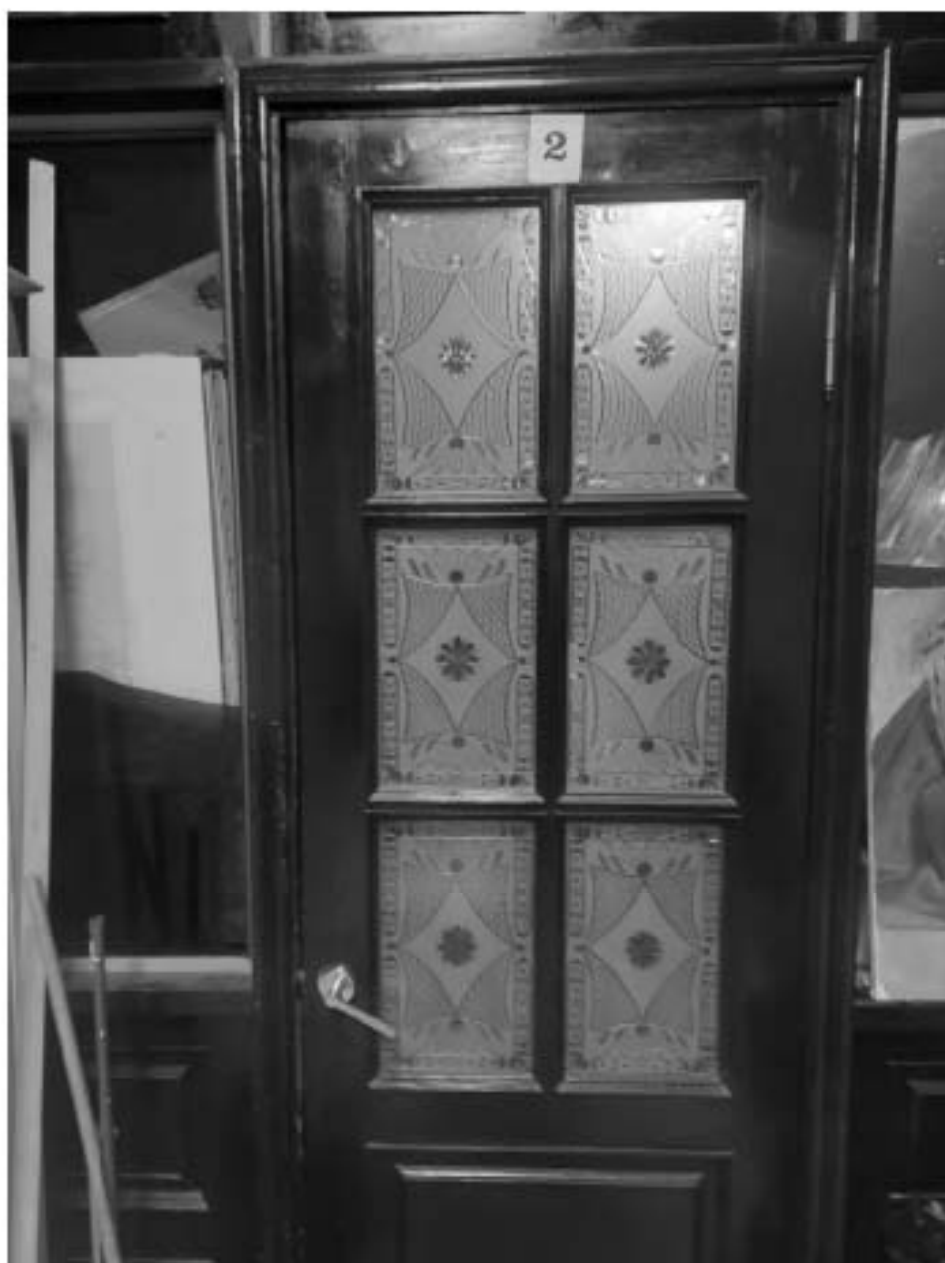
Фото 6. Дверь тамбура, деталь расстекловки.
