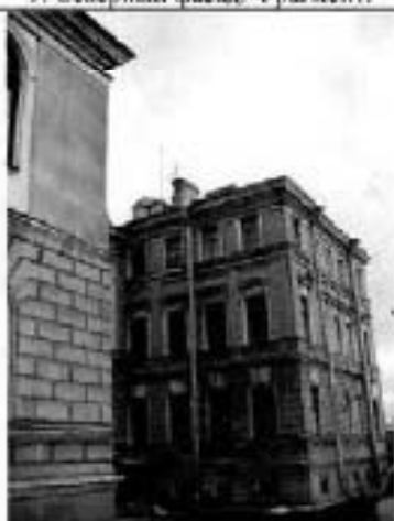
11. Западный фасад. Фрагмент.
