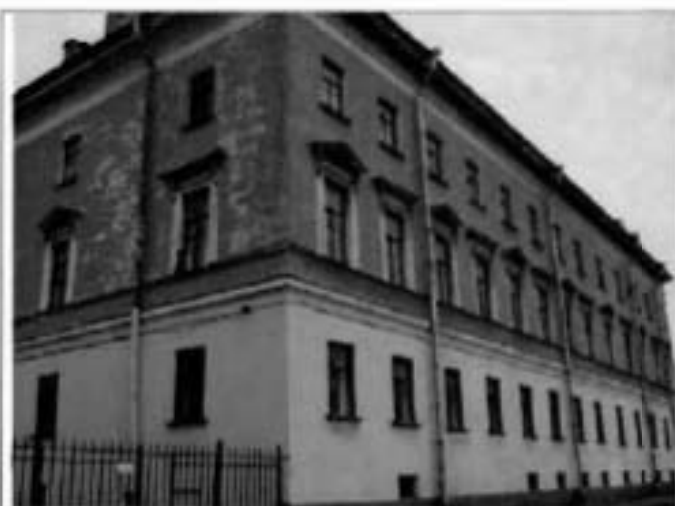
1. Южный фасад. Общий вид
