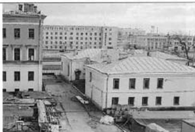
Общий вид здания. 01.05.2020 г.
