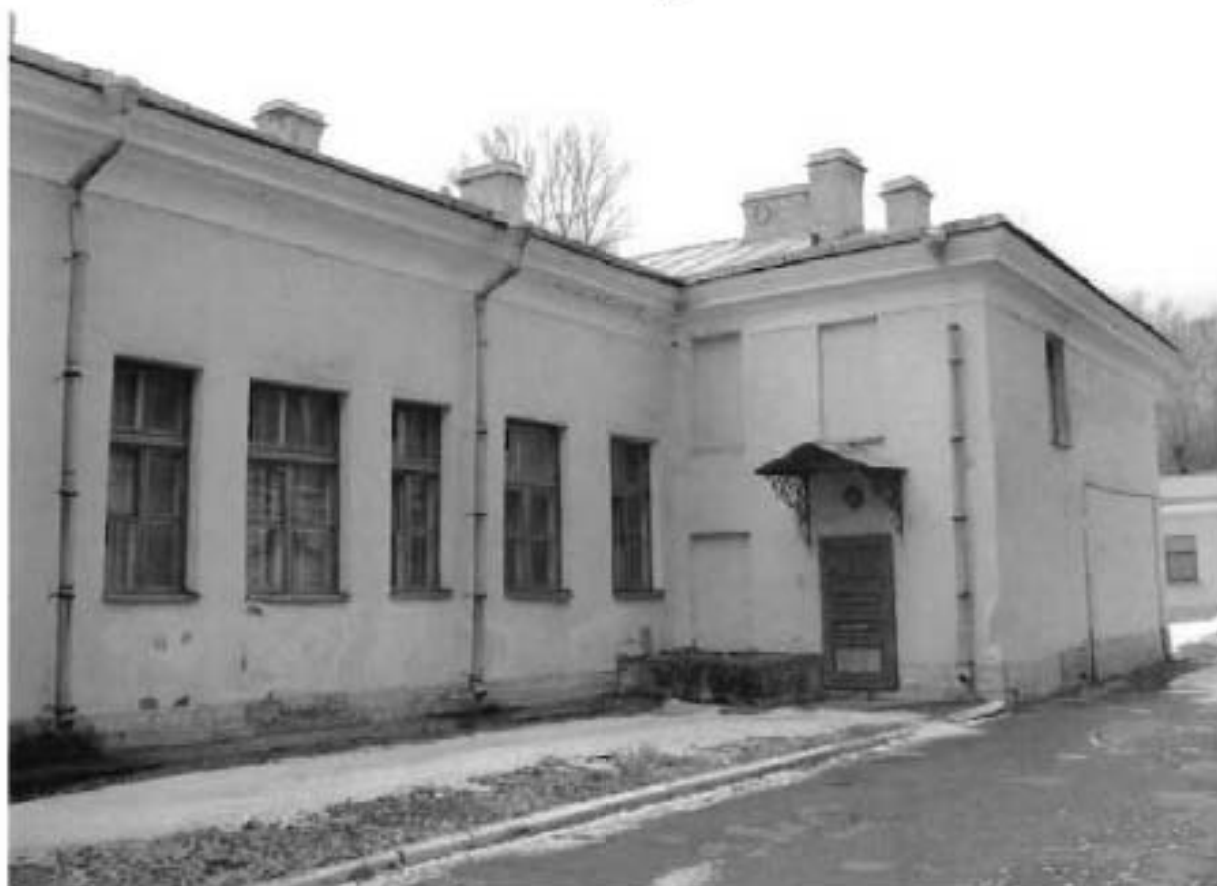
3. Фрагмент восточного фасада. Вид с юго-востока.
