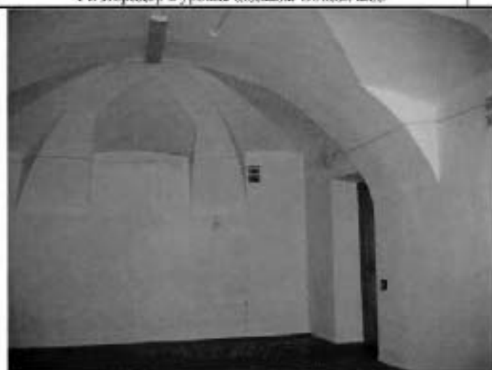
16. Помещение 1-го этажа. Общий вид.
