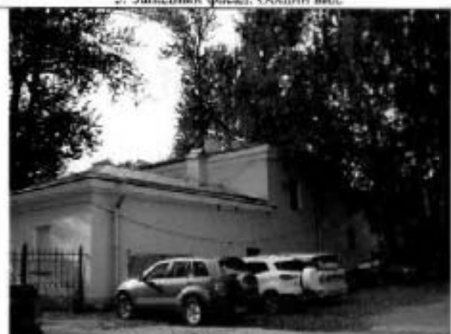
7. Северный фасад. Общий вид.
