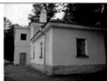
2. Южный фасад. Фрагмент.
