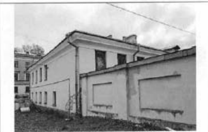
Северный фасад здания. 15.05.2020 г.
