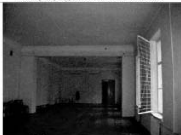
28. Помещение 2-го этажа. Общий вид.
