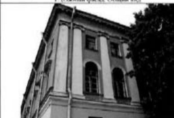
3. Фрагмент восточного фасада.
