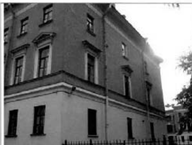
8. Западный торцевой фасад северного флигеля. Общий вид.
