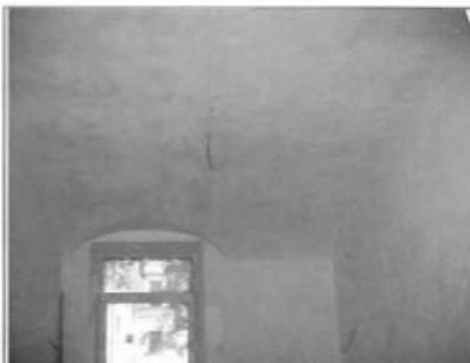
9. Перекритие помещений 1-го этажа.
