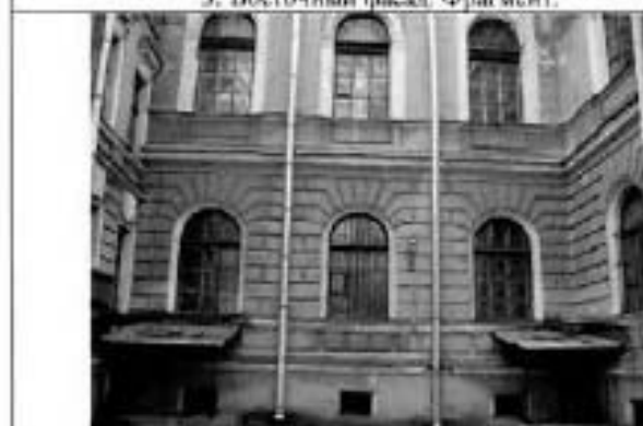
5. Восточный фасад. Фрагмент.
