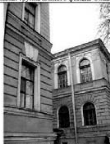
4. Восточный фасад. Фрагмент.
