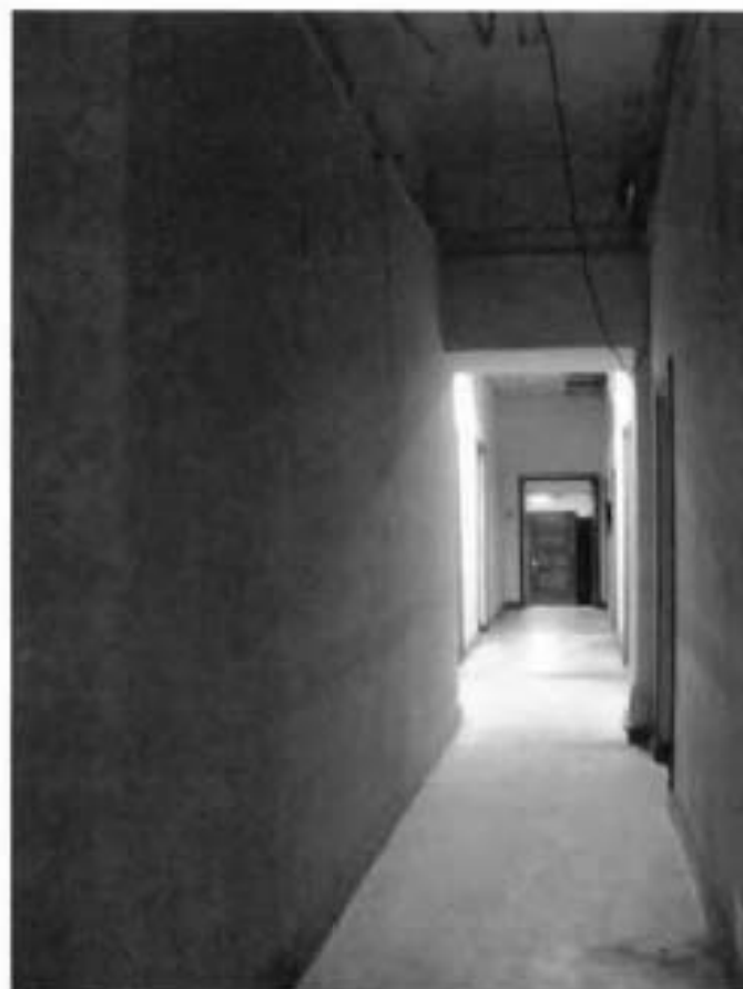
5. Первый этаж. Коридор (пом. 1-Н (13)).
