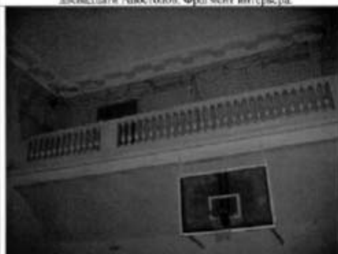
34. Помещение 3-Н (111) бывшего Актного зала. Балкон в уровне 2-го этажа.
