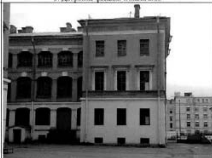
11. Дворовые фасады южного флигеля. Общий вид.
