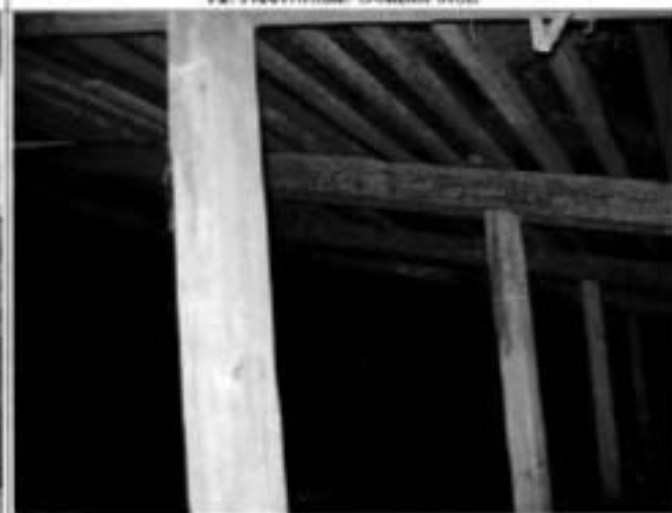
14. Конструкция крыши. Общий вид.
