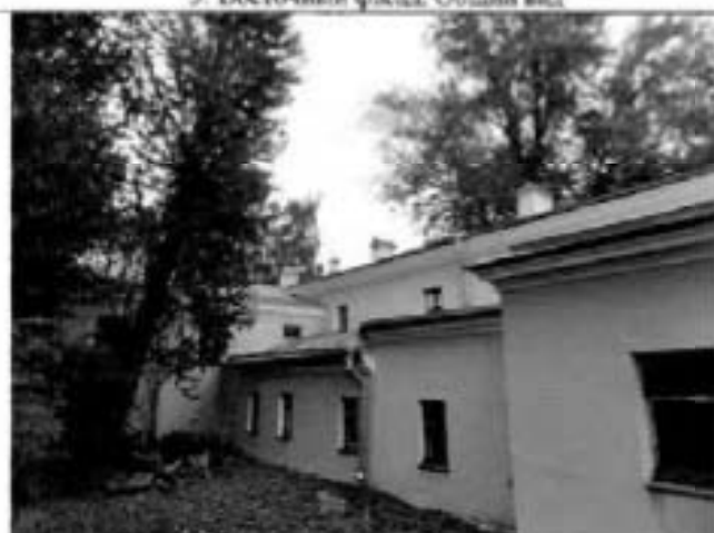
5. Западный фасад. Общий вид.
