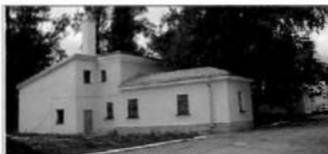
1. Южный фасад. Общий вид.
