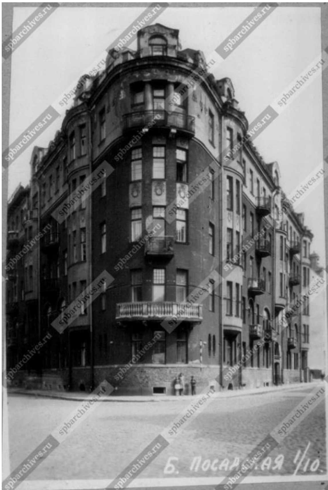
Ил. 77. Большая Посадская улица. Угловой фасад дома № 1/10. Автор не установлен. 1960 г. ЦГА КФФД СПб. Описание 1ГР-48. Ед.хр. 74238.
