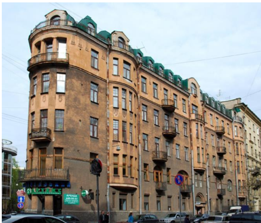
Ил. 79. Жилой дом СПб Товарищества для устройства постоянных квартир по Большой Посадской, д. 1 и Малой Посадской, д. 10. Фото, 2009 г. Фасад по Малой Посадской. URL: https://www.citywalls.ru/house6102.html
