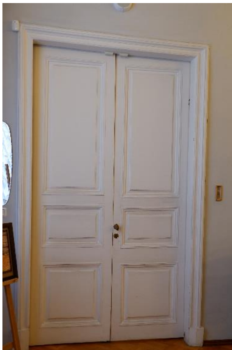
7. Дверные заполнения помещения № 11 по плану ПИБ 2012 г. объекта культурного наследия федерального значения «Дворец Таврический. Дворец», расположенного по адресу: г. Санкт-Петербург, ул. Шпалерная, д. 47, лит. А. 15.10.2021
