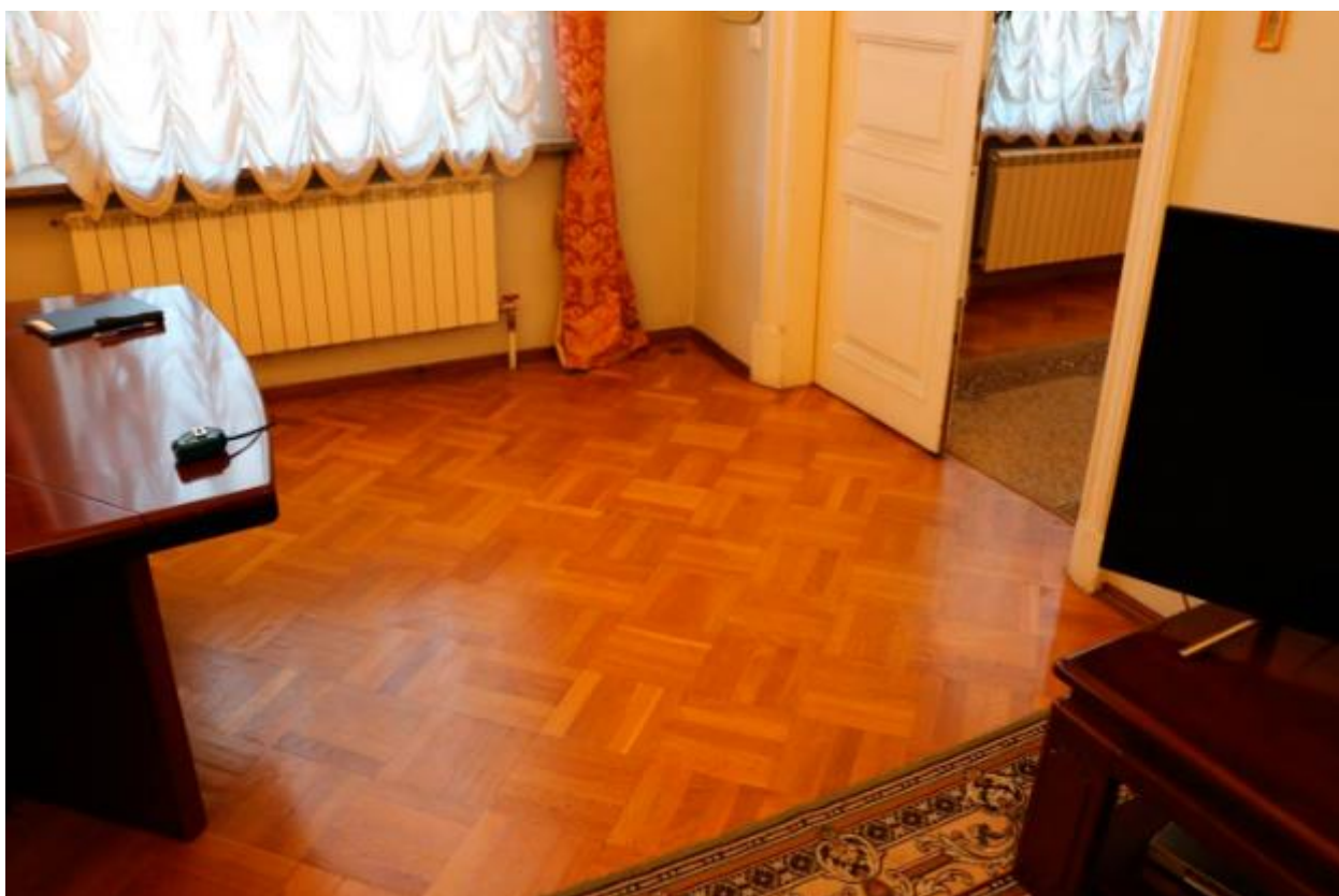
8. Помещение № 11 по плану ПИБ 2012 г. объекта культурного наследия федерального значения «Дворец Таврический. Дворец», расположенного по адресу: г. Санкт-Петербург, ул. Шпалерная, д. 47, лит. А. 15.10.2021
