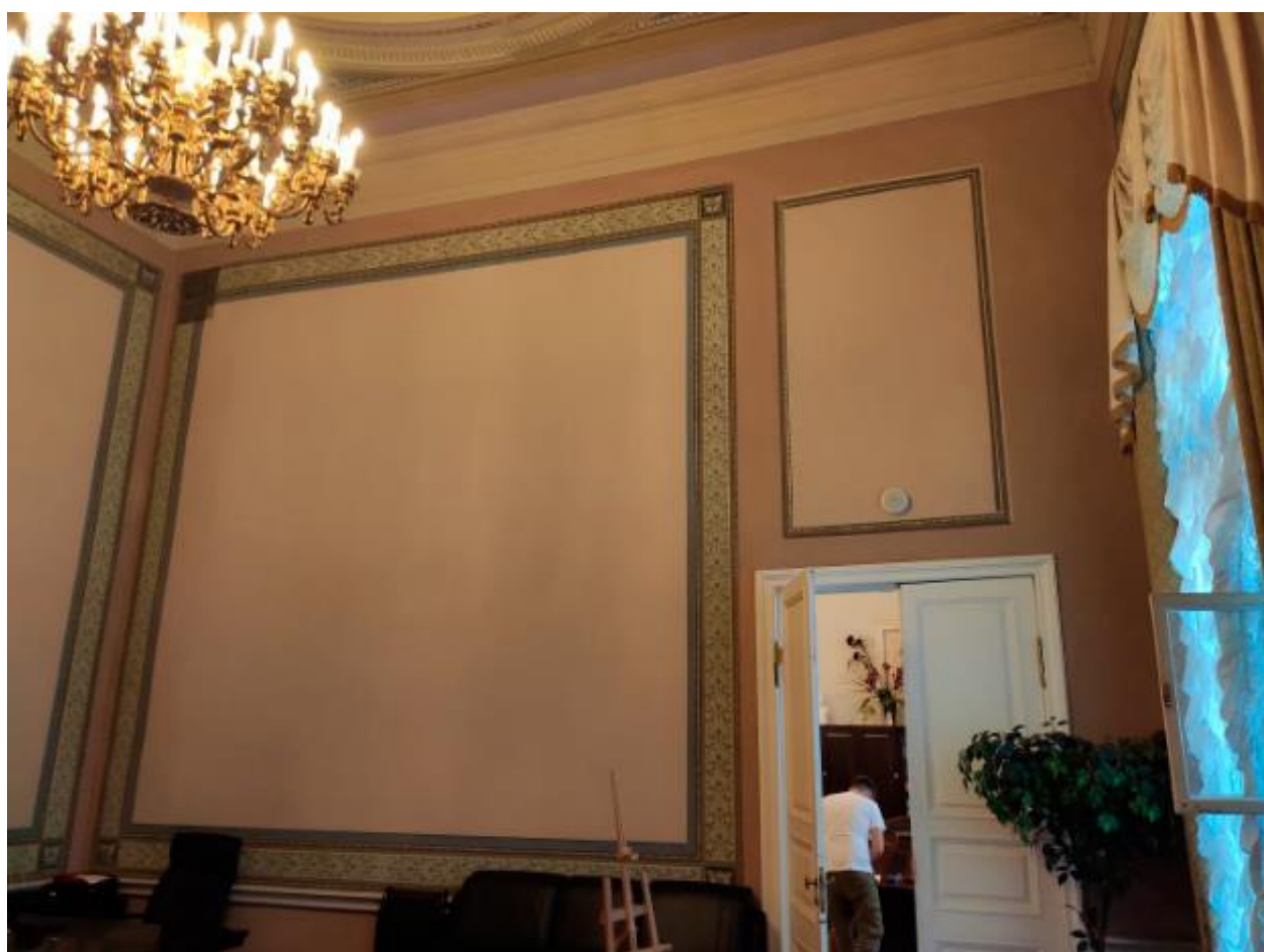
13. Помещение № 12 по плану ПИБ 2012 г. объекта культурного наследия федерального значения «Дворец Таврический. Дворец», расположенного по адресу: г. Санкт-Петербург, ул. Шпалерная, д. 47, лит. А. 15.10.2021
