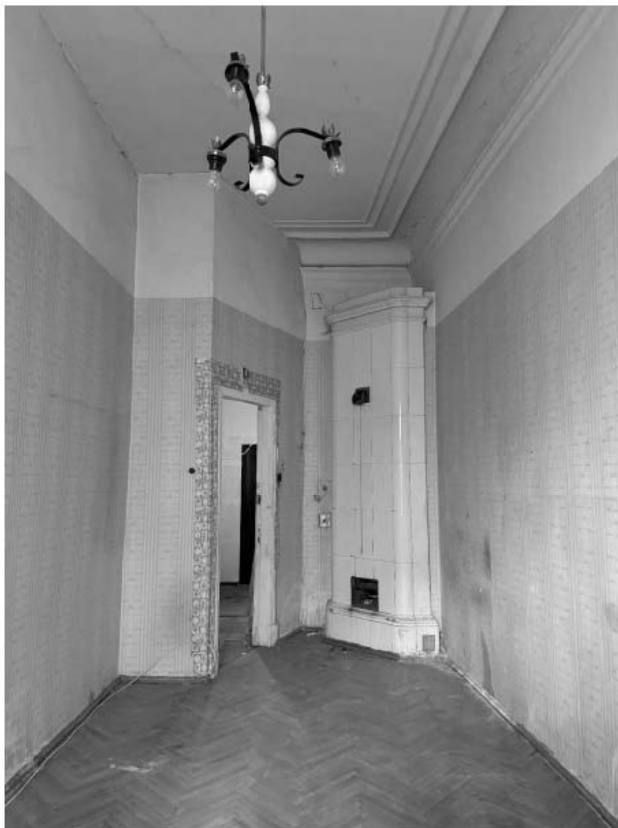
Фото 34. Вид на помещение квартиры № 17 объекта культурного наследия.
