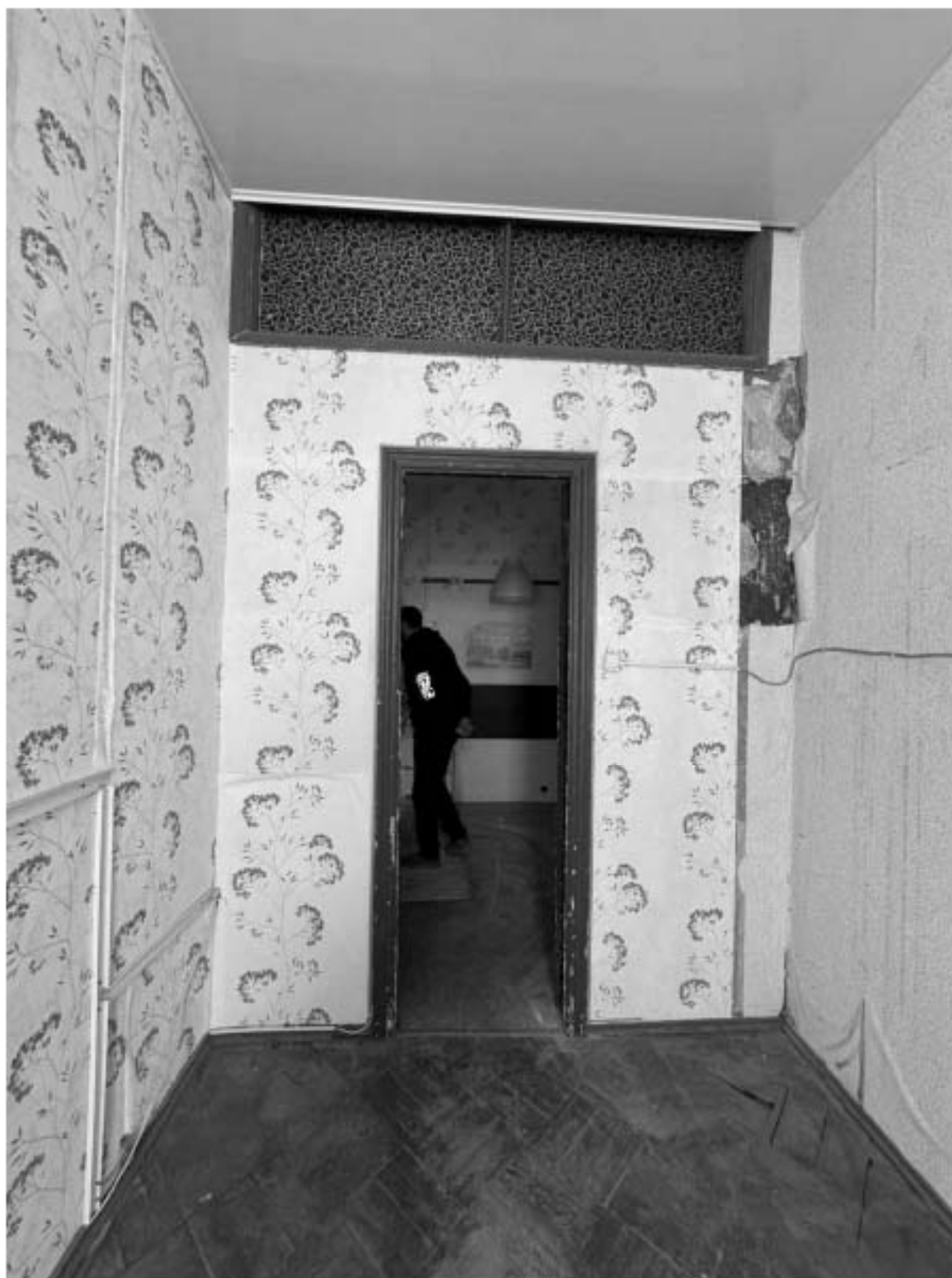
Фото 126. Вид на помещение квартиры № 16 объекта культурного наследия.
