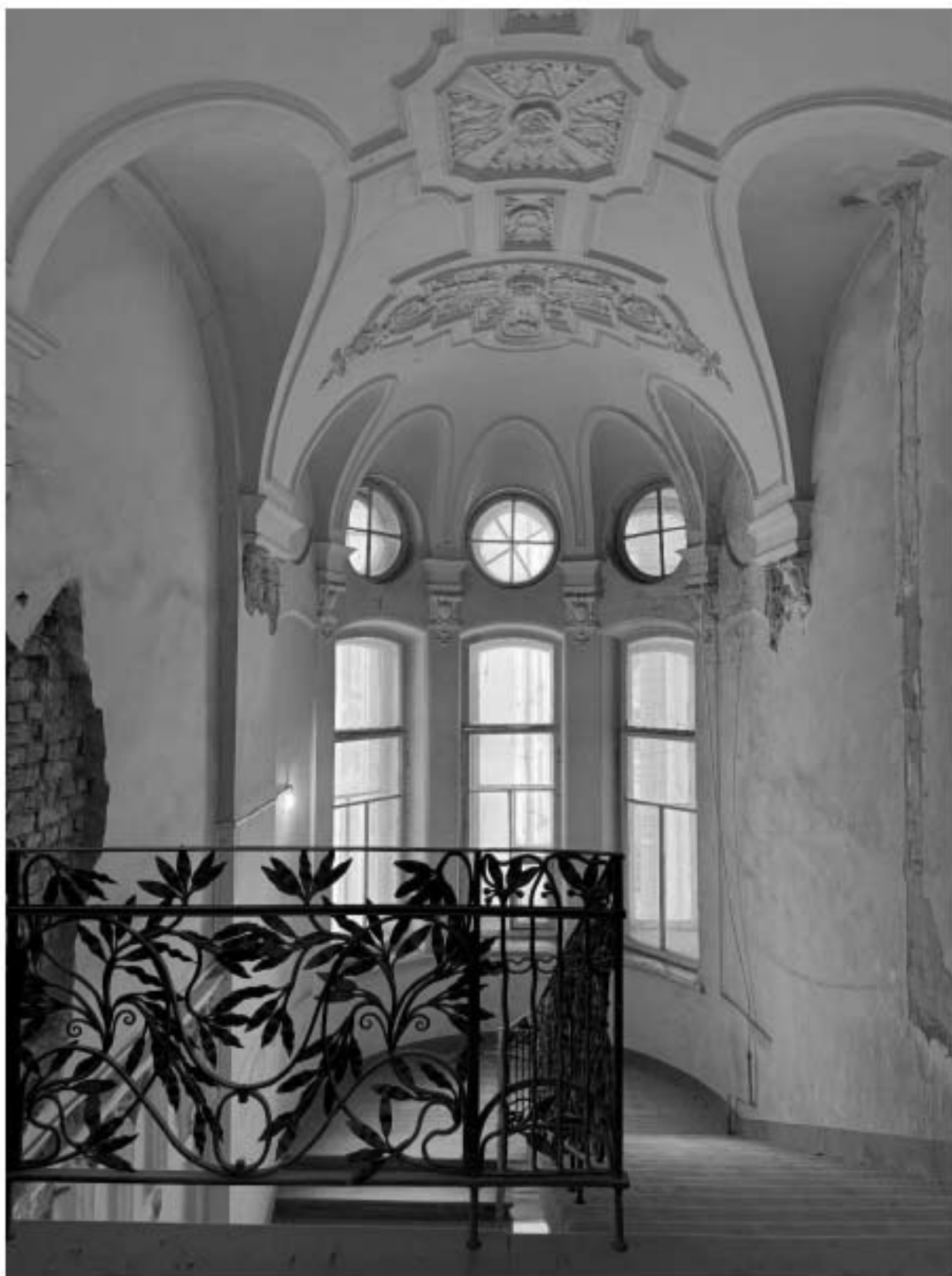
Фото 107. Вид на лестницу 4-ЛК объекта культурного наследия.
