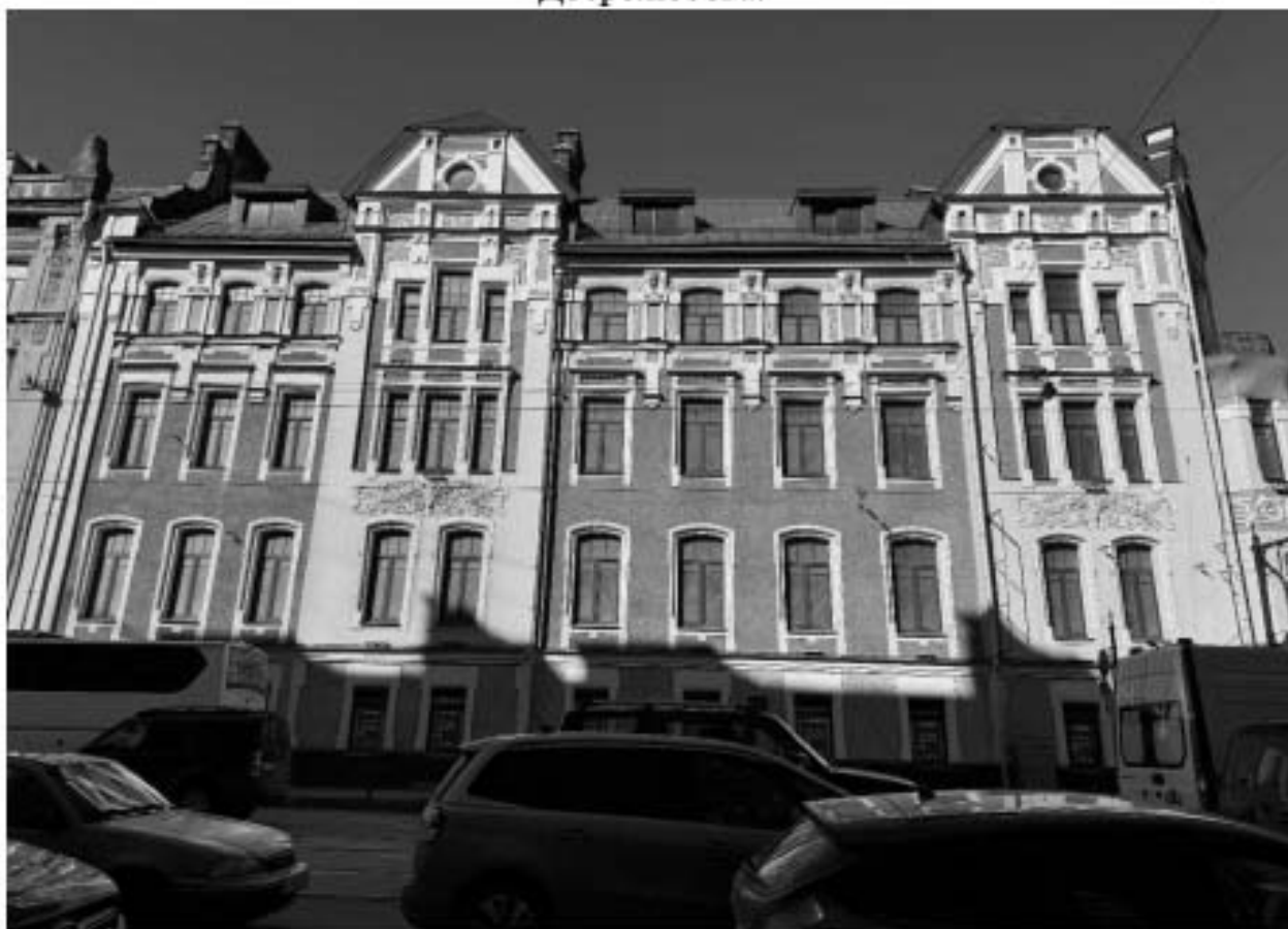
Фото 3. Фрагмент лицевого фасада объекта культурного наследия по проспекту Добролюбова.
