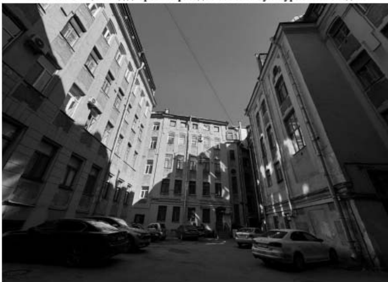
Фото 16. Общий вид дворовых фасадов объекта культурного наследия.
