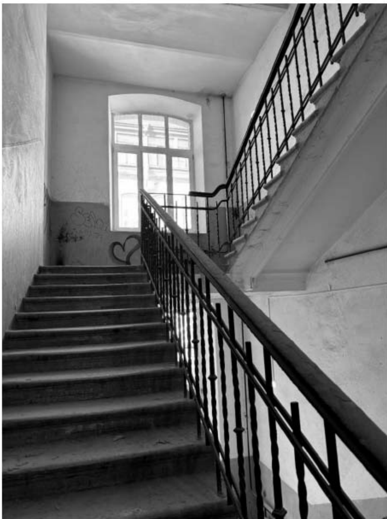
Фото 54. Вид на лестницу 5-ЛК объекта культурного наследия.
