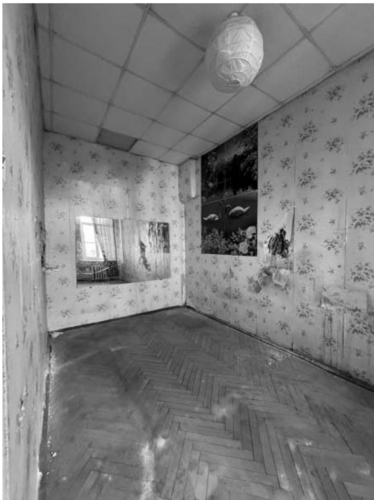
Фото 134. Вид помещения квартиры № 16 объекта культурного наследия.
