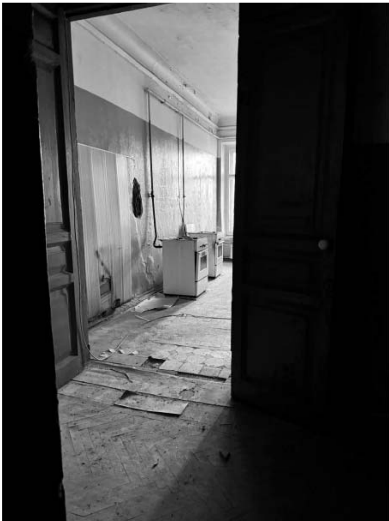
Фото 63. Вид на помещение квартиры № 11 объекта культурного наследия.
