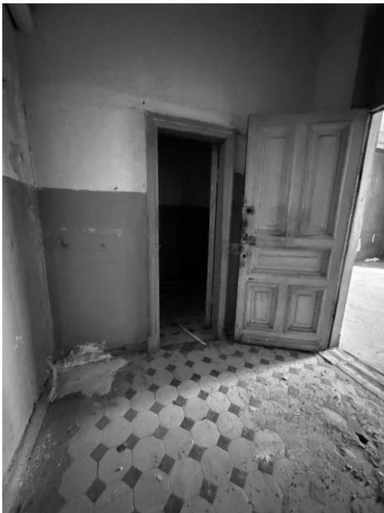
Фото 60. Вид на помещение квартиры № 11 объекта культурного наследия.
