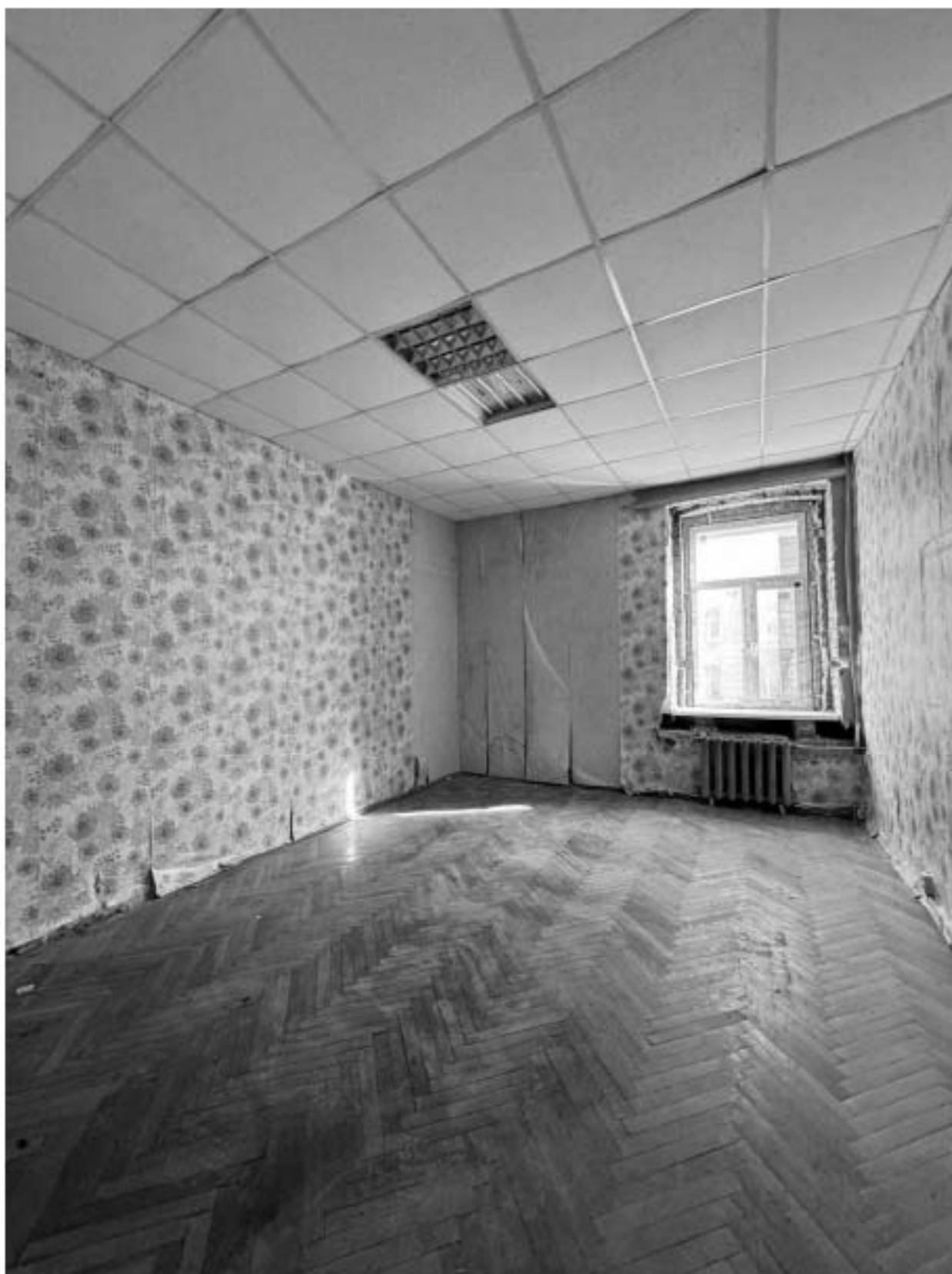
Фото 120. Вид на помещение квартиры № 16 объекта культурного наследия.
