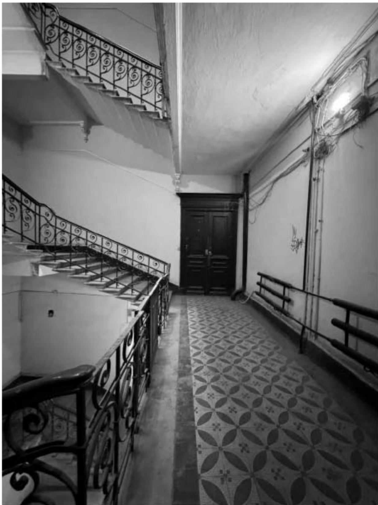
Фото 24. Вид на лестницу 1-ЛК объекта культурного наследия.
