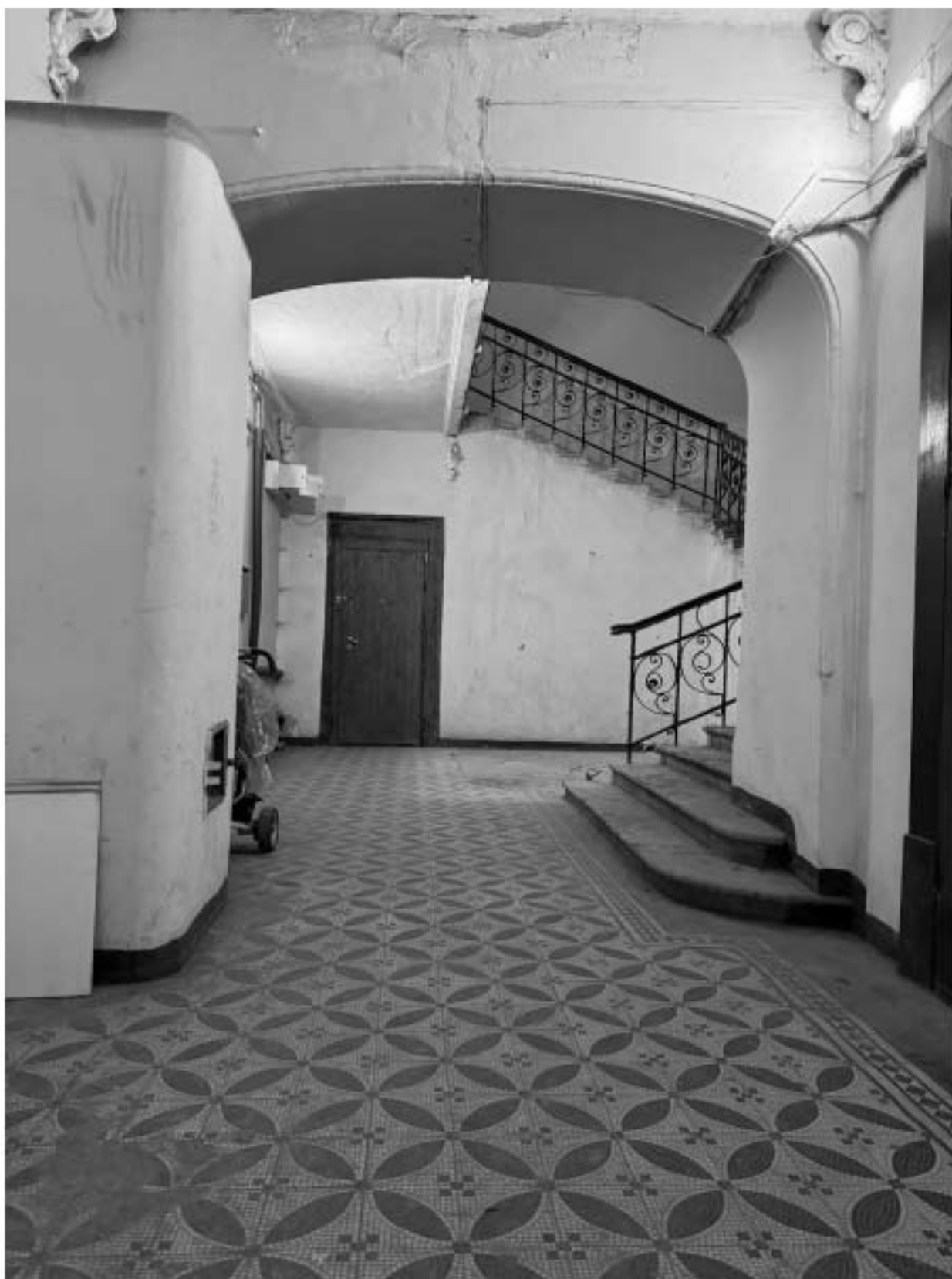
Фото 20. Вид на помещение вестибюля и лестницу 1-ЛК объекта культурного наследия.
