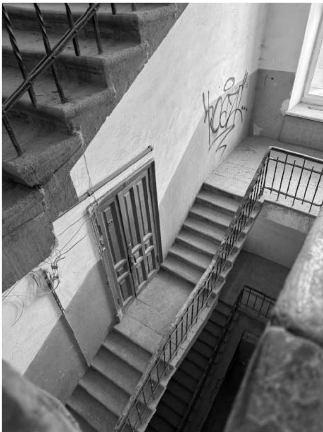
Фото 55. Вид на лестницу 5-ЛК объекта культурного наследия.
