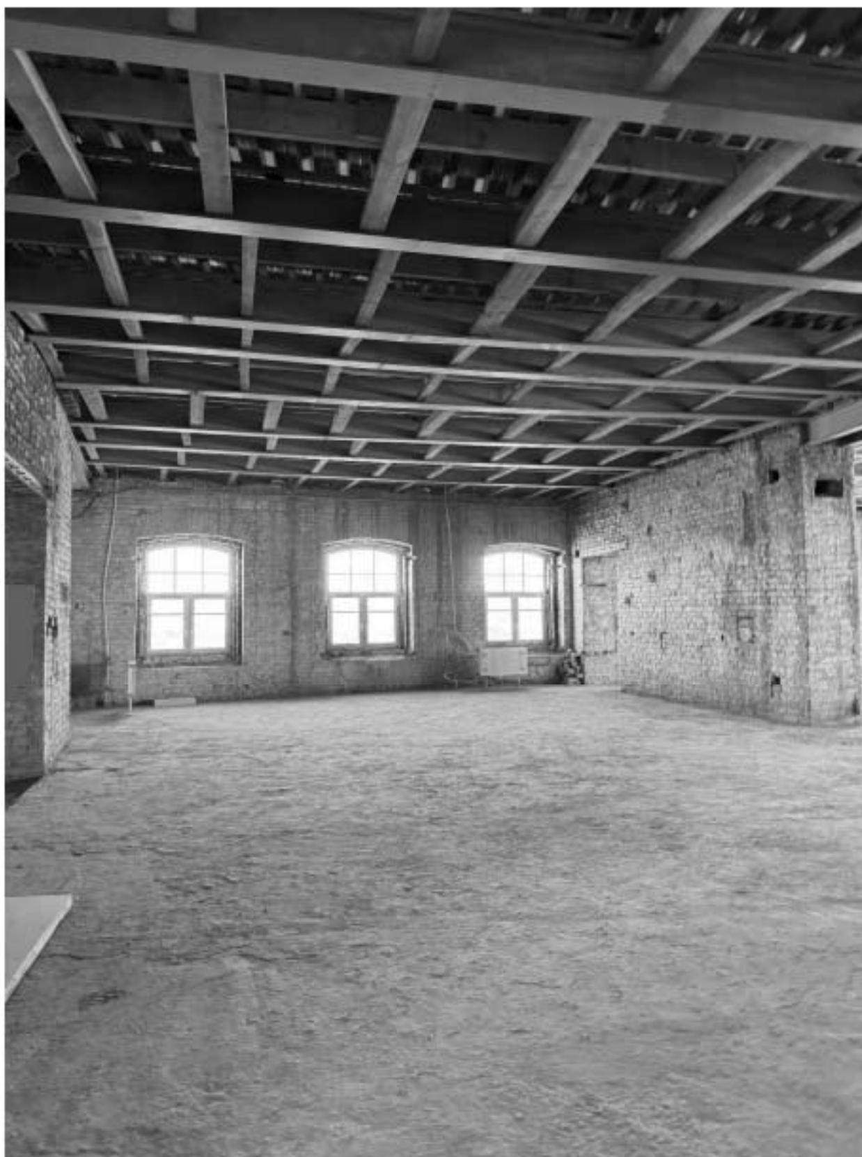
Фото 110. Вид на помещение квартиры № 53 объекта культурного наследия.
