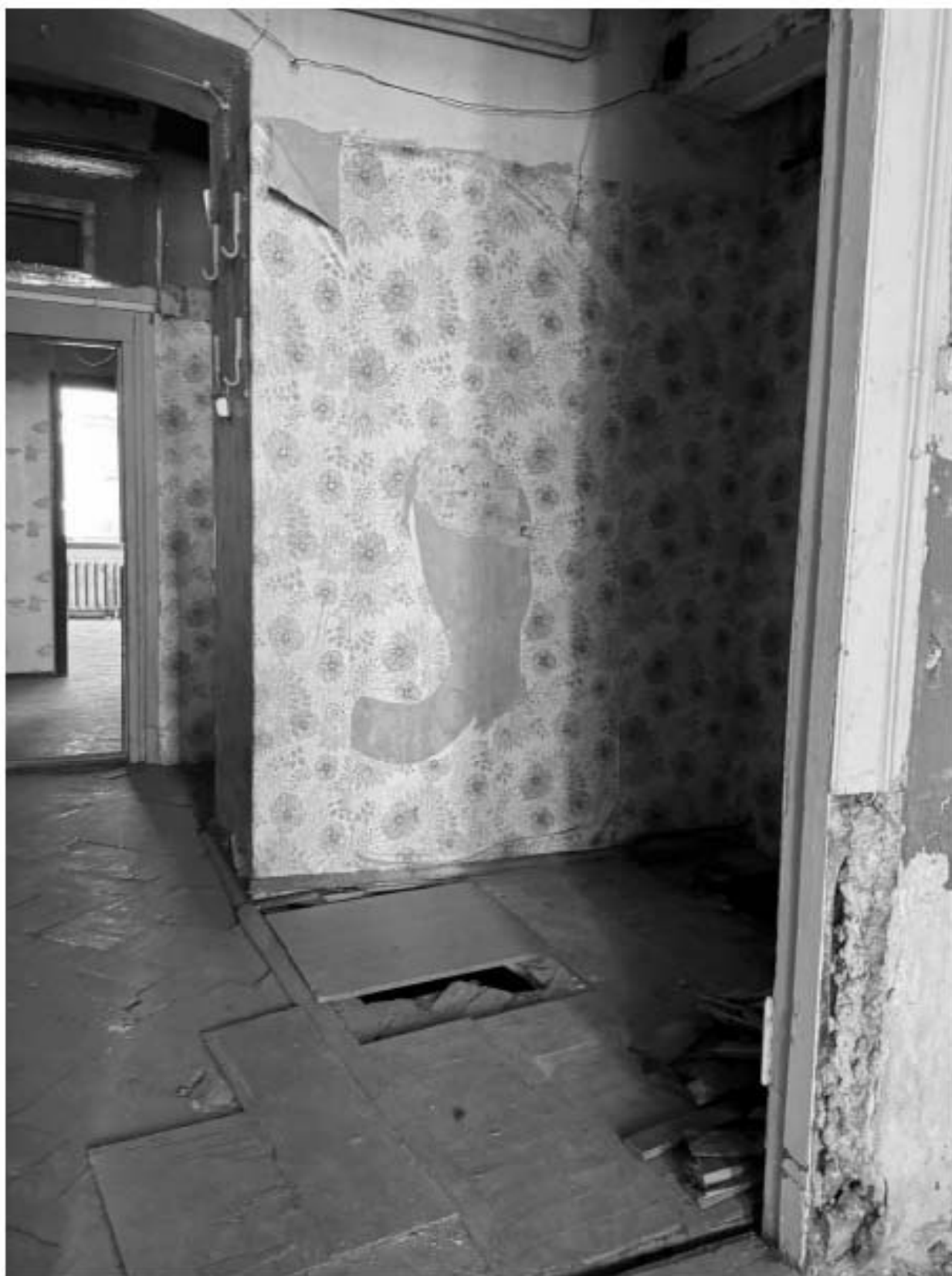
Фото 119. Вид на помещение квартиры № 16 объекта культурного наследия.
