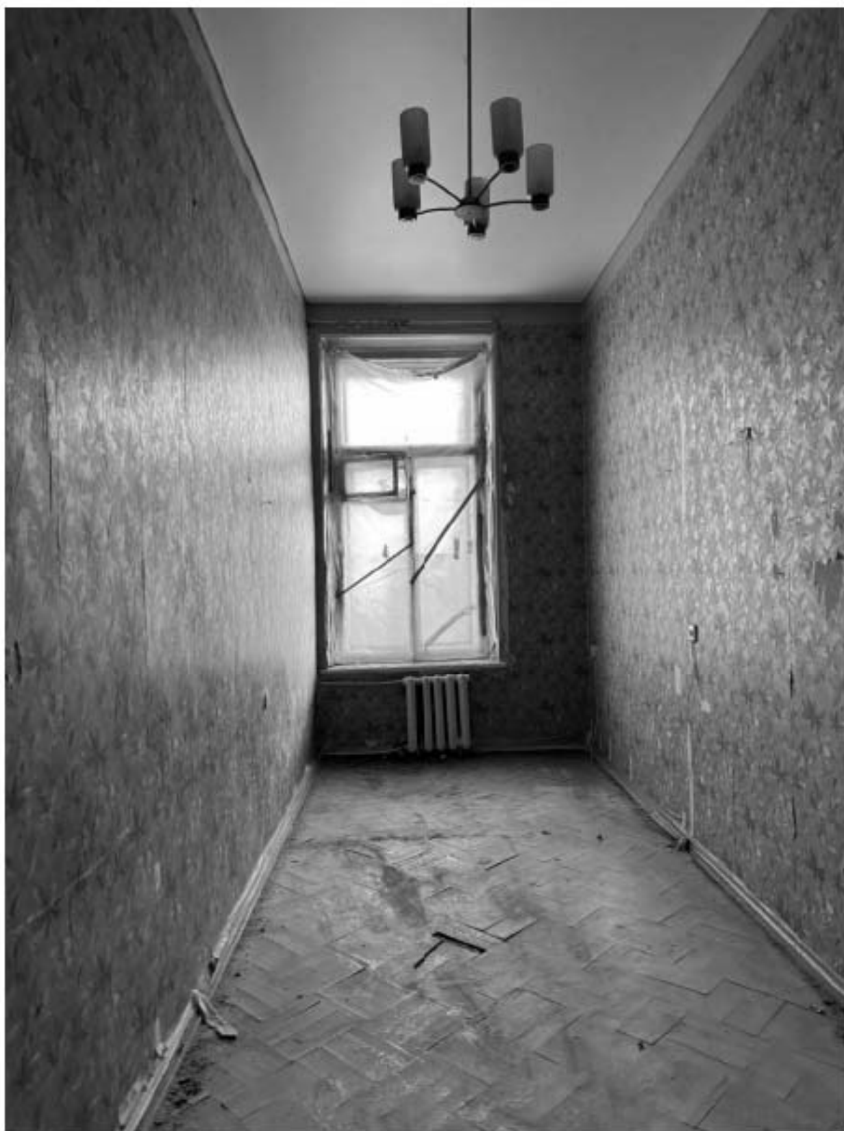
Фото 35. Вид на помещение квартиры № 17 объекта культурного наследия.
