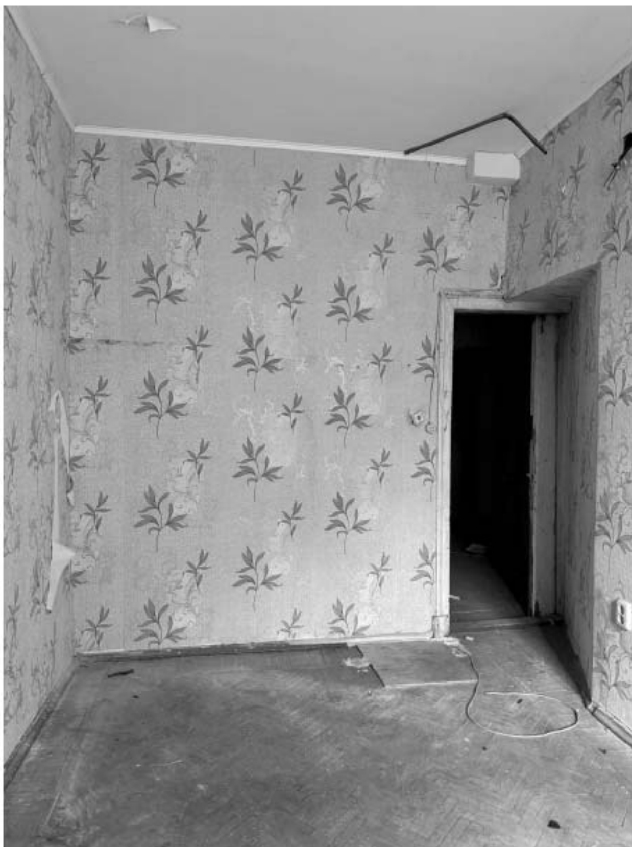
Фото 71. Вид на помещение квартиры № 11 объекта культурного наследия.
