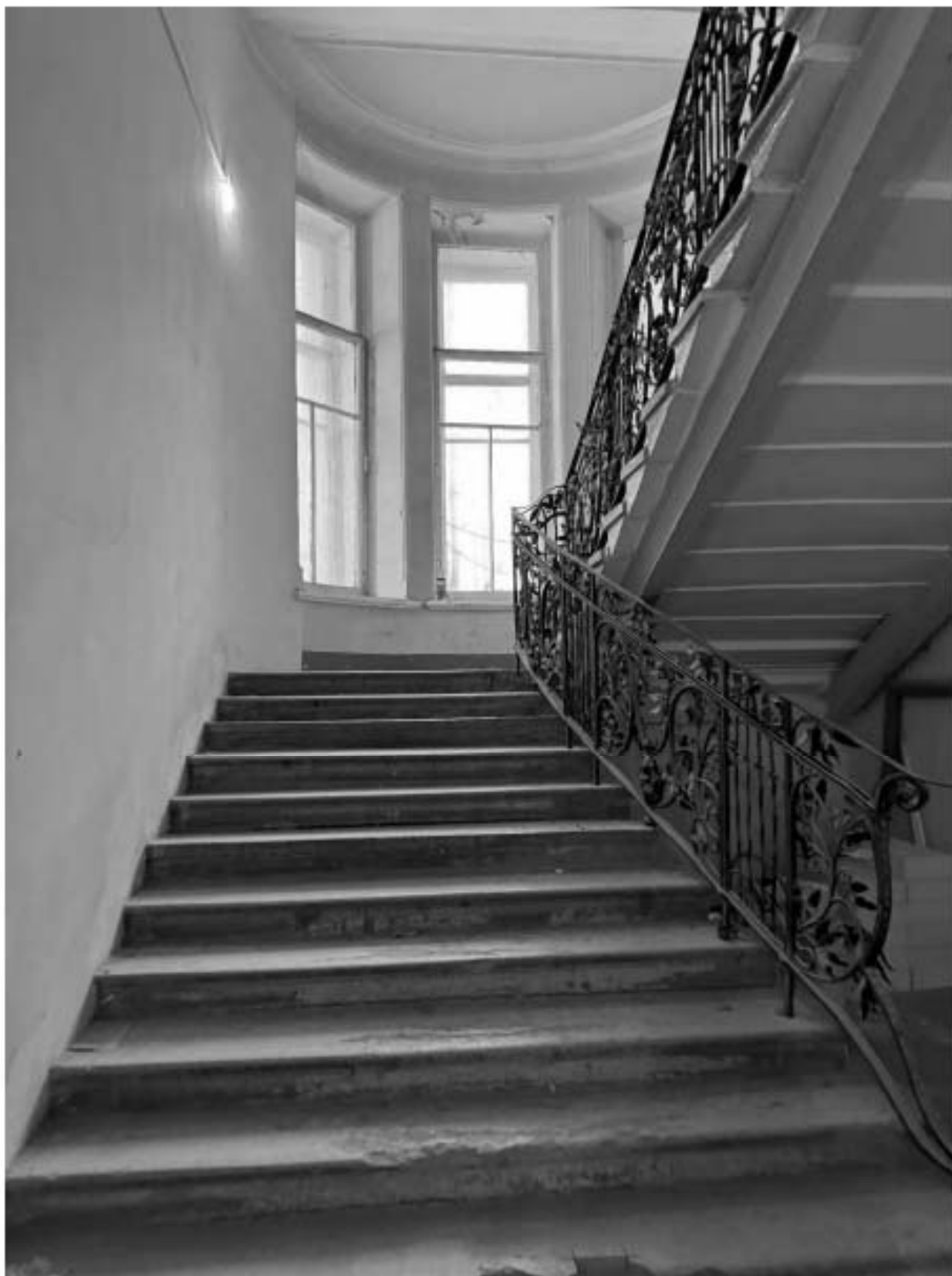
Фото 103. Вид на лестницу 4-ЛК объекта культурного наследия.
