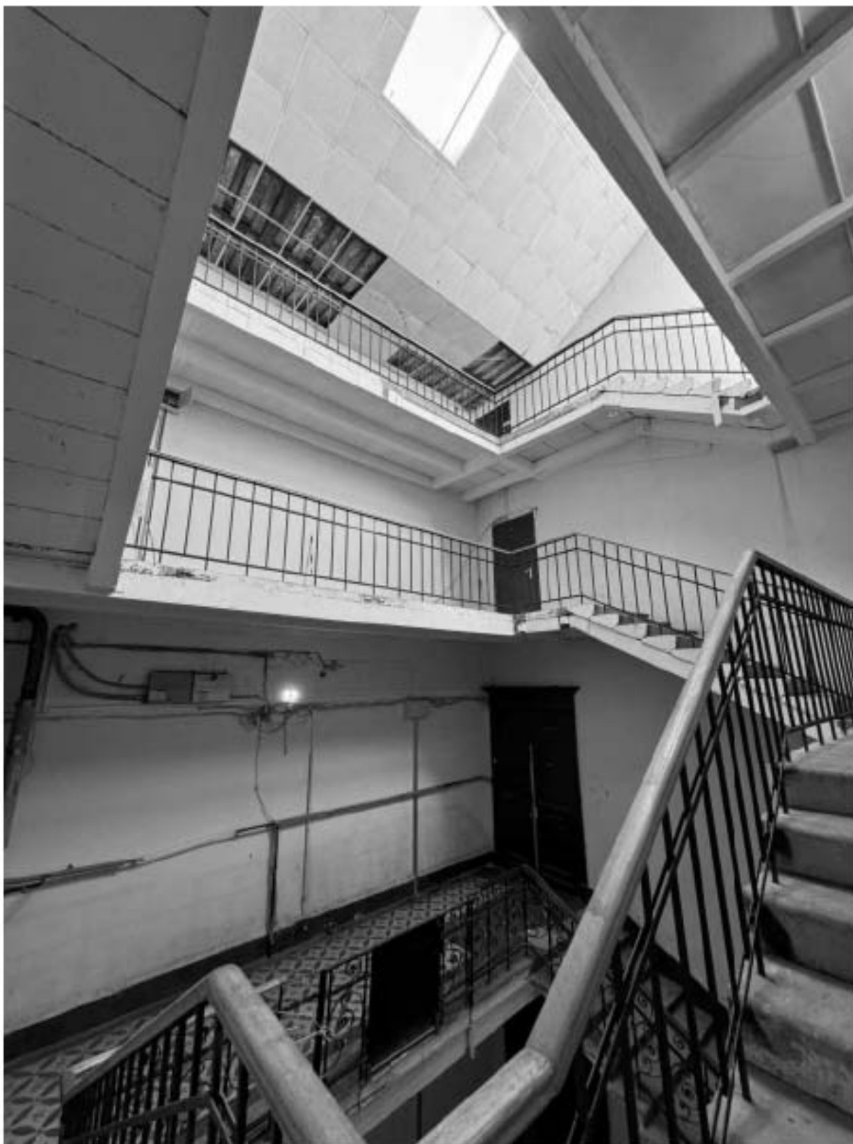
Фото 53. Вид на лестницу 1-ЛК объекта культурного наследия.
