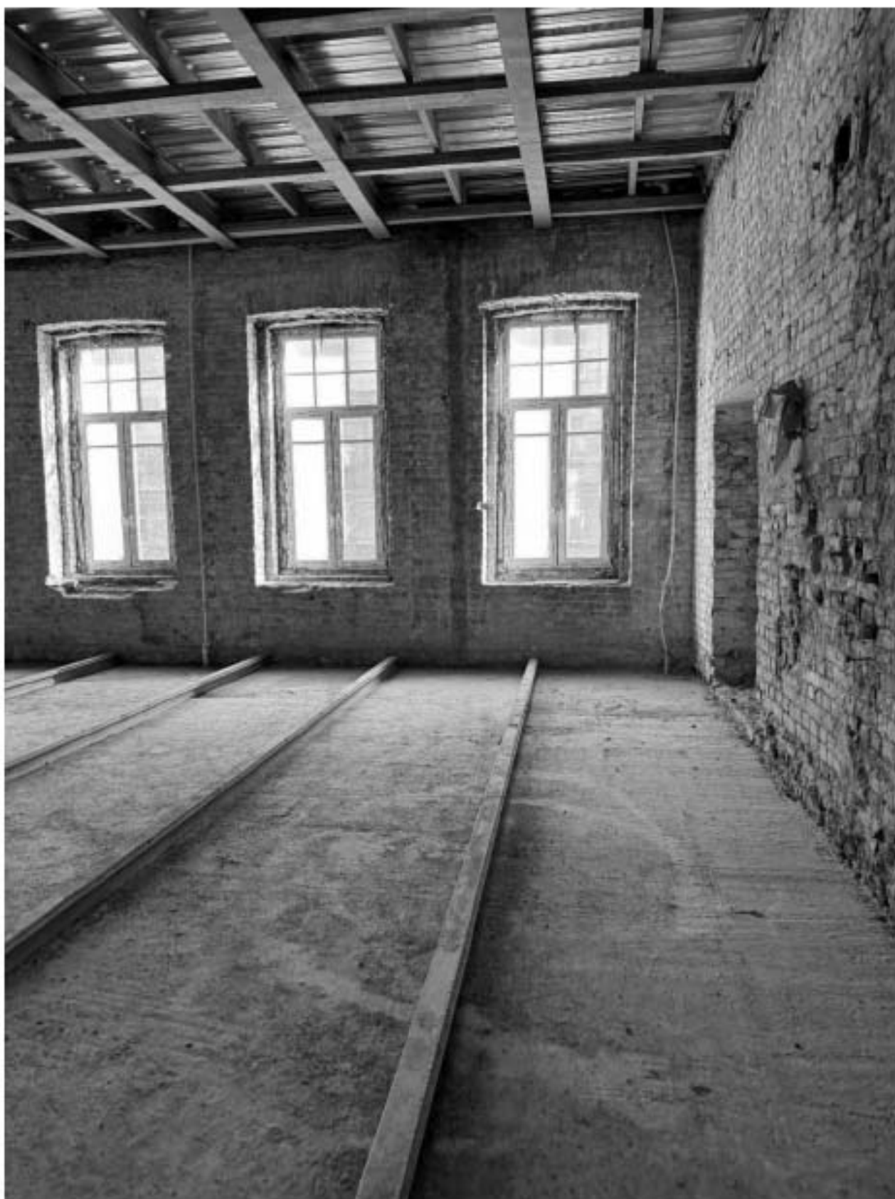
Фото 149. Вид на помещение квартиры № 50 объекта культурного наследия.
