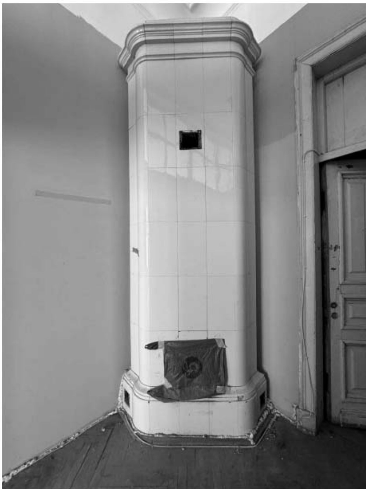
Фото 45. Вид на печь квартиры № 17 объекта культурного наследия.
