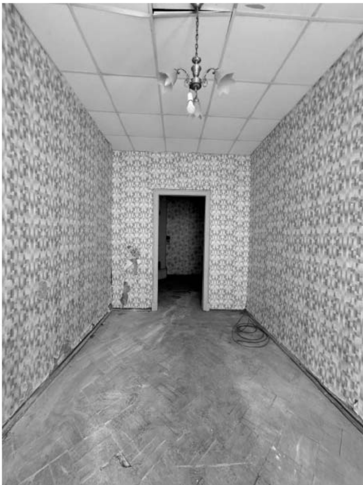
Фото 131. Вид помещения квартиры № 16 объекта культурного наследия.
