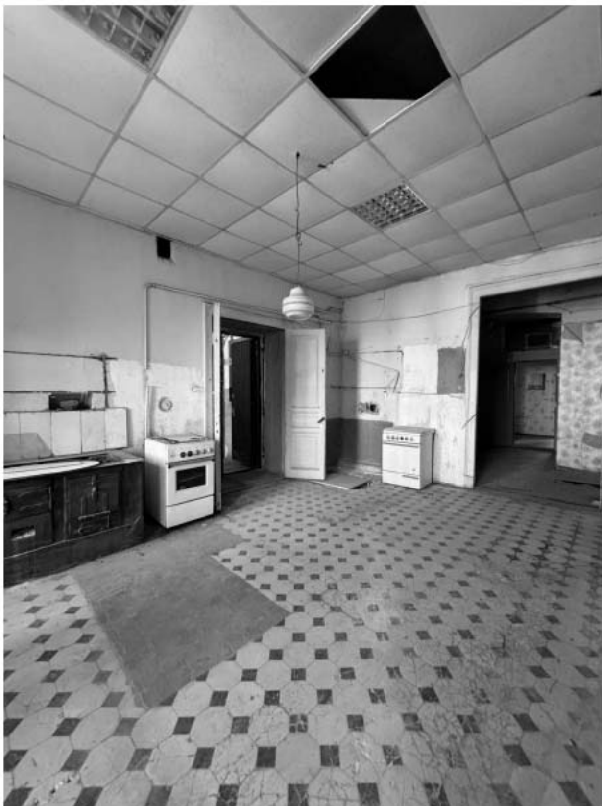
Фото 136. Вид на помещение квартиры № 16 объекта культурного наследия.
