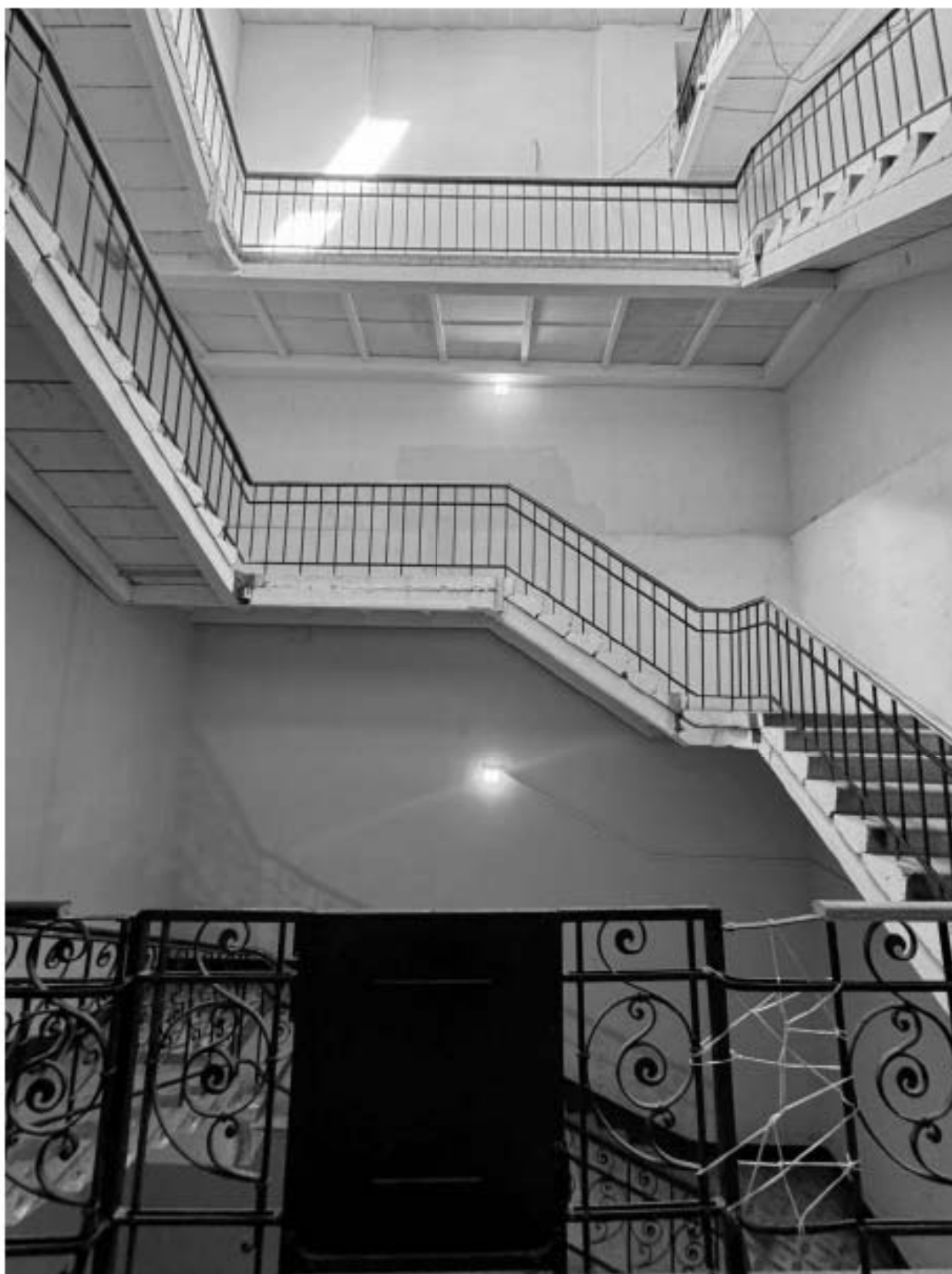
Фото 52. Вид на лестницу 1-ЛК объекта культурного наследия.
