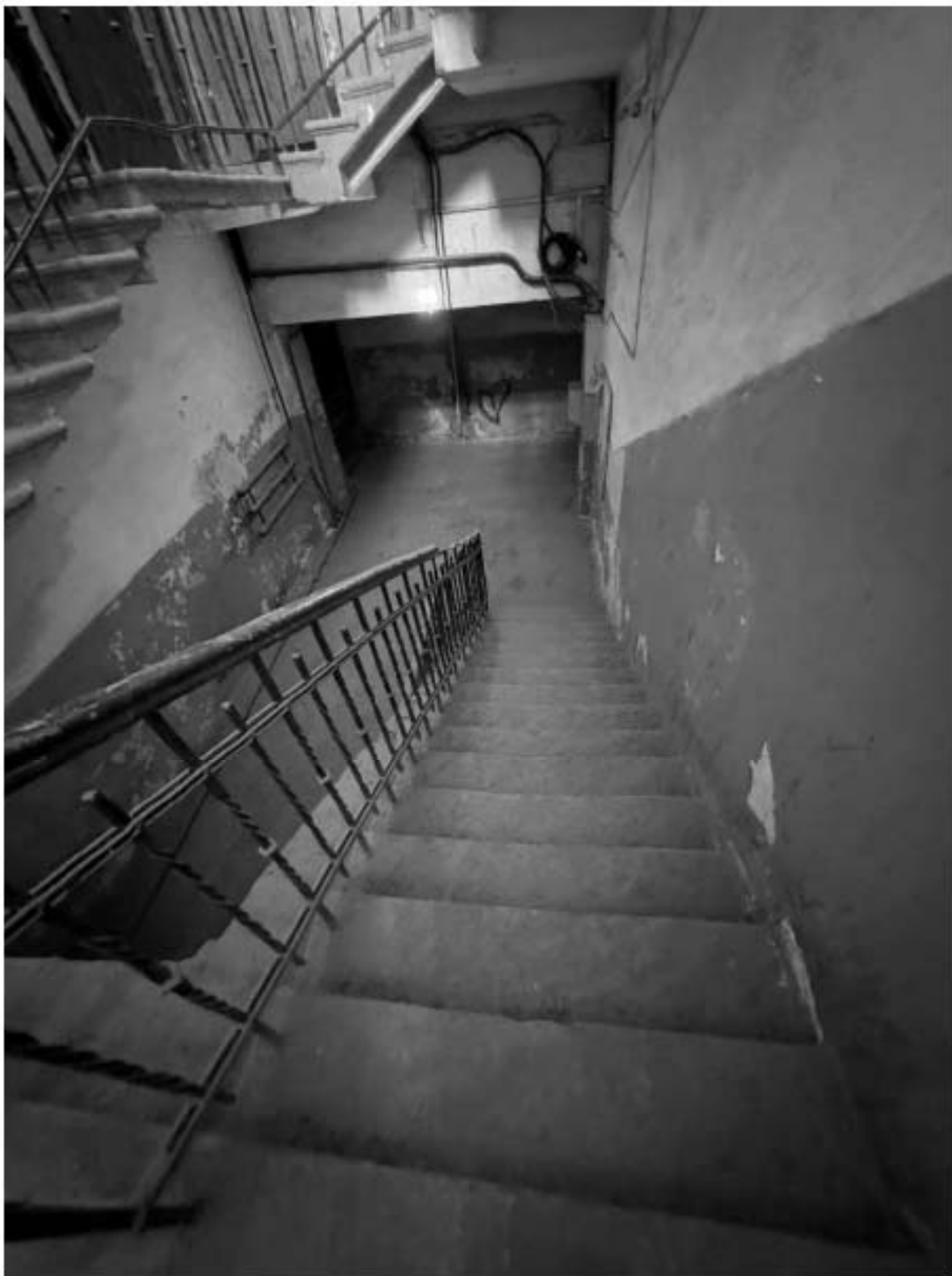
Фото 86. Вид на лестницу 5-ЛК объекта культурного наследия.
