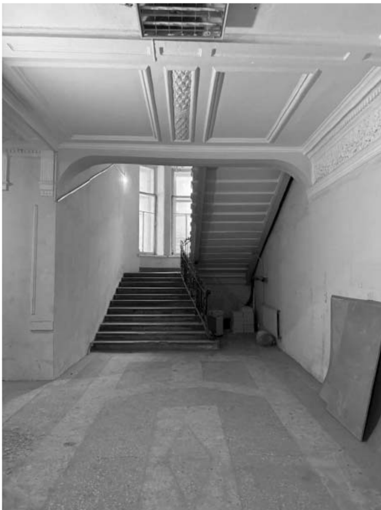
Фото 102. Вид на вестибюль и лестницу 4-ЛК объекта культурного наследия.
