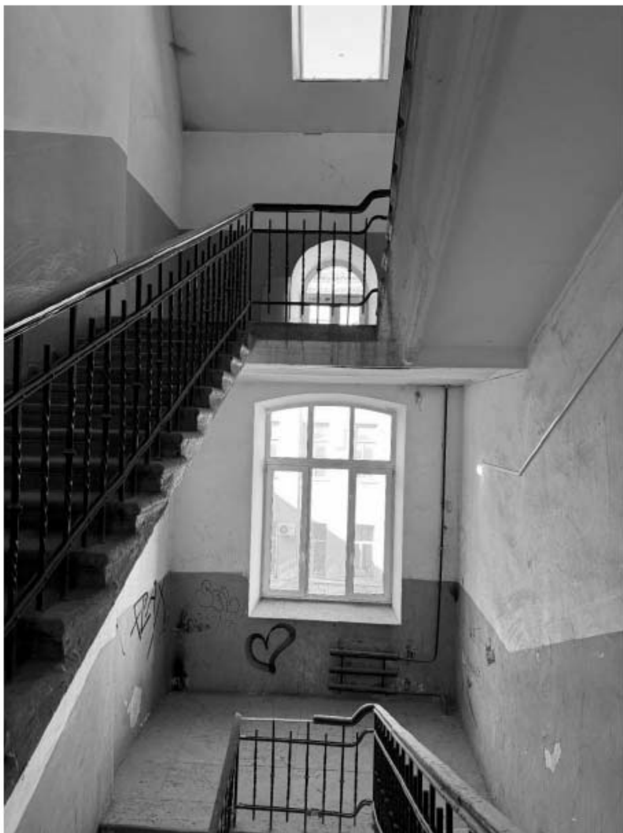
Фото 114. Вид на лестницу 5-ЛК объекта культурного наследия.
