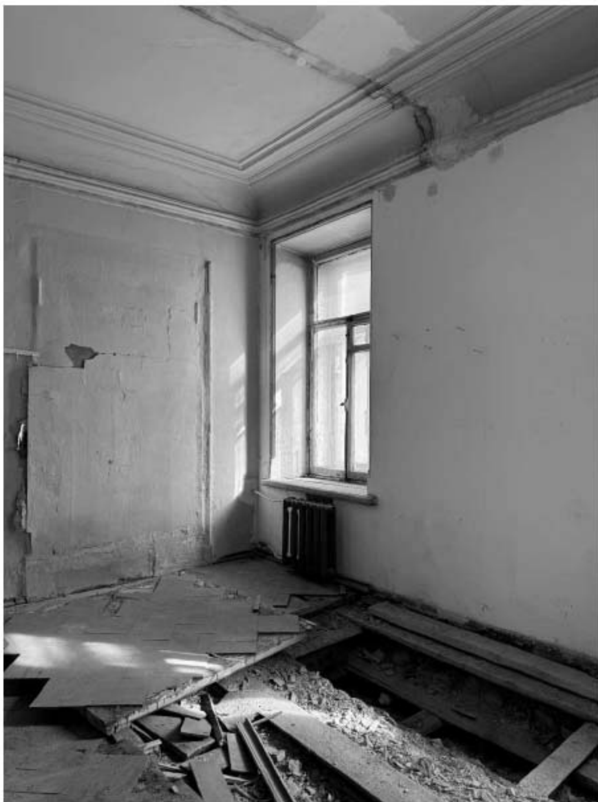
Фото 67. Вид на помещение квартиры № 11 объекта культурного наследия.
