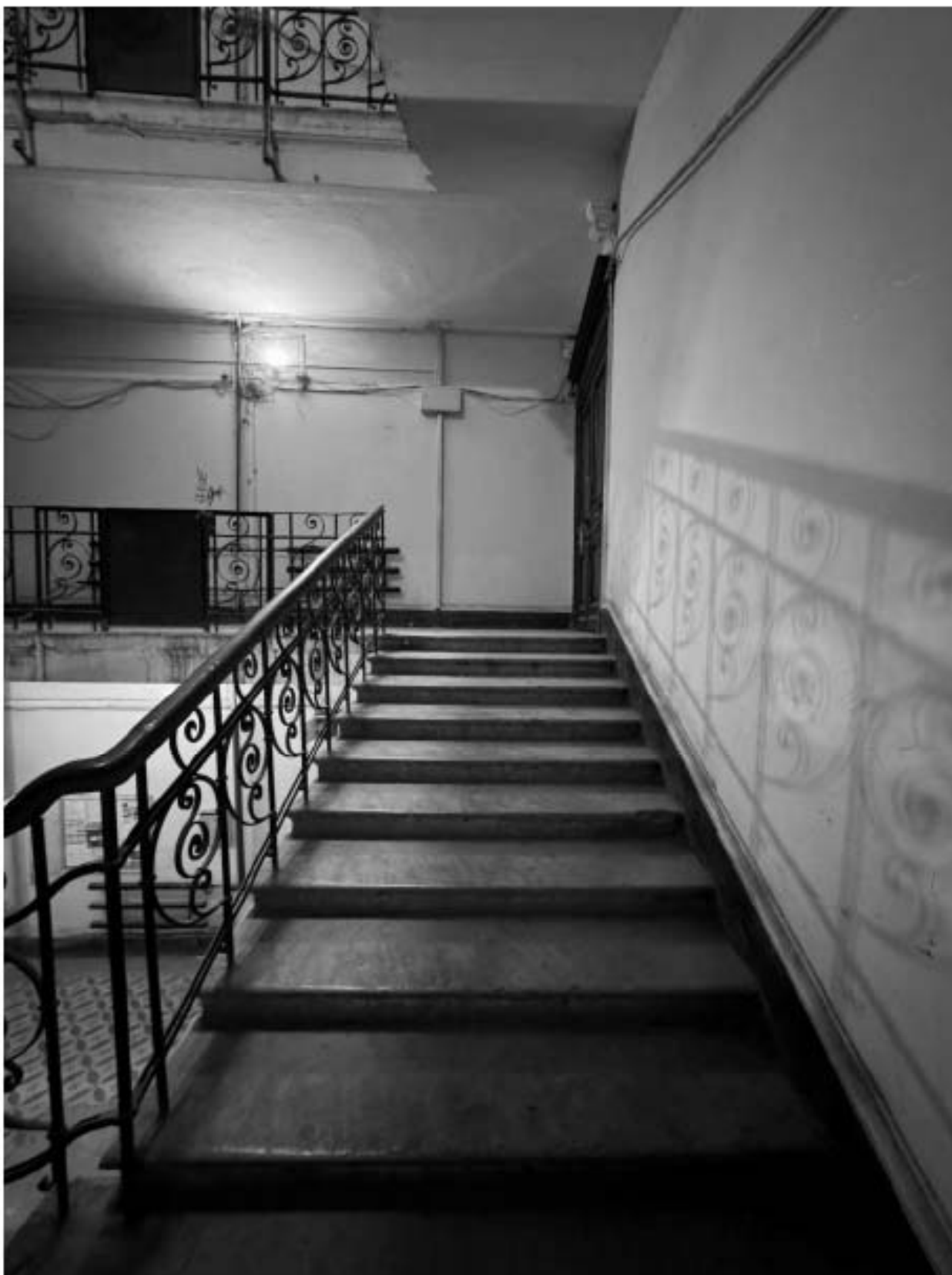
Фото 23. Вид на лестницу 1-ЛК объекта культурного наследия.
