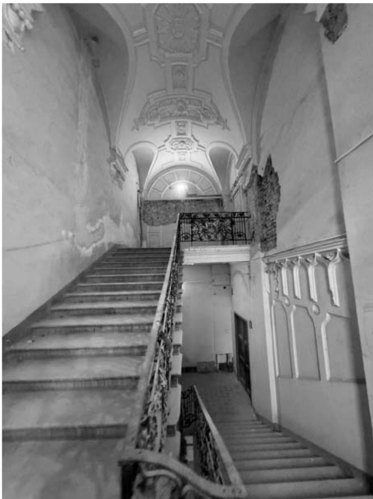
Фото 106. Вид на лестницу 4-ЛК объекта культурного наследия.
