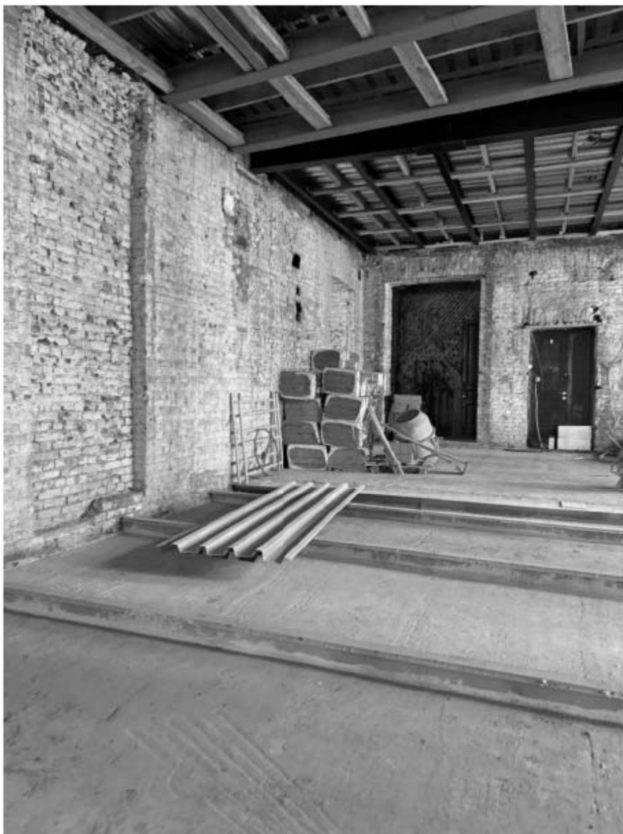
Фото 148. Вид на помещение квартиры № 52 объекта культурного наследия.
