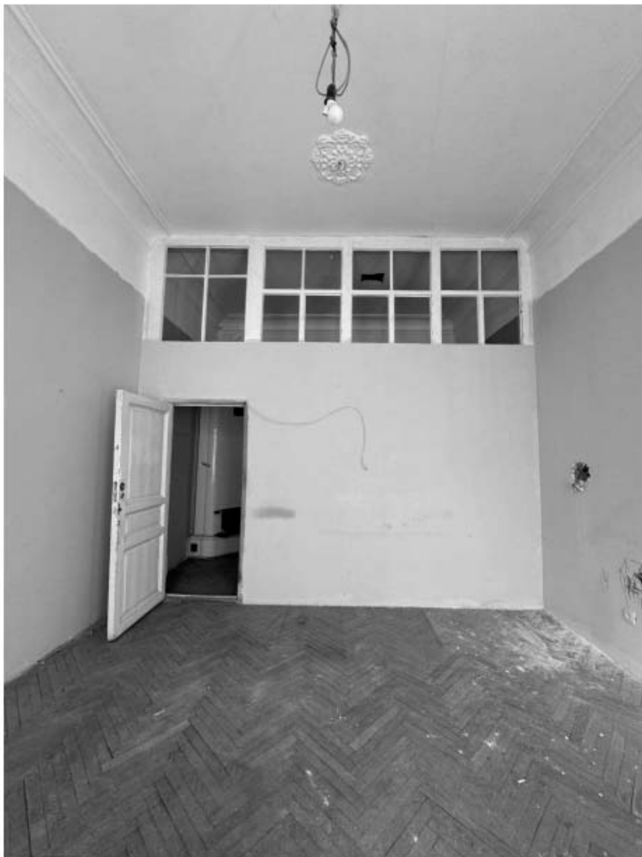
Фото 47. Вид на помещение квартиры № 17 объекта культурного наследия.
