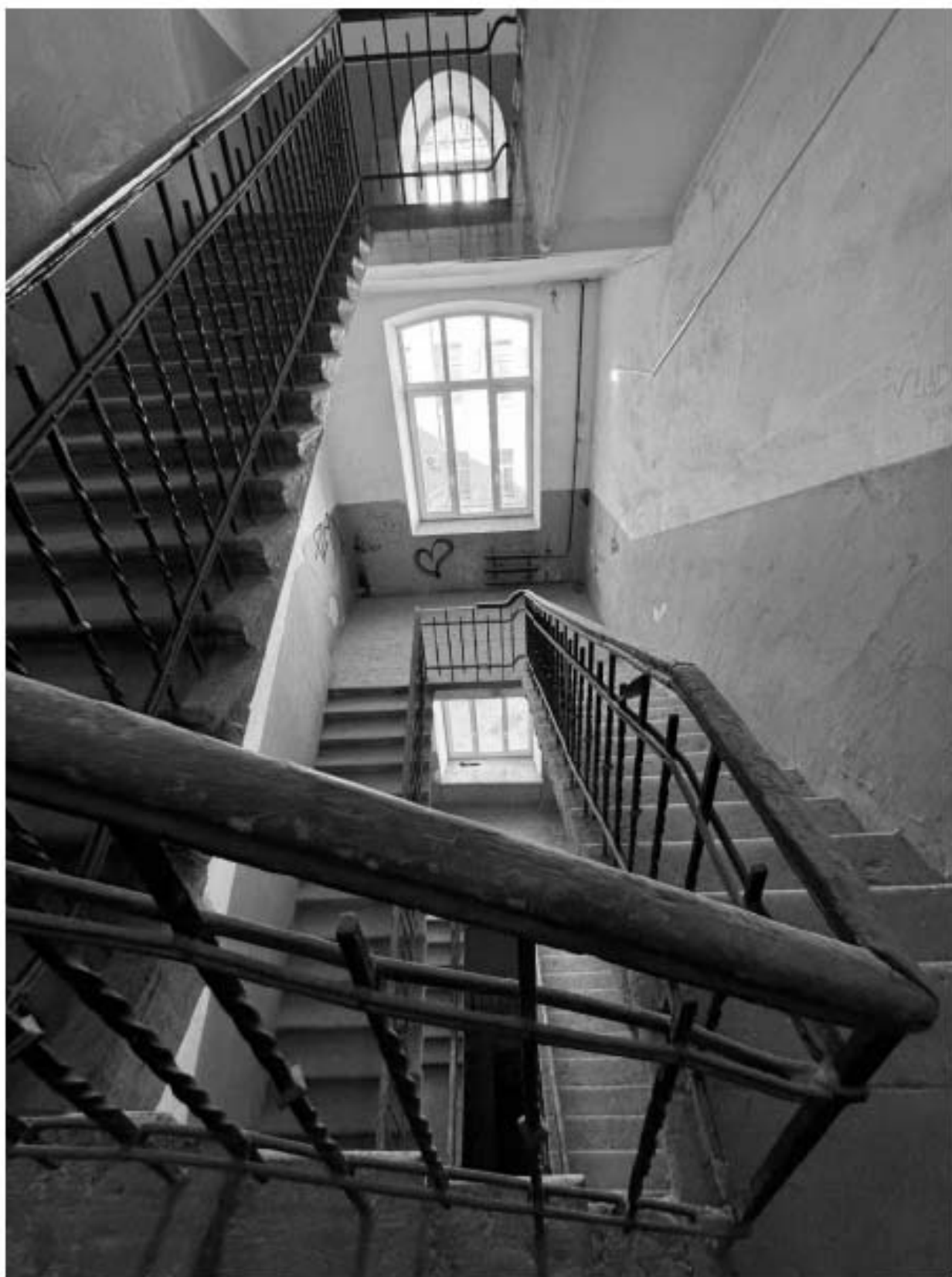
Фото 115. Вид на лестницу 5-ЛК объекта культурного наследия.
