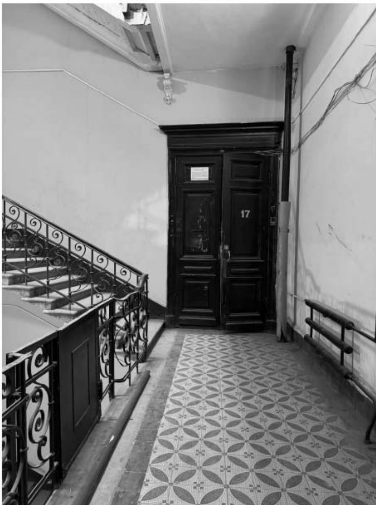
Фото 27. Вид на лестницу 1-ЛК объекта культурного наследия.
