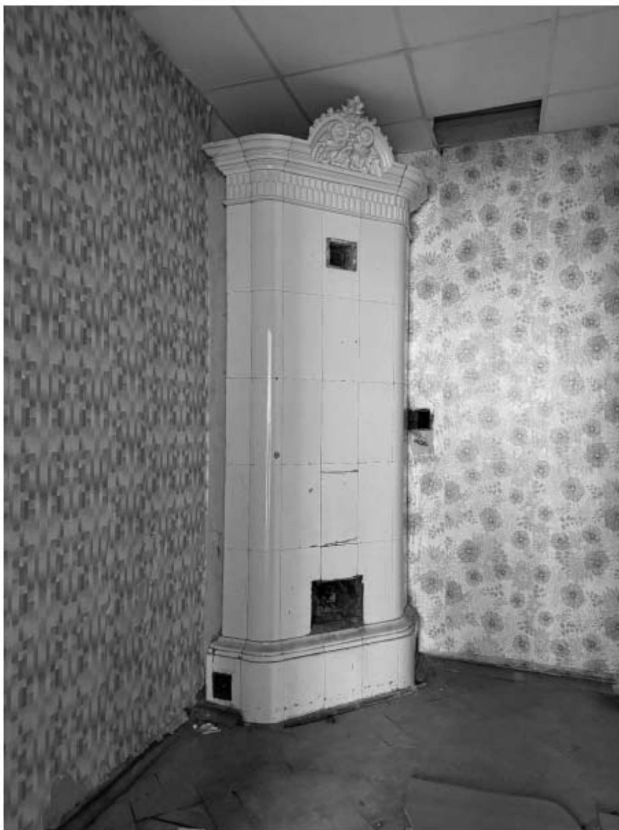
Фото 130. Вид печь квартиры № 16 объекта культурного наследия.
