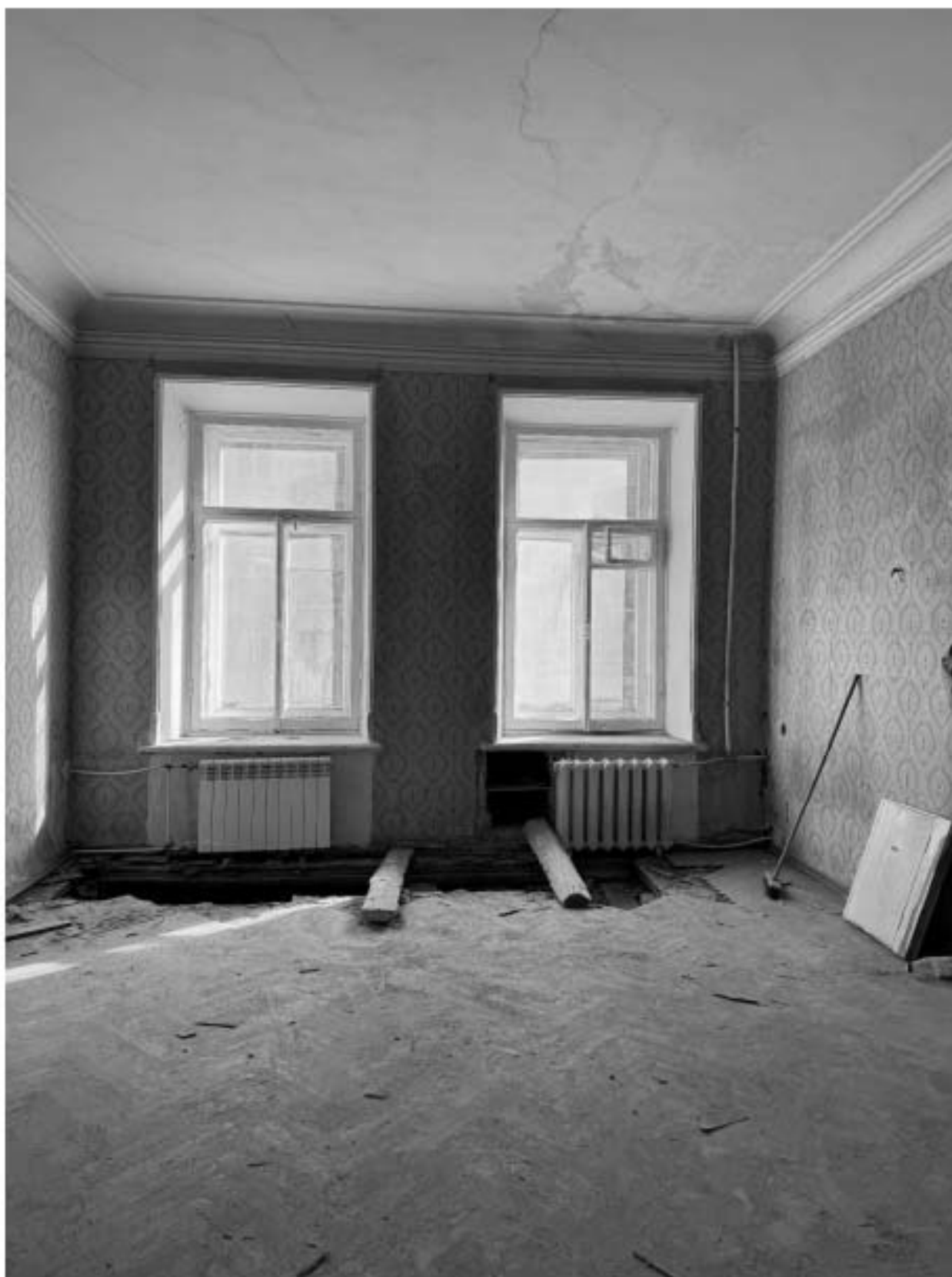
Фото 64. Вид на помещение квартиры № 11 объекта культурного наследия.
