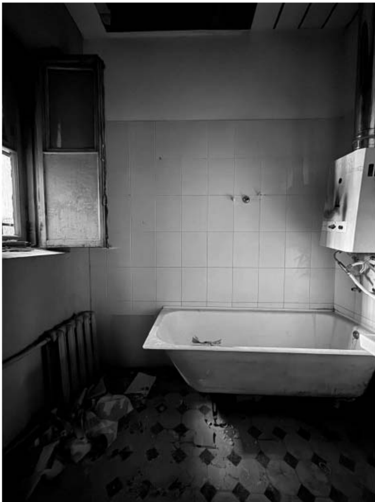
Фото 43. Вид на помещение квартиры № 17 объекта культурного наследия.
