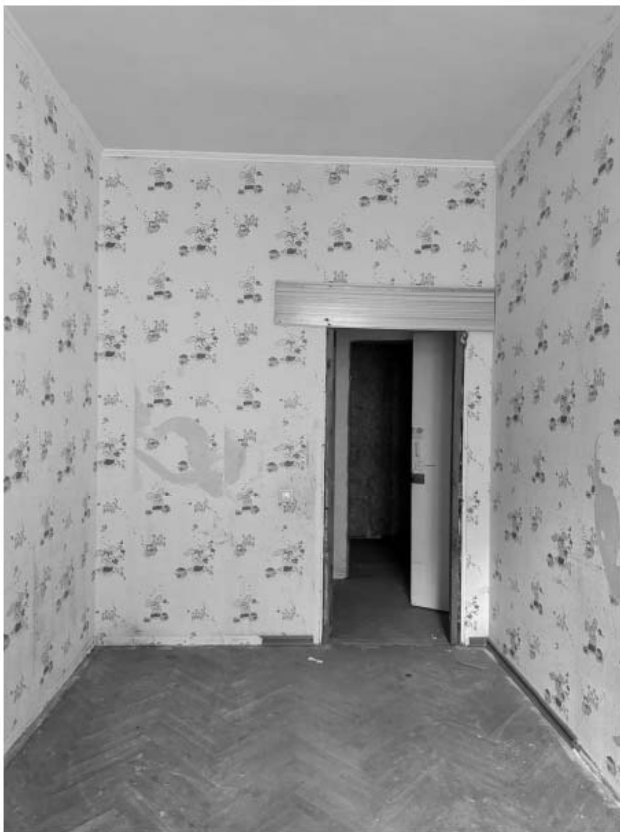
Фото 76. Вид на помещение квартиры № 11 объекта культурного наследия.
