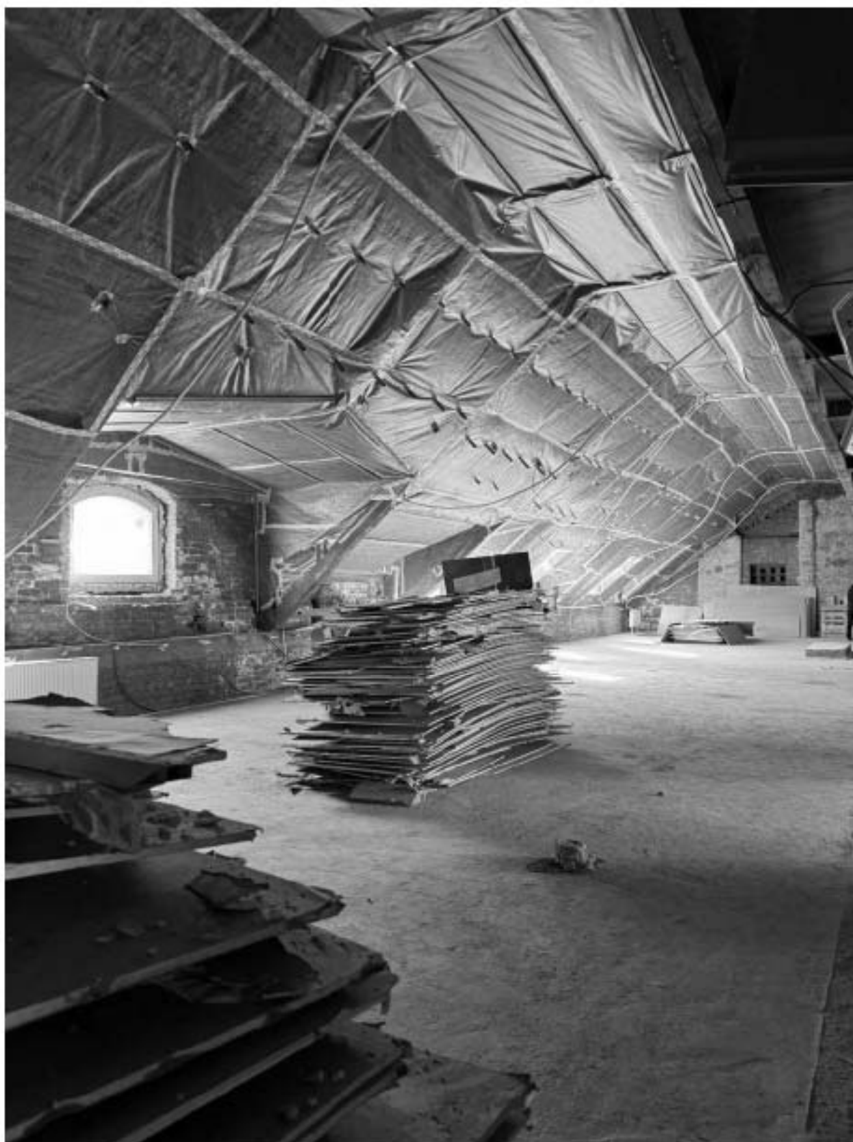
Фото 143. Вид на помещение квартиры № 56 объекта культурного наследия.
