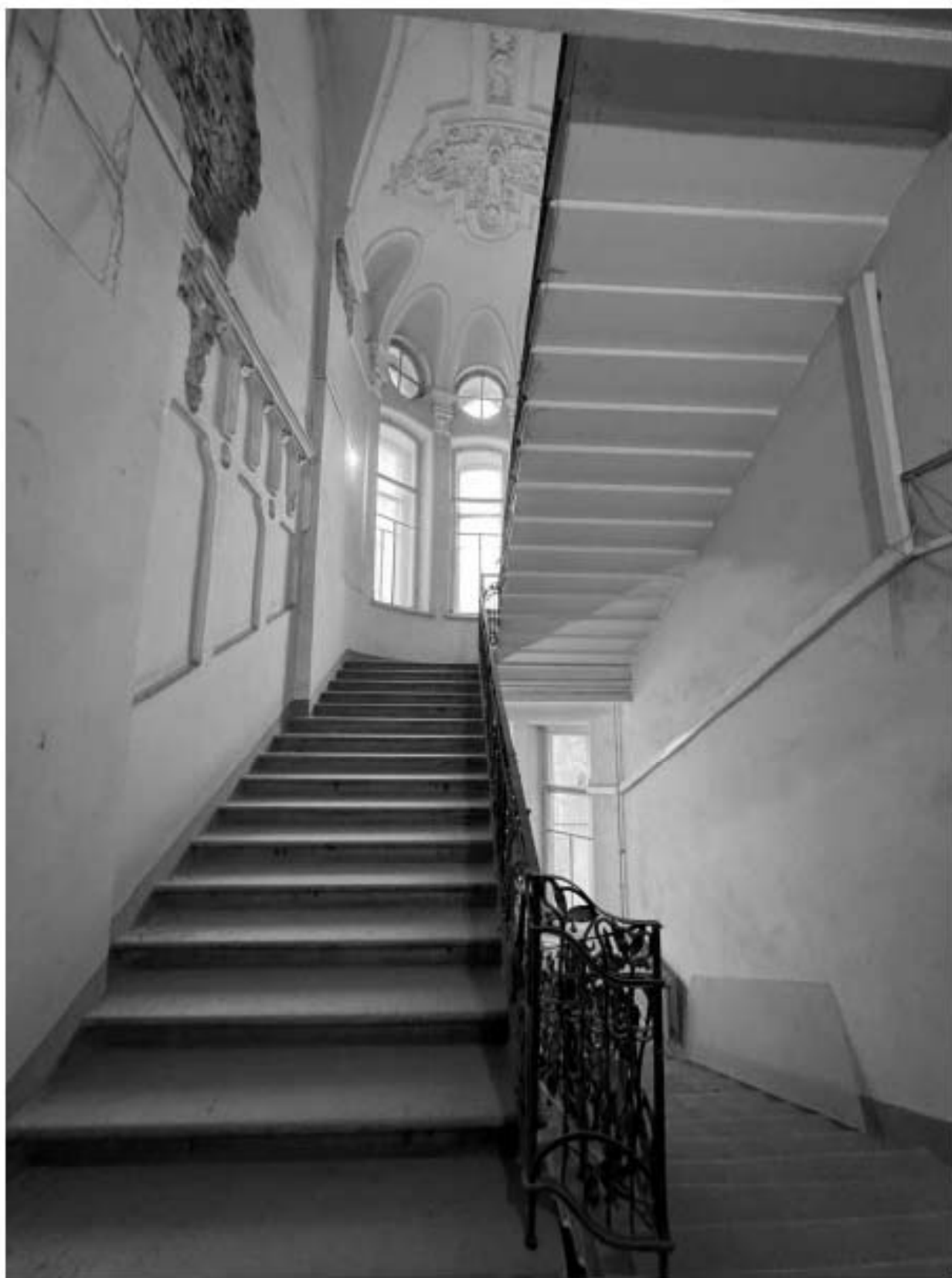
Фото 104. Вид на лестницу 4-ЛК объекта культурного наследия.
