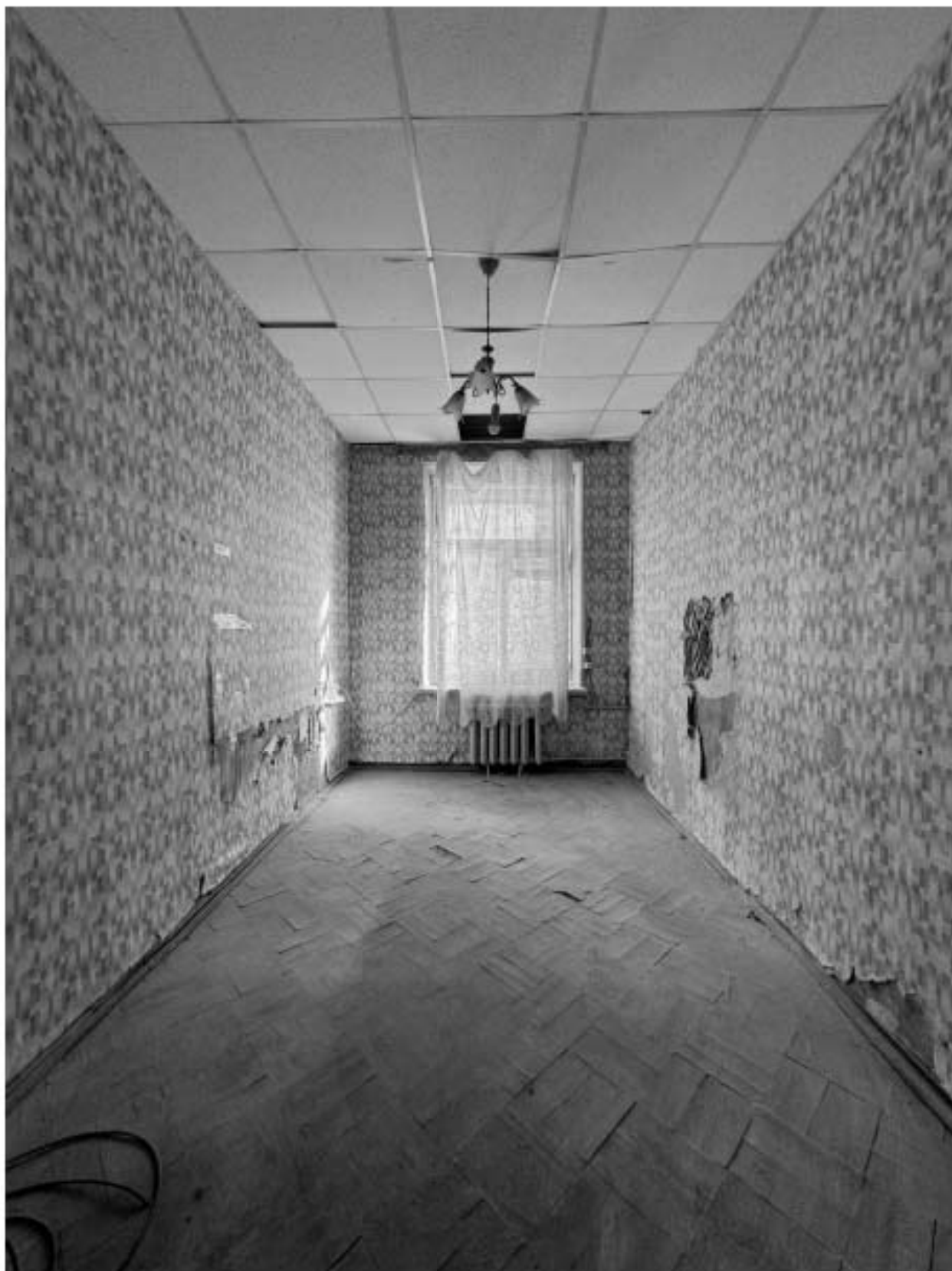
Фото 129. Вид на помещение квартиры № 16 объекта культурного наследия.
