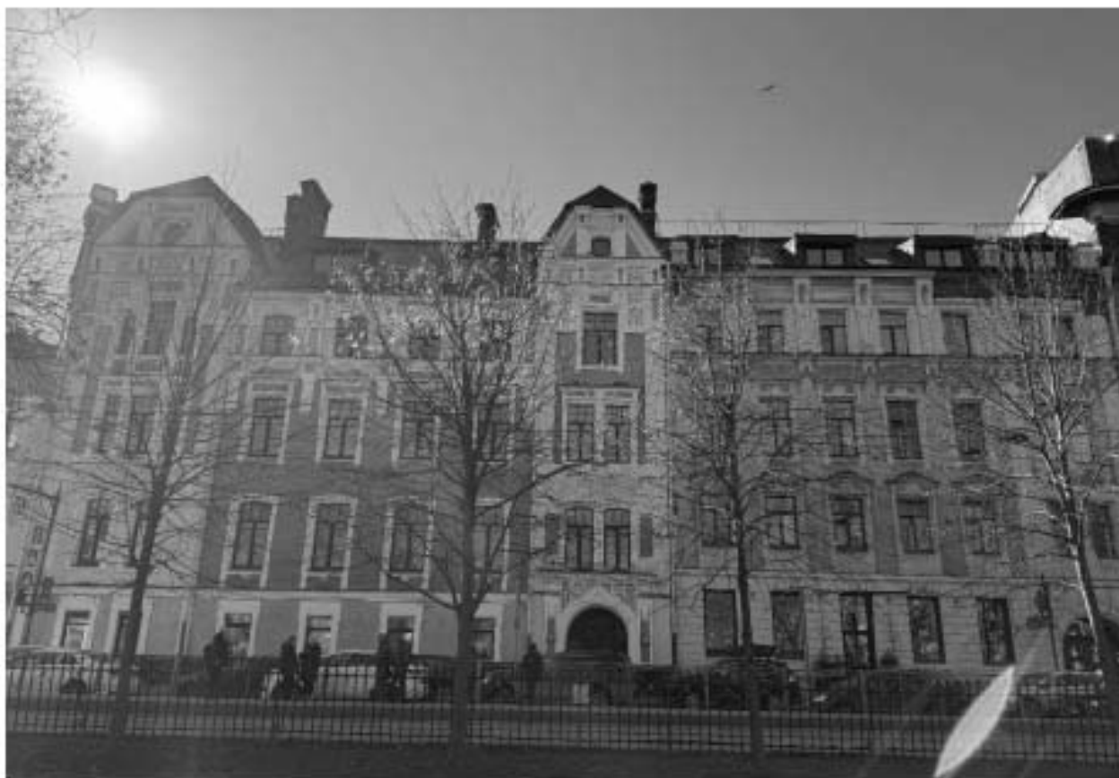
Фото 6. Общий вид фасадов объекта культурного наследия по Кронверкскому проспекту.
