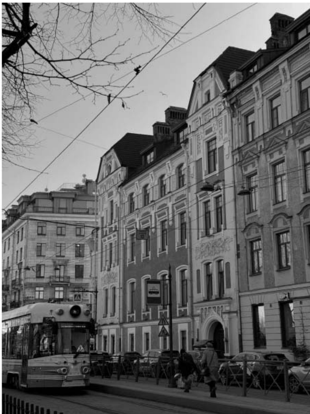
Фото 8. Фрагмент лицевого фасада объекта культурного наследия по Кронверкскому проспекту.
