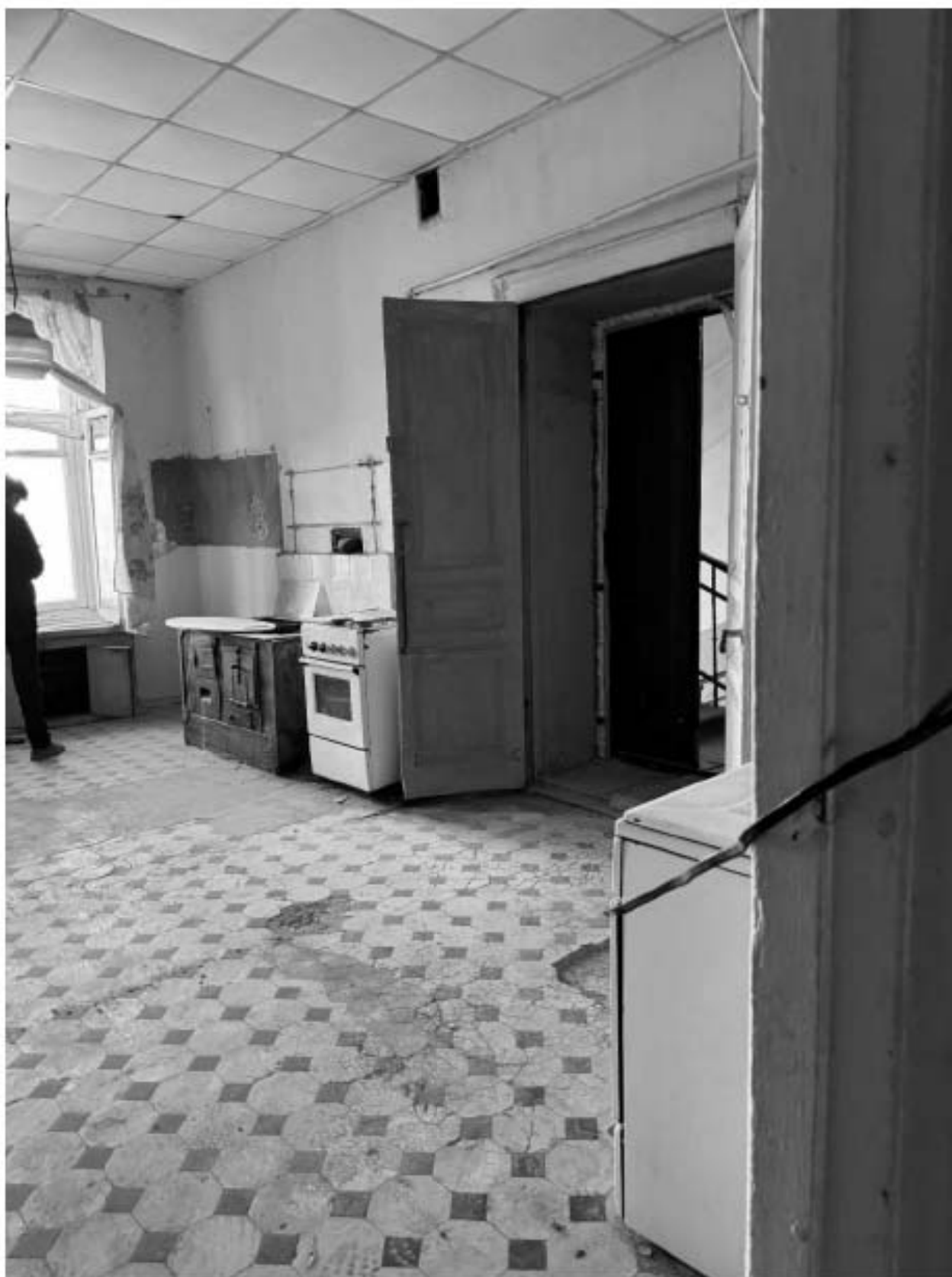
Фото 133. Вид помещения квартиры № 16 объекта культурного наследия.
