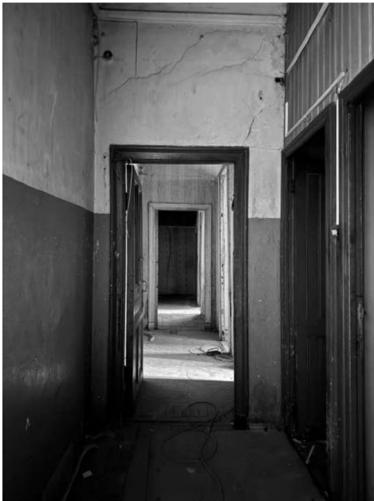
Фото 68. Вид на помещение квартиры № 11 объекта культурного наследия.
