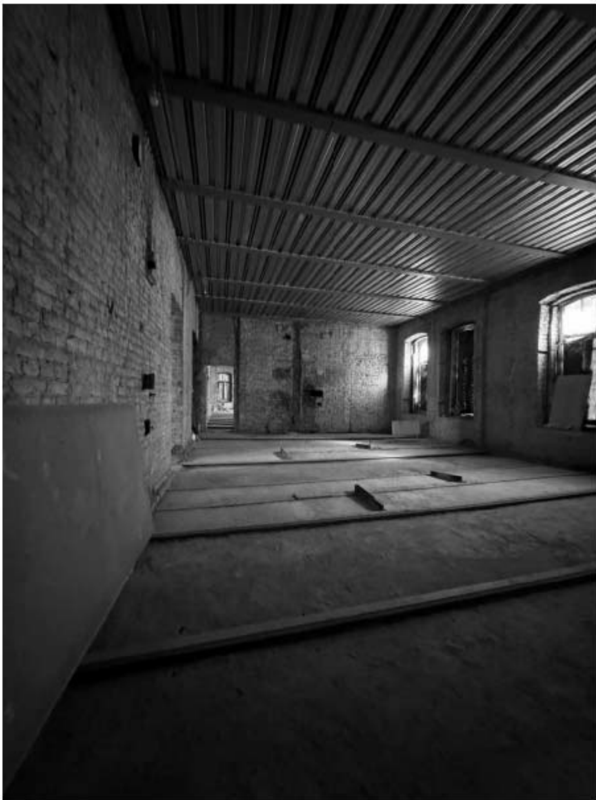
Фото 90. Вид на помещение квартиры № 10 объекта культурного наследия.
