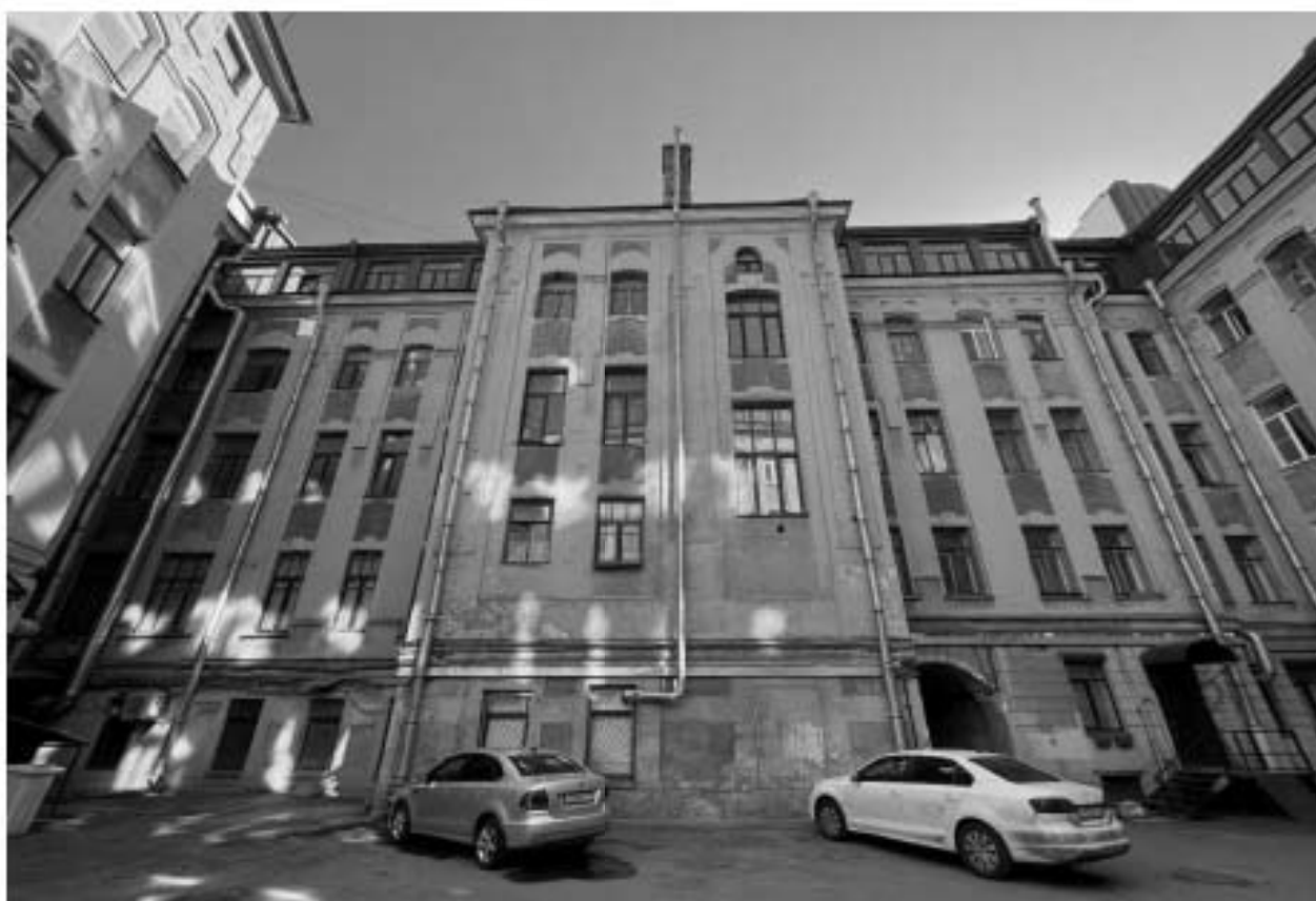
Фото 13. Общий вид дворовых фасадов объекта культурного наследия.
