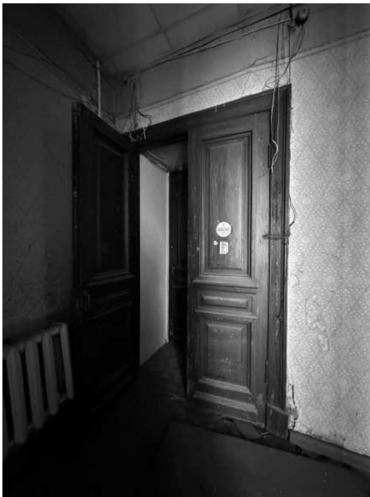
Фото 82. Вид на дверное заполнение квартиры № 11 объекта культурного наследия.
