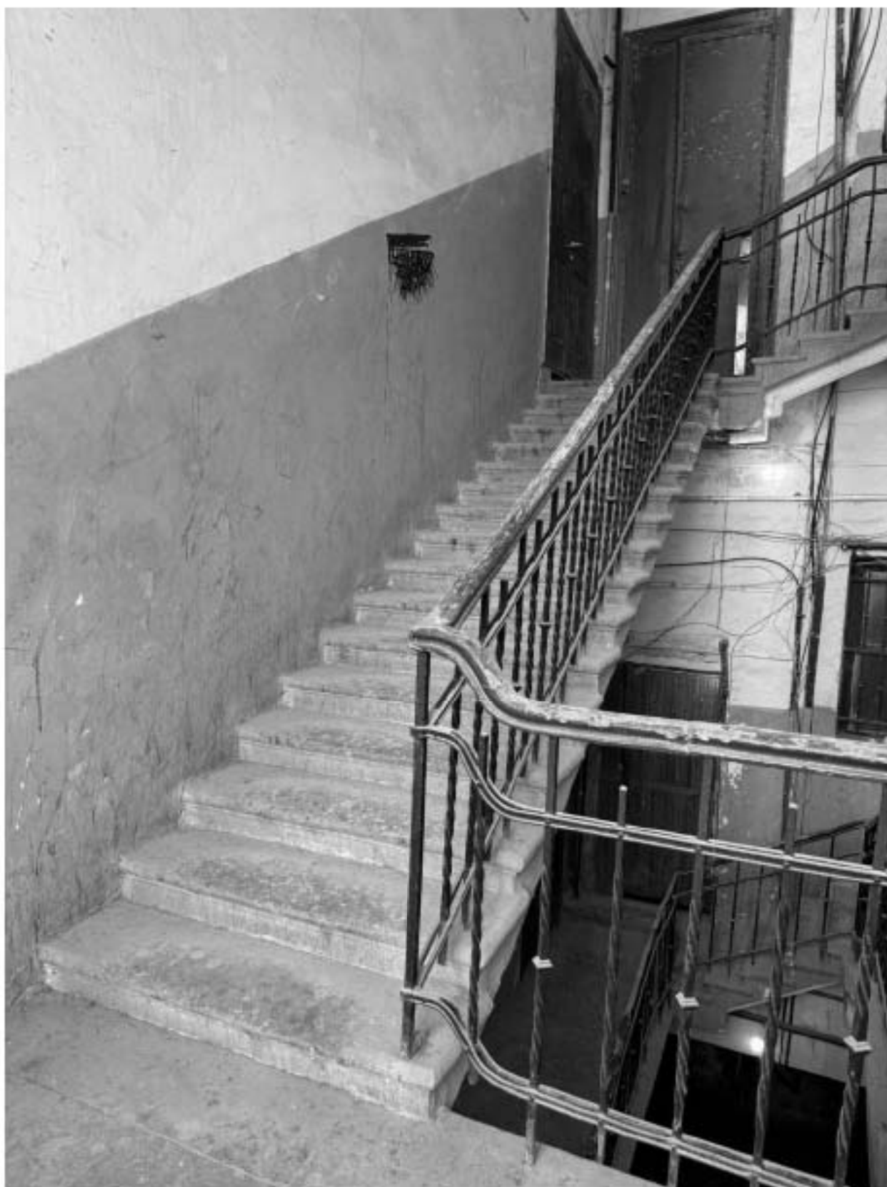
Фото 56. Вид на лестницу 5-ЛК объекта культурного наследия.
