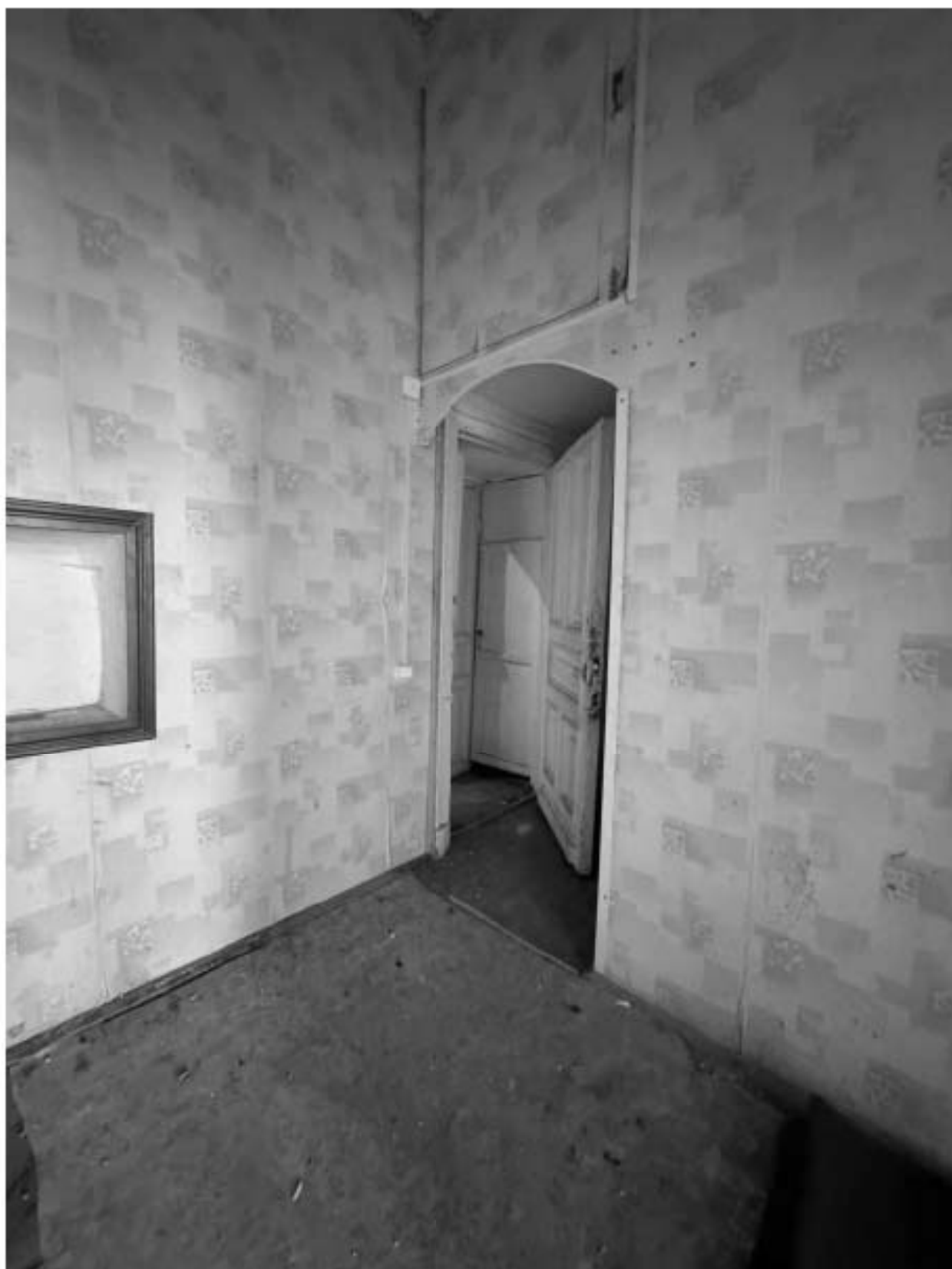
Фото 39. Вид на помещение квартиры № 17 объекта культурного наследия.
