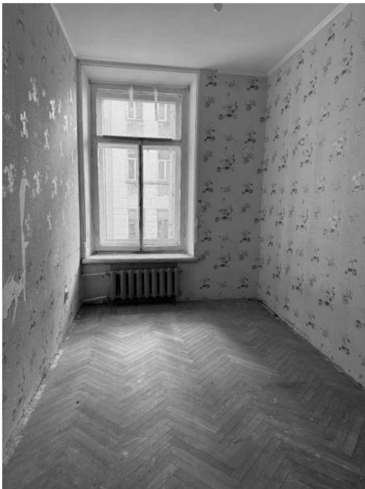
Фото 75. Вид на помещение квартиры № 11 объекта культурного наследия.
