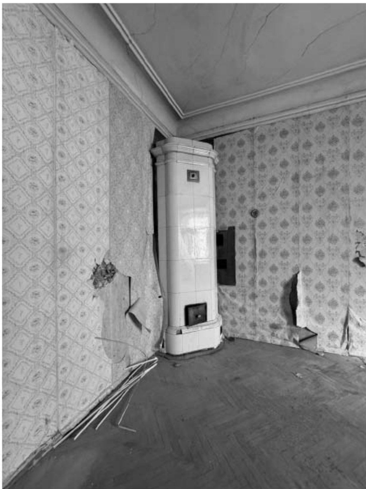
Фото 61. Вид на помещение квартиры № 11 объекта культурного наследия.
