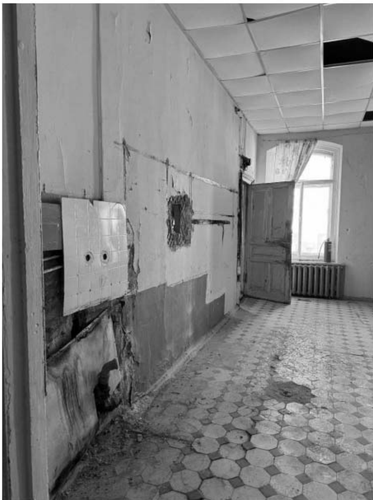
Фото 132. Вид помещения квартиры № 16 объекта культурного наследия.
