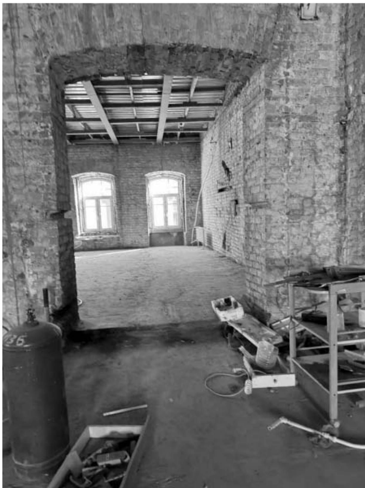
Фото 113. Вид на помещение квартиры № 15 объекта культурного наследия.
