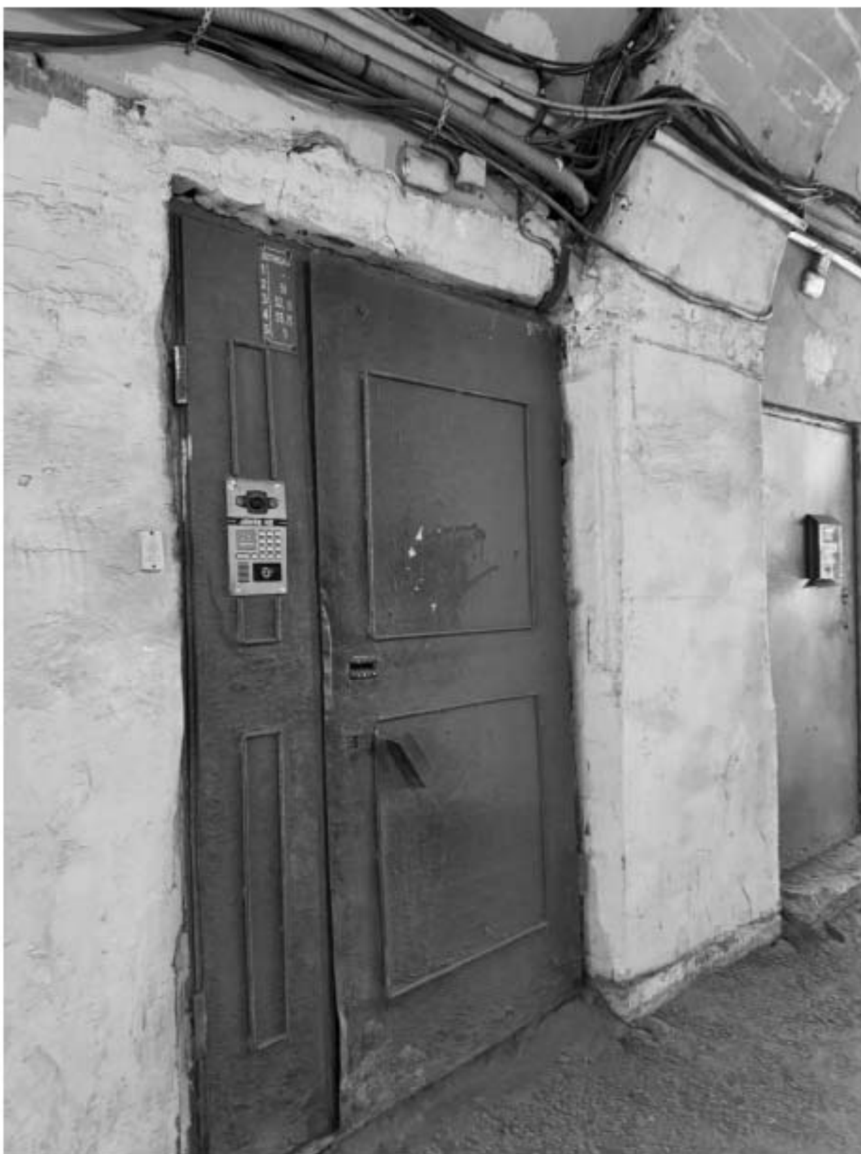
Фото 17. Вид на дверное заполнение, ведущее к лестнице 5-ЛК, объекта культурного наследия.
