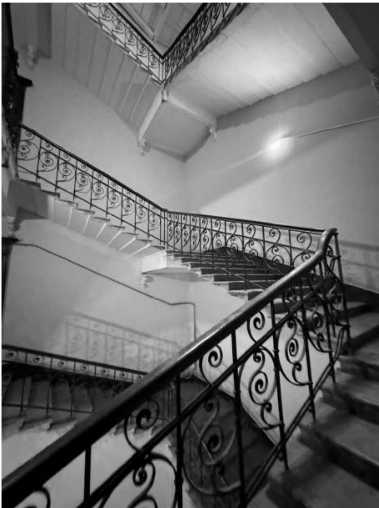
Фото 25. Вид на лестницу 1-ЛК объекта культурного наследия.
