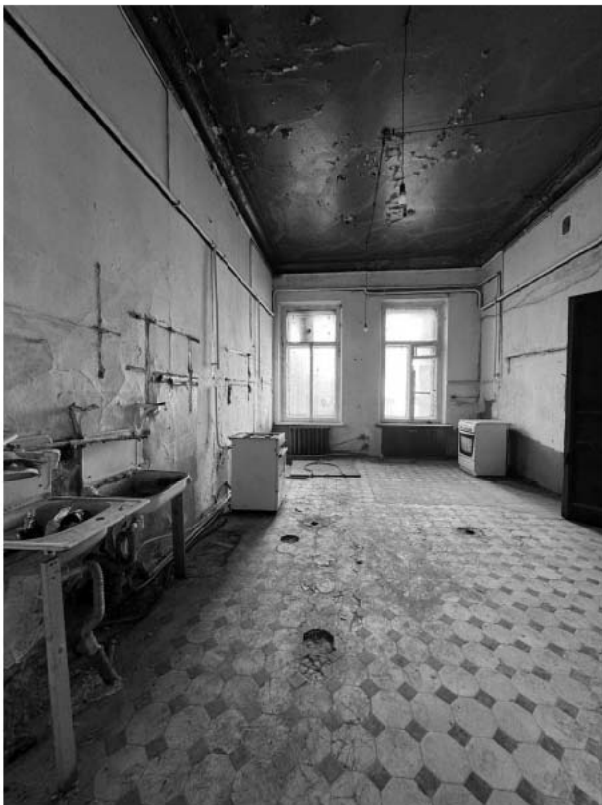
Фото 41. Вид на помещение квартиры № 17 объекта культурного наследия.
