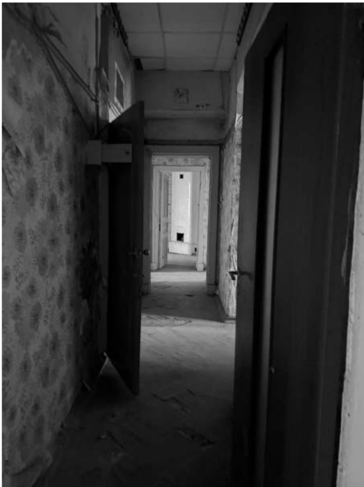
Фото 122. Вид на помещение квартиры № 16 объекта культурного наследия.
