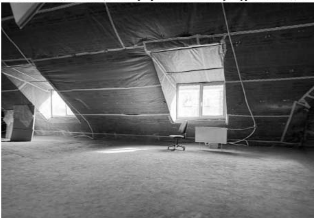
Фото 141. Вид на помещение квартиры № 58 объекта культурного наследия.
