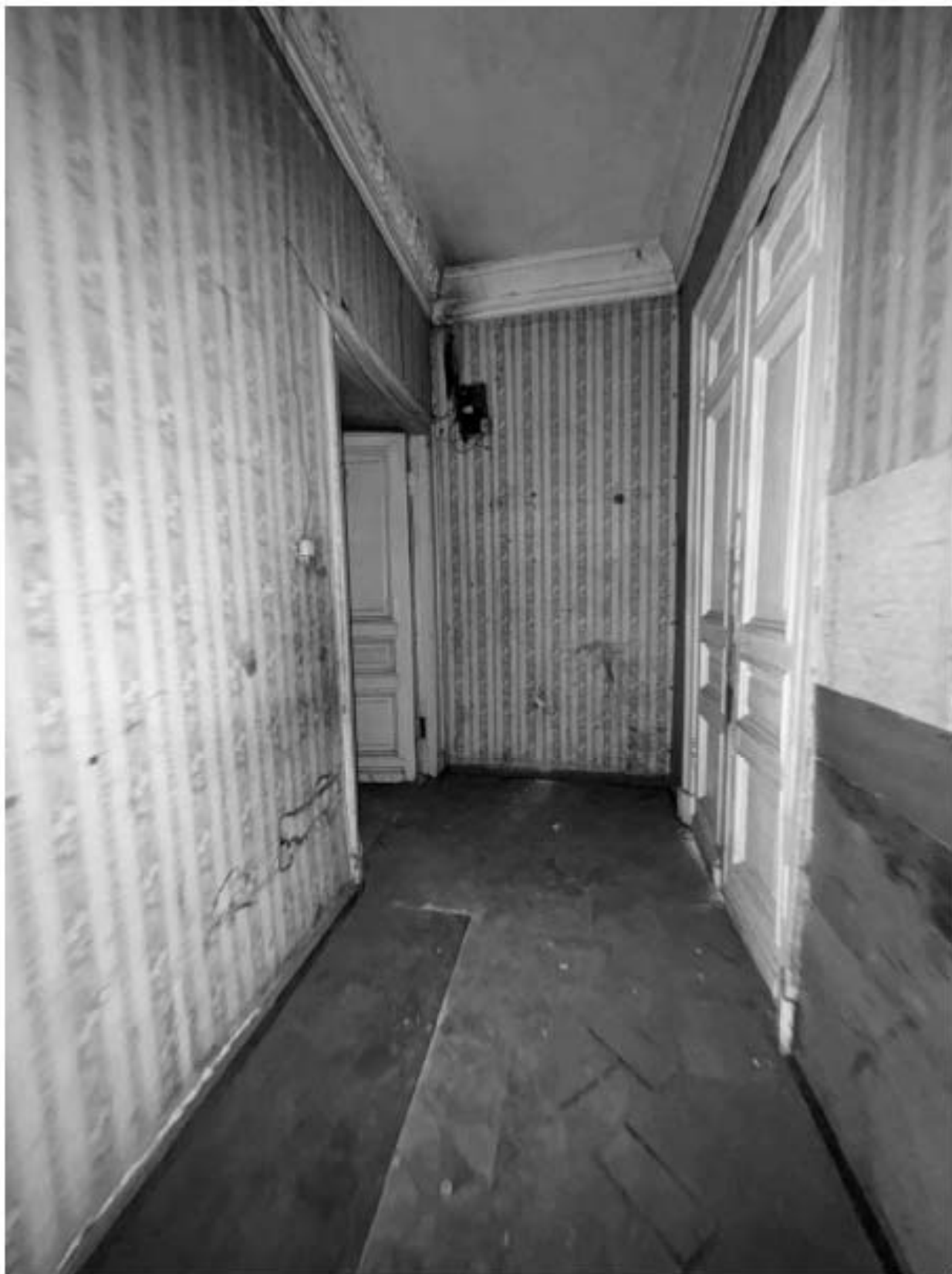
Фото 83. Вид на помещение квартиры № 11 объекта культурного наследия.
