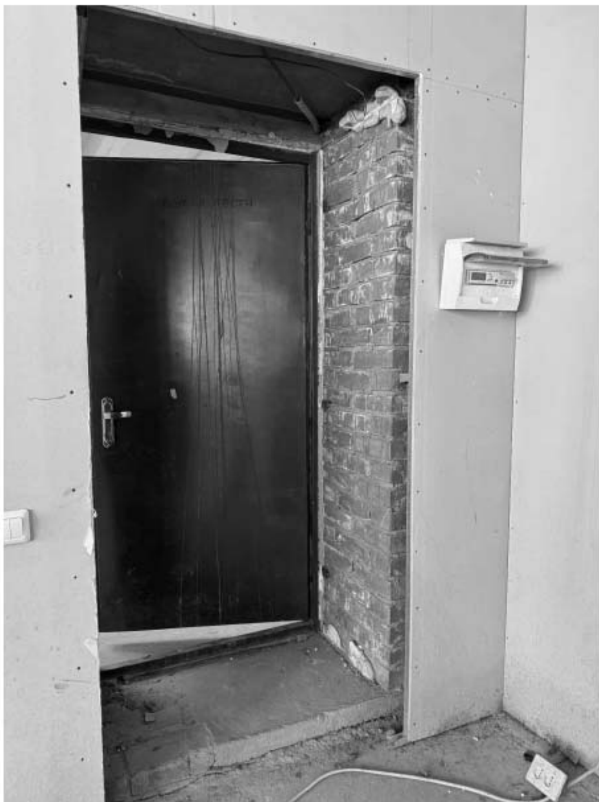
Фото 153. Вид на дверное заполнение помещения квартиры № 57 объекта культурного наследия.
