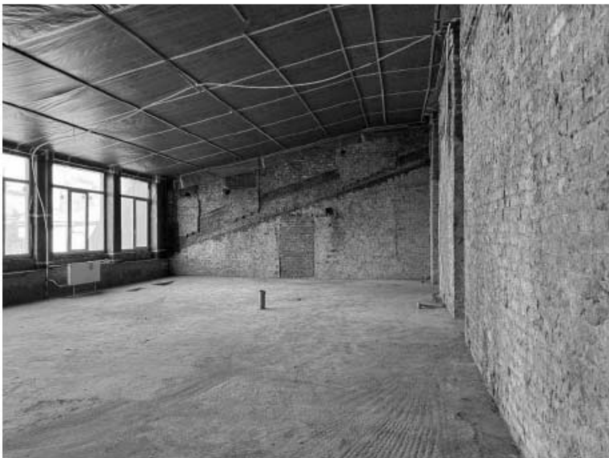
Фото 144. Вид на помещение квартиры № 56 объекта культурного наследия.
