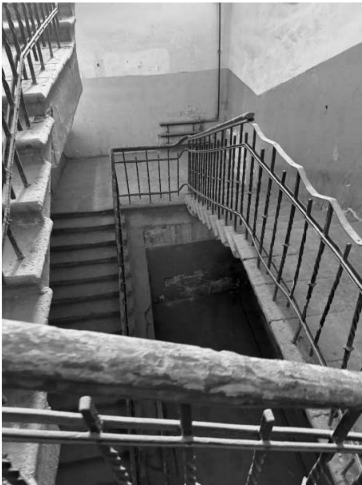
Фото 84. Вид на лестницу 5-ЛК объекта культурного наследия.
