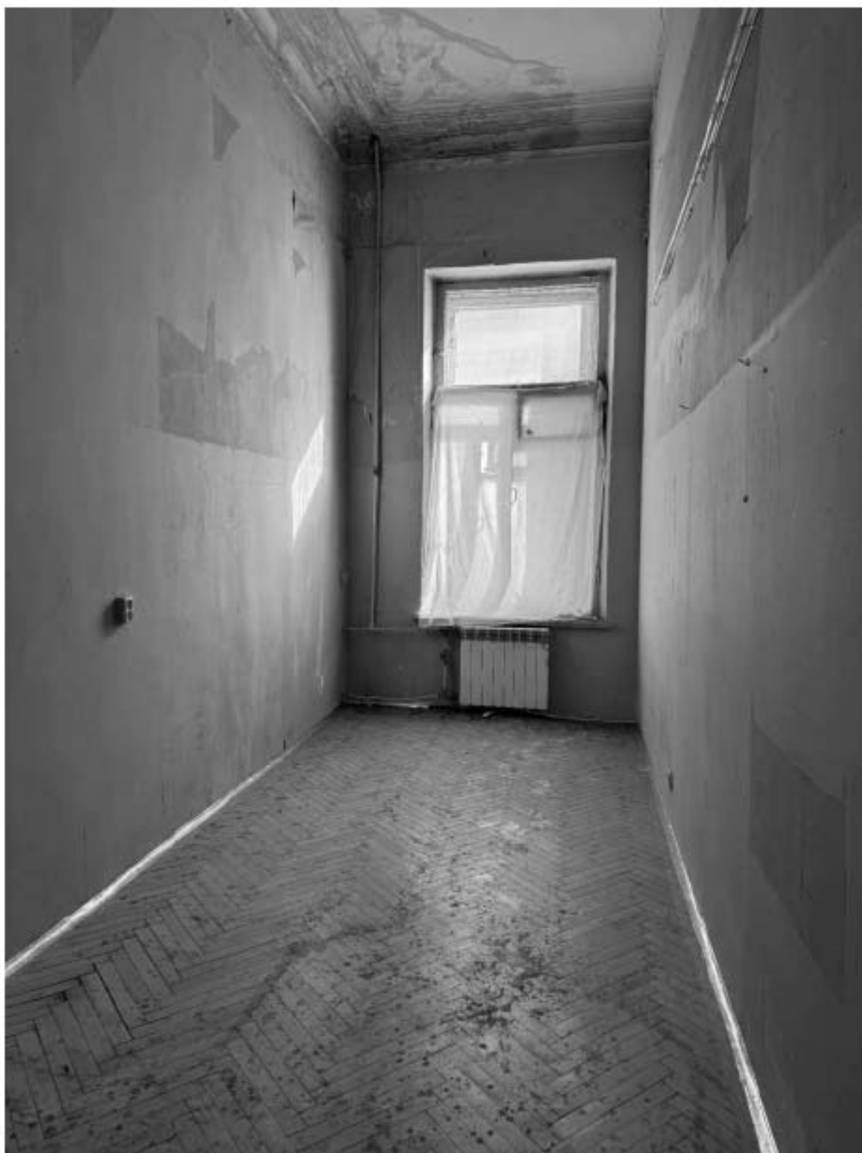
Фото 31. Вид на помещение квартиры № 17 объекта культурного наследия.
