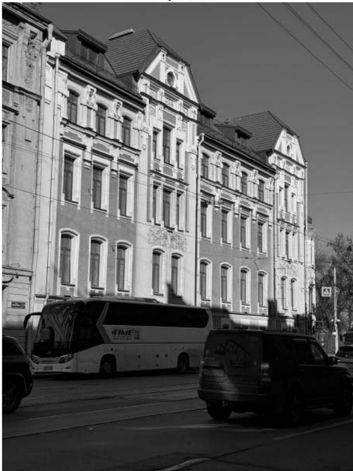
Фото 1. Фрагмент лицевого фасада объекта культурного наследия по проспекту Добролюбова.
