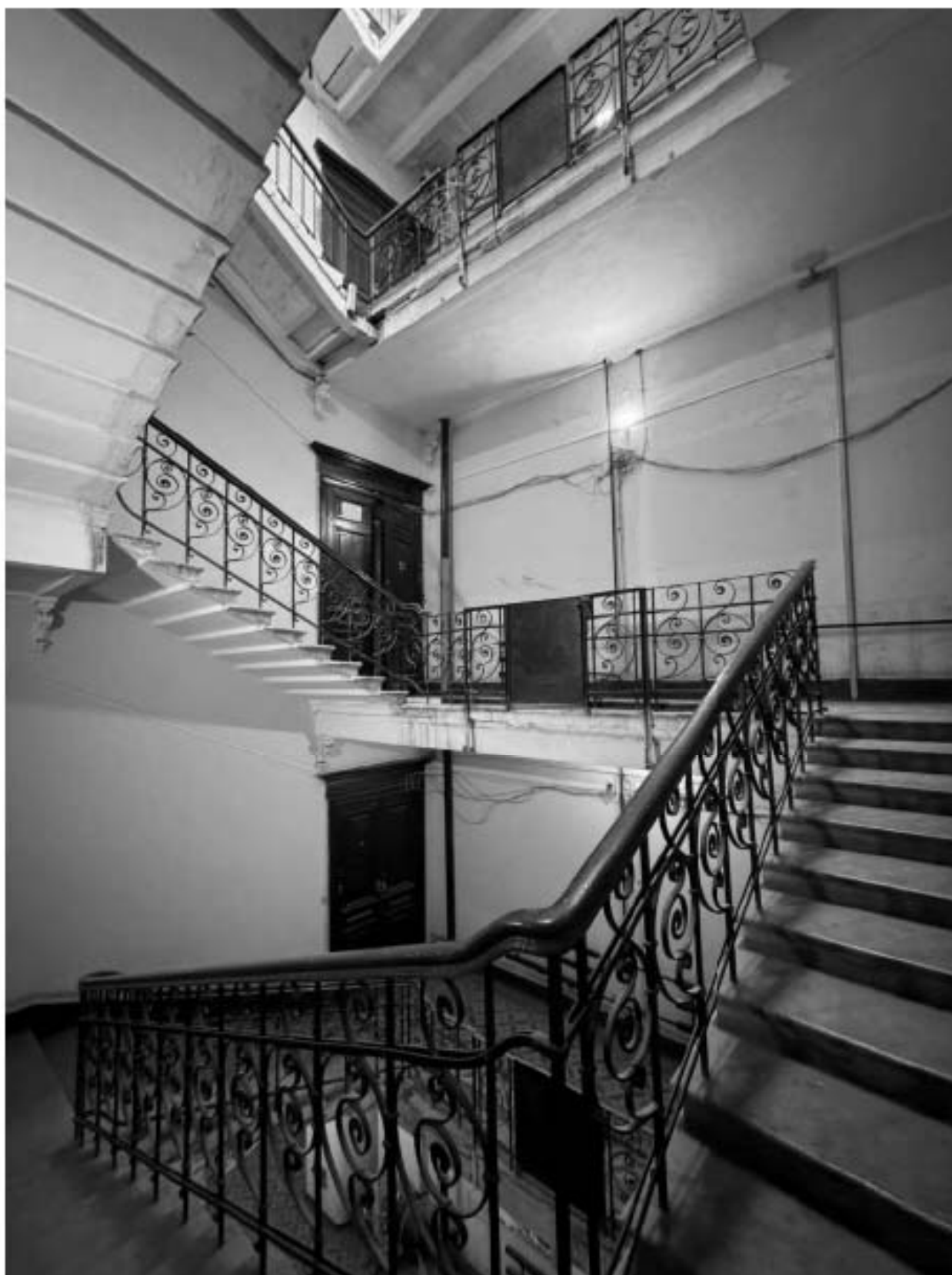
Фото 26. Вид на лестницу 1-ЛК объекта культурного наследия.
