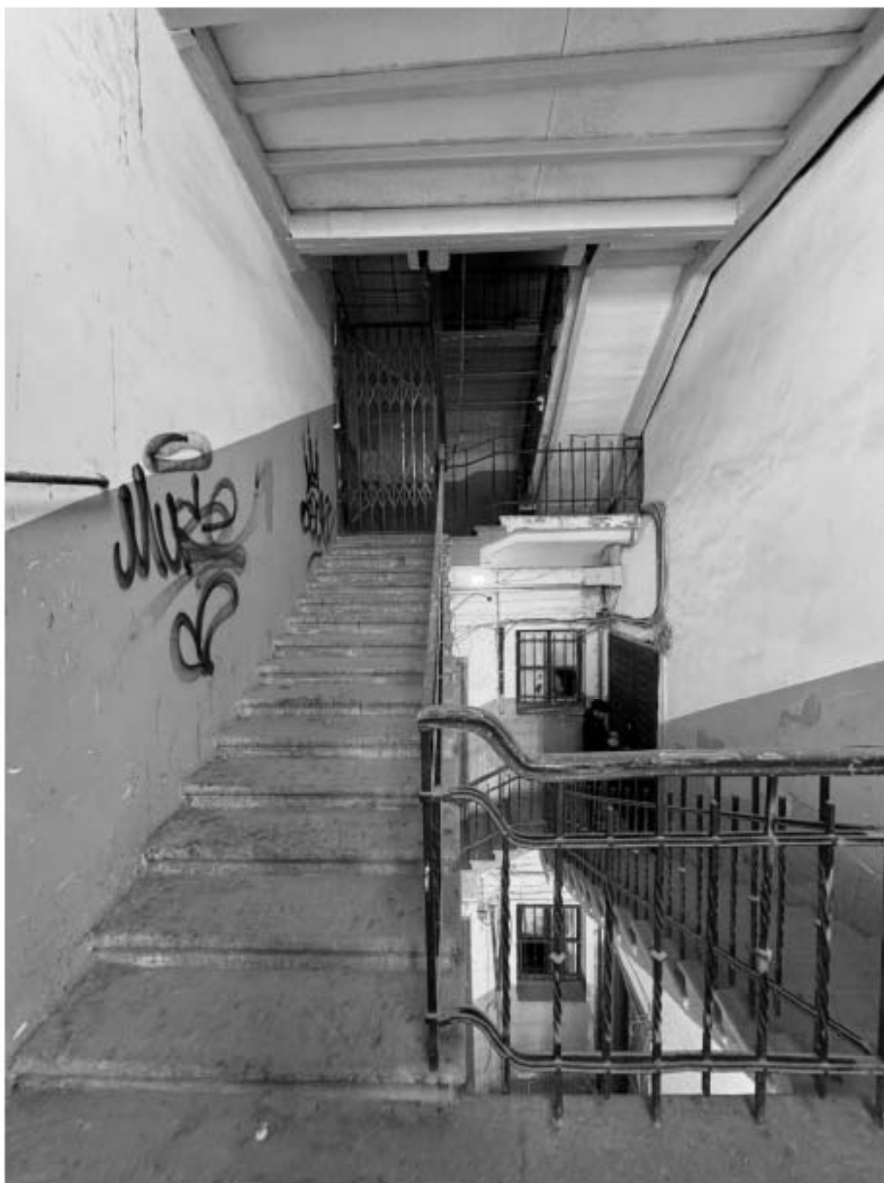
Фото 117. Вид на лестницу 5-ЛК объекта культурного наследия.
