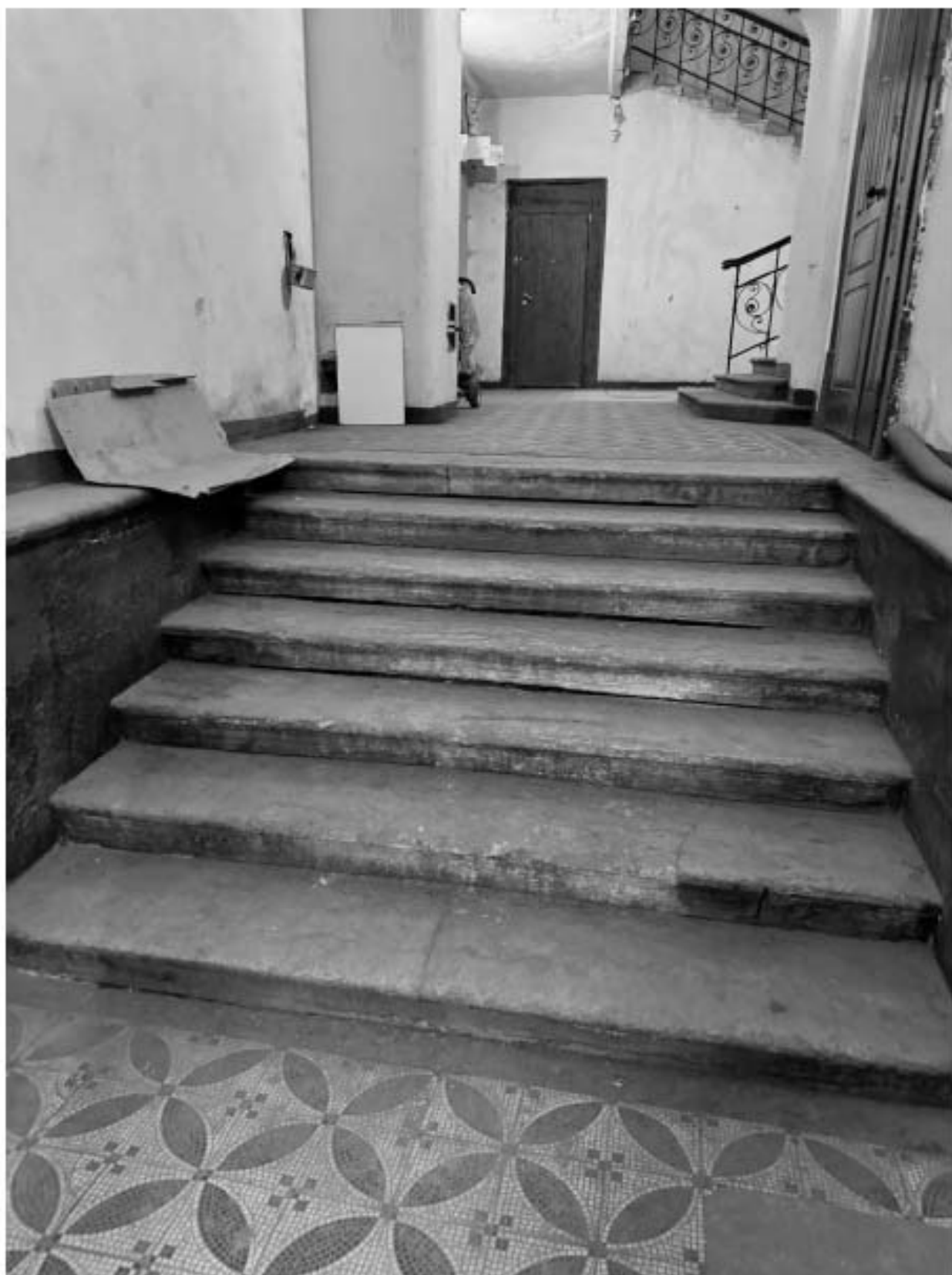
Фото 19. Вид на помещение вестибюля и лестницу 1-ЛК объекта культурного наследия.
