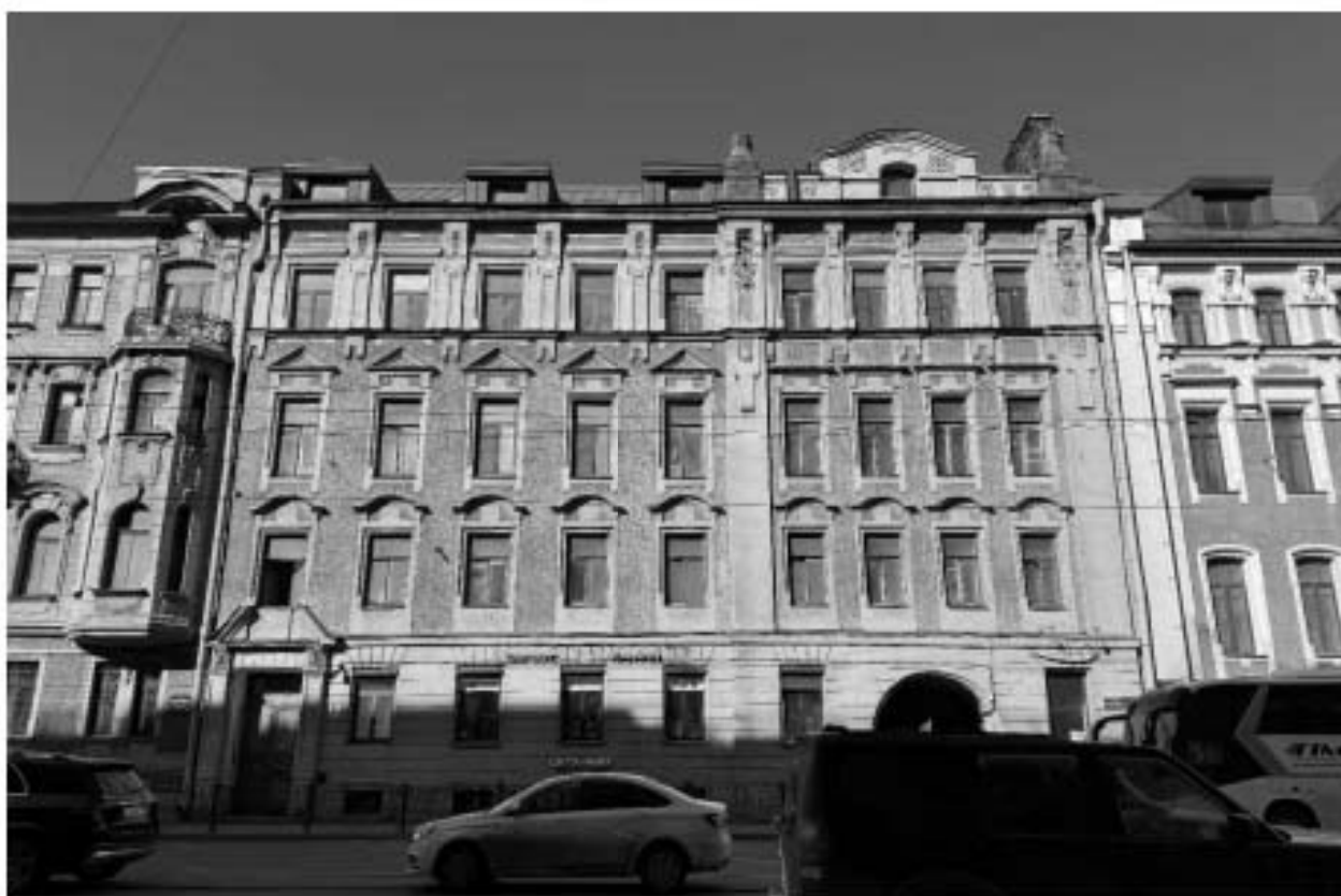
Фото 2. Фрагмент лицевого фасада объекта культурного наследия по проспекту Добролюбова.
