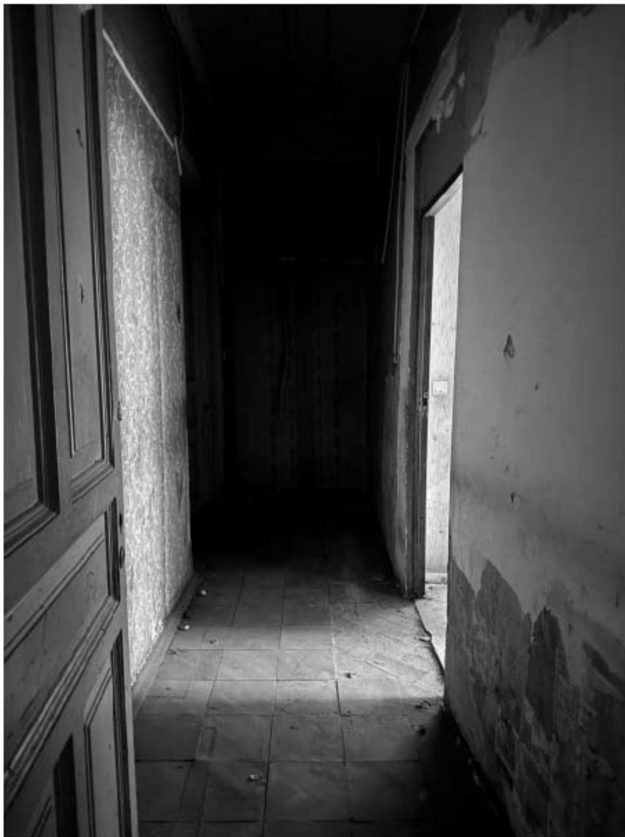
Фото 74. Вид на помещение квартиры № 11 объекта культурного наследия.
