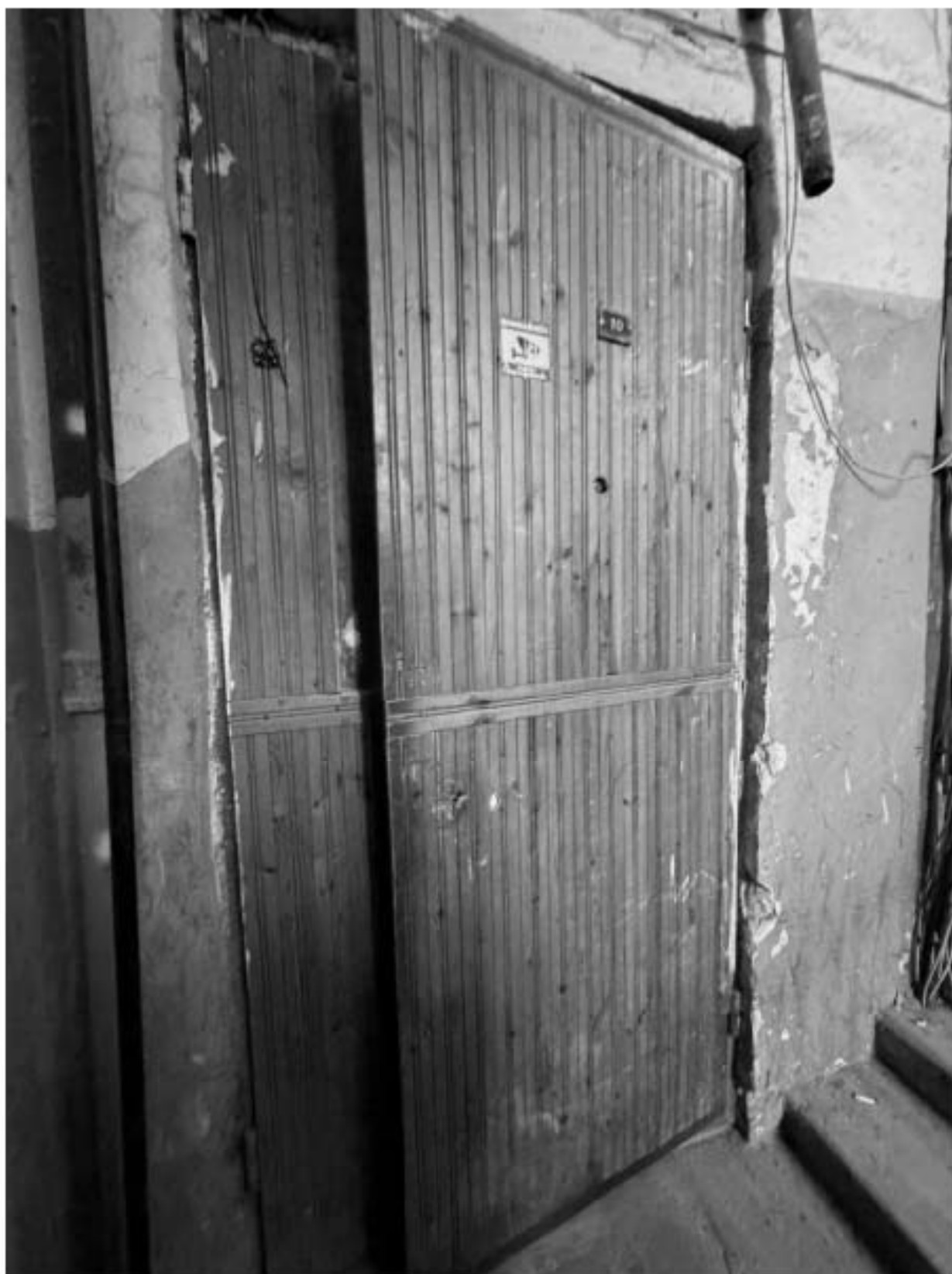
Фото 87. Вид на дверное заполнение квартиры № 10 объекта культурного наследия.
