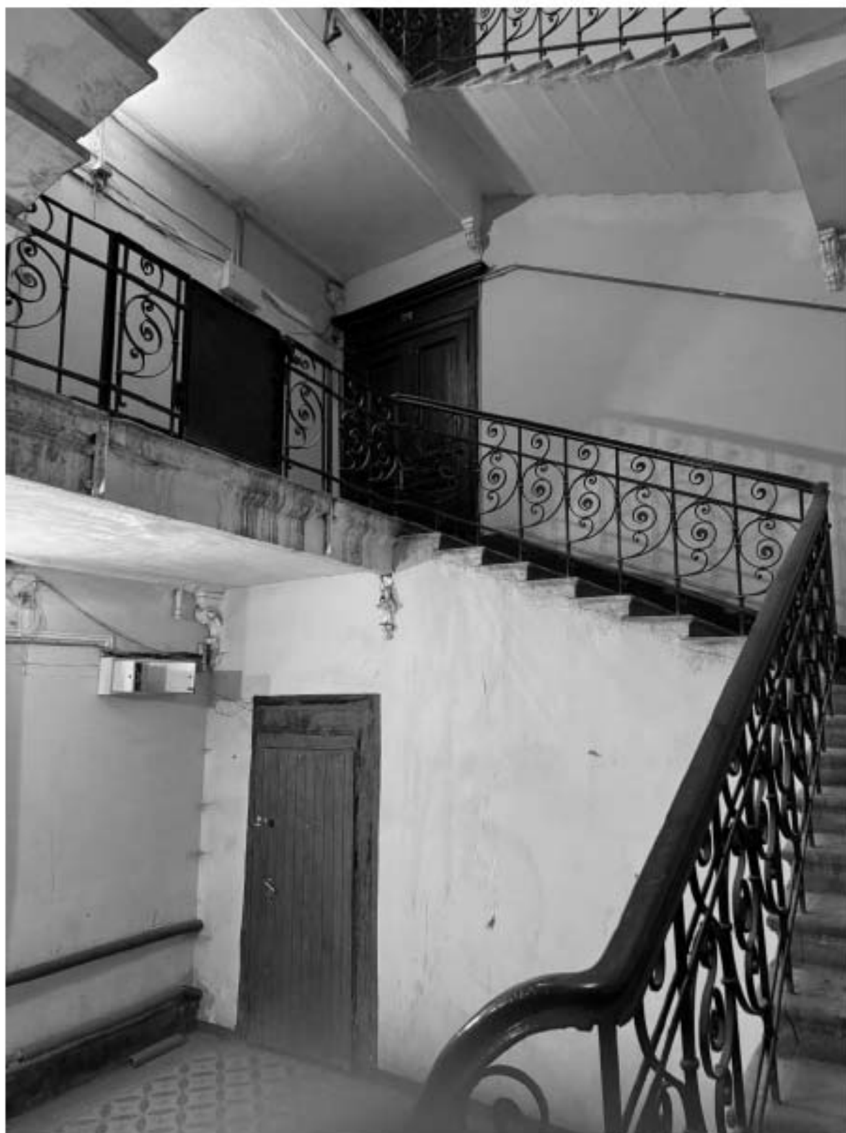
Фото 22. Вид на помещение вестибюля и лестницу 1-ЛК объекта культурного наследия.
