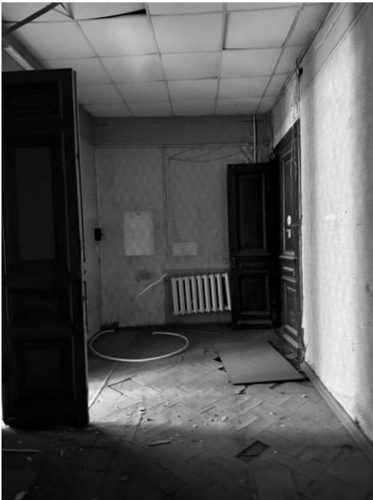
Фото 79. Вид на помещение квартиры № 11 объекта культурного наследия.
