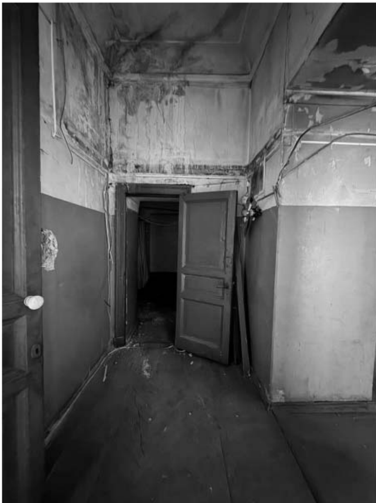
Фото 59. Вид на помещение квартиры № 11 объекта культурного наследия.
