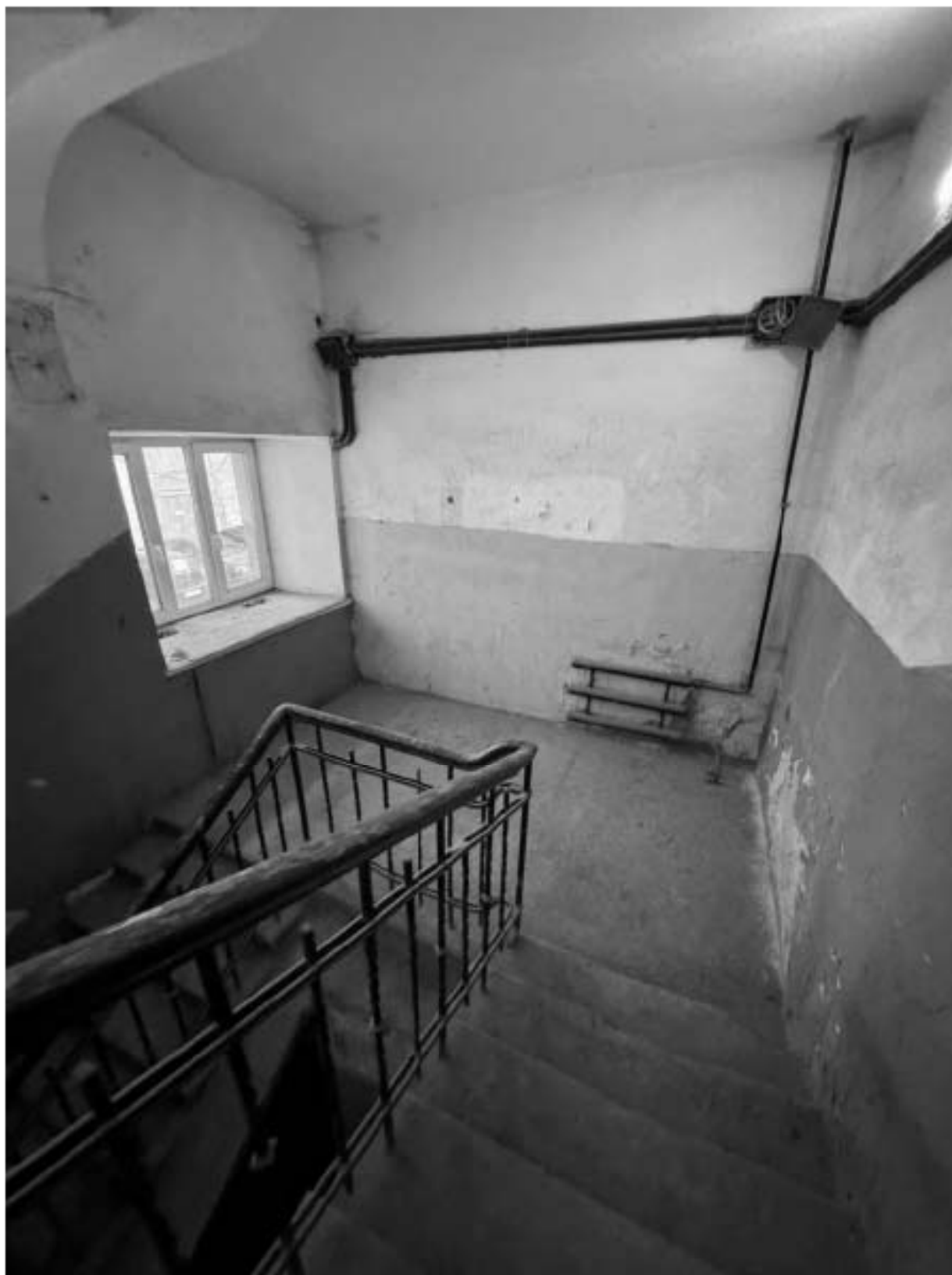
Фото 85. Вид на лестницу 5-ЛК объекта культурного наследия.
