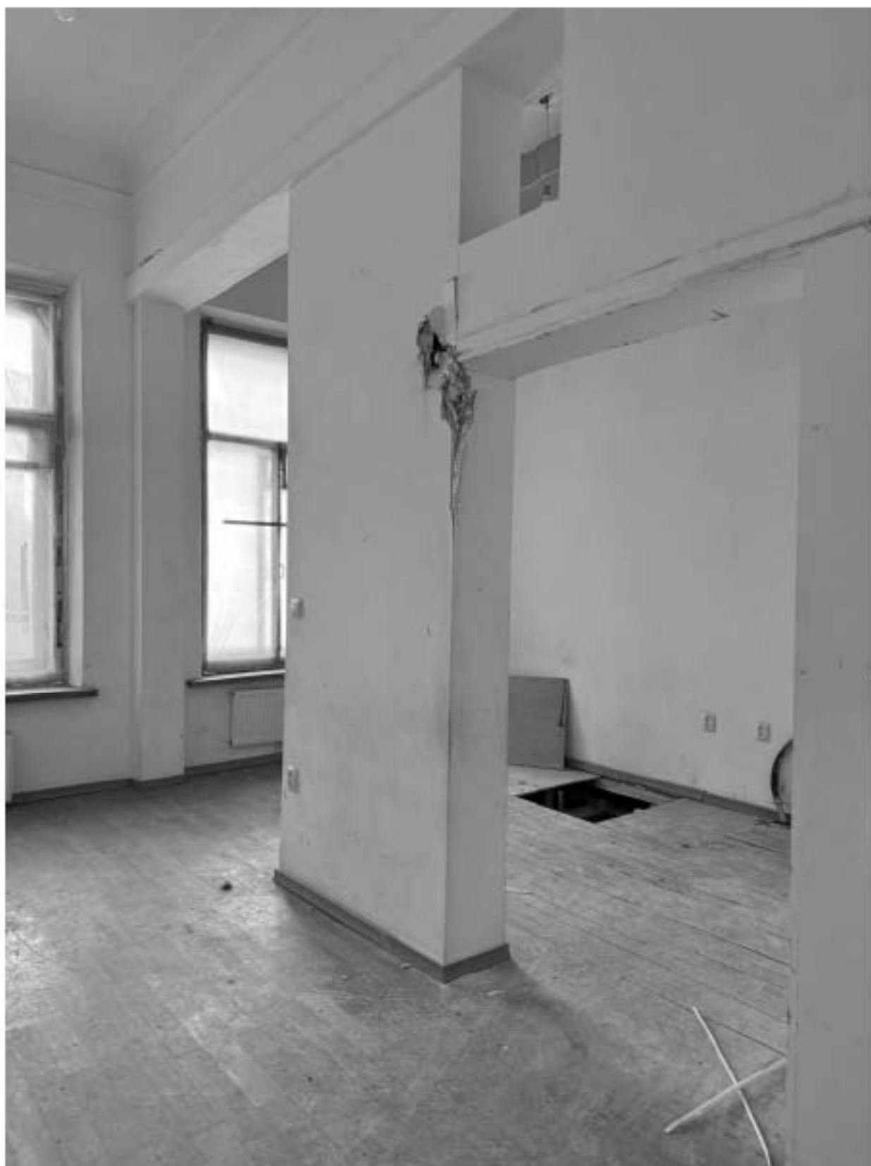
Фото 37. Вид на помещение квартиры № 17 объекта культурного наследия.
