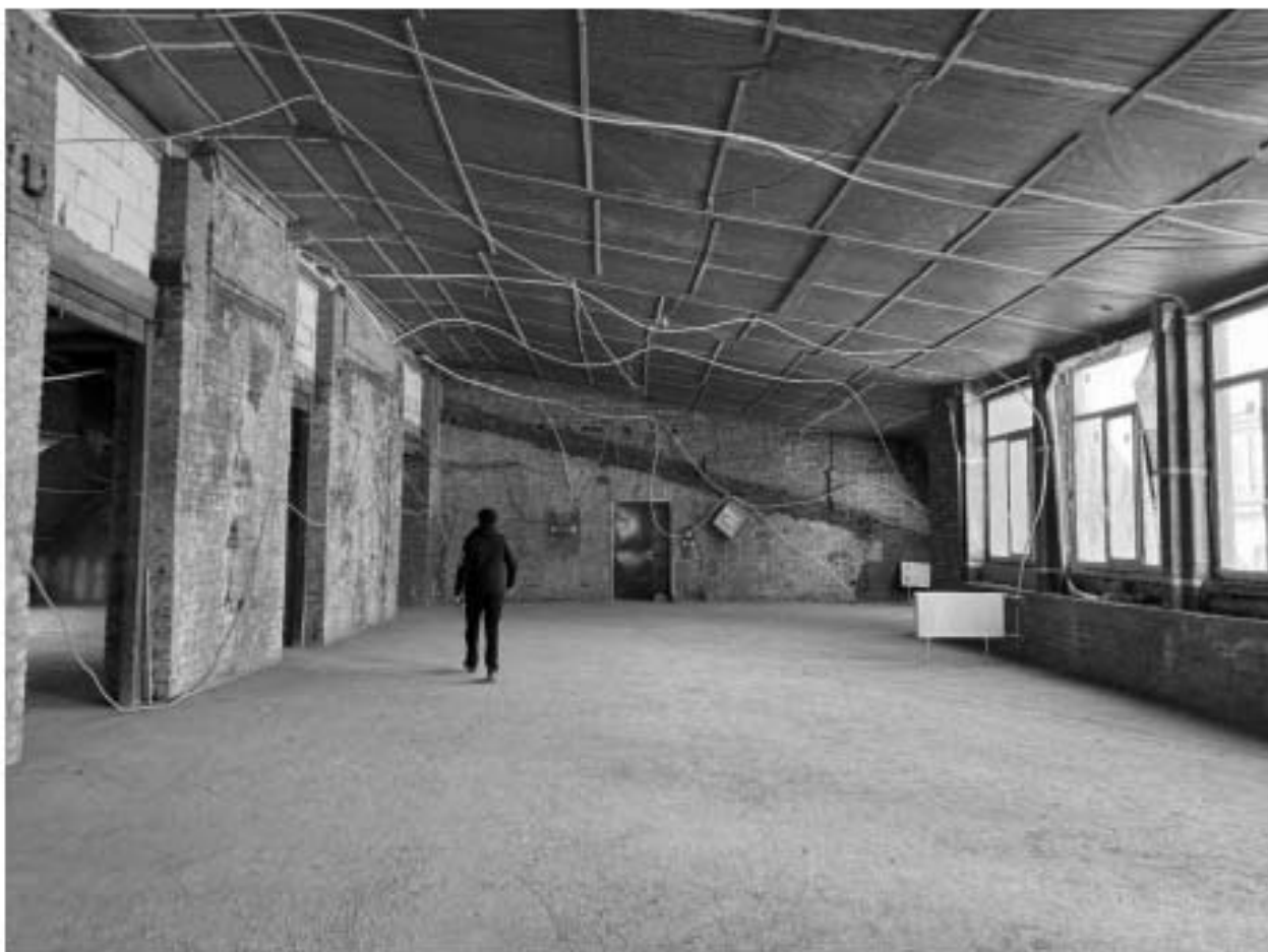
Фото 140. Вид на помещение квартиры № 58 объекта культурного наследия.
