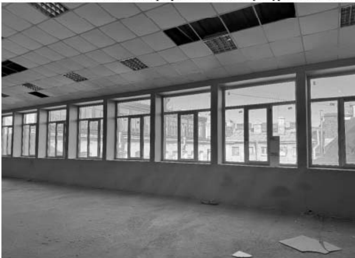
Фото 152. Вид на помещение квартиры № 57 объекта культурного наследия.
