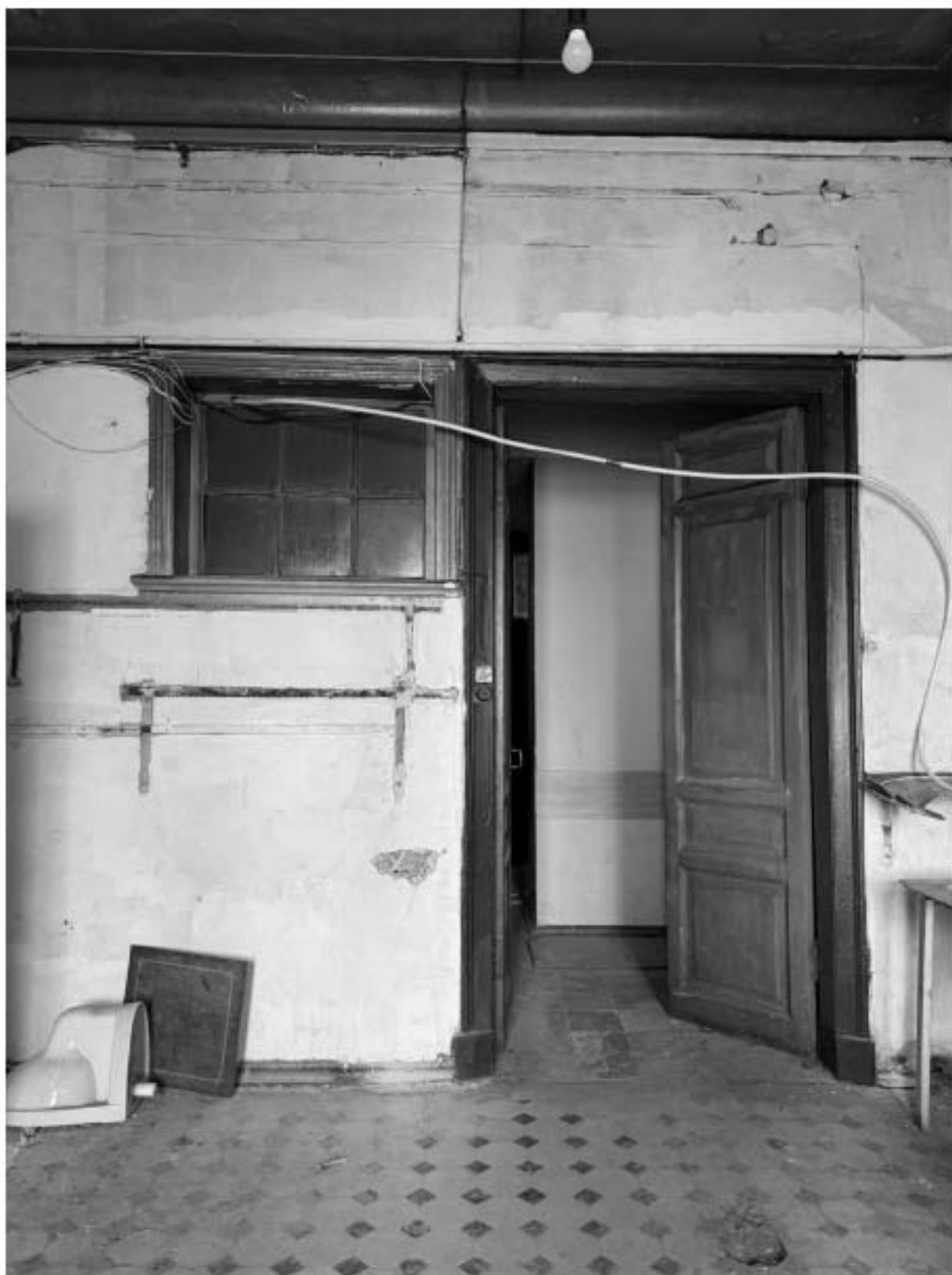
Фото 42. Вид на помещение квартиры № 17 объекта культурного наследия.
