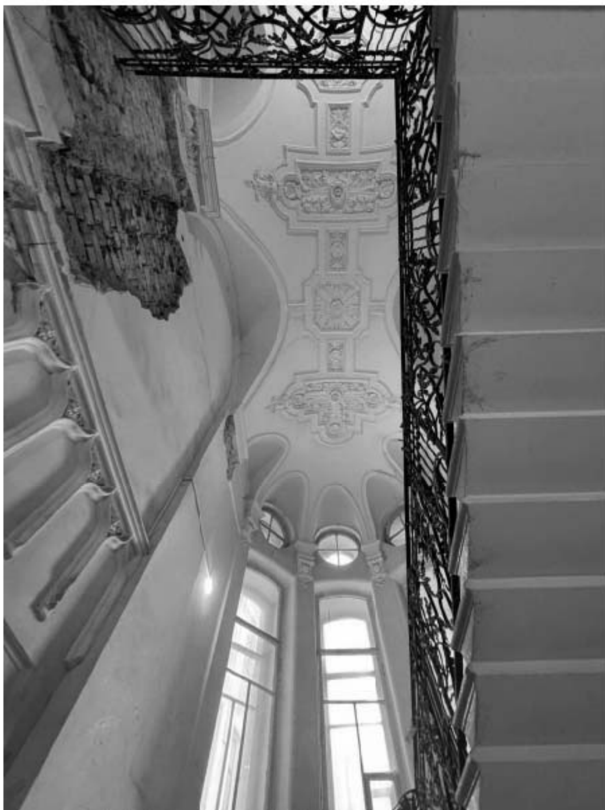
Фото 105. Вид на лестницу 4-ЛК объекта культурного наследия.
