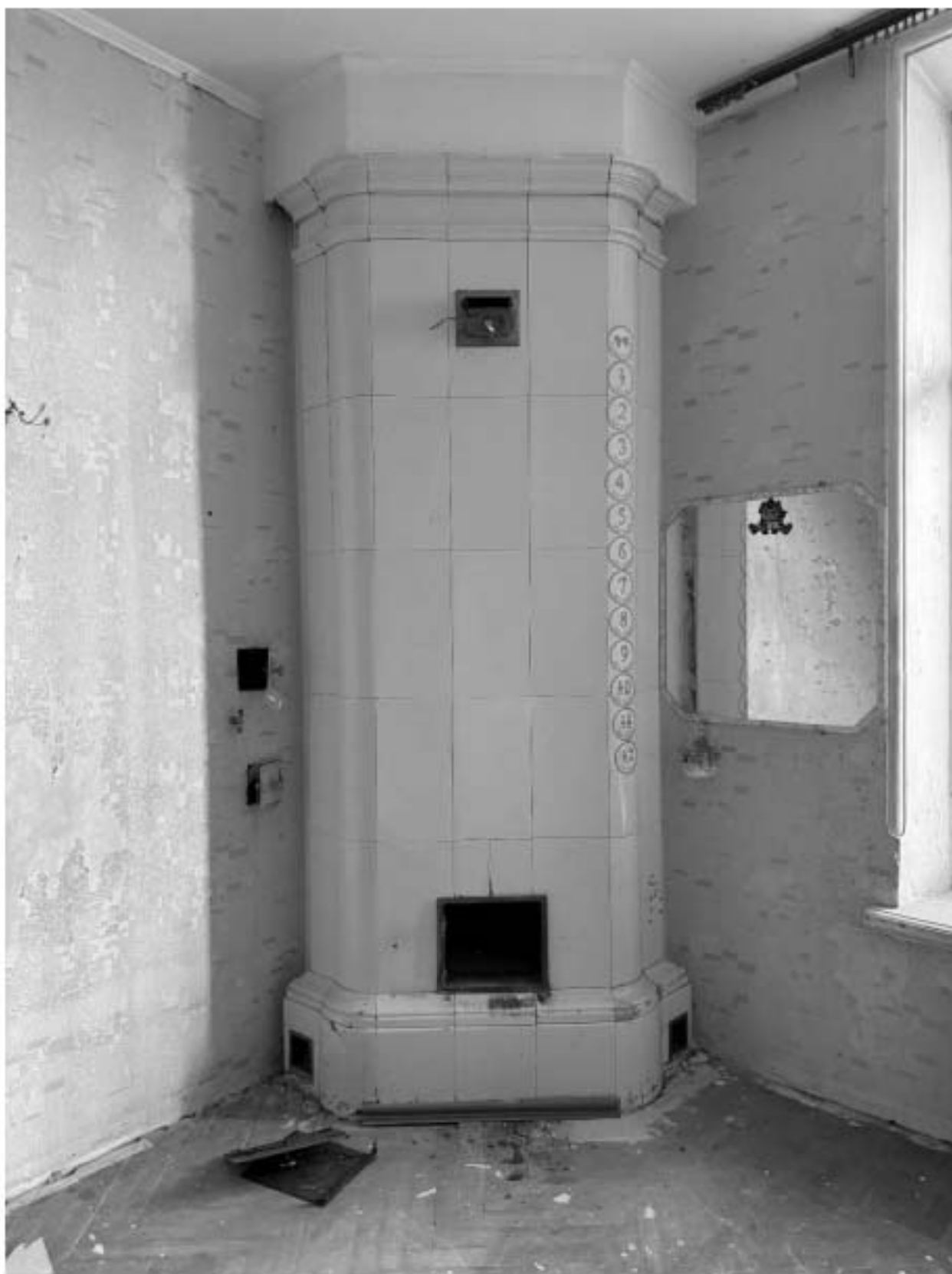
Фото 77. Вид на печь квартиры № 11 объекта культурного наследия.
