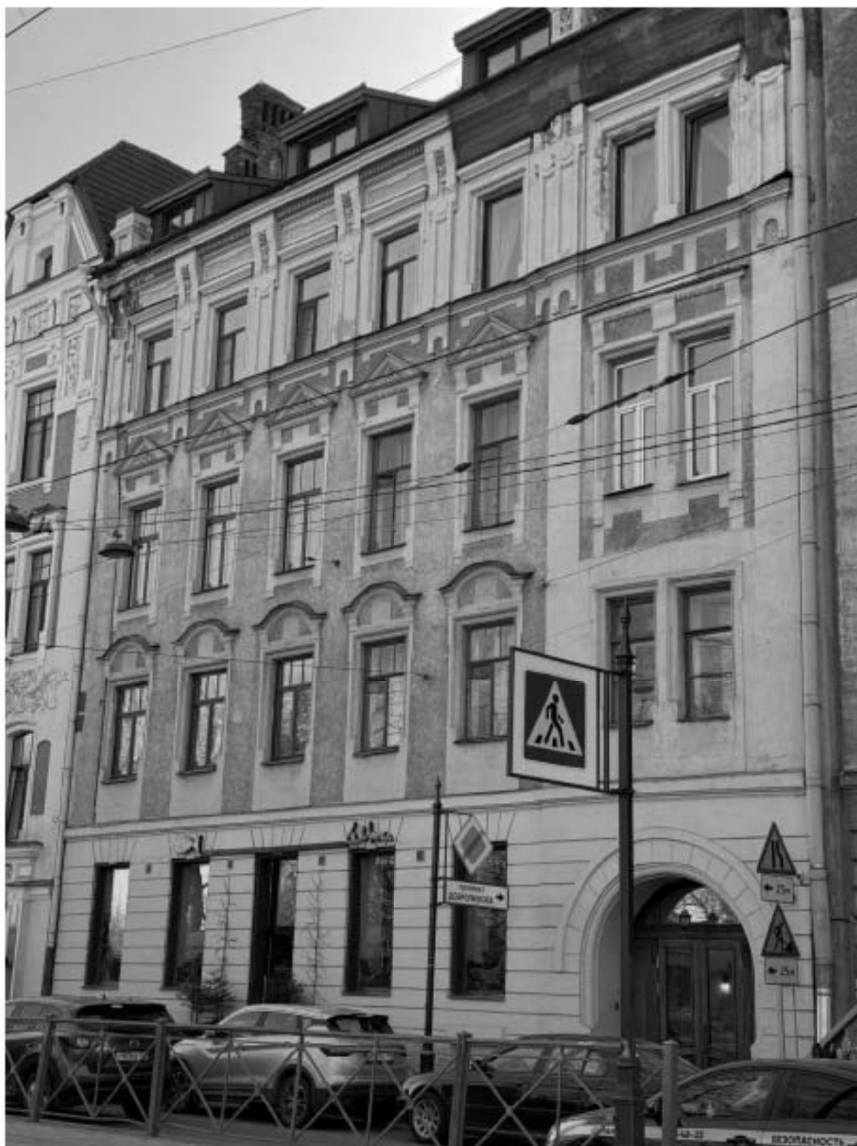
Фото 7. Фрагмент лицевого фасада объекта культурного наследия по Кронверкскому проспекту.
