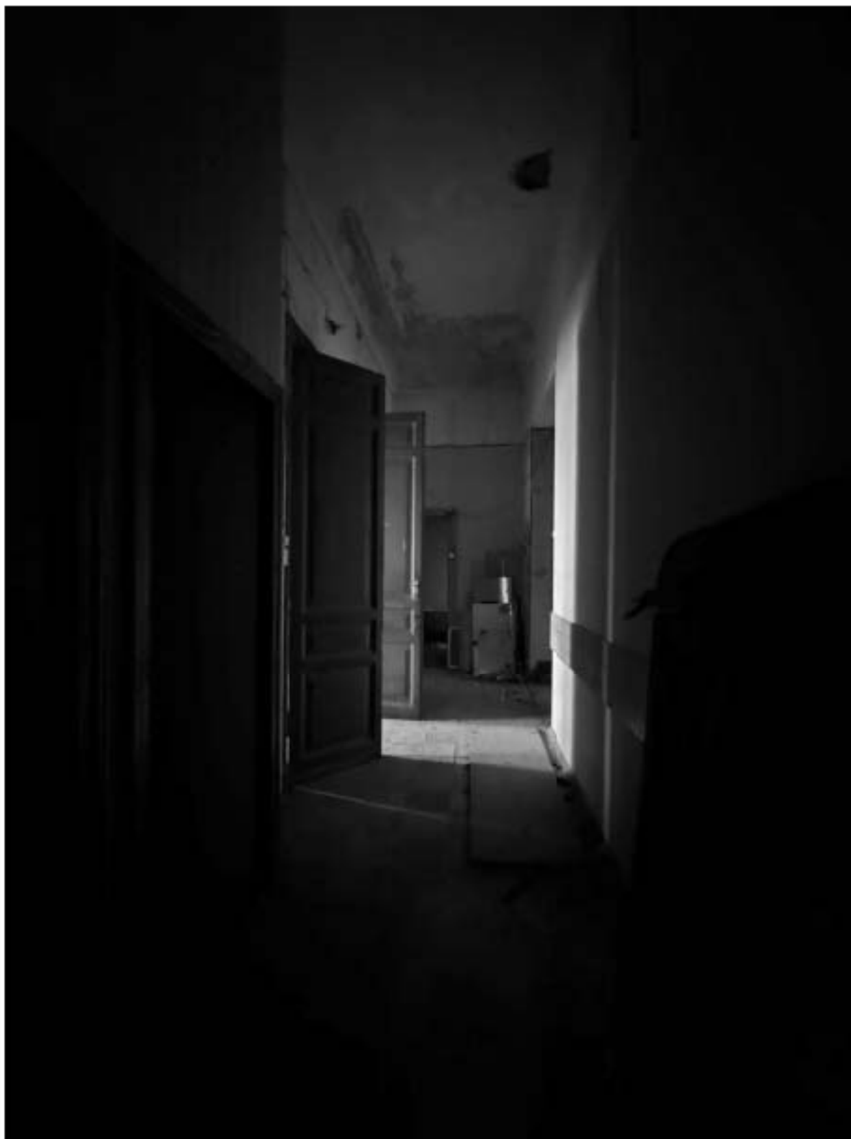
Фото 40. Вид на помещение квартиры № 17 объекта культурного наследия.
