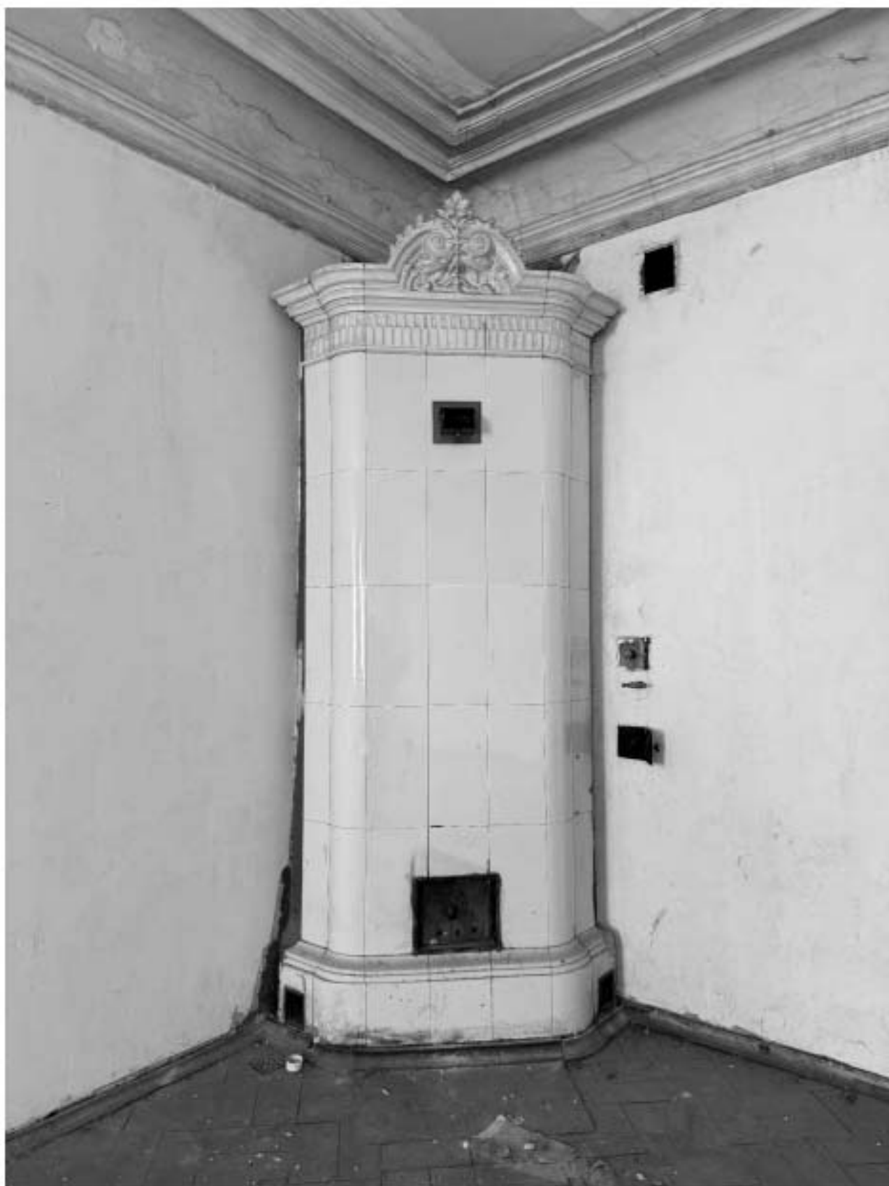
Фото 66. Вид на печь квартиры № 11 объекта культурного наследия.
