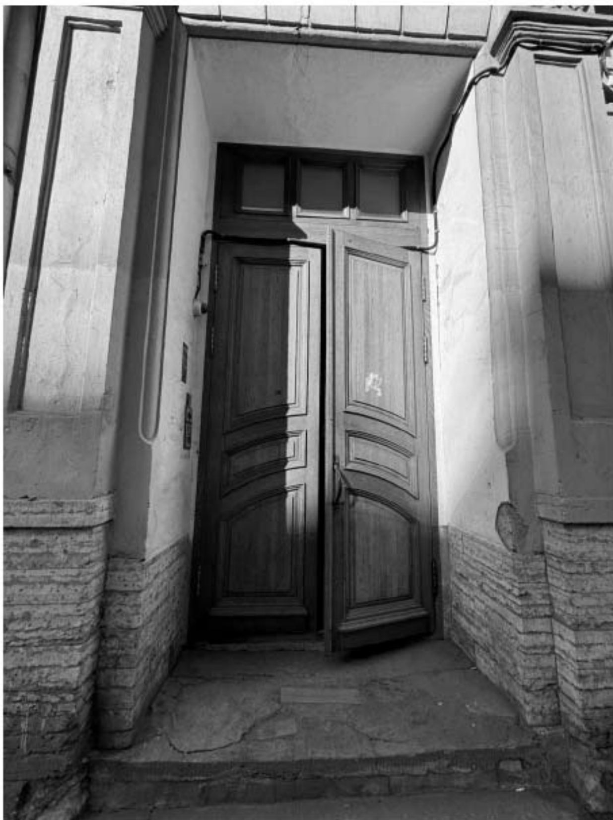
Фото 18. Вид на дверное заполнение, ведущее к лестнице 1-ЛК, объекта культурного наследия.
