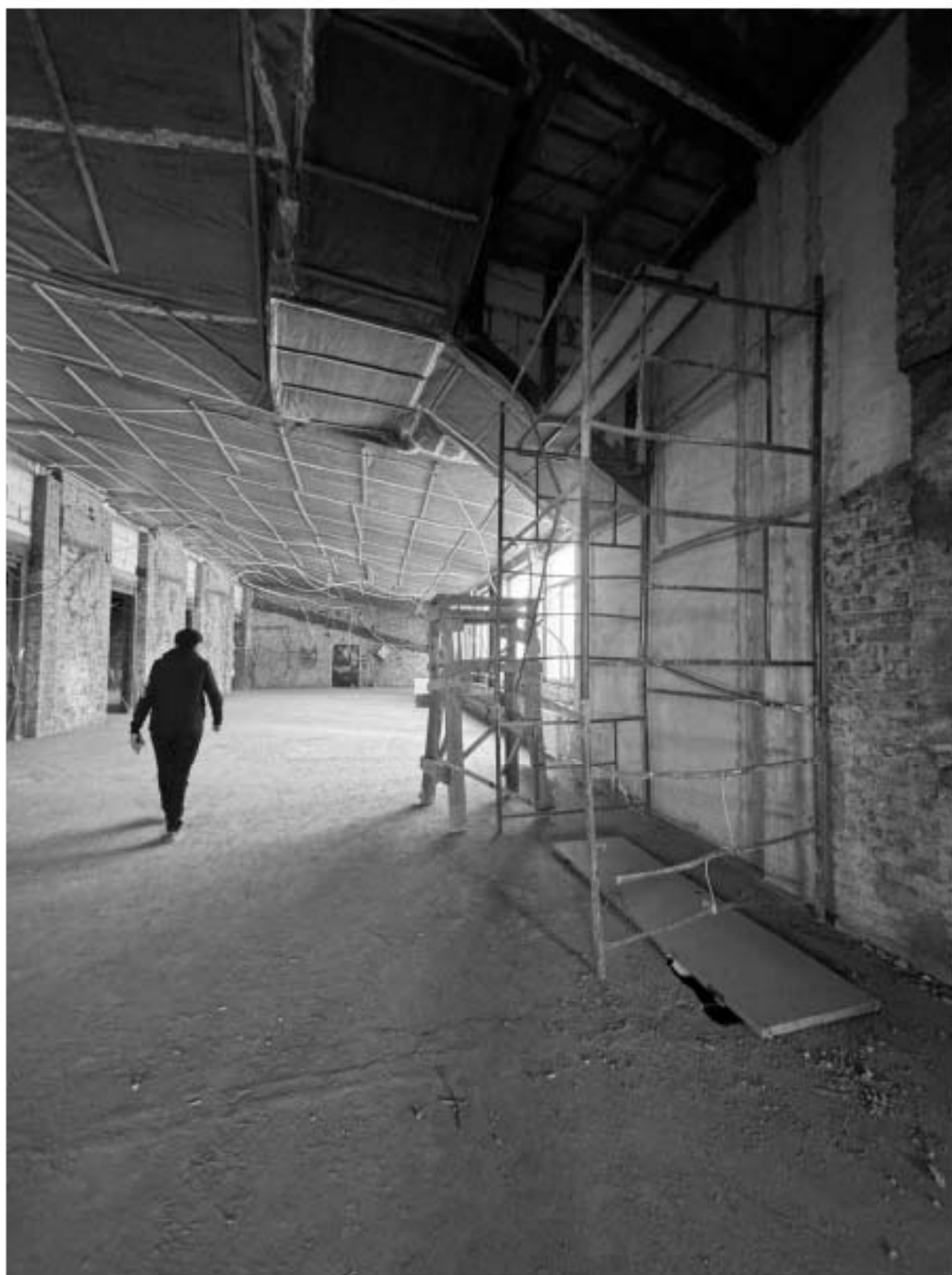
Фото 138. Вид на помещение квартиры № 58 объекта культурного наследия.
