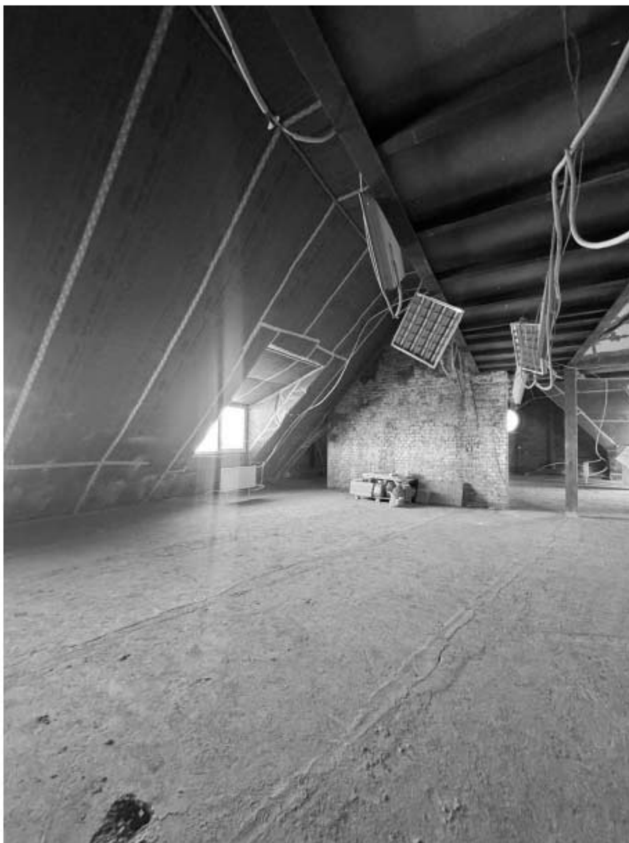
Фото 139. Вид на помещение квартиры № 58 объекта культурного наследия.
