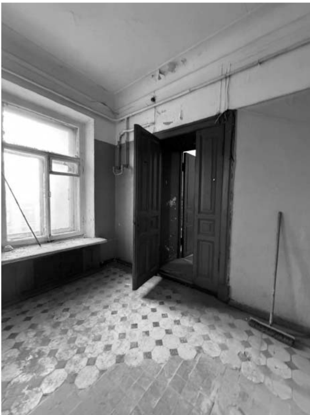
Фото 57. Вид на помещение квартиры № 11 объекта культурного наследия.
