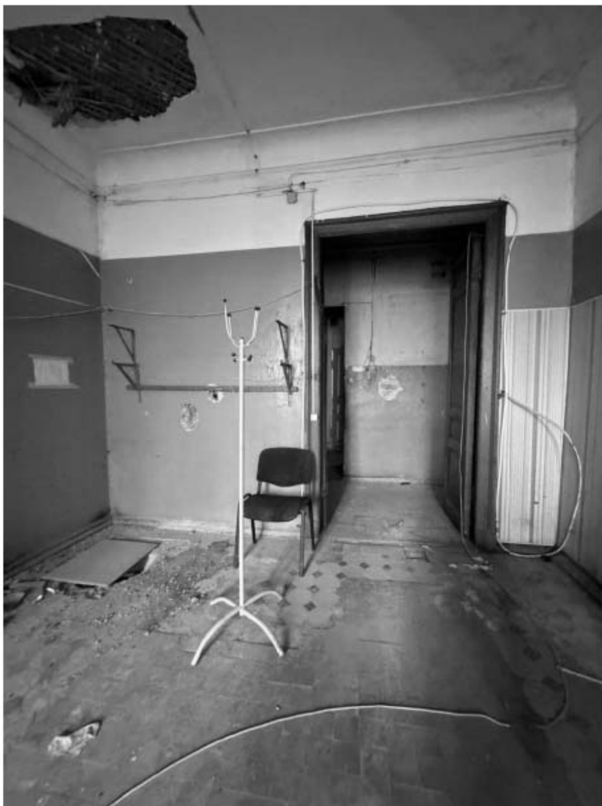
Фото 58. Вид на помещение квартиры № 11 объекта культурного наследия.
