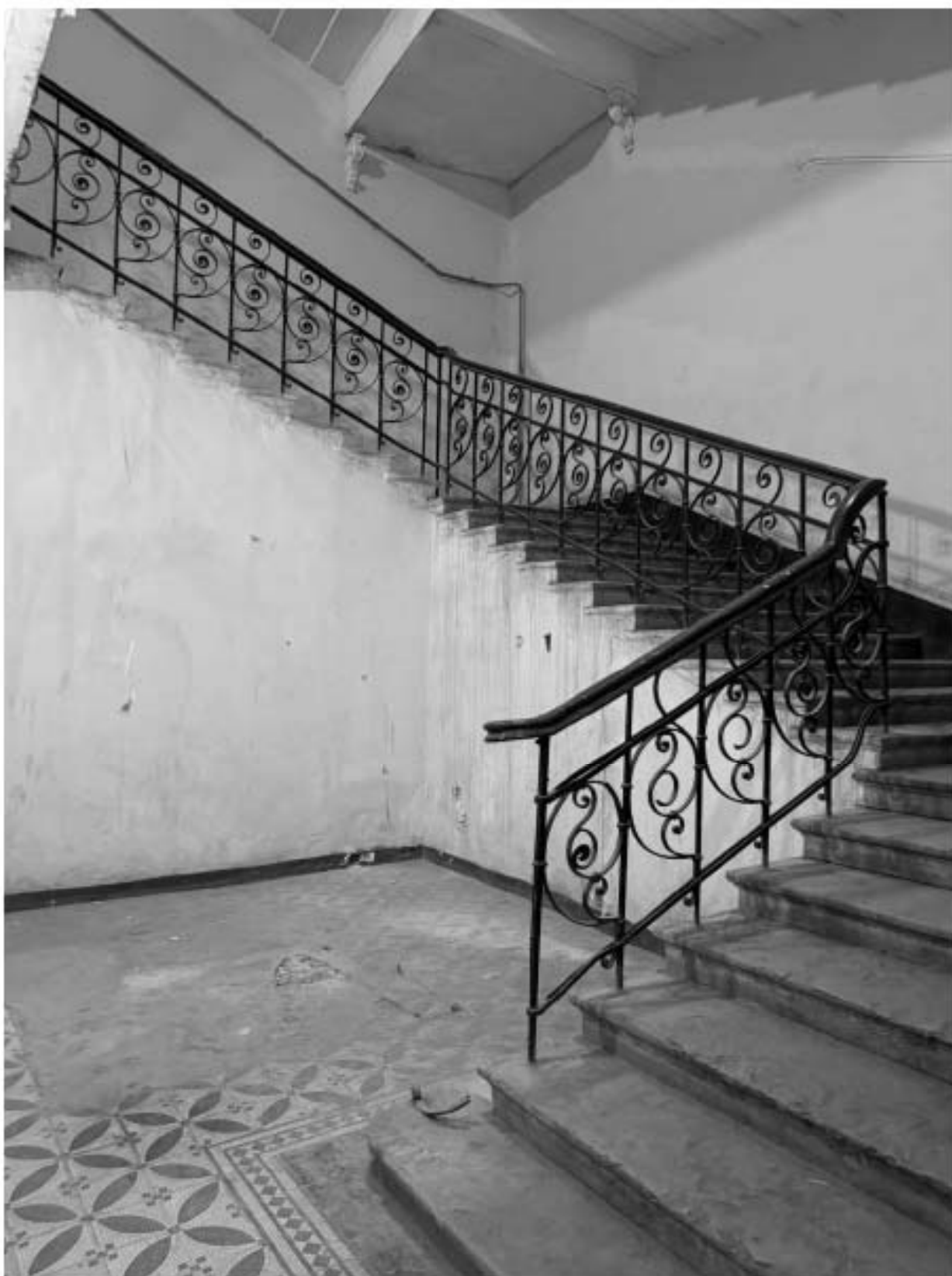
Фото 21. Вид на помещение вестибюля и лестницу 1-ЛК объекта культурного наследия.
