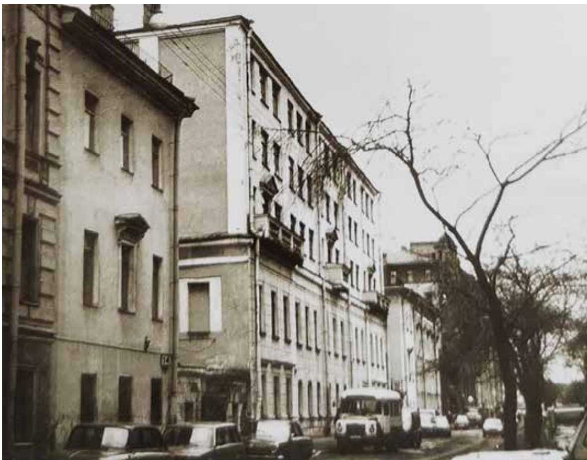
Илл. 21. Фасад дома № 14 по Захарьевской улице. Общий вид. Фотография. 1992 г. Автор съемки: неизвестен.
