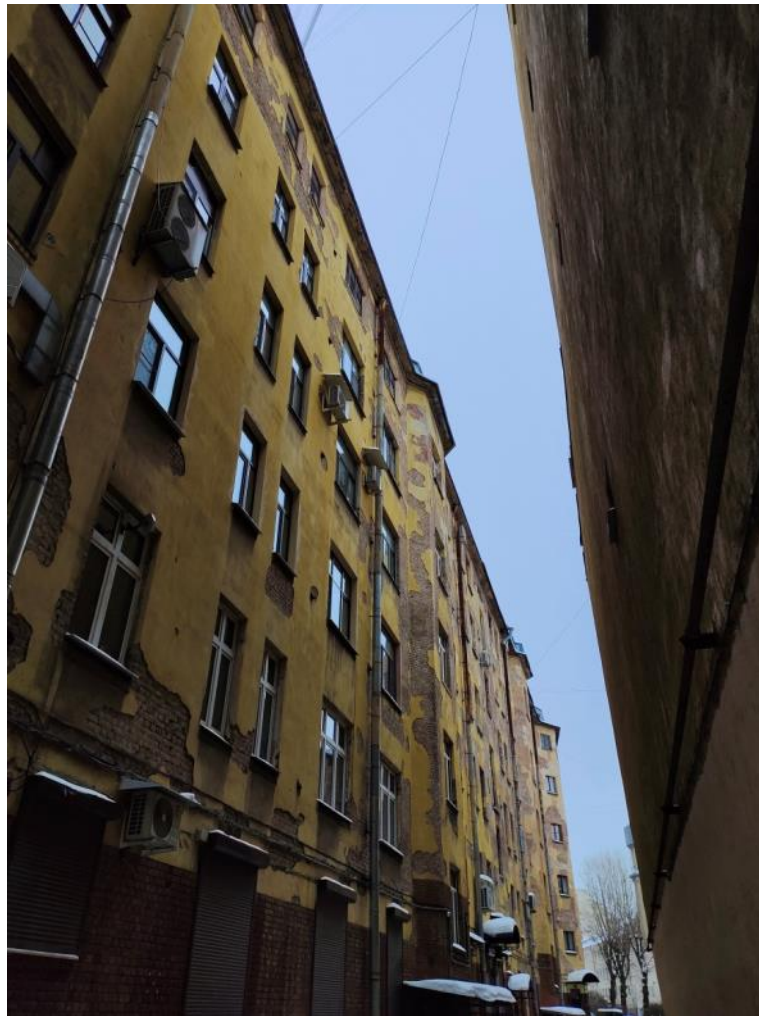
9. ОКН регионального значения «Дом М.П. Толстого». Дворовый фасад.
