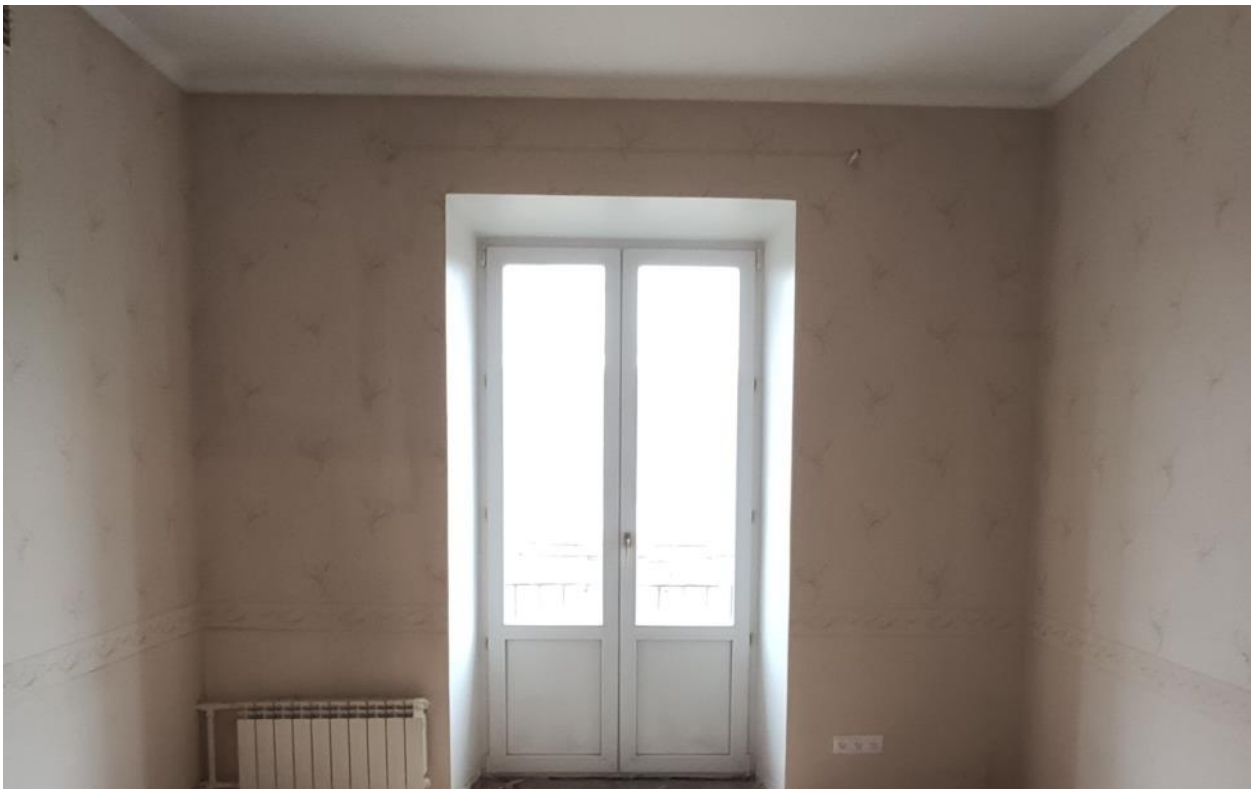
15. ОКН регионального значения «Дом М.П. Толстого» кв. 653
