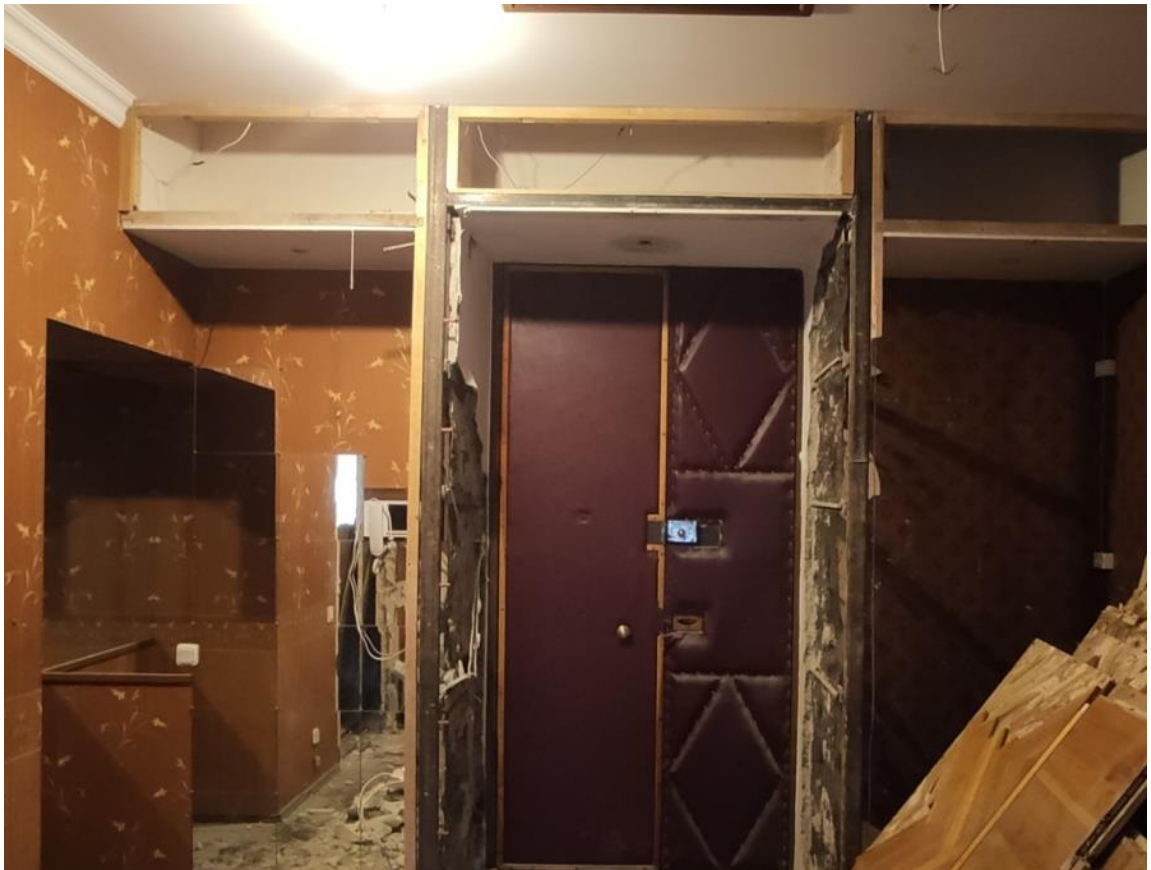
17. ОКН регионального значения «Дом М.П. Толстого» кв. 653
