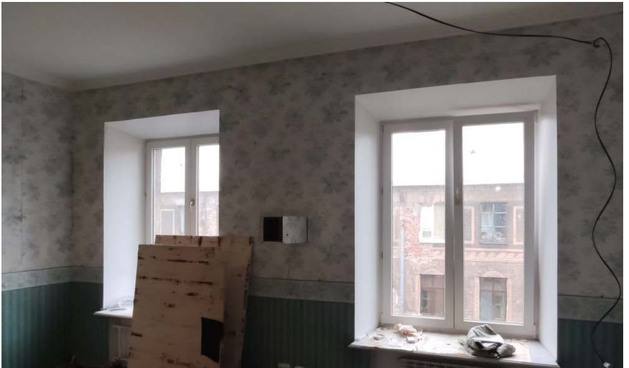
21. ОКН регионального значения «Дом М.П. Толстого» кв. 653
