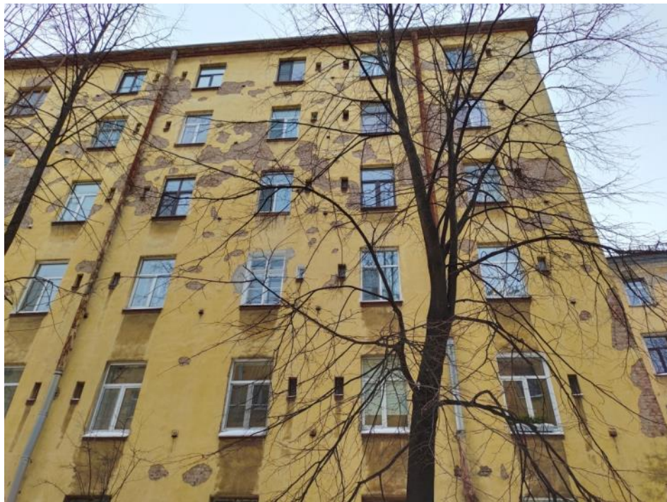
12. ОКН регионального значения «Дом М.П. Толстого». Дворовый фасад.
