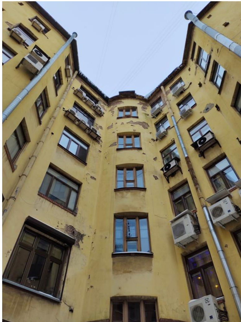
13. ОКН регионального значения «Дом М.П. Толстого». Дворовый фасад.
