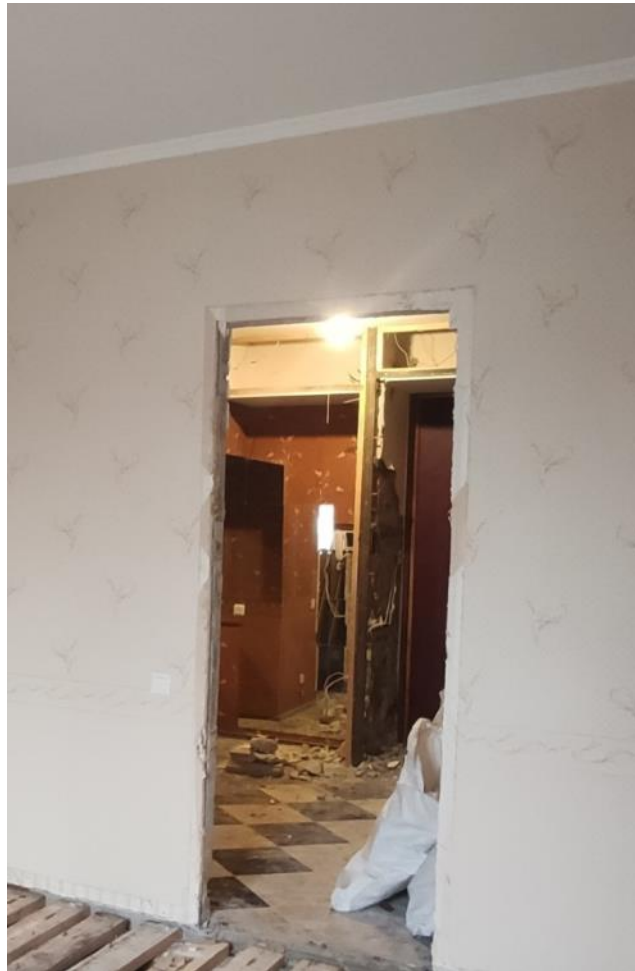
16. ОКН регионального значения «Дом М.П. Толстого» кв. 653
