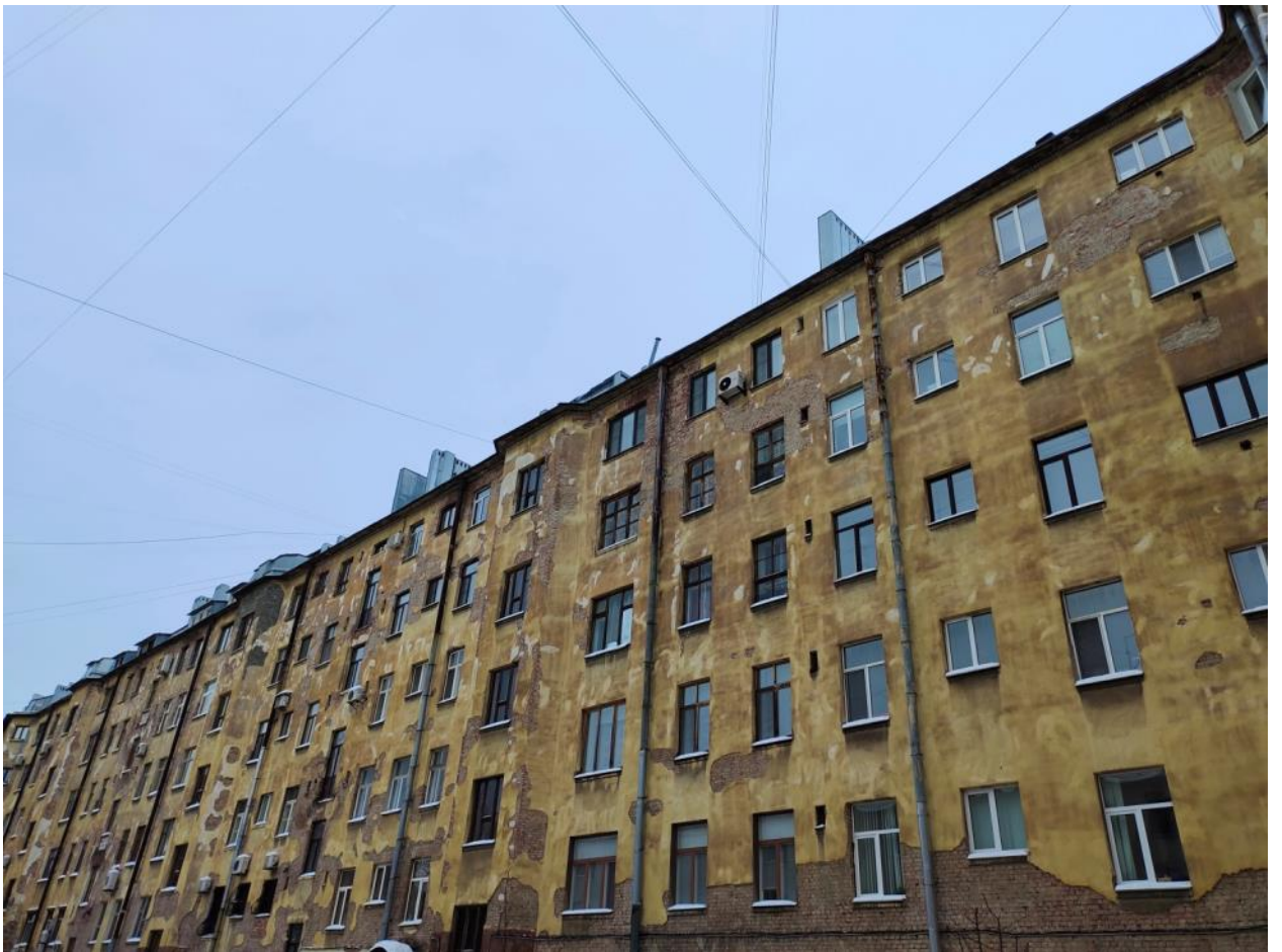
11. ОКН регионального значения «Дом М.П. Толстого». Дворовый фасад.
