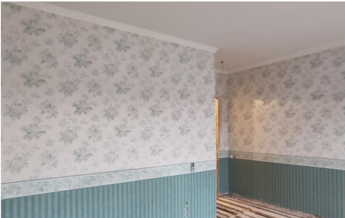
22. ОКН регионального значения «Дом М.П. Толстого» кв. 653
