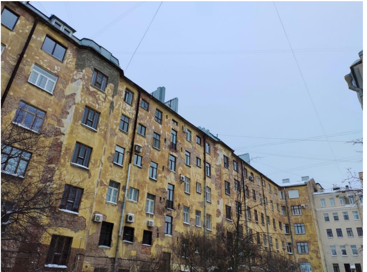
10. ОКН регионального значения «Дом М.П. Толстого». Дворовый фасад.
