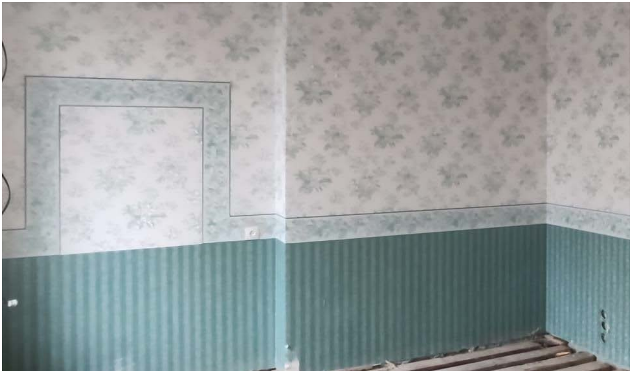
20. ОКН регионального значения «Дом М.П. Толстого» кв. 653
