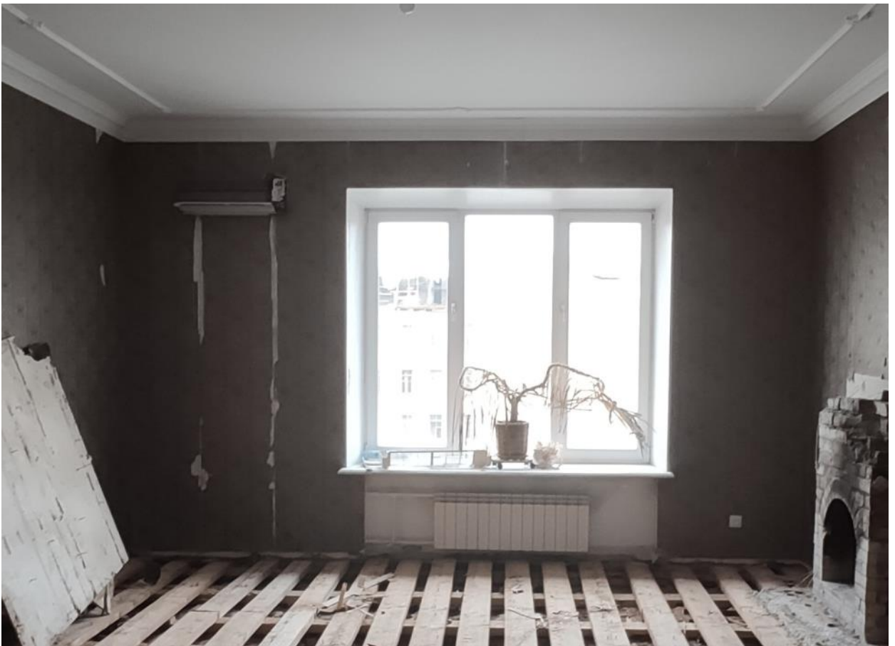
19. ОКН регионального значения «Дом М.П. Толстого» кв. 653
