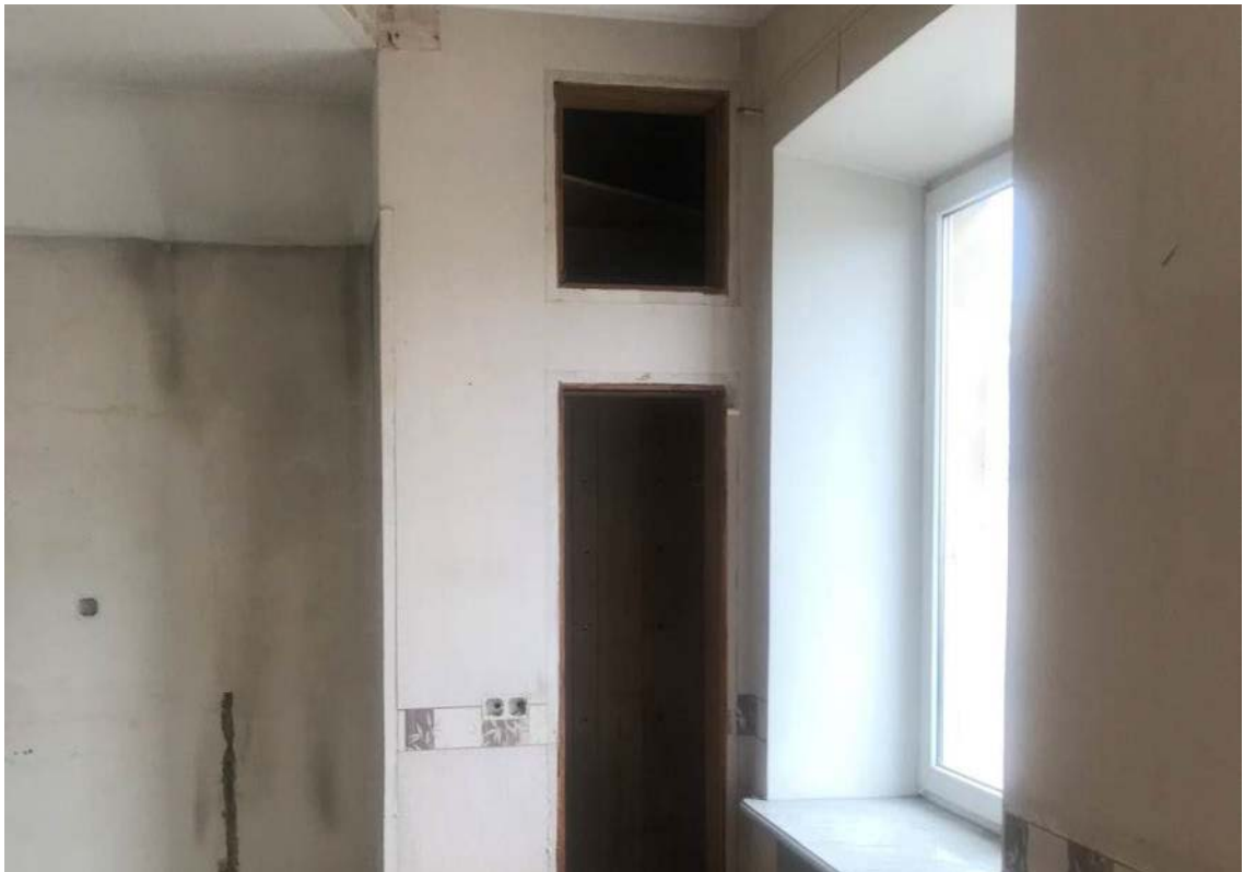
18. ОКН регионального значения «Дом М.П. Толстого» кв. 653
