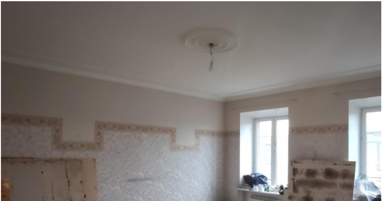
23. ОКН регионального значения «Дом М.П. Толстого» кв. 653
