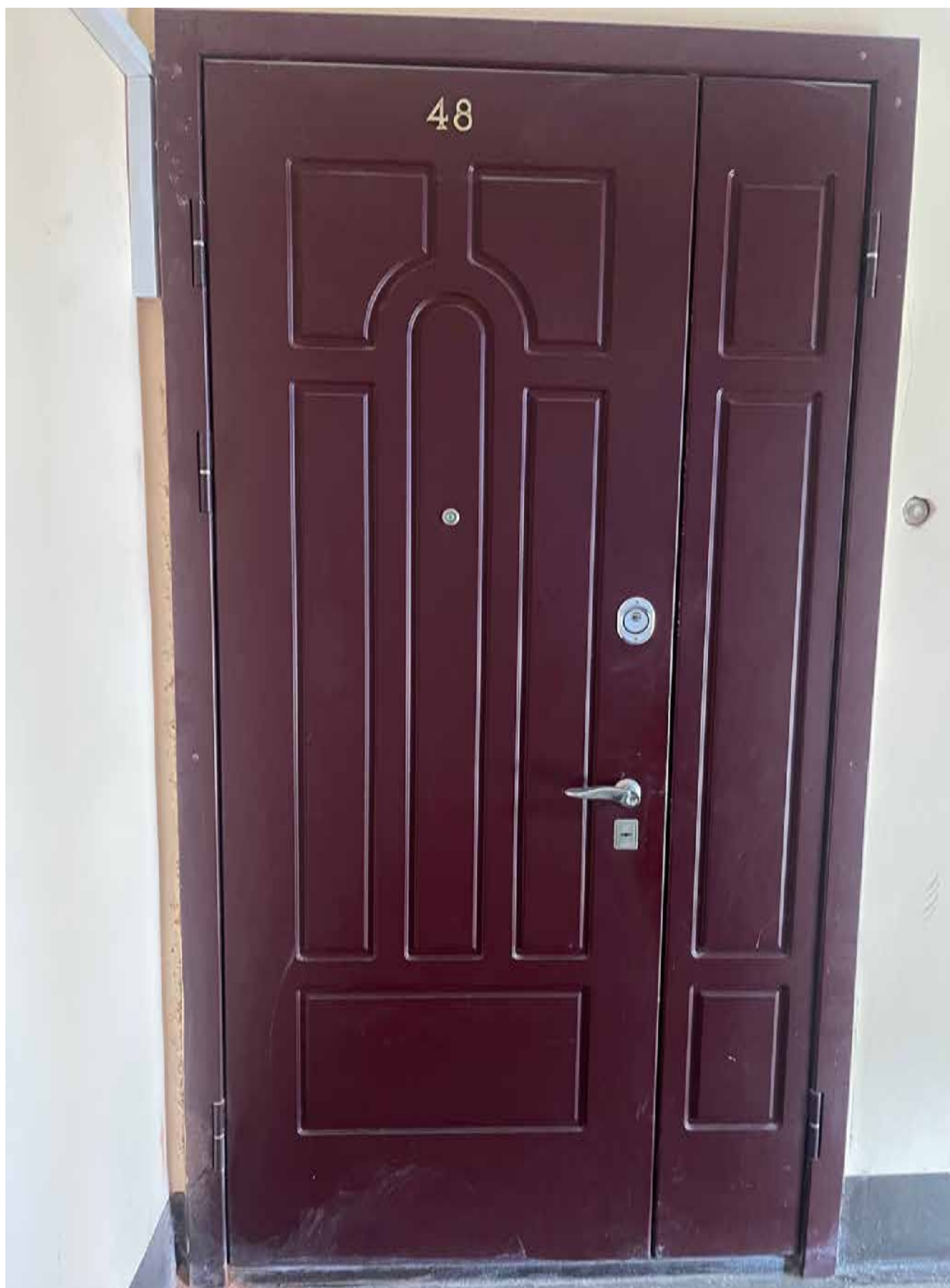
5. Входная дверь квартиры со стороны лестничной клетки.
