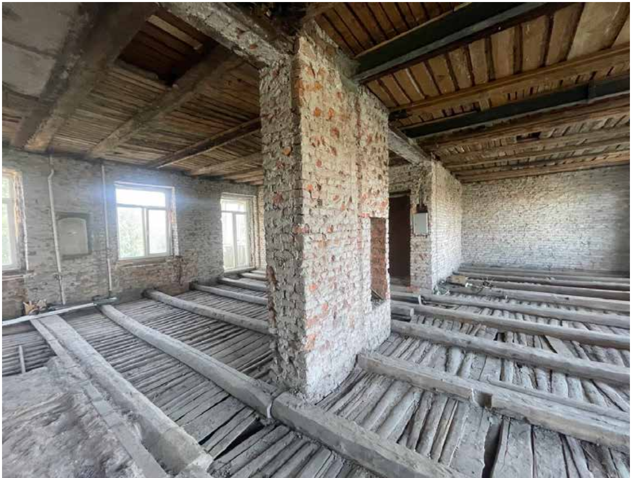
9. Общий вид помещений.
