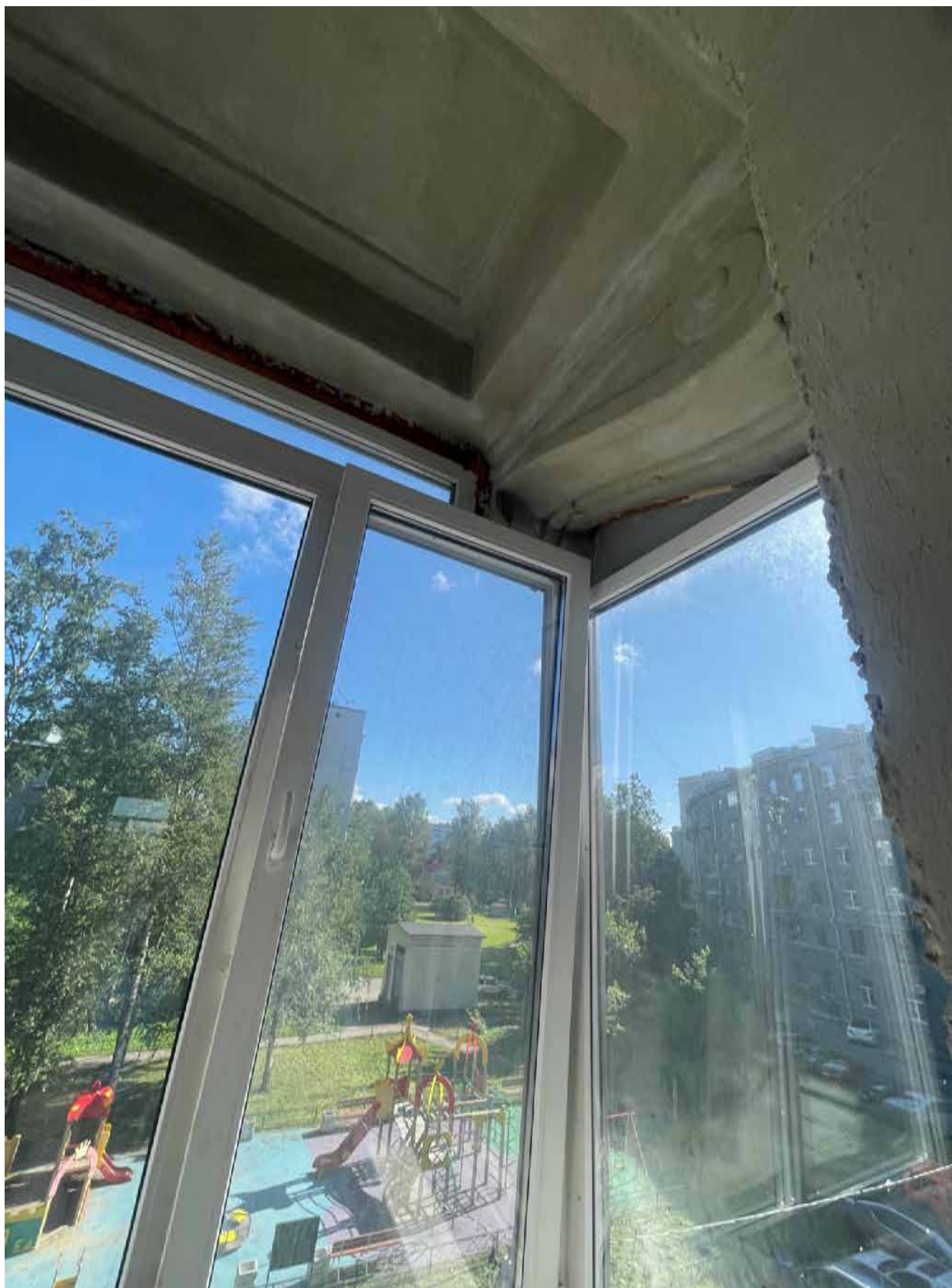
12. Балкон со стороны дворового фасада.
