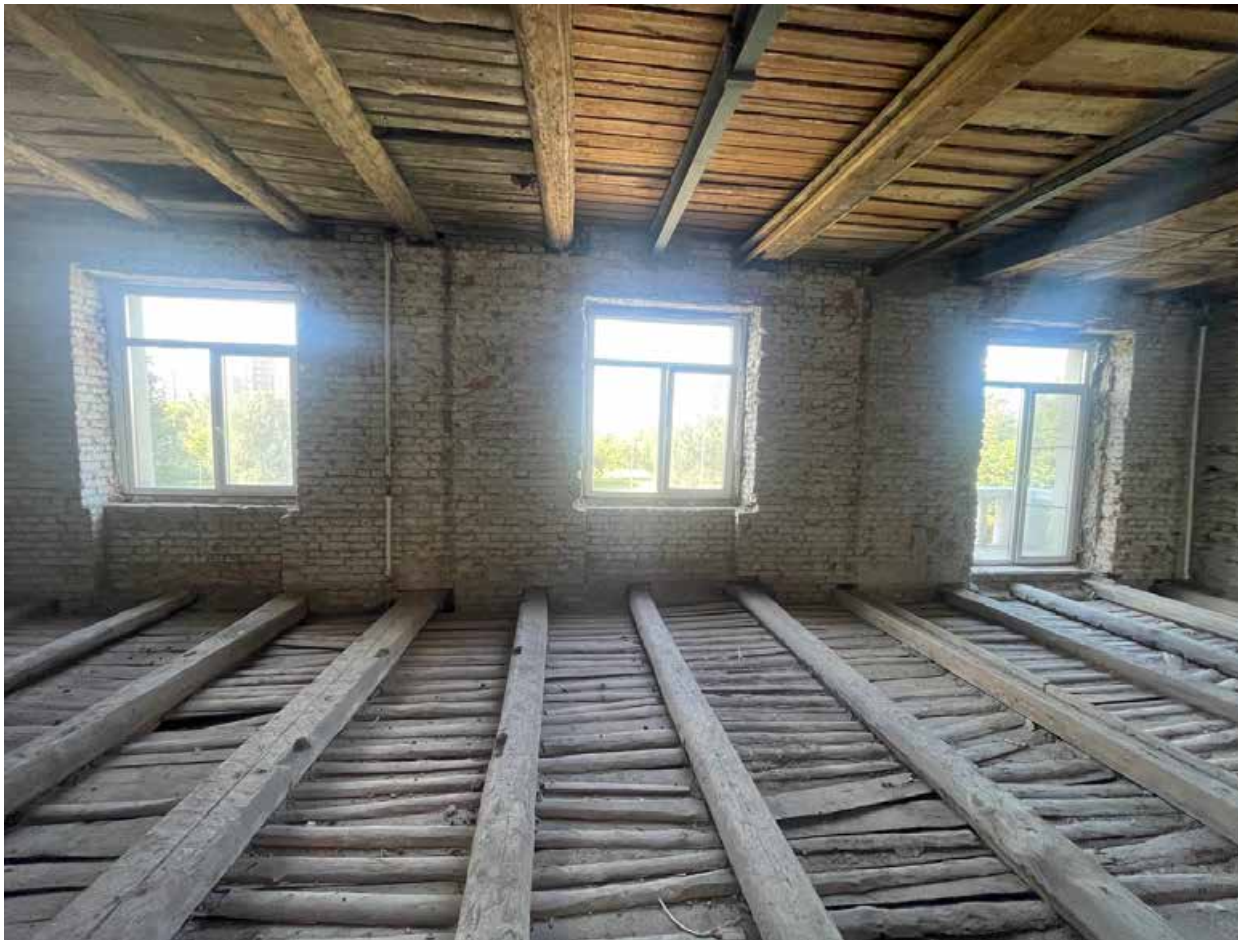
7. Помещение со стороны лицевого фасада.
