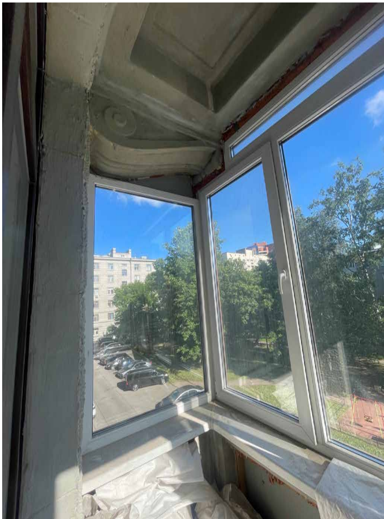
11. Балкон со стороны дворового фасада.
