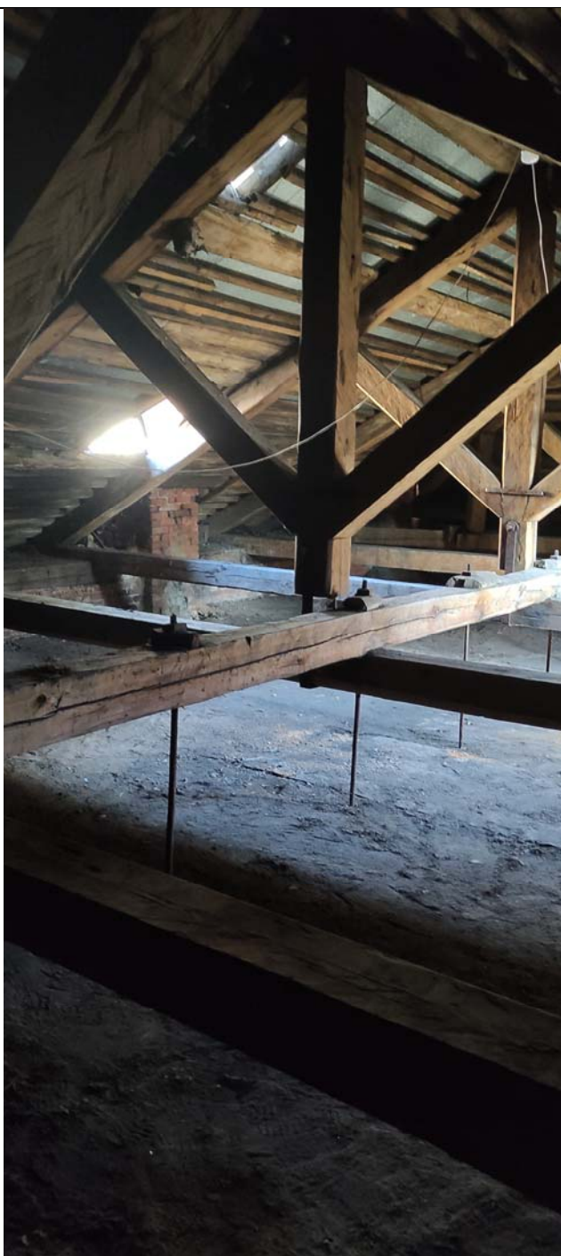
13.Анатомический театр». Стропильная система. Фрагмент.
