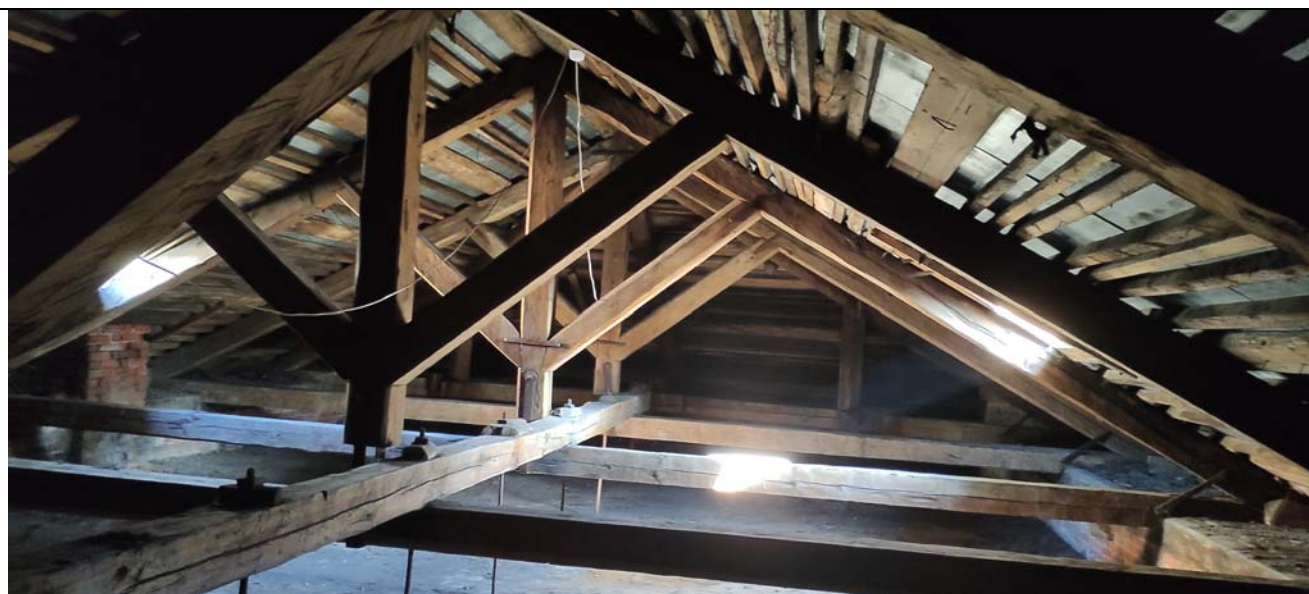
11. «Анатомический театр». Стропильная система. Общий вид.
