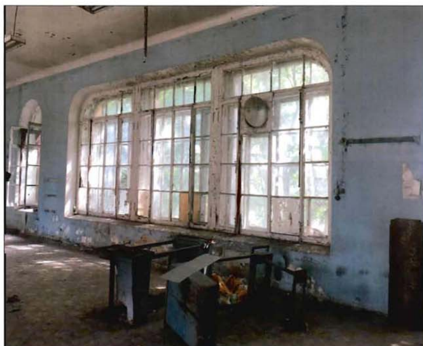
6. Интерьер помещения в уровне второго этажа.
