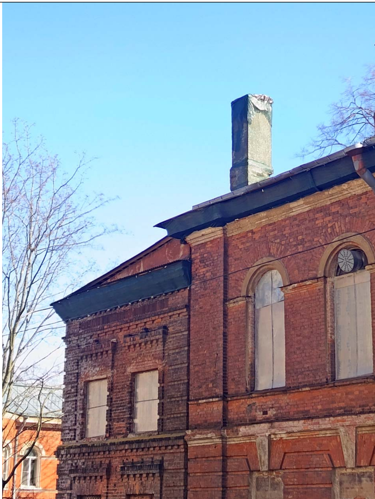
4. «Анатомический театр». Западный фасад. Кирпичная пристройка.
