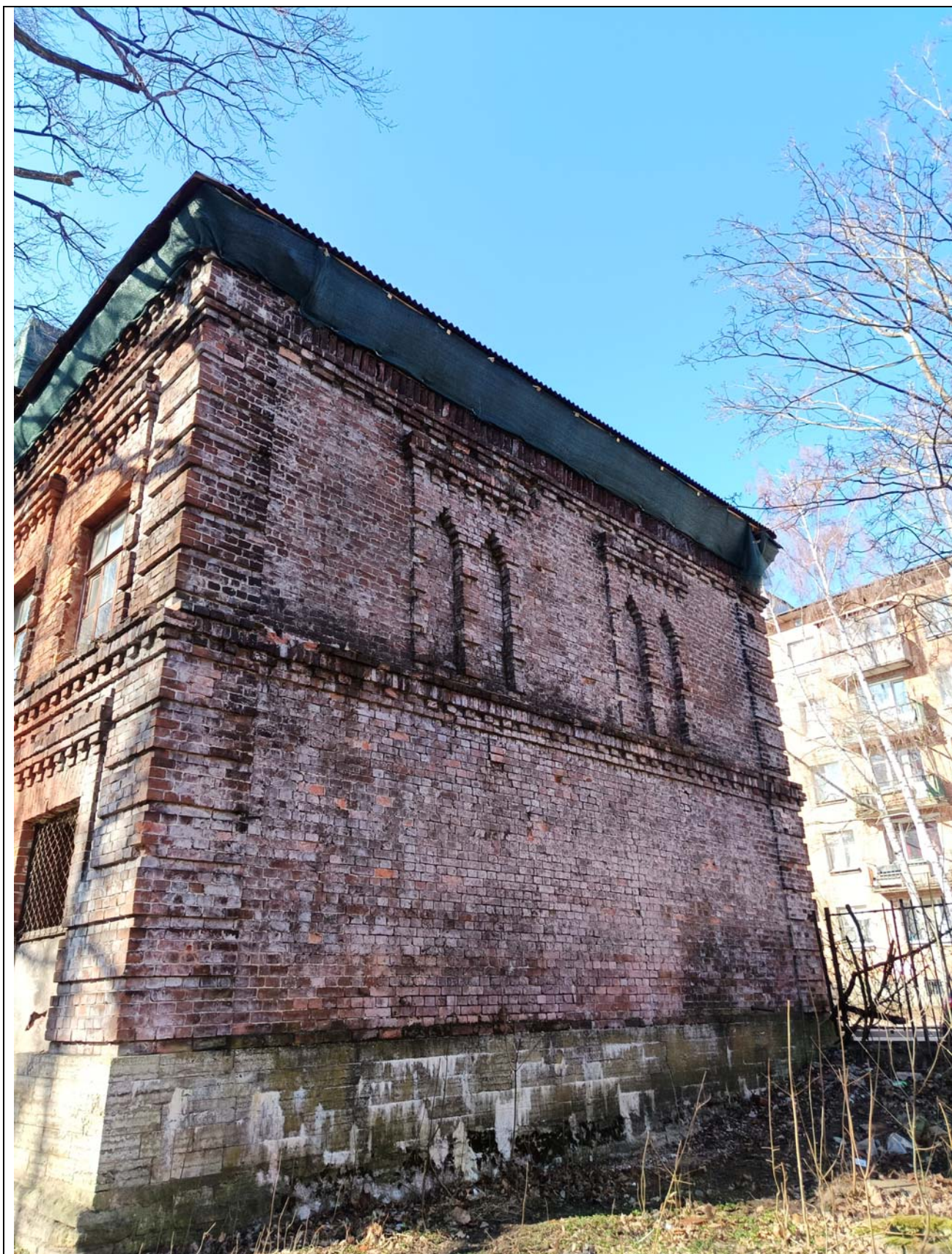
9. «Анатомический театр». Северный фасад кирпичной пристройки.
