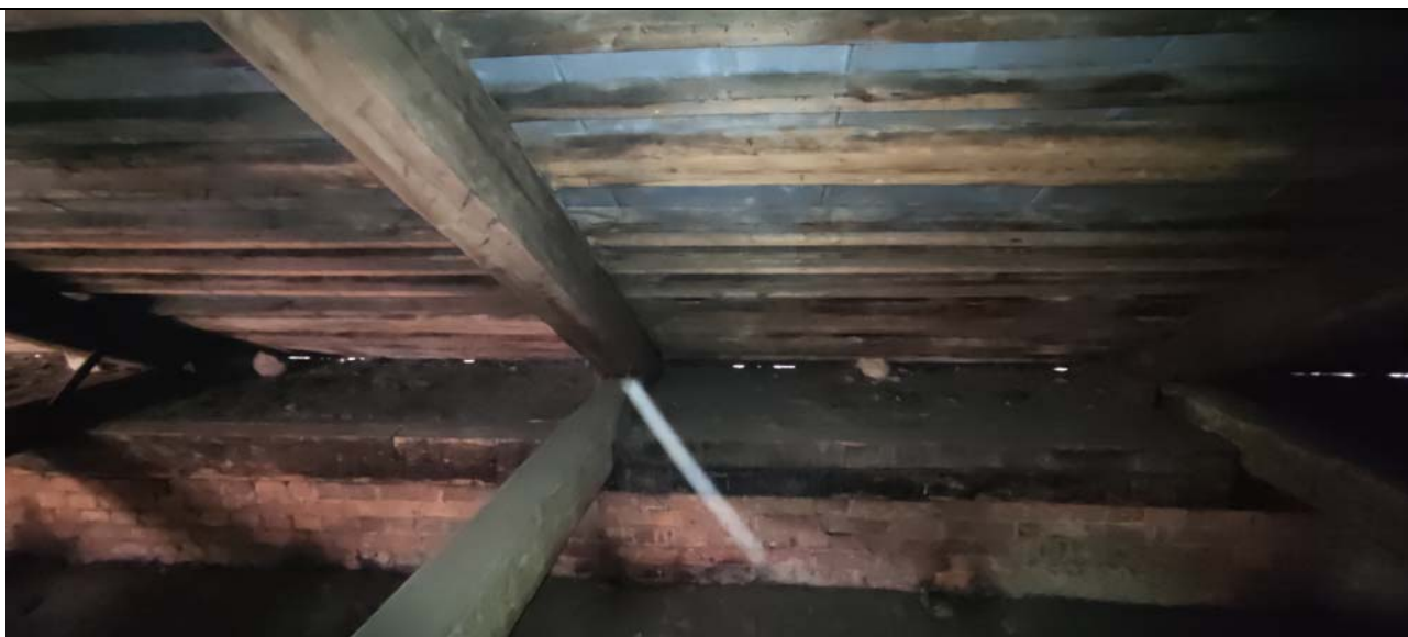
12. «Анатомический театр». Стропильная система. Фрагмент.
