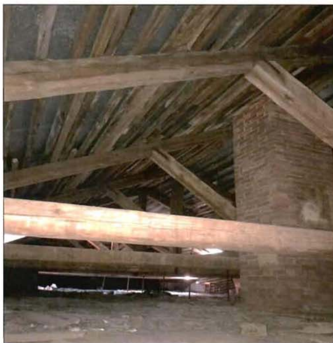
8. Фрагмент стропильной системы.
