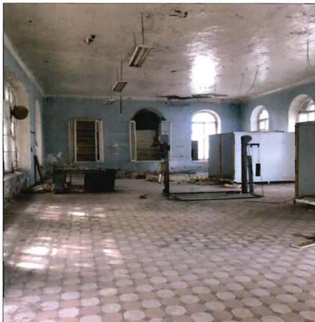
5. Интерьер помещения в уровне второго этажа.
