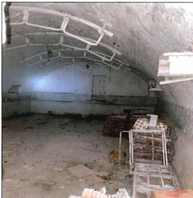
7. Фрагмент подвального помещения.
