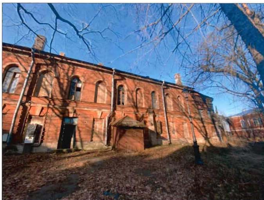
3. Вид на дворовый фасад.
