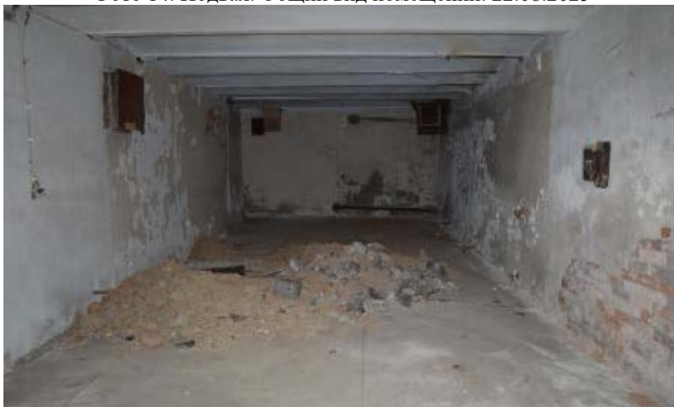
Фото 15. Подвал. Общий вид помещений. 22.08.2025
