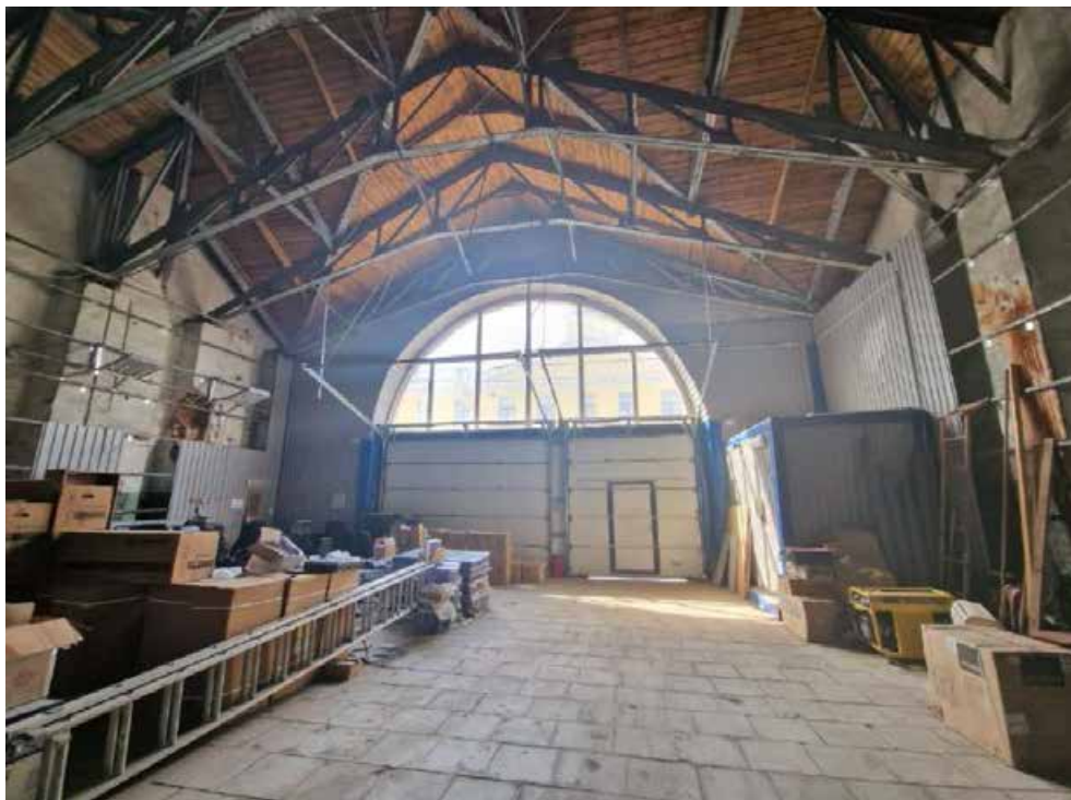
Фото 22. Первый этаж. Общий вид помещений первого этажа. 22.08.2025
