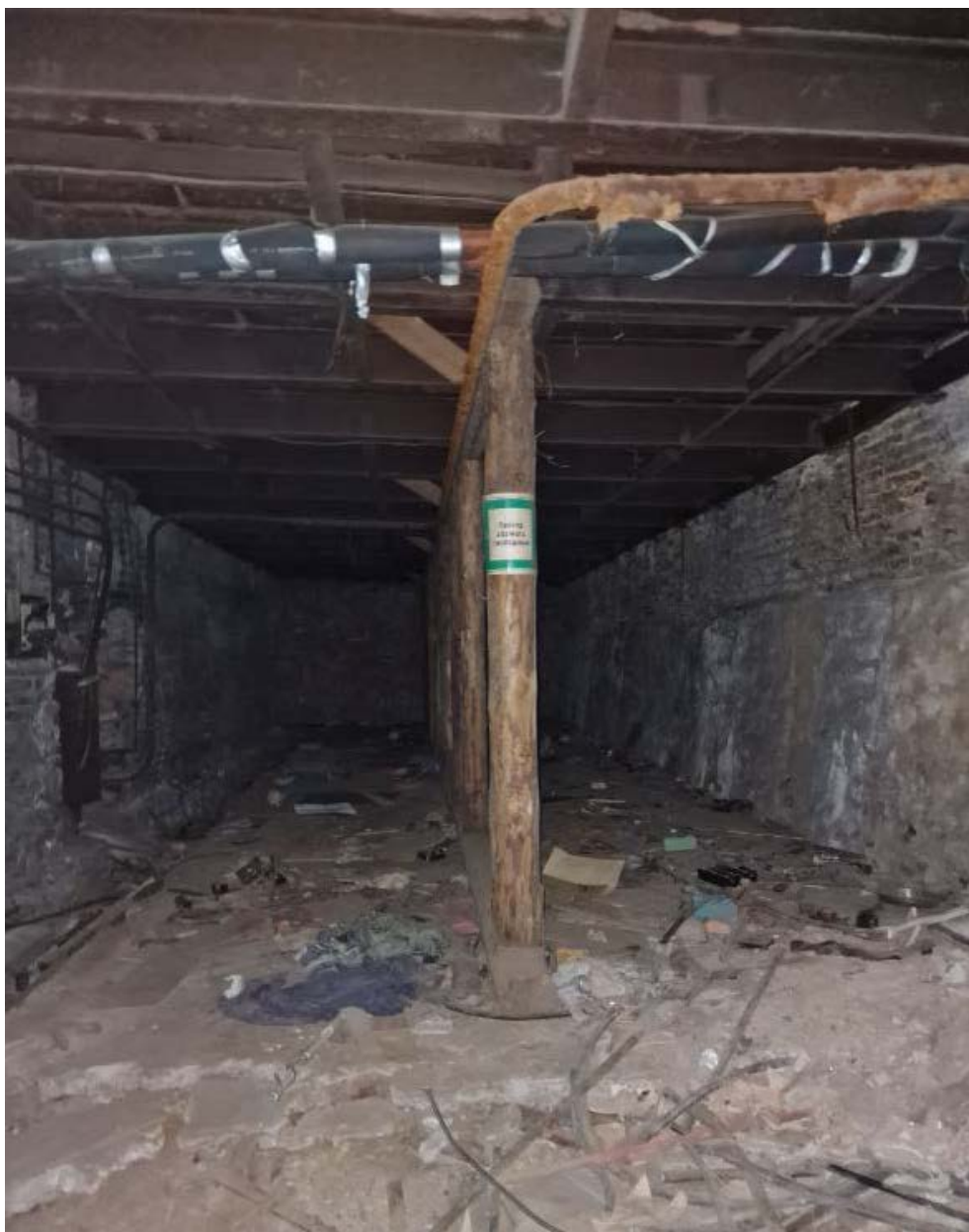
Фото 14. Подвал. Общий вид помещений. 22.08.2025
