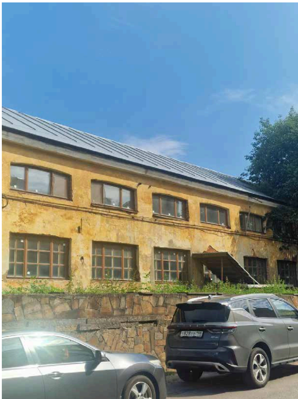
Фото 6. Фрагмент фасада. Место для размещения мусорных баков. ИТП. 22.08.2025
