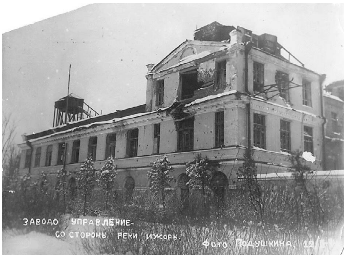
Илл. 27. Здание заводоуправления. Фото 1942 г. Из фондов МИЗ
