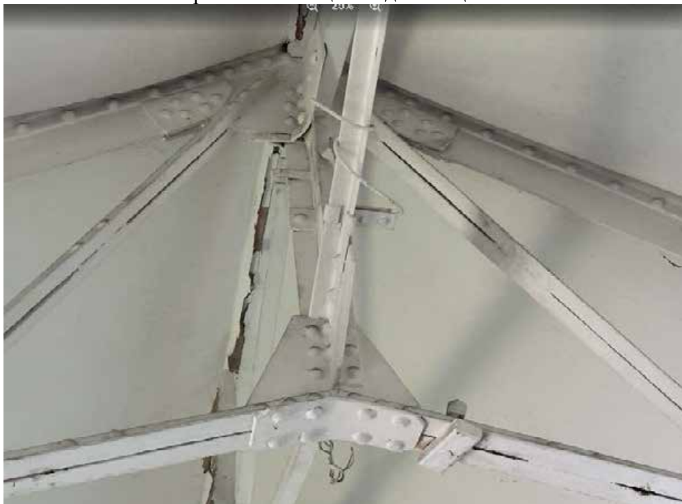
Фото 28. Второй этаж. Фрагмент металлической фермы. 22.08.2025
