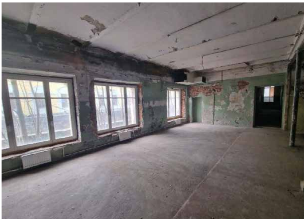
Фото 19. Первый этаж. Общий вид помещений первого этажа. 22.08.2025
