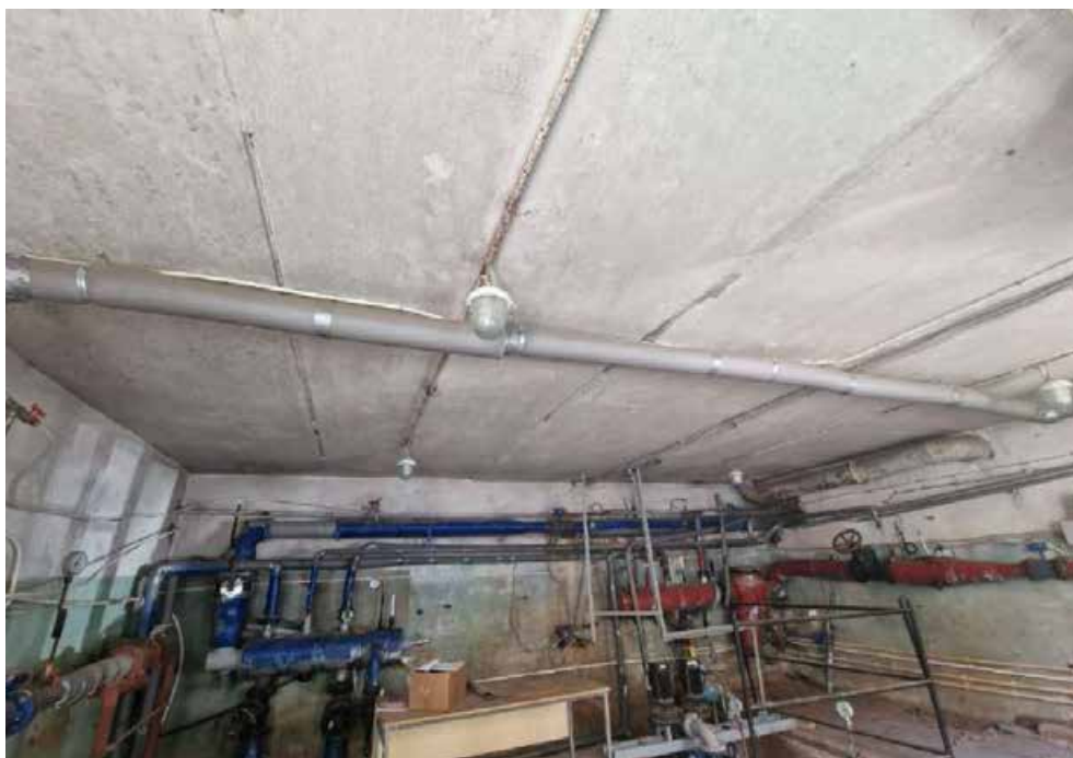
Фото 24. Первый этаж. Общий вид помещений первого этажа. 22.08.2025
