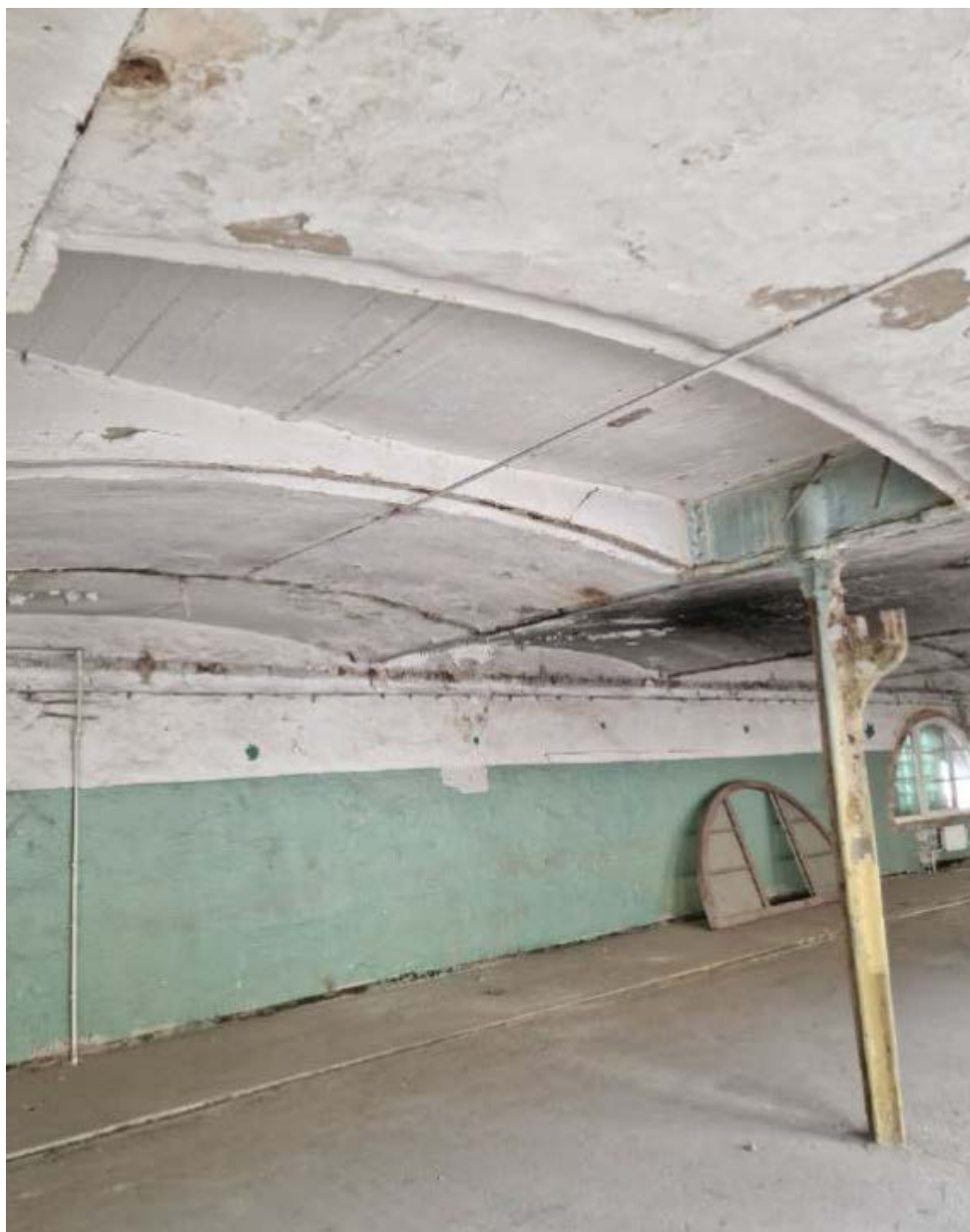
Фото 21. Первый этаж. Общий вид помещений первого этажа. 22.08.2025
