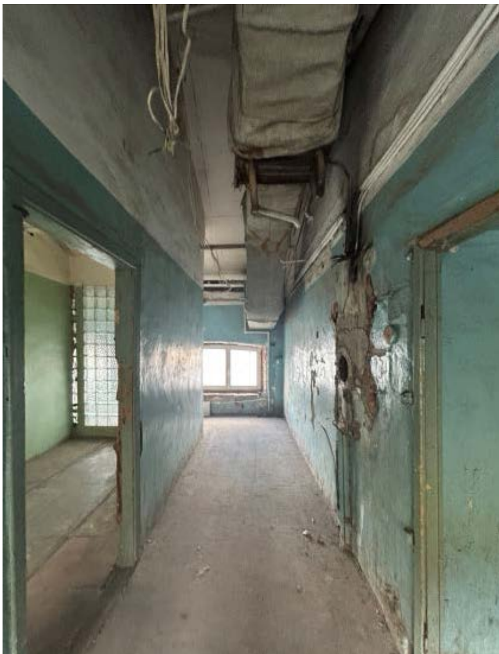
Фото 25. Второй этаж. Общий вид помещений. 22.08.2025
