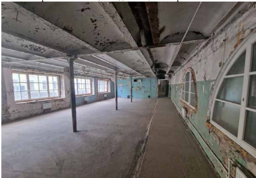
Фото 20. Первый этаж. Общий вид помещений первого этажа. 22.08.2025
