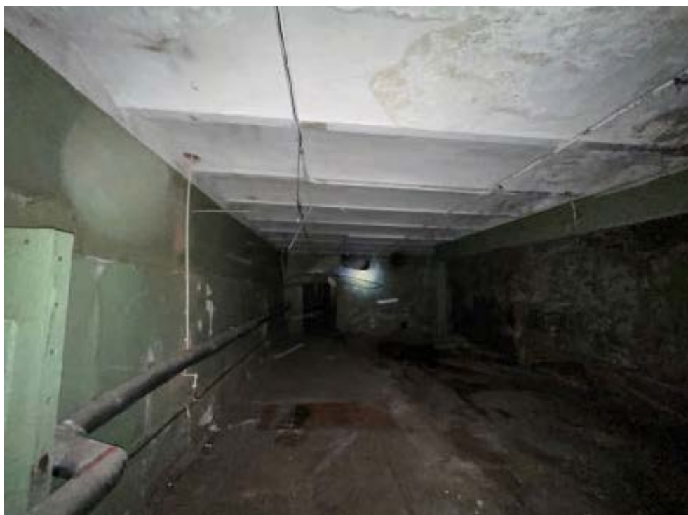
Фото 16. Подвал. Общий вид помещений. 22.08.2025
