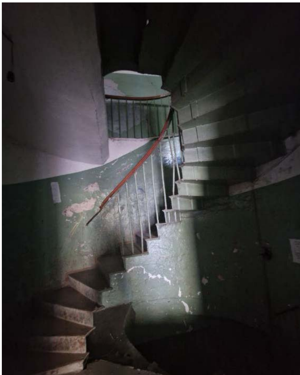
Фото 13. Подвал. Спуск со стороны винтовой лестницы.
