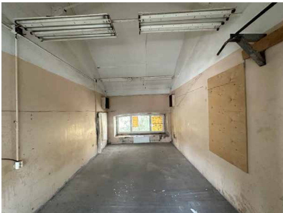
Фото 29. Второй этаж. Фрагмент металлической фермы. 22.08.2025
