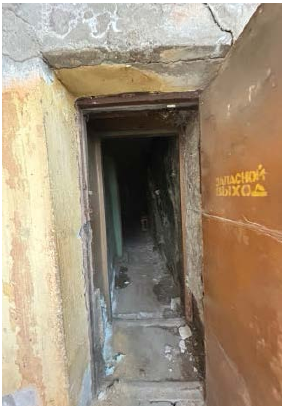
Фото 18. Подвал. Вход со стороны поздней пристройки. 22.08.2025
