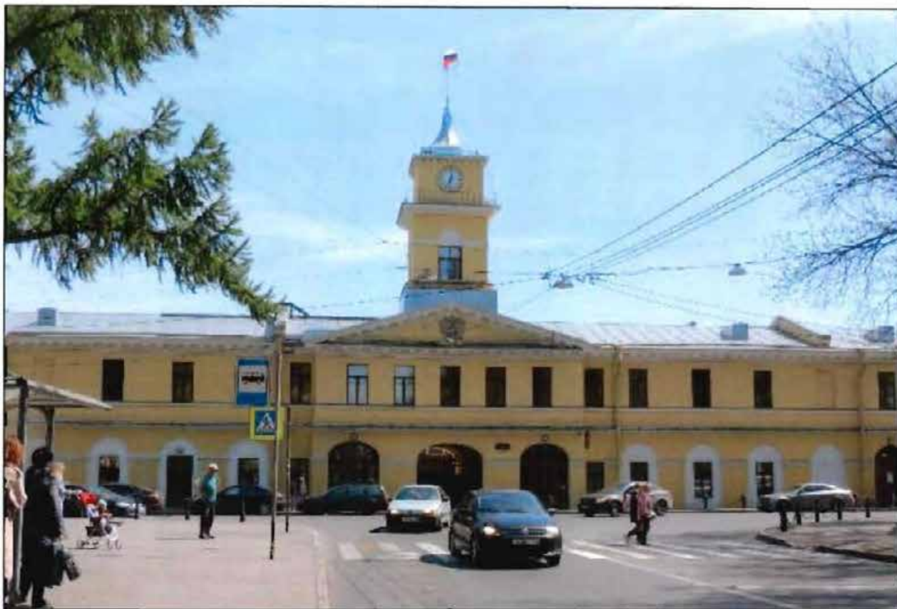
2. Лицевой западный фасад объекта культурного наследия. Фрагмент.
