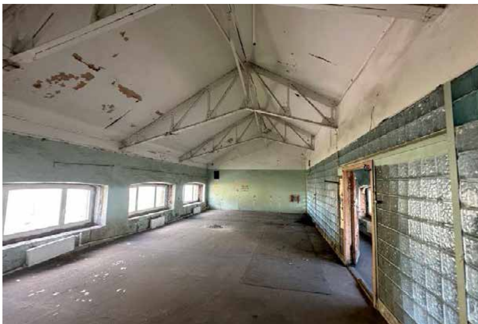
Фото 27. Второй этаж. Общий вид помещений. 22.08.2025
