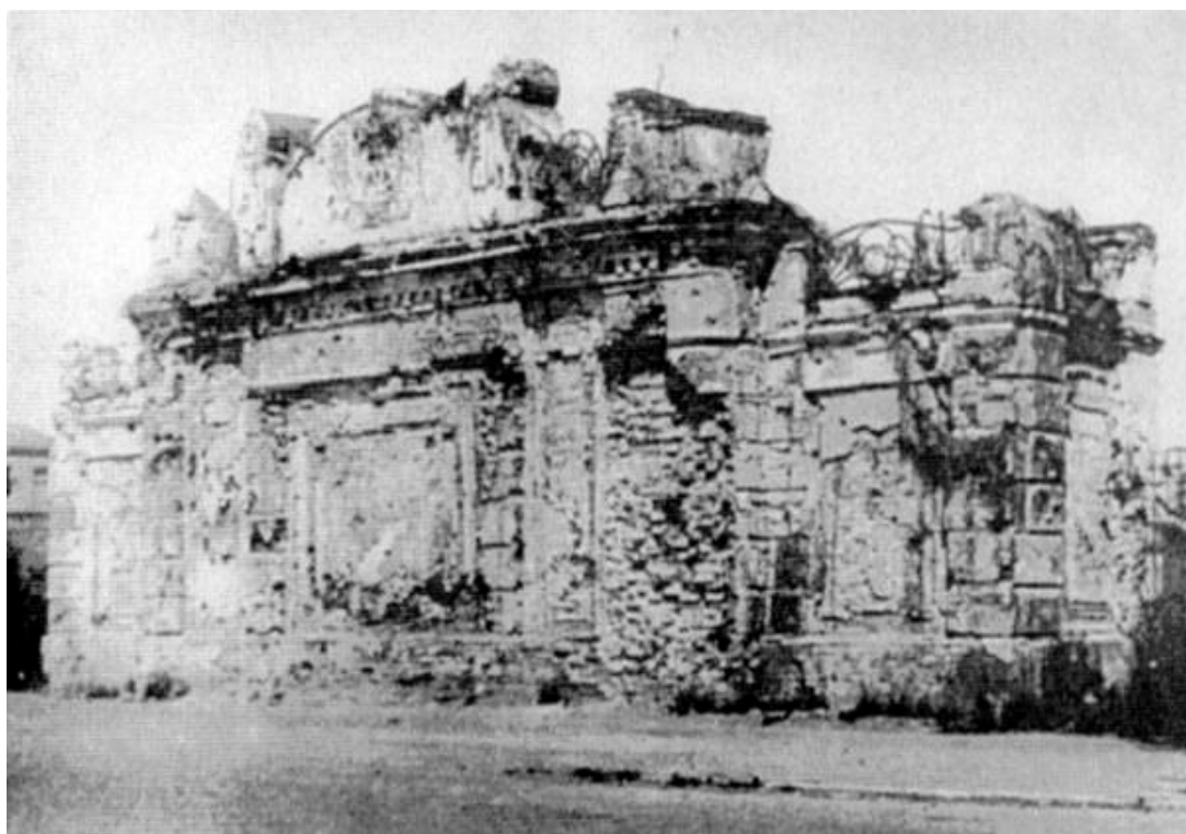
Илл. 24. Стена на главной плотине в годы блокады. Сизенов Е.П., Иволга Р.С., Ефимова Г.А. История Колпина. СПб, 2007 г.
