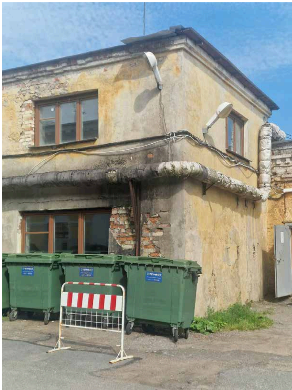
Фото 5. Фрагмент фасада. Место для размещения мусорных баков. ИТП. 22.08.2025
