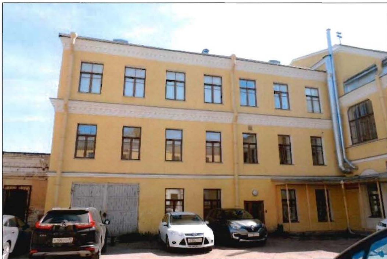
7. Западный дворовый фасад объекта культурного наследия.
