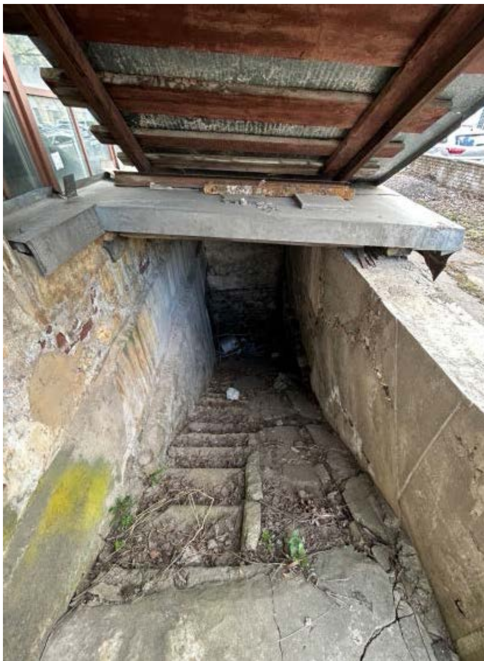
Фото 12. Подвал. Спуск со стороны подворной стенки.
