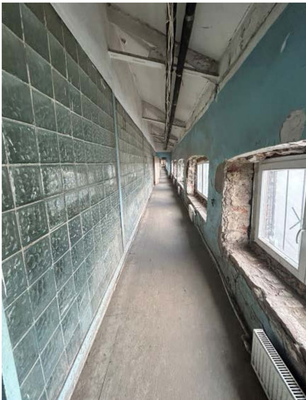
Фото 26. Второй этаж. Общий вид помещений. 22.08.2025
