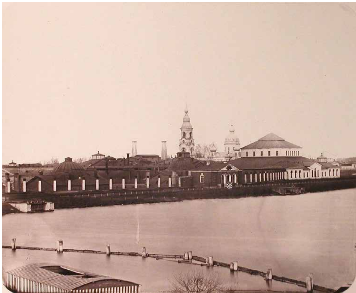
Илл. 16. Главная плотина. Цепная кузница. Сборочная. Фото 1866 г. Из альбома «Виды Ижевского завода». 1866 г
