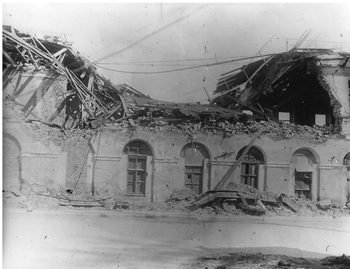
Илл. 28. Здание заводоуправления. Фото 1942 г. Из фондов МИЗ
