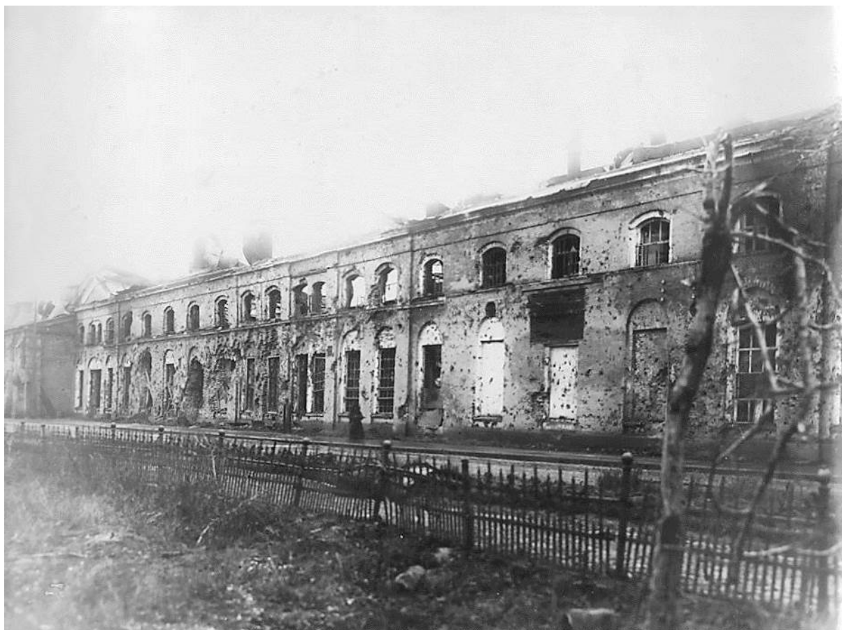
Илл. 25. Здание заводоуправления. Фото 1942 г. Из фондов МИЗ
