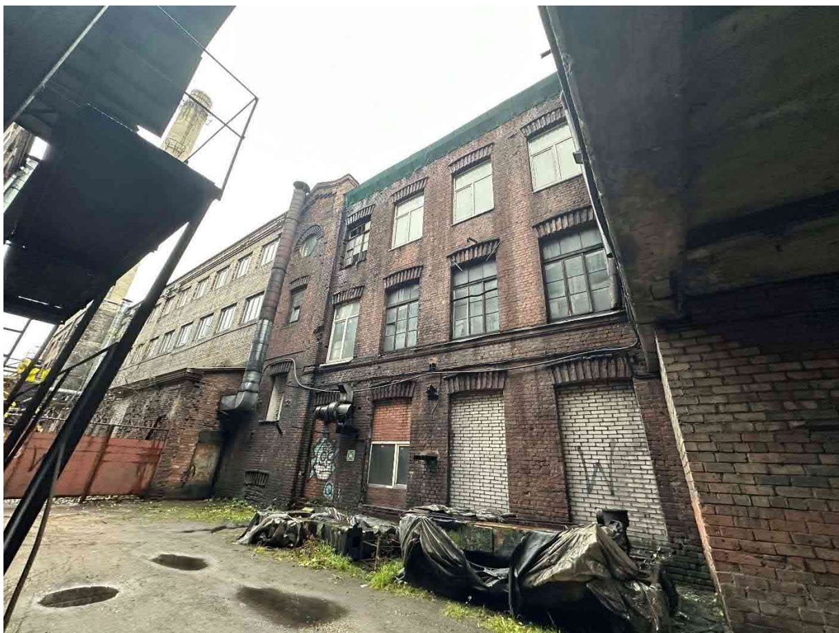
Фото 19. Общий вид здания.
