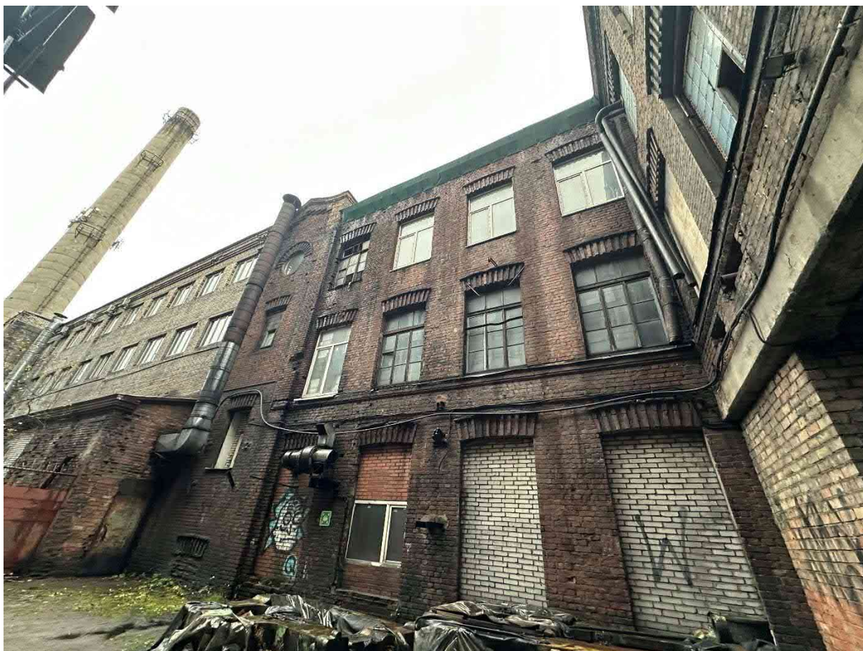
Фото 20. Общий вид здания.
