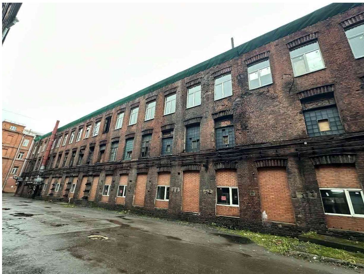
Фото 6. Общий вид здания
