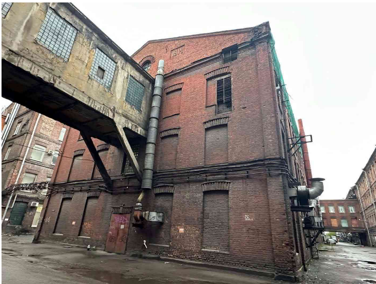
Фото 11. Общий вид здания.
