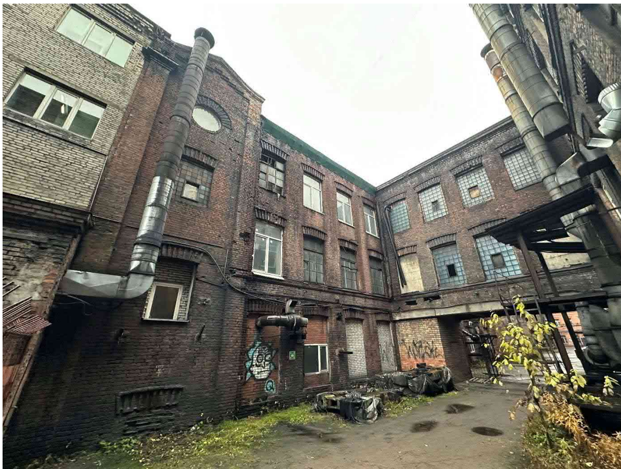
Фото 21. Общий вид здания.
