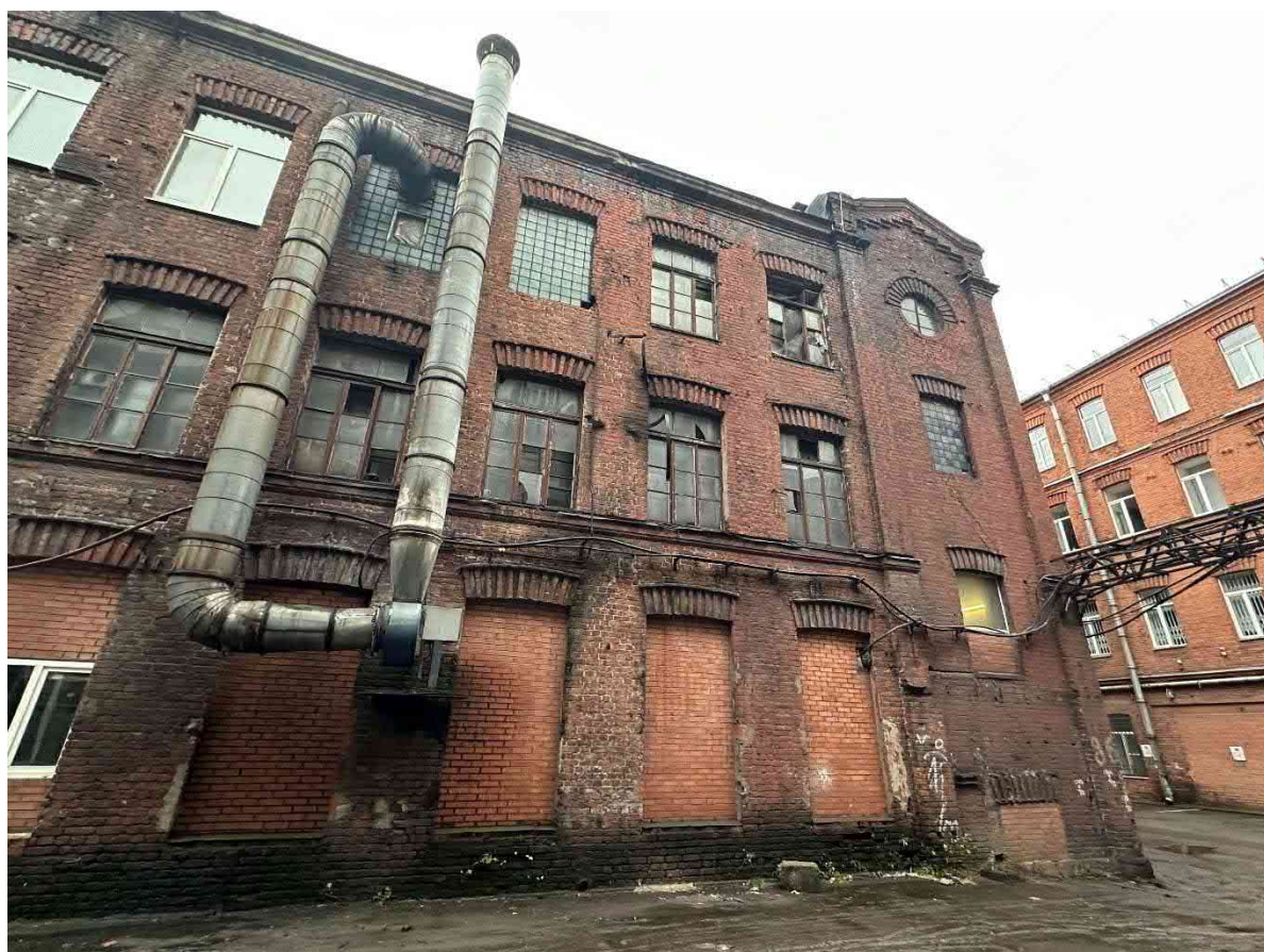
Фото 14. Общий вид здания.
