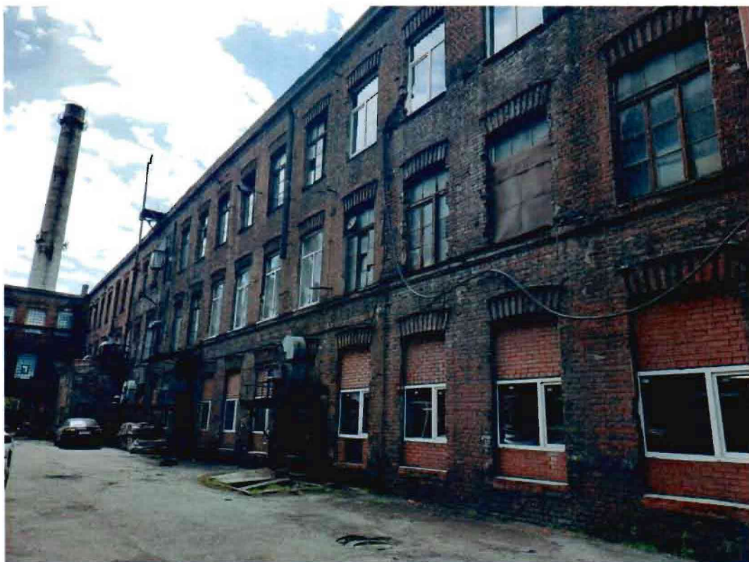
7. Фрагмент восточного фасада объекта культурного наследия
