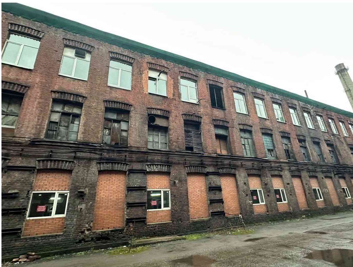
Фото 3. Общий вид здания
