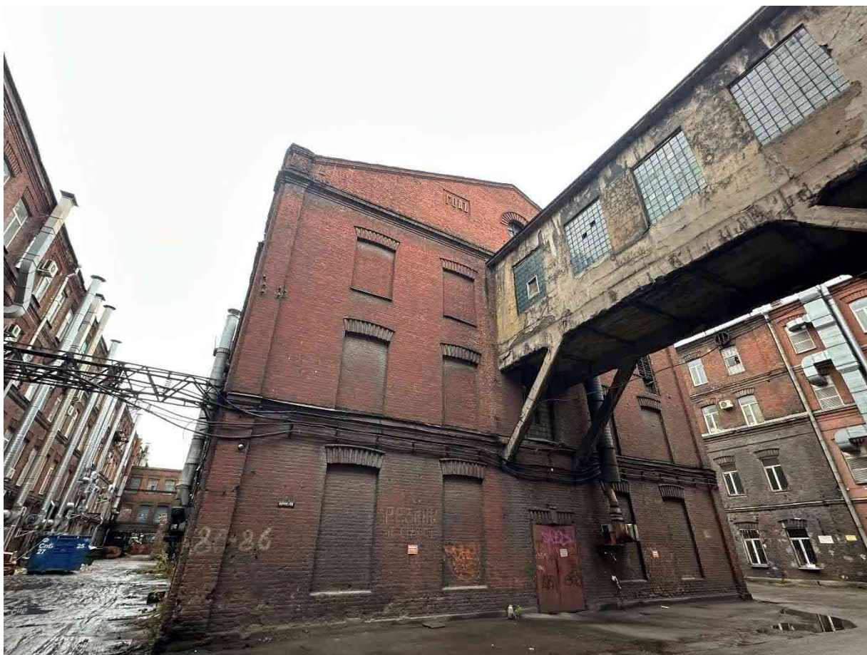
Фото 12. Общий вид здания.
