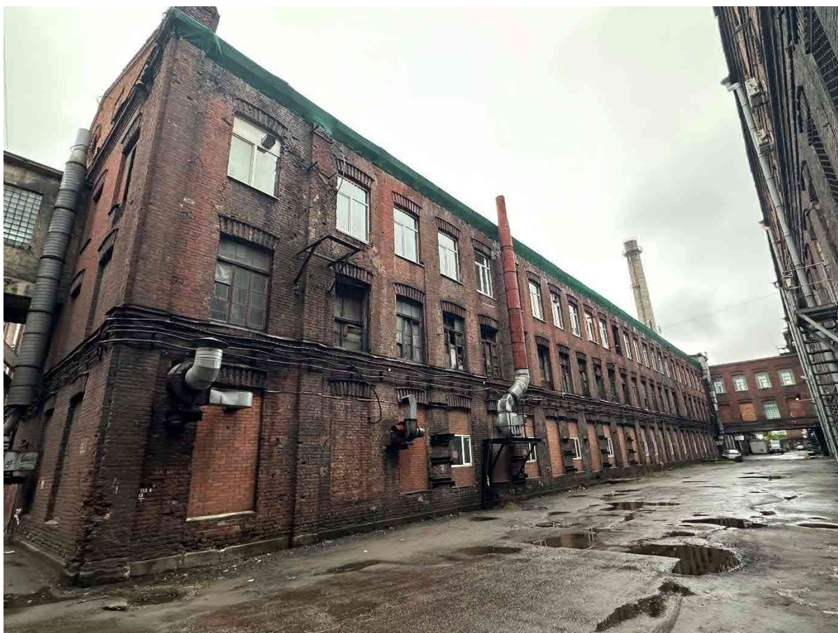
Фото 1. Общий вид здания
