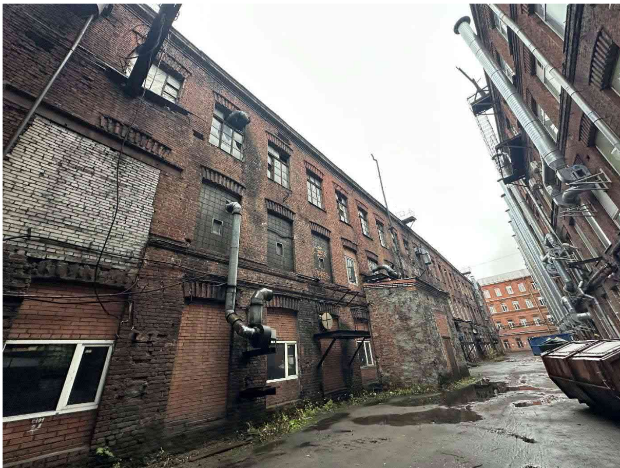
Фото 22. Общий вид здания.
