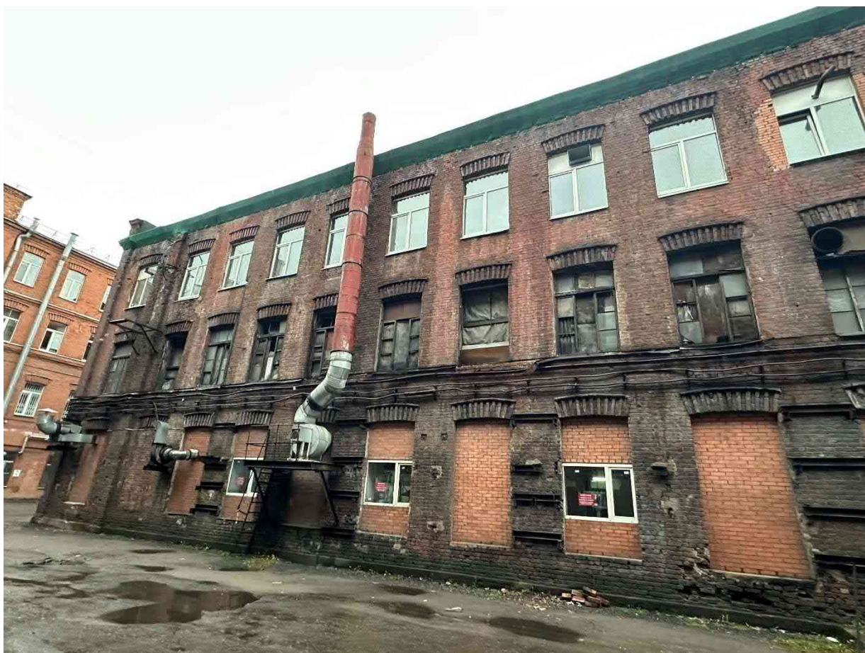
Фото 2. Общий вид здания
