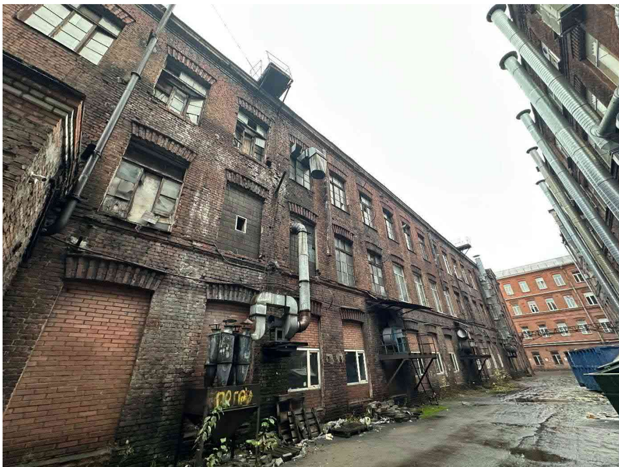
Фото 23. Общий вид здания.
