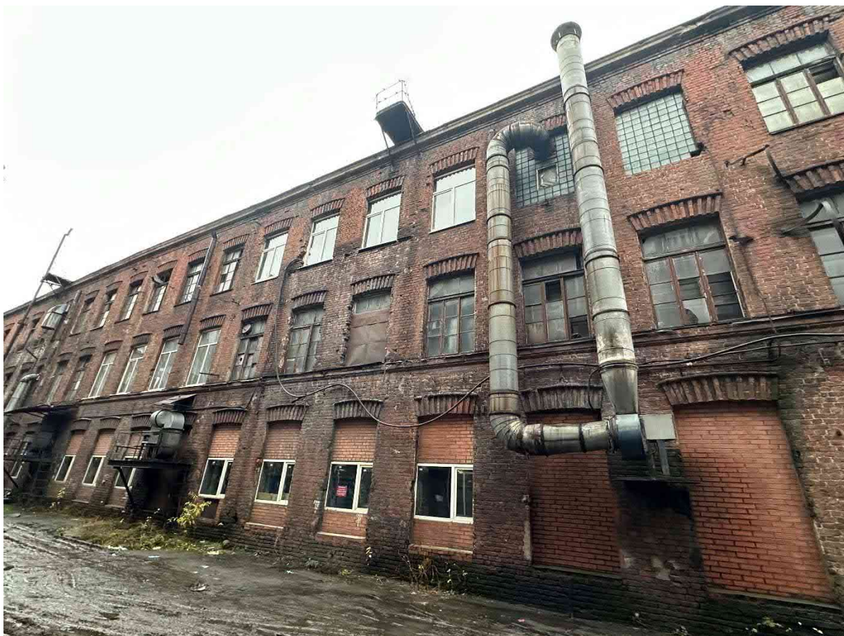
Фото 15. Общий вид здания.
