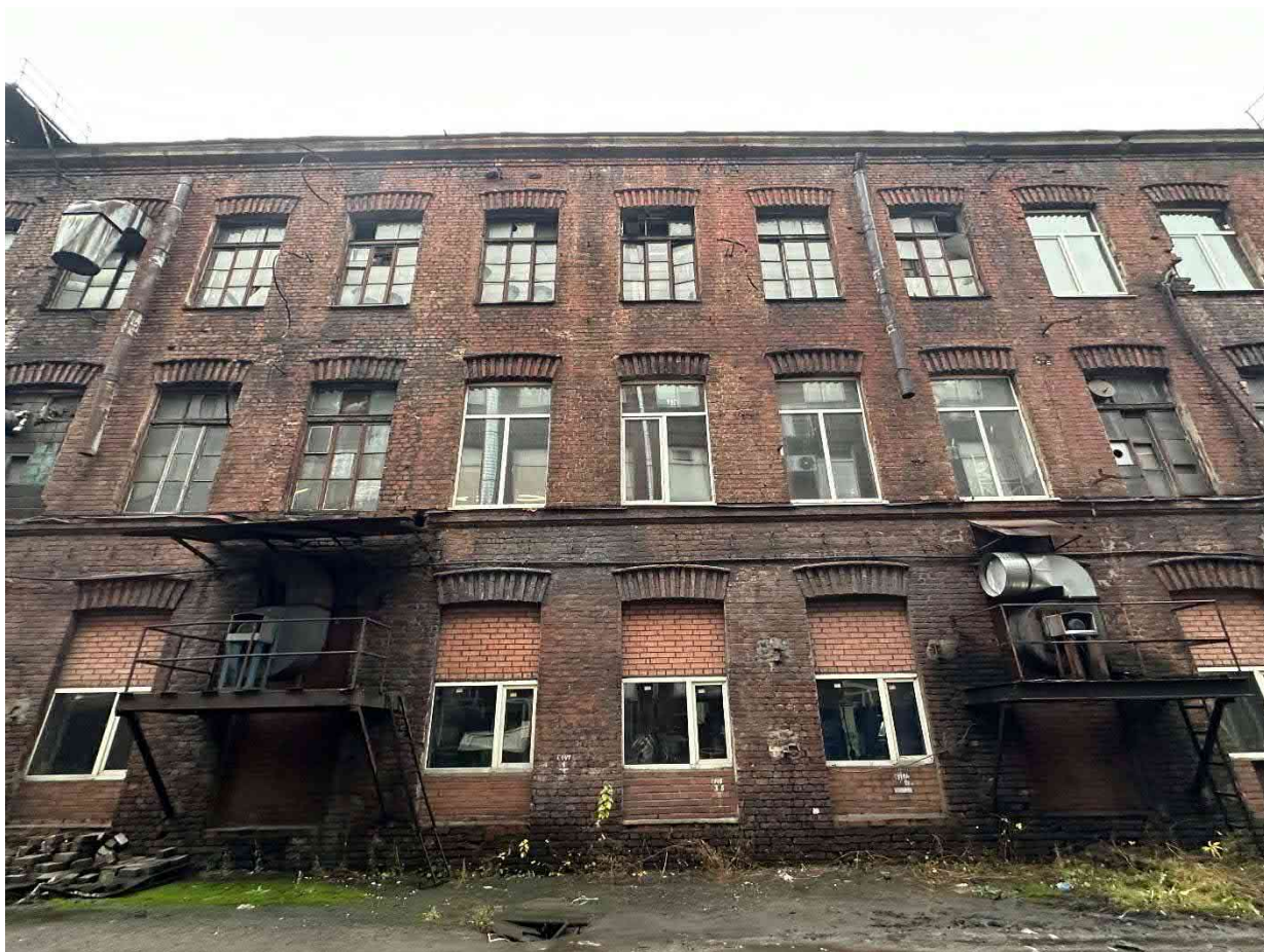
Фото 16. Общий вид здания.
