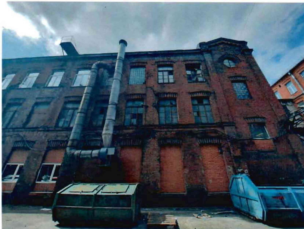
8. Фрагмент восточного фасада объекта культурного наследия
