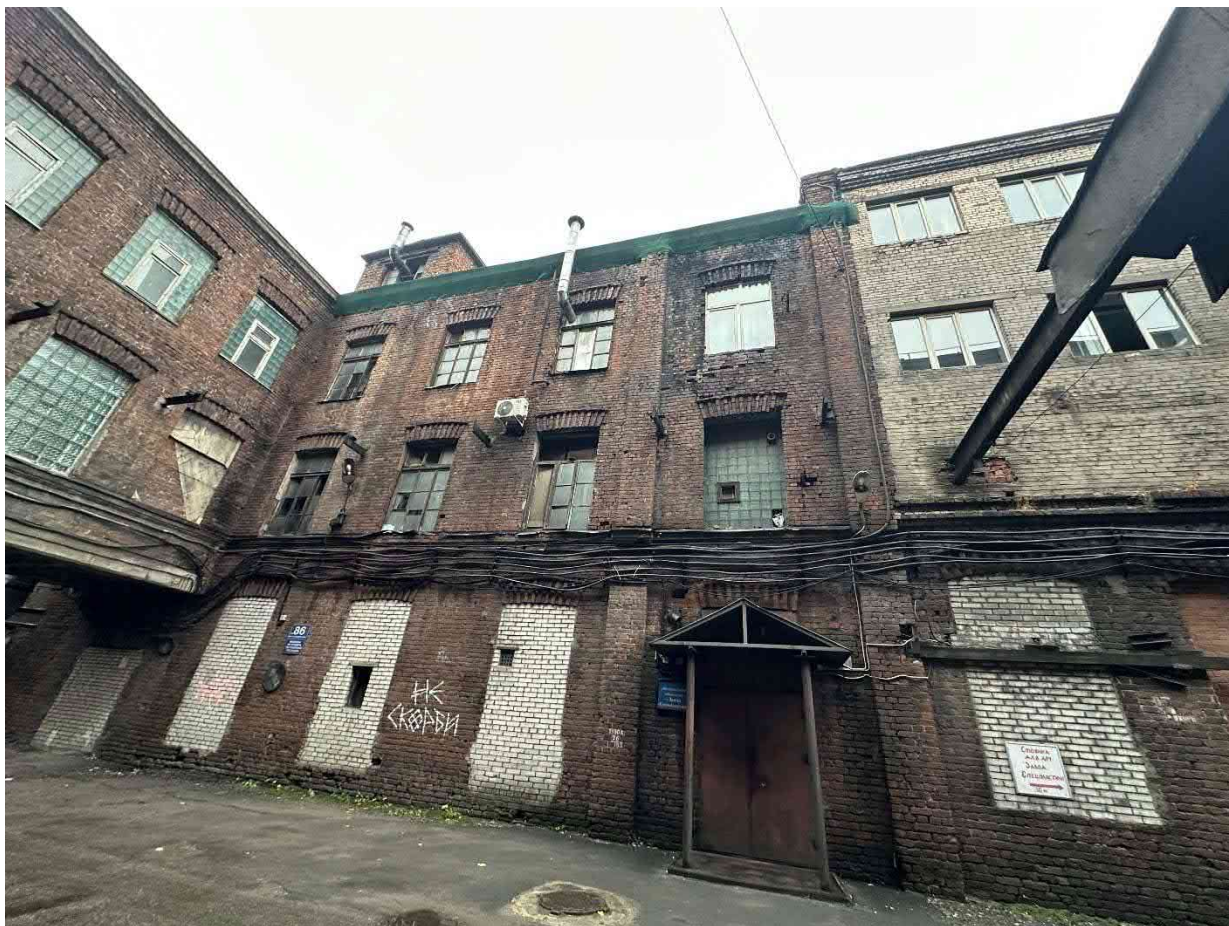
Фото 9. Общий вид здания.
