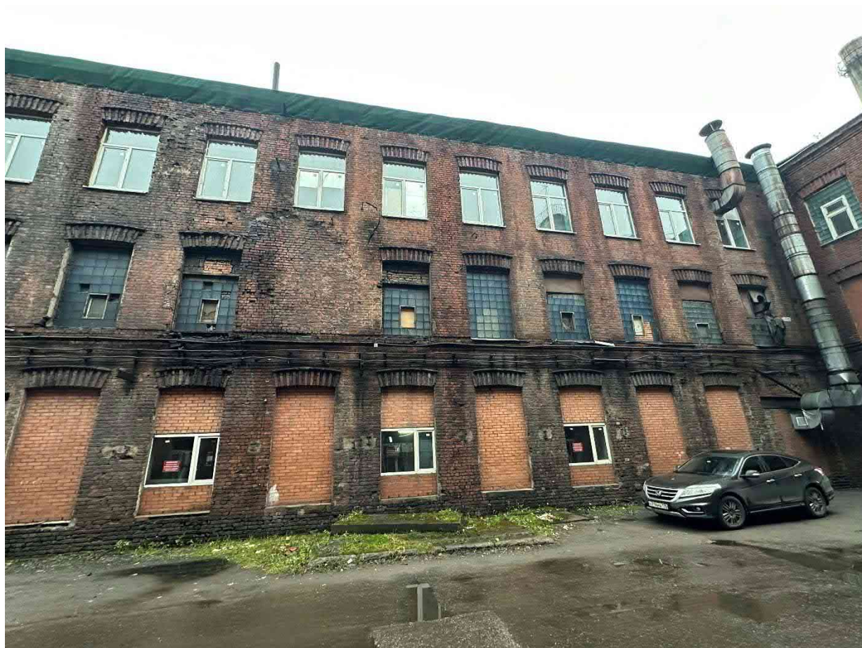
Фото 5. Общий вид здания
