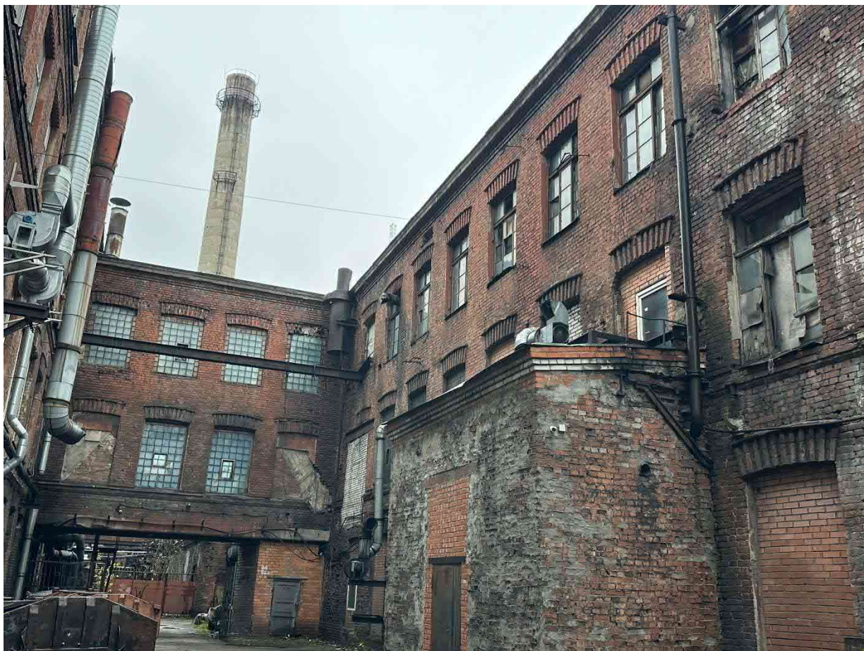
Фото 17. Общий вид здания. Галерея
