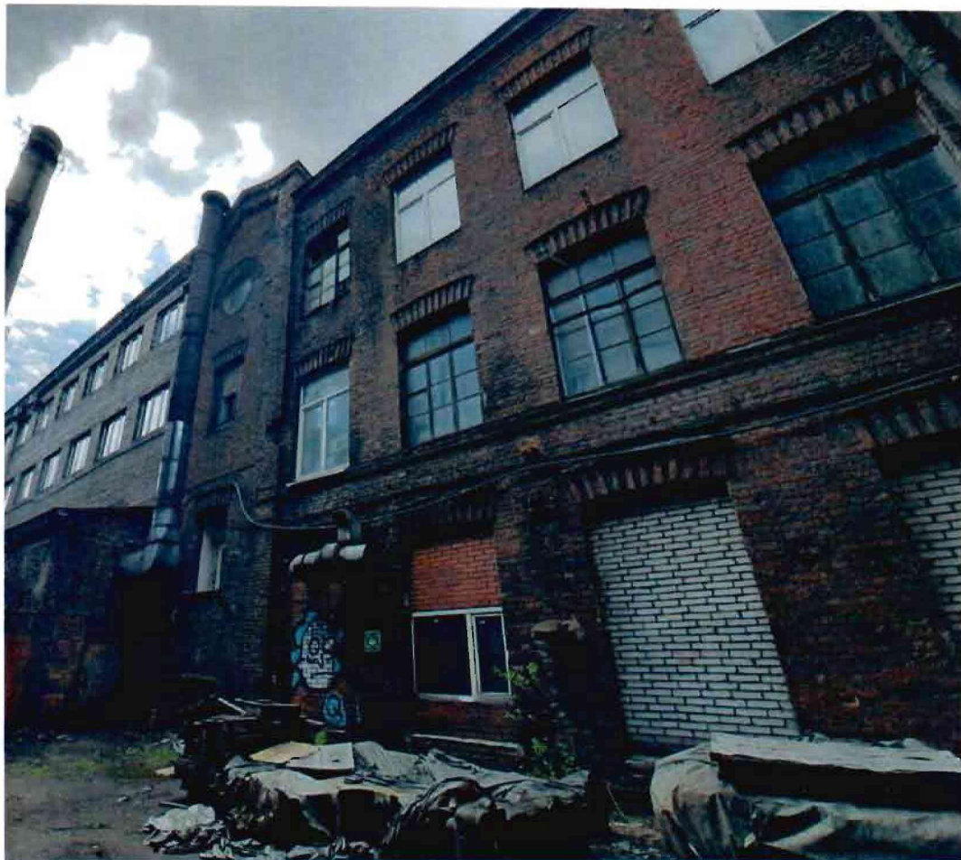
6. Фрагмент восточного фасада объекта культурного наследия
