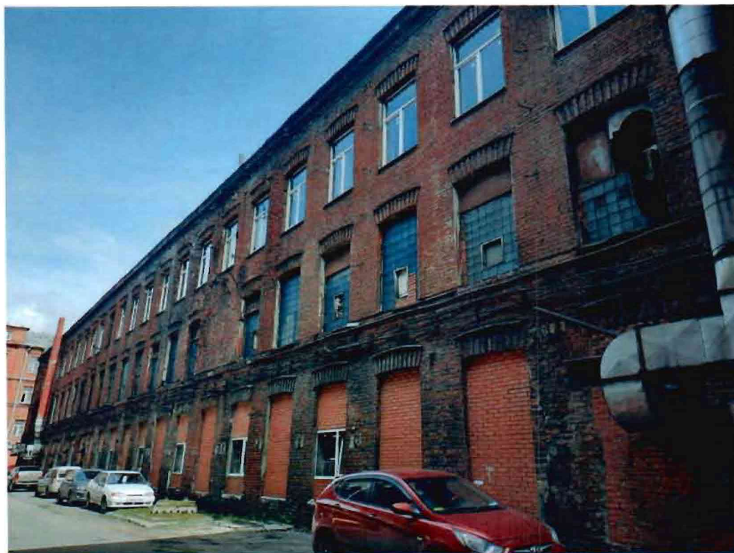
1. Фрагмент западного фасада объекта культурного наследия
