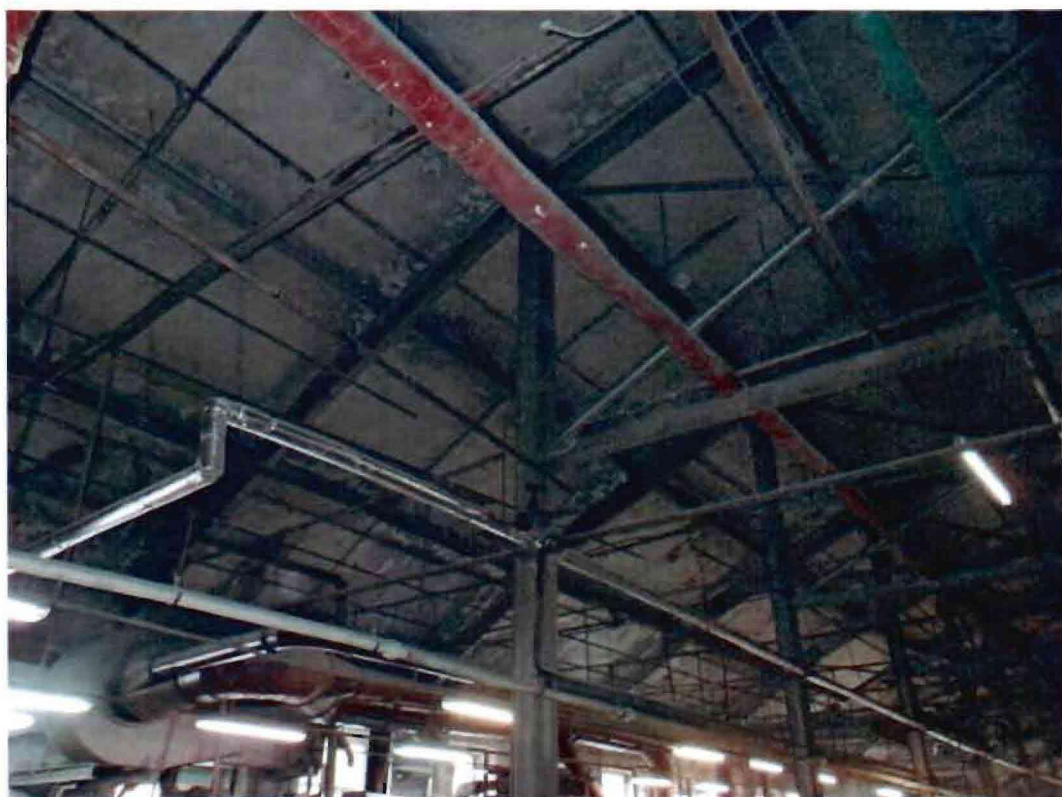
11. Помещения объекта культурного наследия
