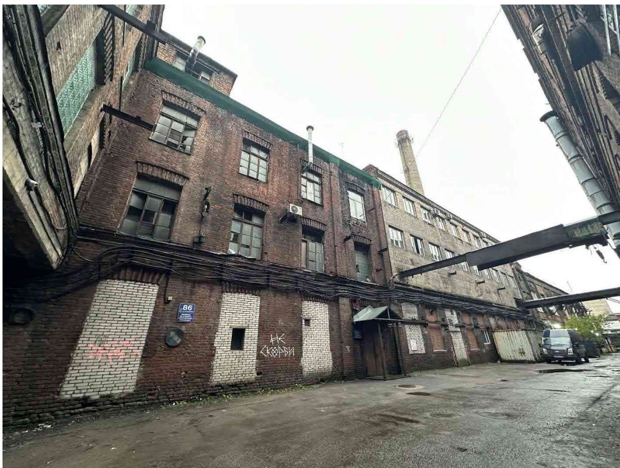
Фото 8. Общий вид здания
