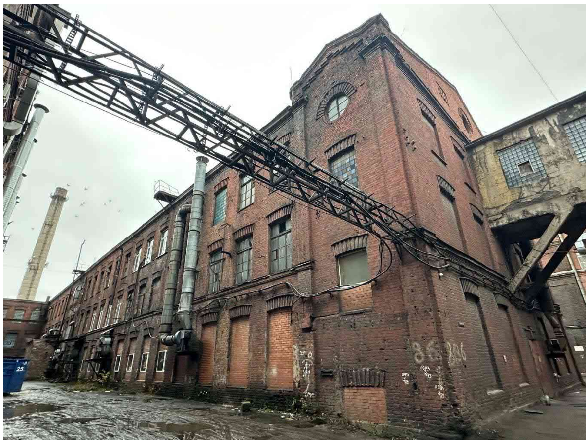
Фото 13. Общий вид здания.
