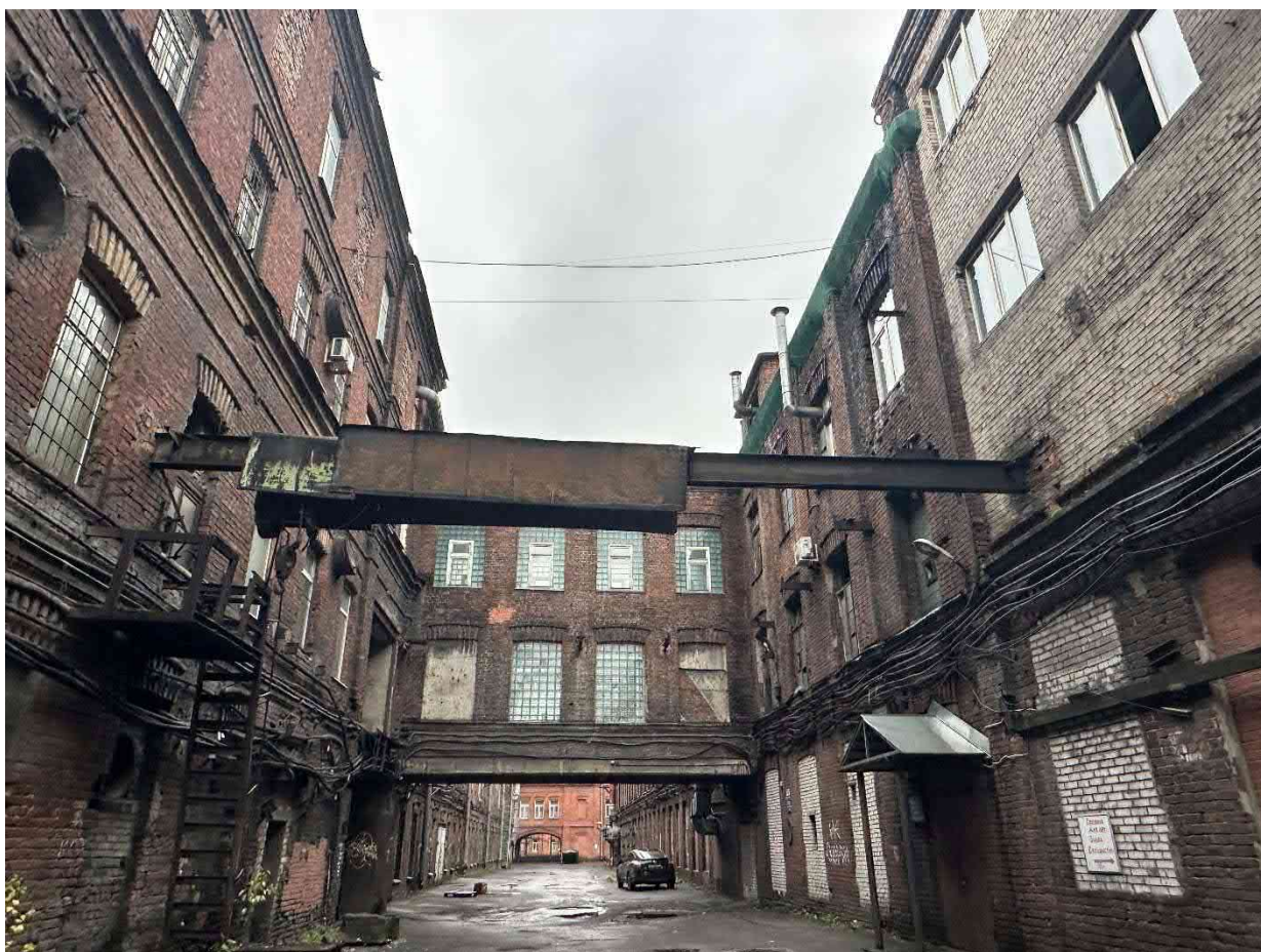
Фото 10. Общий вид здания. Галерея
