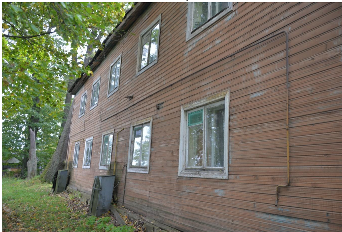
4. Вид с северо-запада на северный фасад
