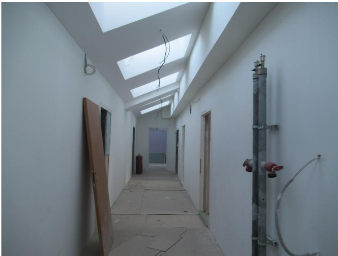
42. Мансардный этаж двухэтажного лицевого флигеля.
