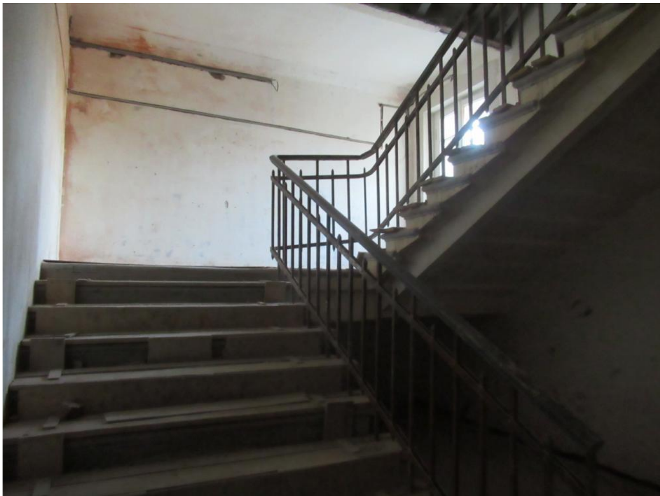
15. Лестница в исторической части двухэтажного лицевого флигеля.
