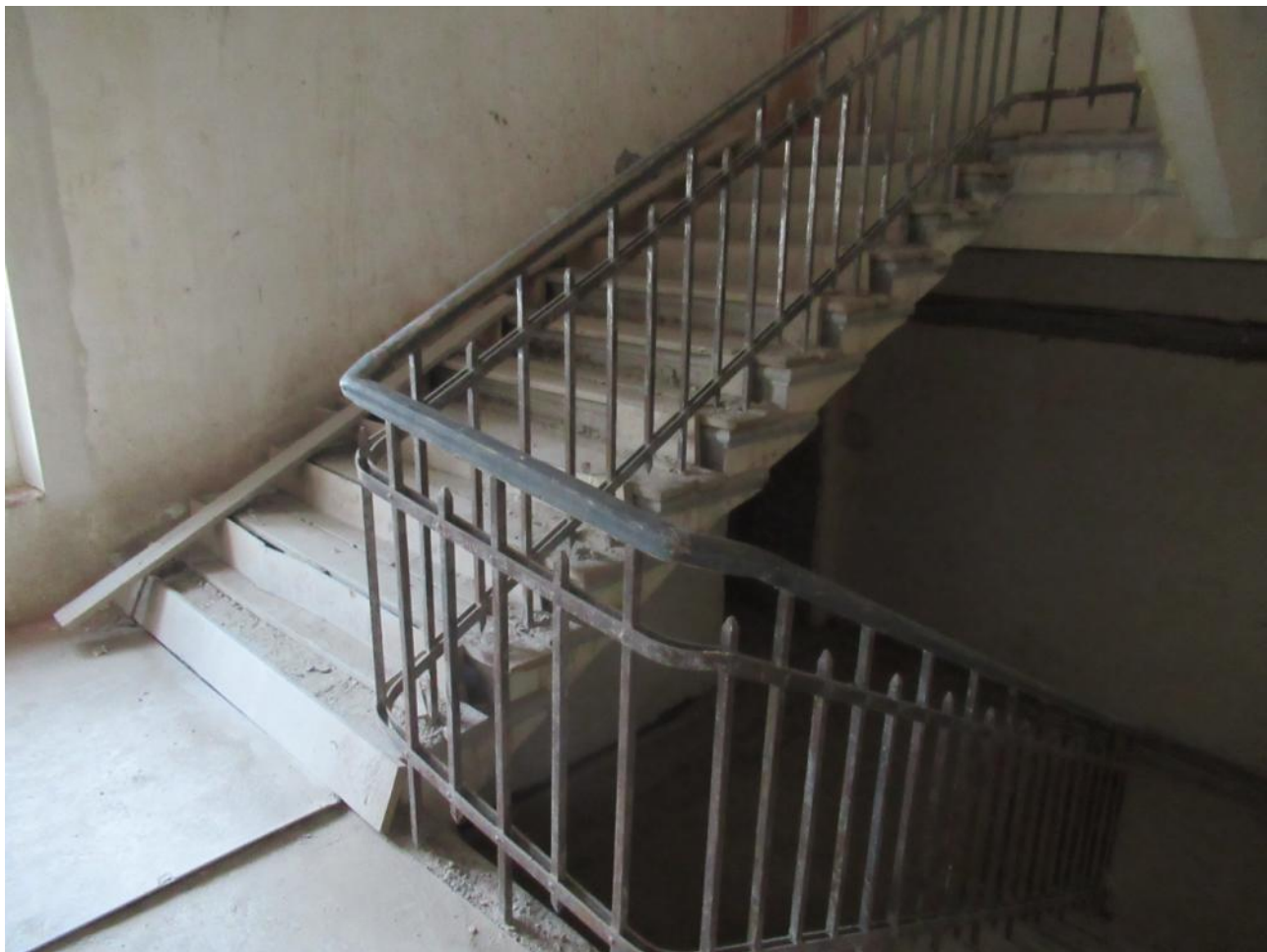
16. Лестница в исторической части двухэтажного лицевого флигеля.
