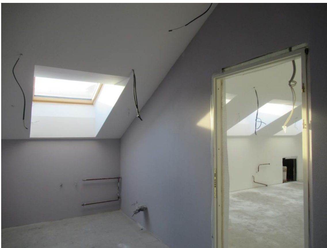
40. Мансардный этаж двухэтажного лицевого флигеля.
