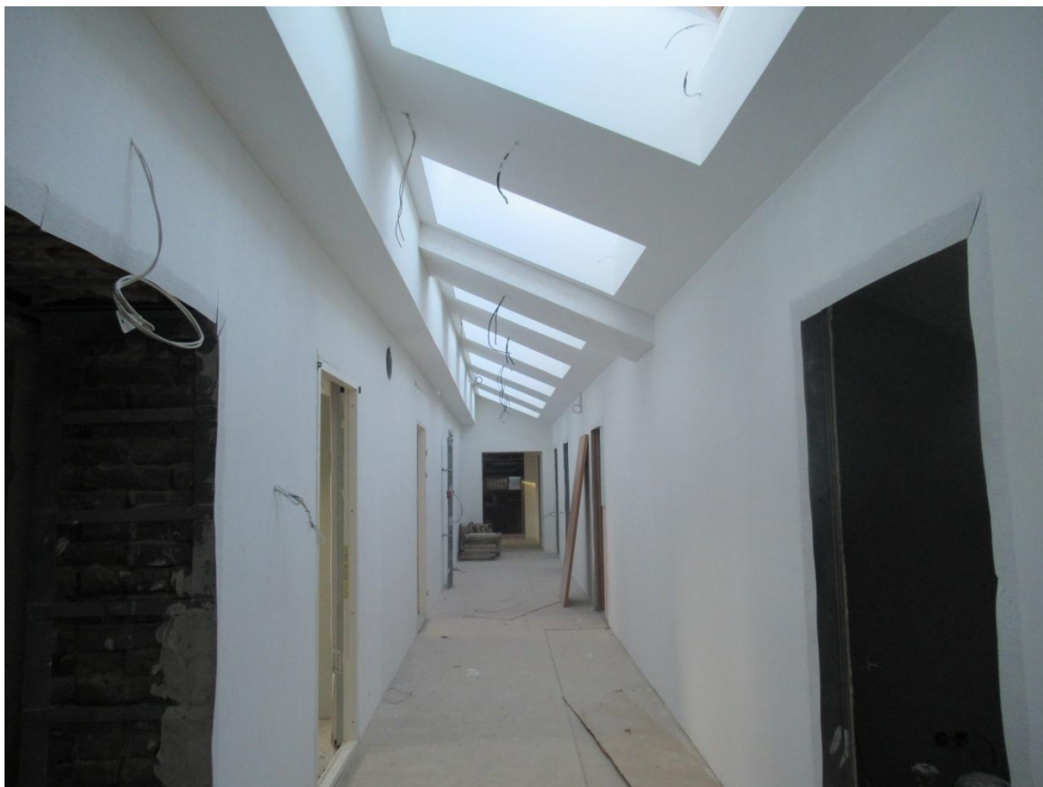
37. Мансардный этаж двухэтажного лицевого флигеля.
