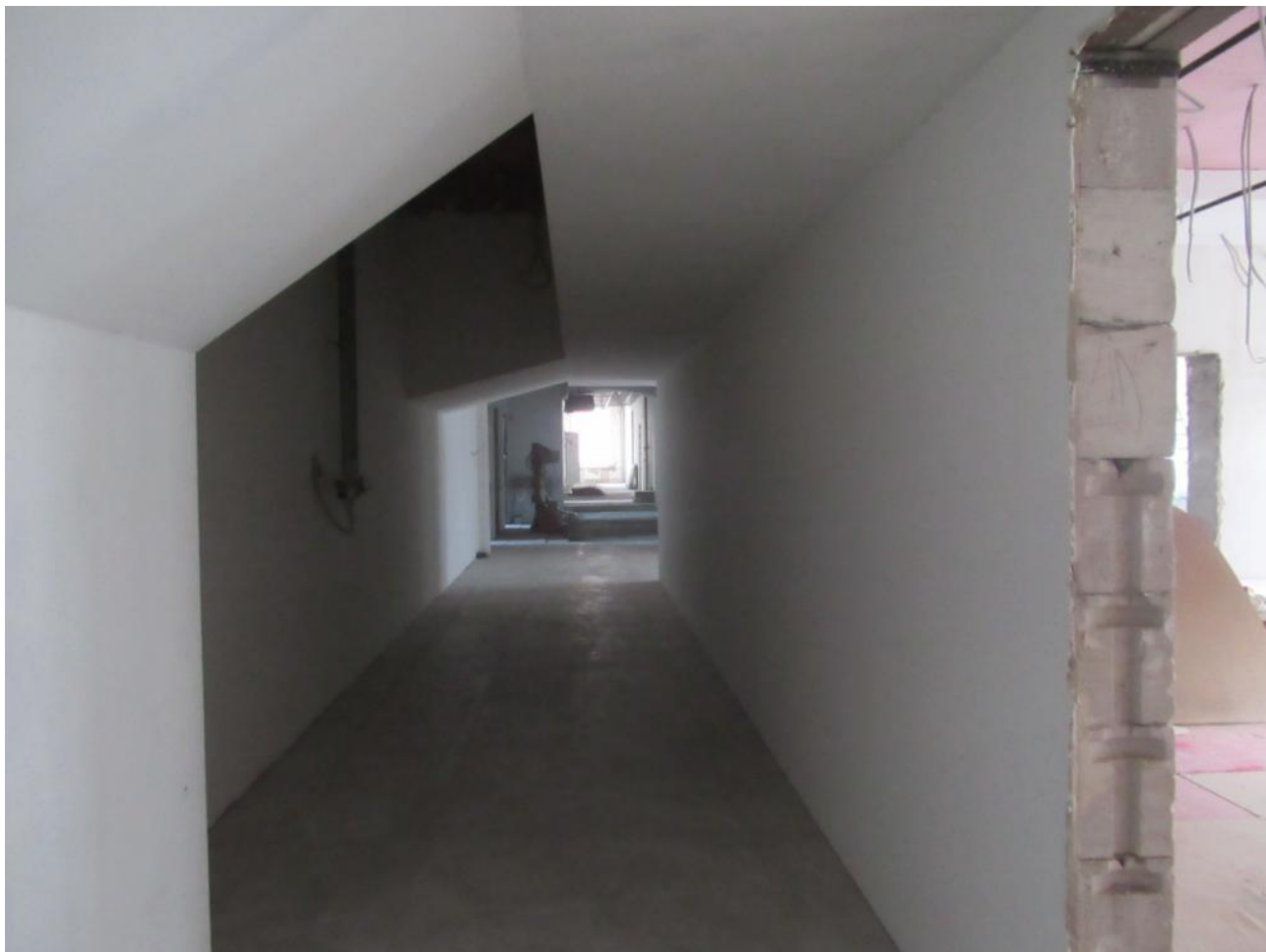
28. Помещение 2-го этажа двухэтажного лицевого флигеля.
