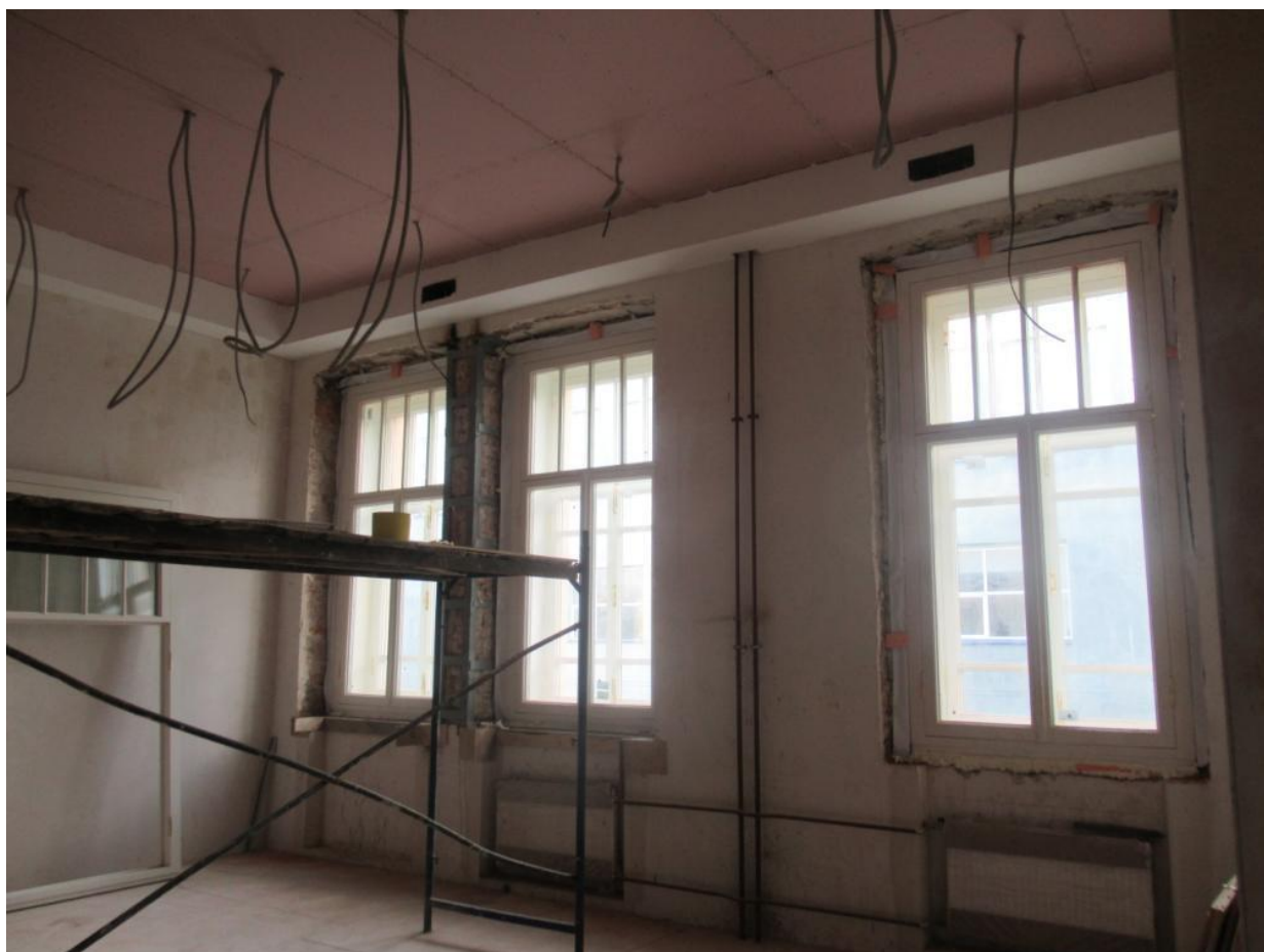
29. Помещение 2-го этажа двухэтажного лицевого флигеля.
