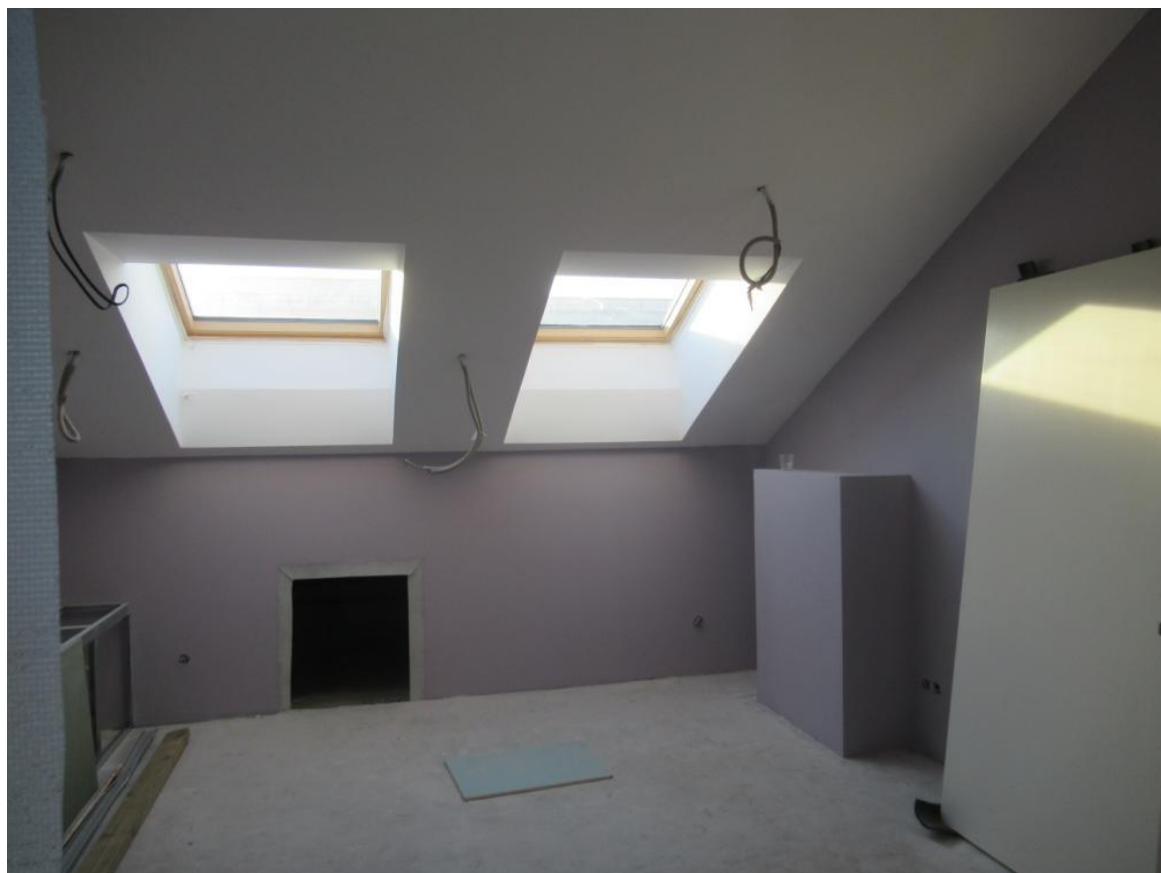
38. Мансардный этаж двухэтажного лицевого флигеля.
