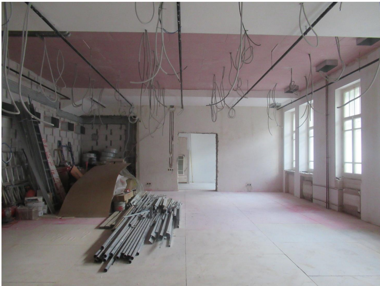
26. Помещение 2-го этажа двухэтажного лицевого флигеля.
