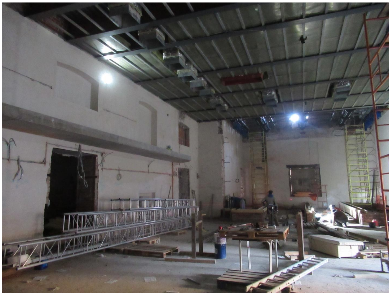
13. Помещение двухсветного зала
