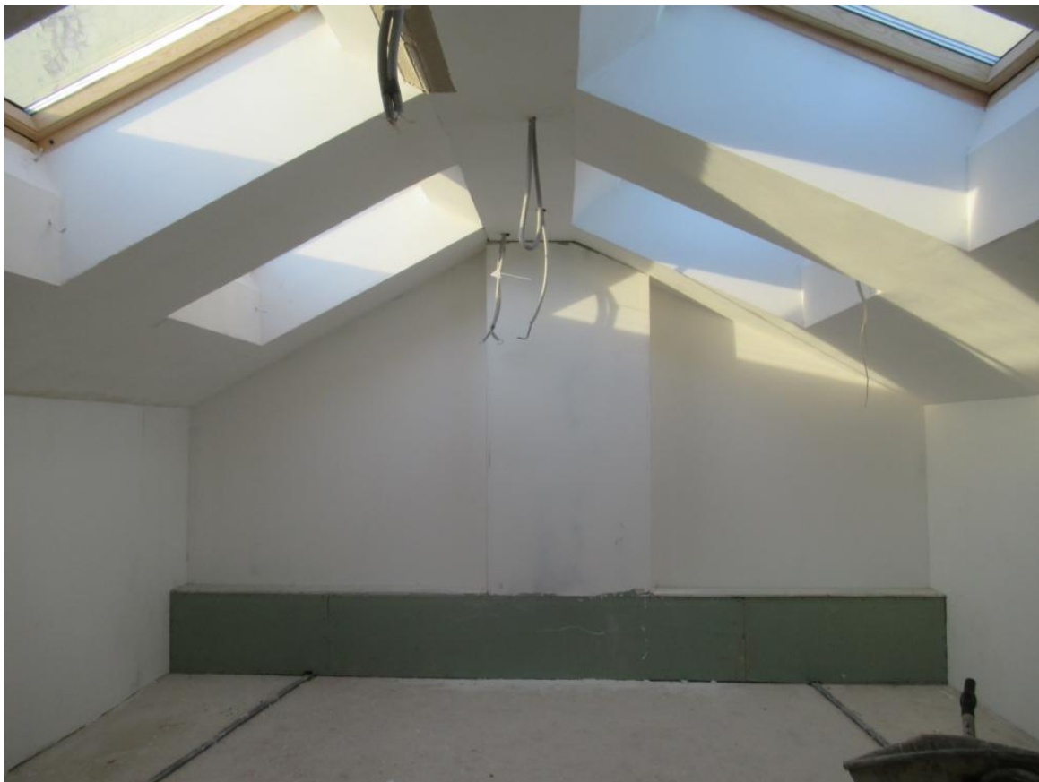
41. Мансардный этаж двухэтажного лицевого флигеля.
