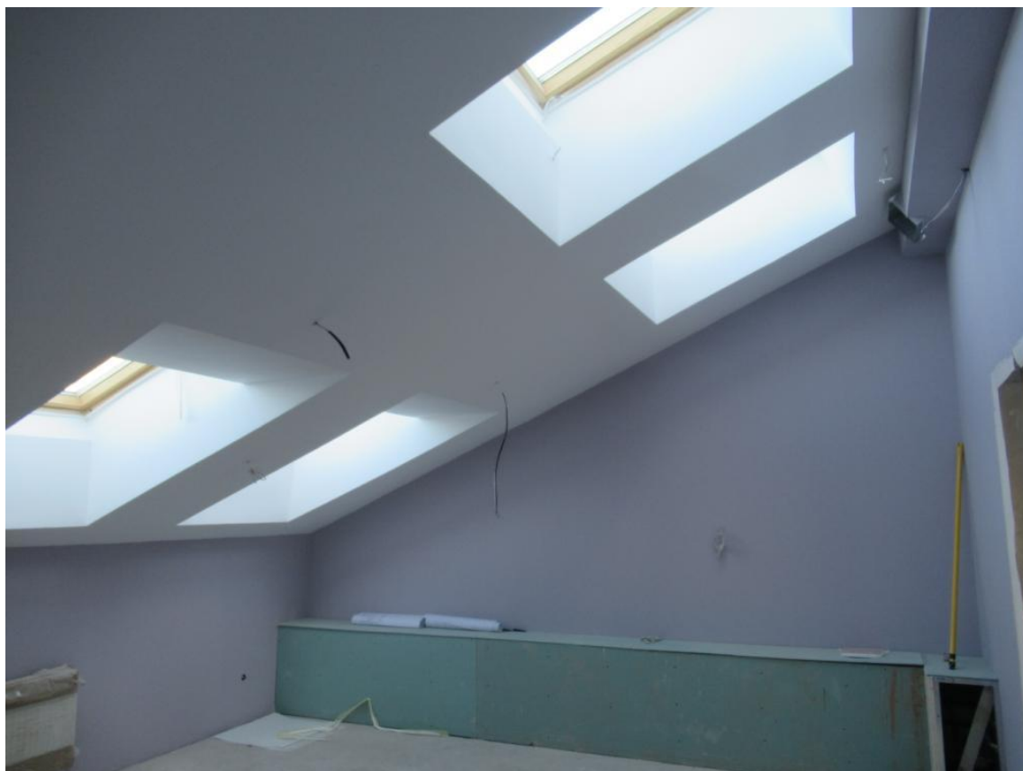
39. Мансардный этаж двухэтажного лицевого флигеля.
