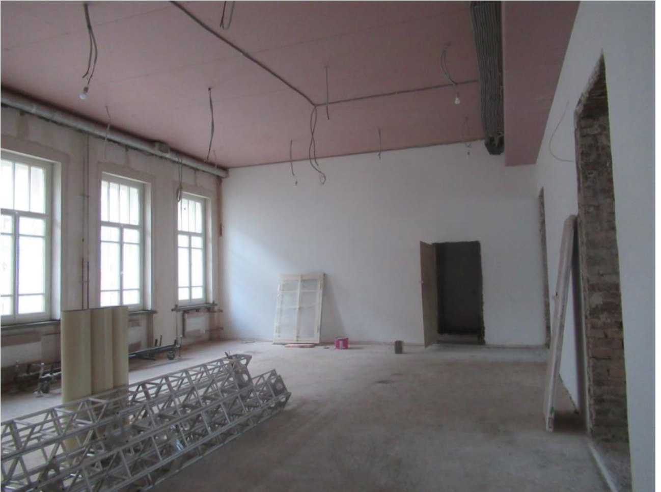
18. Помещение 1-го этажа двухэтажного лицевого флигеля.
