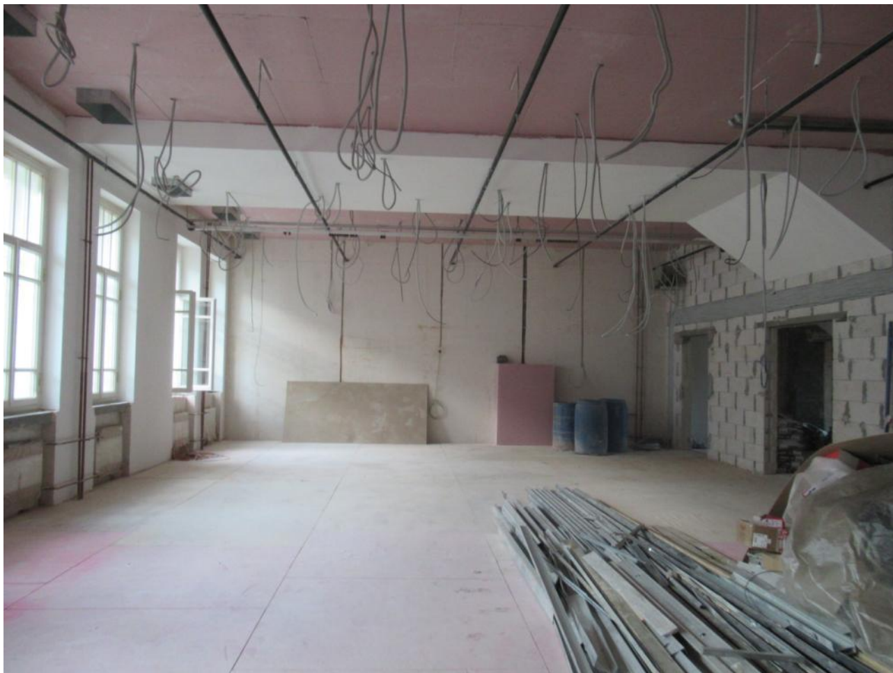
27. Помещение 2-го этажа двухэтажного лицевого флигеля.
