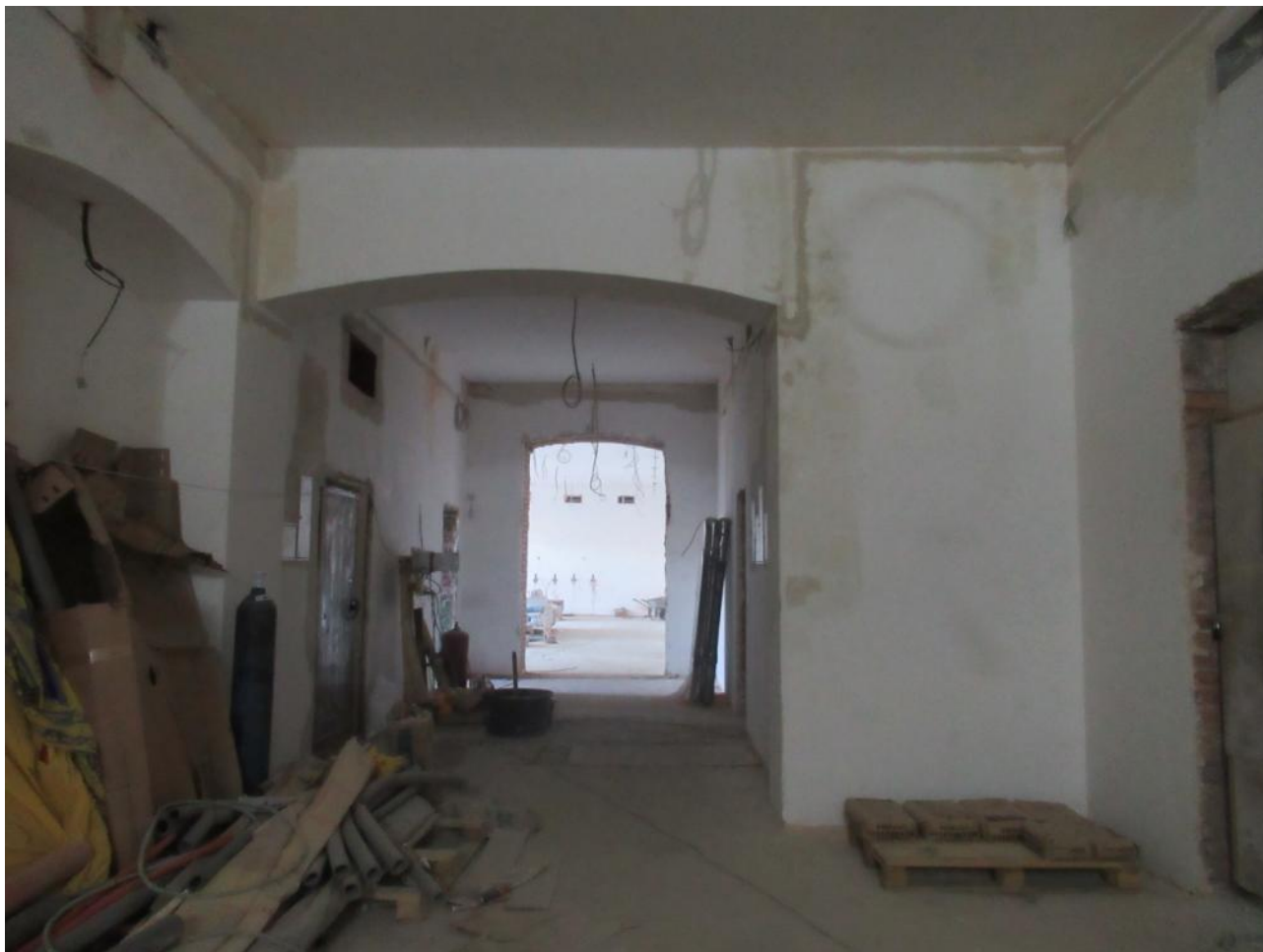
14. Переход из зала на 1-й этаж двухэтажного лицевого флигеля (фойе).
