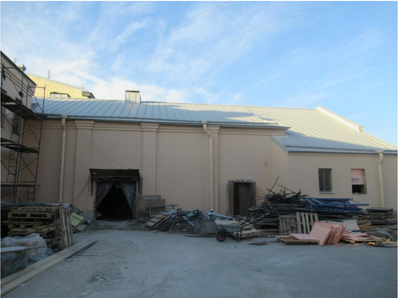
б. Дворовый (одноэтажный) флигель. Фрагмент южного фасада.
