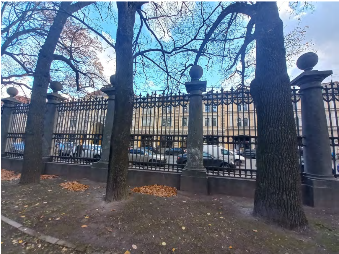
Фото 5. Вид с территории сада. Направление съемки – юго-восток.
