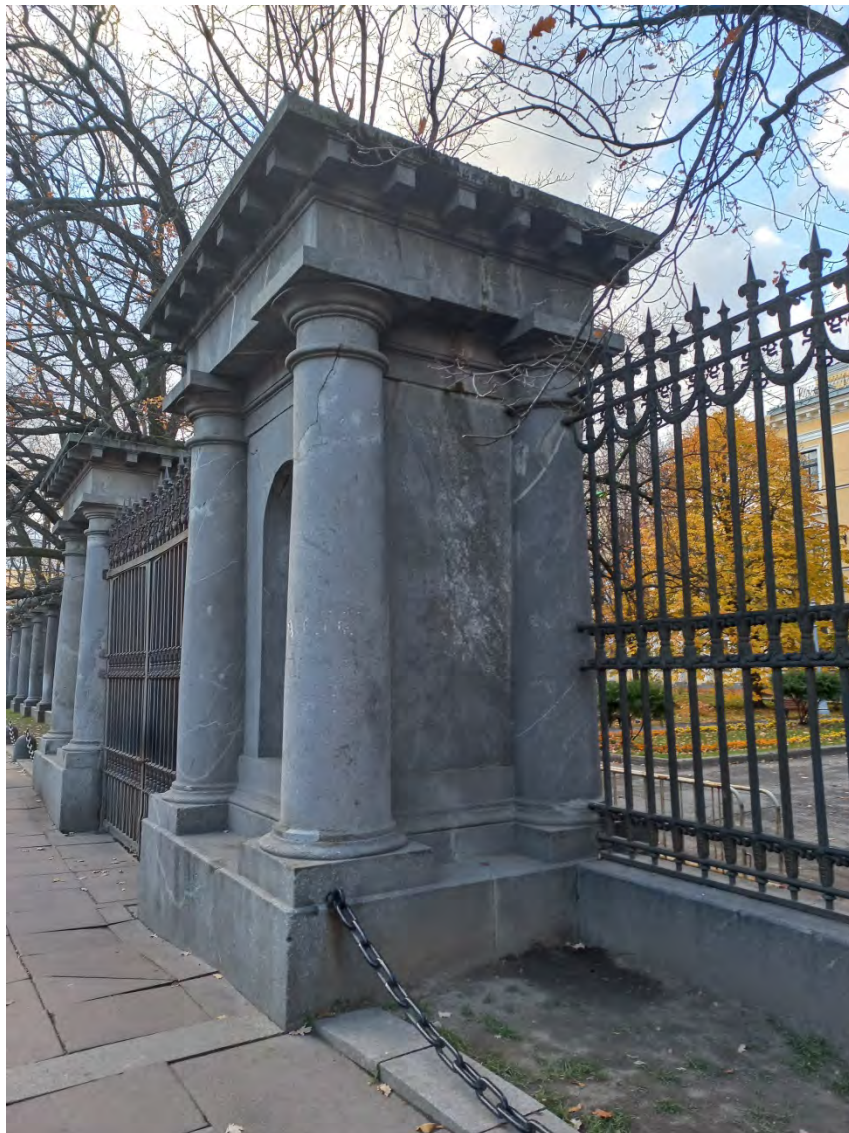
Фото 9. Вид с ул. Садовая. Центральная часть – пилоны и ворота. Направление съемки – юго-запад.
