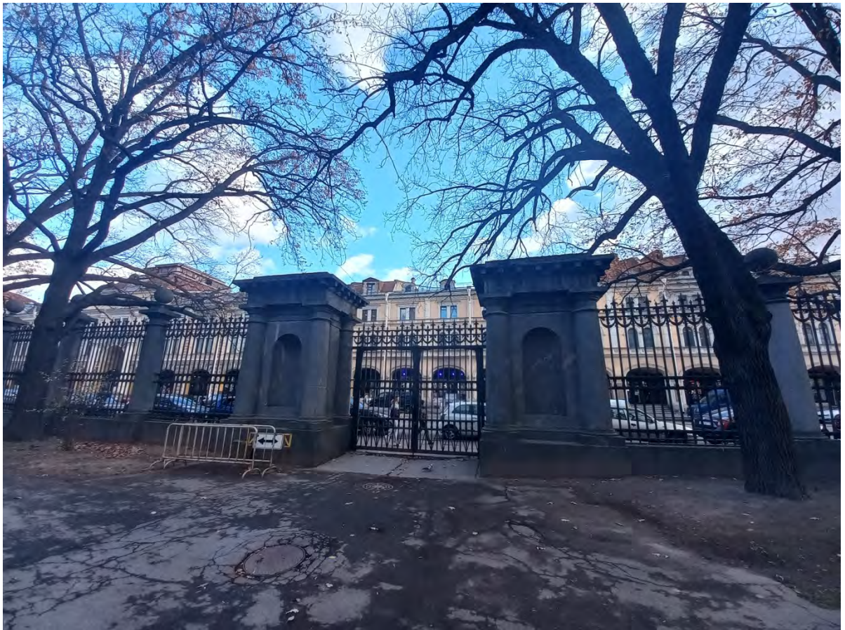
Фото 6. Вид с территории сада. Гранитные пилоны и ворота. Направление съемки – юго-восток.
