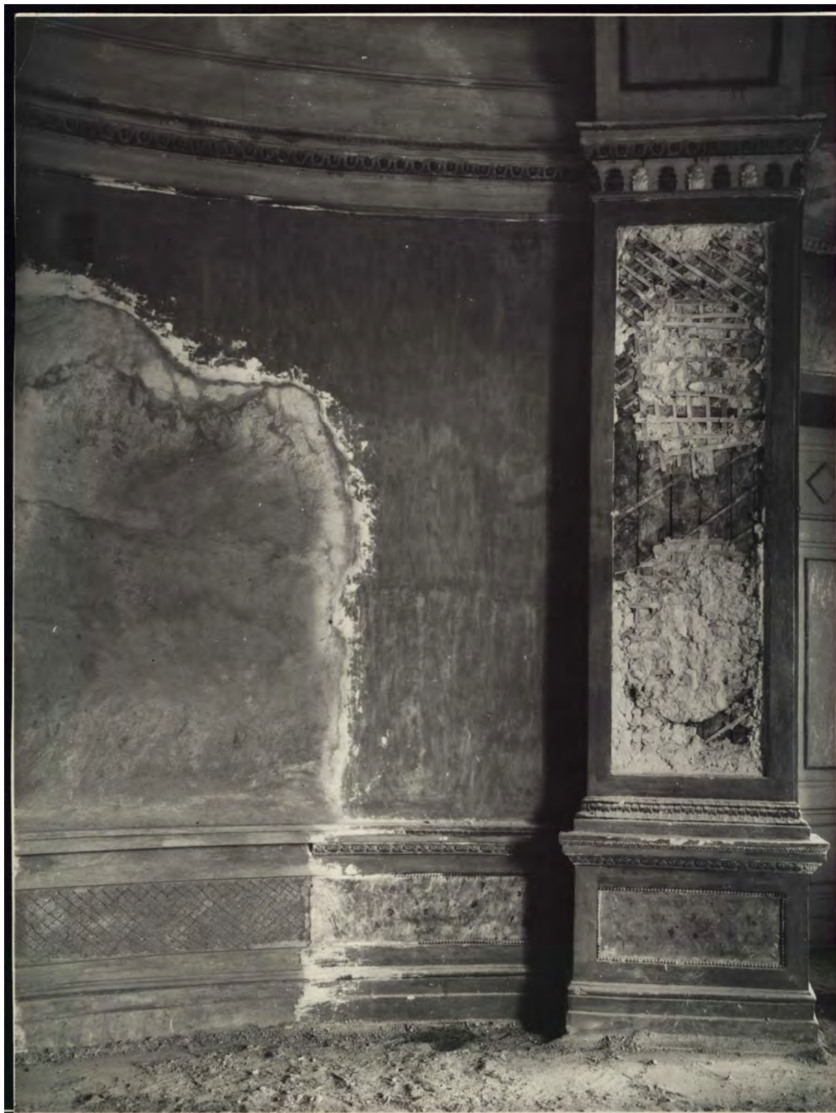
35. Малая тронная. Повреждение искусственного мрамора и восстановление штукатурки стен. Фото 1953 г.
