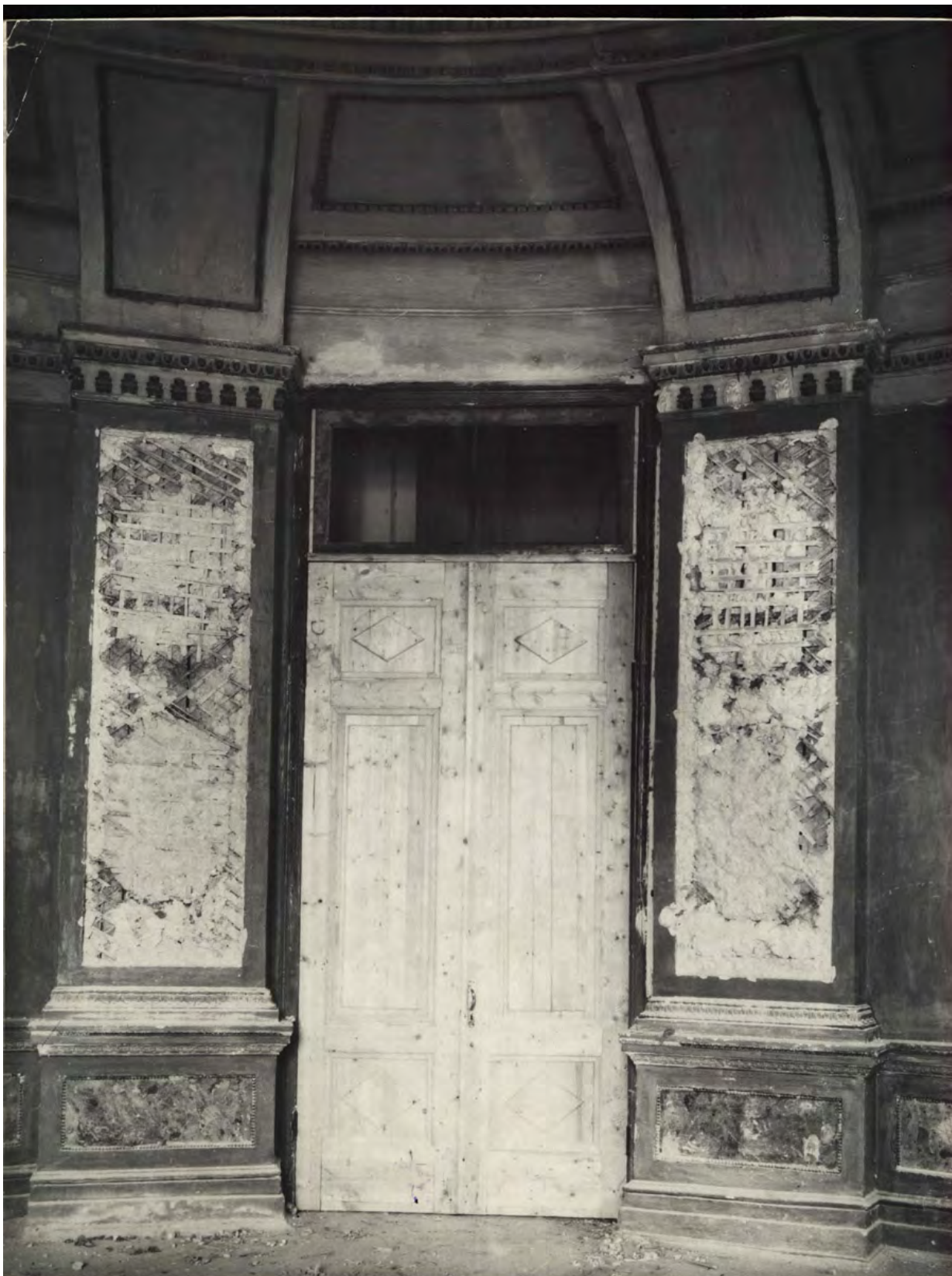
34. Малая тронная. Повреждение искусственного мрамора стен. До реставрации. Фото 1953 г.
