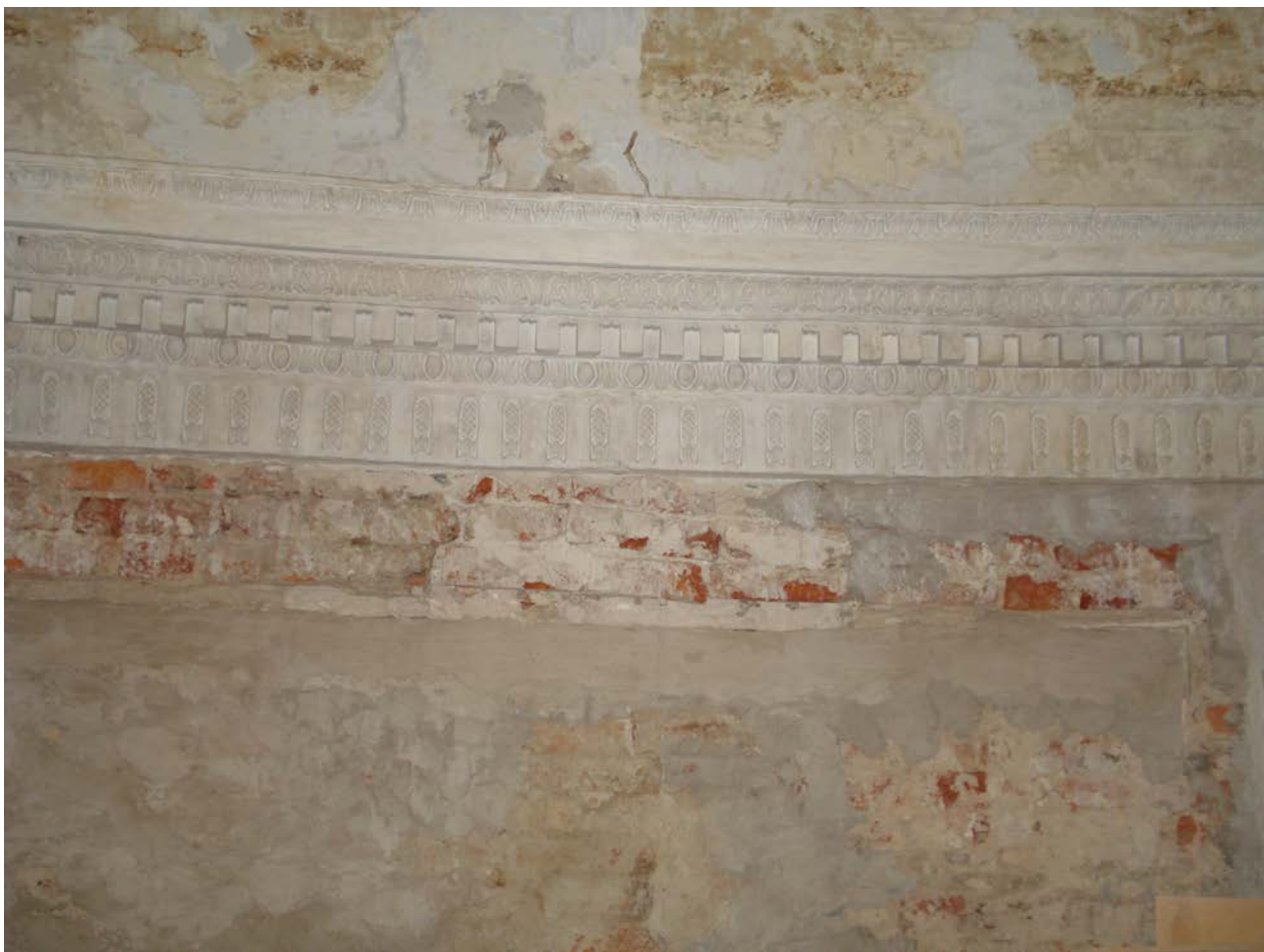
69. Фрагмент карниза в помещении 4 этажа Михайловского замка (верхний ярус Малого Тронного зала). Фото 2009 г.
