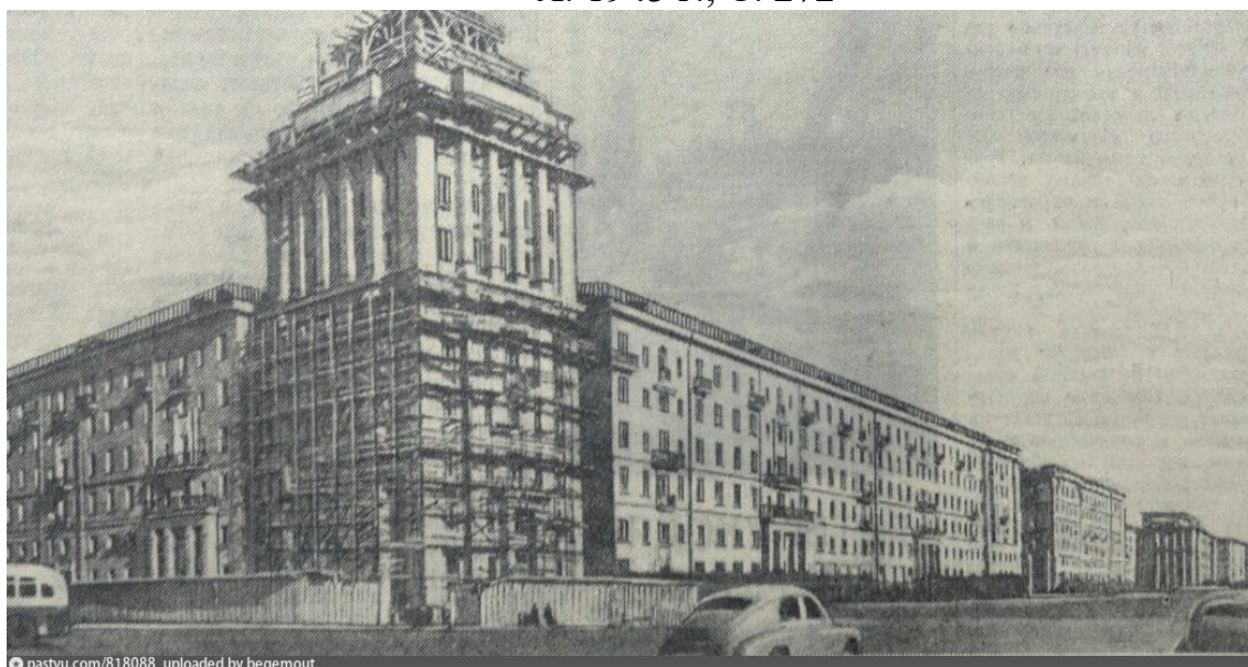
6. Строительство высотного дома на проспекте Сталина. 1953 г. Из газеты «Вечерний Ленинград» за 1953 г.
