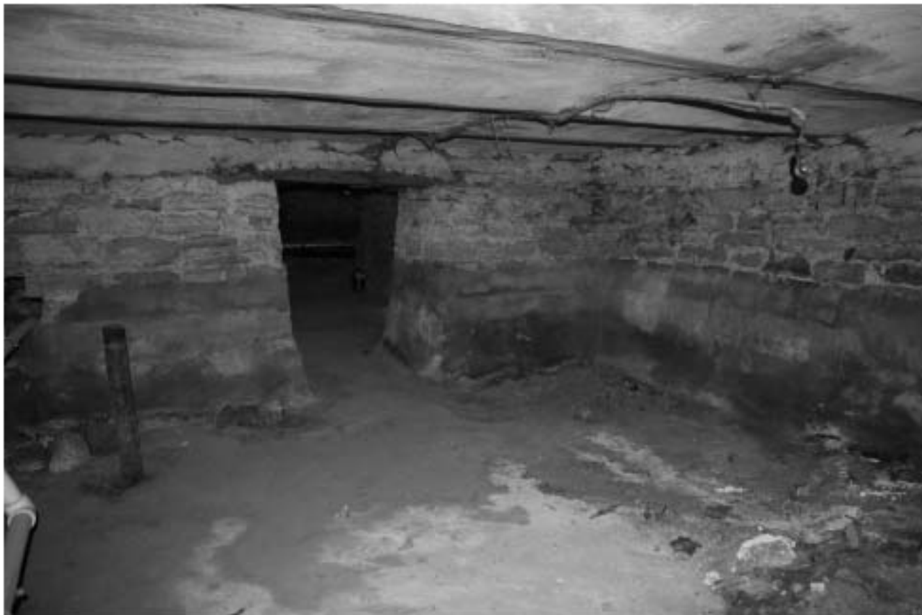
23. Фрагмент подвального помещения
