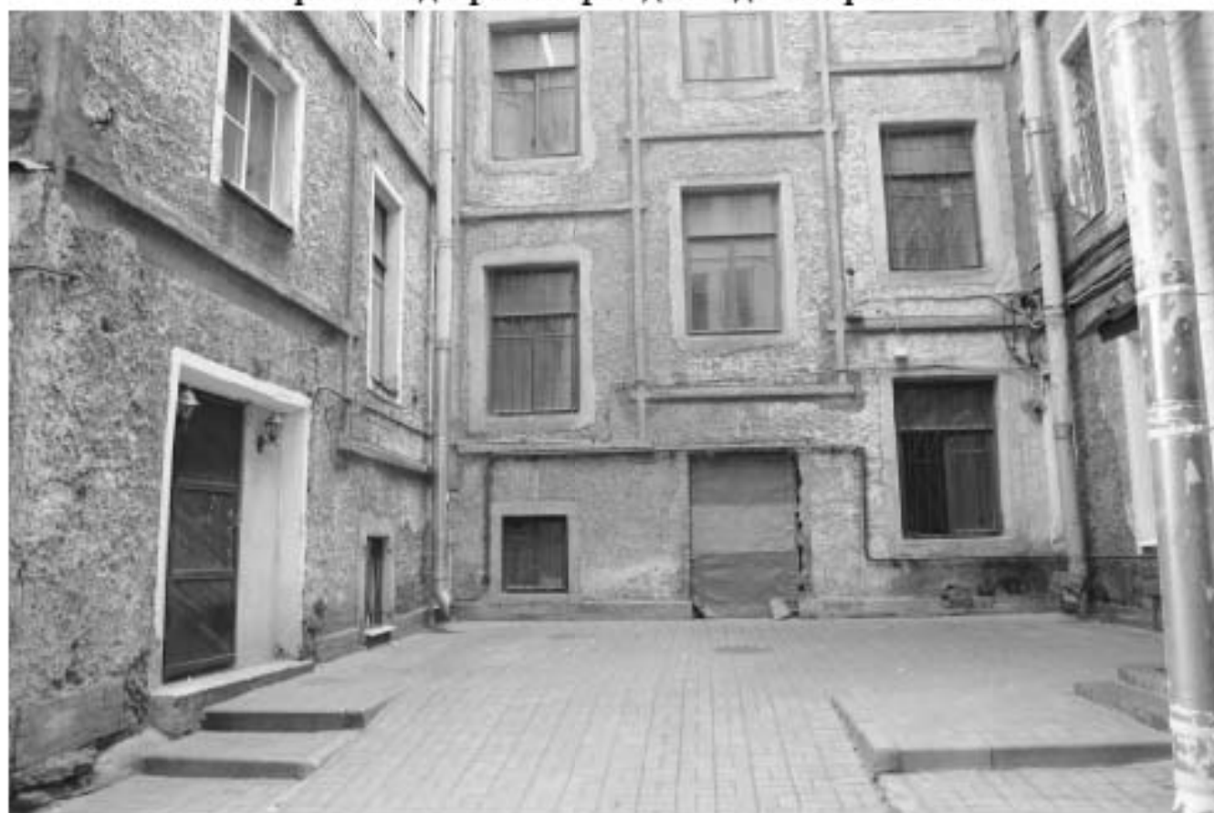
13. Фрагмент дворового фасада. Вид с севера.
