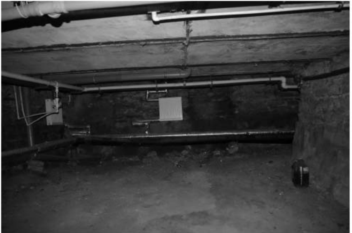
25. Фрагмент подвального помещения
