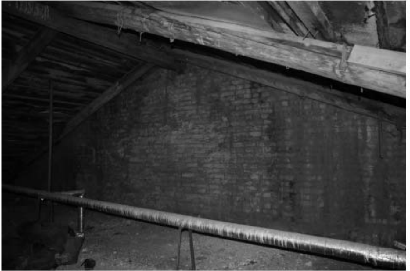
53. Пространство чердачного помещения
