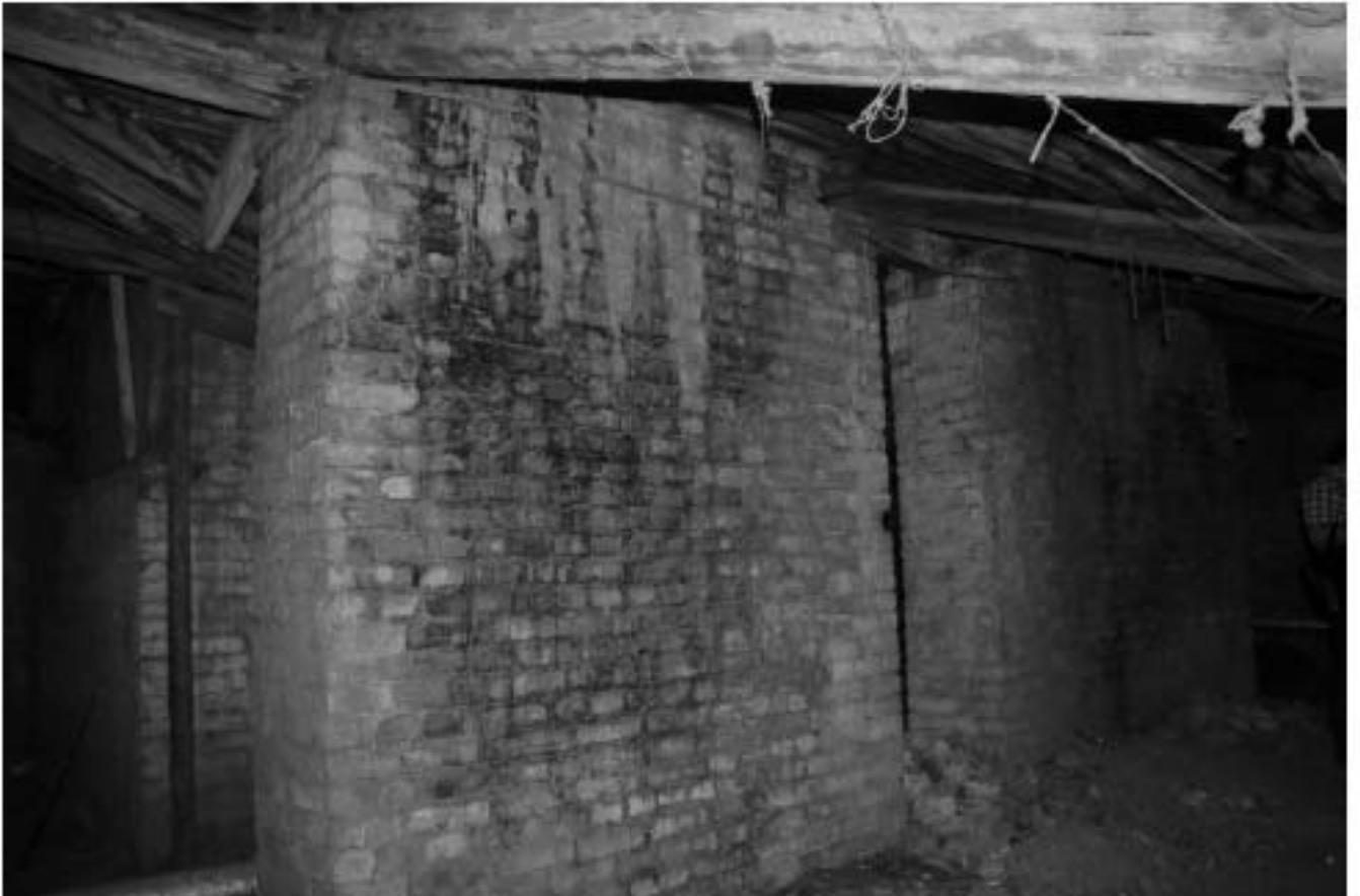
56. Пространство чердачного помещения
