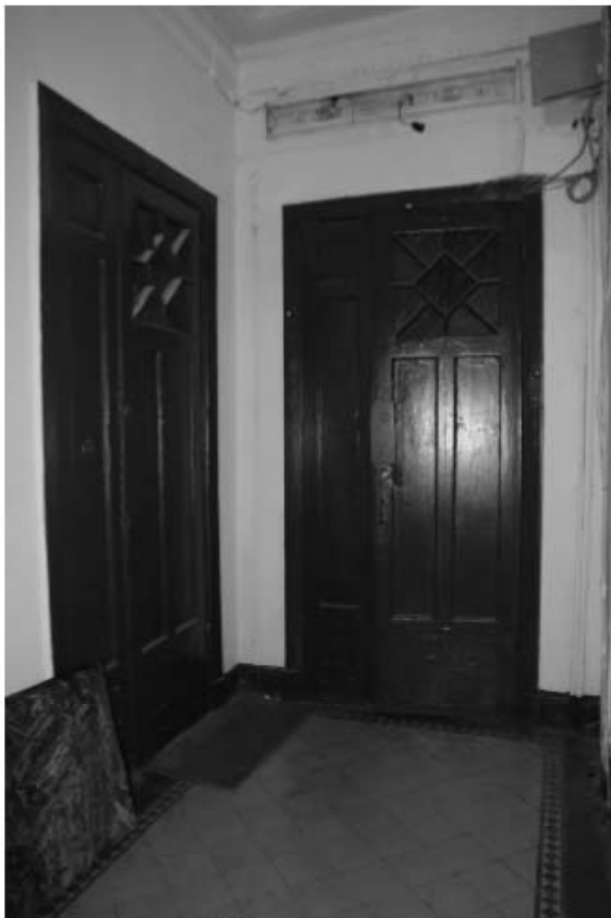
39. Интерьер парадной. Дверные заполнения жилых помещений.
