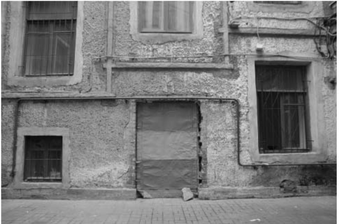
14. Фрагмент дворового фасада. Вид с севера.
