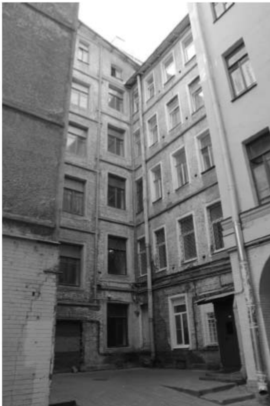
5. Фрагмент дворового фасада. Вид с северо-востока.
