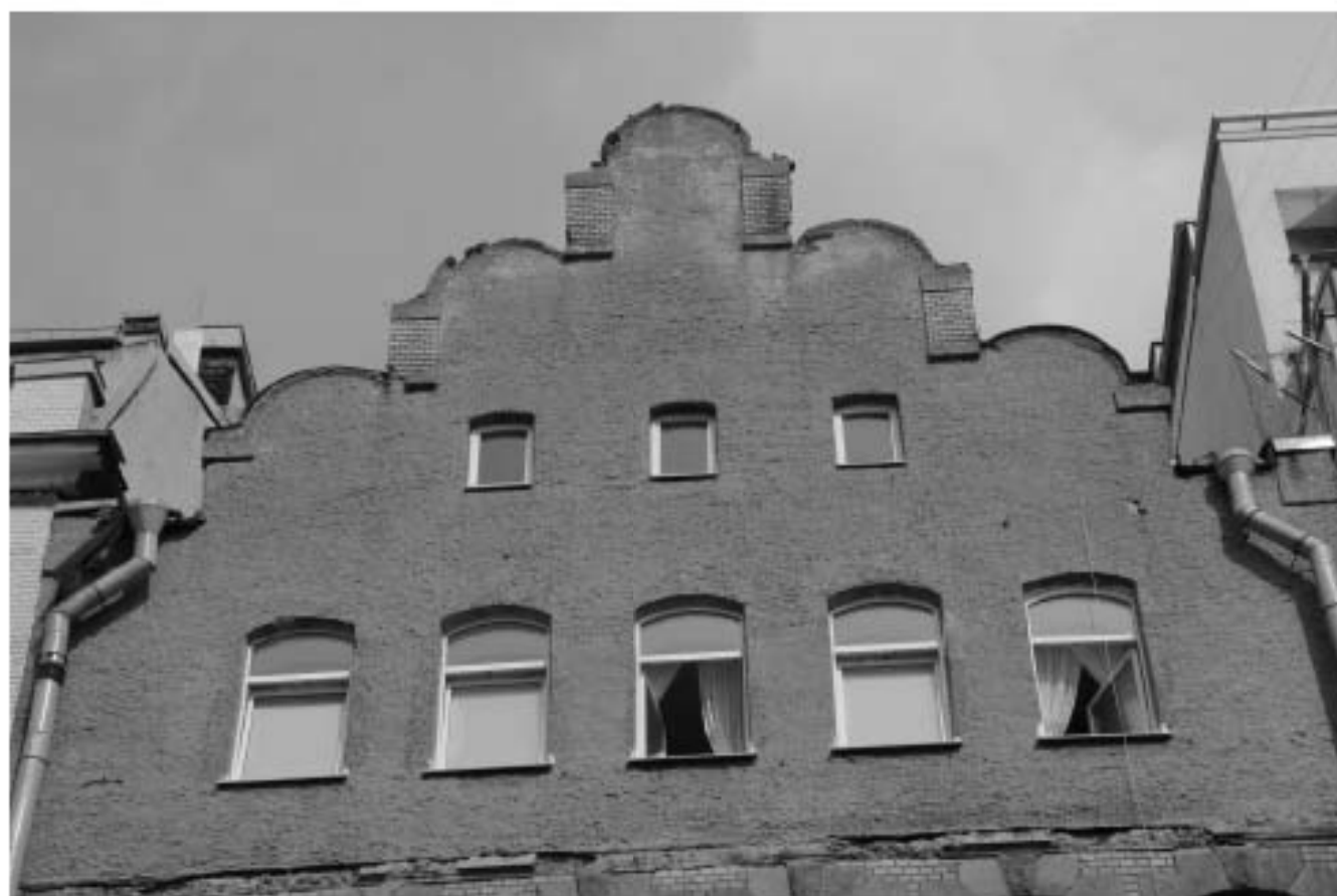
11. Фрагмент главного фасада. Вид с запада.
