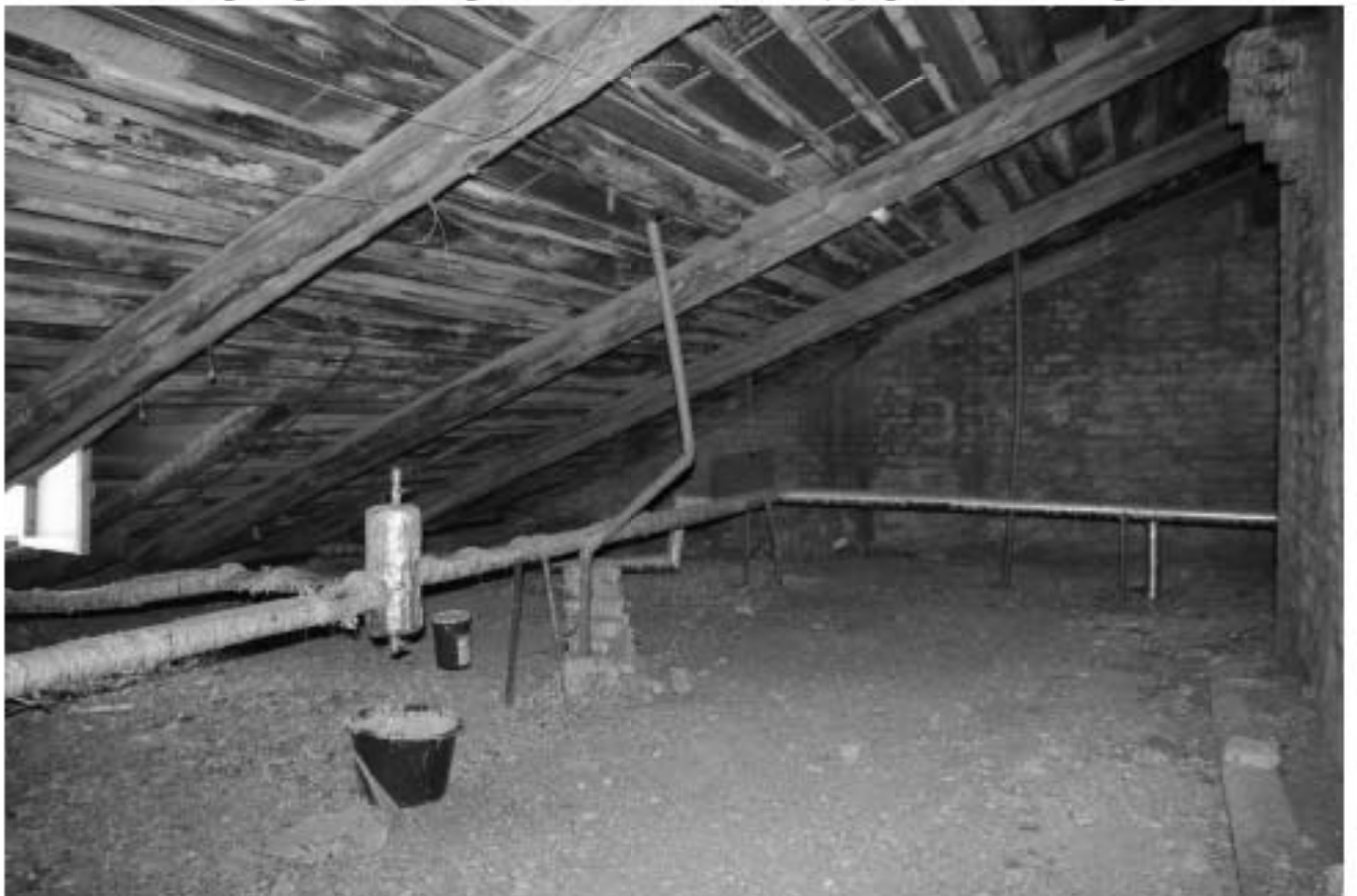
52. Пространство чердачного помещения
