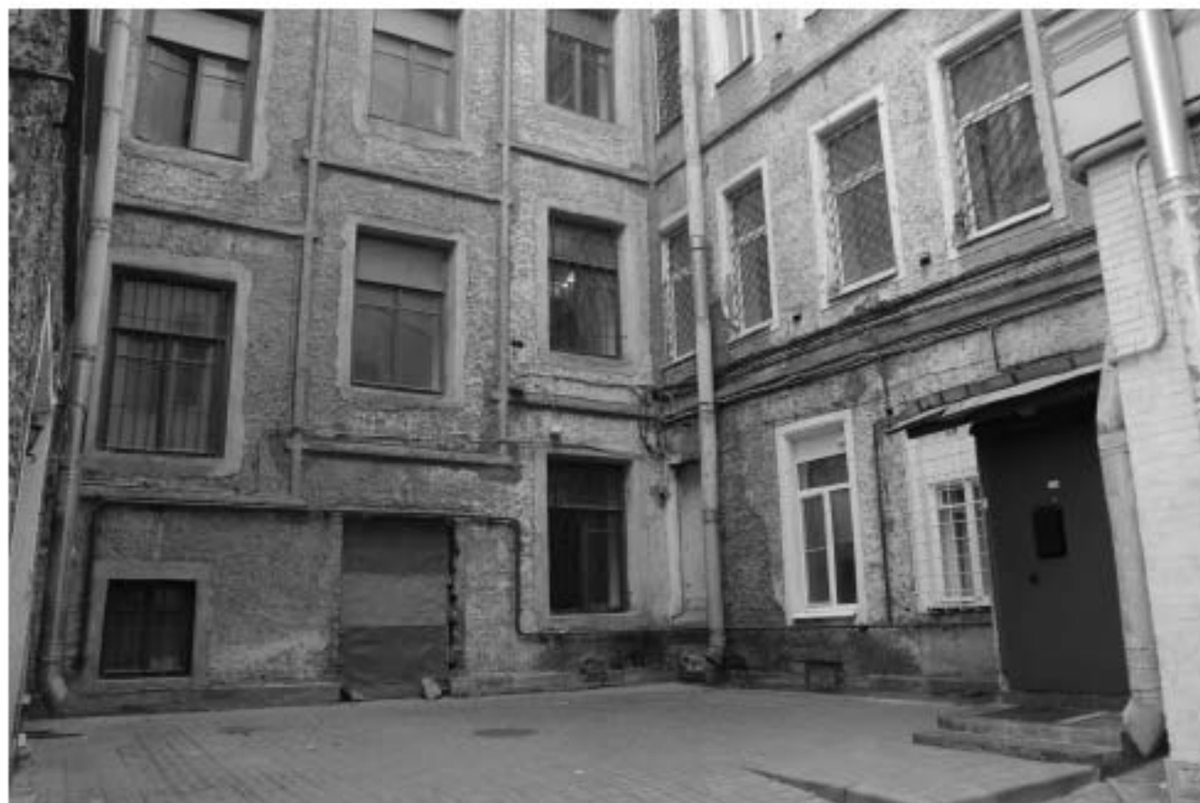
12. Фрагмент дворового фасада. Вид с северо-востока
