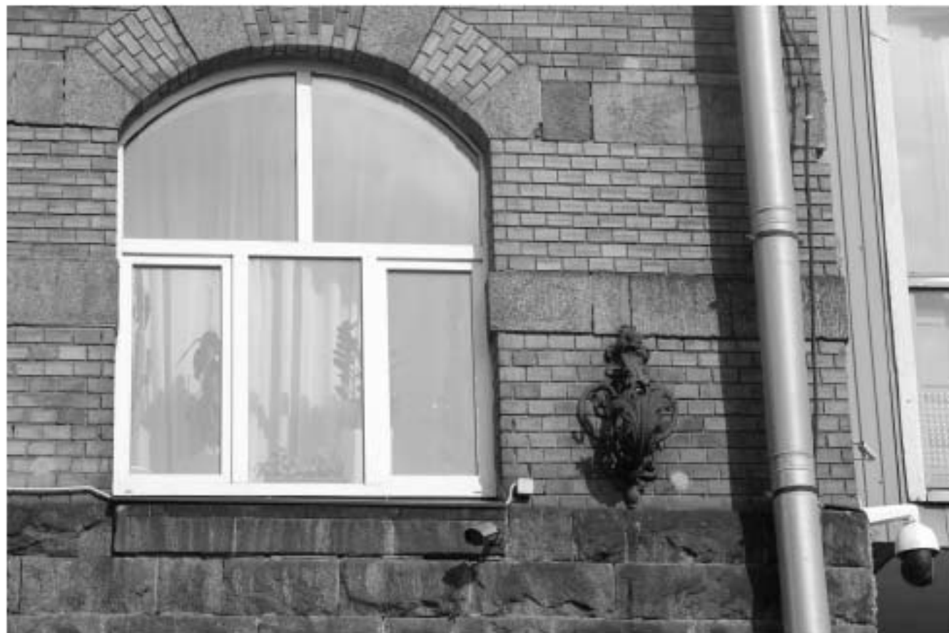
10. Фрагмент главного фасада. Оформление оконного проема. Вид с запада.
