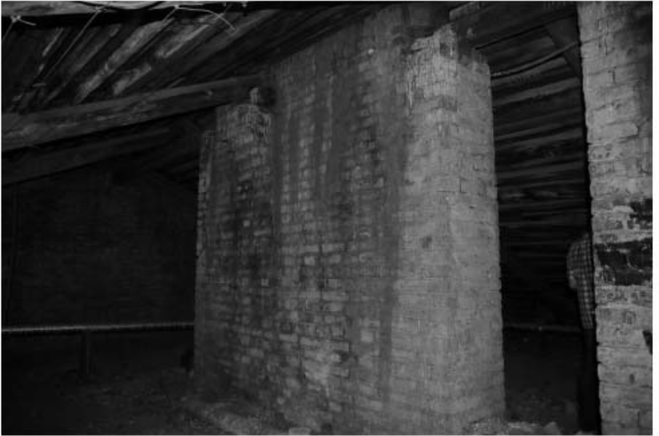
55. Пространство чердачного помещения
