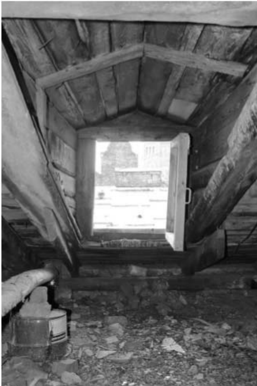
59. Пространство чердачного помещения. Чердачное окно.
