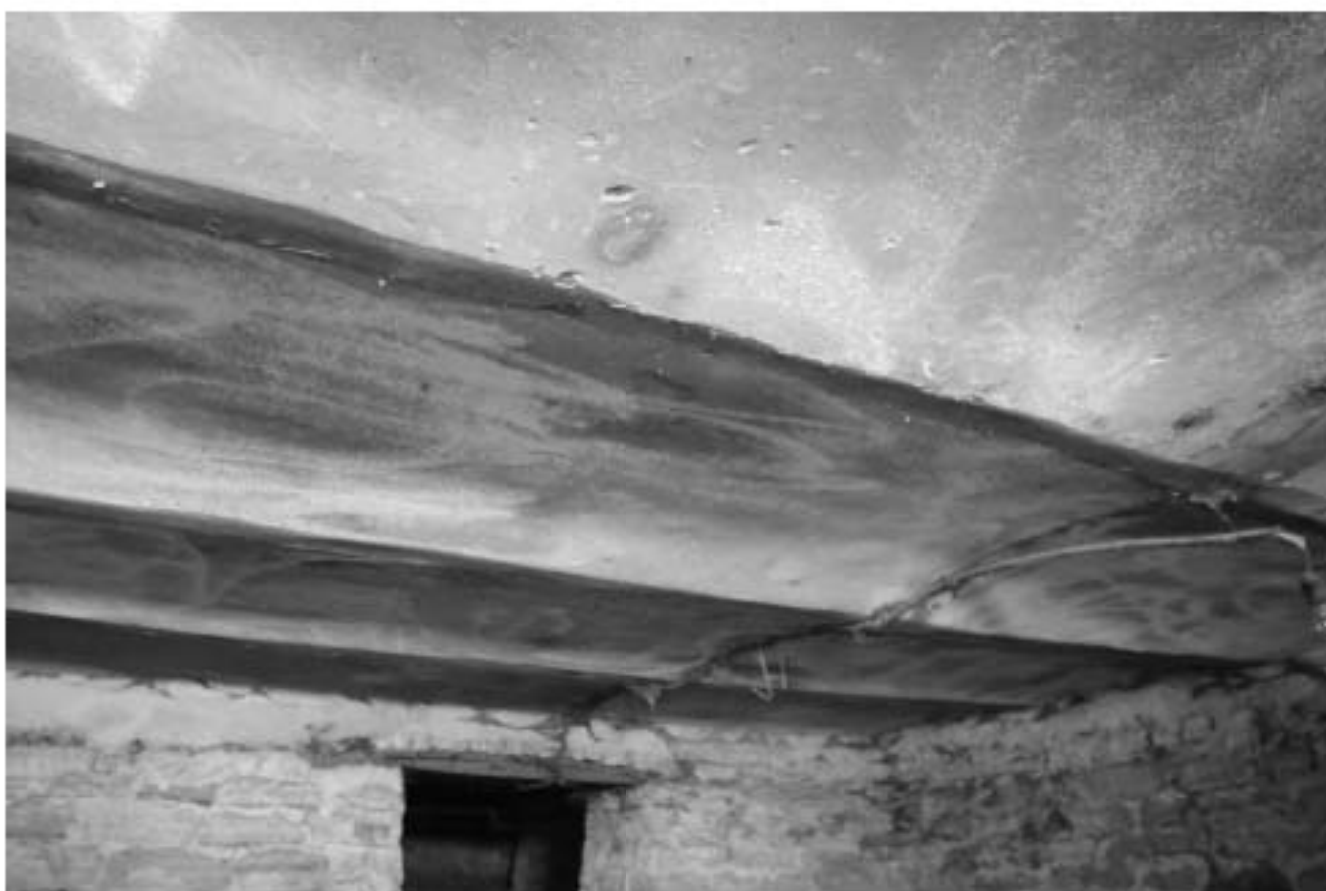
24. Фрагмент подвального помещения. Оформление свода
