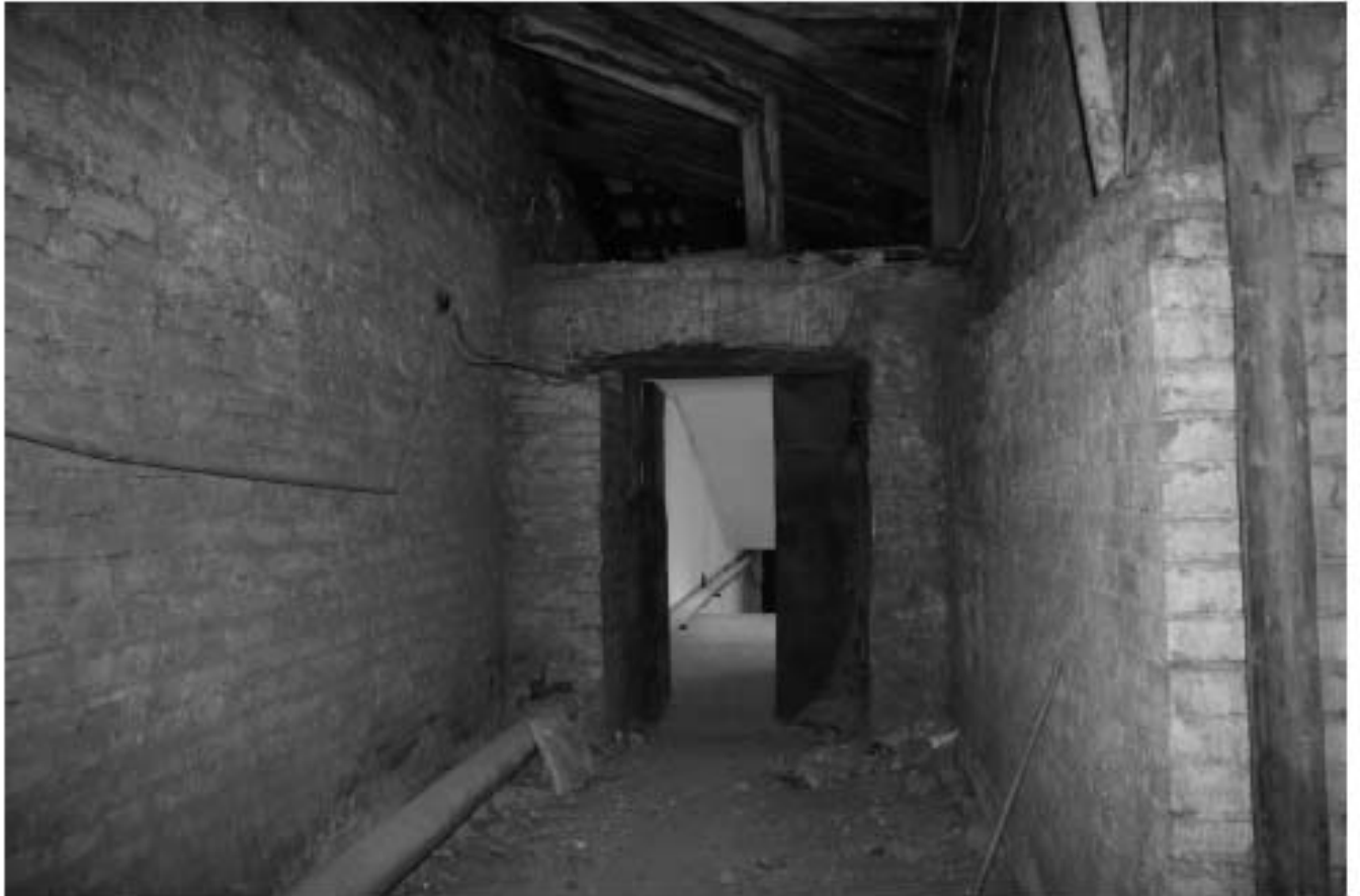
51. Пространство чердачного помещения. Дверь входа на чердак.
