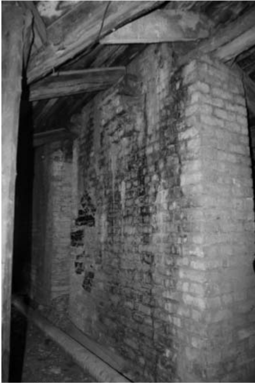
54. Пространство чердачного помещения
