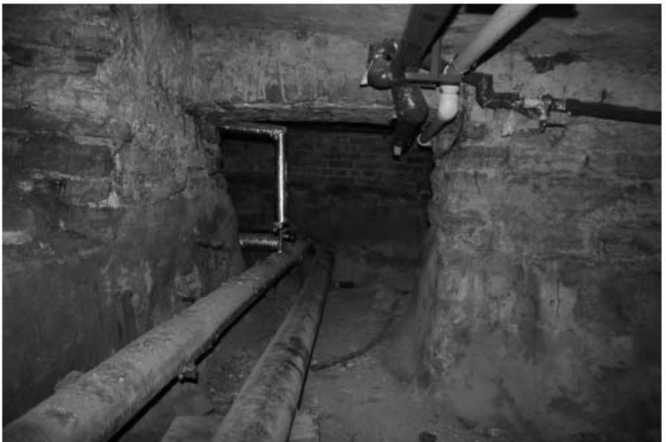
26. Фрагмент подвального помещения
