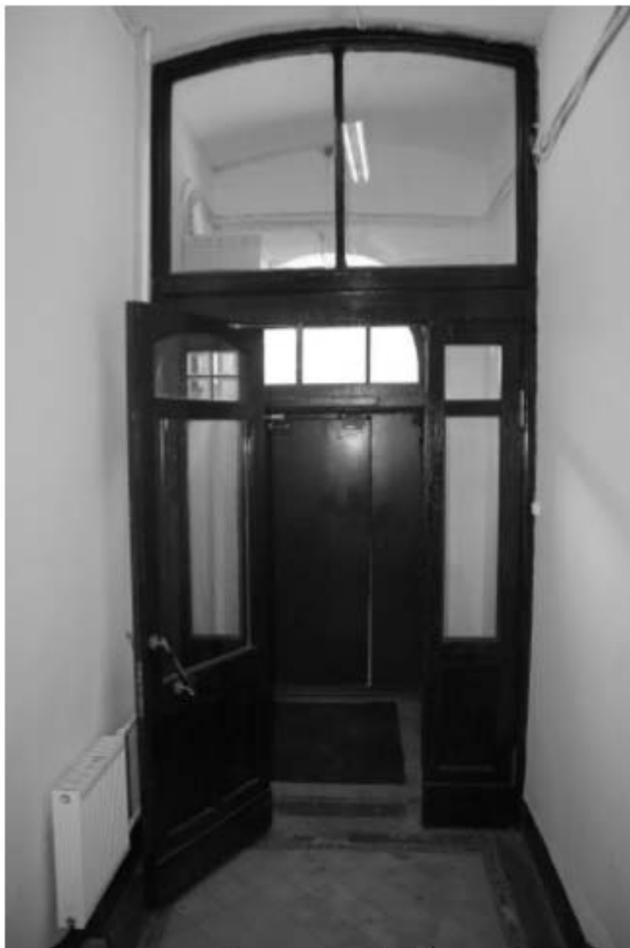
30. Интерьер вестибюля парадной. Двери тамбура входа
