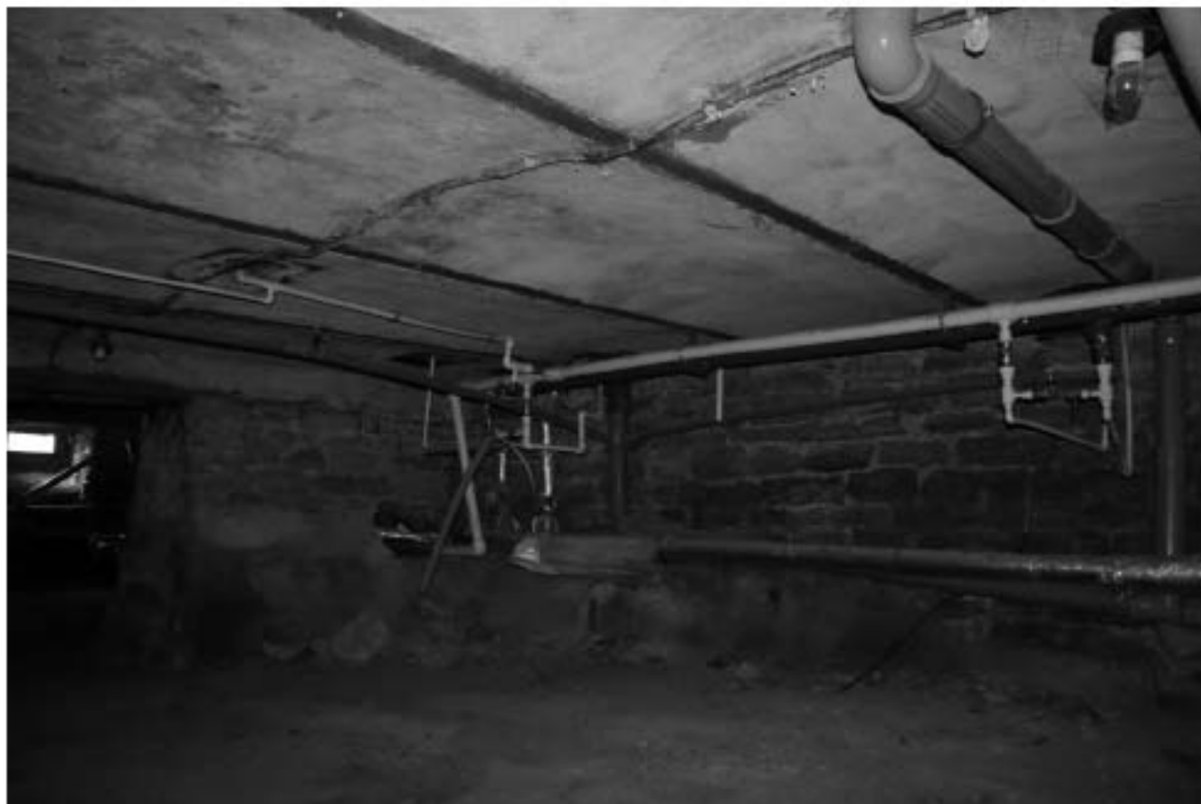
19. Фрагмент подвального помещения. Оформление свода
