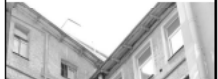
венчающий карниз на деревянных кобылках
