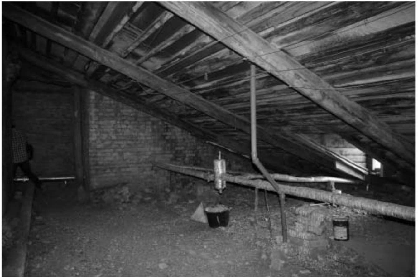
57. Пространство чердачного помещения
