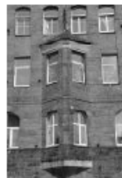
эркер главного фасада
