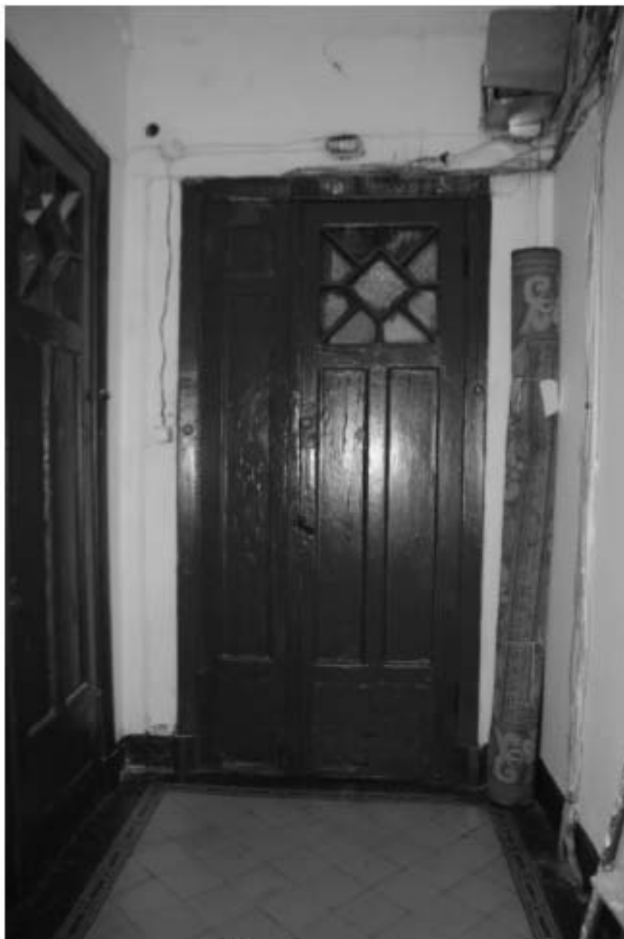
44. Интерьер парадной. Дверные заполнения жилых помещений.
