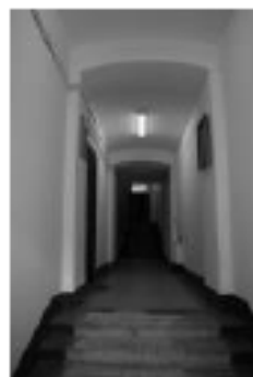
лестничной переход между вестибюлем и площадкой парадной лестницы
