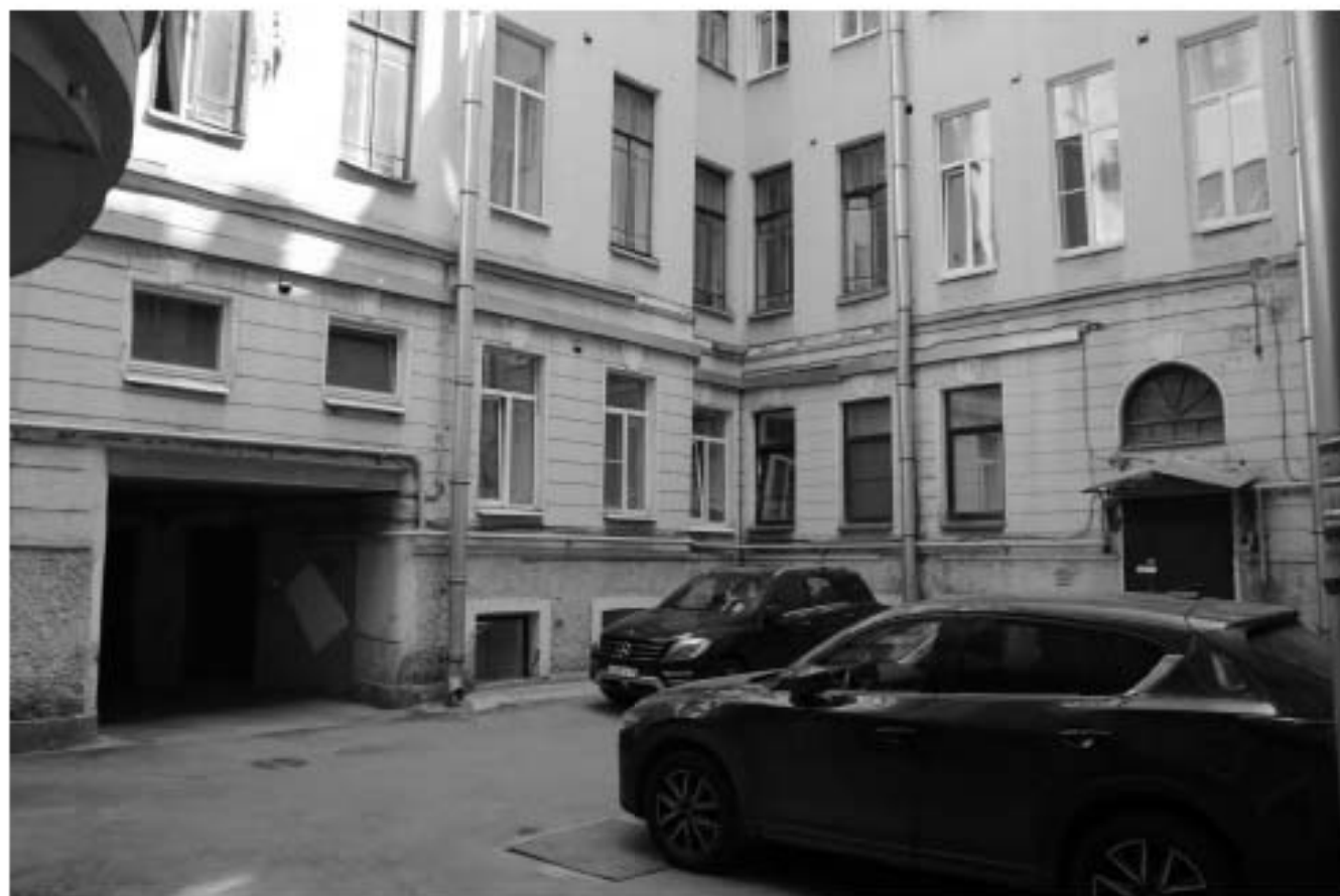
34. Фрагмент дворового фасада. Вид с юго-запада
