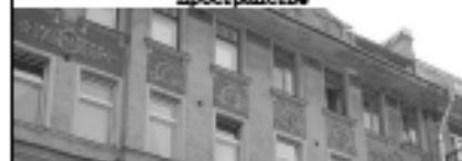
фриз из эмалированной керамической плитки с линейным декором
