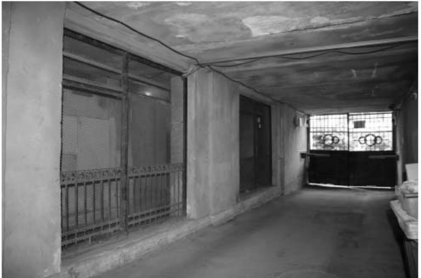
25. Проездная арка. Решетчатые перегородки между проездной аркой и аркой прохода во внутренний двор
