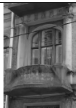
оформление балконных проемов на уровне 2 этажа
