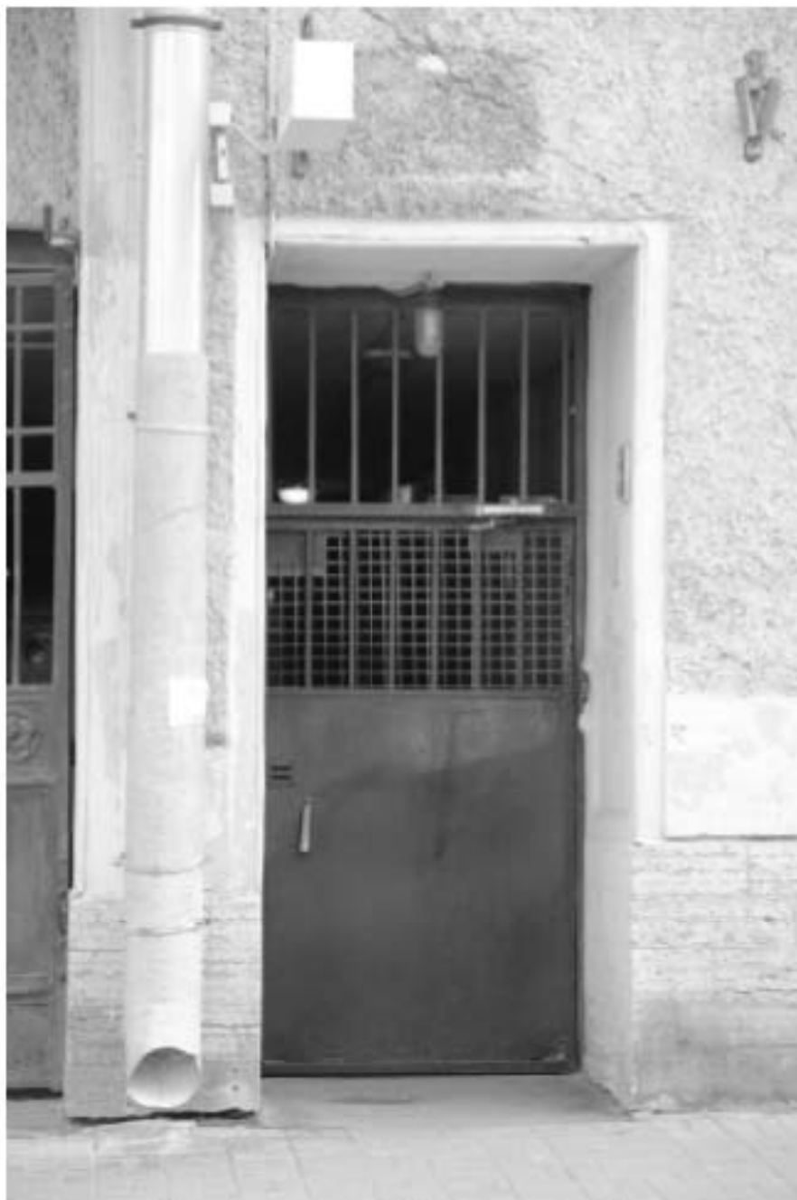
14. Фрагмент главного фасада по улице Таврическая. Ворота входа. Вид с запада
