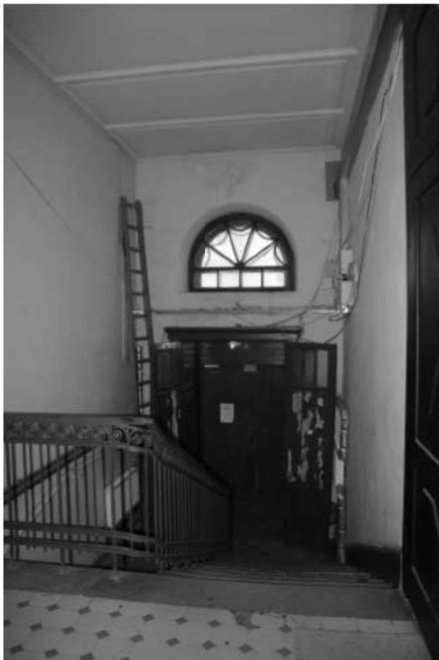
57. Интерьер вестибюля дворовой парадной. Двери тамбура входа
