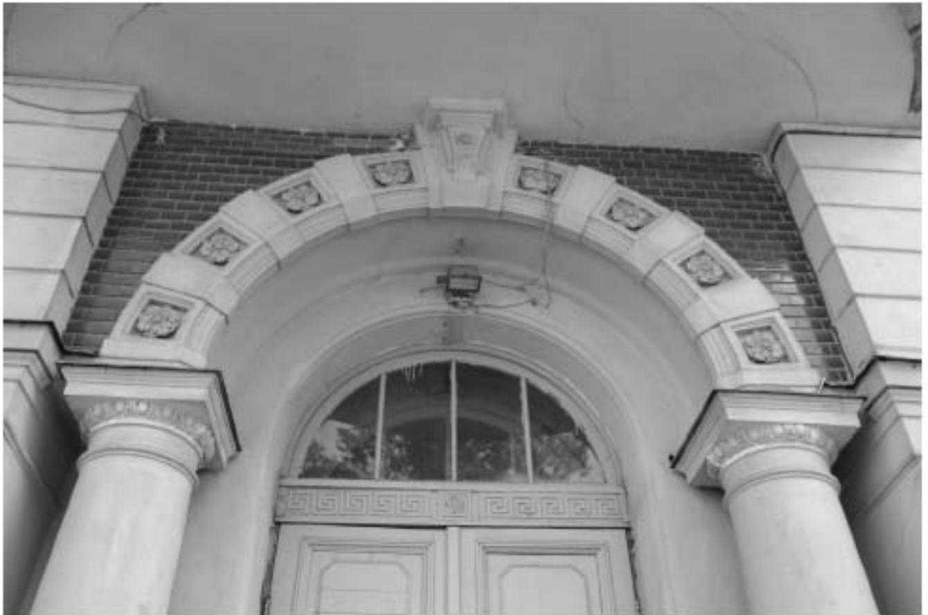
11. Фрагмент оформления двери парадного входа. Вид с запада
