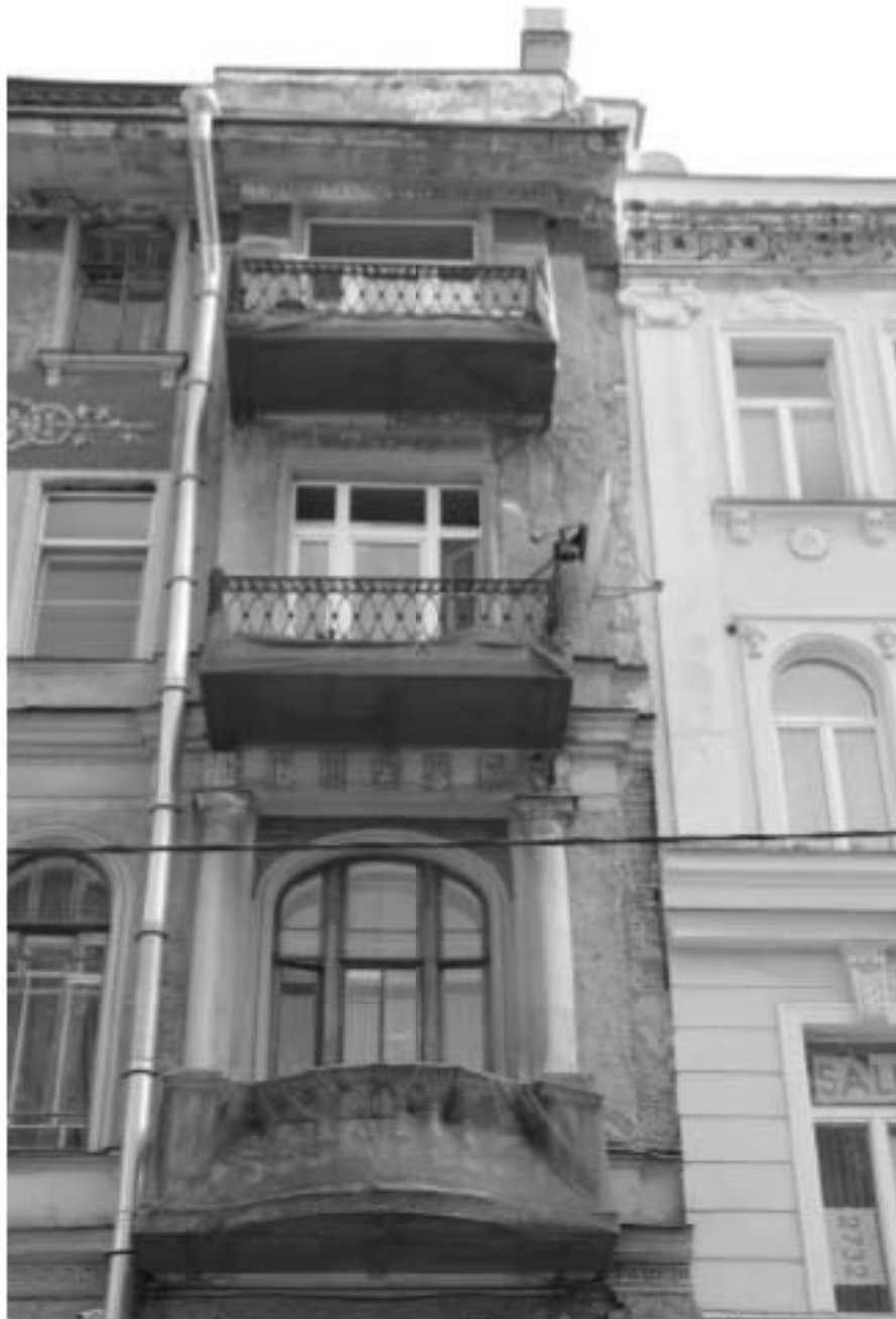
8. Фрагмент главного фасада по улице Таврической. Оформление оконных проемов и балконов. Вид с запада
