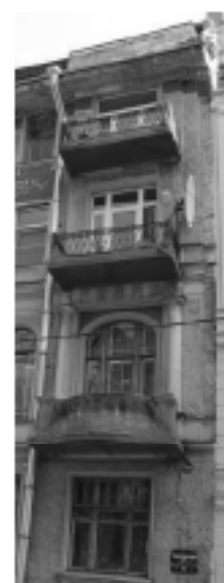
балконы с деревянным и металлическим ограждением по одной из осей фасада
