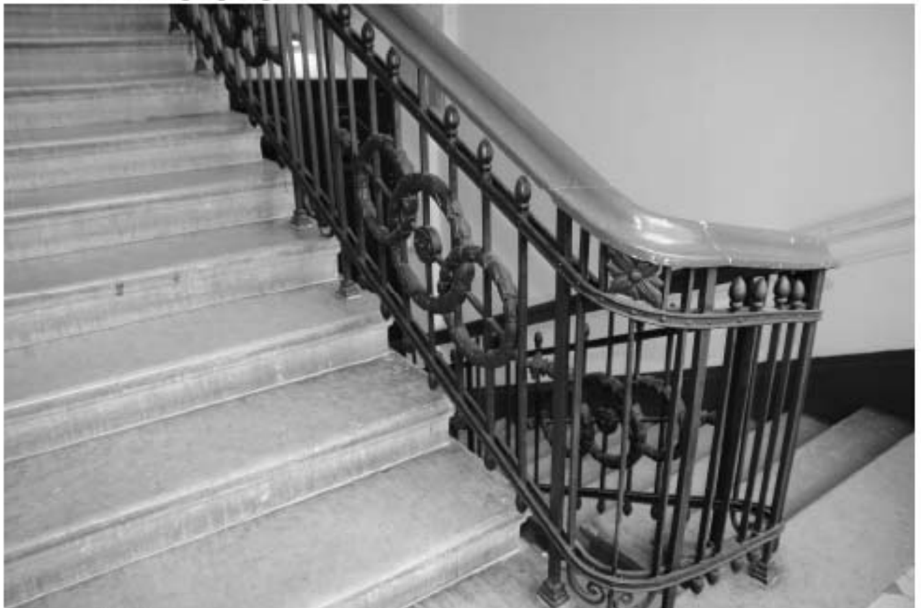
54. Интерьер парадного входа. Фрагмент лестничного ограждения
