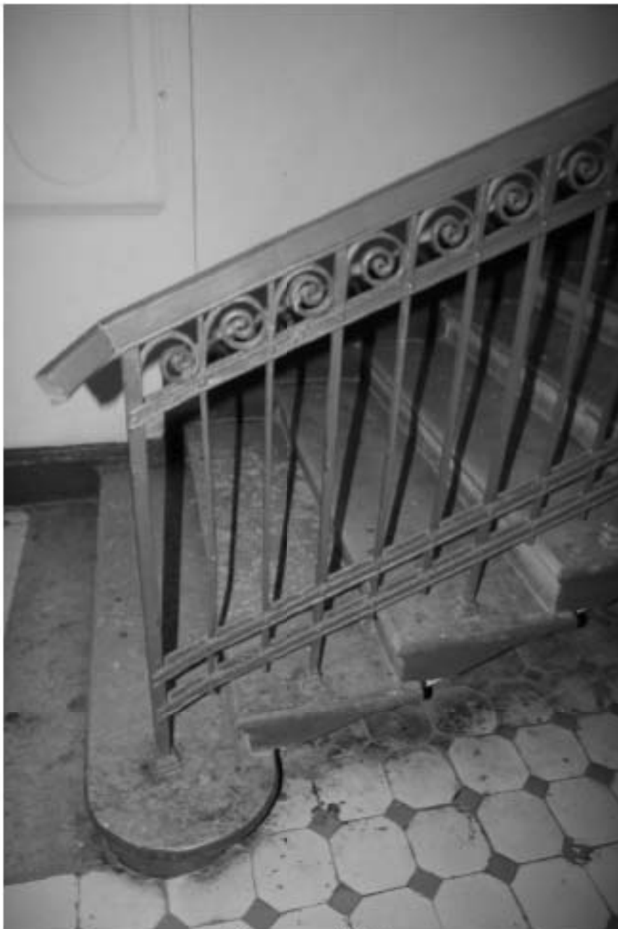
60. Интерьер вестибюля дворовой парадной. Фрагмент лестничного ограждения
