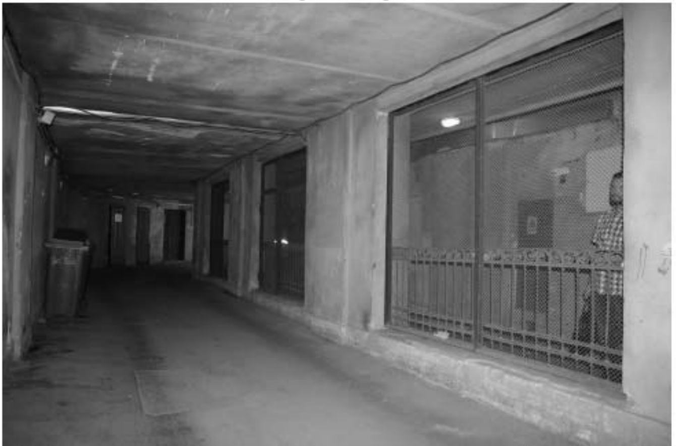
22. Проездная арка. Решетчатые перегородки между проездной аркой и аркой прохода во внутренний двор
