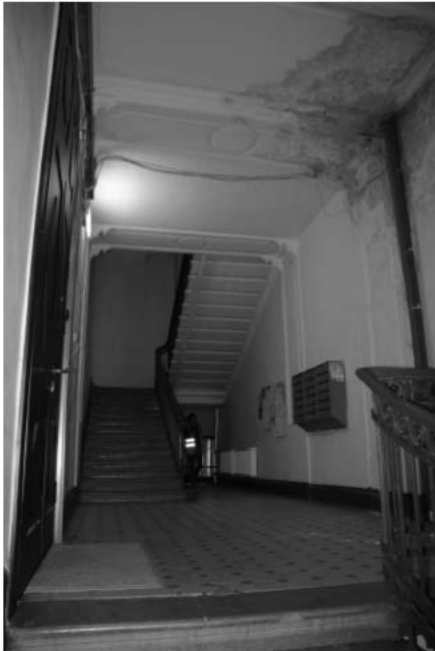
56. Интерьер вестибюля дворовой парадной. Лестница прохода на второй этаж
