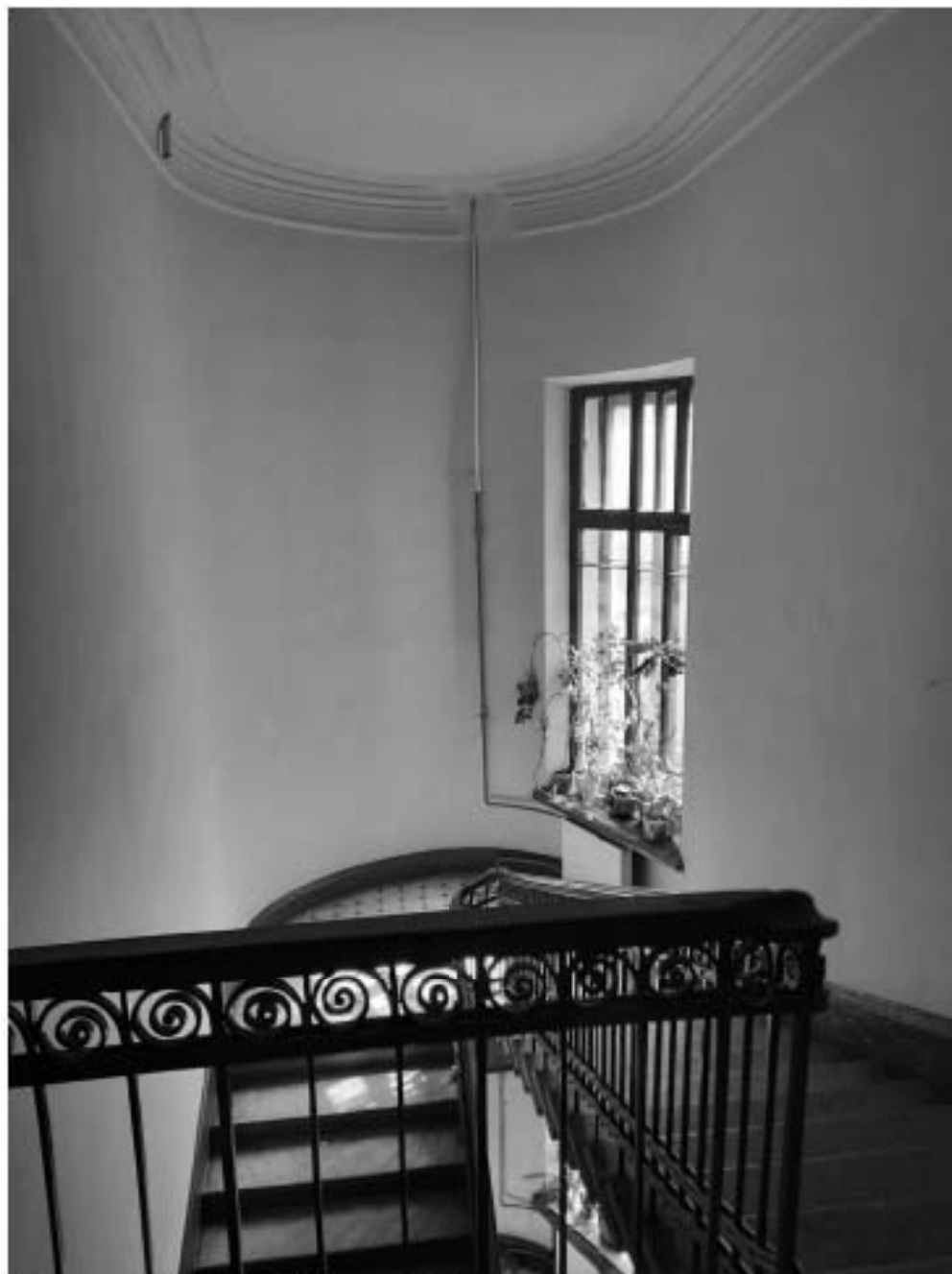
65. Интерьер дворовой парадной. Лестничная площадка пятого этажа
