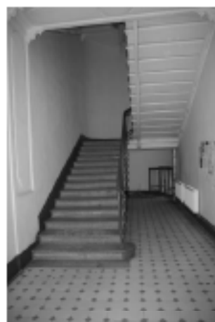
вестибюль служебной лестницы
