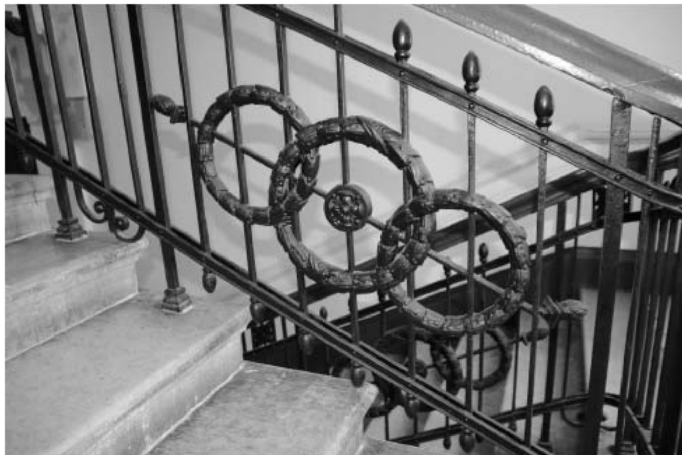
55. Интерьер парадного входа. Фрагмент лестничного ограждения
