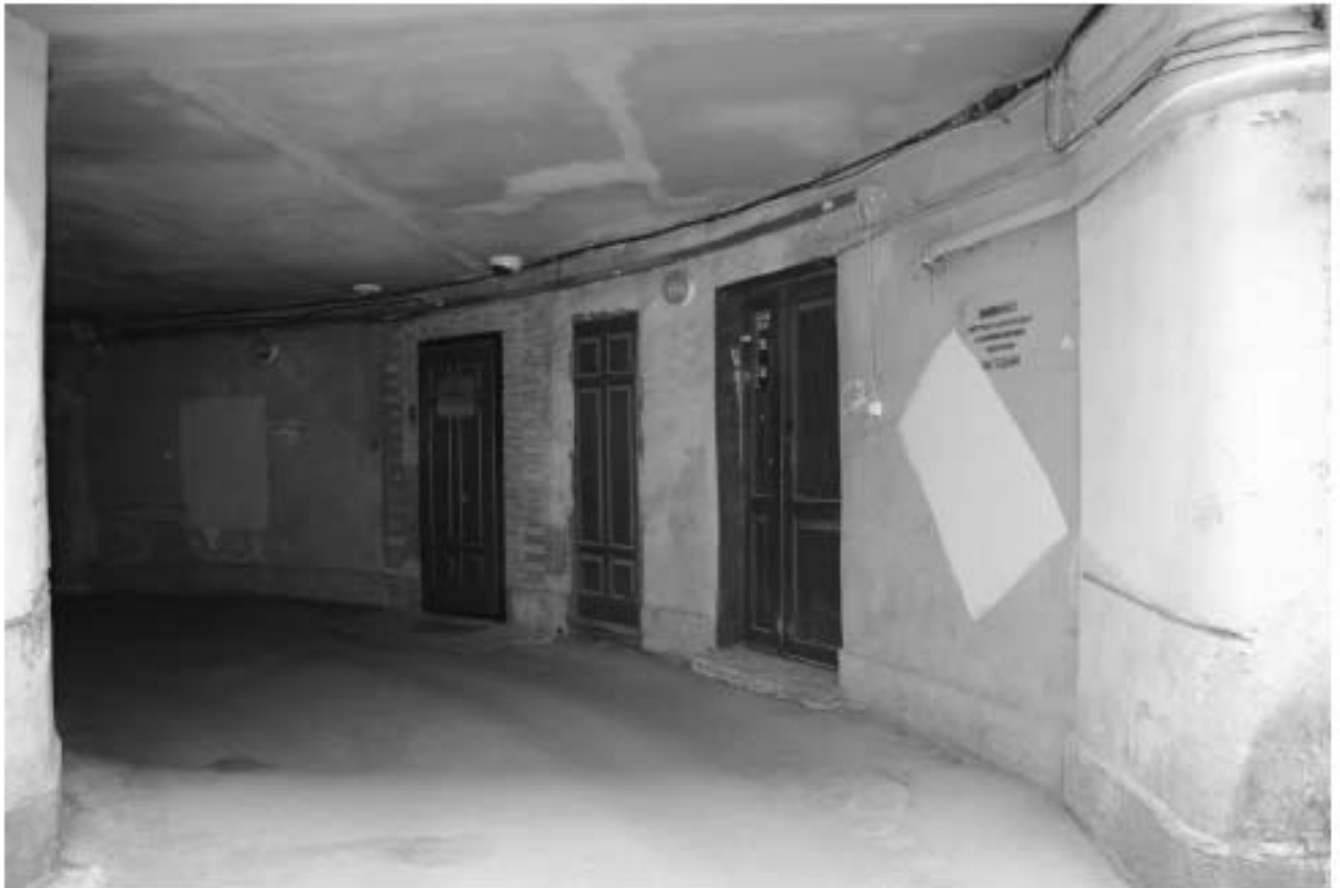
27. Дверные проемы в проездной арке
