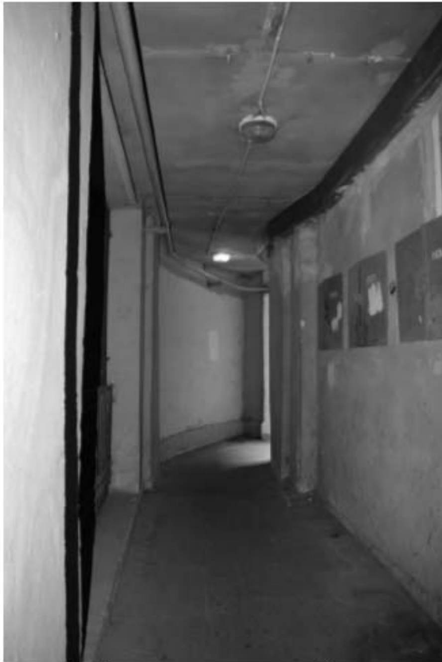
16. Арка прохода во внутренний двор
