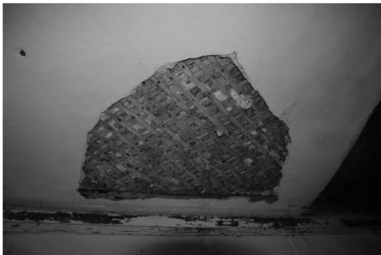
17. Подвальное помещение. Фрагмент оформления потолка
