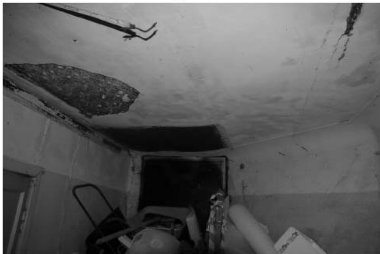
16. Подвальное помещение. Фрагмент оформления потолка
