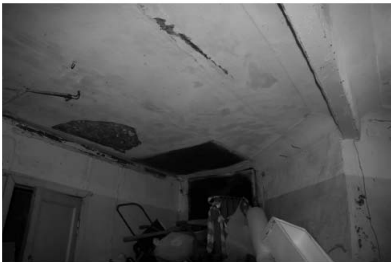
15. Подвальное помещение. Фрагмент оформления потолка
