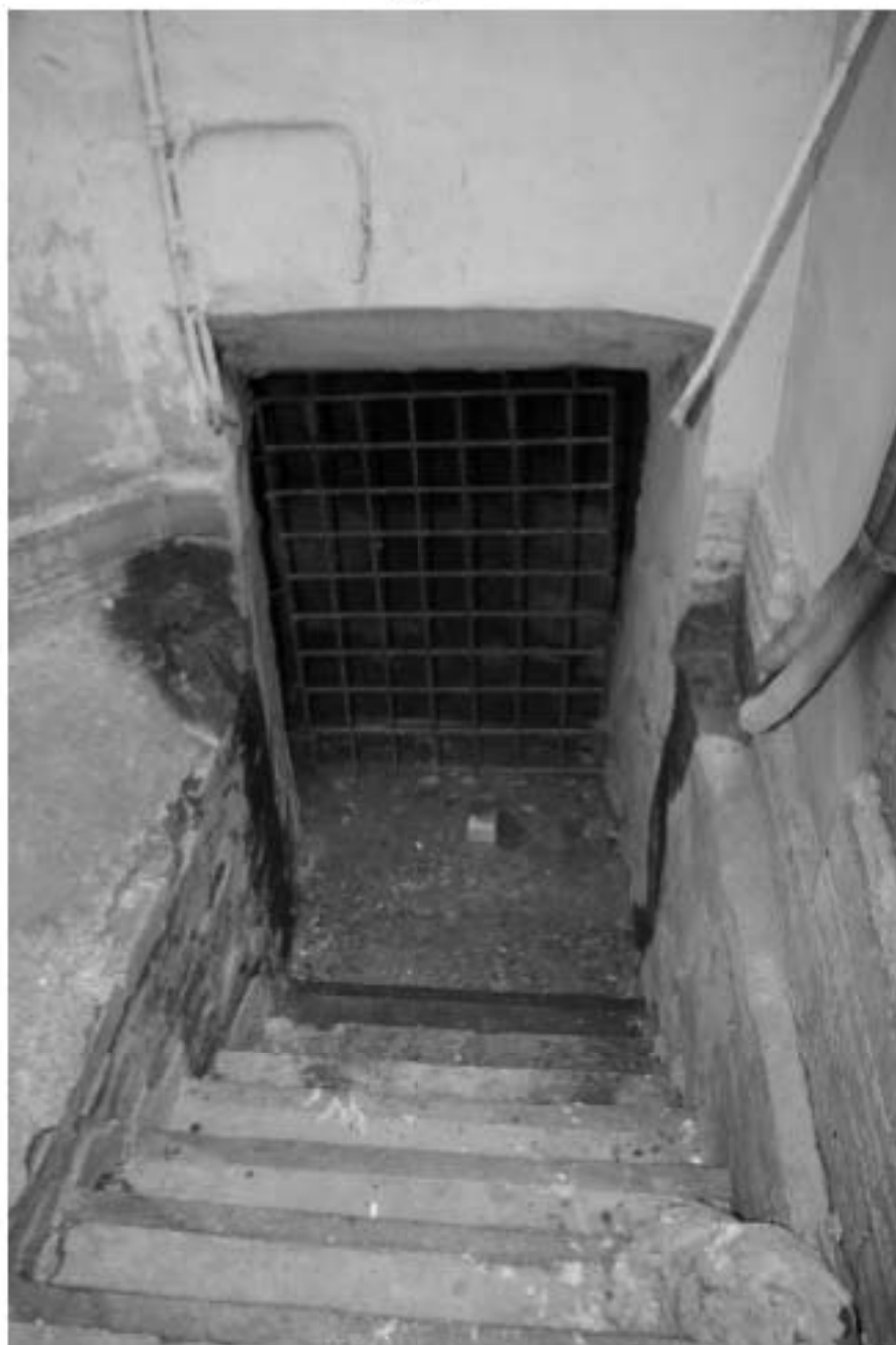
11. Вход в подвал
