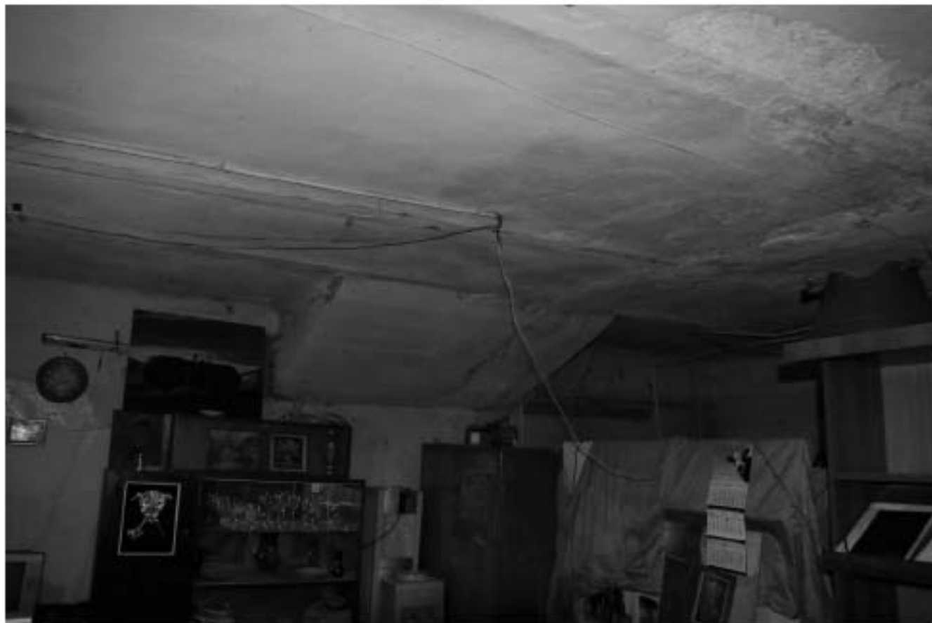
14. Подвальное помещение. Фрагмент оформления потолка
