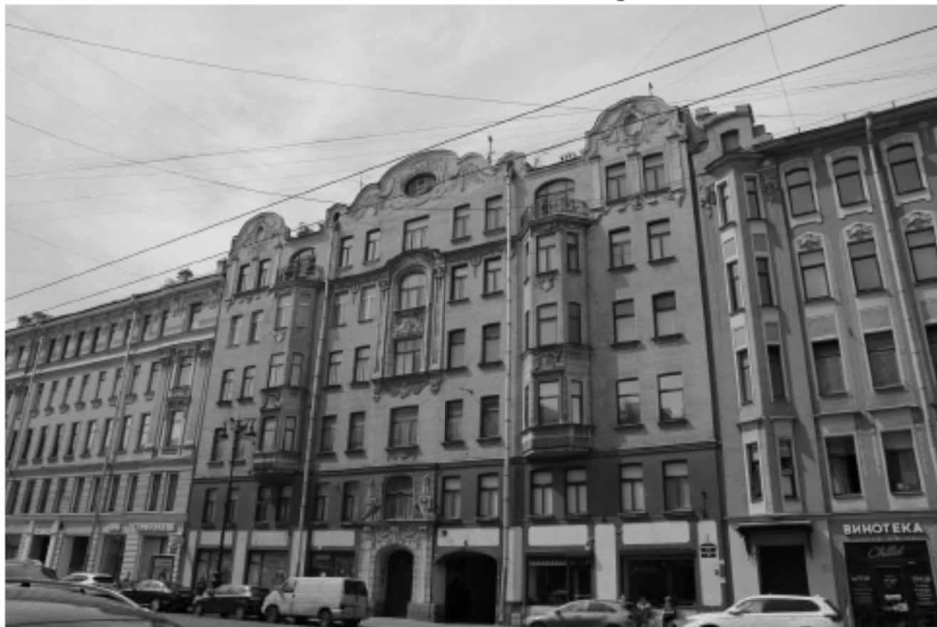
1. Общий вид главного фасада по Суворовскому проспекту. Вид с востока
