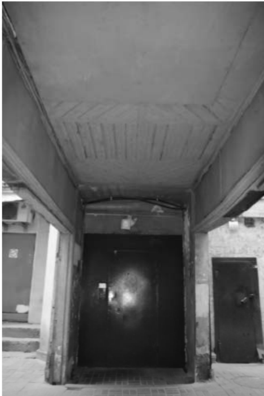
19. Фрагмент фасада внутреннего двора здания. Сторона арки, соединяющей литеру А и литеру Б, с дверью входа в парадную литеры Б. Вид с юго-востока
