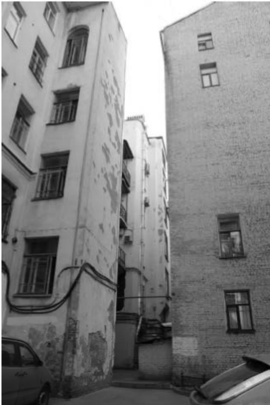
13. Фрагменты фасадов зданий литеры А и литеры Б со стороны внутреннего двора. Вид с северо-востока
