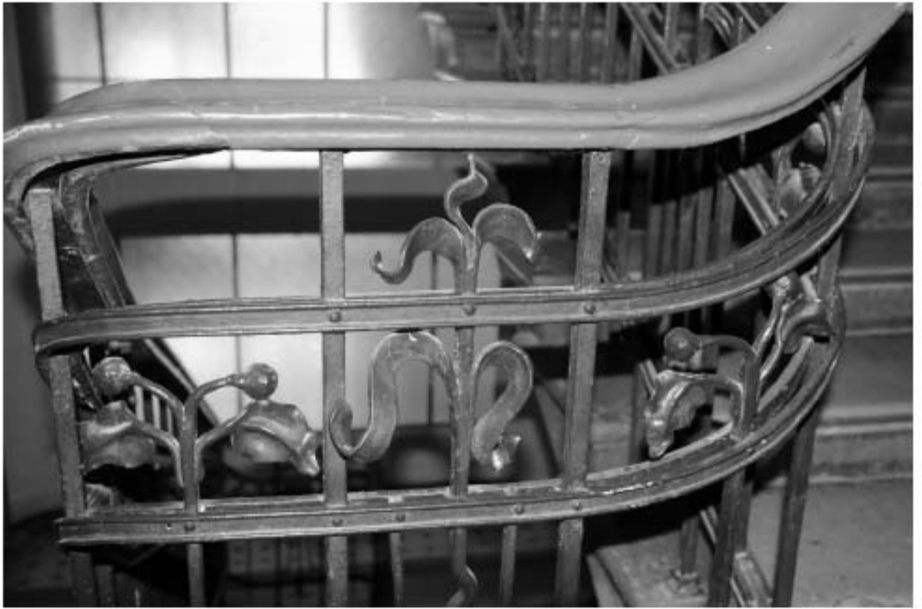
32. Интерьер парадной. Фрагмент лестничного ограждения
