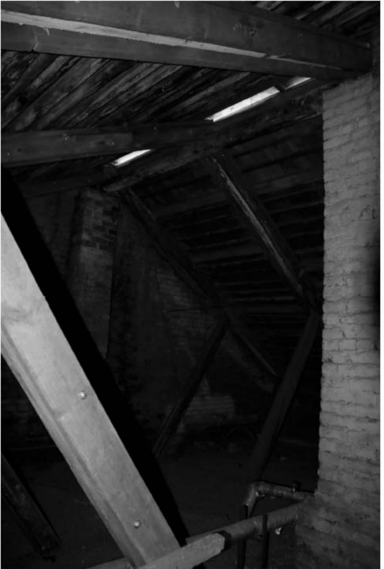
39. Фрагмент чердачного помещения
