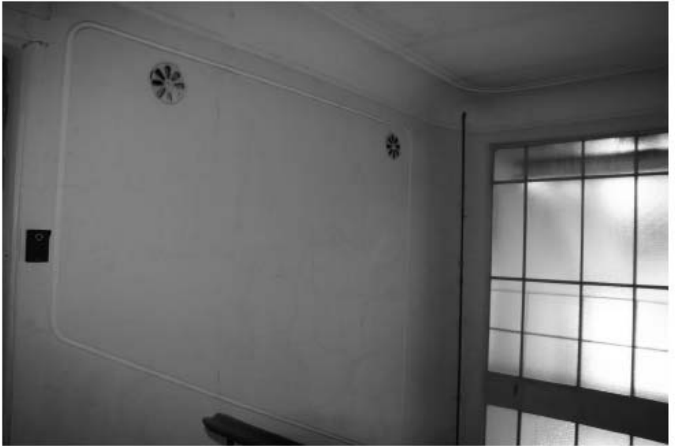
34. Интерьер парадной. Фрагмент оформления стен
