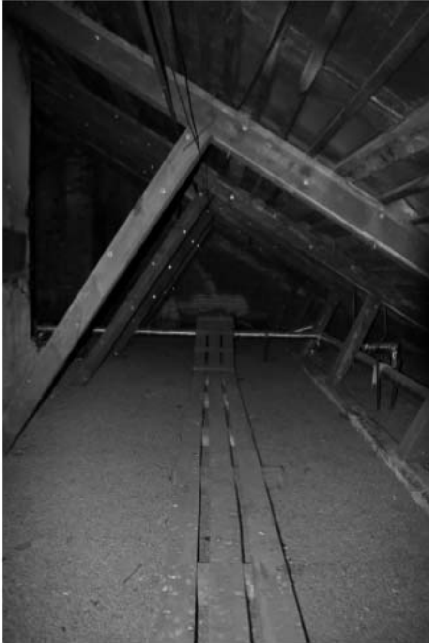
37. Фрагмент чердачного помещения
