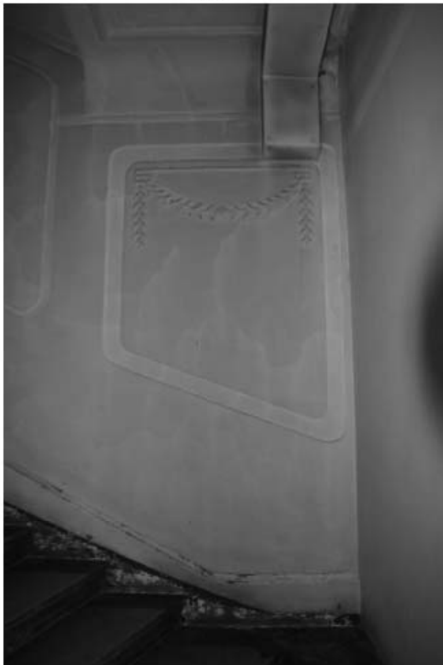
29. Интерьер парадной. Фрагмент оформления стен
