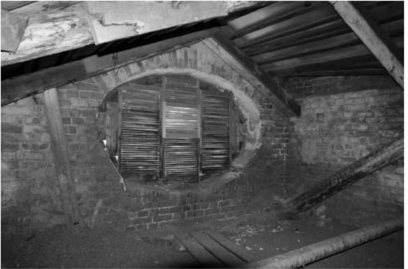
41. Фрагмент чердачного помещения
