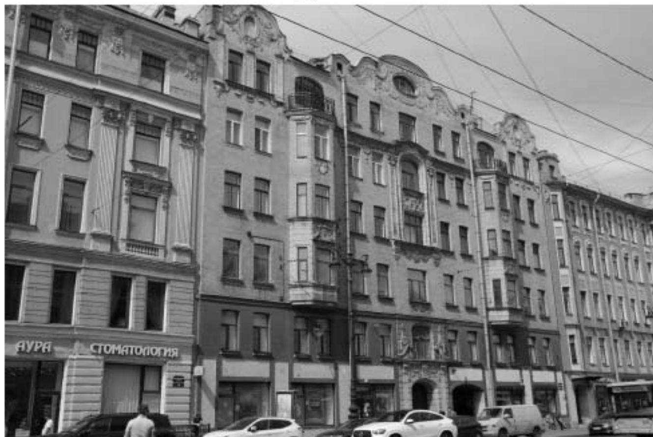
3. Общий вид главного фасада по Суворовскому проспекту. Вид с юга
