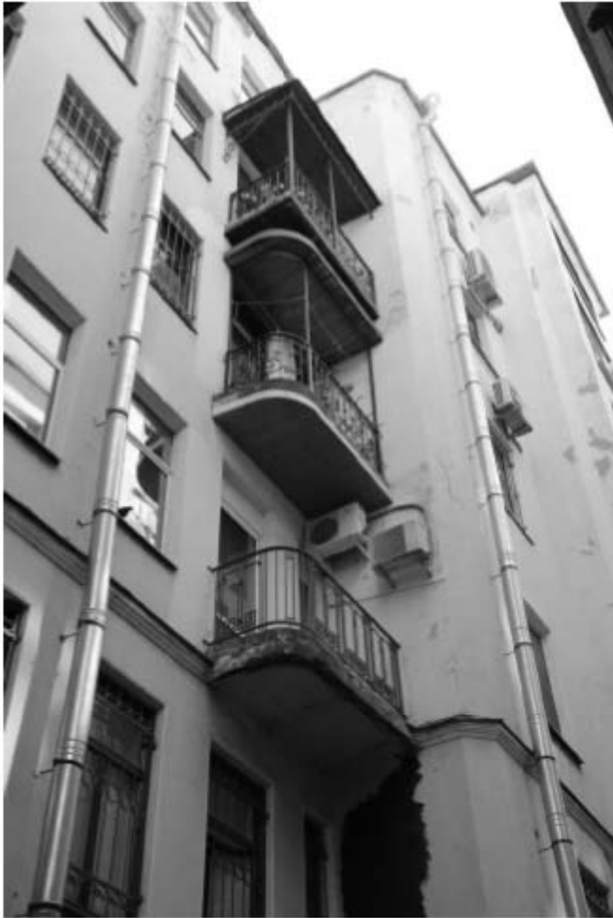
14. Фрагмент фасада со стороны внутреннего двора. Вид с северо-востока
