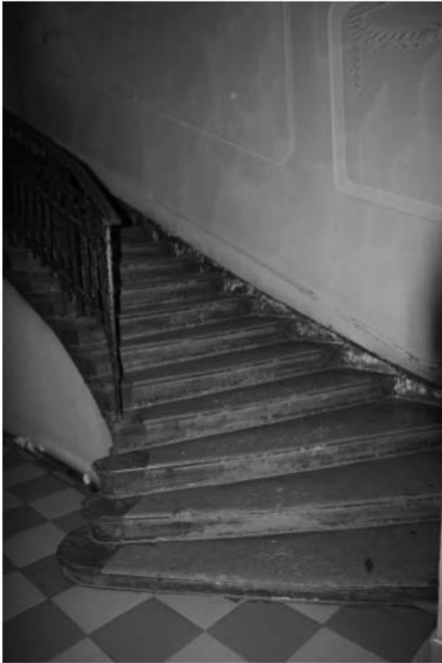
25. Интерьер вестибюля парадной. Фрагмент лестницы на второй этаж
