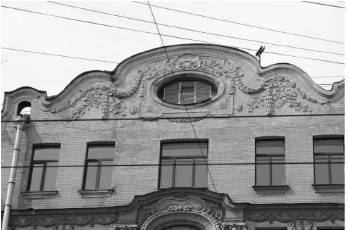
6. Фрагмент главного фасада по Суворовскому проспекту. Центральная часть аттика с окном типа «бычий глаз». Вид с юго-востока
