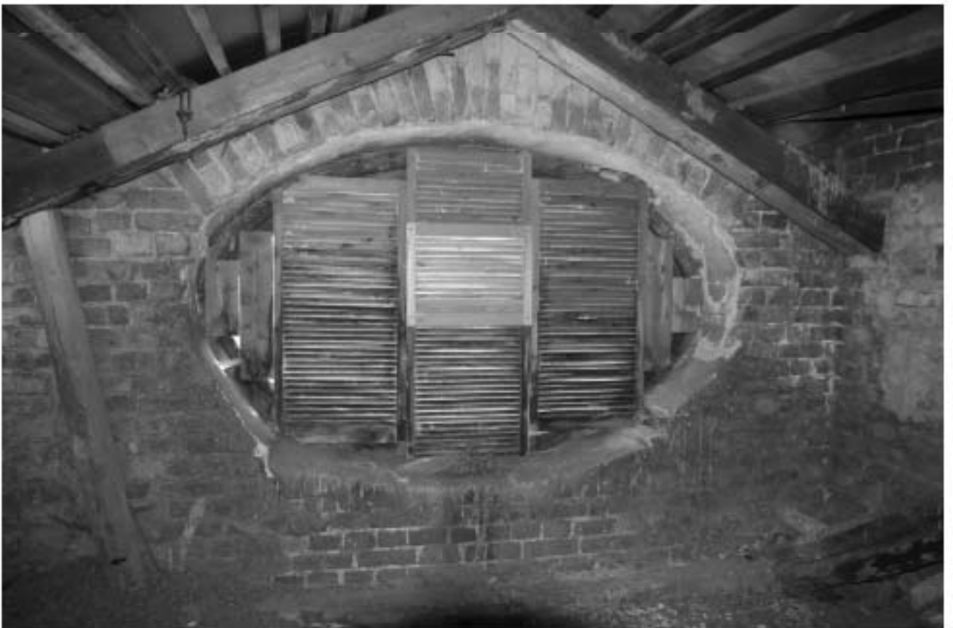
42. Фрагмент чердачного помещения
