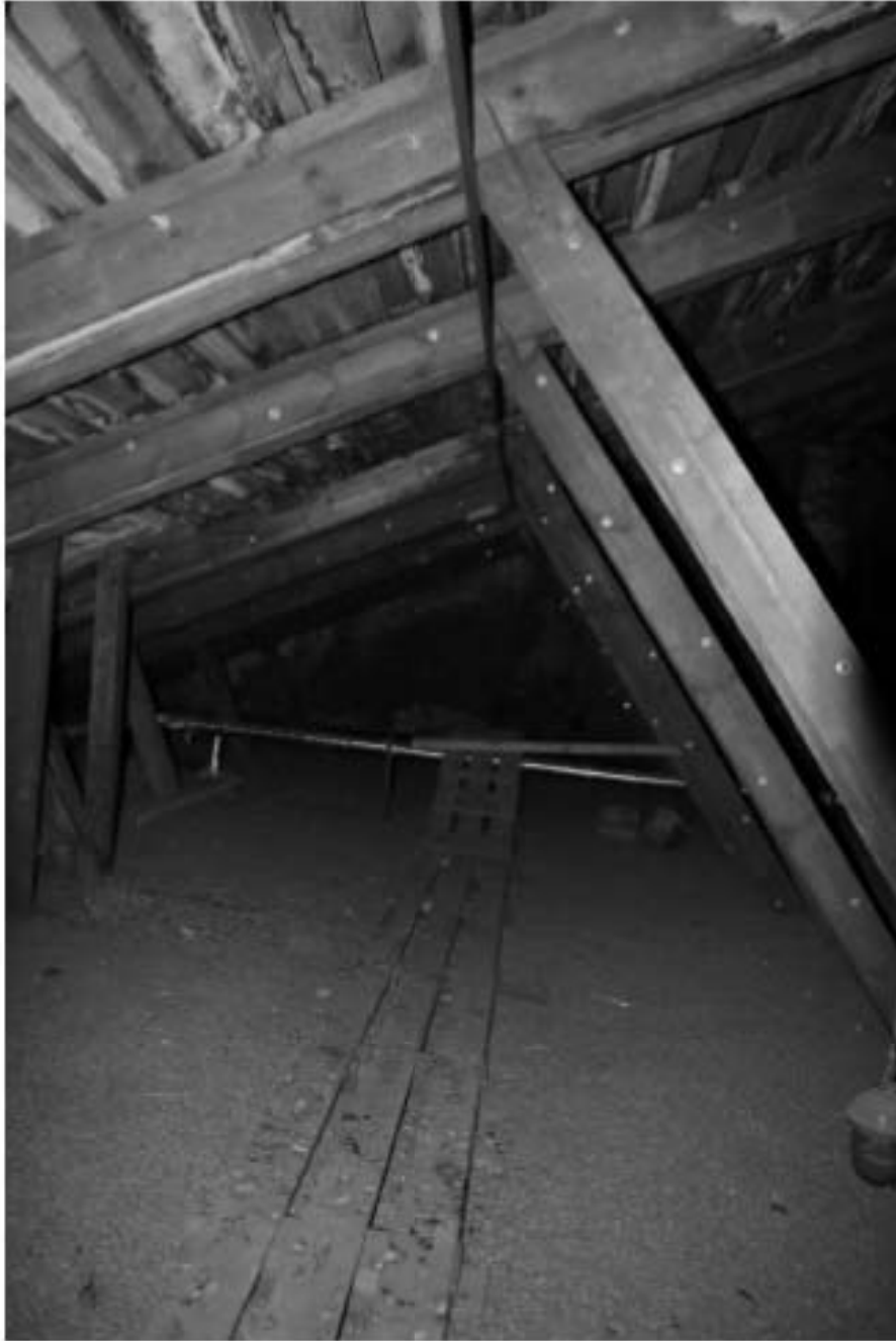
38. Фрагмент чердачного помещения
