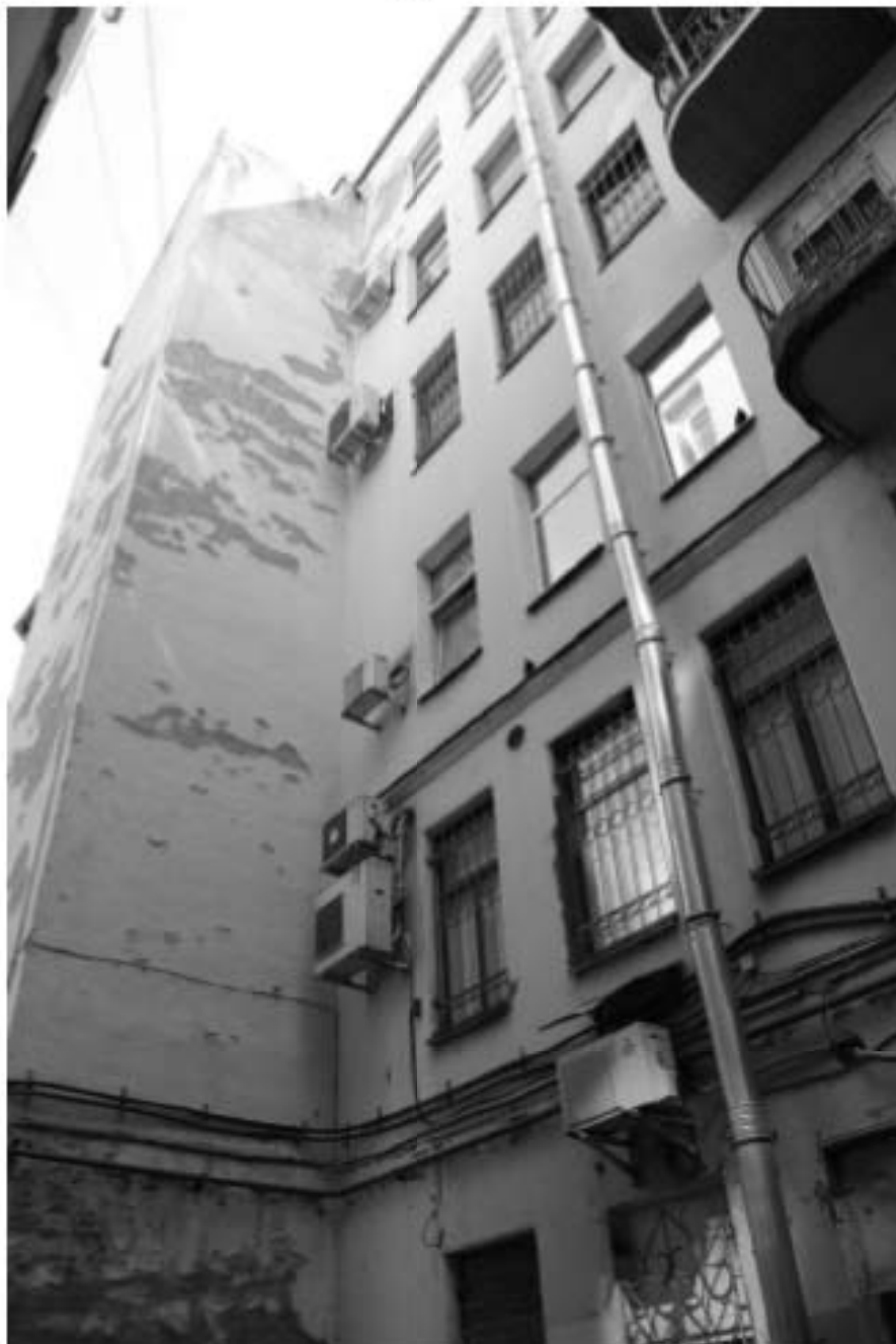
15. Фрагмент фасада со стороны внутреннего двора. Вид с запада
