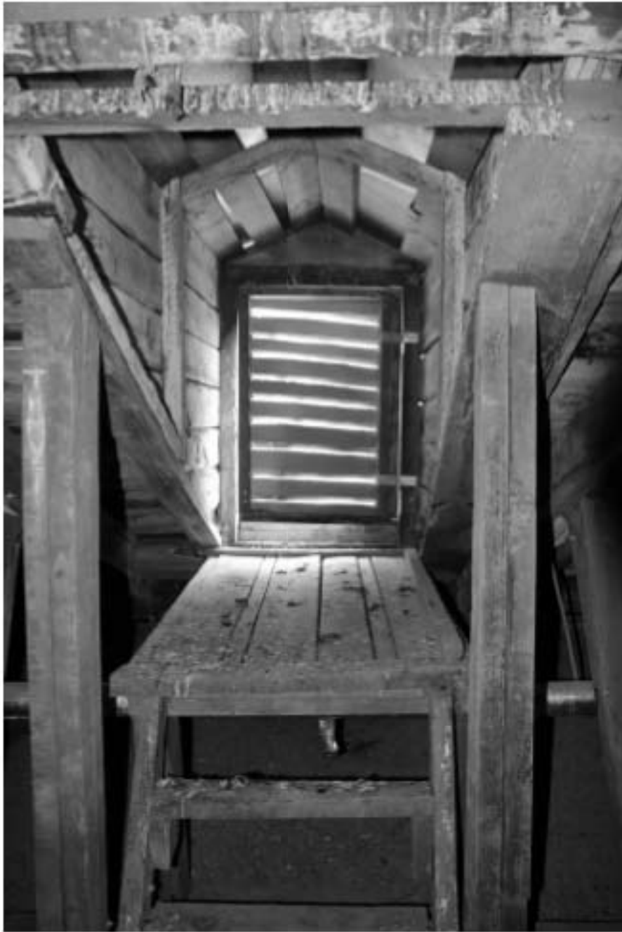
40. Фрагмент чердачного помещения. Чердачное окно
