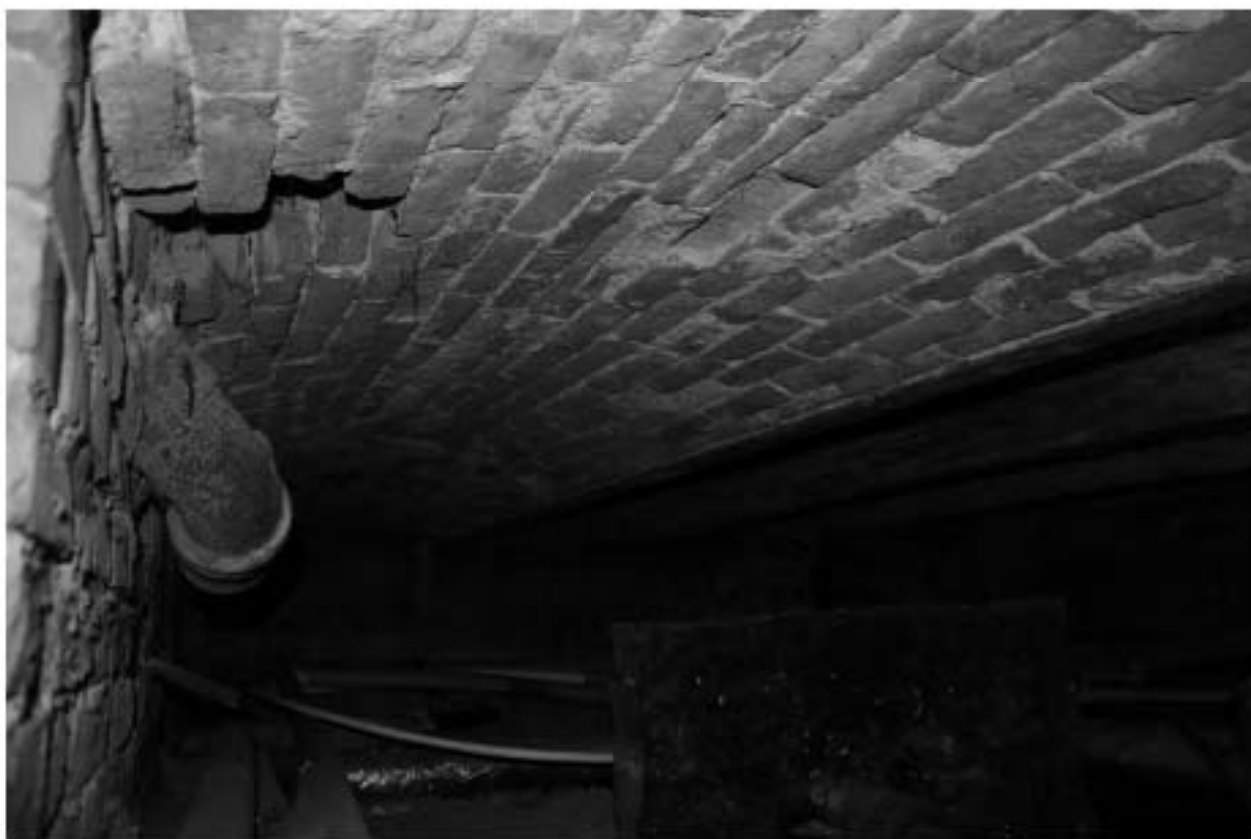
18. Фрагмент оформления потолка подвального помещения
