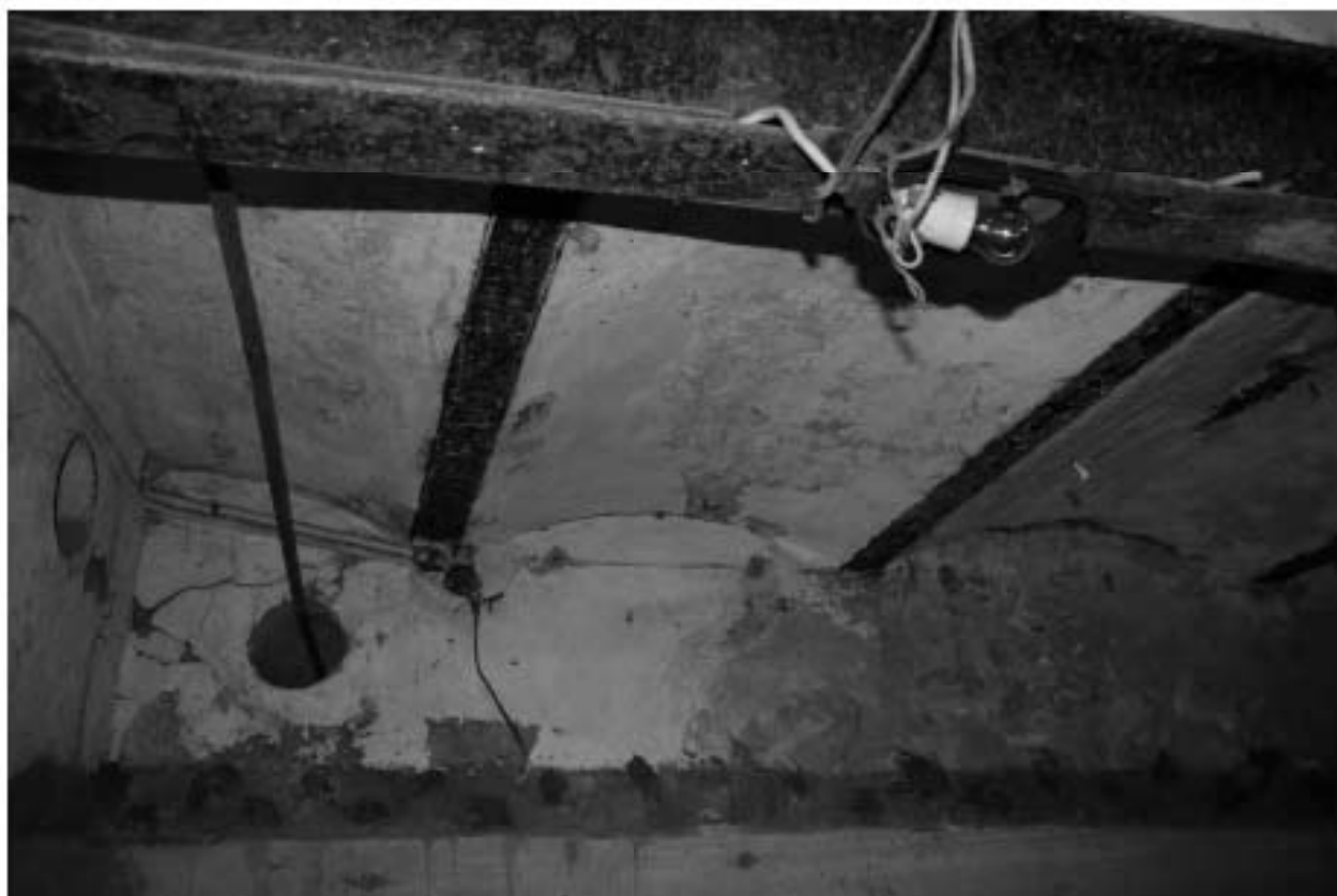
16. Фрагмент оформления потолка подвального помещения
