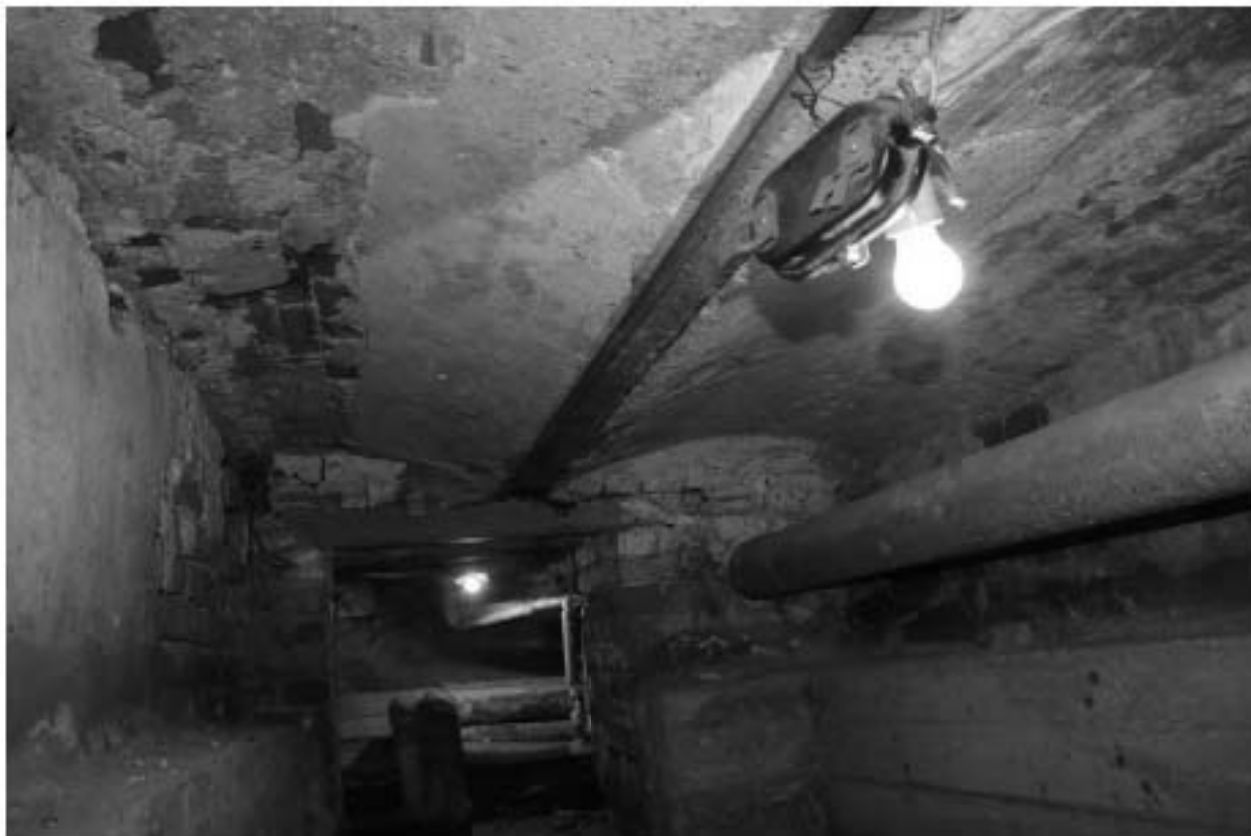
17. Фрагмент оформления потолка подвального помещения
