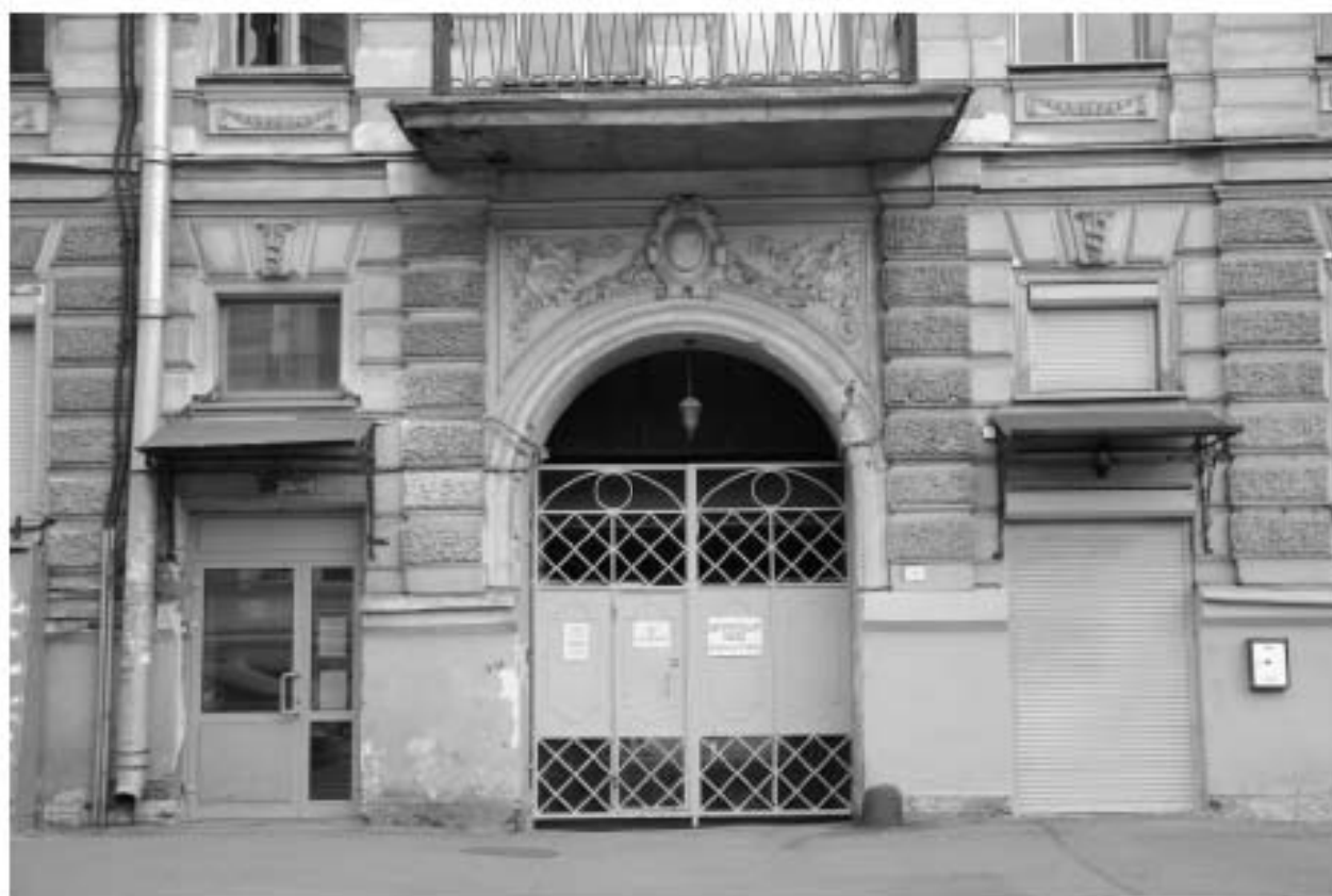
4. Фрагмент главного фасада по Саперному переулку. Оформление воротного проезда. Вид с севера
