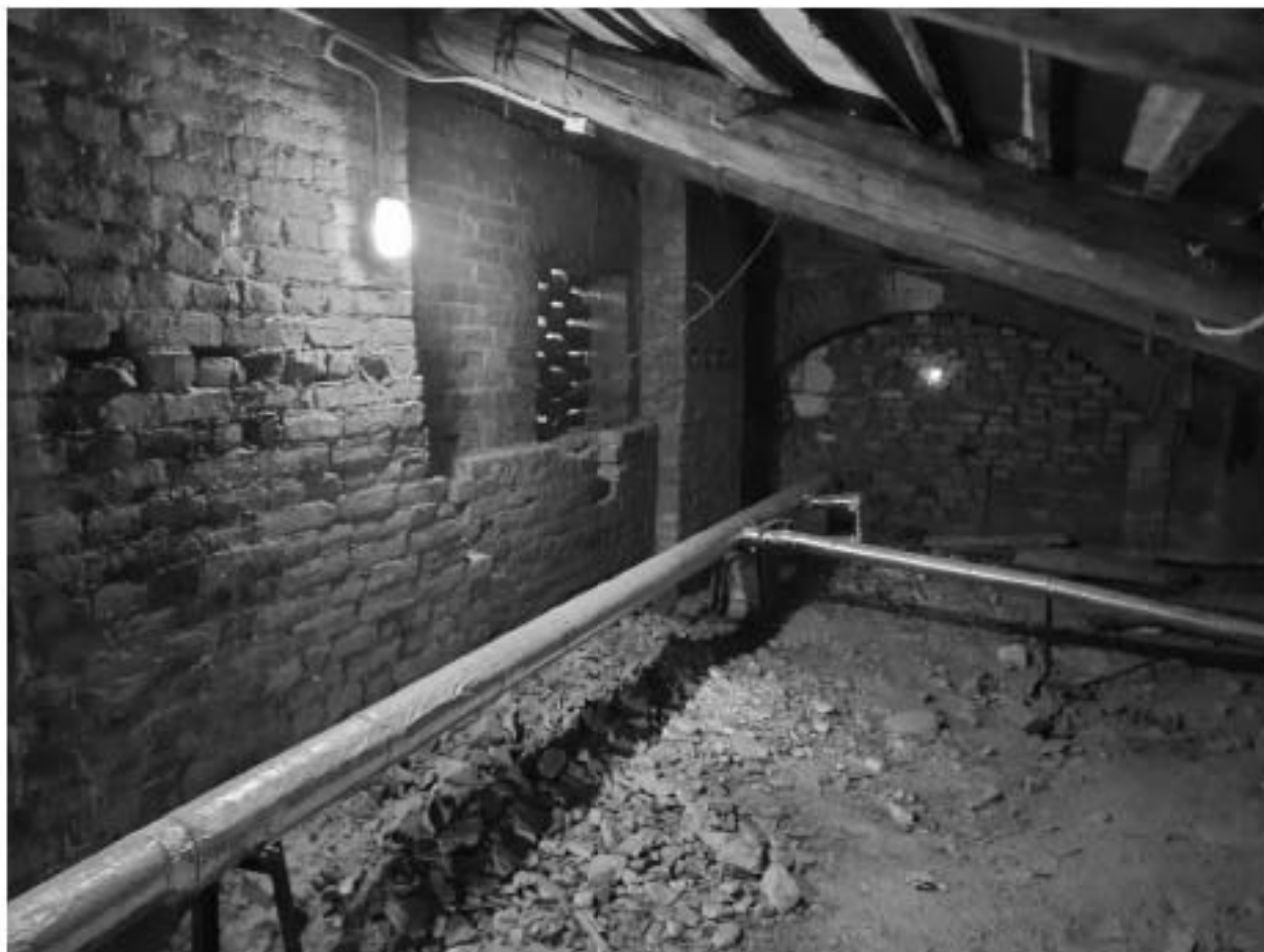
26. Фрагмент интерьера чердачного помещения
