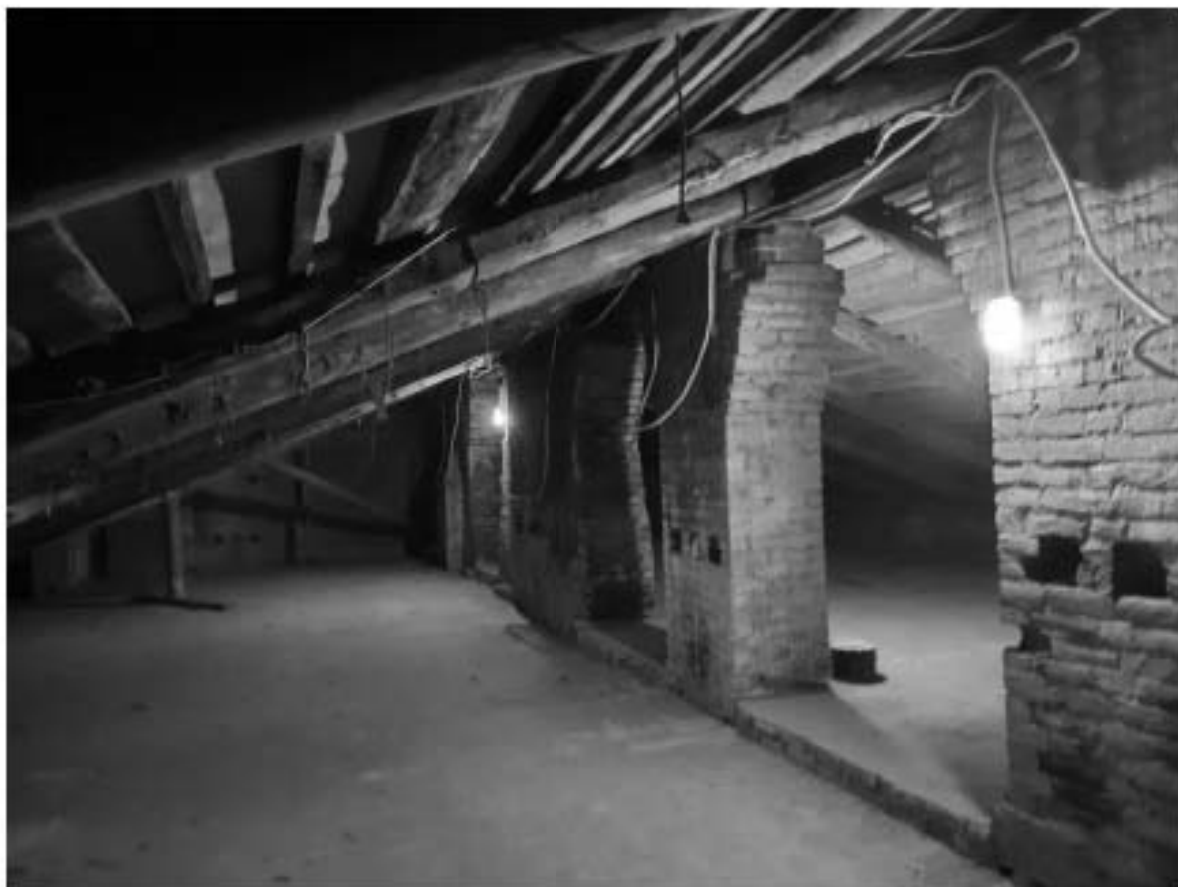
24. Фрагмент интерьера чердачного помещения
