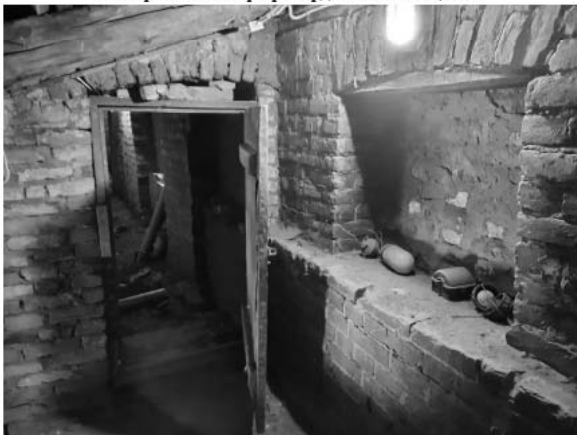
25. Фрагмент интерьера чердачного помещения
