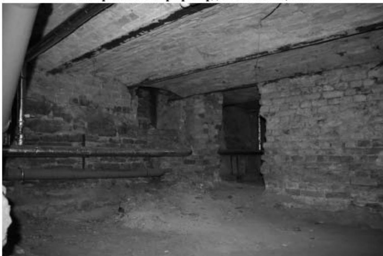
27. Фрагмент интерьера подвального помещения
