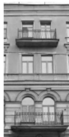
проемы балконных дверей
