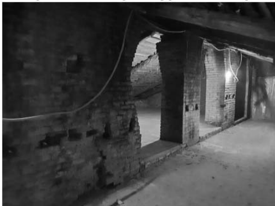
23. Фрагмент интерьера чердачного помещения
