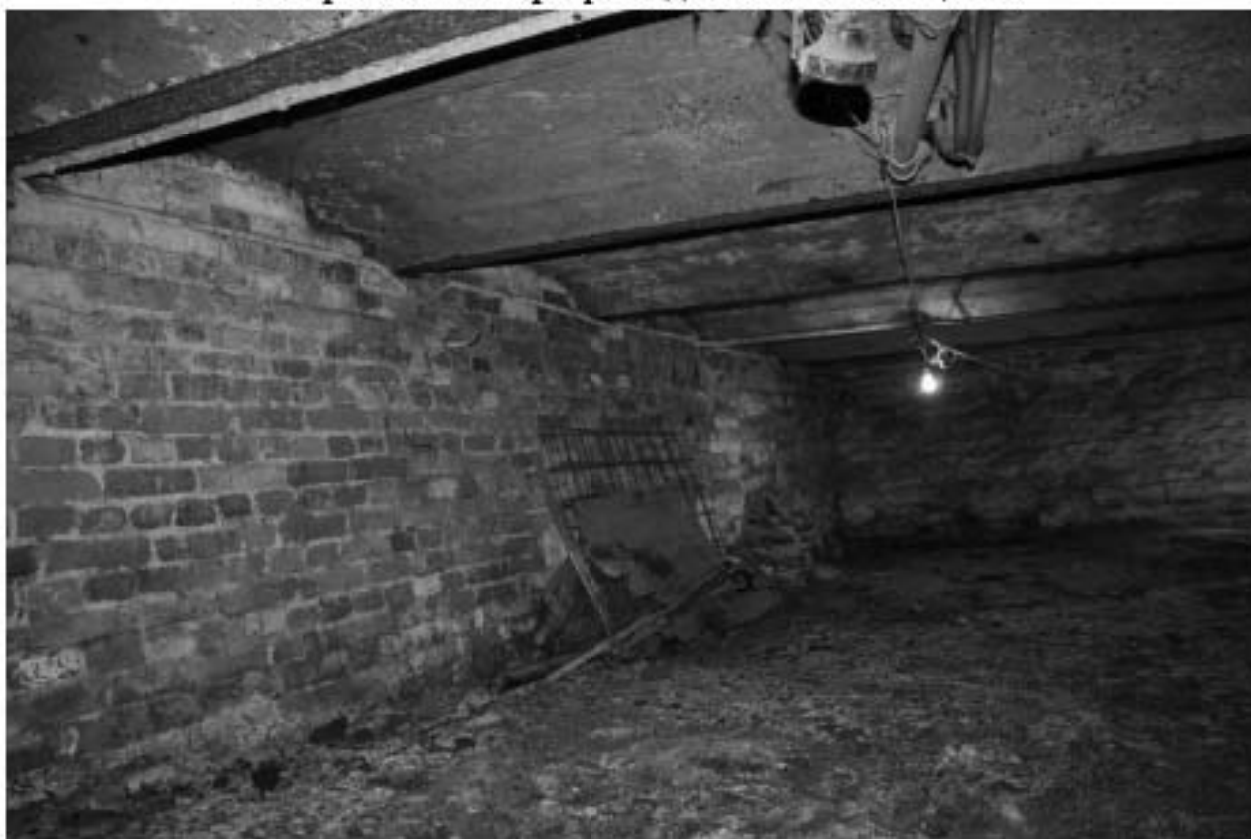
29. Фрагмент интерьера подвального помещения
