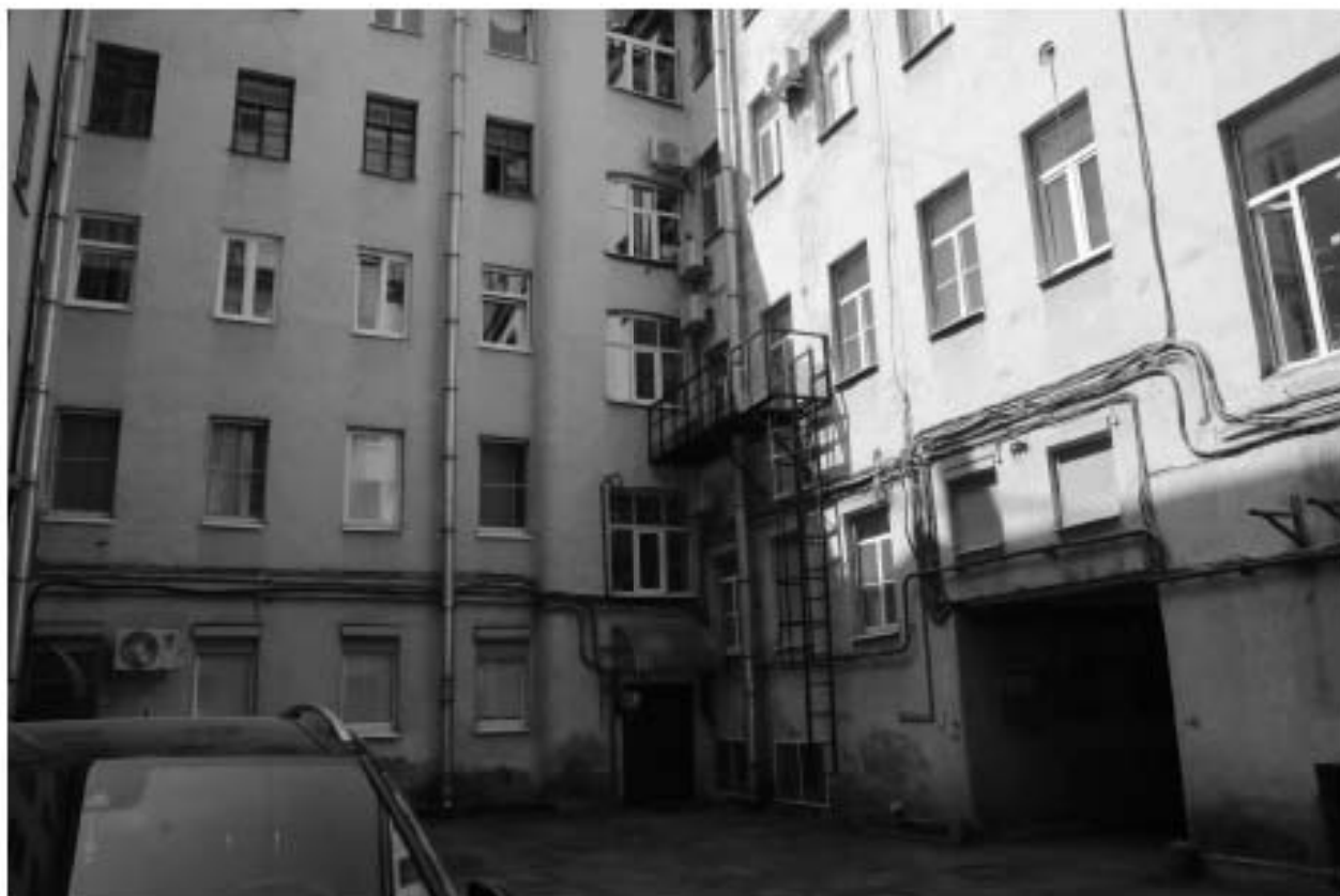
10. Фрагмент фасада внутреннего двора. Вид с юго-востока
