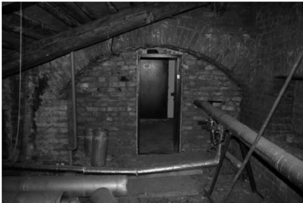
22. Чердачное помещение. Фрагмент оформления входа на чердак
