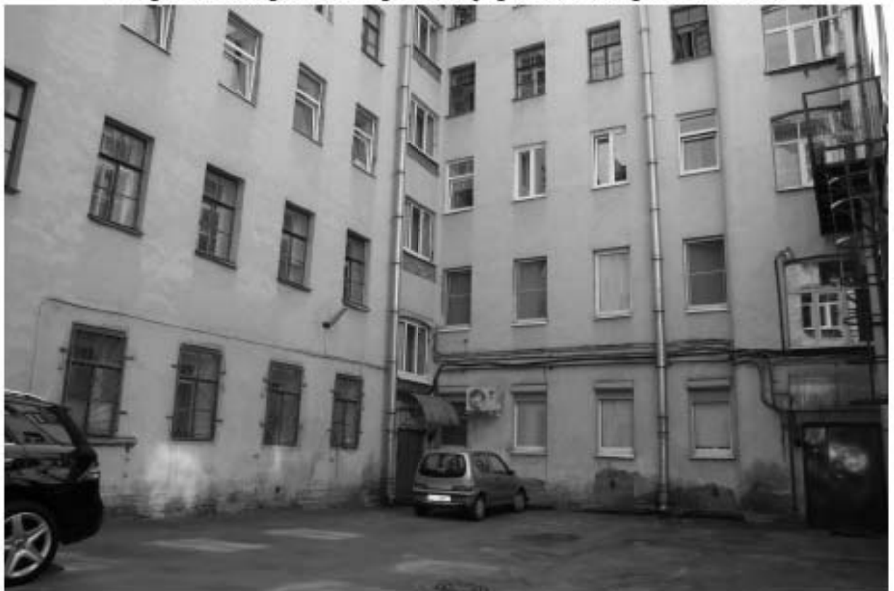
8. Фрагмент фасадов внутреннего двора. Вид с северо-востока
