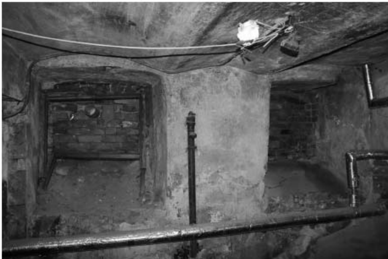
28. Фрагмент интерьера подвального помещения
