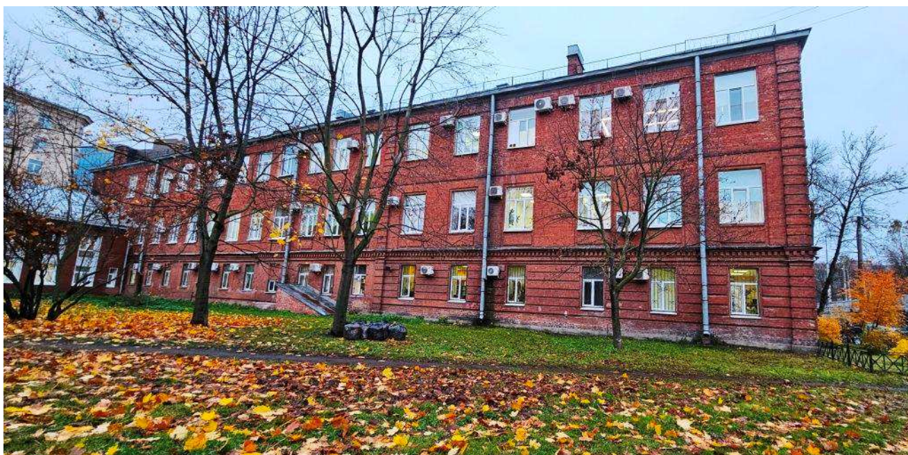
4. Вид продольного (южного) фасада.
