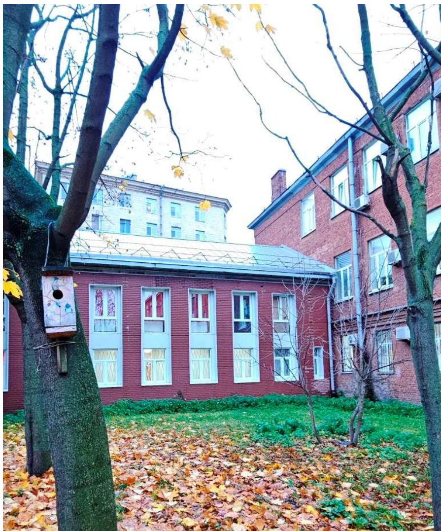
5. Поздняя пристройка к южному фасаду.
