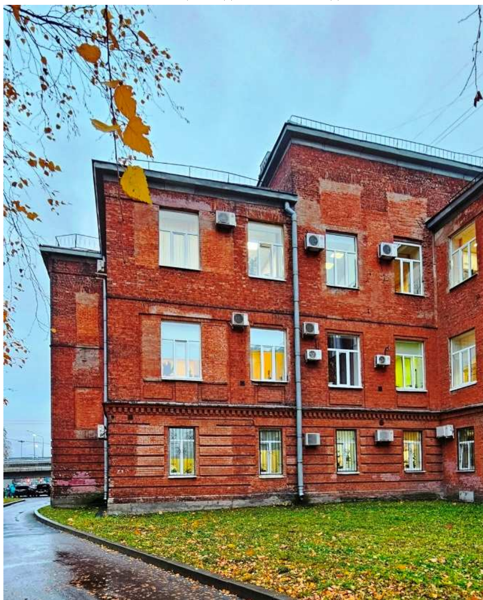
10. Вид западного фасада основного объема.
