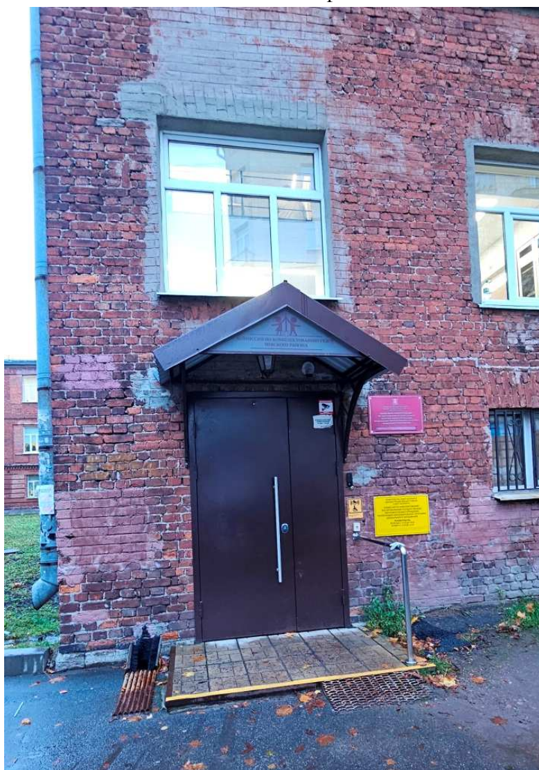
8. Фрагмент западного фасада. Вход.
