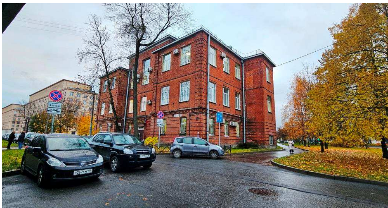
12. Общий вид объекта с северо-востока.
