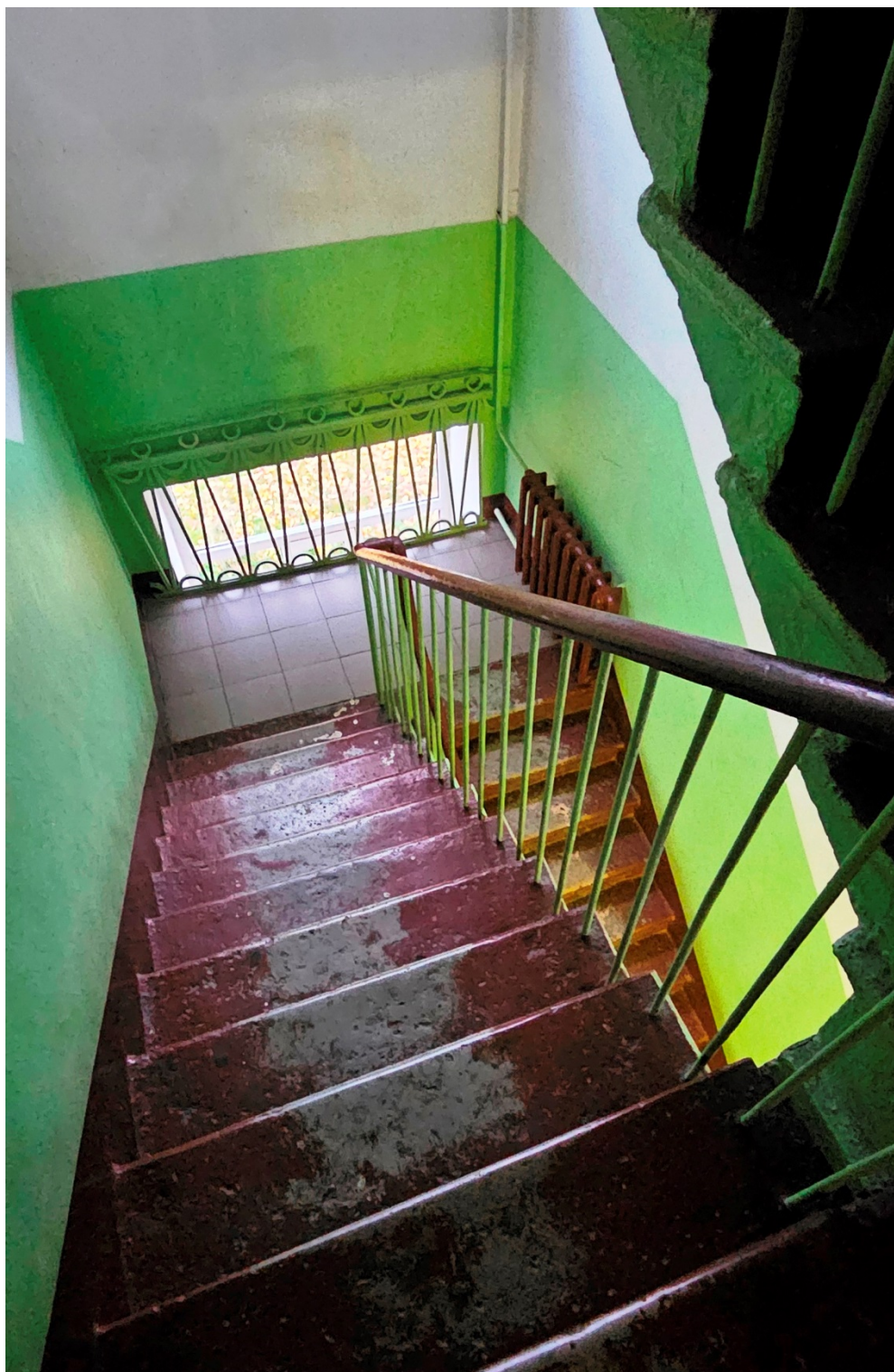
29. Служебная лестница. Общий вид конструкций.
