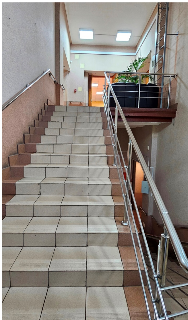
21. Главная лестница. Вид на площадку 3-го этажа.
