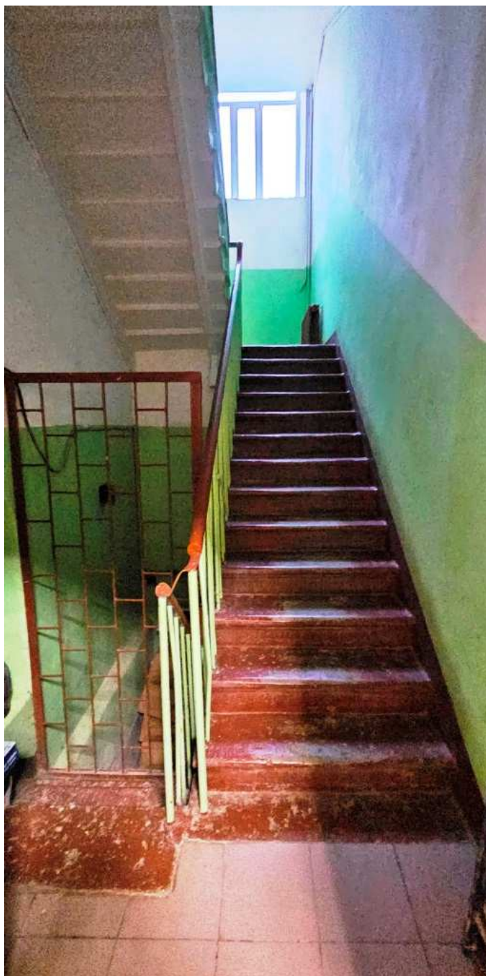
27. Служебная лестница. Площадка 1-го этажа.
