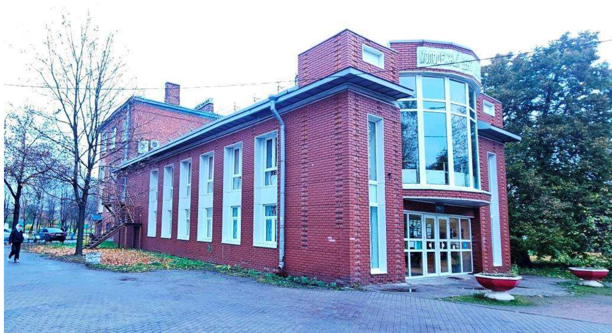
6. Общий вид поздней пристройки к южному фасаду.
