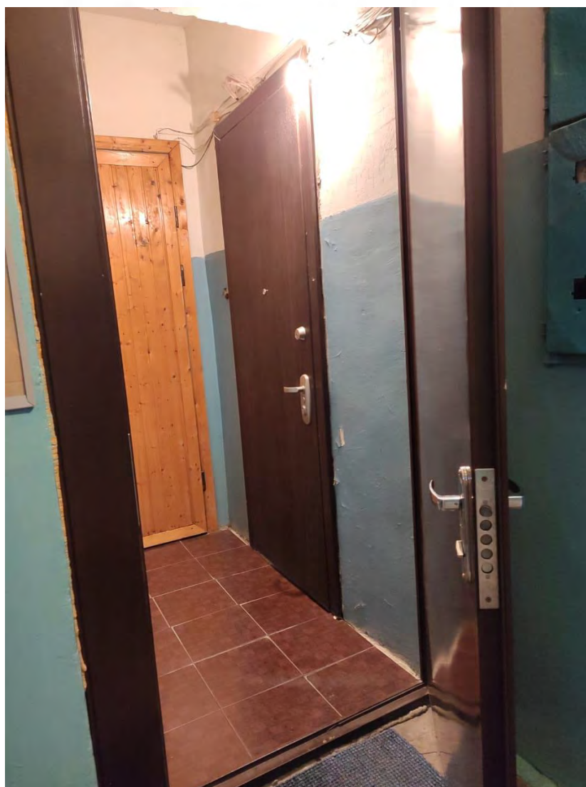
5. Входное дверное заполнение кв. № 2 в уровне 1-го этажа на юго-восточном лицевом фасаде объекта культурного наследия регионального значения «Дом Н.И. Олонкина, в котором в 1864-1867 годах жил Ф.М. Достоевский», расположенного по адресу: г. Санкт-Петербург, ул. Казначейская, д. 7, лит. А. Вид с лестничной клетки. Фото предоставлено заказчиком.
