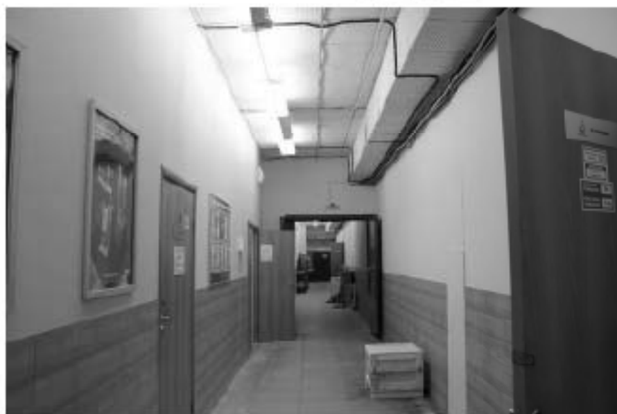
92. «Производственный корпус» (24-я линия В.О., д. 3-7, литера Ж-1 (Ж7)), входящий в состав заглавного объекта культурного наследия «Комплекс сооружений электромеханического завода «Сименс-Шуккерт»». 3-й этаж, пом. 24-Н(53). Дата фотофиксации: 10.09.2025.
