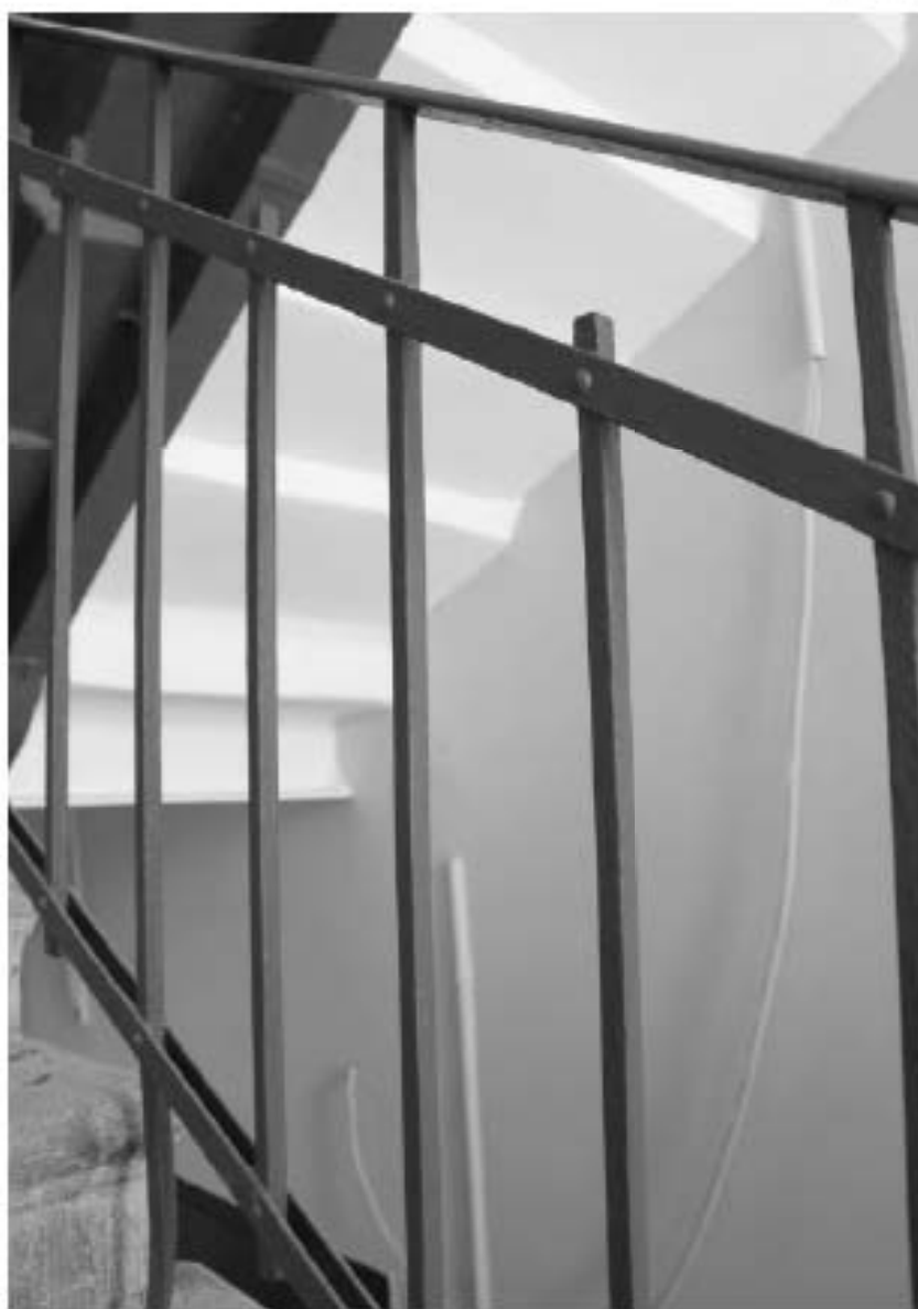
76. «Дом владельца» (24-я линия, д. 3-7, литера С (Ж6)), входящий в состав выявленного объекта культурного наследия «Комплекс сооружений электромеханического завода «Сименс-Шуккерт»». Ограждение лестничных маршей. Фрагмент. Дата фотофиксации: 10.09.2025.
