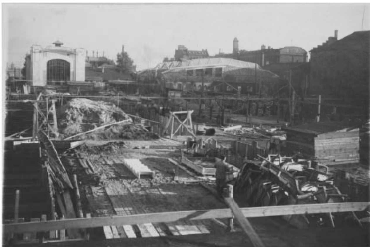
116. Общий вид территории завода во время реконструкции. 1929-1930 гг. // ЦГАКФФД СПб. Шифр: Гр 19864.
