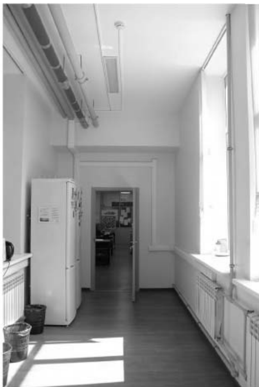
116. «Производственный корпус» (24-я линия В.О., д. 3-7, литера Ж-2 (ЖЗ)), входящий в состав выявленного объекта культурного наследия «Комплекс сооружений электромеханического завода «Сименс-Шуккерт»». 2-й этаж, пом. 1-Н (103). Вид в сторону помещения 1-Н (100). Дата фотофиксации: 10.09.2025.
