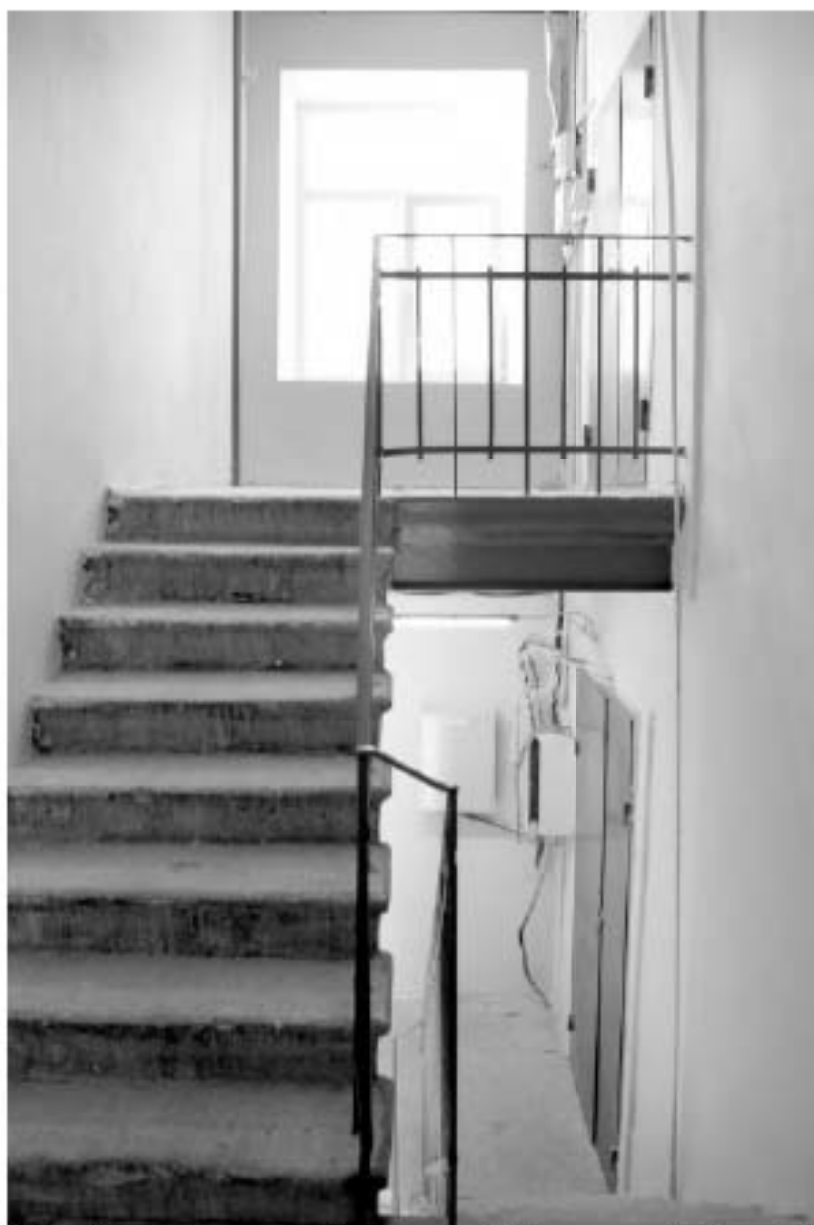
143. «Производственный корпус» (24-я линия В.О., д. 3-7, литера П (Ж5)), входящий в состав выявленного объекта культурного наследия «Комплекс сооружений электромеханического завода «Сименс-Шуккерт»». 5-й этаж, ЛК-1. Общий вид лестничного марша с площадки между 4-м и 5-м этажами. Дата фотофиксации: 10.09.2025.
