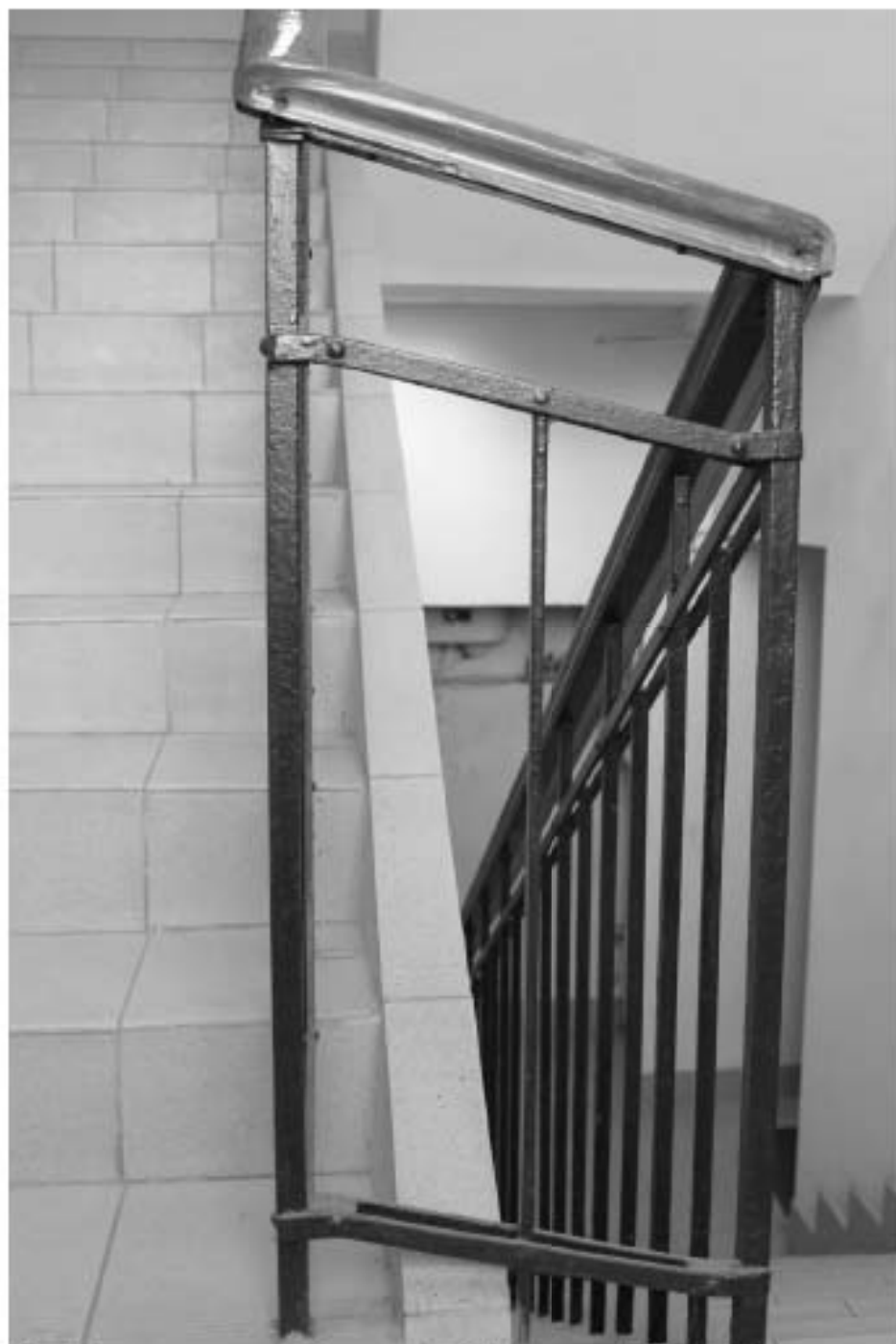
80. «Производственный корпус» (24-я линия В.О., д. 3-7, литера Ж-1 (Ж7)), входящий в состав выявленного объекта культурного наследия «Комплекс сооружений электромеханического завода «Сименс-Шуккерт»». Ограждение лестницы (ЛК-3). Дата фотофиксации: 10.09.2025.
