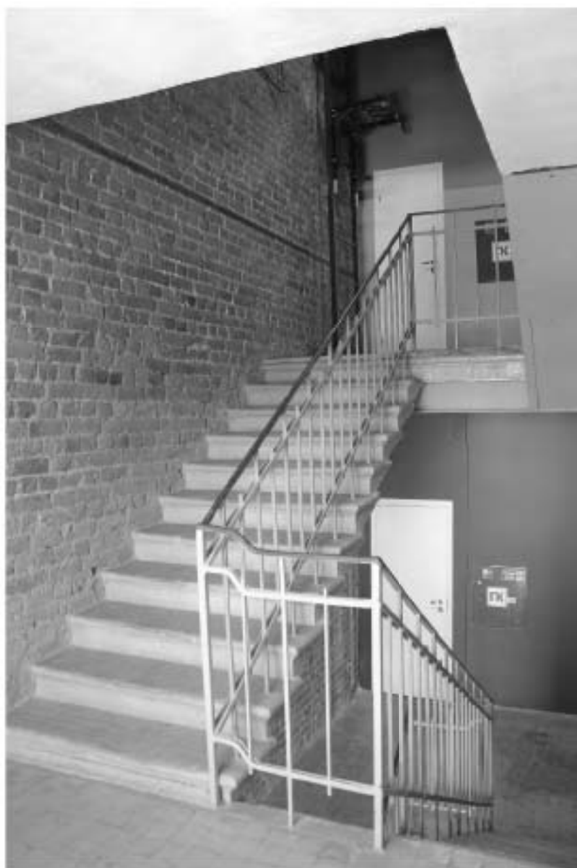
111. «Производственный корпус» (24-я линия В.О., д. 3-7, литера Ж-2 (ЖЗ)), входящий в состав выявленного объекта культурного наследия «Комплекс сооружений электромеханического завода «Сименс-Шуккерт»». Вид с лестничной площадки между 5-м этажом и мансардой. Дата фотофиксации: 10.09.2025.
