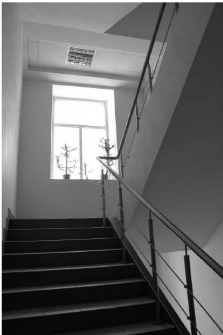
78. «Производственный корпус» (24-я линия В.О., д. 3-7, литера Ж-1 (Ж7)), входящий в состав выявленного объекта культурного наследия «Комплекс сооружений электромеханического завода «Сименс-Шуккерт»». Вид лестничного марша (ЛК-3) между 2-м и 3-м этажами. Дата фотофиксации: 10.09.2025.
