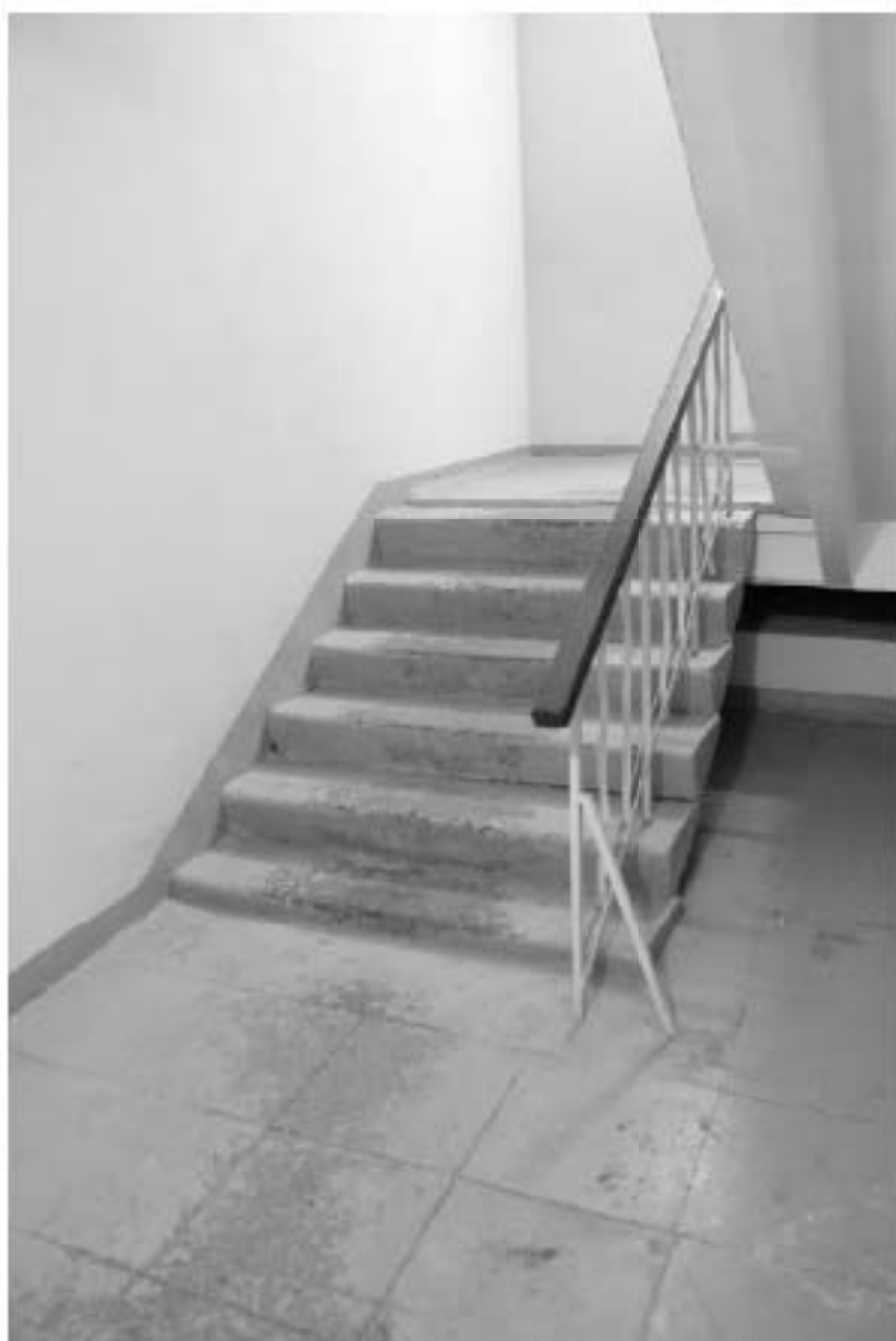
123. «Производственный корпус» (24-я линия В.О., д. 3-7, литера П (Ж5)), входящий в состав выявленного объекта культурного наследия «Комплекс сооружений электромеханического завода «Сименс-Шуккерт»». 1-й этаж, пом. 15-Н(2). Общий вид лестничной клетки. Дата фотофиксации: 10.09.2025.
