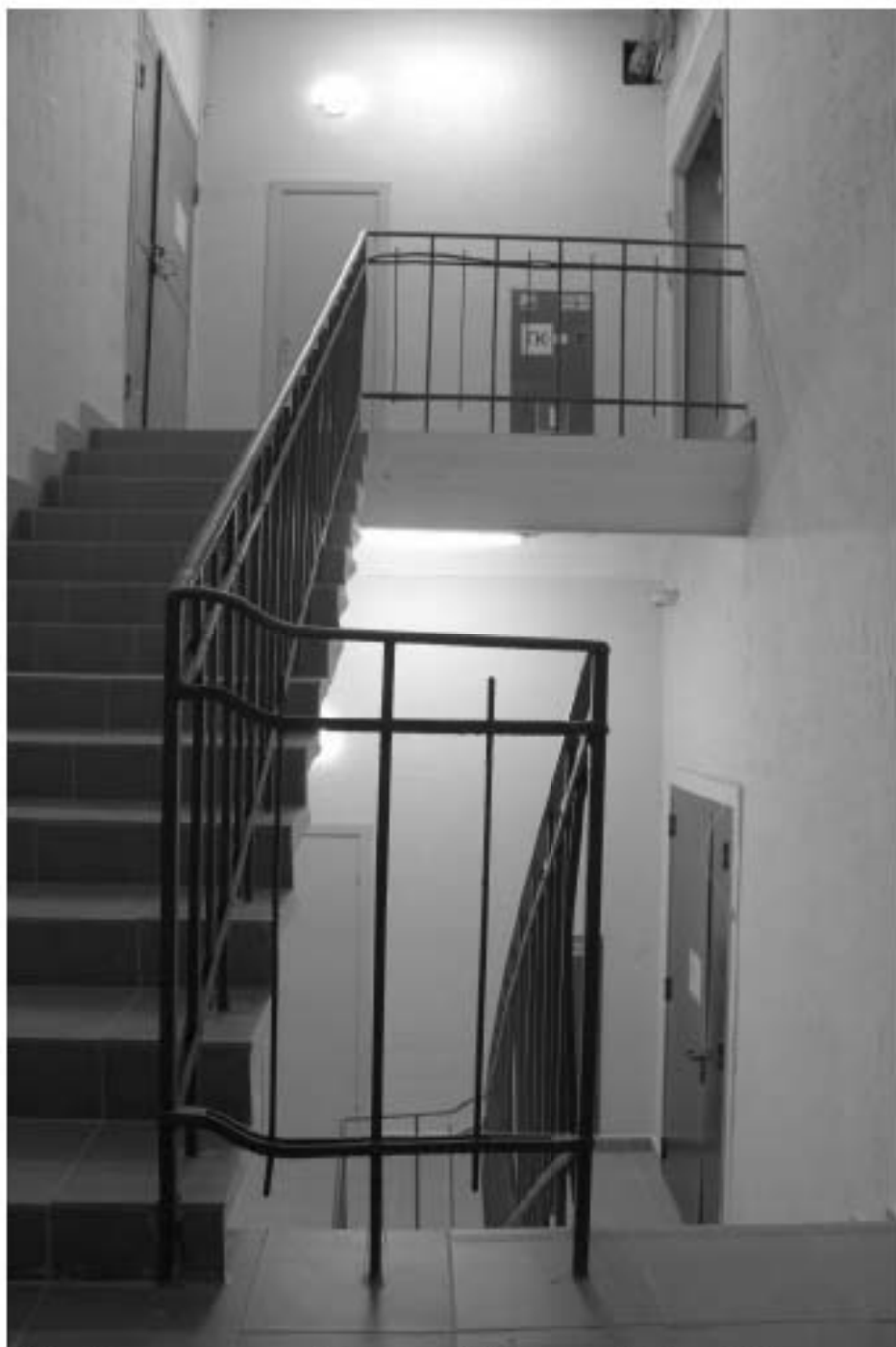
107. «Производственный корпус» (24-я линия В.О., д. 3-7, литера Ж-1 (Ж7)), входящий в состав выявленного объекта культурного наследия «Комплекс сооружений электромеханического завода «Сименс-Шуккерт»». Общий вид лестничной клетки (ЛК-2) с площадки между 4-м и 5-м этажами. Дата фотофиксации: 10.09.2025.
