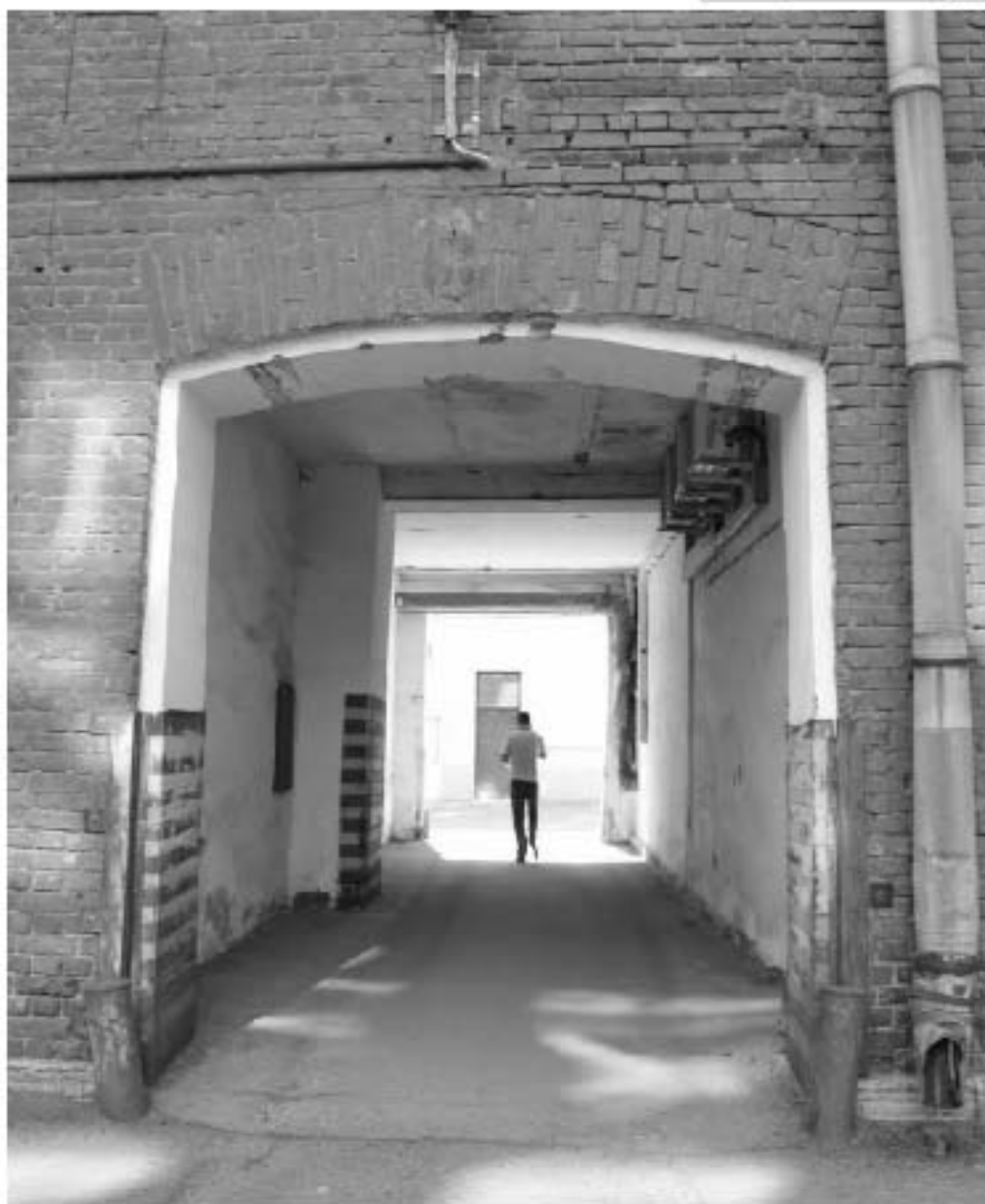
42. «Производственный корпус» (24-я линия В.О., д. 3-7, литера П (Ж5)), входящий в состав выявленного объекта культурного наследия «Комплекс сооружений электромеханического завода «Сименс-Шуккерт»». Фрагмент северо-западного фасада. Дата фотофиксации: 10.09.2025.
