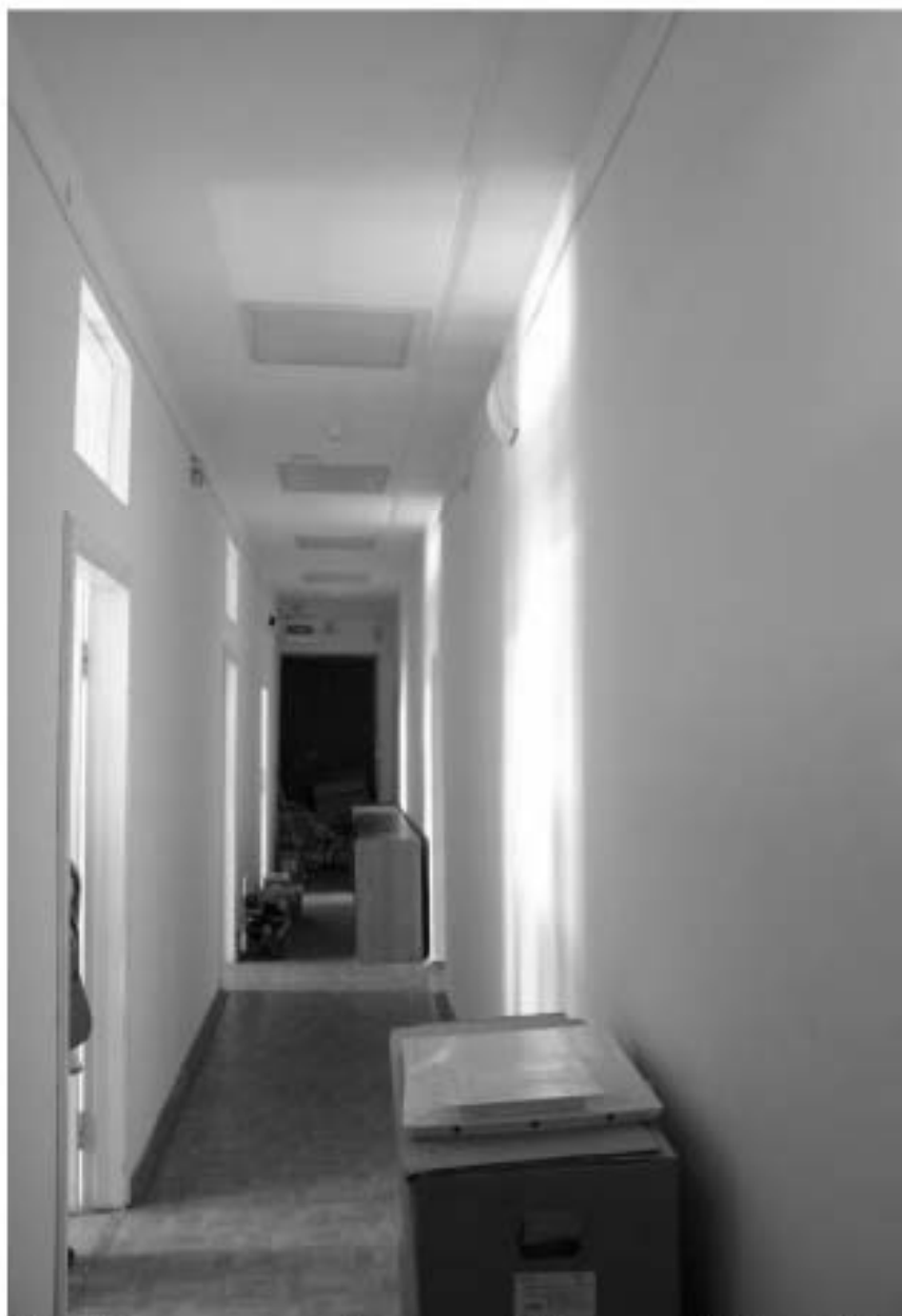
135. «Производственный корпус» (24-я линия В.О., д. 3-7, литера П (Ж5)), входящий в состав выявленного объекта культурного наследия «Комплекс сооружений электромеханического завода «Сименс-Шуккерт»». 4-й этаж, пом. 15-Н(29). Коридор, общий вид. Дата фотофиксации: 10.09.2025.
