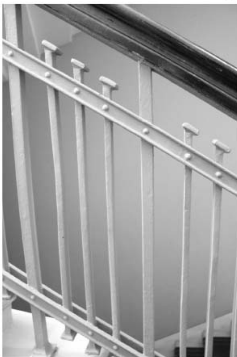
54. «Дом владельца» (24-я линия, д. 3-7, литера С (Ж6)), входящий в состав выявленного объекта культурного наследия «Комплекс сооружений электромеханического завода «Сименс-Шуккерт»». Парадная лестница. Ограждение лестничных маршей. Фрагмент. Дата фотофиксации: 10.09.2025.
