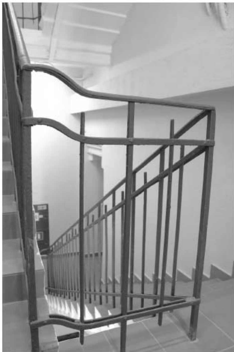
105. «Производственный корпус» (24-я линия В.О., д. 3-7, литера Ж-1 (Ж7)), входящий в состав выявленного объекта культурного наследия «Комплекс сооружений электромеханического завода «Сименс-Шуккерт»». Ограждение лестницы (ЛК-2). Дата фотофиксации: 10.09.2025.
