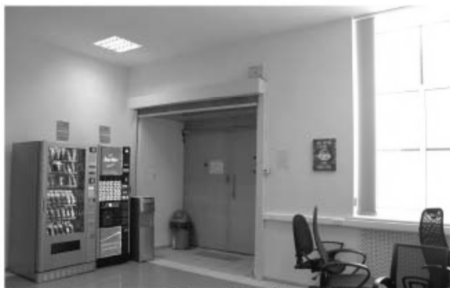
87. «Производственный корпус» (24-я линия В.О., д. 3-7, литера Ж-1 (Ж7)), входящий в состав земельного объекта культурного наследия «Комплекс сооружений электромеханического завода «Сименс-Шуккерт»». 2-й этаж, пом. 24-Н(23). Фрагмент коридора, вид в сторону лифтовой шахты. Дата фотофиксации: 10.09.2025.
