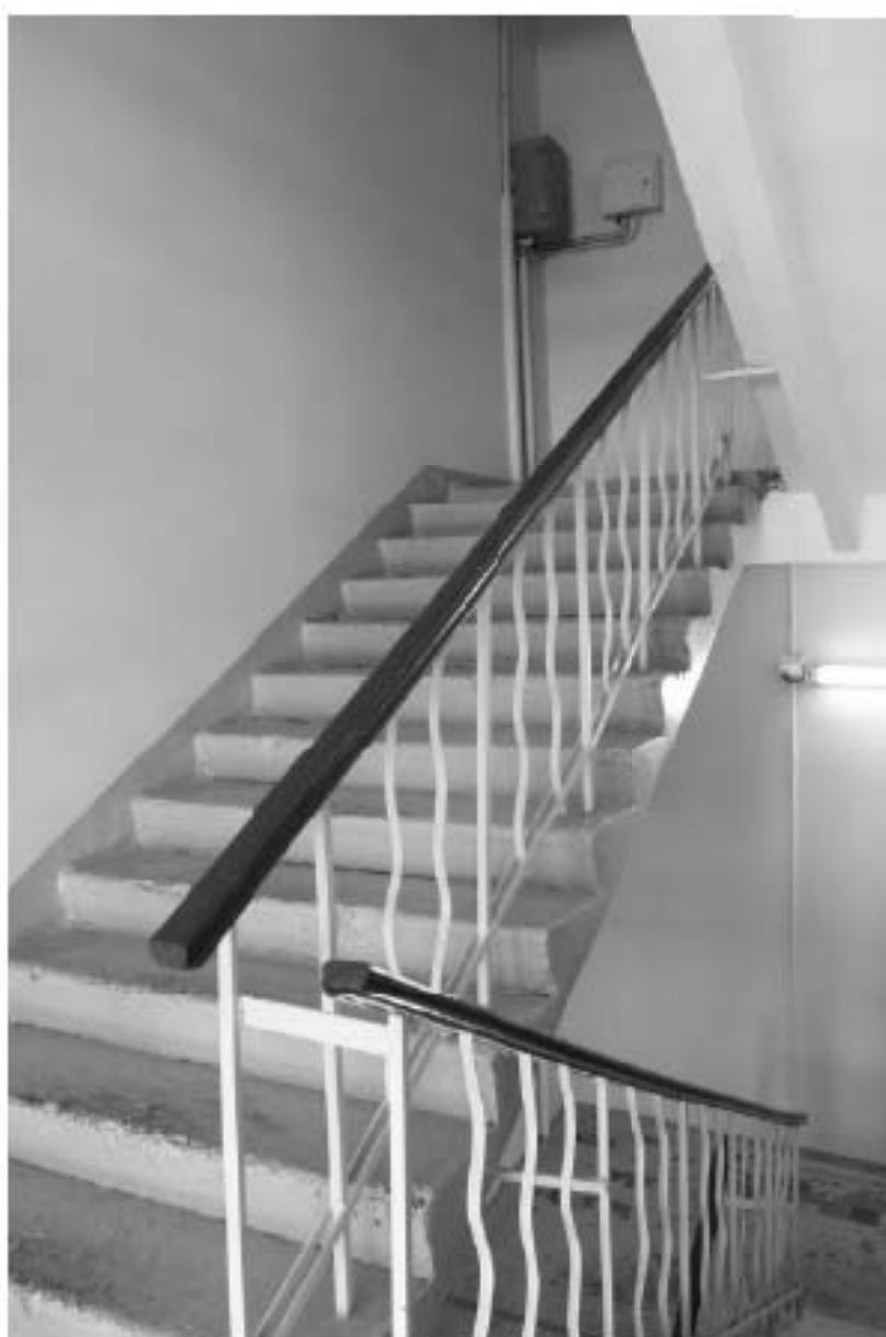
125. «Производственный корпус» (24-я линия В.О., д 3-7, литера П (Ж5)), входящий в состав выявленного объекта культурного наследия «Комплекс сооружений электромеханического завода «Сименс-Шуккерт»». Вид с лестничной площадки между 3-м и 4-м этажами. Дата фотофиксации: 10.09.2025.
