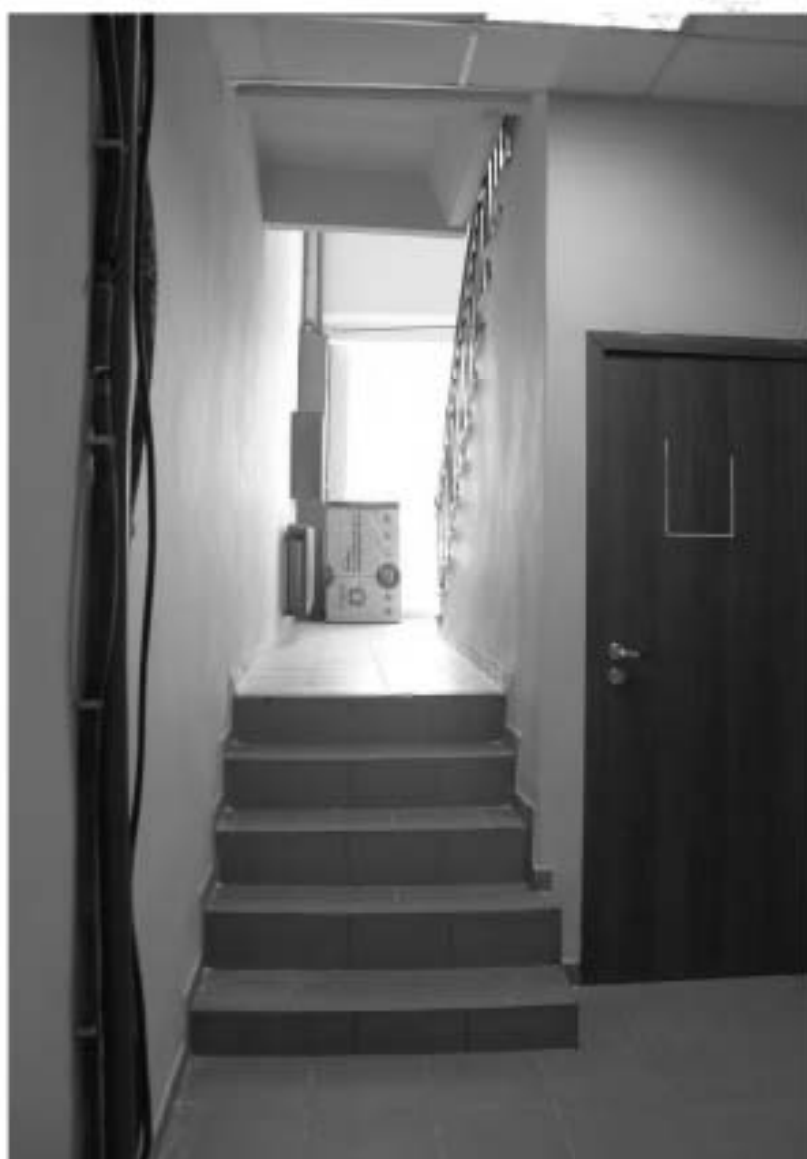
74. «Дом владельца» (24-я линия, д. 3-7, литера С (Ж6)), входящий в состав выявленного объекта культурного наследия «Комплекс сооружений электромеханического завода «Сименс Шуккерт»». 1-й этаж, пом. ЛК-1 (1). Общий вид лестницы. Дата фотофиксации: 10.09.2025.
