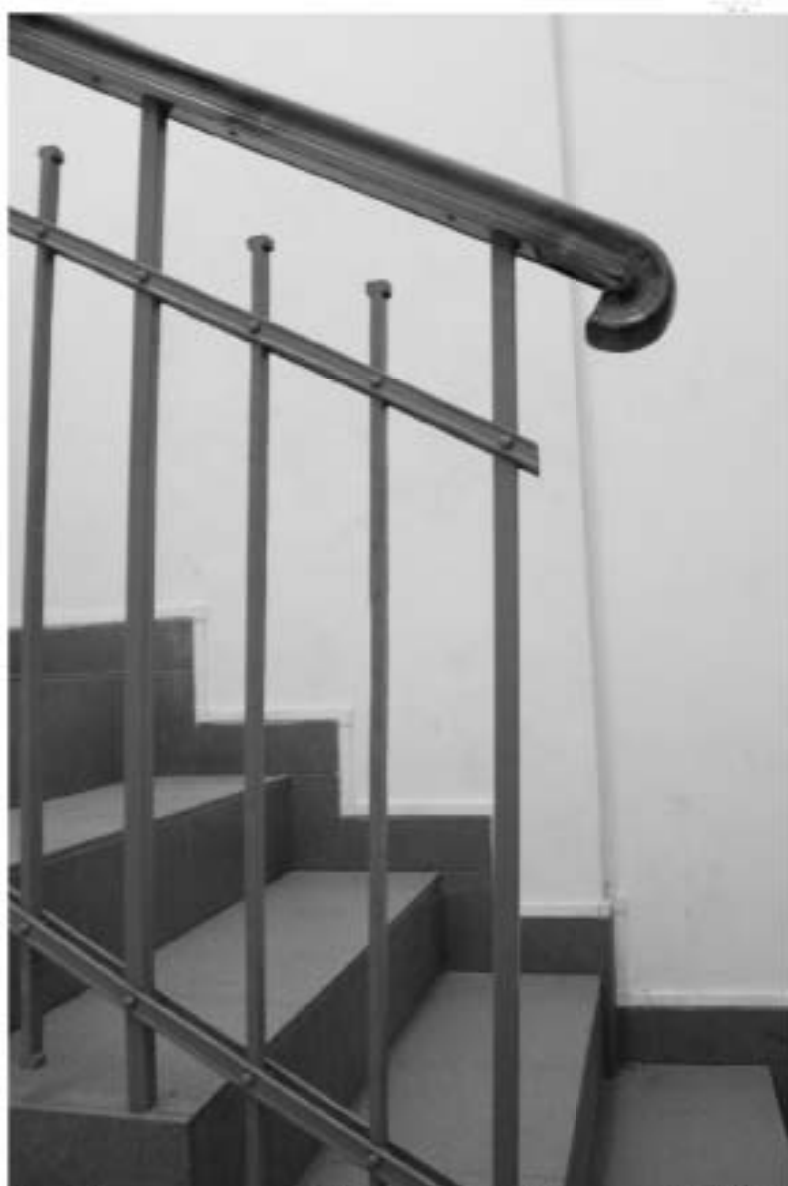
61. «Дом владельца» (24-я линия, д. 3-7, литера С (Ж6)), входящий в состав выявленного объекта культурного наследия «Комплекс сооружений электромеханического завода «Сименс-Шуккерт»». 1-й этаж, пом. ЛК-4 (1). Ограждение лестничного марша. Фрагмент. Дата фотофиксации: 10.09.2025.
