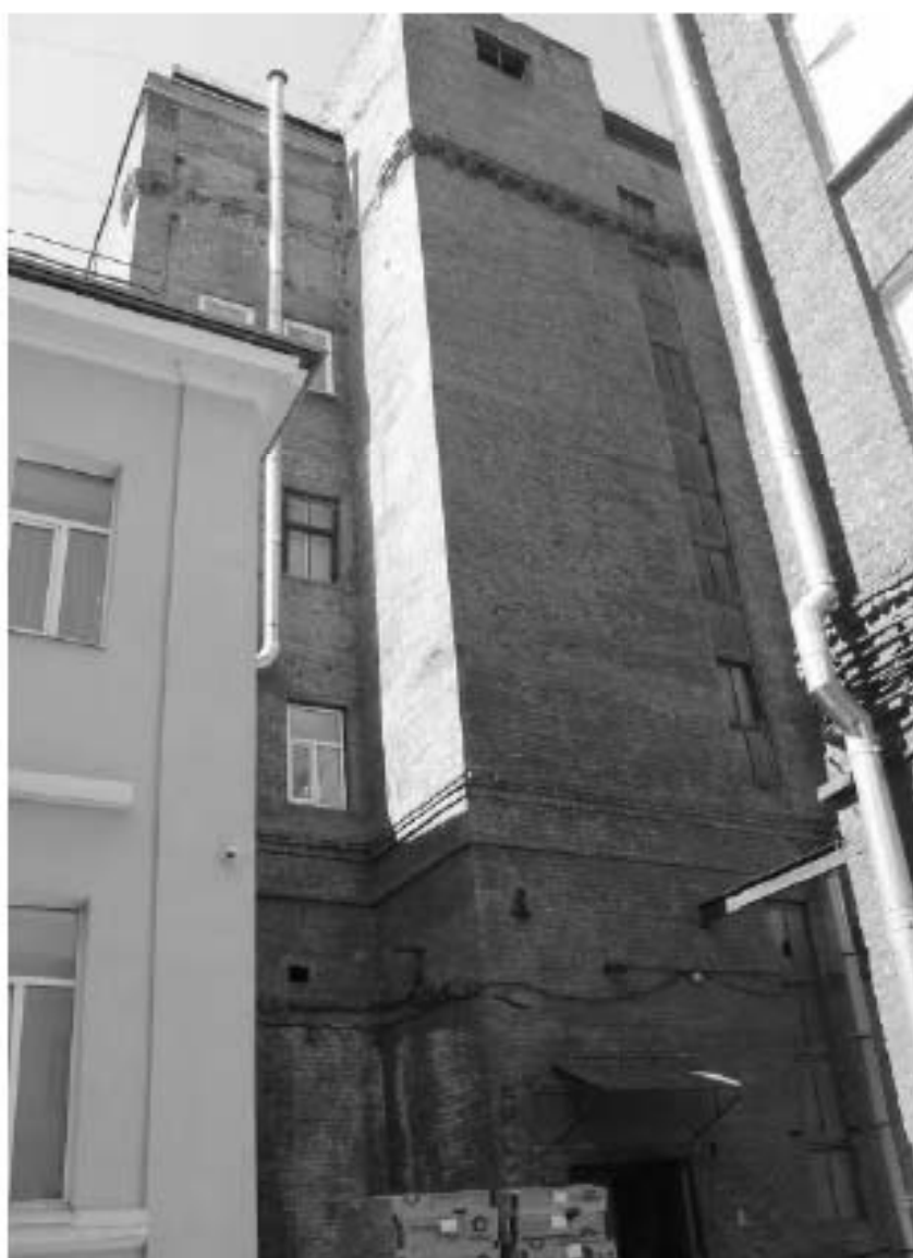
37. Поздняя пристройка (на 5 осей), включенная в объем «Производственного корпуса» (24-я линия В.О., д. 3-7, литера Ж-1 (Ж7)). Вид со стороны внутреннего двора, образованного корпусами, входящими в состав выявленного объекта культурного наследия «Комплекс сооружений электромеханического завода «Сименс-Шуккерт»». Дата фотофиксации: 10.09.2025.
