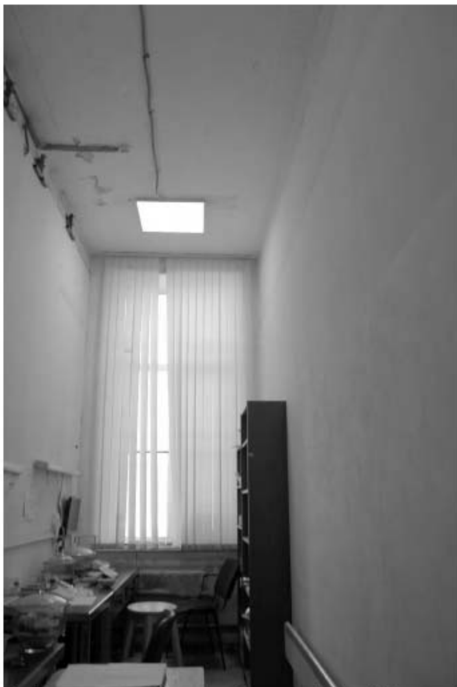
98. «Производственный корпус» (24-я линия В.О., д. 3-7, литера Ж-1 (Ж7)), входящий в состав выявленного объекта культурного наследия «Комплекс сооружений электромеханического завода «Сименс-Шуккерт»». 4-й этаж, пом. 24-Н(104). Общий вид помещения. Дата фотофиксации: 10.09.2025.
