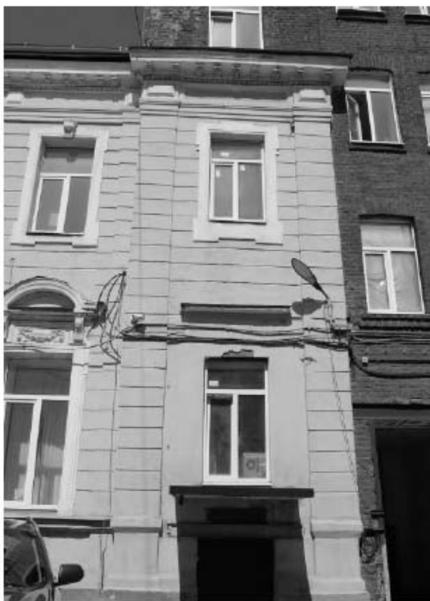
47. «Дом владельца» (24-я линия В.О., д. 3-7, литера С (Ж6)), входящий в состав выявленного объекта культурного наследия «Комплекс сооружений электромеханического завода «Сименс-Шуккерт»». Фрагмент юго-восточного фасада в месте примыкания к «Производственному корпусу» (24-я линия В.О., д. 3-7, литера П (Ж5)). Вид с территории завода «Электроаппарат». Дата фотофиксации: 10.09.2025.
