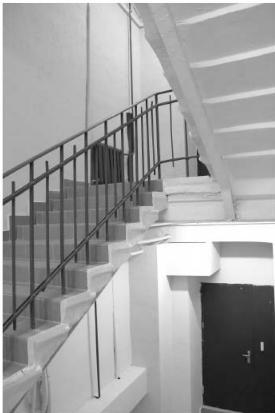
106. «Производственный корпус» (24-я линия В.О., д. 3-7, литера Ж-1 (Ж7)), входящий в состав выявленного объекта культурного наследия «Комплекс сооружений электромеханического завода «Сименс-Шуккерт»». Вид с лестничного марша (ЛК-2) между 3-м и 4-м этажами. Дата фотофиксации: 10.09.2025.
