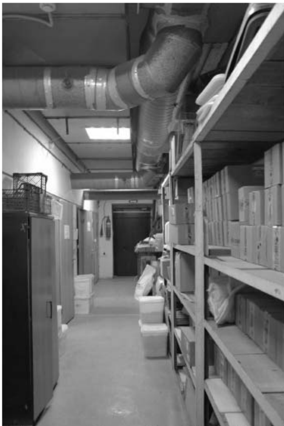
97. «Производственный корпус» (24-я линия В.О., д. 3-7, литера Ж-1 (Ж7)), входящий в состав выявленного объекта культурного наследия «Комплекс сооружений электромеханического завода «Сименс-Шуккерт»». 4-й этаж, пом. 24-Н(76). Коридор, общий вид помещения. Дата фотофиксации: 10.09.2025.
