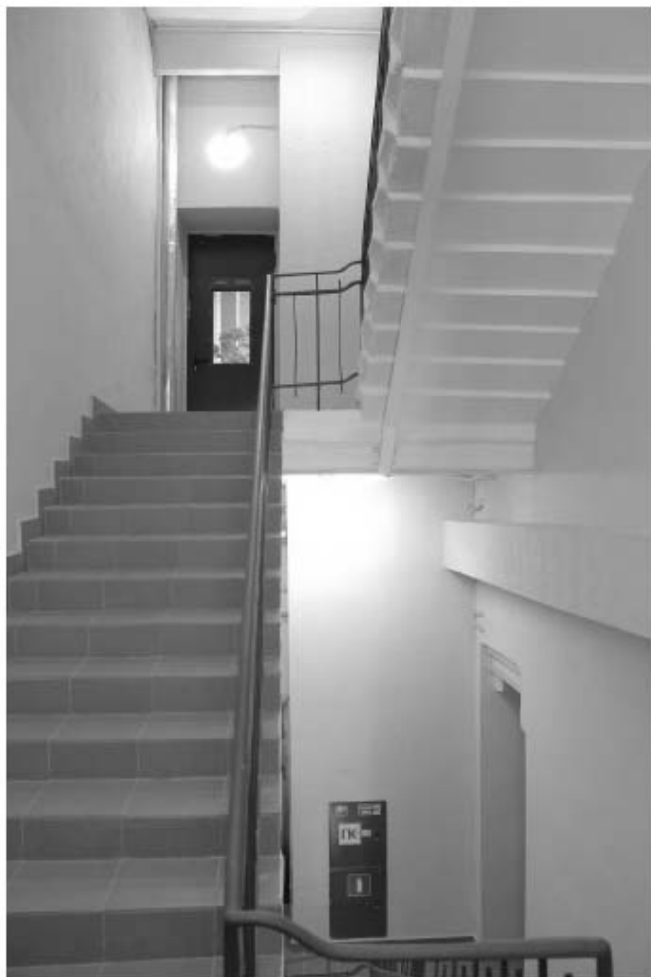
104. «Производственный корпус» (24-я линия В.О., д. 3-7, литера Ж-1 (Ж7)), входящий в состав выявленного объекта культурного наследия «Комплекс сооружений электромеханического завода «Сименс-Шуккерт»». Общий вид лестничной клетки (ЛК-2) с площадки между 2-м и 3-м этажами. Дата фотофиксации: 10.09.2025.
