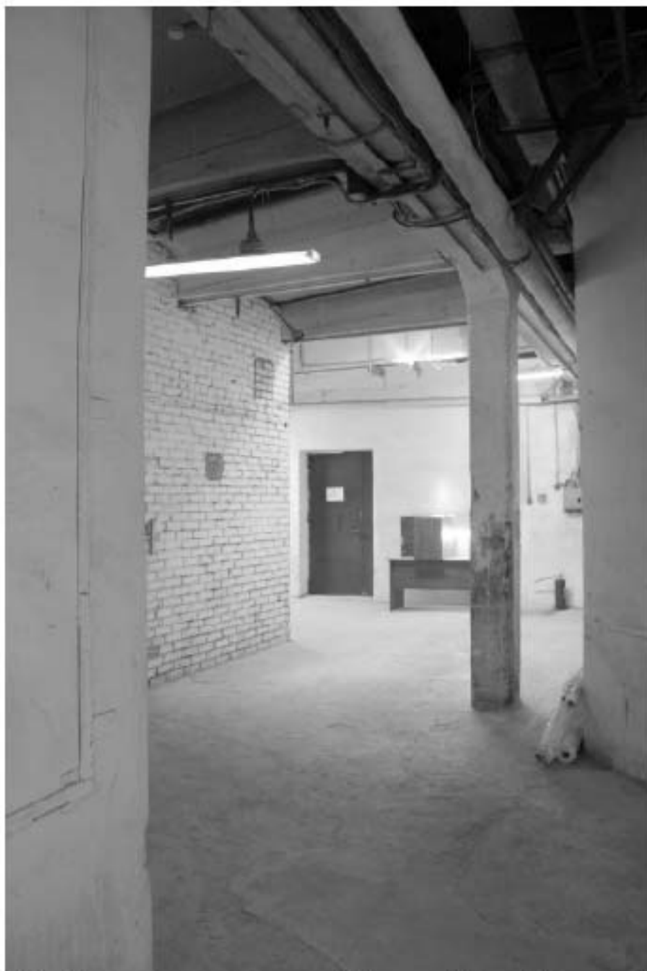
100. «Производственный корпус» (24-я линия В.О., д. 3-7, литера Ж-1 (Ж7)), входящий в состав выявленного объекта культурного наследия «Комплекс сооружений электромеханического завода «Сименс-Шуккерт»». 5-й этаж, пом. 24-Н(118). Общий вид помещения. Дата фотофиксации: 10.09.2025.
