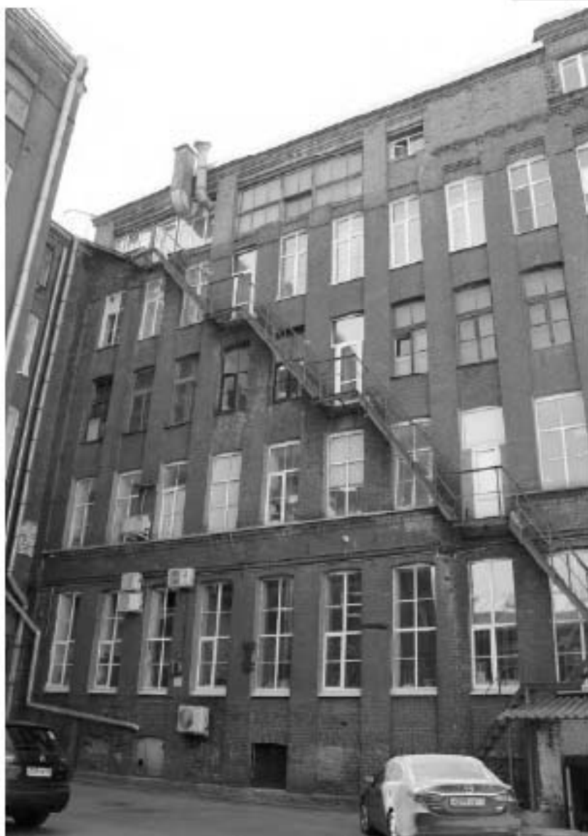
30. «Производственный корпус» (24-я линия В.О., д. 3-7, литера Ж-1 (Ж7)), входящий в состав выявленного объекта культурного наследия «Комплекс сооружений электромеханического завода «Сименс-Шуккерт»». Фрагмент дворового (северо-восточного) фасада. Поздняя надстройка корпуса. Вид в юго-западном направлении. Дата фотофиксации: 10.09.2025.
