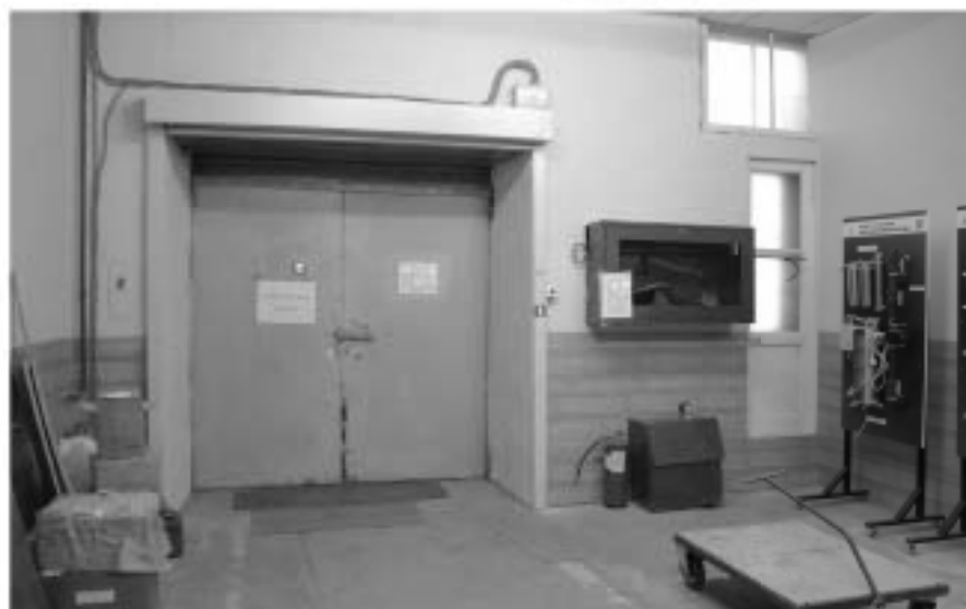
90. «Производственный корпус» (24-я линия В.О., д. 3-7, литера Ж-1 (Ж7)), входящий в состав земельного объекта культурного наследия «Комплекс сооружений электромеханического завода «Сименс-Шуккерт»». 3-й этаж, пом. 24-Н(53). Коридор, вид в сторону лифтовой шахты. Дата фотофиксации: 10.09.2025.
