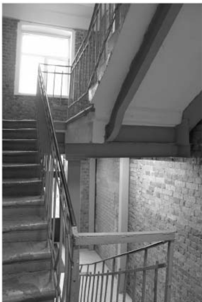
109. «Производственный корпус» (24-я линия В.О., д. 3-7, литера Ж-2 (ЖЗ)), входящий в состав выявленного объекта культурного наследия «Комплекс сооружений электромеханического завода «Сименс-Шуккерт»». Вид с лестничной площадки между 1-м и 2-м этажами. Дата фотофиксации: 10.09.2025.
