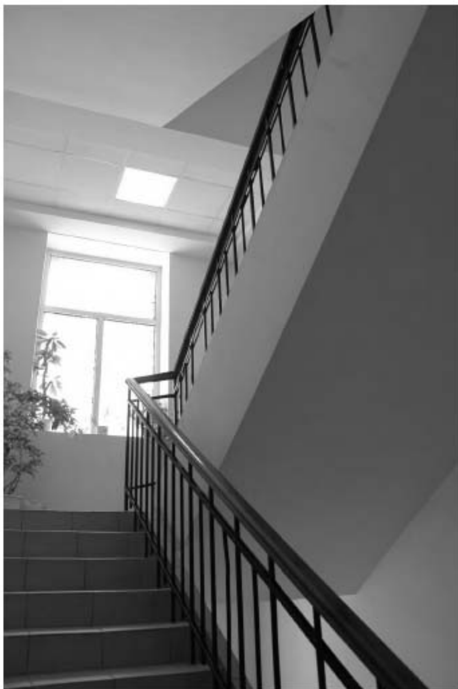
79. «Производственный корпус» (24-я линия В.О., д. 3-7, литера Ж-1 (Ж7)), входящий в состав выявленного объекта культурного наследия «Комплекс сооружений электромеханического завода «Сименс-Шуккерт»». Вид лестничного марша (ЛК-3) между 3-м и 4-м этажами. Дата фотофиксации: 10.09.2025.
