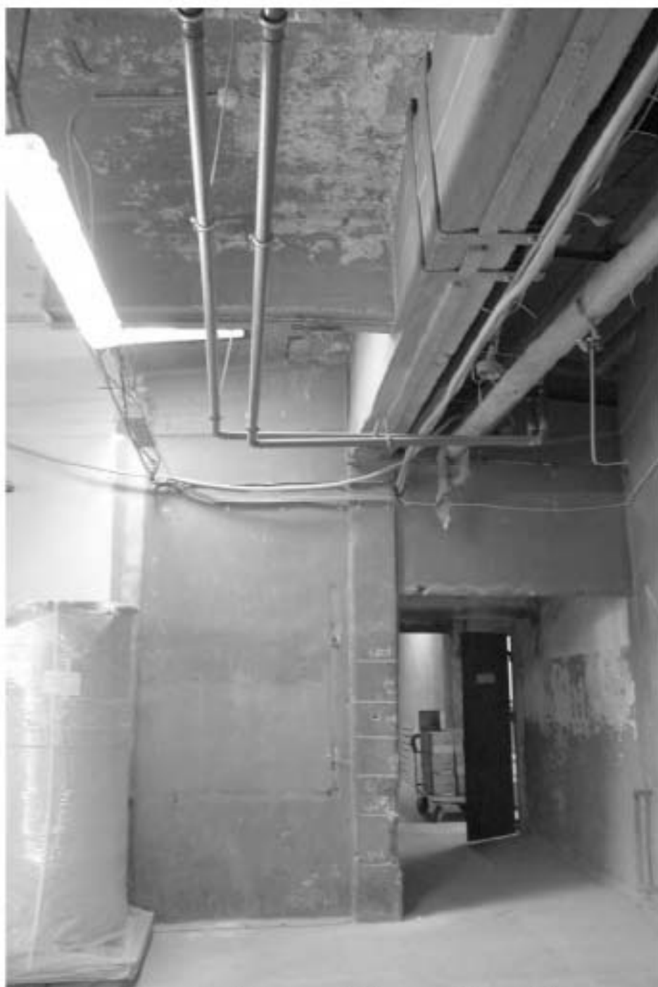
103. «Производственный корпус» (24-я линия В.О., д. 3-7, литера Ж-1 (Ж7)), входящий в состав выявленного объекта культурного наследия «Комплекс сооружений электромеханического завода «Сименс-Шуккерт»». 5-й этаж, пом. 24-Н(110). Общий вид помещения. Дата фотофиксации: 10.09.2025.
