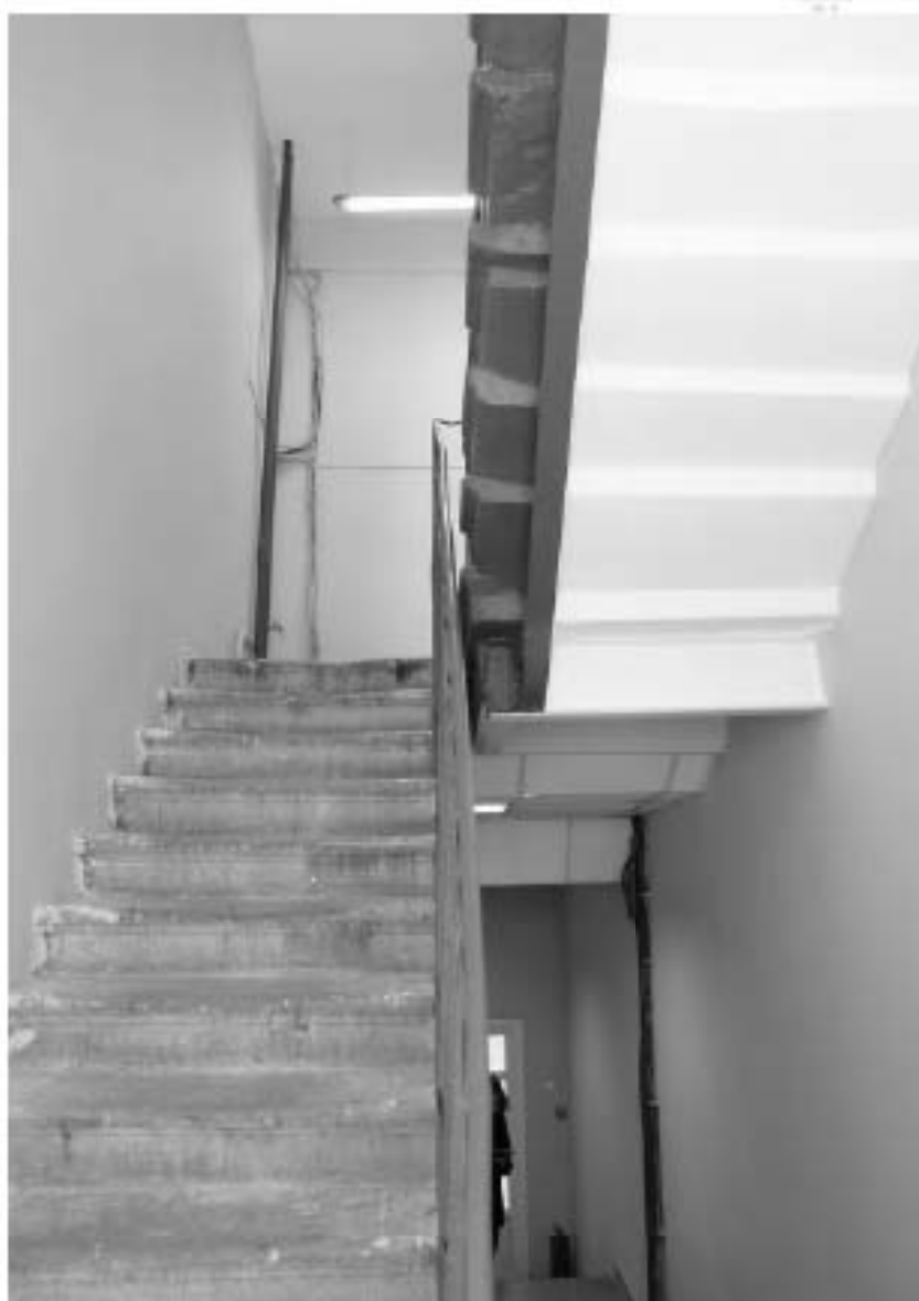
75. «Дом владельца» (24-я линия, д. 3-7, литера С (Ж6)), входящий в состав выявленного объекта культурного наследия «Комплекс сооружений электромеханического завода «Сименс-Шуккерт»». Общий вид лестницы между 1-м и 2-м этажами. Дата фотофиксации: 10.09.2025.
