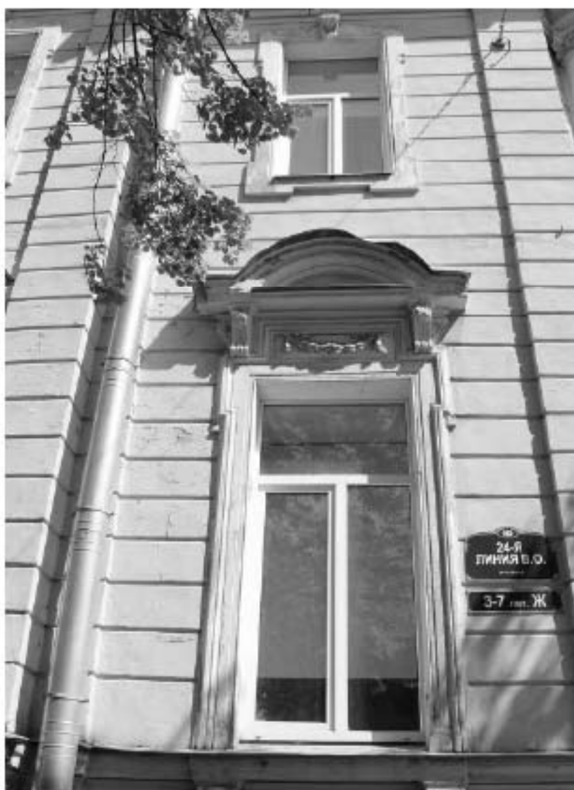
6. «Дом владельца» (24-я линия В.О., д. 3-7, литера С (Ж6)), входящий в состав выявленного объекта культурного наследия «Комплекс сооружений электромеханического завода «Сименс-Шуккерт»». Лицевой (юго-западный) фасад. Декоративное оформление оконных проемов. Дата фотофиксации: 10.09.2025.
