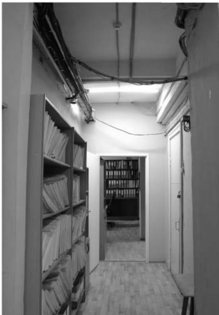
83. «Производственный корпус» (24-я линия В.О., д. 3-7, литера Ж-1 (Ж7)), входящий в состав выявленного объекта культурного наследия «Комплекс сооружений электромеханического завода «Сименс-Шуккерт»». Антресоль 1-ого этажа, пом. 23-Н(1). Коридор, общий вид. Дата фотофиксации: 10.09.2025.
