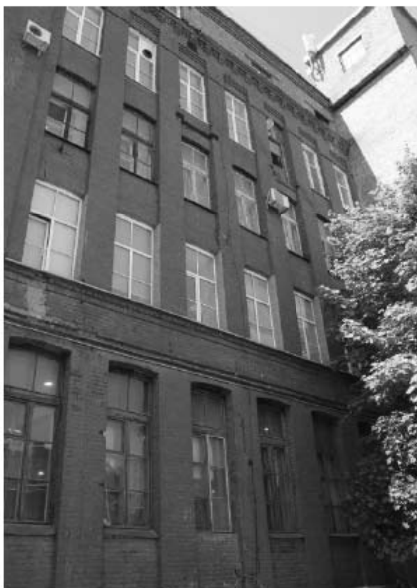
29. «Производственный корпус» (24-я линия В.О., д. 3-7, литера Ж-1 (Ж7)), входящий в состав выявленного объекта культурного наследия «Комплекс сооружений электромеханического завода «Сименс-Шуккерт»». Фрагмент дворового (северо-восточного) фасада корпуса. Оформление оконных проемов вытянутыми по вертикали нишами (со ступенчатым завершением в уровне 4-го этажа). Вид в западном направлении. Дата фотофиксации: 10.09.2025.
