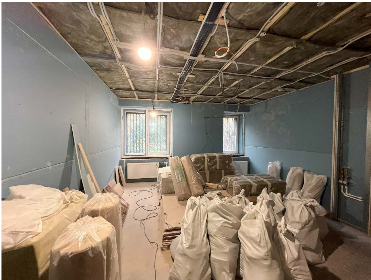
Фото №23. Помещение 7-Н (11).
