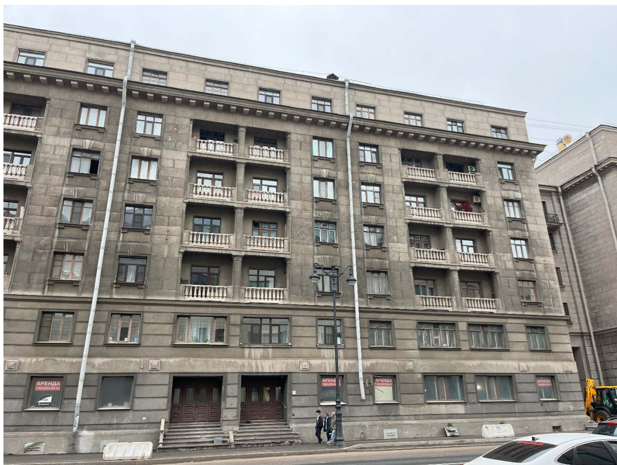
Фото №3. Фрагмент лицевого фасада по улице Декабристов.
