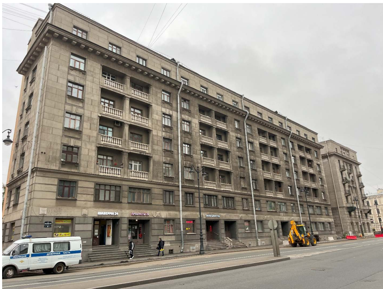
Фото №1. Лицевой фасад по улице Декабристов.
