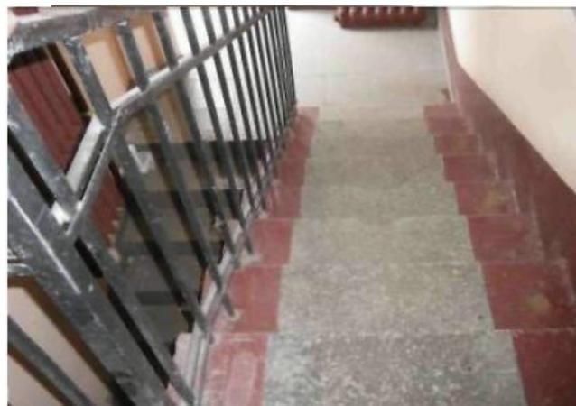
лестницы выходов во двор с бетонными ступенями с наливным покрытием (частично утрачено), в том числе с металлическим ограждением простого рисунка, их местоположение, конструкции (по косоурам), ограждение (материал – металл, рисунок ограждения).
