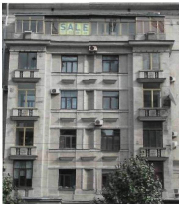
балконы с бетонным ограждением с балясинами, тумбами и лепными композициями в центральных тумбах, филенки в нижней части балконных плит;
