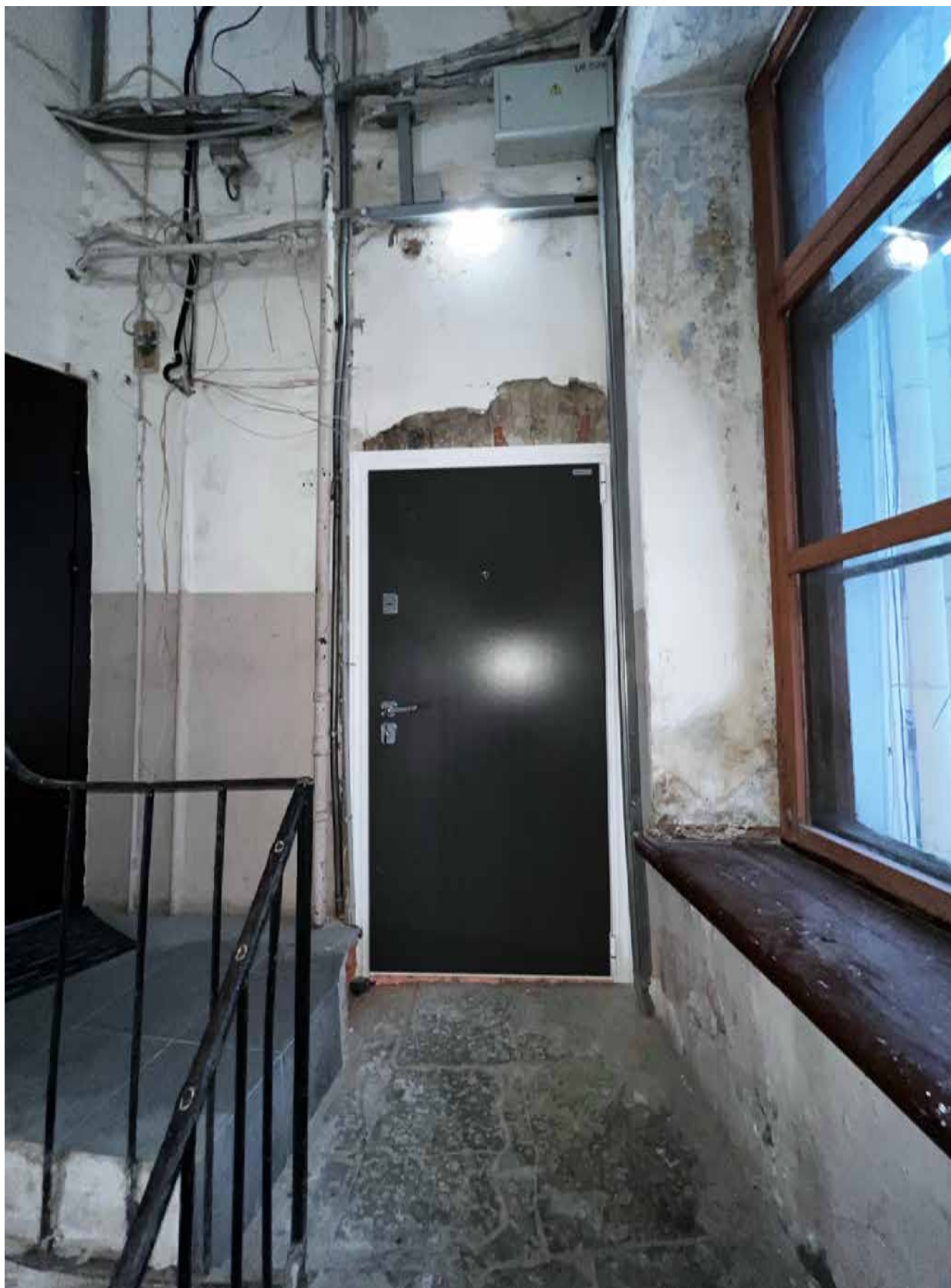
4. Входная дверь в квартиру № 11 со стороны 2ЛК.
