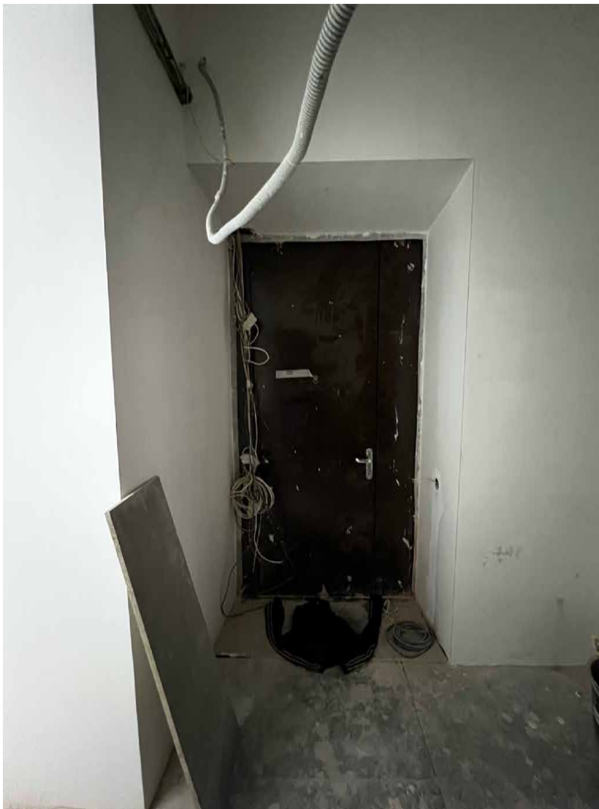
5. Входная дверь в квартиру № 11 со стороны 1ЛК изнутри.
