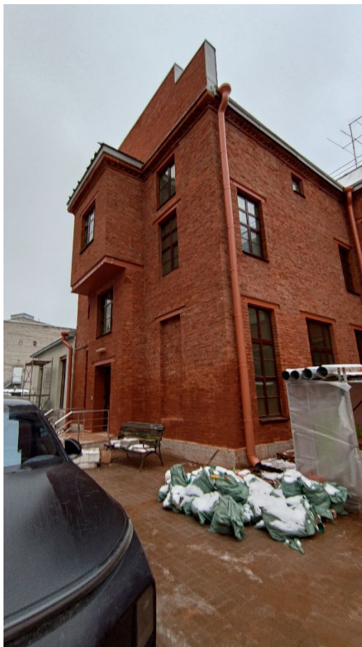
Фото 7. Северный фасад. Фрагмент. Дата фотофиксации: 20.11.25.
