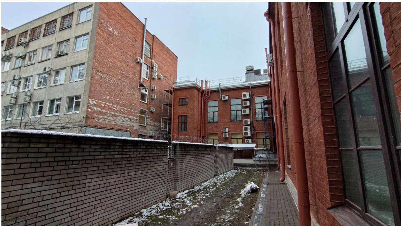
Фото 17. Юго-восточный фасад. Фрагмент. Дата фотофиксации: 20.11.25.
