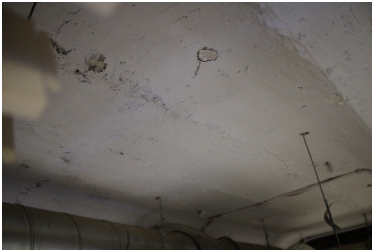
Фото 26. Пространство помещений 7 и 8 (1-Н). Своды. Фрагмент. Дата фотофиксации: 20.11.25.
