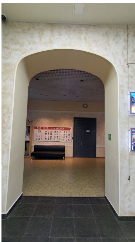
Фото 51. Портал с лучковым завершением. Уровень 2-го этажа (4-Н). Общий вид. Дата фотофиксации: 20.11.25.
