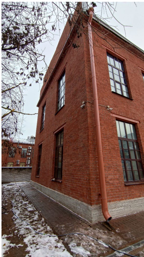
Фото 11. Юго-восточный фасад. Фрагмент. Дата фотофиксации: 20.11.25.
