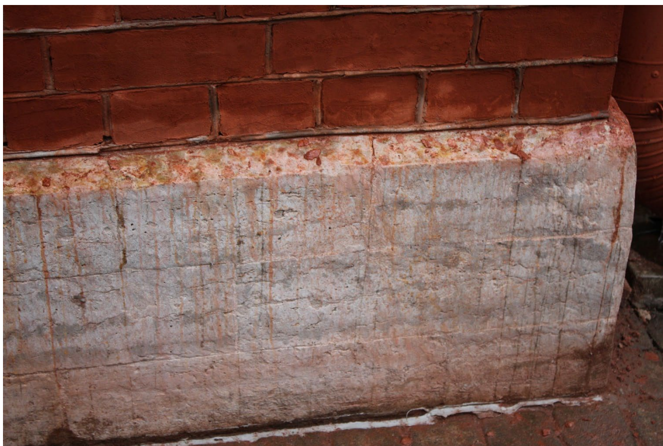
Фото 8. Отделка цоколя – путиловская плита. Фрагмент. Дата фотофиксации: 20.11.25.
