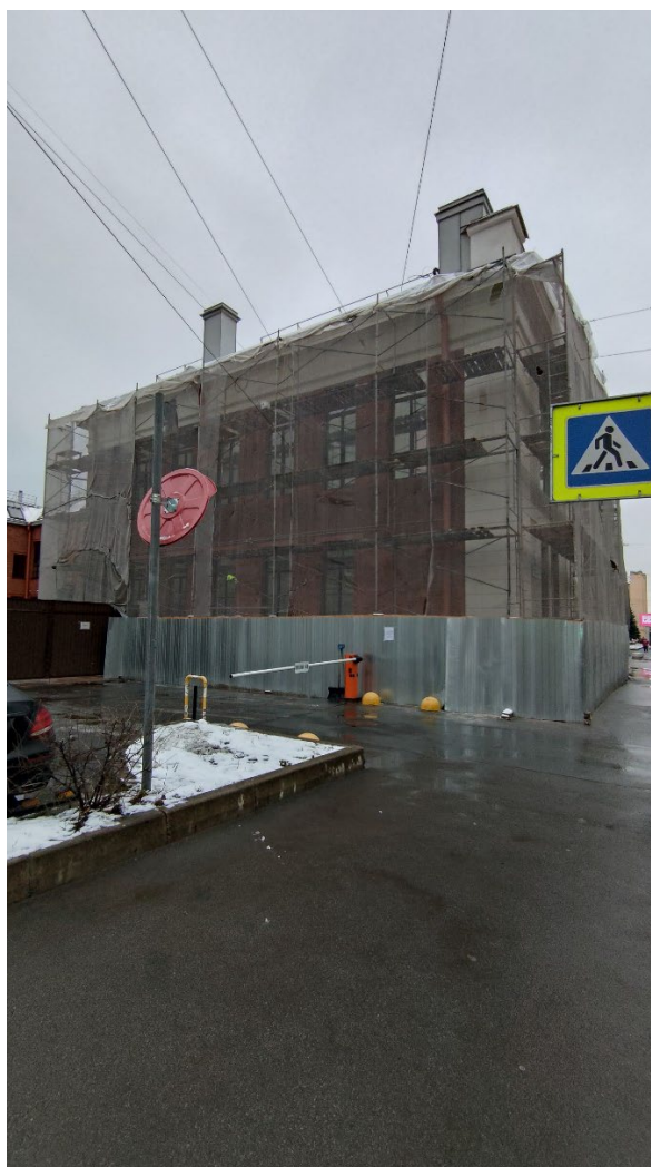
Фото 2. Северный фасад. Фрагмент. Дата фотофиксации: 20.11.25.
