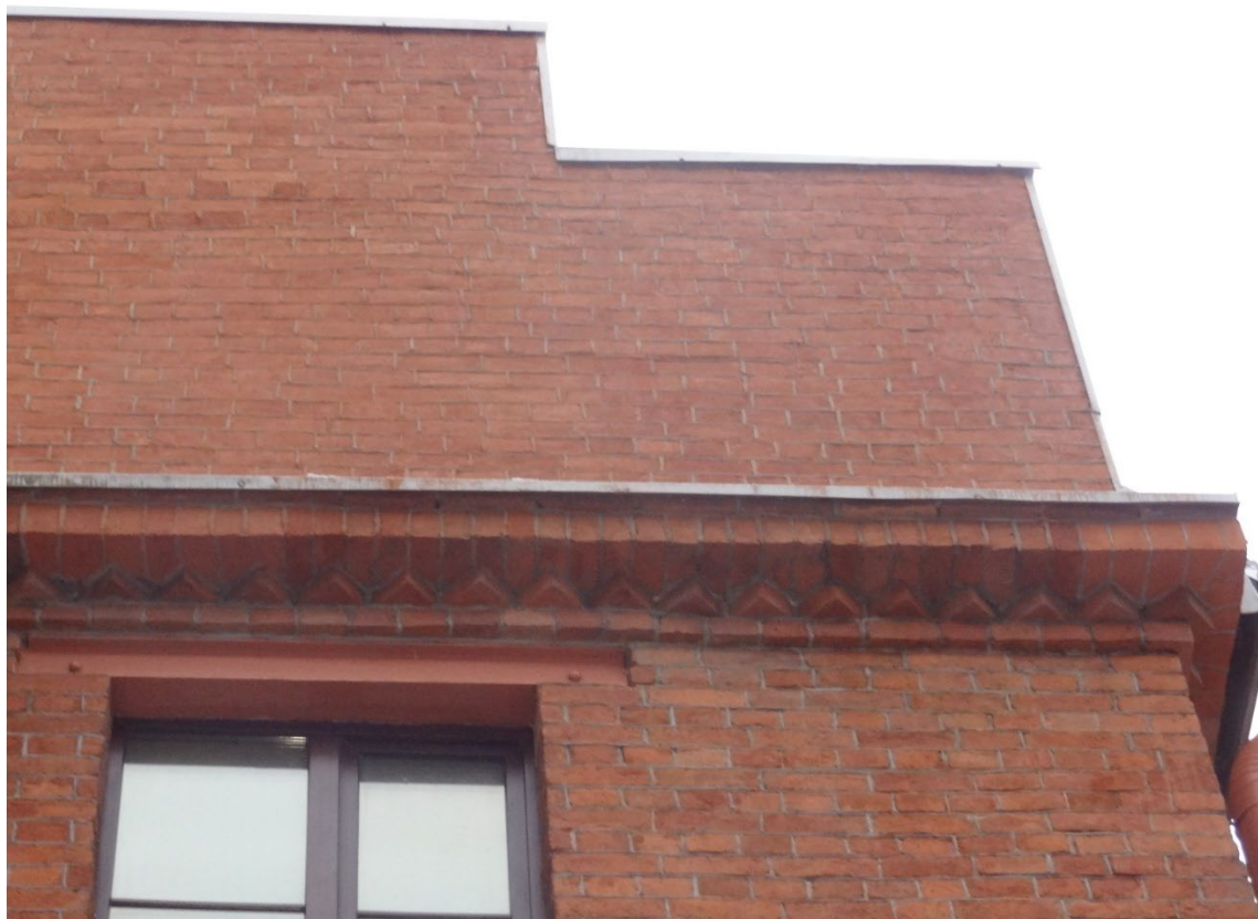
Фото 12. Венчающий карниз, декорированный «сухариками». Фрагмент. Дата фотофиксации: 20.11.25.
