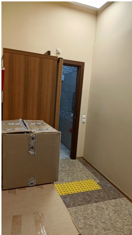
Фото 36. Пространство помещений 2-8 (3-Н). Фрагмент. Дата фотофиксации: 20.11.25.
