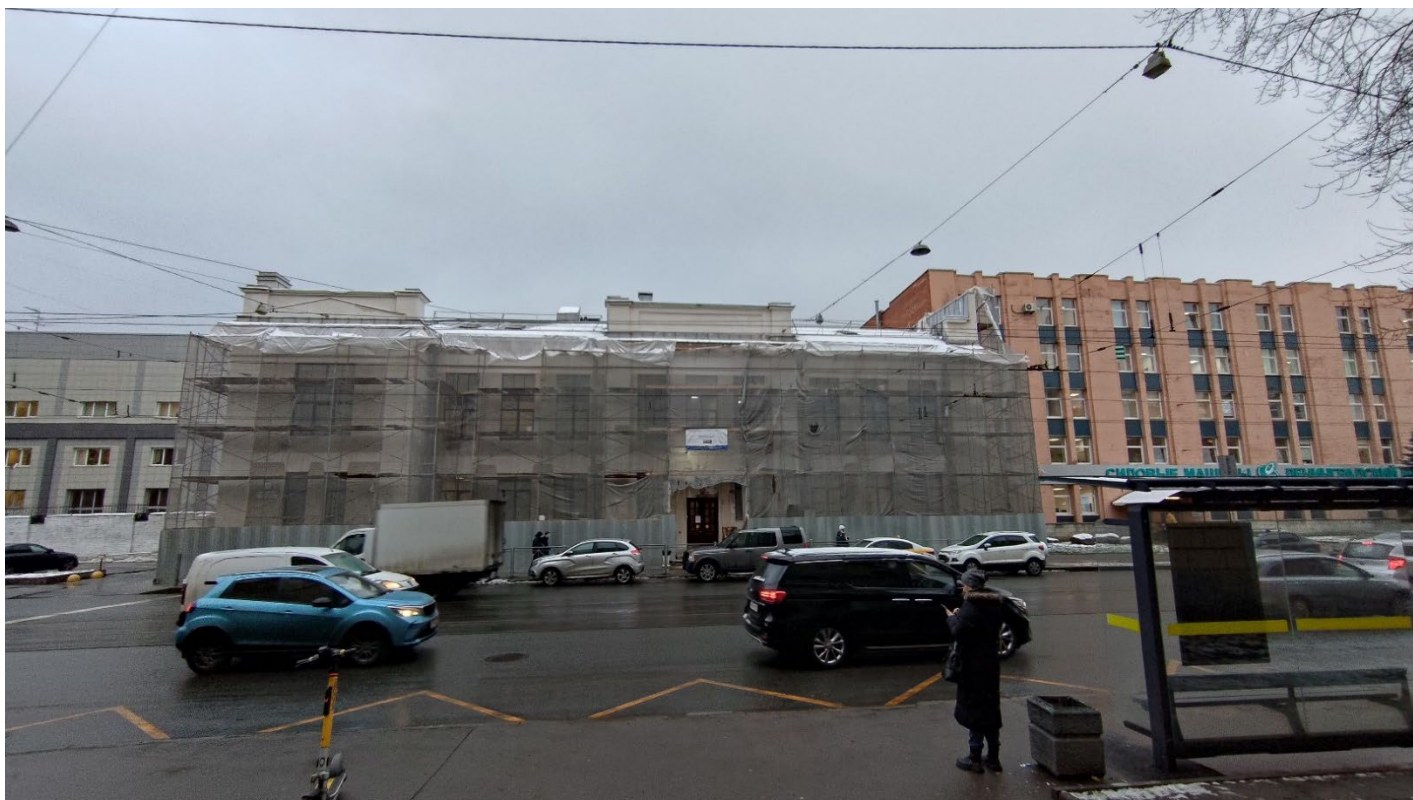
Фото 1. Лицевой (западный) фасад. Общий вид. Дата фотофиксации: 20.11.25.
