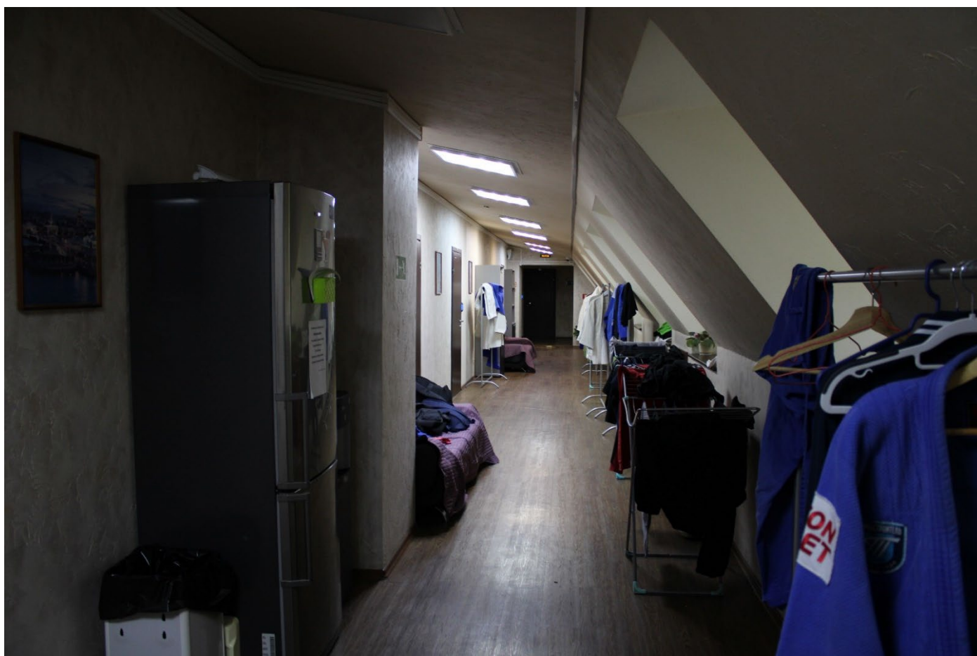
Фото 61. Объем помещений мансарды. Фрагмент. Дата фотофиксации: 20.11.25.
