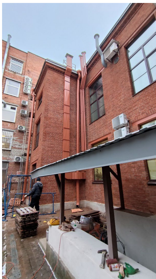
Фото 18. Юго-восточный фасад. Фрагмент. Дата фотофиксации: 20.11.25.
