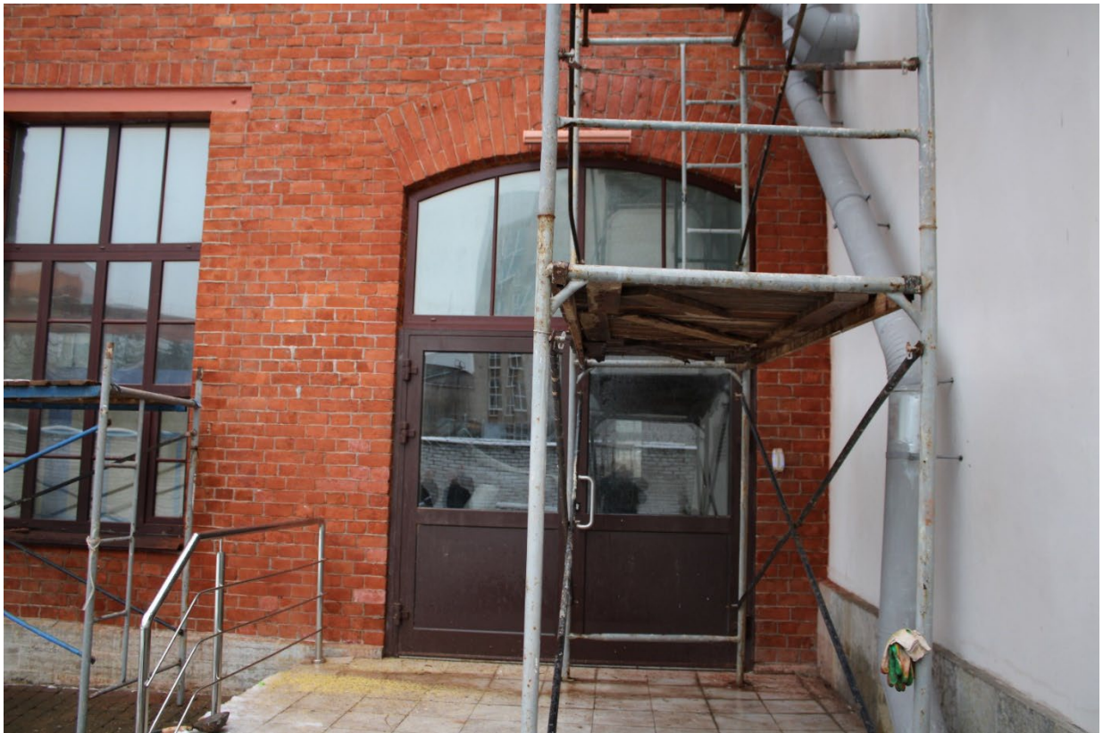
Фото 13. Дверной проём юго-восточного фасада. Общий вид. Дата фотофиксации: 20.11.25.
