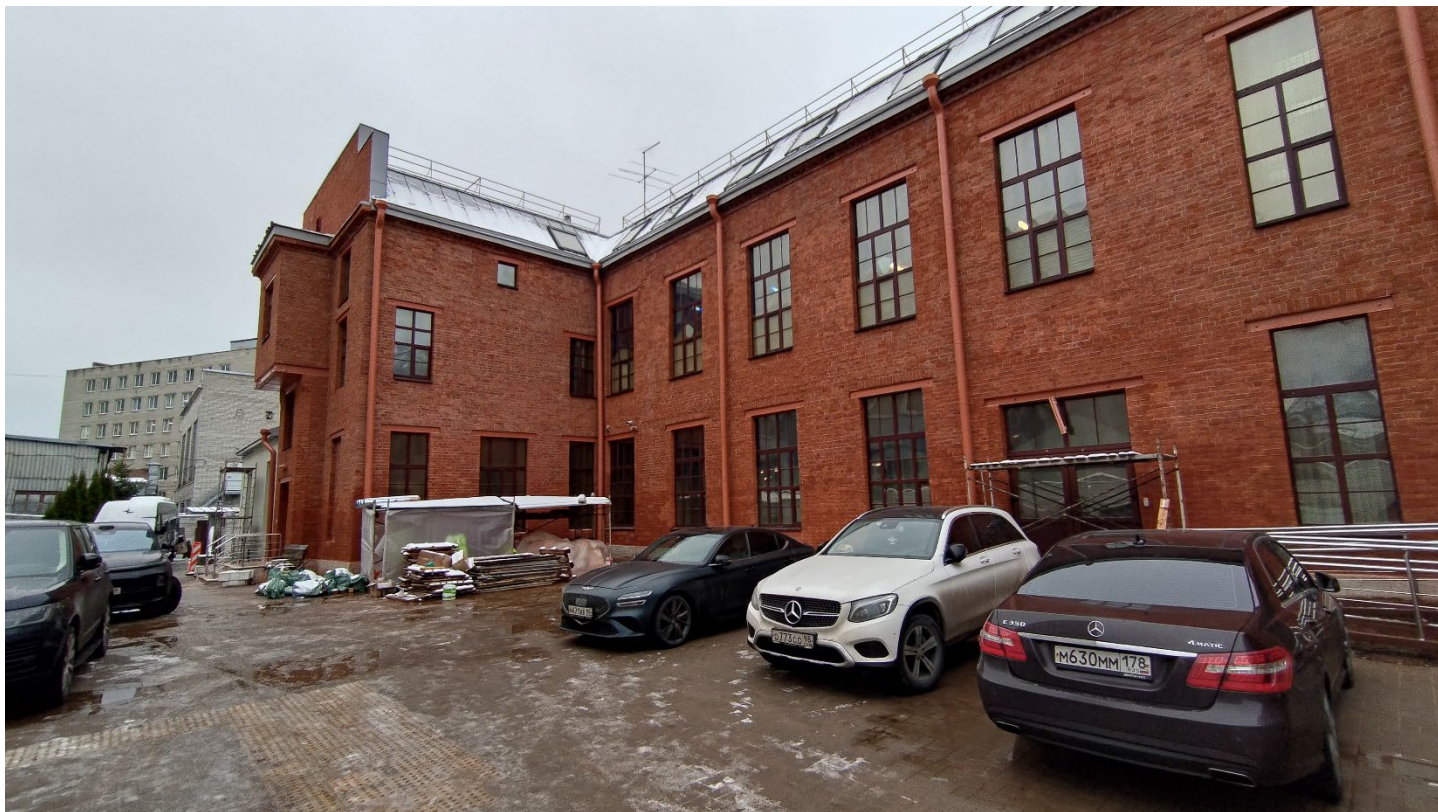
Фото 5. Северный фасад. Фрагмент. Дата фотофиксации: 20.11.25.
