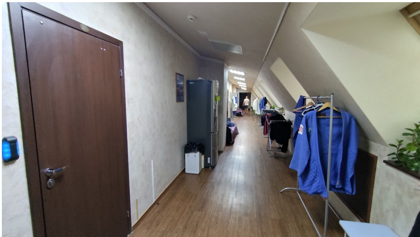
Фото 60. Объем помещений мансарды. Фрагмент. Дата фотофиксации: 20.11.25.
