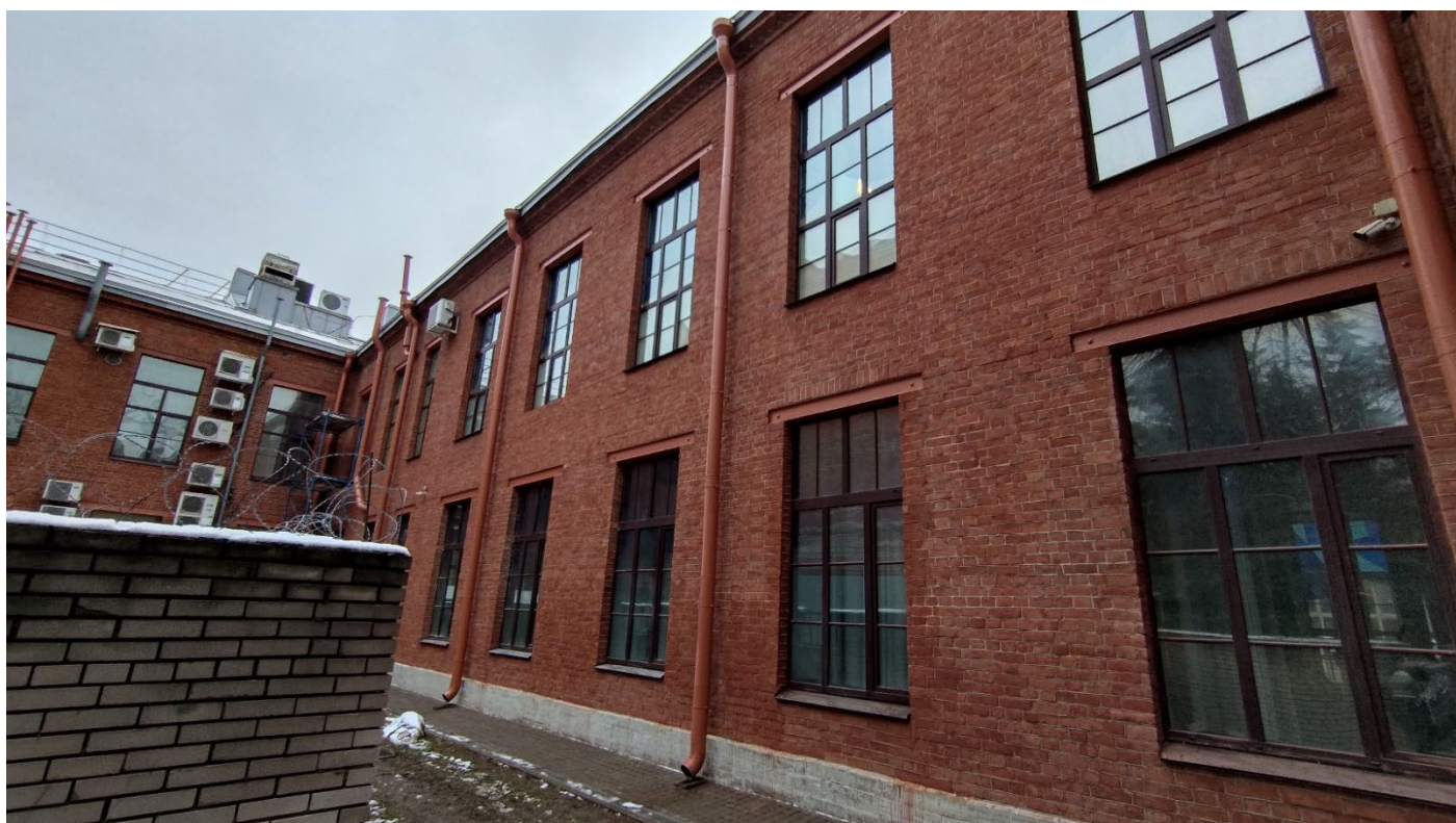
Фото 16. Южный фасад. Фрагмент. Дата фотофиксации: 20.11.25.
