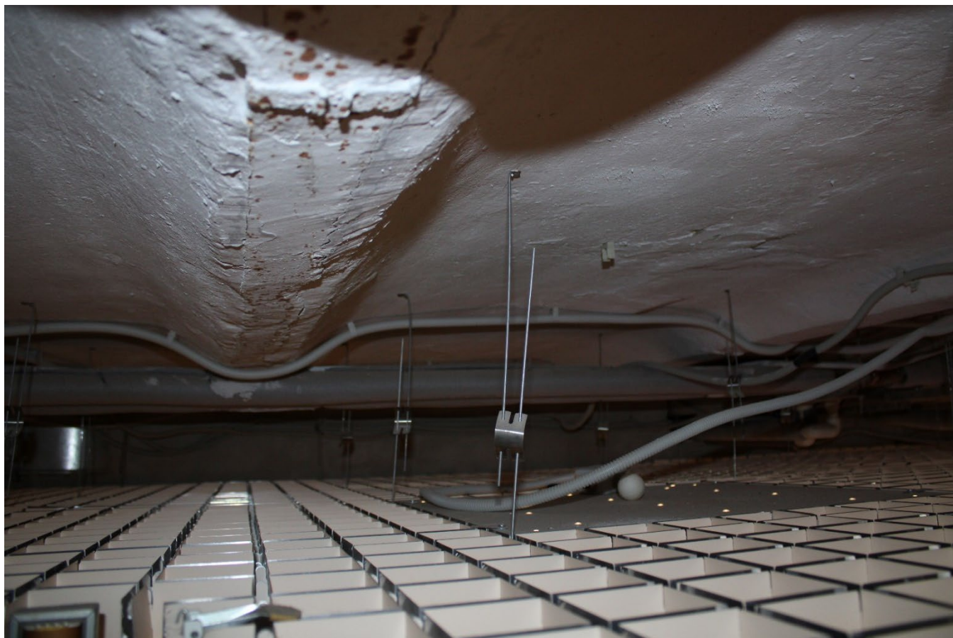
Фото 20. Пространство помещений 27, 21, 16 (1-Н). Своды. Фрагмент. Дата фотофиксации: 20.11.25.
