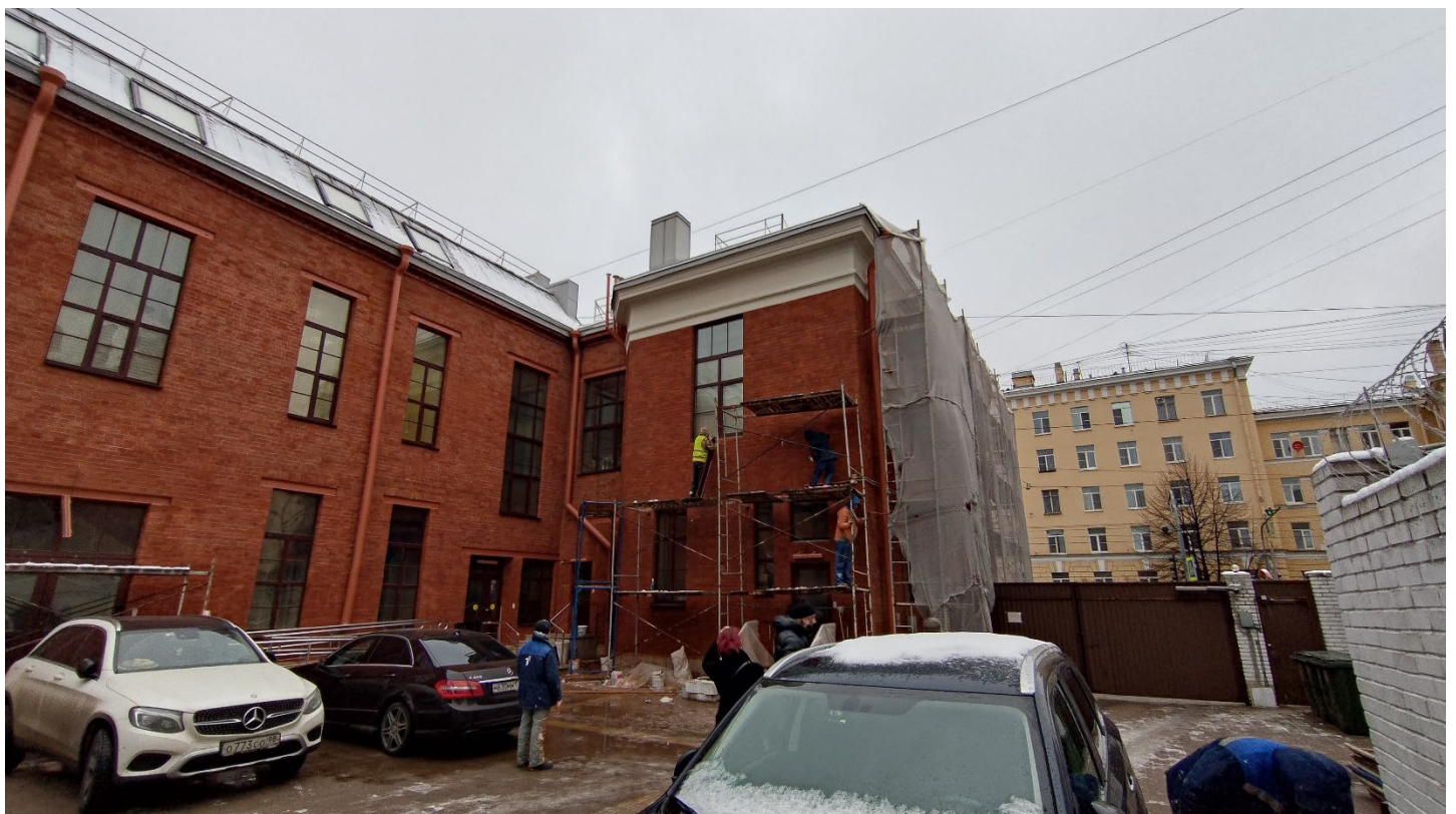
Фото 4. Северный фасад. Фрагмент. Дата фотофиксации: 20.11.25.
