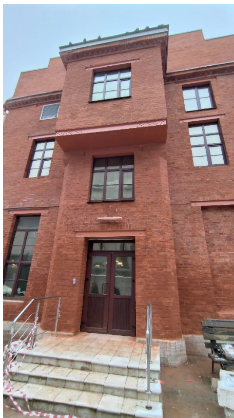
Фото 6. Эркер в уровне 3-го этажа. Северный фасад. Общий вид. Дата фотофиксации: 20.11.25.
