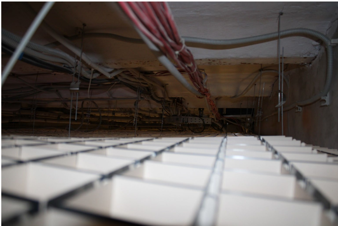
Фото 21. Пространство помещений 27, 21, 16 (1-Н). Своды. Фрагмент. Дата фотофиксации: 20.11.25.
