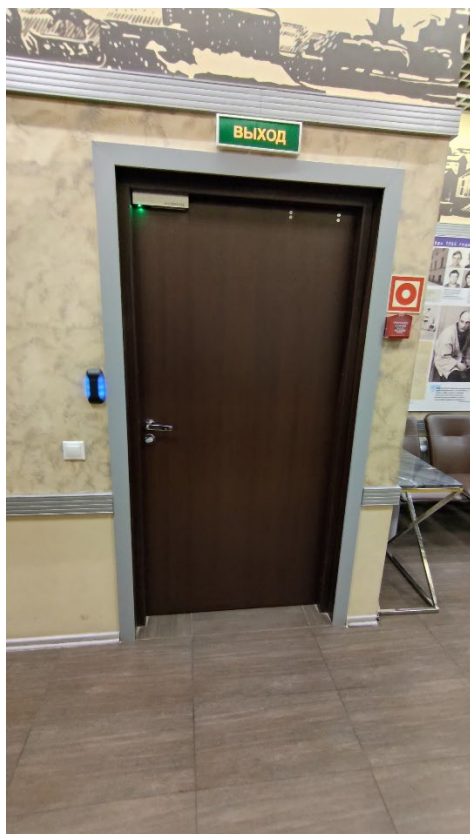
Фото 32. Дверное заполнение в пространстве помещений 10-11 (3-Н). Общий вид. Дата фотофиксации: 20.11.25.
