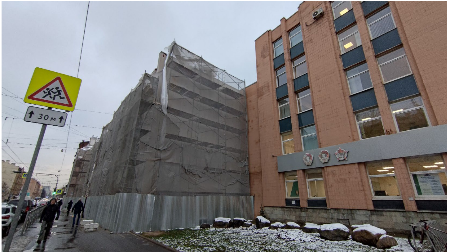
Фото 3. Южный фасад. Фрагмент. Дата фотофиксации: 20.11.25.
