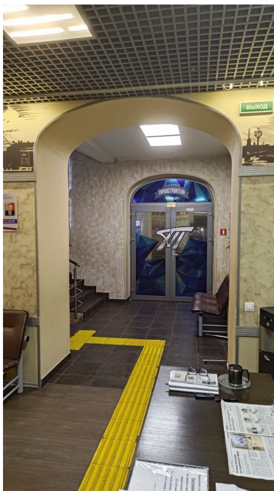
Фото 31. Портал с лучковым завершением в уровне 1-го этажа (3-Н). Общий вид. Дата фотофиксации: 20.11.25.
