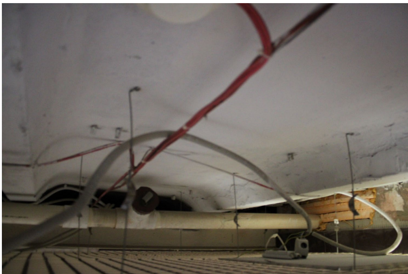
Фото 28. Пространство помещений 7 и 8 (1-Н). Своды. Фрагмент. Дата фотофиксации: 20.11.25.
