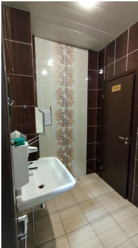
Фото 58. Помещение 13 (4-Н). Фрагмент. Дата фотофиксации: 20.11.25.
