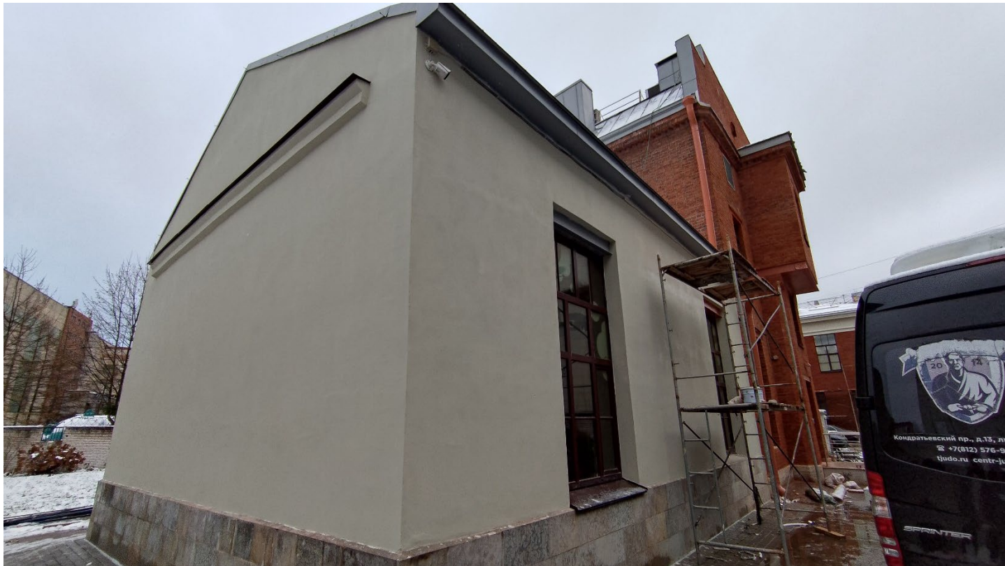
Фото 9. Северо-восточный фасад. Фрагмент. Дата фотофиксации: 20.11.25.
