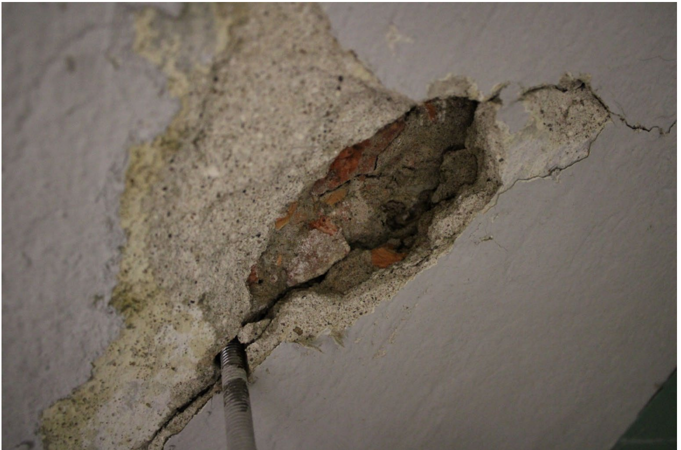
Фото 24. Пространство помещений 27, 21, 16 (1-Н). Своды. Фрагмент кирпичной кладки. Дата фотофиксации: 20.11.25.
