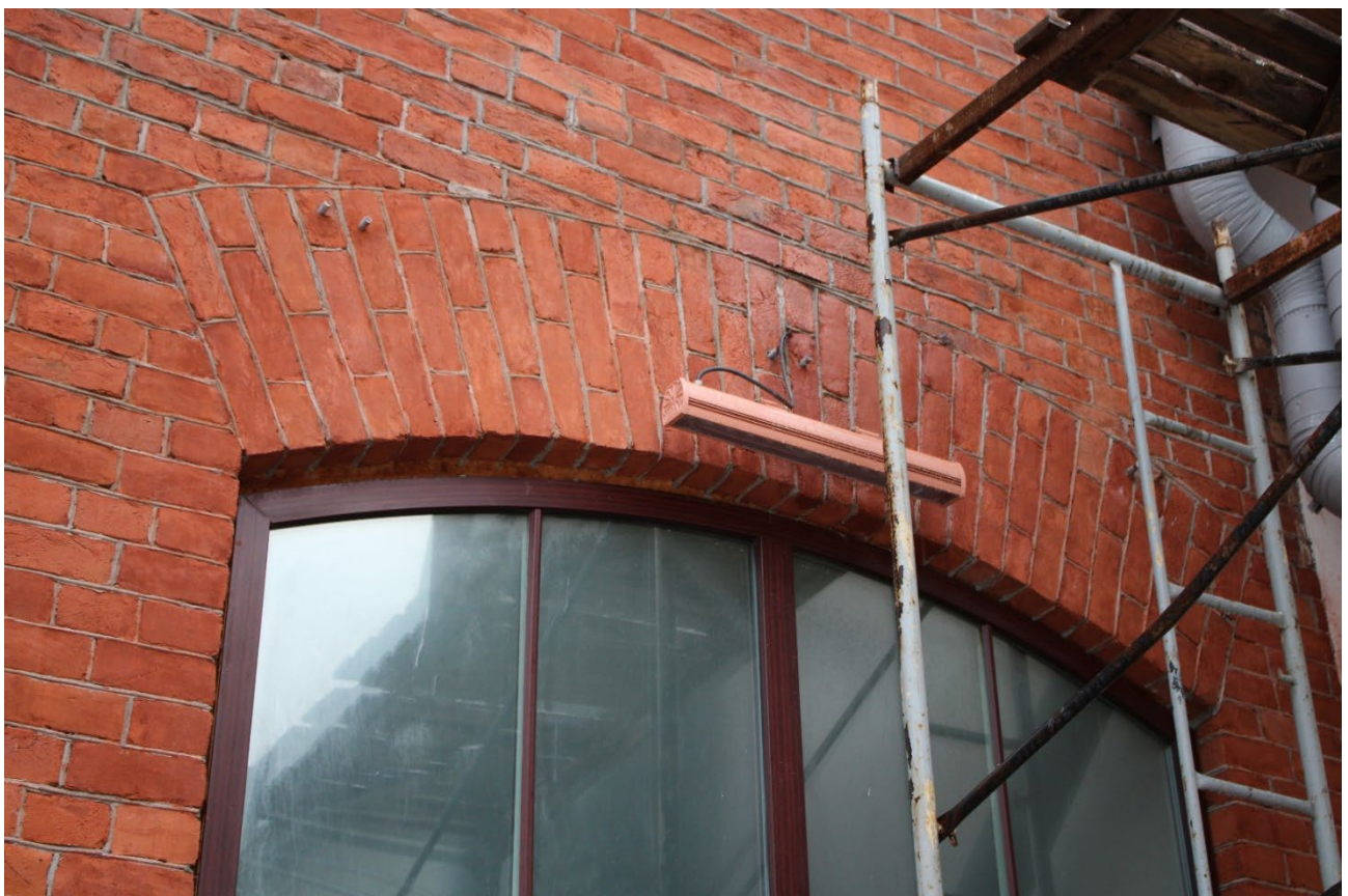
Фото 14. Лучковая перемычка дверного проёма юго-восточного фасада. Общий вид. Дата фотофиксации: 20.11.25.
