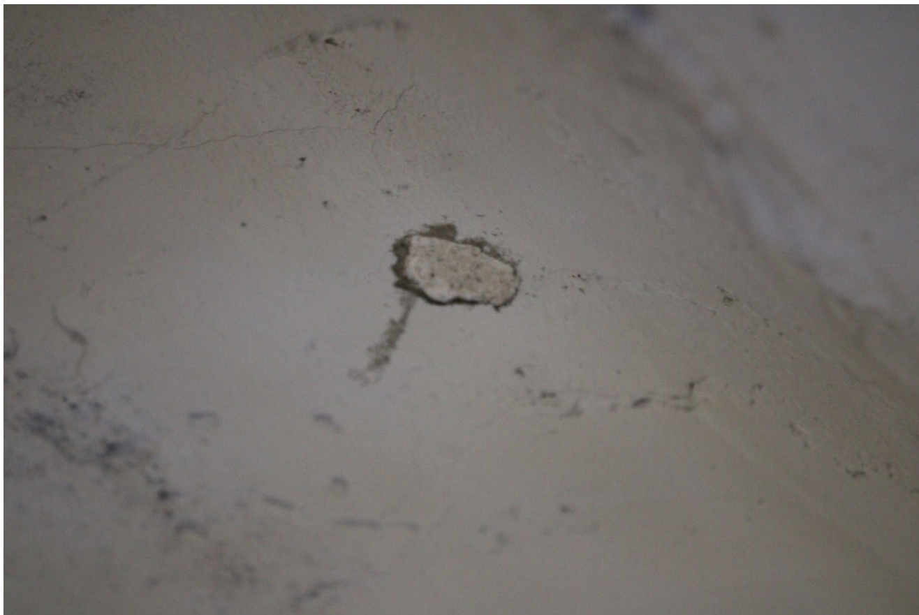
Фото 27. Пространство помещений 7 и 8 (1-Н). Своды. Фрагмент. Дата фотофиксации: 20.11.25.
