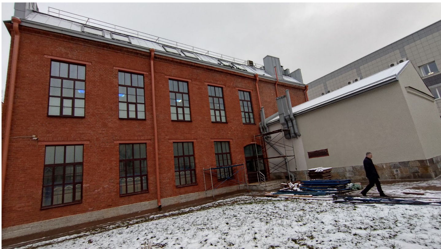
Фото 10. Восточный фасад. Фрагмент. Дата фотофиксации: 20.11.25.
