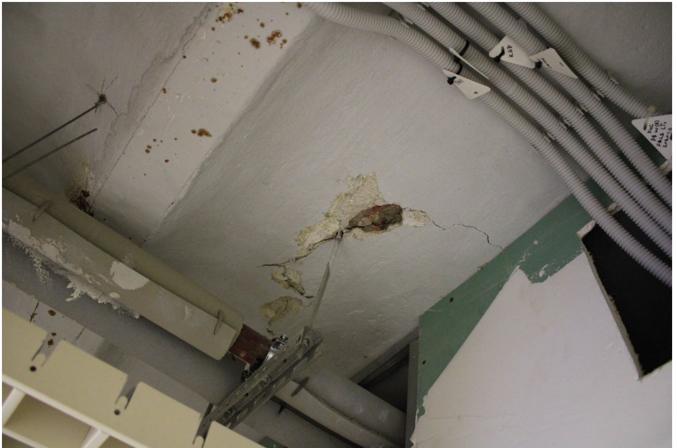
Фото 23. Пространство помещений 27, 21, 16 (1-Н). Своды. Фрагмент кирпичной кладки. Дата фотофиксации: 20.11.25.
