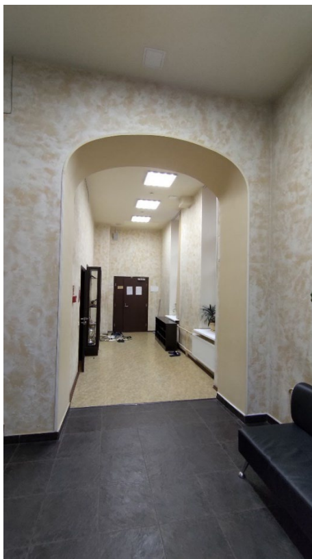
Фото 50. Портал с лучковым завершением. Уровень 2-го этажа (4-Н). Общий вид. Дата фотофиксации: 20.11.25.
