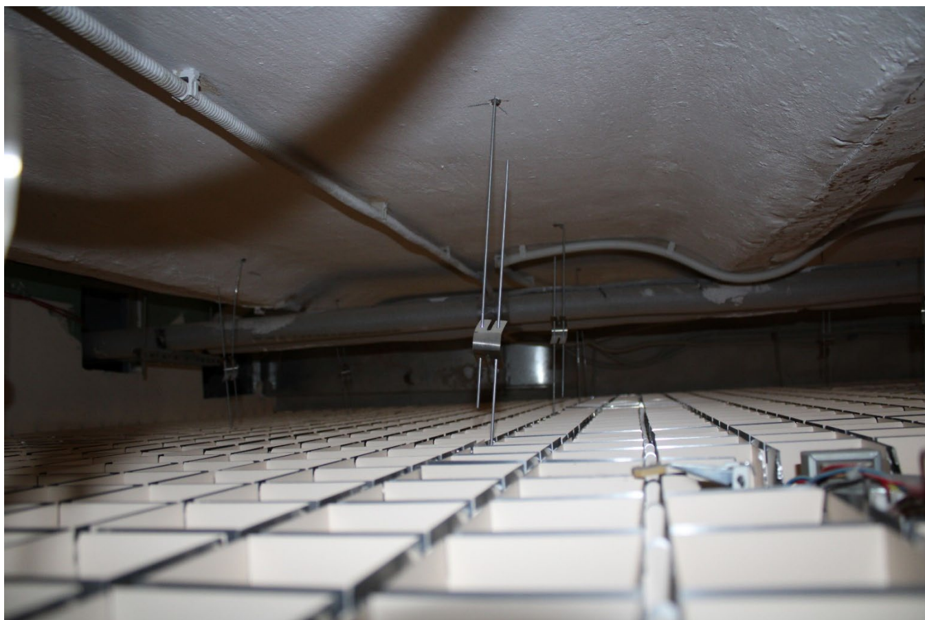
Фото 22. Пространство помещений 27, 21, 16 (1-Н). Своды. Фрагмент. Дата фотофиксации: 20.11.25.
