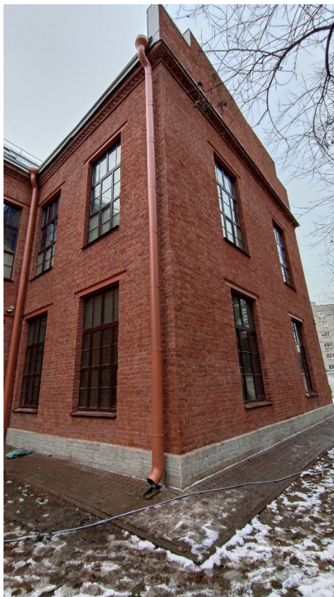
Фото 15. Южный фасад. Фрагмент. Дата фотофиксации: 20.11.25.
