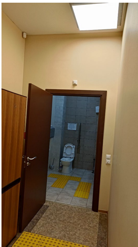
Фото 35. Пространство помещений 2-8 (3-Н). Фрагмент. Дата фотофиксации: 20.11.25.
