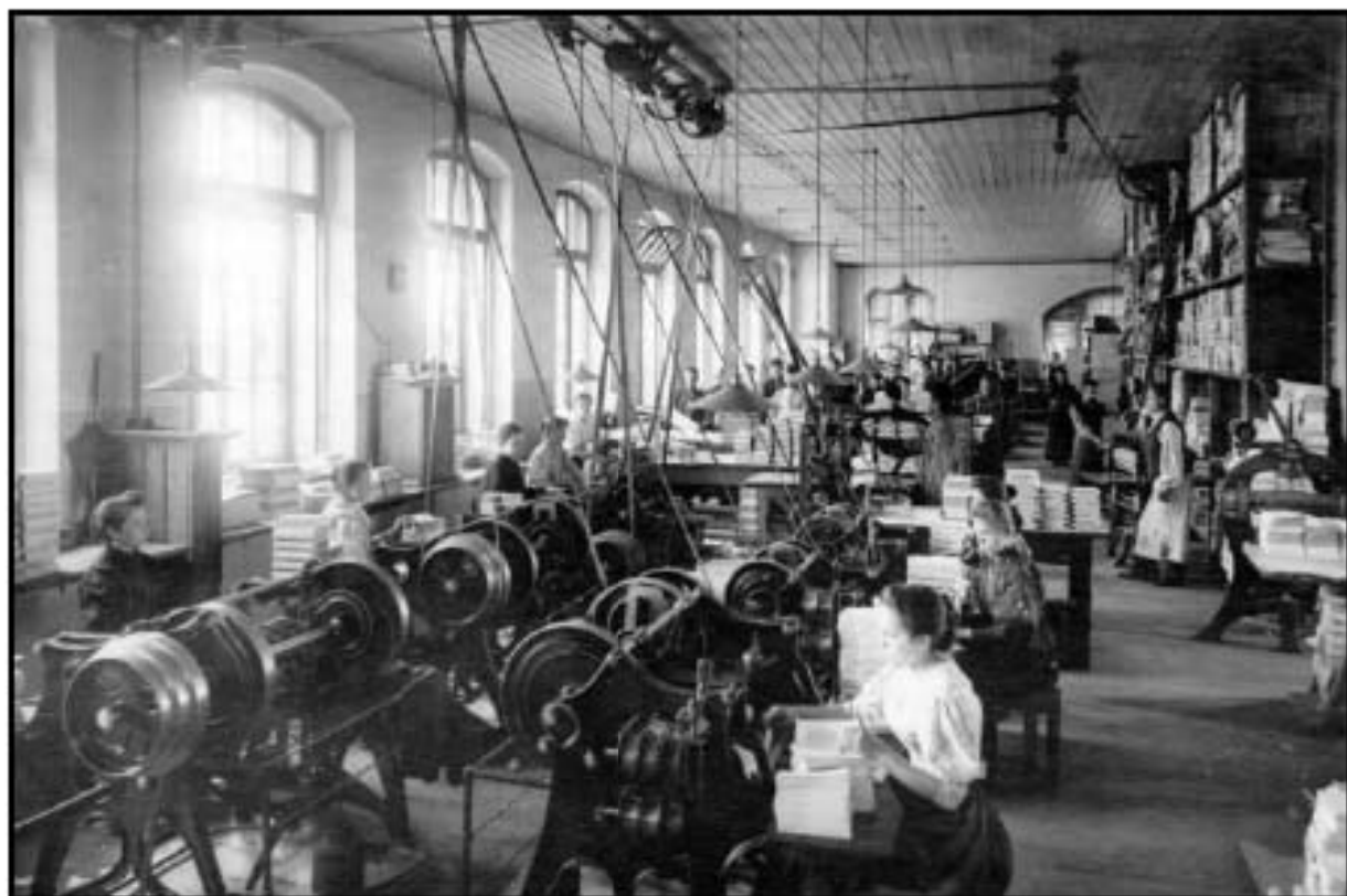
70. Производственный пех фабрики «Отто Кирхнер» (современный корпус лит. В). 1909 г. // ЦГА КФФД СПб. Шифр: Д 14316.
