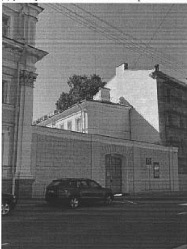
Кирпичная ограда между главным домом и западным флигелем, деревянное двустворчатое филенчатое воротное заполнение
