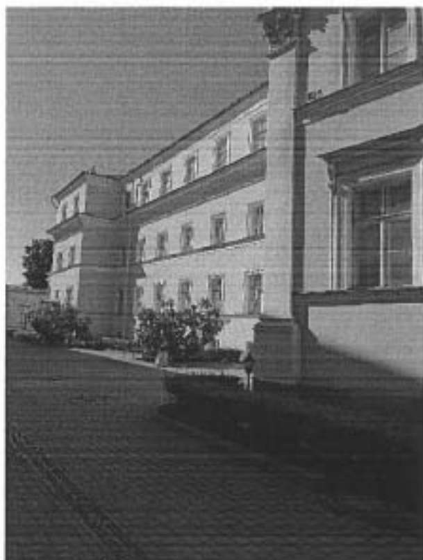
Восточный фасад главного дома
