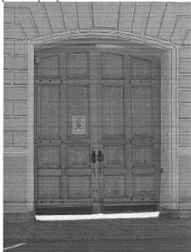
Кирпичная ограда между главным домом и западным флигелем, деревянное двустворчатое филенчатое воротное заполнение
