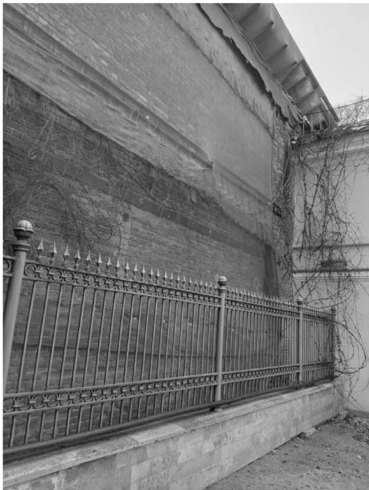
Фото 12. Северный участок Ограды (Предмет охраны объекта «Сад» в составе объекта культурного наследия федерального значения "Усадьба Державина Г.Р." по адресу: г. Санкт-Петербург, Адмиралтейский район, наб. р. Фонтанки, дом 118, лит.А,Д,Ж.
