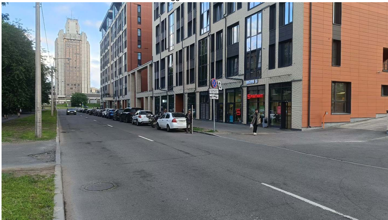
Рис. 18. СПб-2025, Белоостровская ул., д. 9, лит А. Точка фотофиксации 3, вид с северо-востока.
