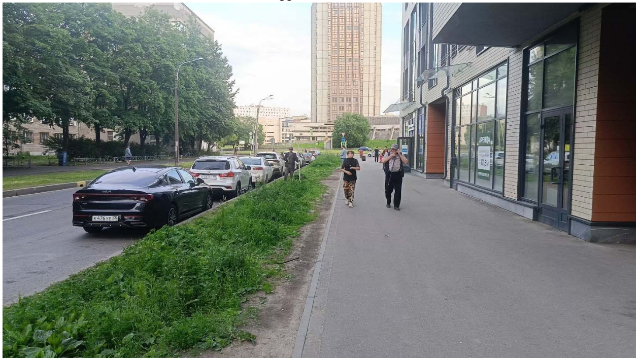
Рис. 16. СПб-2025, Белоостровская ул., д. 9, лит А. Точка фотофиксации 2, вид с севера.
