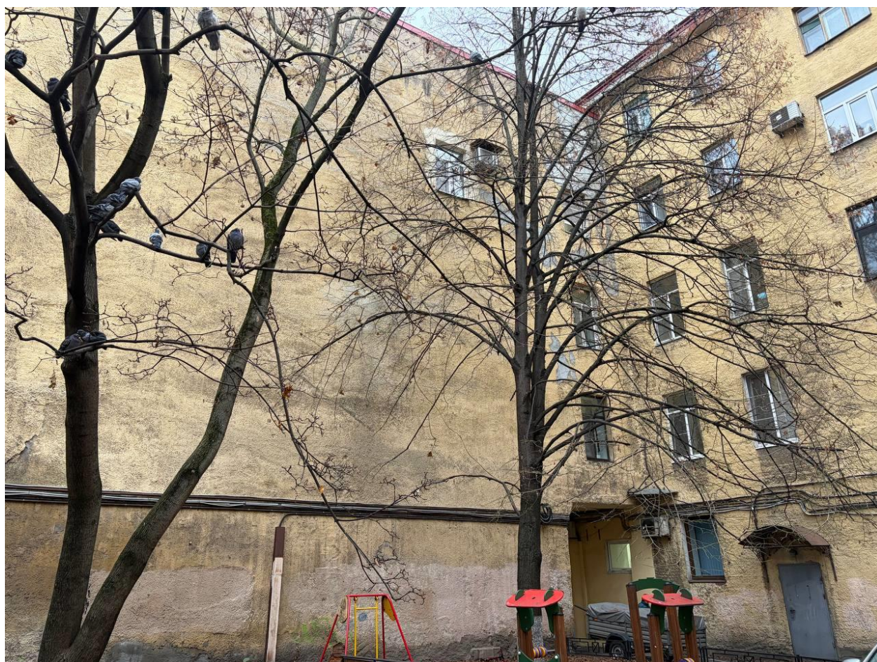
Фото 16. Вид на фрагмент дворового фасада выявленного объекта культурного наследия «Дом К. Штрауха», расположенного по адресу: Санкт-Петербург, Вознесенский пр., 21
