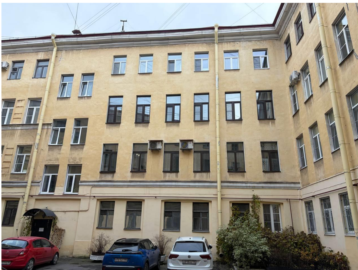
Фото 6. Вид на фрагмент дворового фасада выявленного объекта культурного наследия «Дом К. Штрауха», расположенного по адресу: Санкт-Петербург, Вознесенский пр., 21
