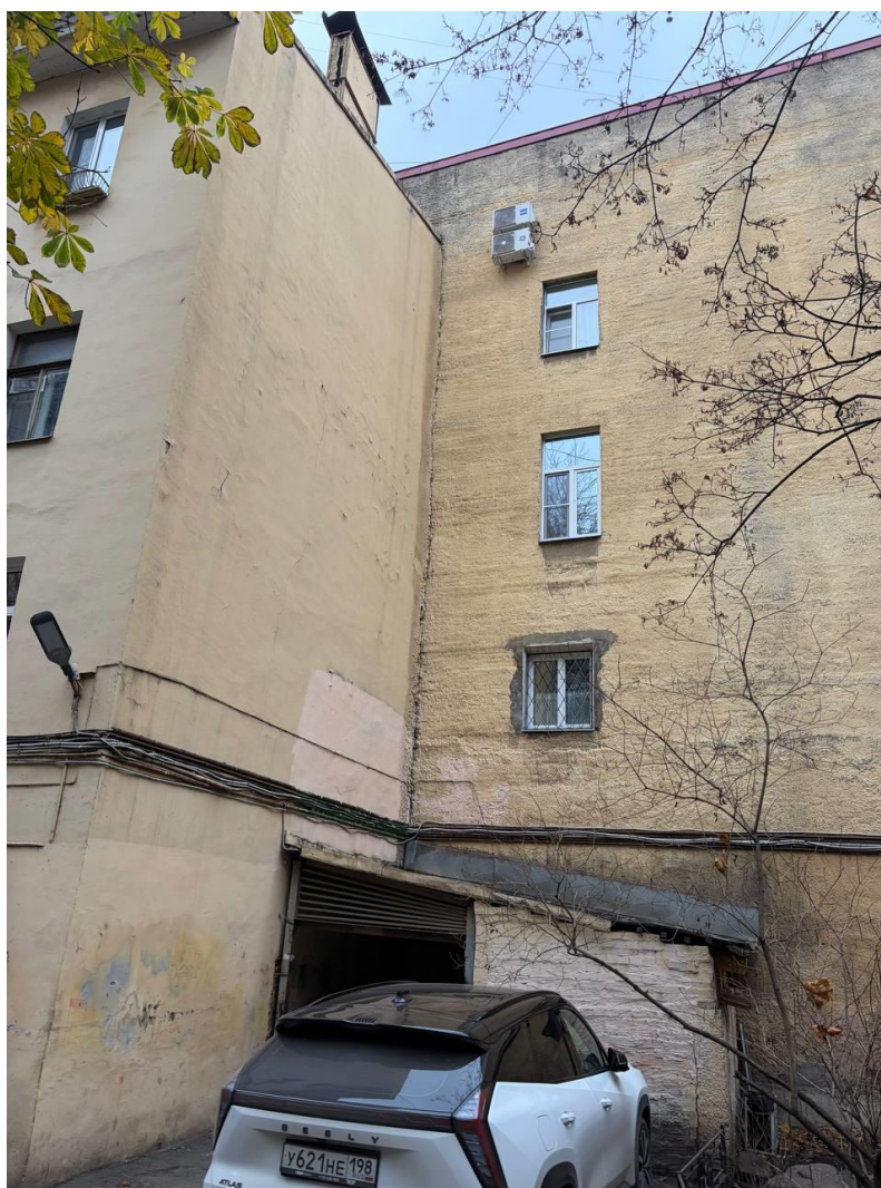
Фото 18. Вид на фрагмент дворового фасада выявленного объекта культурного наследия «Дом К. Штрауха», расположенного по адресу: Санкт-Петербург, Вознесенский пр., 21
