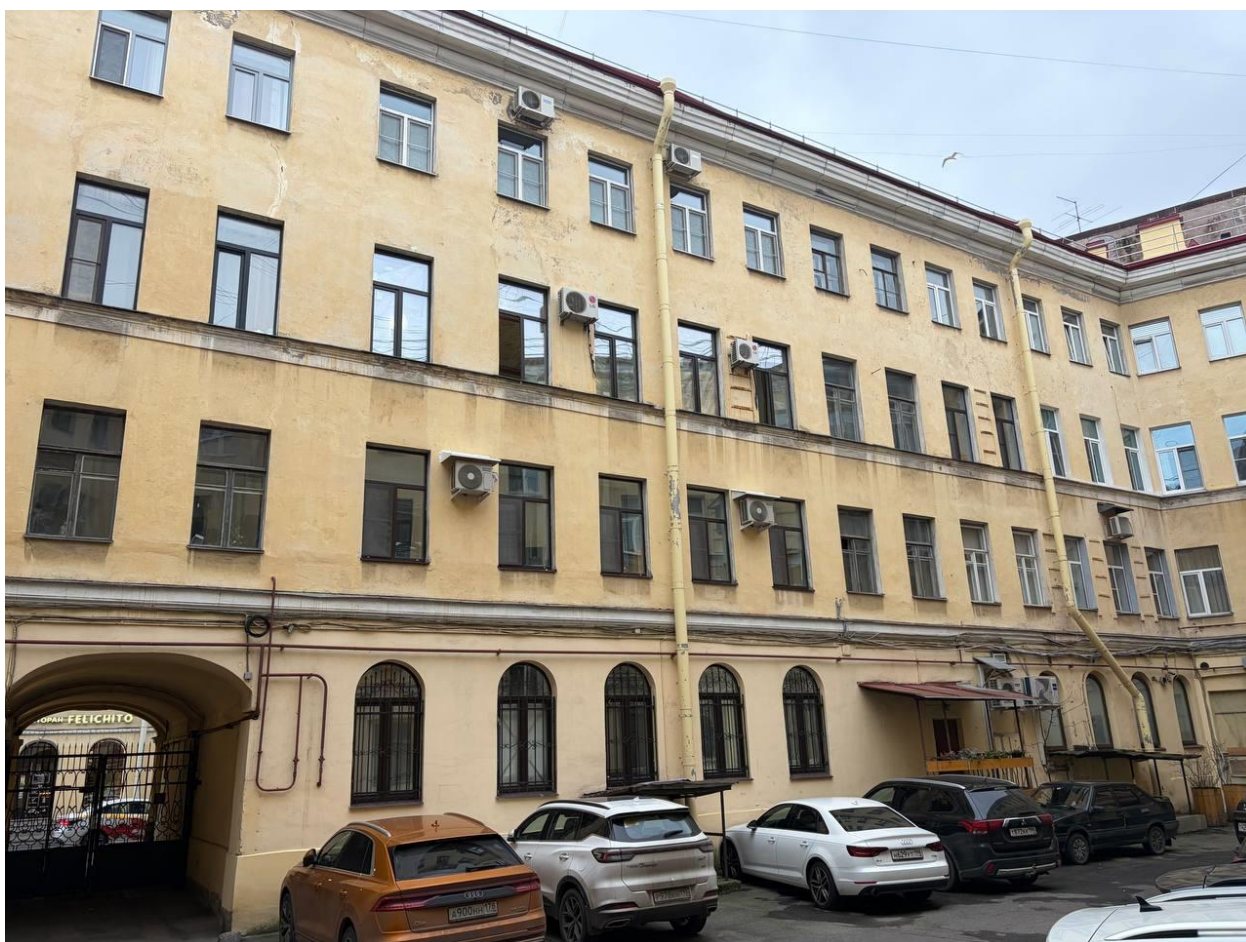
Фото 8. Вид на фрагмент дворового фасада выявленного объекта культурного наследия «Дом К. Штрауха», расположенного по адресу: Санкт-Петербург, Вознесенский пр., 21
