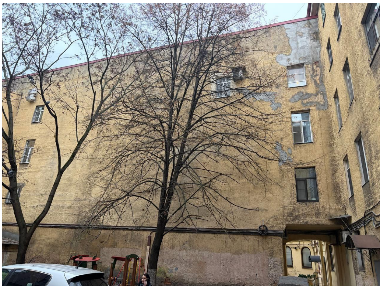
Фото 15. Вид на фрагмент дворового фасада выявленного объекта культурного наследия «Дом К. Штрауха», расположенного по адресу: Санкт-Петербург, Вознесенский пр., 21
