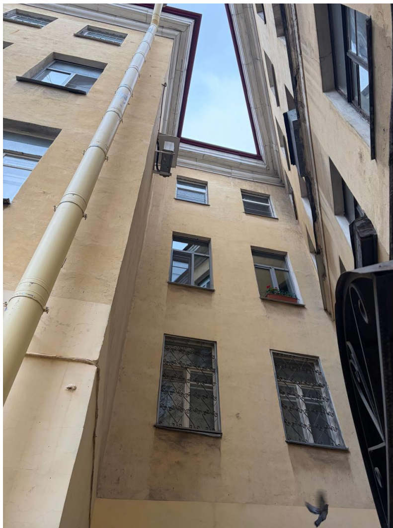
Фото 10. Вид на фрагмент дворового фасада выявленного объекта культурного наследия «Дом К. Штрауха», расположенного по адресу: Санкт-Петербург, Вознесенский пр., 21
