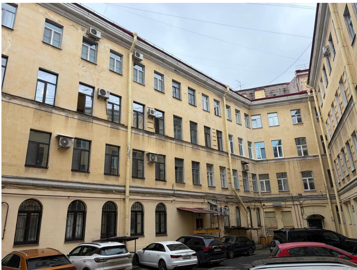
Фото 12. Вид на фрагмент дворового фасада выявленного объекта культурного наследия «Дом К. Штрауха», расположенного по адресу: Санкт-Петербург, Вознесенский пр., 21
