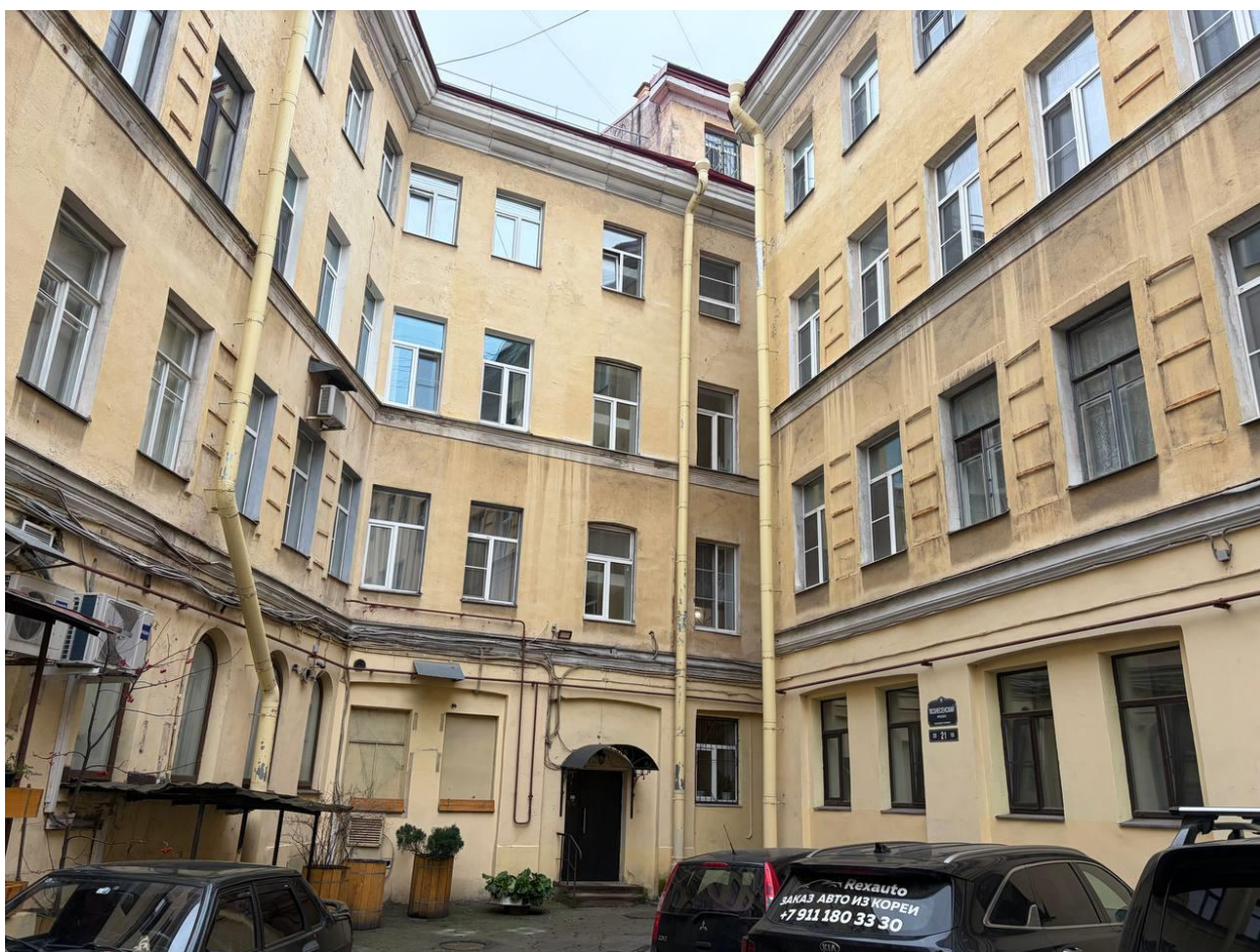
Фото 13. Вид на фрагмент дворового фасада выявленного объекта культурного наследия «Дом К. Штрауха», расположенного по адресу: Санкт-Петербург, Вознесенский пр., 21
