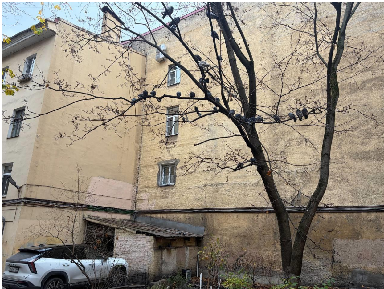
Фото 17. Вид на фрагмент дворового фасада выявленного объекта культурного наследия «Дом К. Штрауха», расположенного по адресу: Санкт-Петербург, Вознесенский пр., 21
