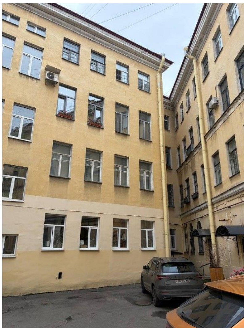
Фото 9. Вид на фрагмент дворового фасада выявленного объекта культурного наследия «Дом К. Штрауха», расположенного по адресу: Санкт-Петербург, Вознесенский пр., 21
