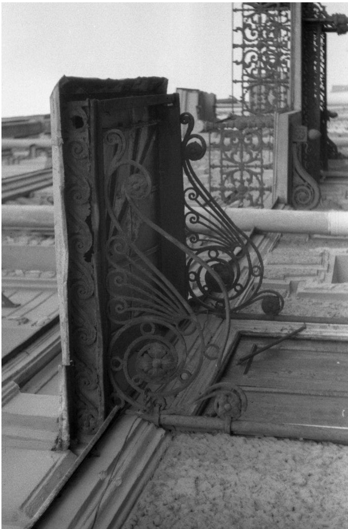
47. Набережная Кутузова, 28. Особняк Е.А. Александровской. Лицевой фасад. Парадный вход. Металлический козырёк. Общий вид. Фотография. Автор фото – Доспехов Сергей Владимирович. 2000 г. // Источник: https://pastvu.com/p/1453501
