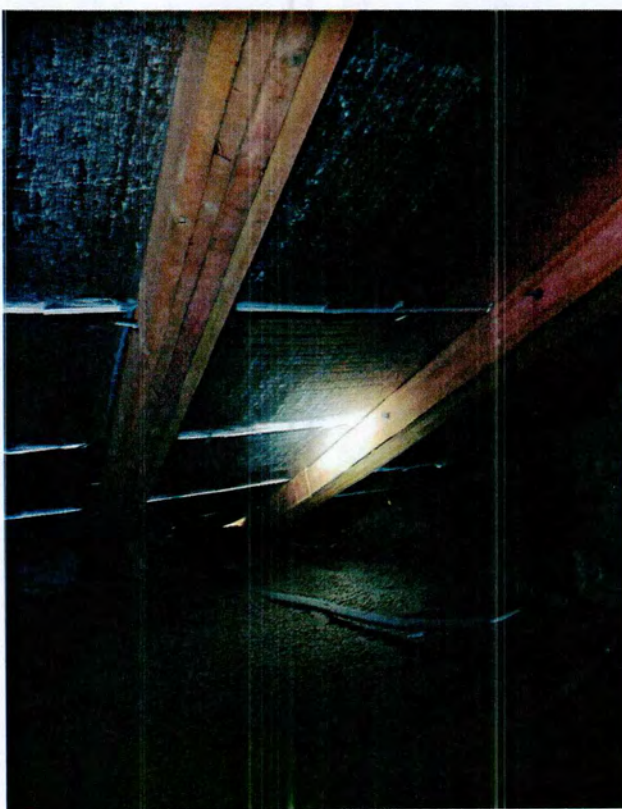
15. Чердачное пространство объекта культурного наследия (фото от 20.02.2024).
