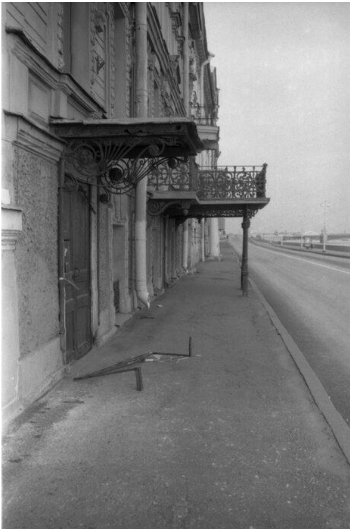
48. Набережная Кутузова, 28. Особняк Е.А. Александровской. Лицевой фасад. Фрагмент. Фотография. Автор фото – Доспехов Сергей Владимирович. 2000 г. // Источник: https://pastvu.com/p/1437416 .
