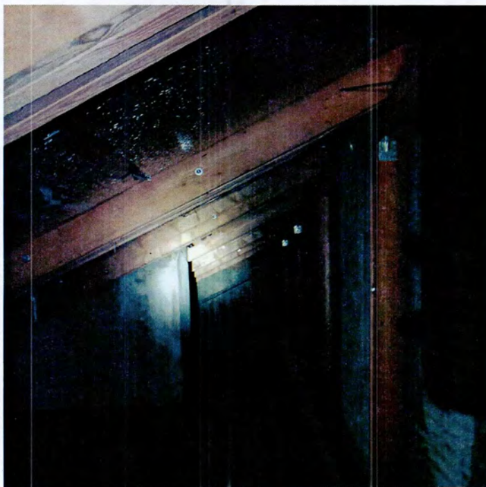
16. Чердачное пространство объекта культурного наследия (фото от 20.02.2024).
