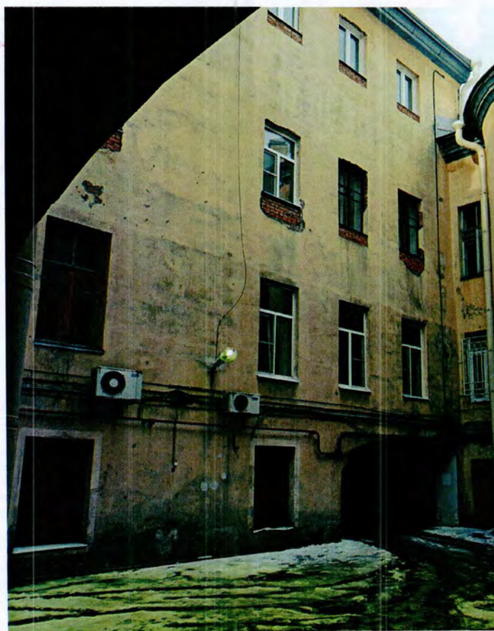
5. Общий вид восточного фасада объекта культурного наследия (фото от 20.02.2024).
