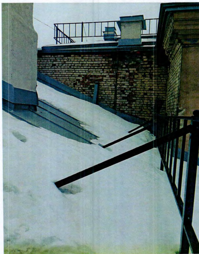
17. Кровля объекта культурного наследия (фото от 20.02.2024).
