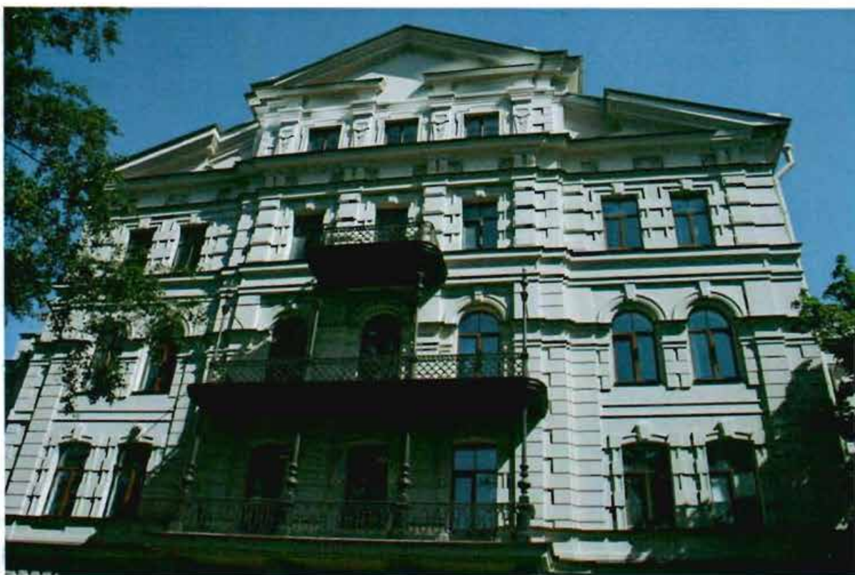
3. Южный лицевой фасад.
