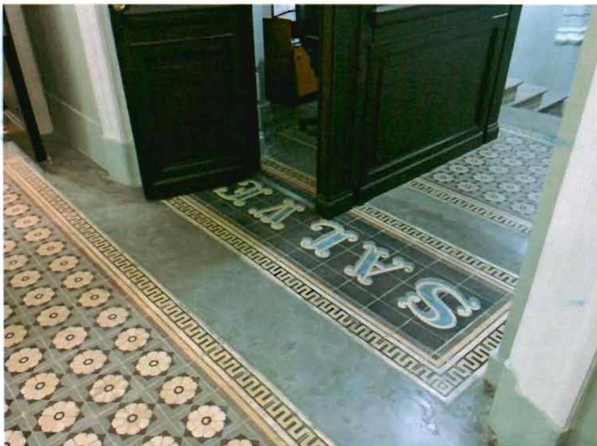
9. Метлахская плитка в парадном вестибюле, надпись «SALVE».
