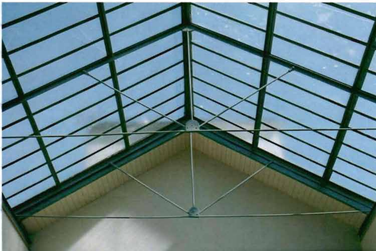
10. Конструкция пирамидального светового фонаря над парадной лестницей.
