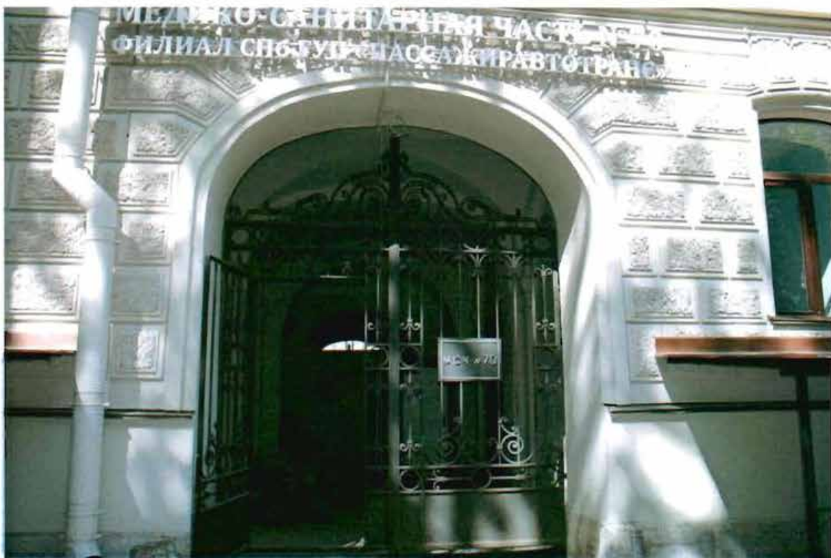
4. Воротный проезд со стороны восточного лицевого фасада.
