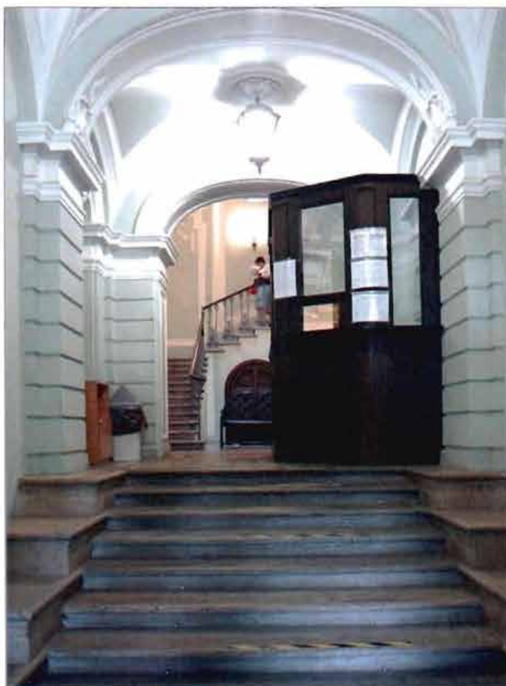
4. Вестибюль. Общий вид.
