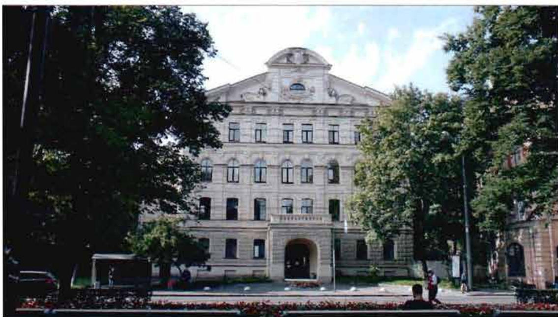
1. Лицевой фасад. Общий вид.
