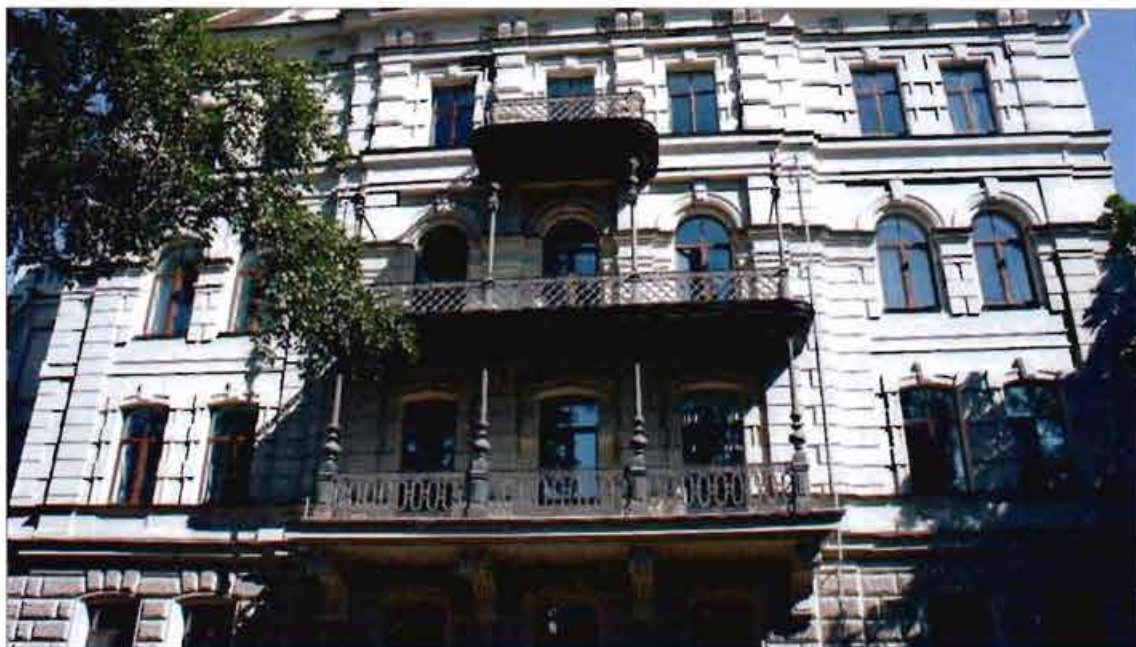
3. Южный фасад. Фрагмент. Трехъярусный балкон.
