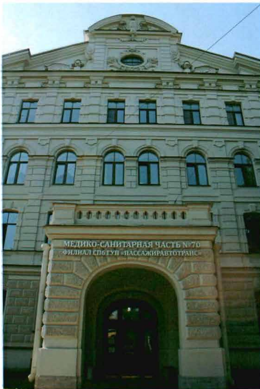
1. Крыльцо со стороны северного лицевого фасада.
