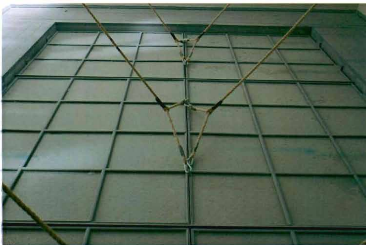
11. Расстекловка пирамидального светового фонаря над парадной лестницей.
