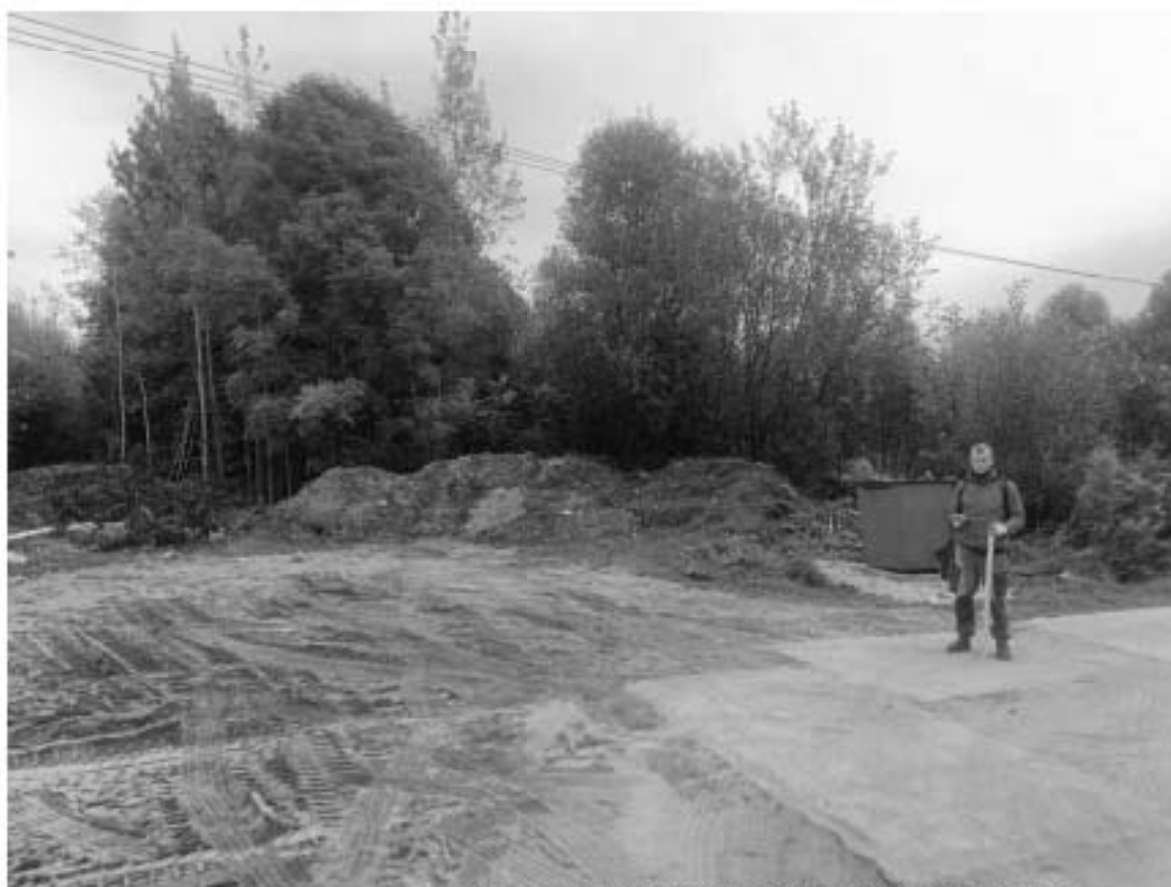
Рис. 60. Волхонское ш.-2025. КН: 78:14:0772303:51, КН: 78:14:0772303:23. Точка фотофиксации 12, вид с запада.
