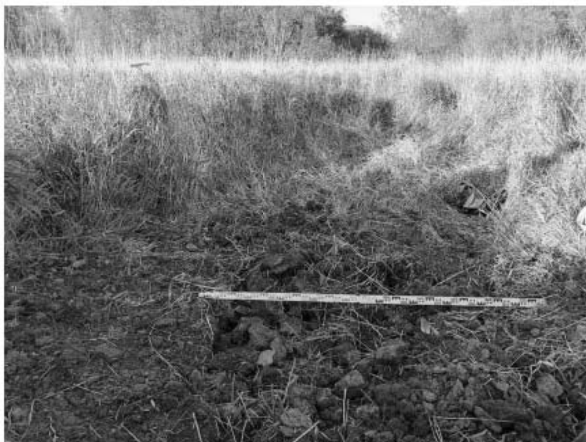
Рис. 300. Волхонское ш.-2025. КН: 78:14:0772303:51, КН: 78:14:0772303:23. Шурф 26, после рекультивации, вид с юга.
