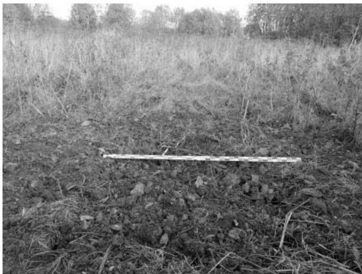
Рис. 796. Волхонское ш.-2025. КН: 78:14:0772303:51, КН: 78:14:0772303:23. Шурф 105, после рекультивации, вид с юга.
