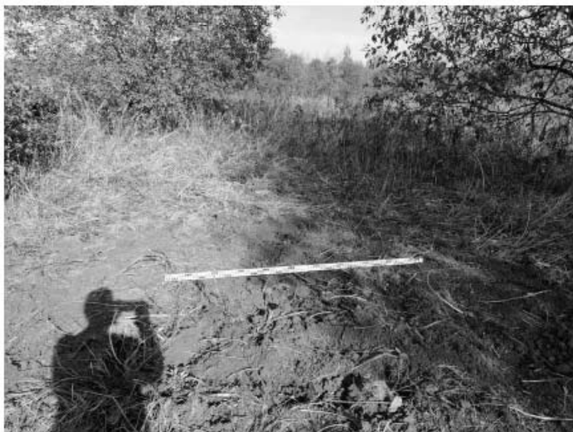
Рис. 464. Волхонское ш.-2025. КН: 78:14:0772303:51, КН: 78:14:0772303:23. Шурф 53, после рекультивации, вид с юга.
