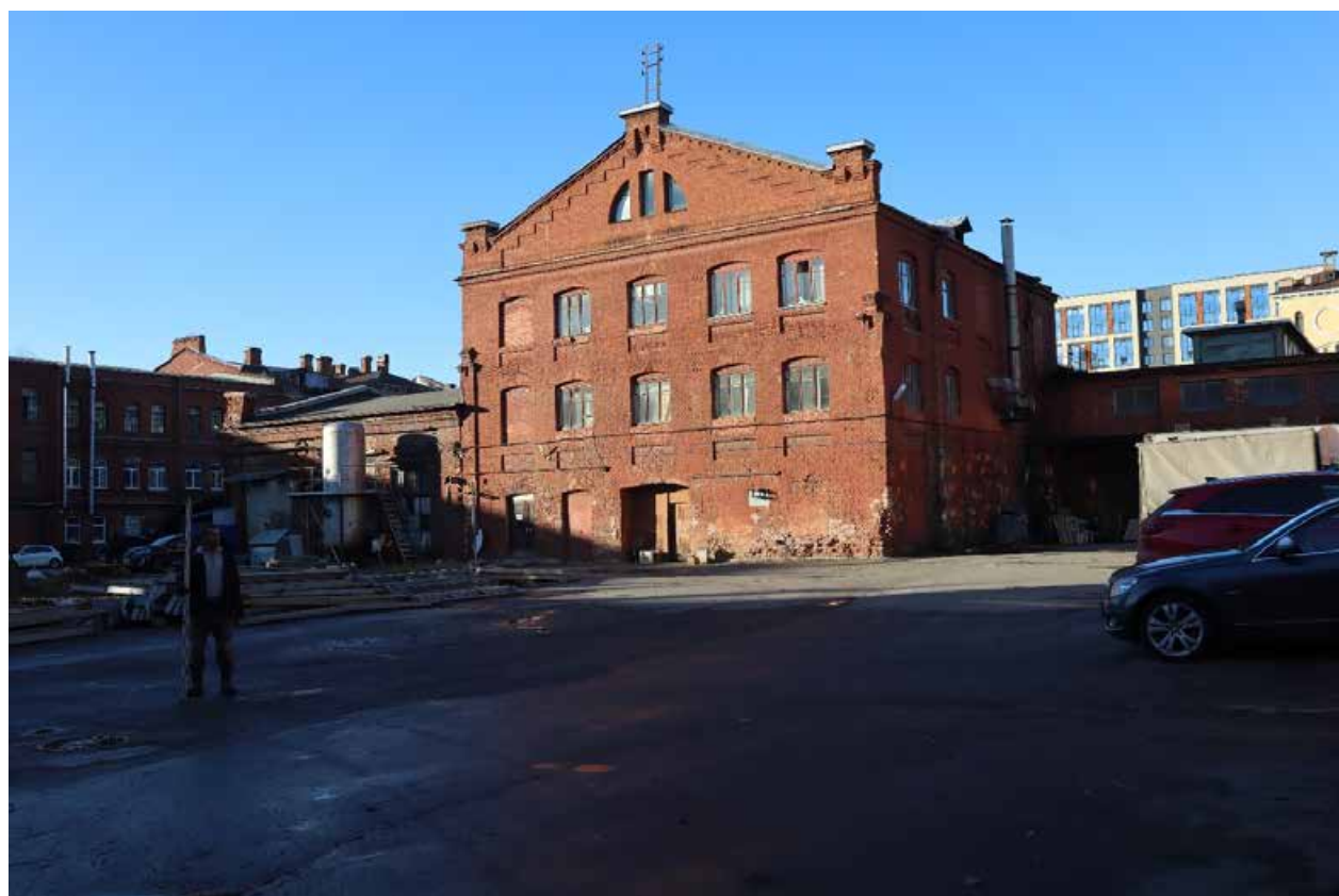
Рис. 53. Санкт-Петербург, Василеостровский р-н. Остров Декабристов, пер. Декабристов, уч. 10; дом 7, лит. Т; У. Общий вид участка. Точка съёмки 23. Вид на северо-запад.
