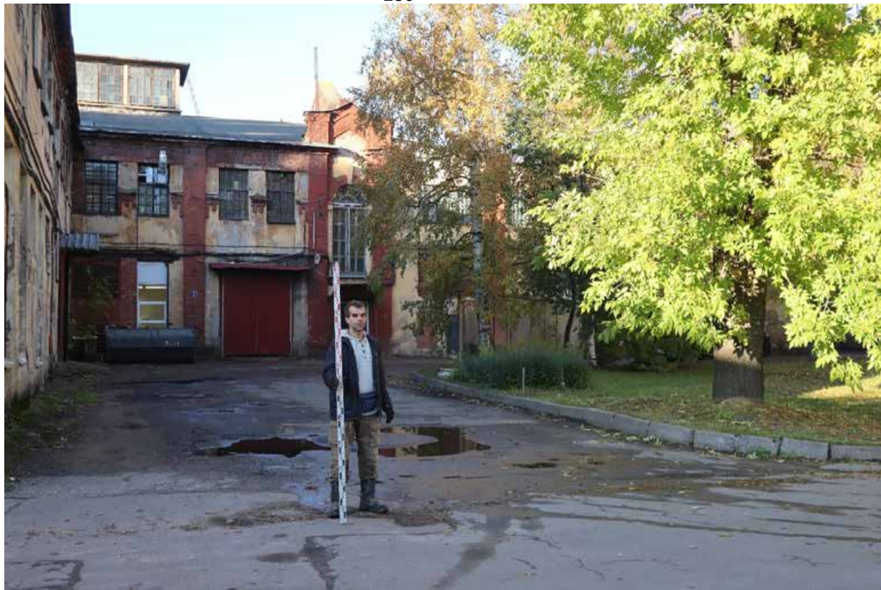
Рис. 64. Санкт-Петербург, Василеостровский р-н Остров Декабристов, пер. Декабристов, уч. 10; дом 7, лит. Т; У. Общий вид участка. Точка съёмки 28. Вид на север.
