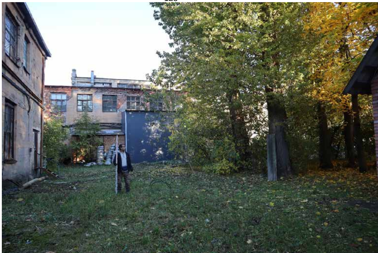
Рис. 60. Санкт-Петербург, Василеостровский р-н. Остров Декабристов, пер. Декабристов, уч. 10; дом 7, лит. Т; У. Общий вид участка. Точка съёмки 26. Вид на восток.
