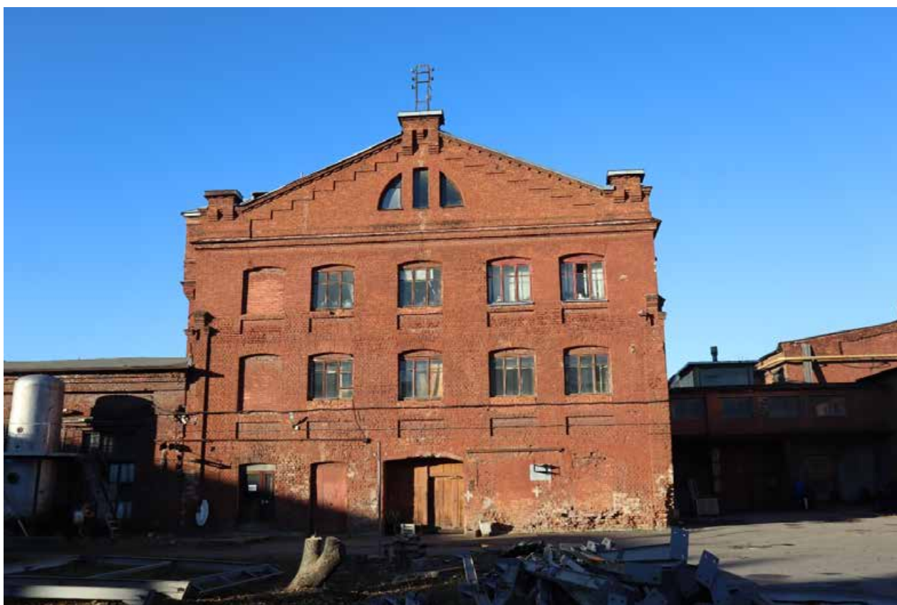
Рис. 55. Санкт-Петербург, Василеостровский р-н. Остров Декабристов, пер. Декабристов, уч. 10; дом 7, лит. Т; У. Общий вид участка. Точка съемки 24. Вид на север.
