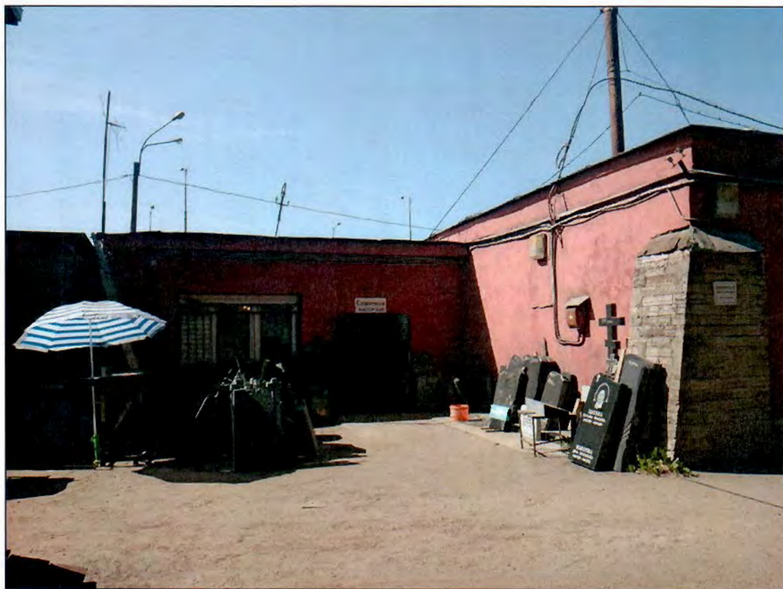
Фото 8. Юго-западный фасад южного павильона (проспект Стачек, д. 98, лит. Б).
