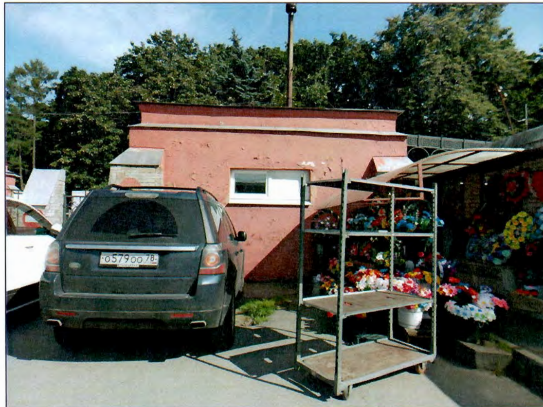
Фото 5. Северо-западный фасад южного павильона (проспект Стачек, д. 98, лит. А).
