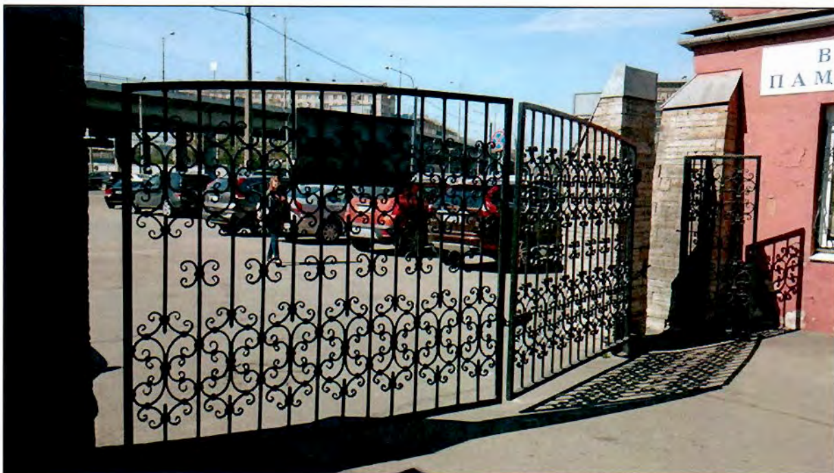
Фото 10. Пилоны ворот с восточной стороны.
