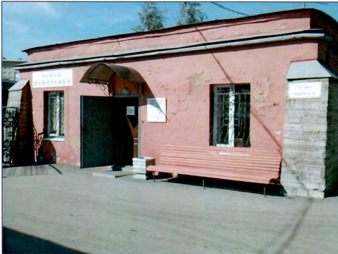
Фото 3. Юго-западный фасад северного павильона (проспект Стачек, д. 98, лит. А).
