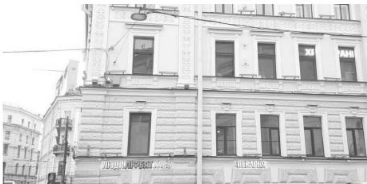
23. «Угловой дом» (в составе «Дома А.Тимофеева (К.А. Тура)») (Невский пр., д. 87/2, лит. А). Лицевой фасад по Гончарной ул. (фрагмент). Фото мест установки оборудования и прокладки кабельных трасс. Штиглиц М.С. 15.11.2025 г.
