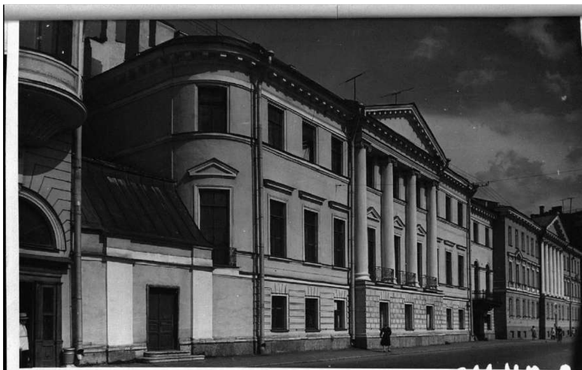
51. Главный (Юго-западный фасад). Фото 1992 г. Архив КГИОП
