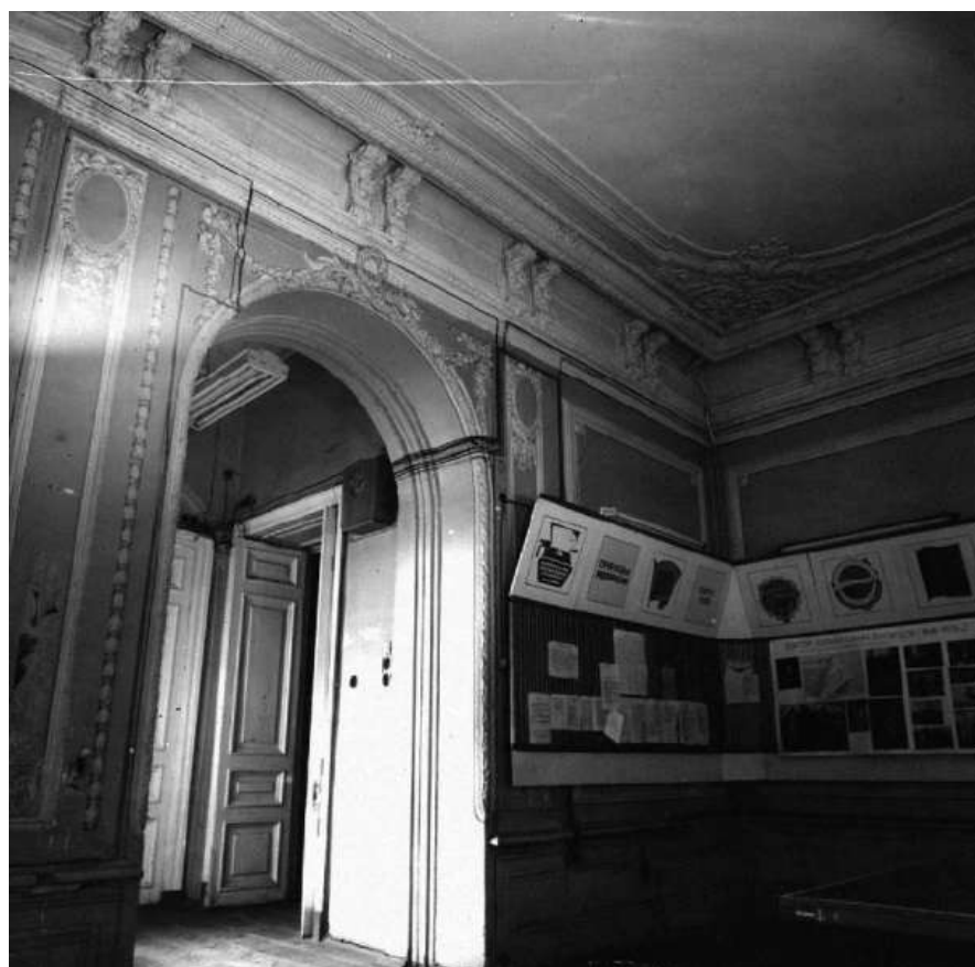
77. Фрагмент б. библиотеки. Фото 1991. Архив КГИОП.
