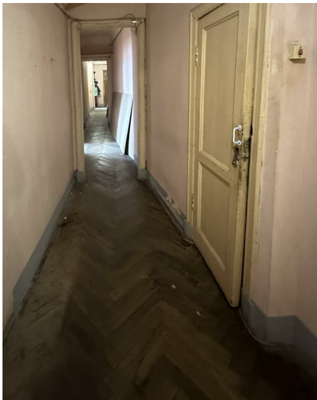
Фото 12. Вид со стороны кухни в коридор
