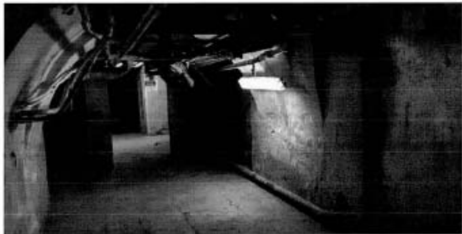
11. Фрагмент интерьеров (помещение подвала)
