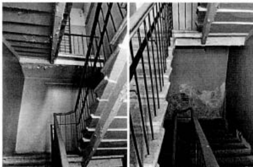
Фото 78, 79. Лестница Л-3 в корпусе по Гагаринской улице
