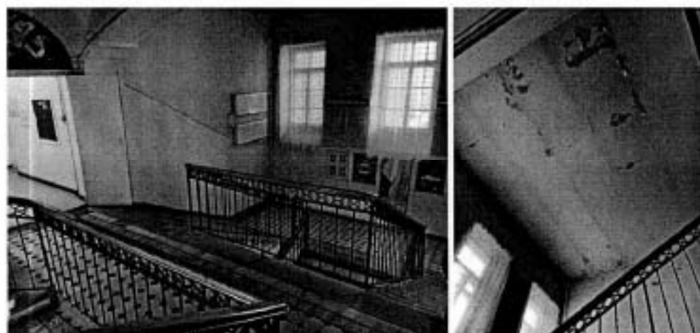
Фото 70, 71. Лестница Л-2 корпуса по Гагаринской улице
