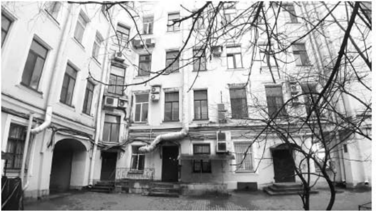
7. «Дом, где в меблированных комнатах «Париж» у Вацлава Вацлавовича Воровского в 1905 г. Владимир Ильич Ленин часто бывал по партийным делам». (наб. реки Фонтанки, д. 29/66, лит. А). Дворовые фасады. Фото мест установки оборудования и прокладки кабельных трасс. Штиглиц М.С. 10.11.2025 г.
