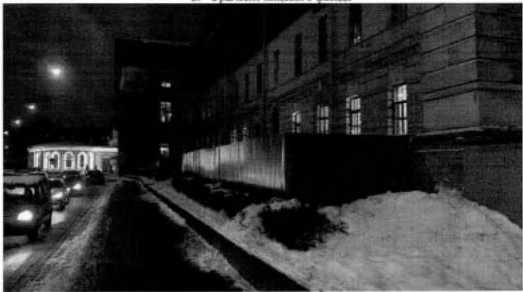
3. Фрагмент лицевого фасада
