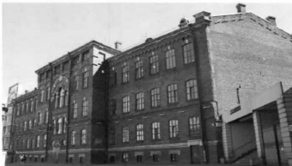
Фото №1. Вид на западный фасад и брашмауэРНую южную стену со стороны Лиговского проспекта.
