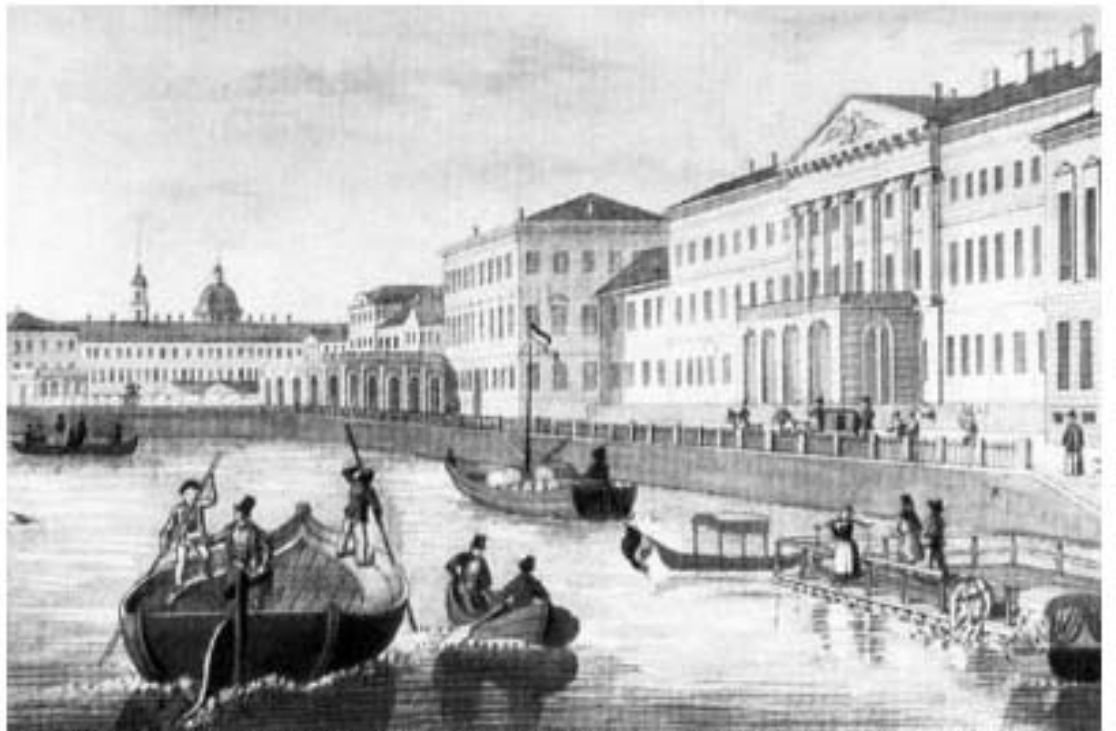
11. «Институт» (в составе «Институт Екатерининский») (наб. реки Фонтанки, д. 36, лит. А). Фонтанка. Вид от Аничкова моста. Гравюра (фрагм.), 1820-е гг. [26].
