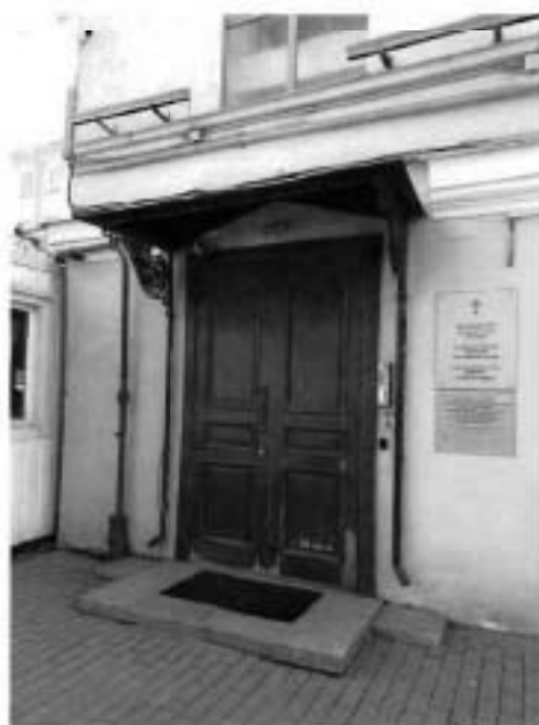
5. Фрагмент западного фасада объекта культурного наследия (фото от 06.09.2023).
