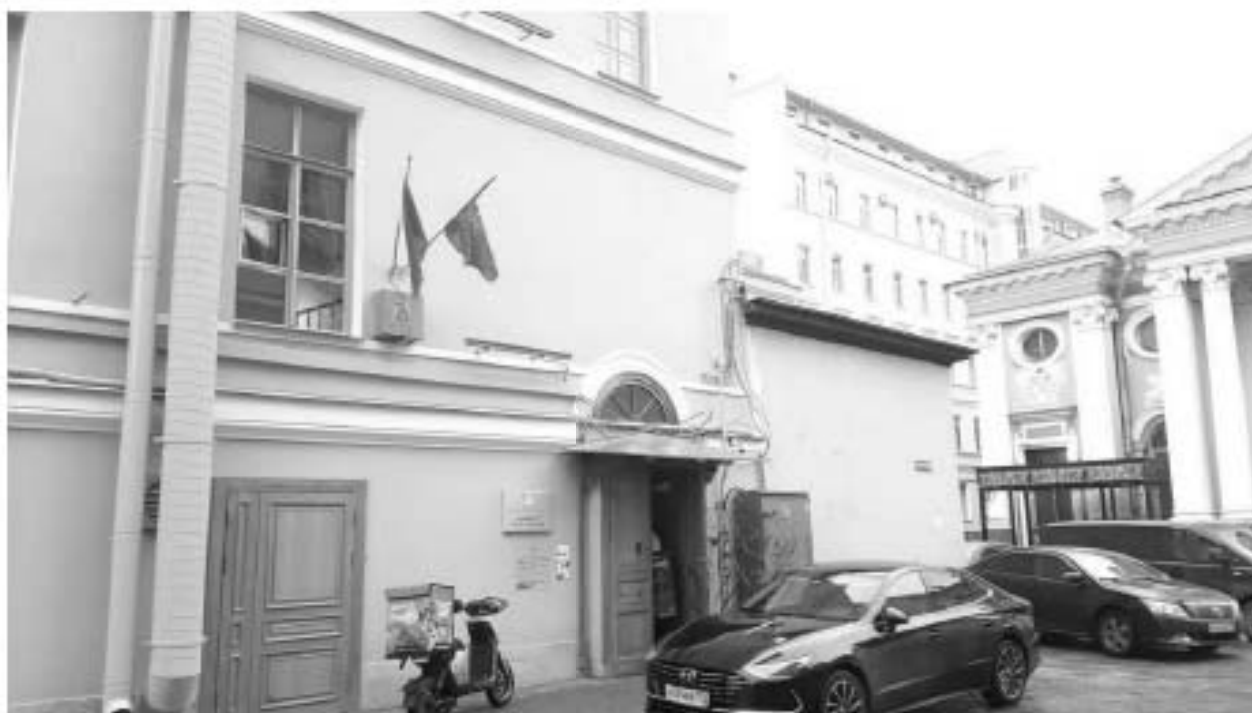
19. «Дом жилой. Здесь жили: в 1823-1832 гг. – государственный деятель Сперанский М.М., в 1823-1825 гг. – декабрист Батеньков Г.С., в 1854-1873 гг. – поэт Тютчев Ф.И.» (в составе «Церковь армянская святой Екатерины») (Невский пр., д. 40-42, лит. А). Дворовые фасады. Фото мест установки оборудования и прокладки кабельных трасс. Штиглиц М.С. 10.11.2025 г.
