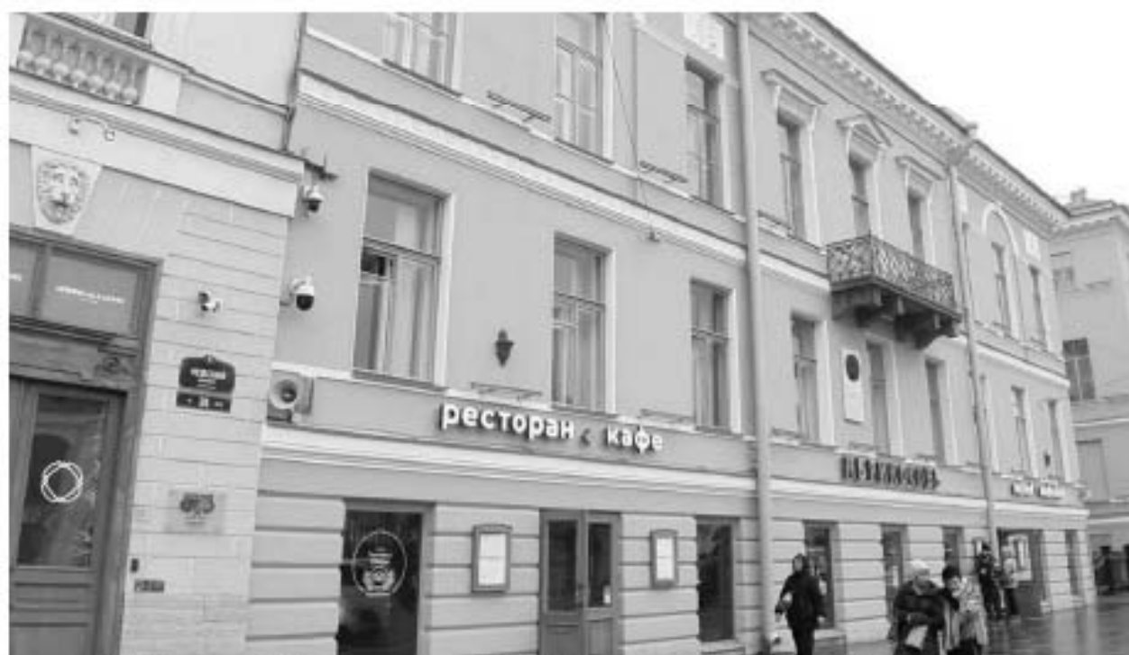
18. «Дом жилой. Здесь жили: в 1823-1832 гг. – государственный деятель Сперанский М.М., в 1823-1825 гг. – декабрист Батеньков Г.С., в 1854-1873 гг. – поэт Тютчев Ф.И.» (в составе «Церковь армянская святой Екатерины») (Невский пр., д. 40-42, лит. А). Лицевой фасад. Фото мест установки оборудования и прокладки кабельных трасс. Штиглиц М.С. 10.11.2025 г.
