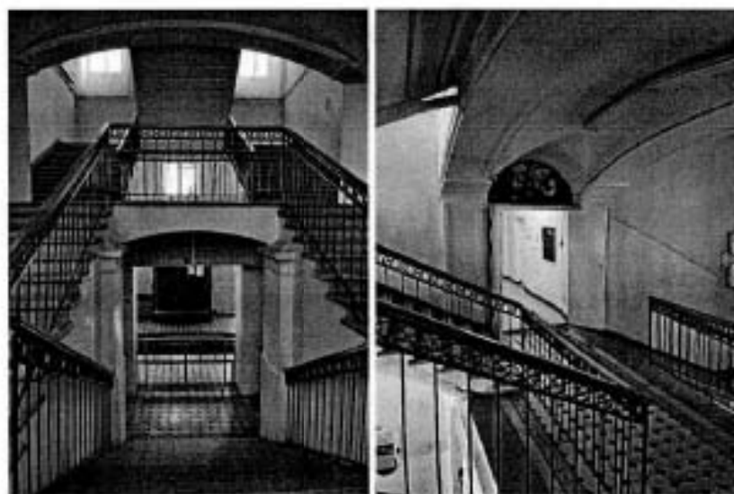
Фото 68, 69. Лестница Л-2 корпуса по Гагаринской улице
