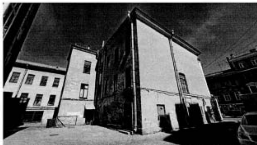
Фото 61. Торцевой южный фасад корпуса по Гагаринской улице
