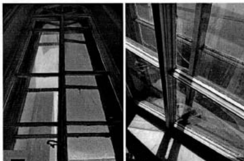
Фото 24, 25. Оконные заполнения в границах парадной лестницы корпуса по Соляному переулку (пом. 1Н (29,69,141,161))
