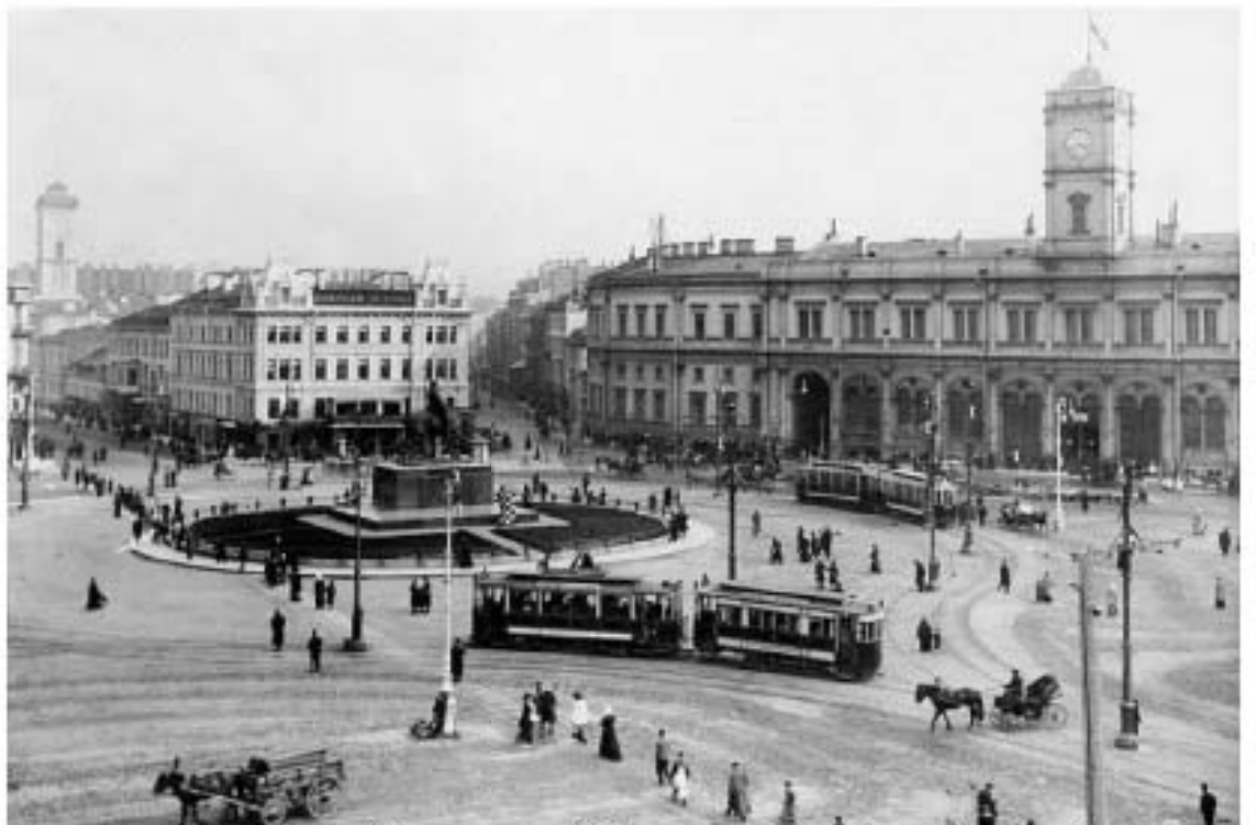
26. «Вокзал Николаевский (Московский)» (Невский пр., д. 85, лит. А). Знаменская площадь. Фотография 1900-х гг. [26].
