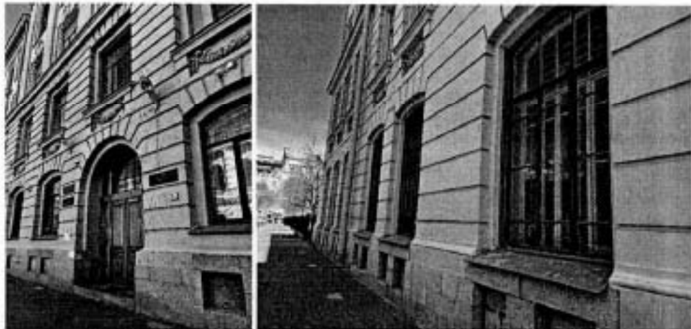
Фото 2, 3. Фрагменты 1 этажа лицевого фасада по Соляному переулку
