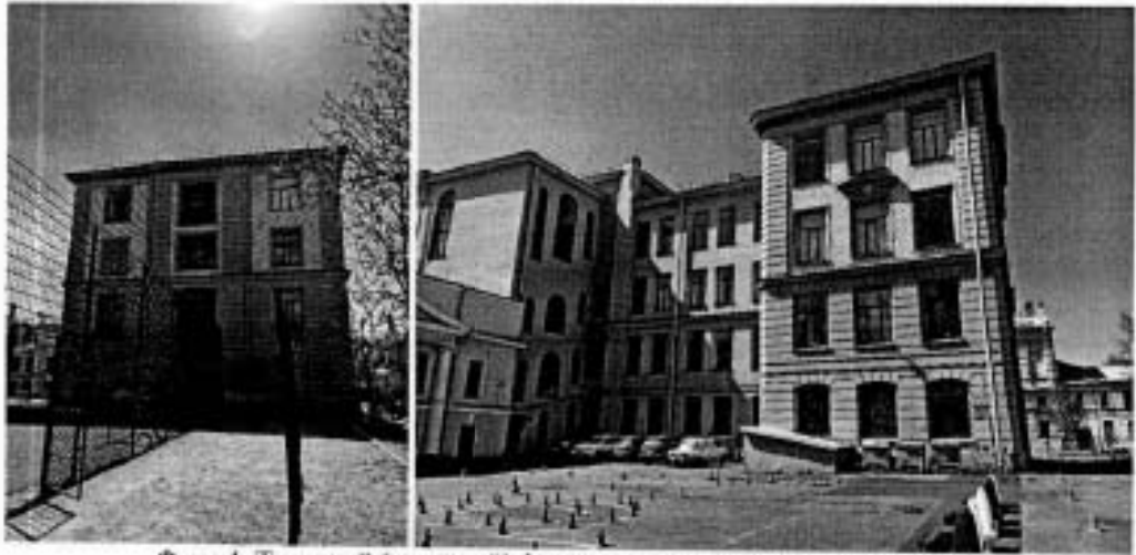
Фото 4. Торцевой (северный) фасад корпуса по Соляному переулку Фото 5. Дворовой (восточный) фасад корпуса по Соляному переулку со стороны северного двора
