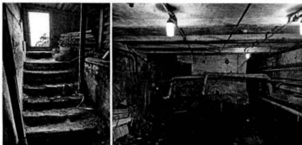
Фото 8. Ступени примка дворового восточного фасада корпуса по Соляному переулку со стороны северного двора
