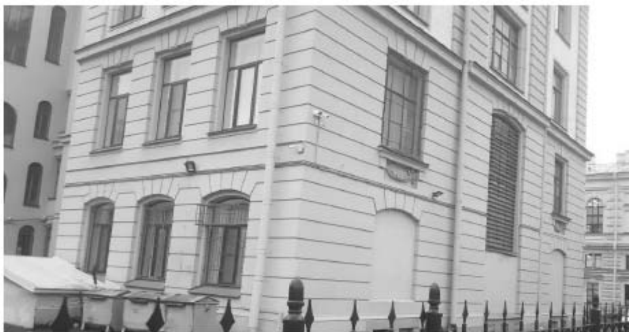
28. «3-я С.Петербургская гимназия с участком бывшего сада») (Соляной пер., д. 12, лит. А). Дворовые фасады. Фото мест установки оборудования и прокладки кабельных трасс. Штиглиц М.С. 10.11.2025 г.
