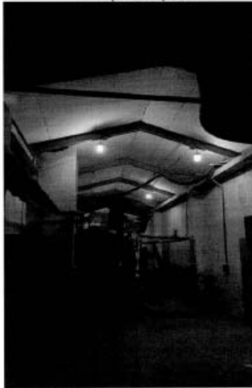
7. Фрагмент помещения чердака
