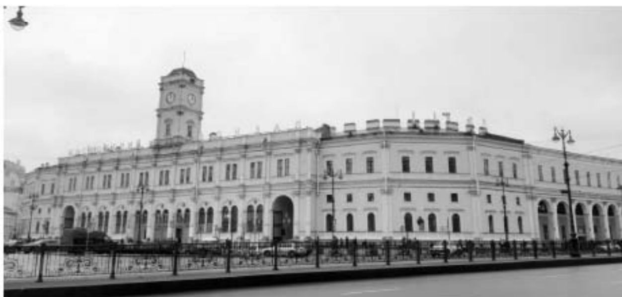
20. «Вокзал Николаевский (Московский)» (Невский пр., д. 85, лит. А). Общий вид. Штиглиц М.С. 10.11.2025 г.
