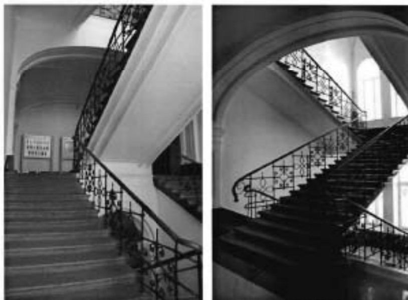
Фото №3, 4, 5. Парадная трехмаршевая распашная межэтажная лестница.
