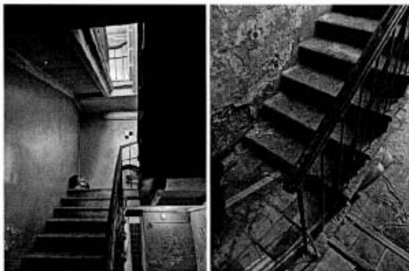
Фото 80, 81. Лестница Л-1 в корпусе по Гагаринской улице
