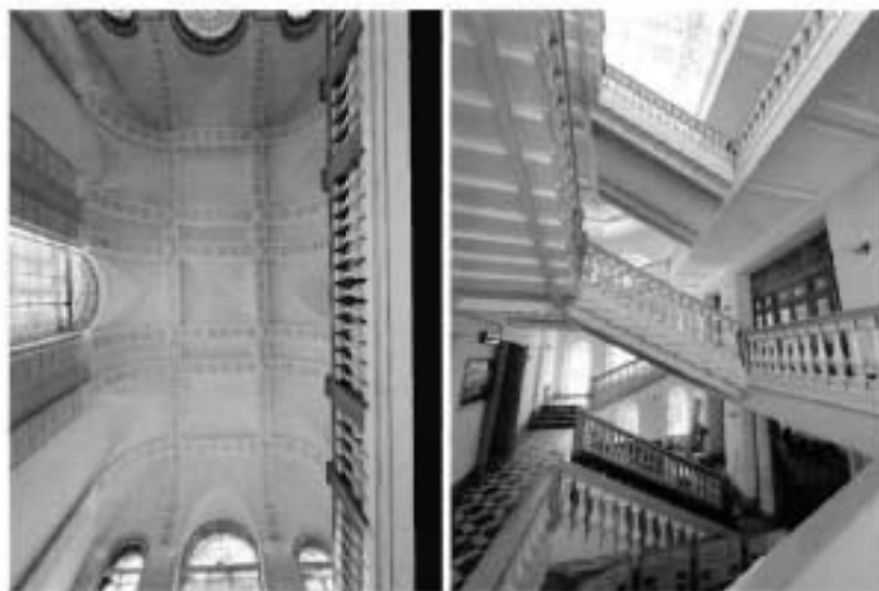
12, 13. Коридоры 2-3 этажа корпуса по Соляному переулку
