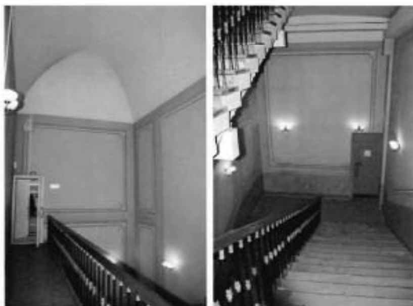
Фото №8, 9. Двухмаршевая межэтажная лестница.
