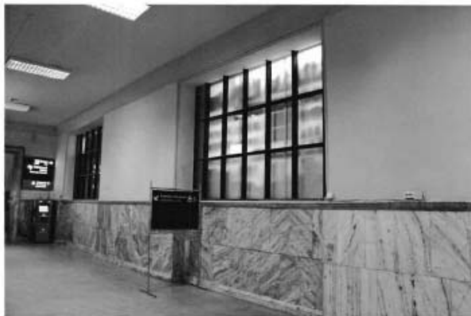
Фото №5. Проходной холл.
