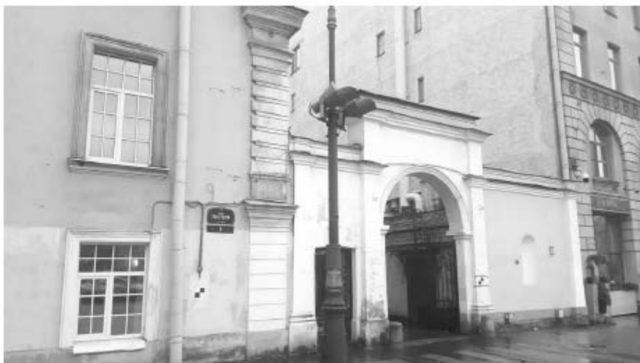
33. «Каменные ворота, помещение для охраны, два флигеля» (в составе «Особняк Кочубея В.П. (комплекс зданий Министерства внутренних дел)») (Пестеля ул., д. 9, лит. В). Лицевой фасад. Фото мест установки оборудования и прокладки кабельных трасс. Штиглиц М.С. 10.11.2025 г.
