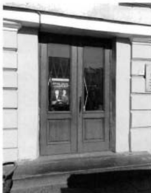
8. Фрагмент южного фасада объекта культурного наследия (фото от 06.09.2023).
