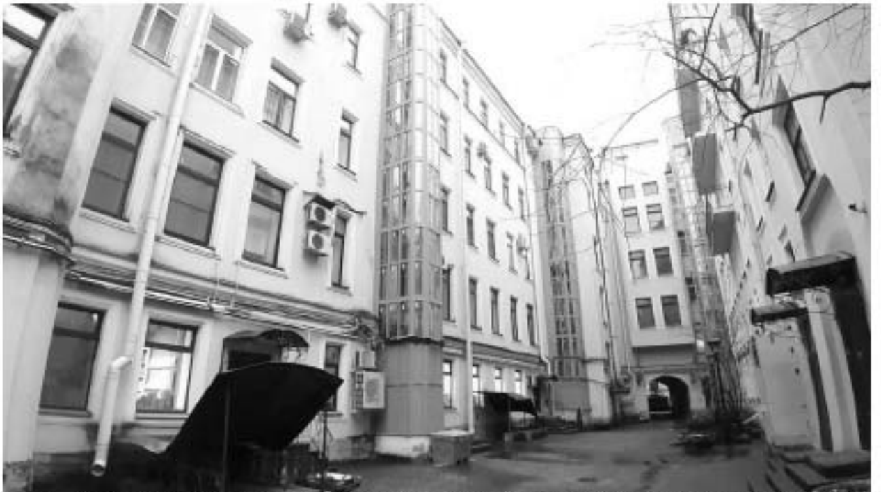
8. «Дом, где в меблированных комнатах «Париж» у Вацлава Вацлавовича Воровского в 1905 г. Владимир Ильич Ленин часто бывал по партийным делам». (наб. реки Фонтанки, д. 29/66, лит. А). Дворовые фасады. Фото мест установки оборудования и прокладки кабельных трасс. Штиглиц М.С. 10.11.2025 г.
