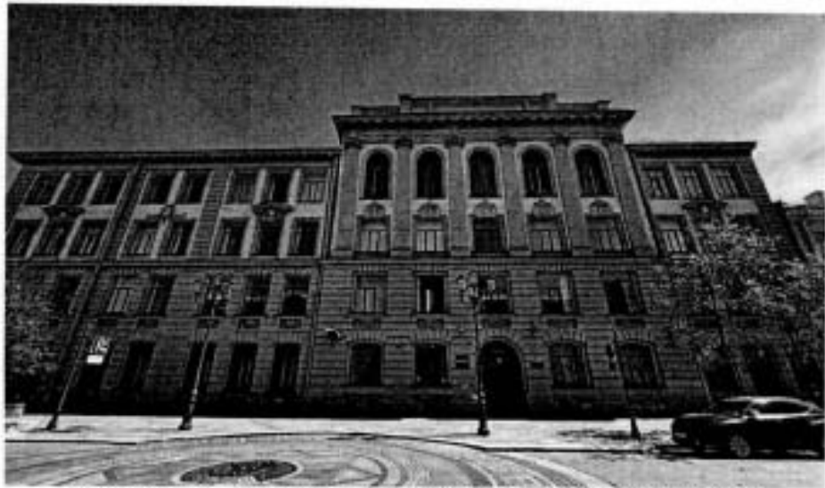
Фото 1. Общий вид лицевого (западного) фасада по Соляному переулку
