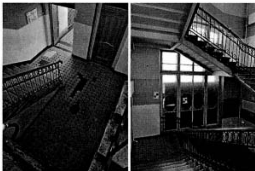
Фото 30, 31, 32, 33. Лестница в северной части корпуса по Соляному переулку (пом. 1-Н (14,85,130,150))
