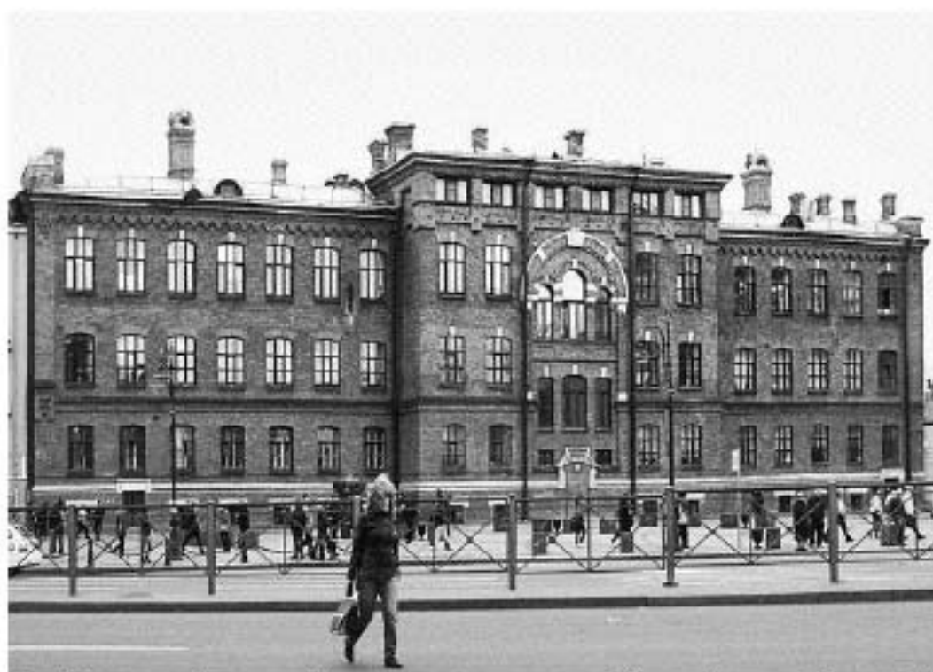
28. «Конторский корпус Николаевского вокзала» (Невский пр., д. 85, лит. 3). 2012 г. Из книги Б. М. Кириков, Л. А. Кирикова, О. В. Петрова. Невский проспект. Дом за домом, 2013.
