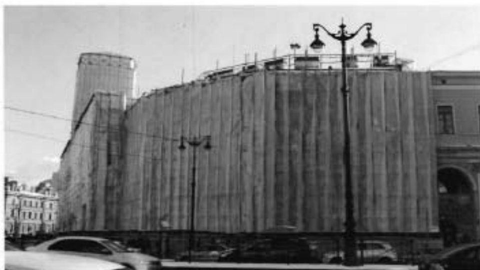
Фото №2. Вид на северо-западную часть фасада со стороны Лиговского проспекта.
