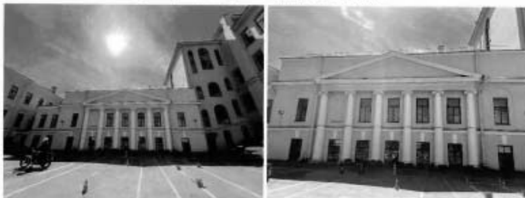
22, 23. Южный фасад центрального дворового корпуса
