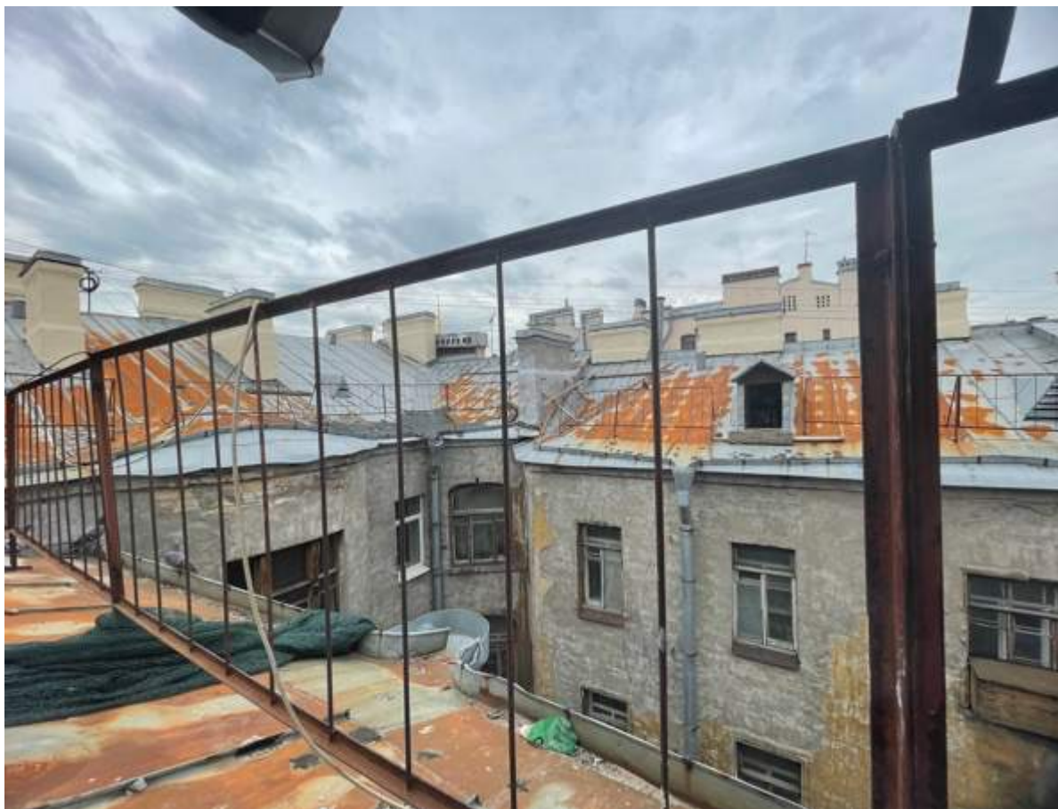
45. Вид на крыши здания
