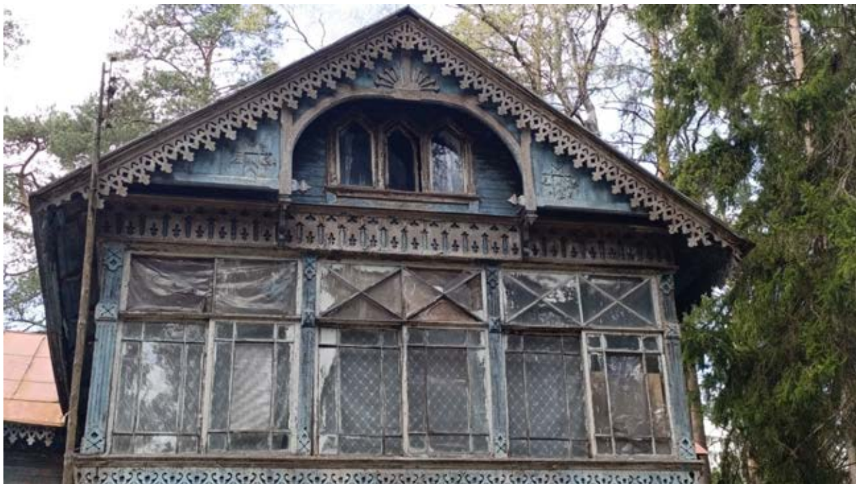
Фото 13. Фронтон восточного фасада.
