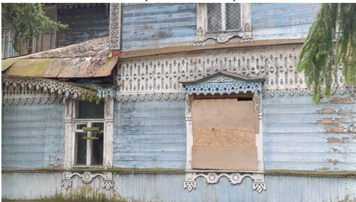
Фото 14. Фрагмент северного фасада.
