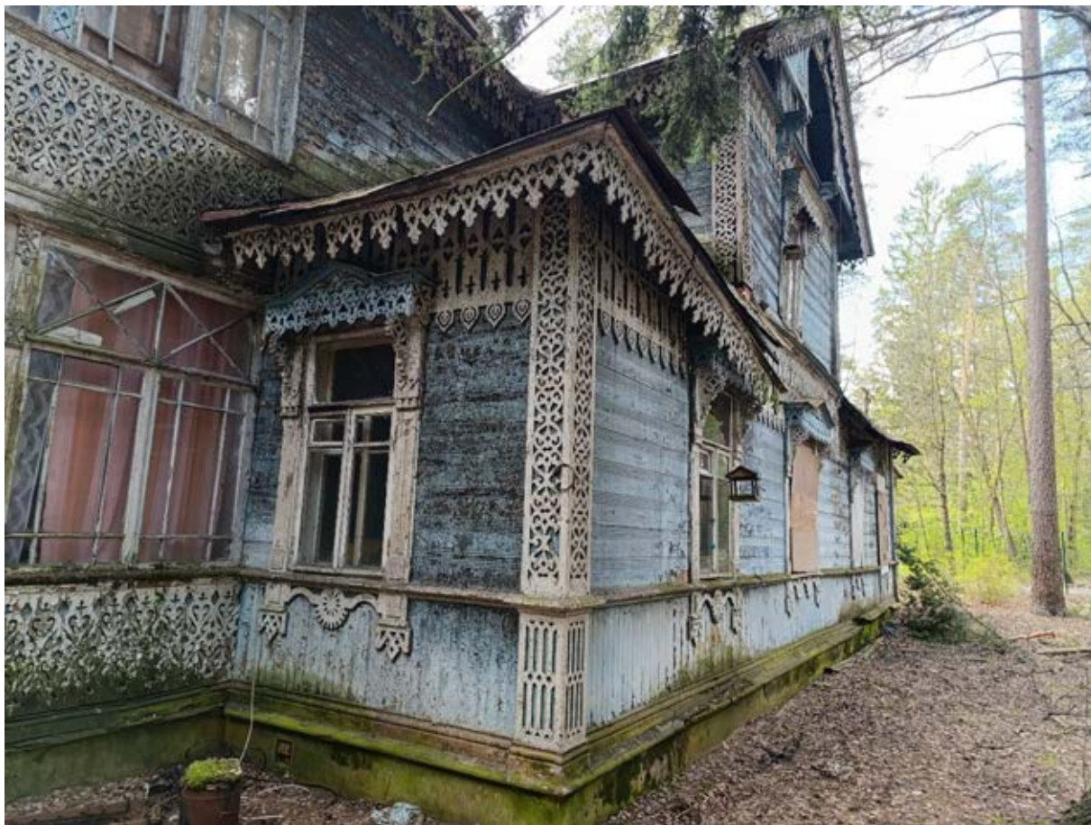
Фото 7. Фрагмент восточного фасада, вид вдоль северного фасада.
