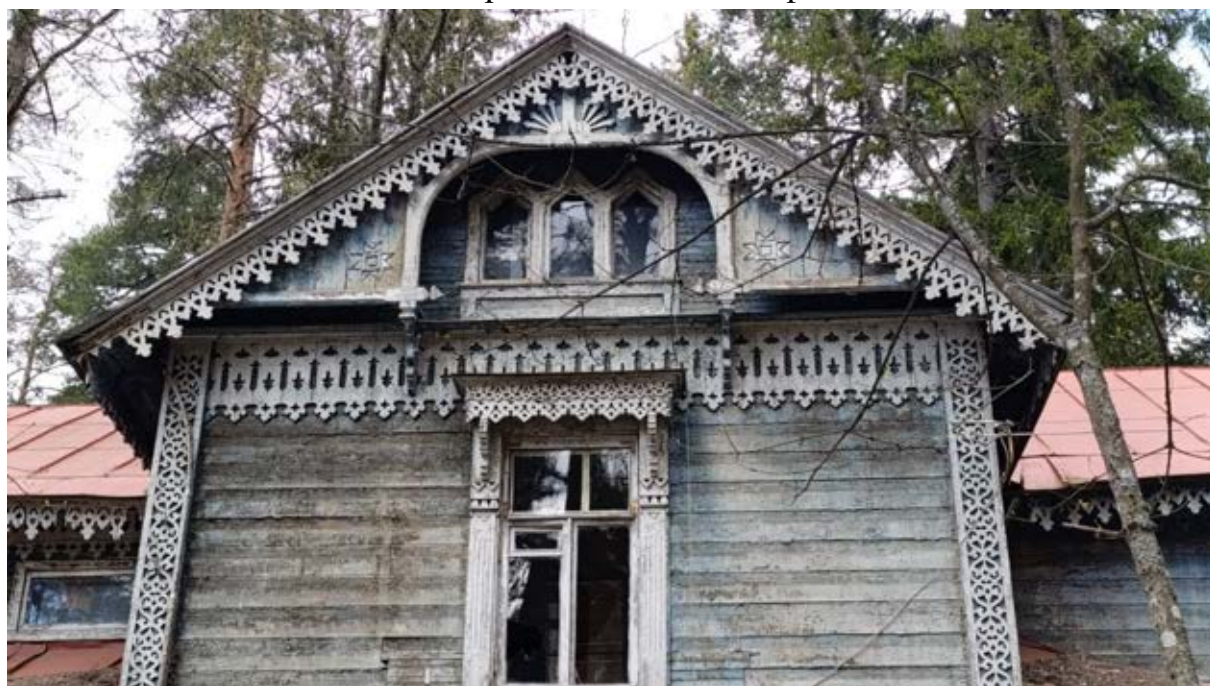
Фото 10. Фронтон южного фасада.
