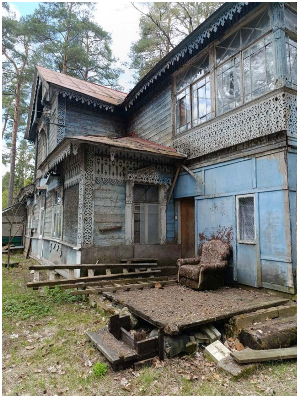
Фото 12. Вид с юго-востока на веранду.
