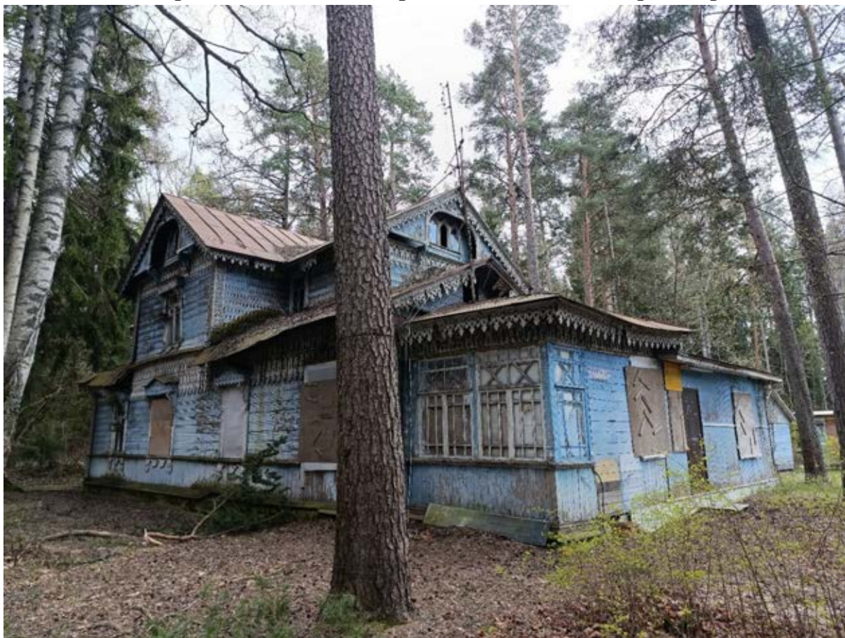
Фото 8. Вид объекта с северо-запада.
