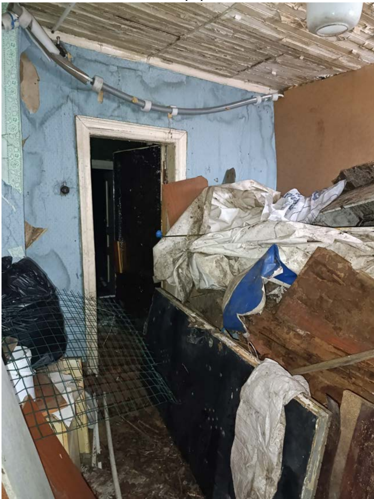
Фото 18. Помещение 15, вид в сторону коридора.
