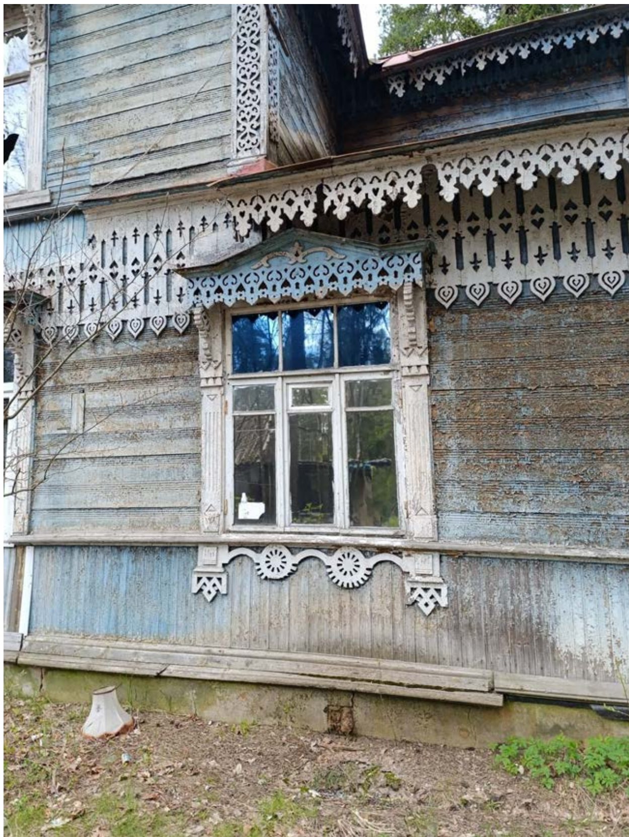
Фото 11. Фрагмент южного фасада, окно.
