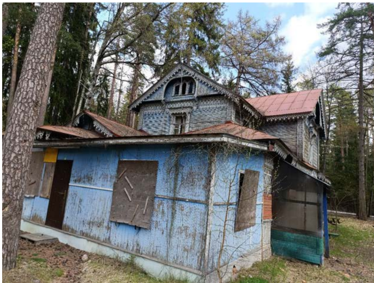
Фото 9. Фрагмент западного фасада.
