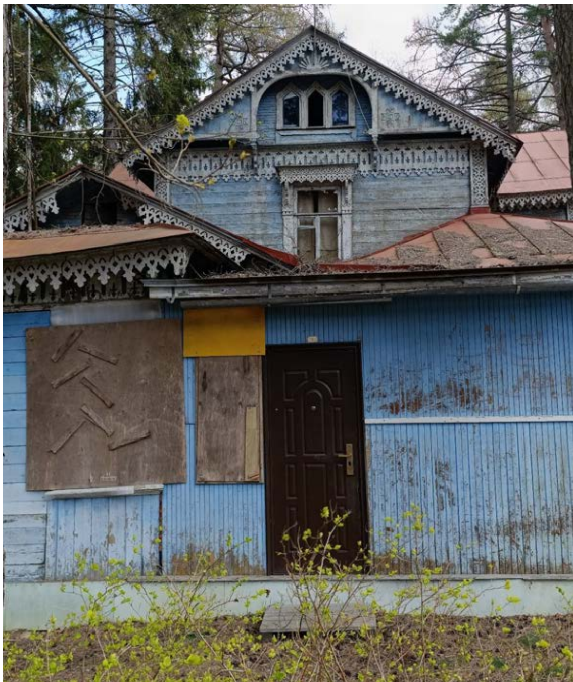
Фото 17. Фрагмент западного фасада
